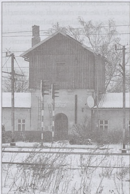
Elewacja frontowa nowotarskiej wieży przed remontem, 13.02.2010 r. Fot. P. Skucha
