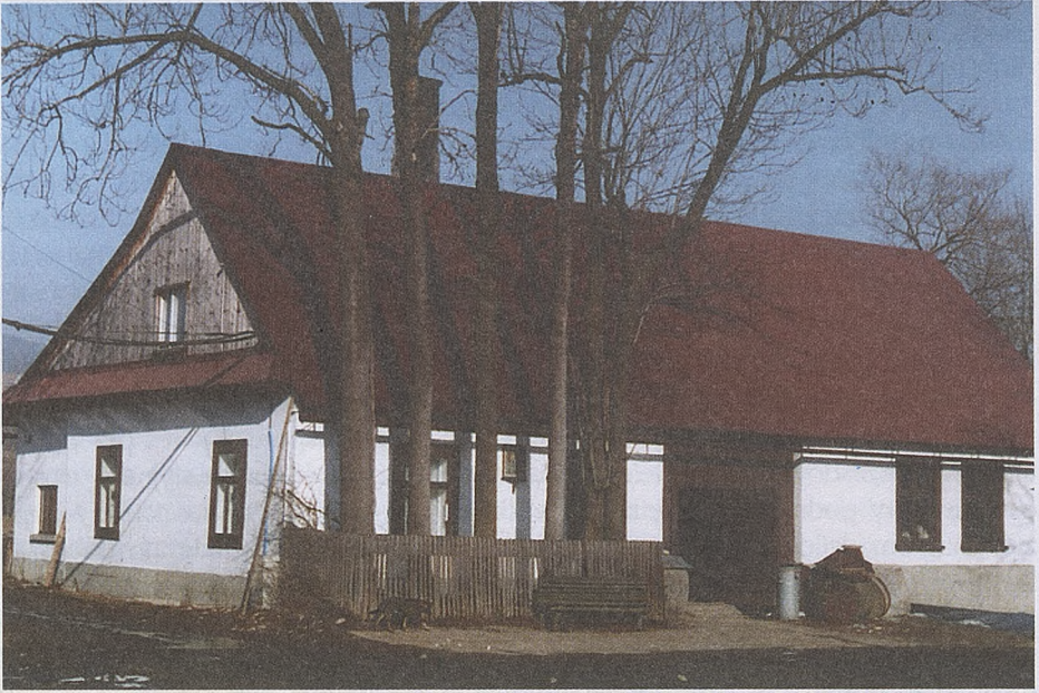
Stary dom mieszkalny i młyn - przebudowany po pożarze w 1990 r. Fot. Adolf Szpytma
