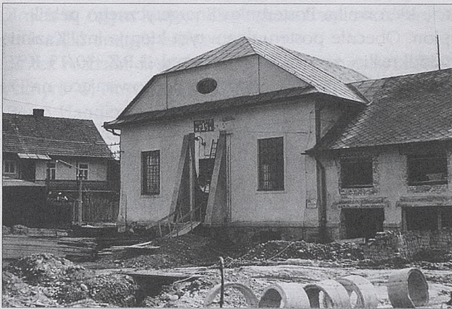
Budynek Elektrowni Miejskiej, stan w 1970 r. w czasie remontu. Fot. Adolf - Szpytma.
