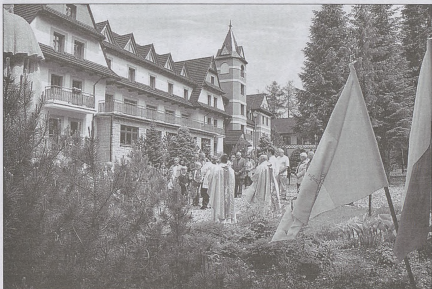
Wyraźny podział dobudowanych części „Księżówki” (drewniana, ceglana, ogrodowa) fot. archiwum
