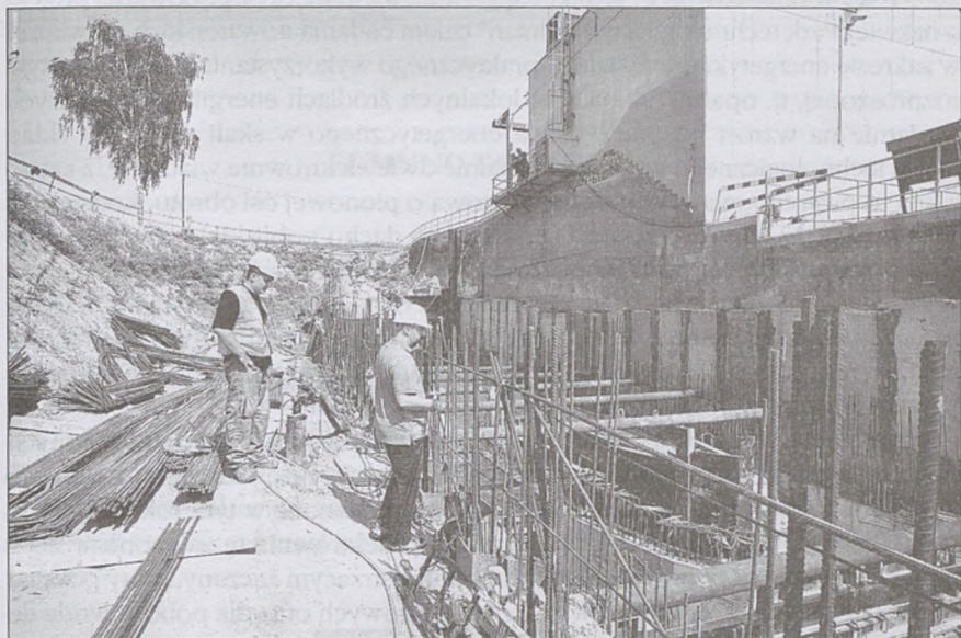
Modernizacja elektrowni wodnej w Łęczanach, fot. Leszek Bajorek
