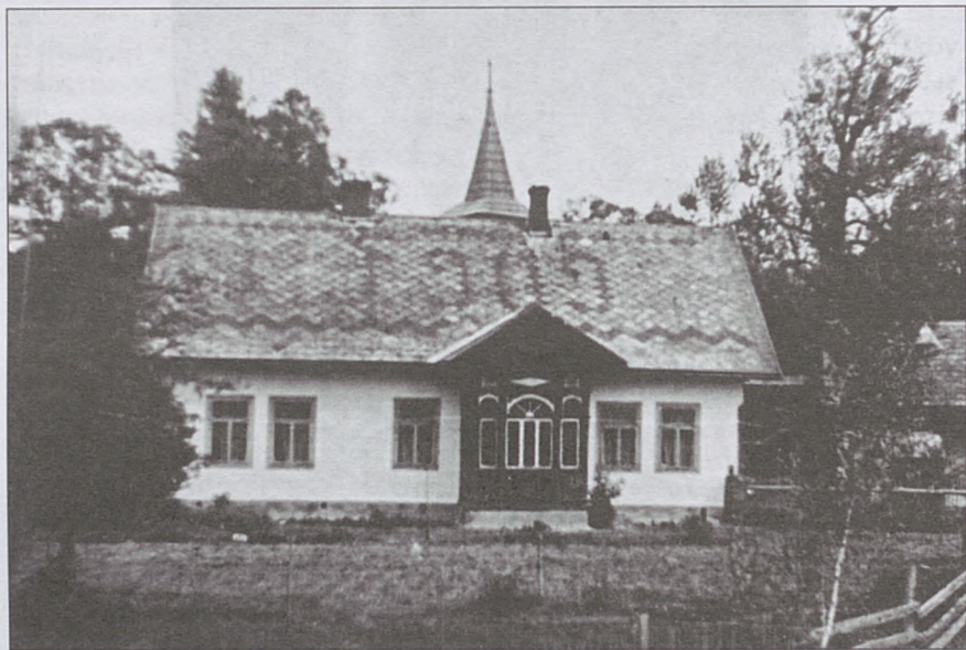
Stary budynek plebanii
