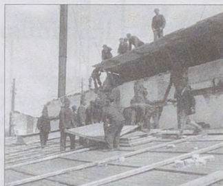
Krycie dachu bali traków. Zdjęcie z 1945 r.
