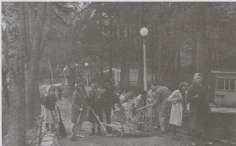
Prace remontowe na deptaku (archiwum K. Ceklarz)
