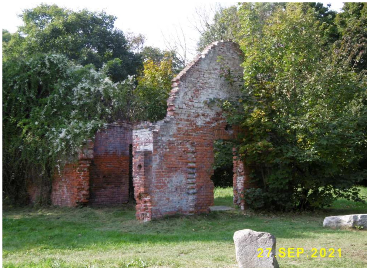
Fot. nr 105 (105-110). Malownicza dziś ruina starej prochowni z czasów Twierdzy Kraków, usytuowana w sąsiedztwie ulicy Swoszowickiej.
