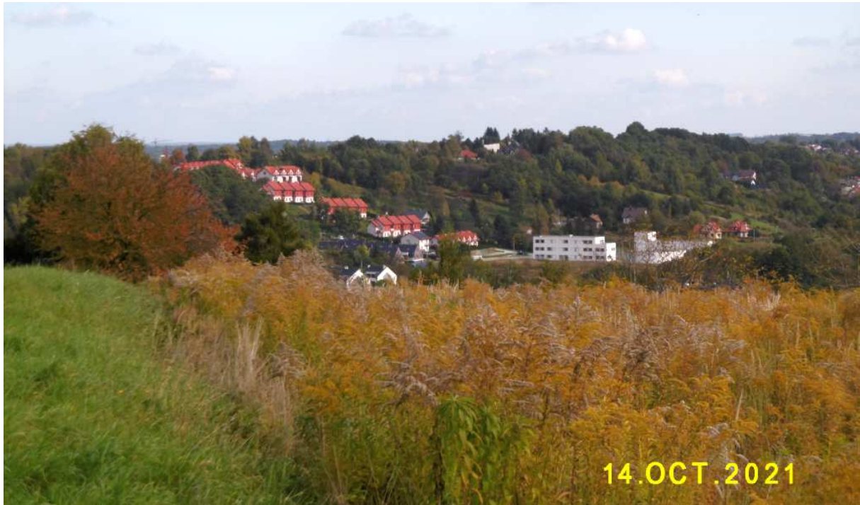
Fot. nr 474 (474-476). Spojrzenia na zabudowę wgórze Kaim, która na tak stromym i labilnym pod względem geologicznym zboczach nigdy nie powinna powstać. O względach historycznych nie wspomnę. Dziś części domów grozi już zjazd w dół.
