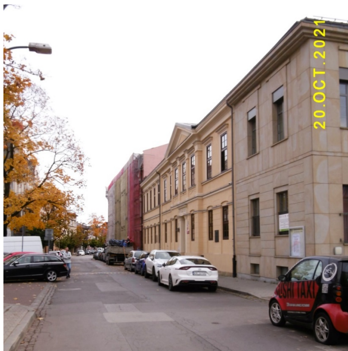
Fot. nr 51 (51-53). Fragment zabudowy ulicy powyżej numeru 10.
