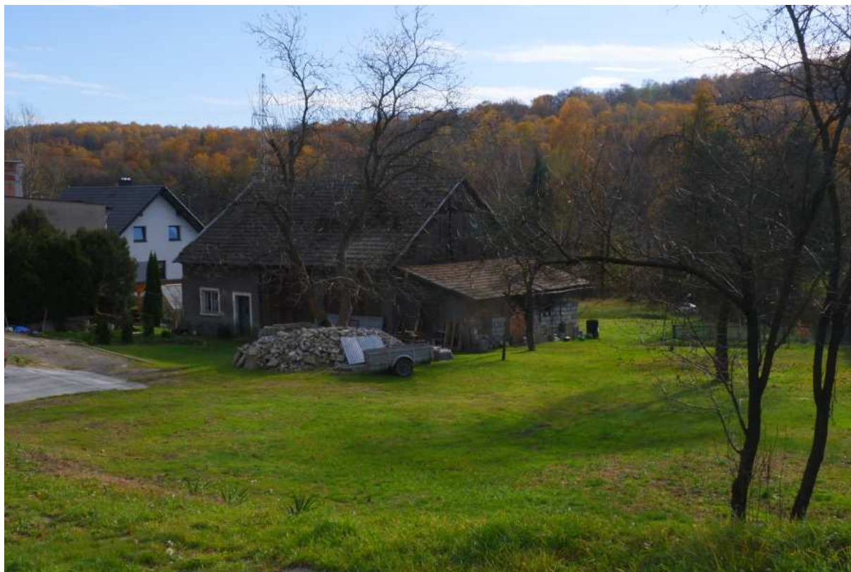
Fot. nr 284. Zagroda pod nr 43 i pusta już przestrzeń po wyburzonej chałupie pod nr 45.
