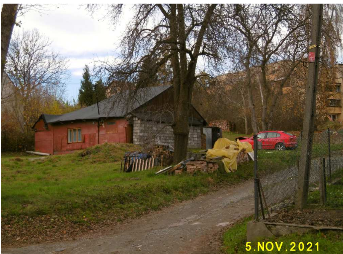
Fot. nr 277 (277-280). Około 150-letnia chałupa pod nr 44, której bielona fasada niedawno została obita pilśnią.
