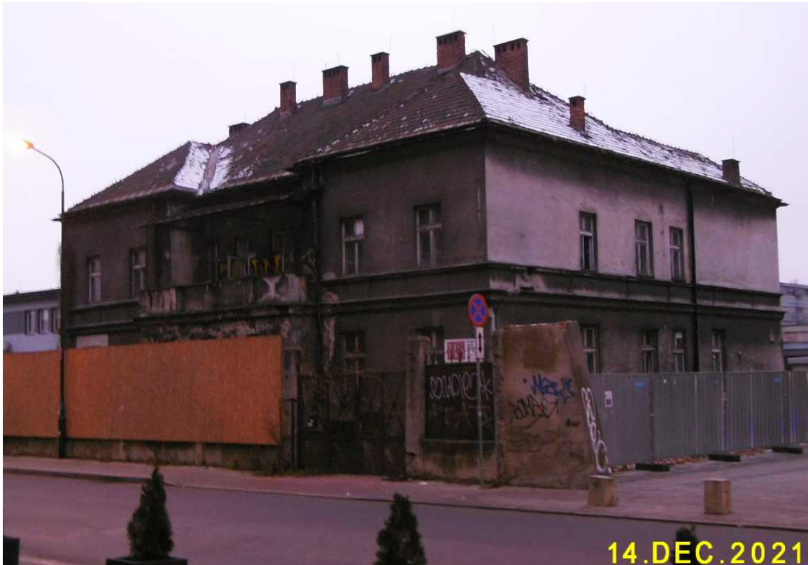
Fot. nr 80 (80-81). Budynek dyrekcji dawnej Fabryki Wyrobów Metalowych Józefa Goreckiego z ulicy Romanowicza 9, który powstał w latach 20. XX wieku, po przeniesieniu tu zakładu produkcyjnego z ulicy św. Wawrzyńca na Zabłocie.
