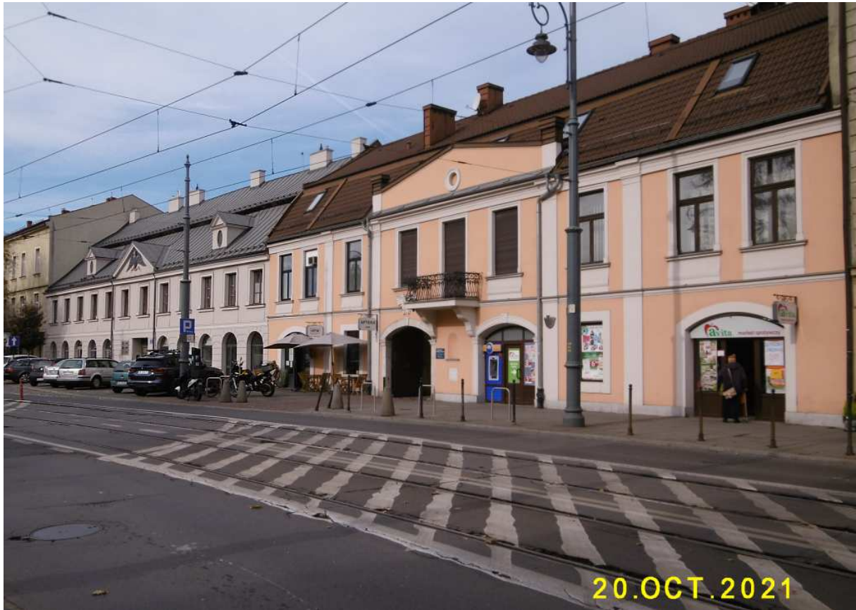
Fot. nr 62 (62-67). Wokół Rynku Podgórskiego. Domy: Pod Czarnym Orłem-z lewej-pod nr 13 i Pod Białym Orłem-dawny ratusz-pod nr 14, w kształtach nadanych im w poł. XIX w.
