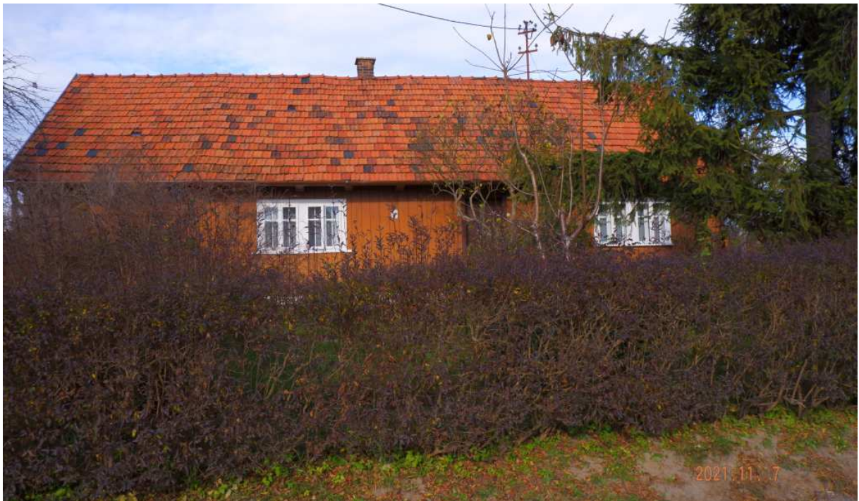
Fot. nr 405. Fasada z oryginalnymi oknami typu ościeżnicowego.
