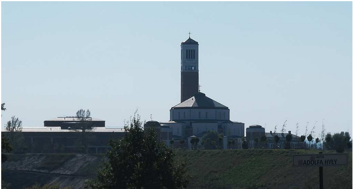
Fot. nr 219. Wieża widokowa przy kościele św. Jana Pawła II.
