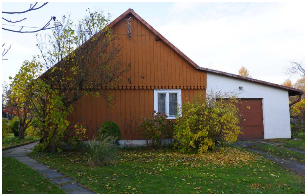
Fot. nr 406. Boczna ściana domu.
