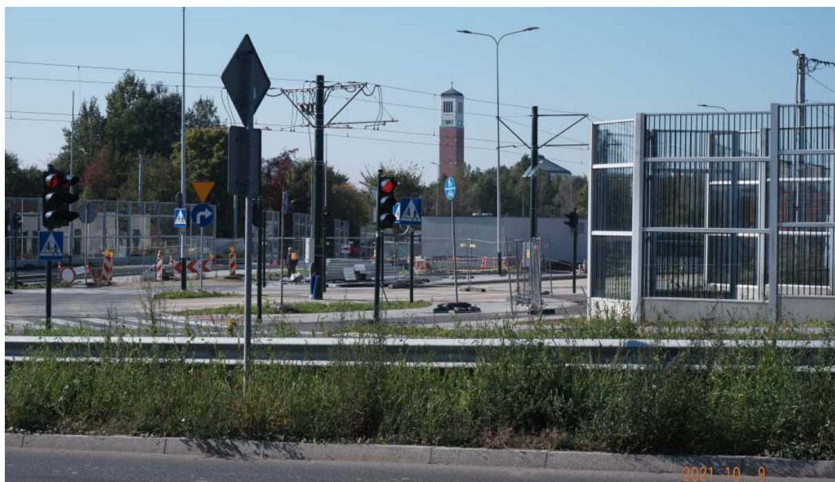
Fot. nr 180 (180-181). Na budowie „trasy Łagiewnickiej”, na przedłużeniu ulicy Witosza.
