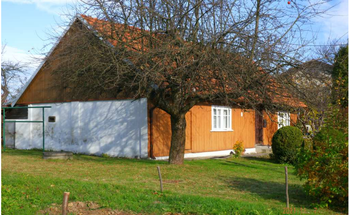
Fot. nr 404 (404-406). Około stuletni, obity szalunkiem dom z ulicy Osterwy 24. Miło patrzeć na taki ciągle zadbane i zamieszkały oryginał.
