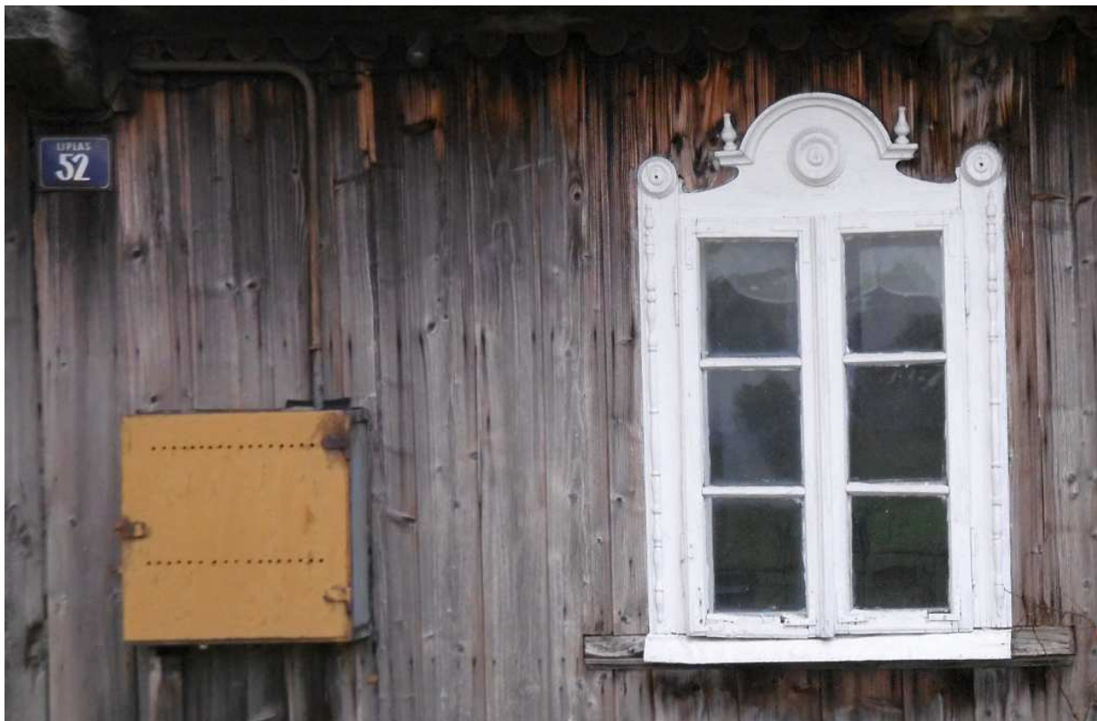
Fot. 565a. Okno z niezwykle oryginalnym obramieniem.
