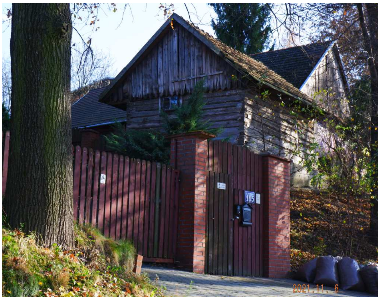
Fot. nr 365 (365-366). Budynek gospodarczy o konstrukcji zrębowej przy ulicy Tuchowskiej 105.
