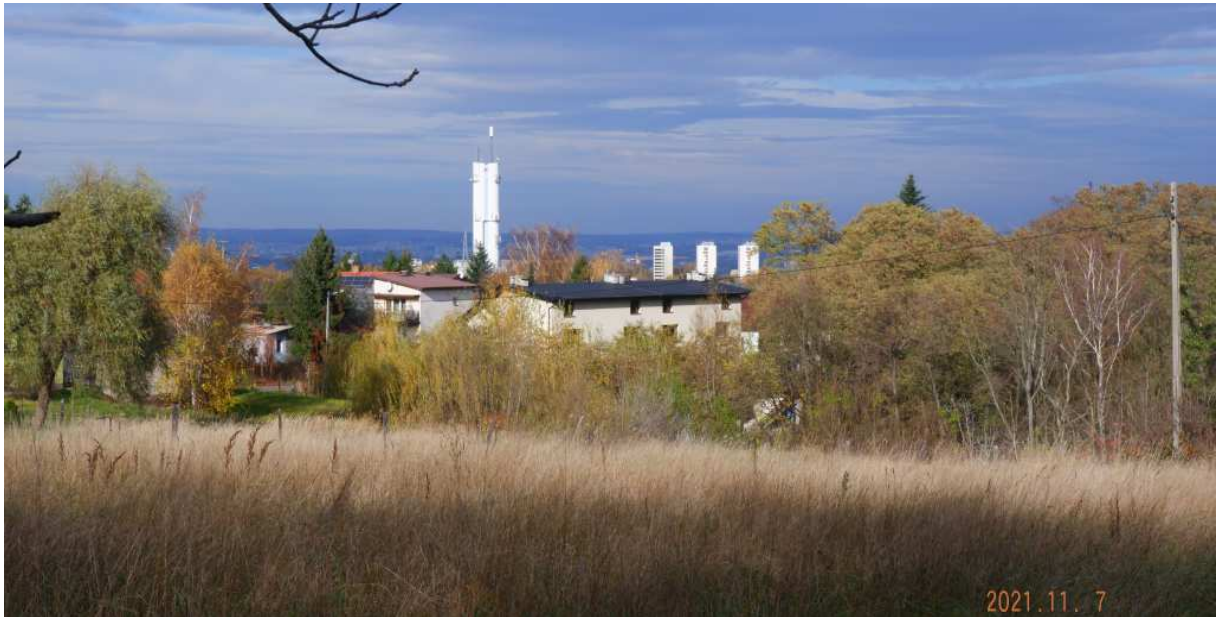
Fot. nr 428. Powrót pod fort Barycz. Pośrodku wieża ciśnięć rurociągu Raba.
