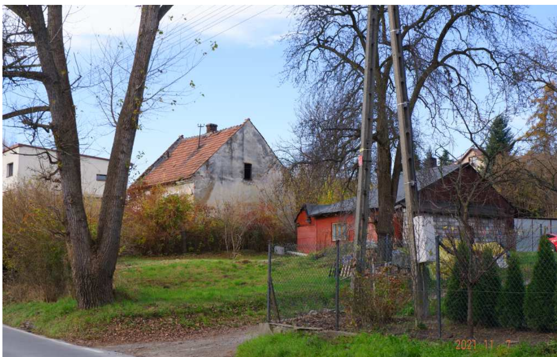
Fot. nr 276(276-287). Wzdłuż ulicy Kosocickiej. Relikty dawnej zabudowy pod nr: 44 i 46.
