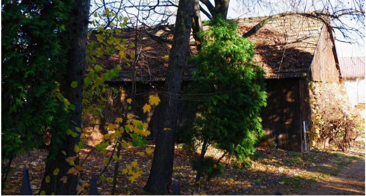
Fot. nr 394. Stodoła na posesji przy ulicy Szczawnickiej 11a.
