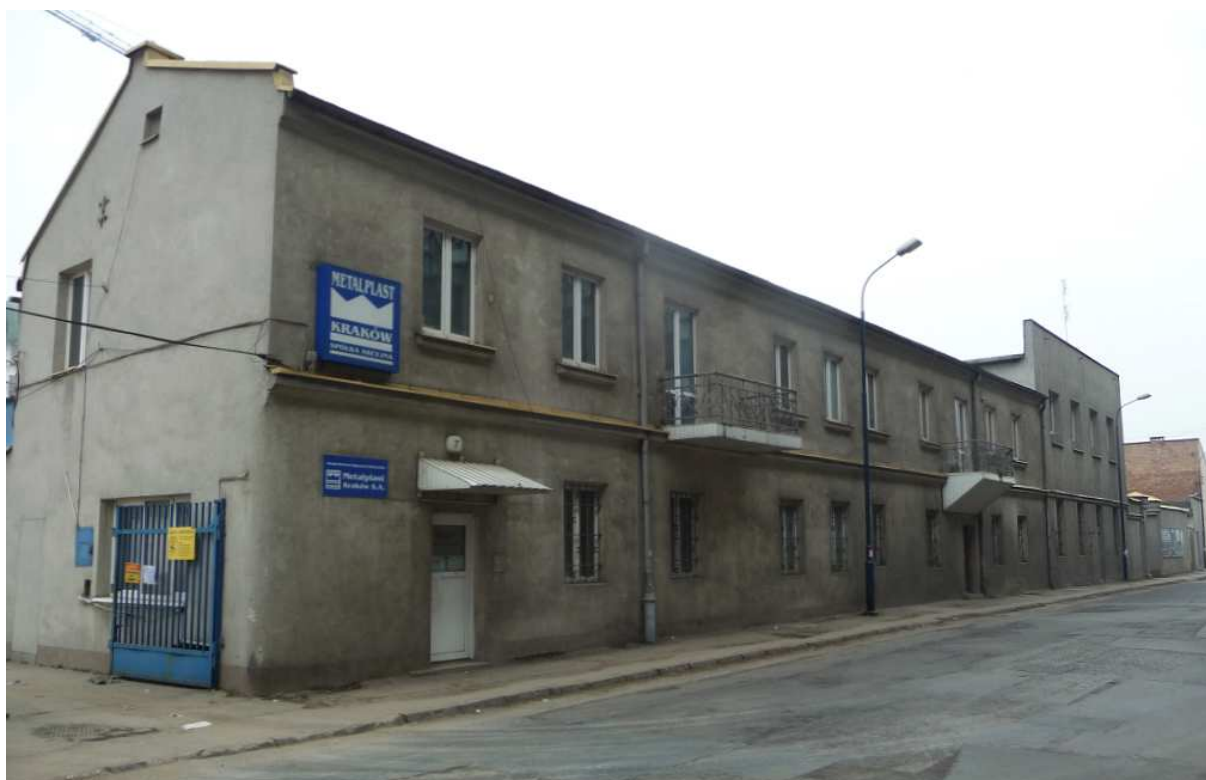
Fot. nr 498. Budynek spod nr 7. (27.02.2014)
