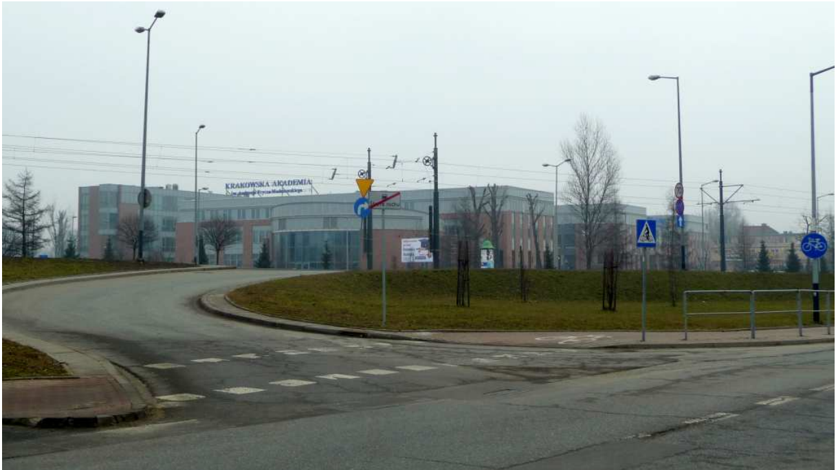
Fot. nr 488. Budynki Krakowskiej Akademii im. A. Frycza Modrzewskiego przy ulicy Gustawa Herlinga-Grudzińskiego 1 – widok z ulicy Zabłocie. (27.02.2014)
