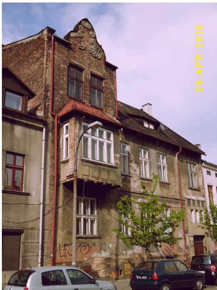
Fot. nr 294 (294-295). Secesyjna kamienica pod nr 23, wybudowana ok. roku 1912, która posiada ciekawe, choć niestety uszkodzone zwieńczenie.
