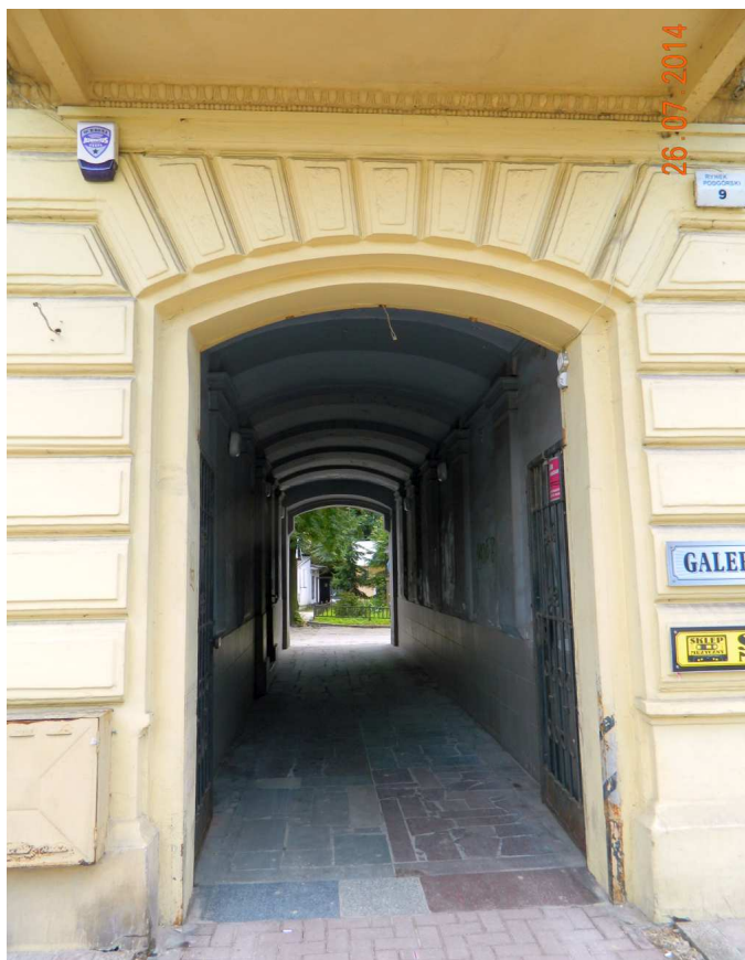
Fot. nr 104. Sień kamienicy.
