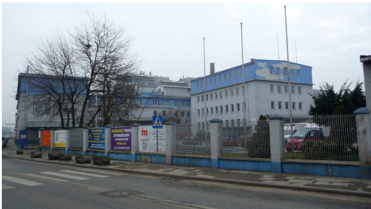
Fot. nr 476 (476-477). Wspomnienie zabudowań fabryki kosmetyków Miraculum (nazwa od 1949) przy na posesji pod nr 23, wybudowanej w 1913 roku, kiedyś giganta w tej branży. (27.02.2014)
