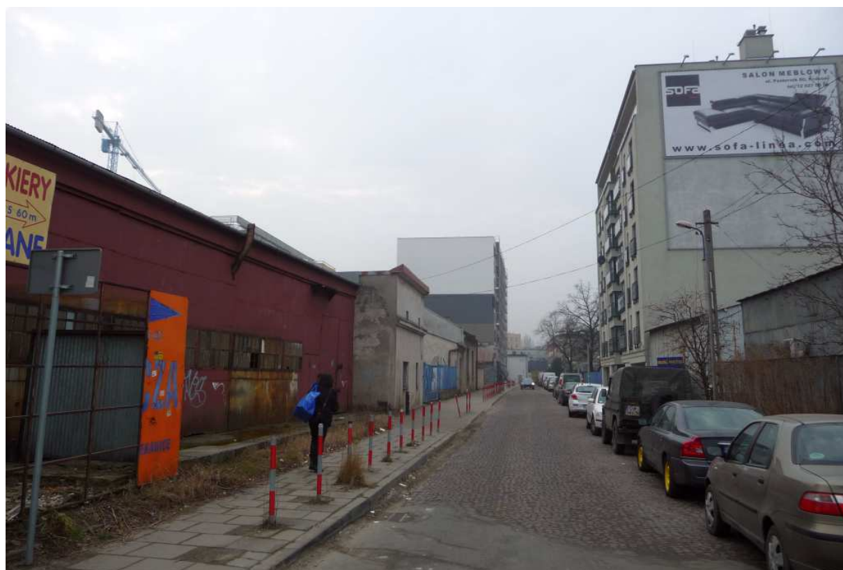
Fot. nr 483 (482-483). Widoki od strony ulicy Zabłocie. (27.02.2014)
