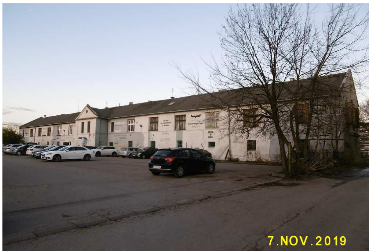
Fot. nr 385. Widok na fasadę.
