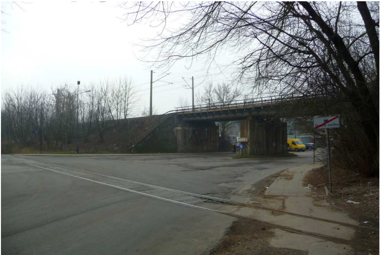
Fot. nr 511. Wiadukt na styku ulic: Dąbrowskiego i Dekerta w ujęciu z ulicy Romanowicza. (27.02.2014)
