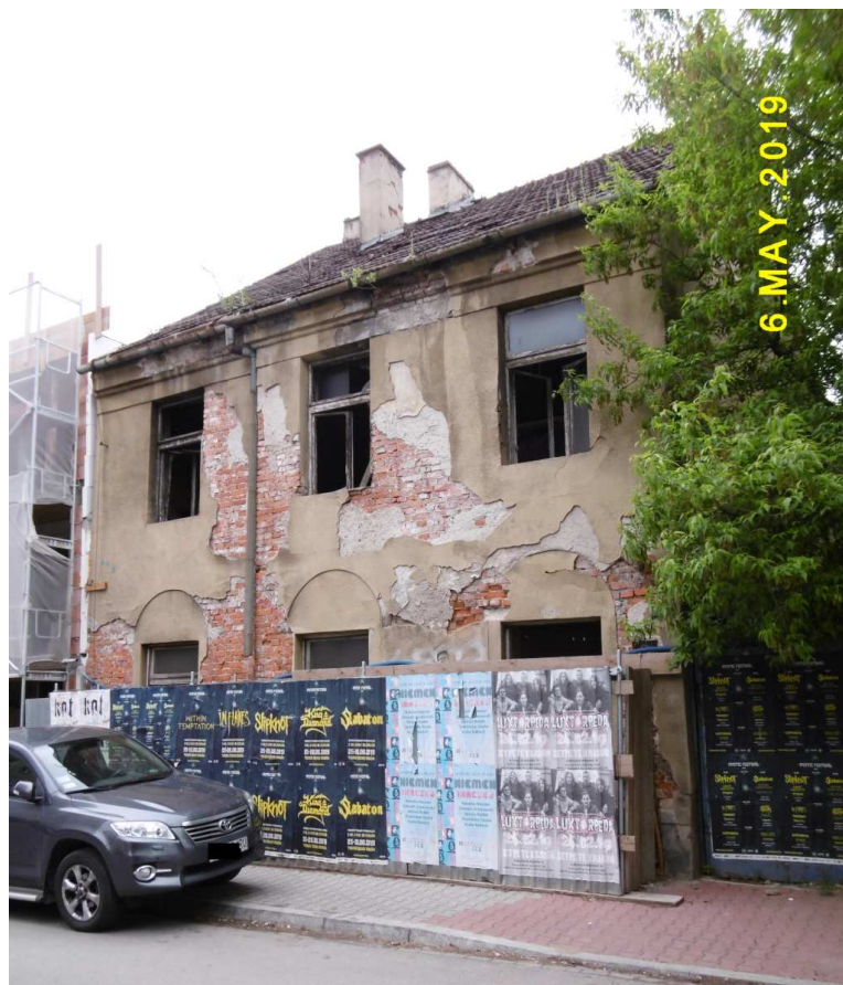
Fot. nr 412. Ruina spod nr 12 na etapie przebudowy.
