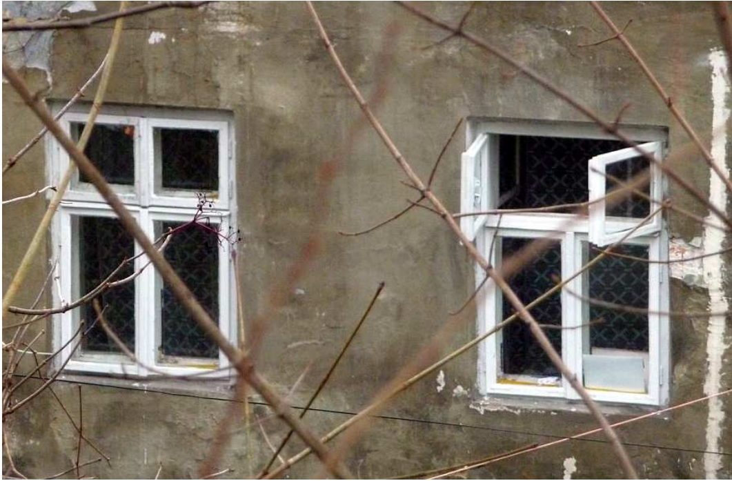
Fot. nr 170. Oryginalne okna typu ościeżnicowego. (23.11.2013)
