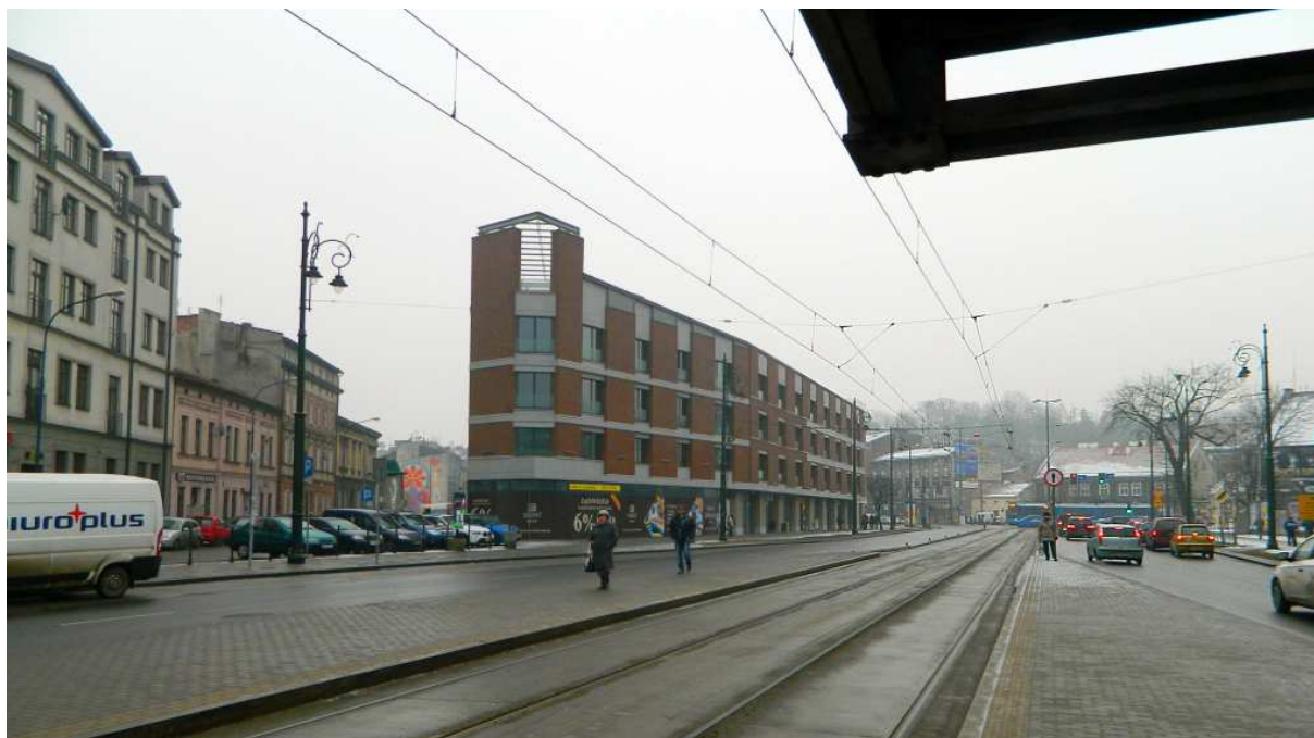
Fot. nr 390 (390-391). Rozwidlenie ulic: Na Zjeździe i Lwowskiej w nowych realiach. (25.01.2017)
