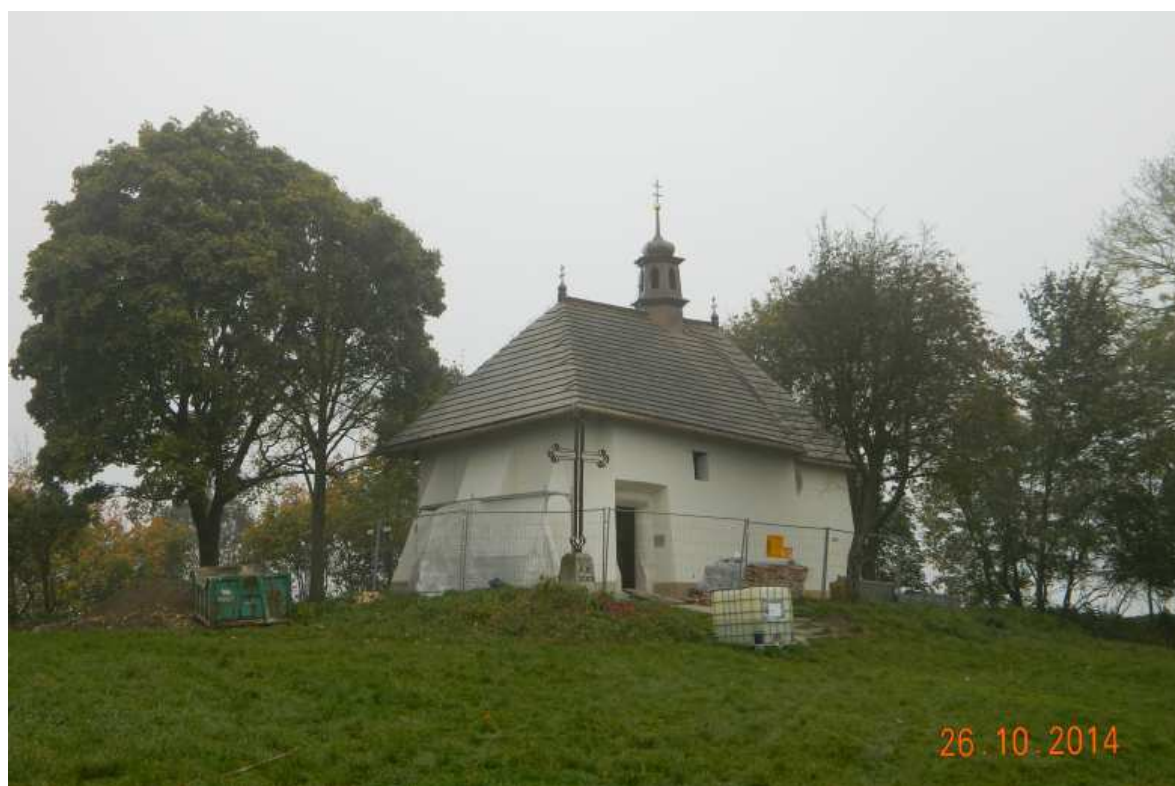
Fot. nr 523. Końcowy etap prac konserwatorskich przy kościółku św. Benedykta, przy których okazji przeprowadzono kolejne badania archeologiczne. Stwierdzono, że pierwszą jego fazą była archaiczna budowla czworokątna, a nie rotunda.
