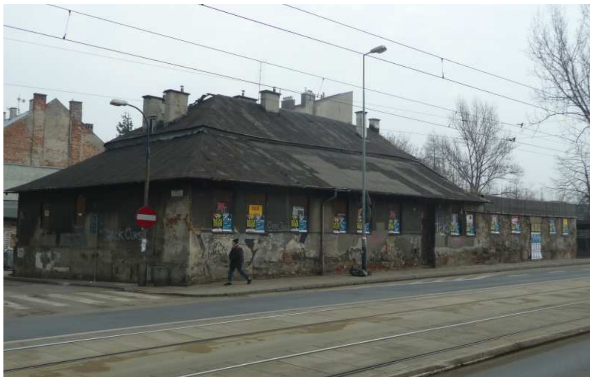
Fot. nr 350 (350-359). Pochodzący z końca XVIII. wieku, częściowo spalony i wykreślony z rejestru zabytków dworek spod nr 47 i jego detale. Jaki czeka go los? (27.02.2014)
