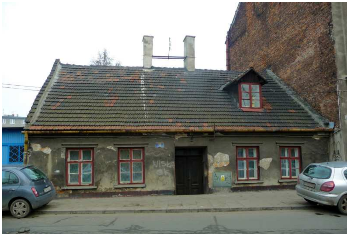
Fot. nr 446 (446-453). Zapewne ponad stuletni relikw dawnej zabudowy Podgórze spod nr 12, który niedawno został wyburzony. (27.02.2014)
