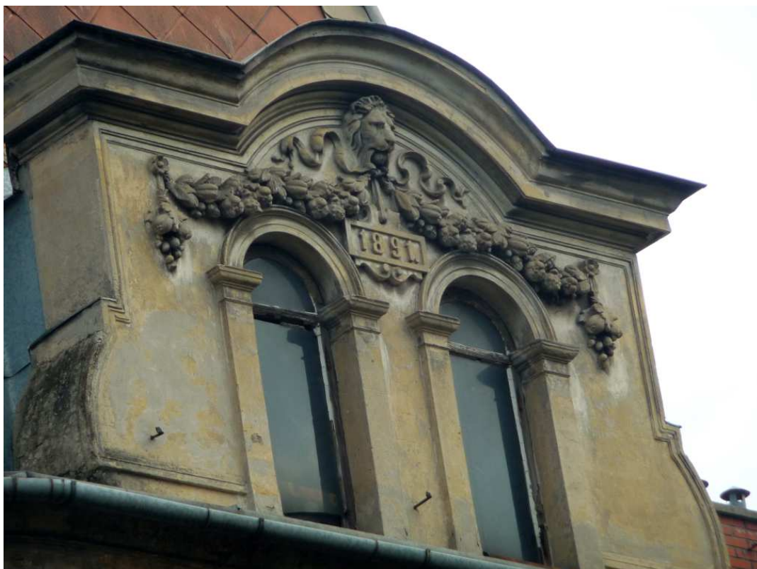
Fot. nr 438. Data ukończenia budowy.
