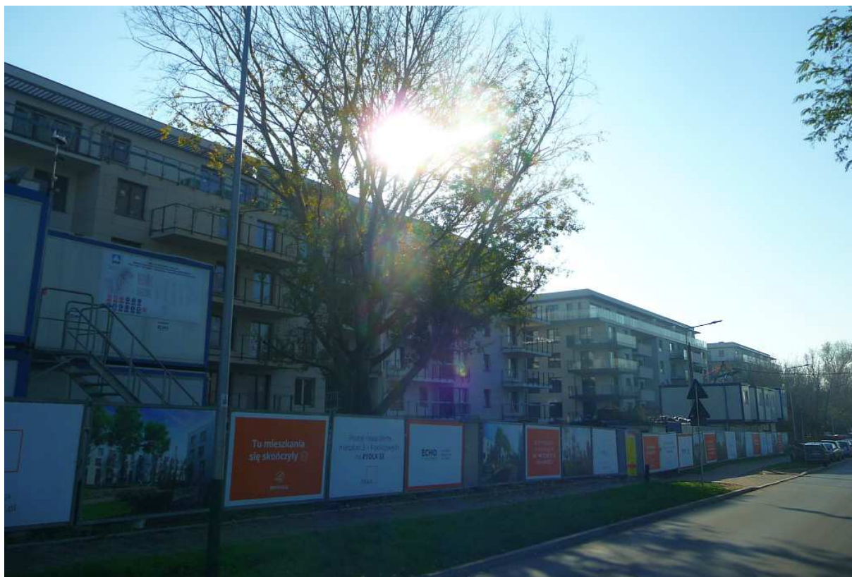
Fot. nr 79 (79-81). Ukończone już blokowisko mieszkalne pod nr 2. (11.11.2018)
