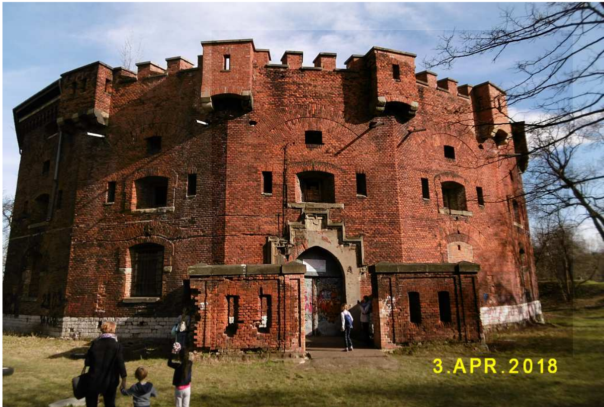
Fot. nr 520. Widok od strony bramy wjazdowej.
