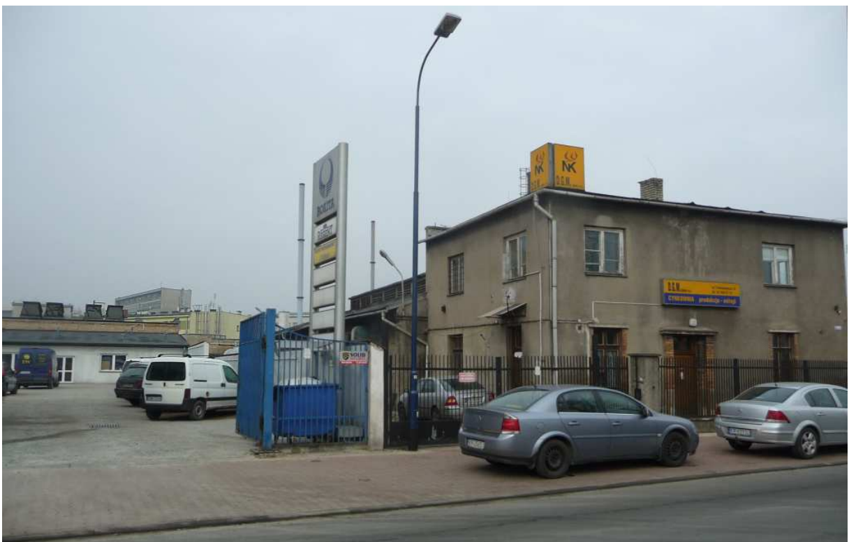
Fot. nr 509. Zabudowania handlowo-usługowe na posesji pod nr 15. (27.02.2014)
