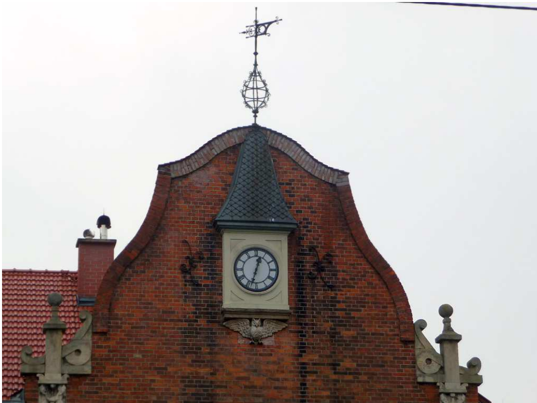
Fot. nr 151. Zwieńczenie budynku. (23.11.2013)
