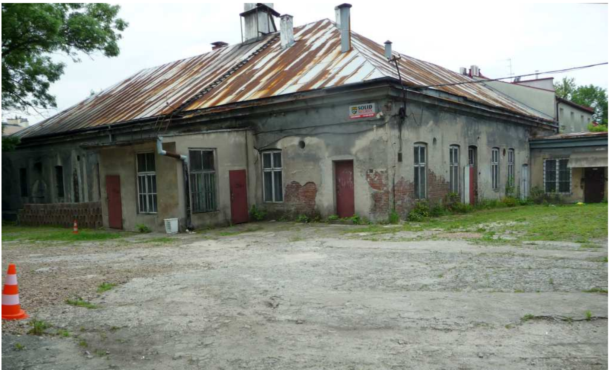
Fot. nr 125 (124-130). Pozostałość po podgórskim przemyśle; zabudowania fabryczno-biurowe S-pni Szklarskiej na posesji pod nr 1 na etapie likwidacji. Ma tu powstać zabudowa mieszkalna. (21.06.14)
