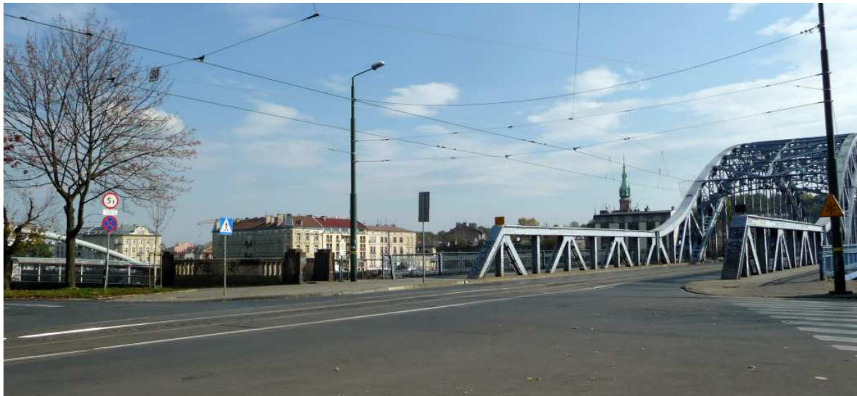
Fot. nr 235. Widok ponad IV. (dziś II.) Mostem im. J. Piłsudskiego. (13.10.2010)
