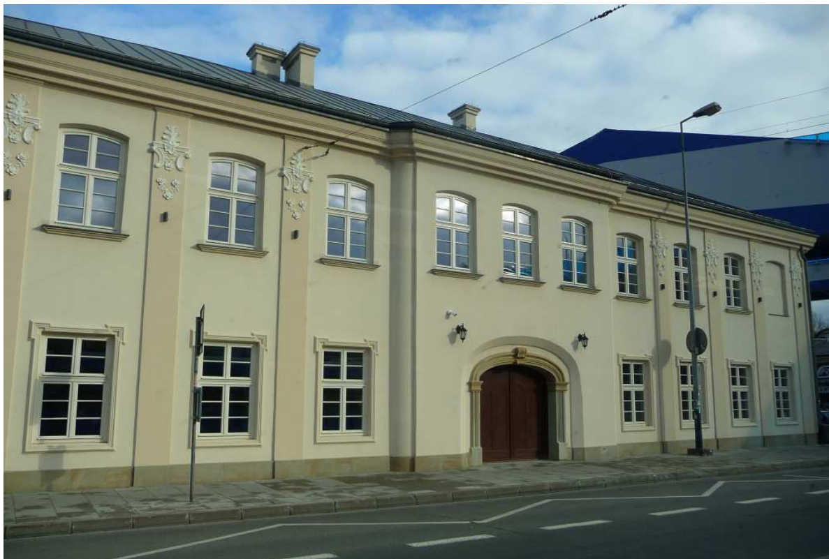
Fot. nr 364 (364-366). Dawny zajazd pięknie odnowiony na siedzibę Muzeum Podgórze, gdzie w fasadzie wyeksponowano zachowane detale rokokowego zdobnictwa. (14.11.2017)
