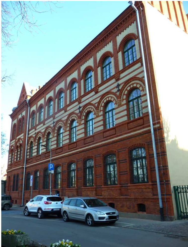
Fot. nr 92. Budynek dawnej szkoły, dziś siedziby podgórskiego Domu Kultury, z ulicy Sokolskiej 13. (11.11.2018)
