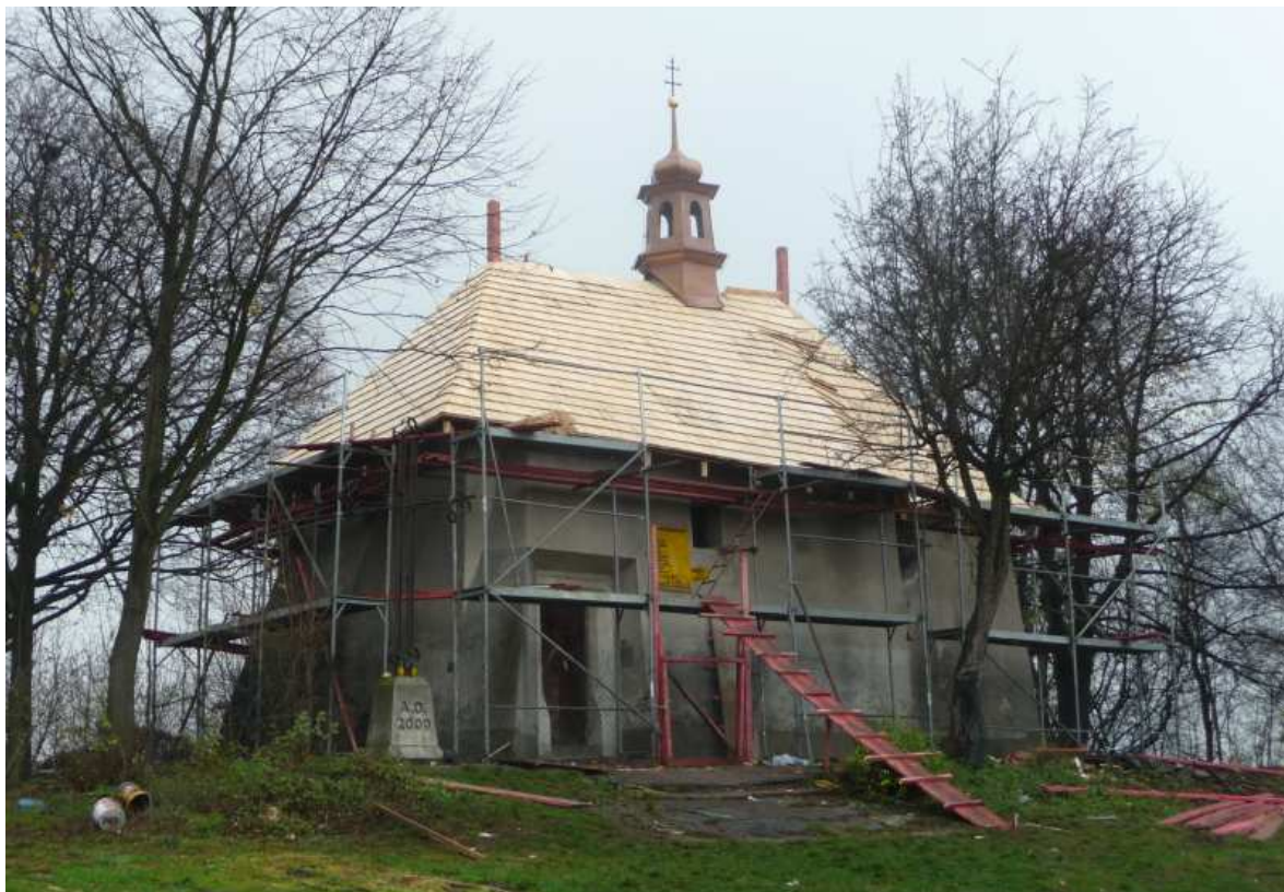
Fot. nr 522 (522-527). Wokół kościółka Kościół św. Benedykta – tu podczas prac remontowych. (23.11.13)
