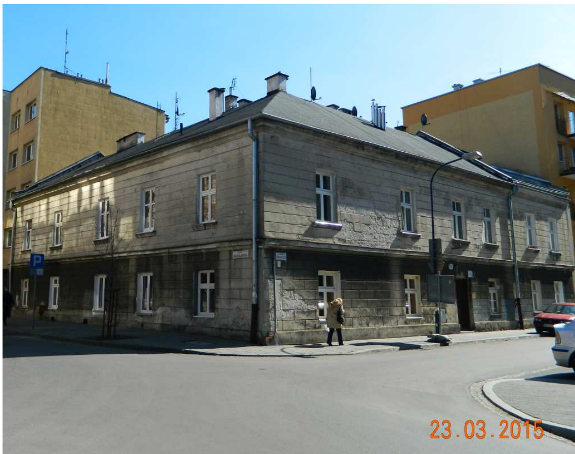
Fot. nr 308. Na styku ulic: Nadwiślańskiej i Krakusa.
