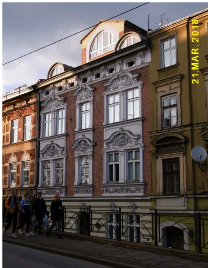
Fot. nr 98. Kamienica pod nr 5 z kuriozalnie dobudowanym poddaszem.
