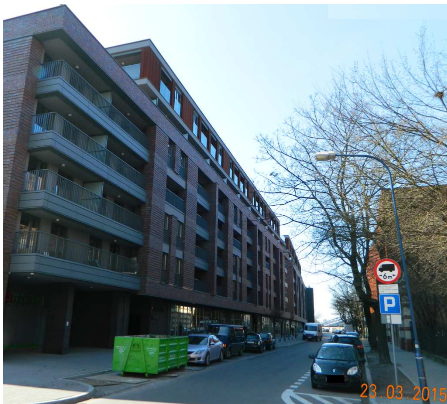
Fot. nr 306. Widok z ulicy Krakusa w stronę kładki o. Bernatka.
