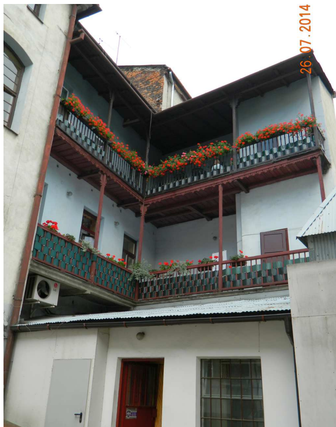
Fot. nr 105. Balkony od strony podwórka.
