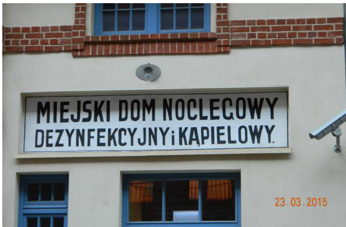
Fot. nr 317 (317-319). Budynek pod nr 4a, przylegający do zespołu dawnej elektrowni i jego dawne detale.
