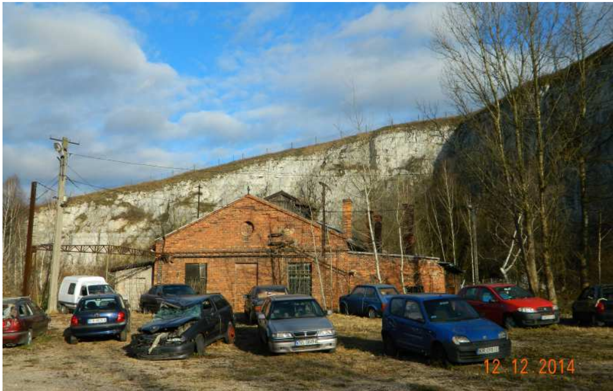
Fot. nr 544 (544-547). Dawny budynek na terenie kamieniołomu, zapewne sztygarówka, obecnie w stanie ruiny.
