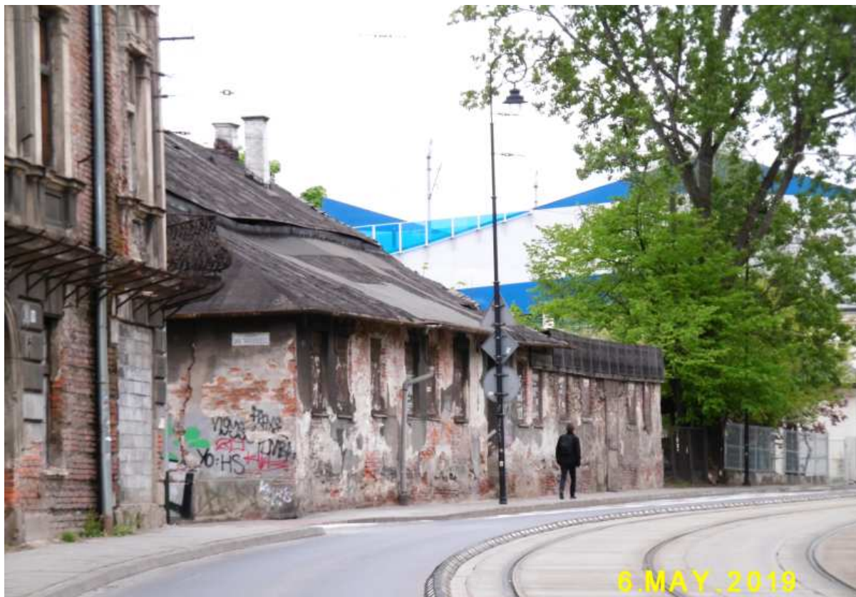
Fot. nr 386. Stan z roku 2019.
