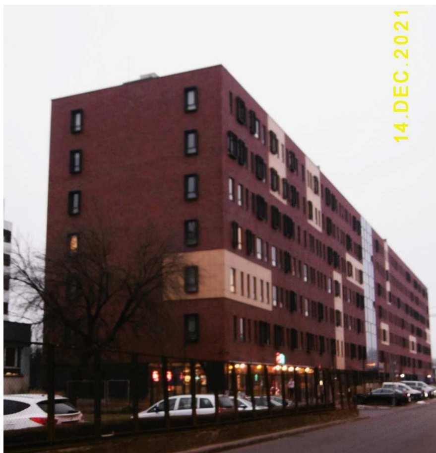
Fot. nr 492. Budynek współcześnie przerobiony na luksusowy akademik.
