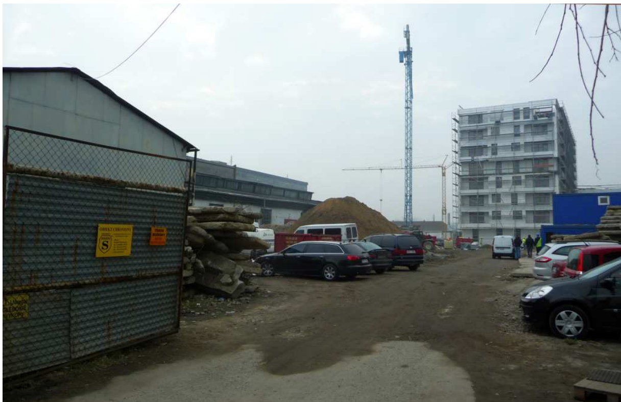
Fot. nr 485. Widok z ulicy Ślusarskiej w stronę ulicy Romanowicza. (27.02.2014)
