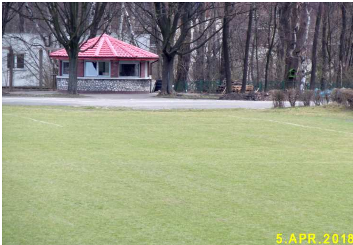
Fot. nr 212. Dawny okrągłak gastronomiczny, który w międzyczasie został poddany remontowi, ale jakby zatracił dawny urok.
