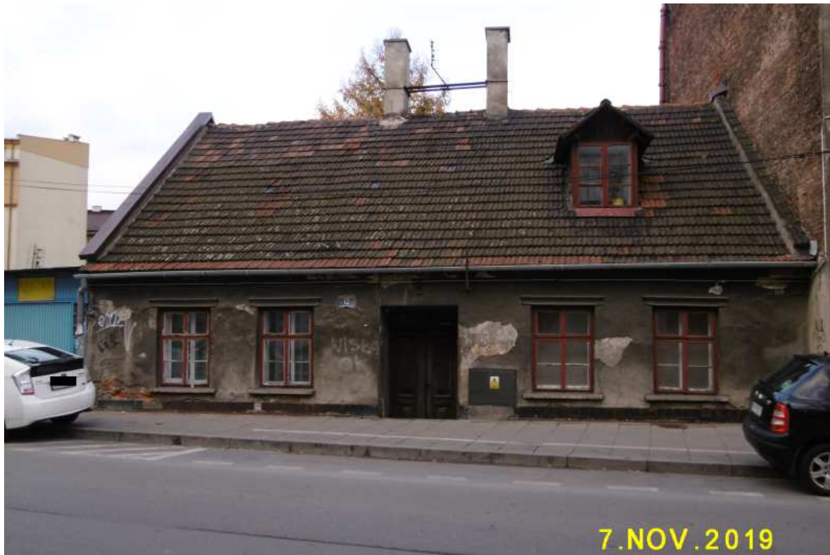
Fot. nr 447. Fasada z facjatką w dachu.
