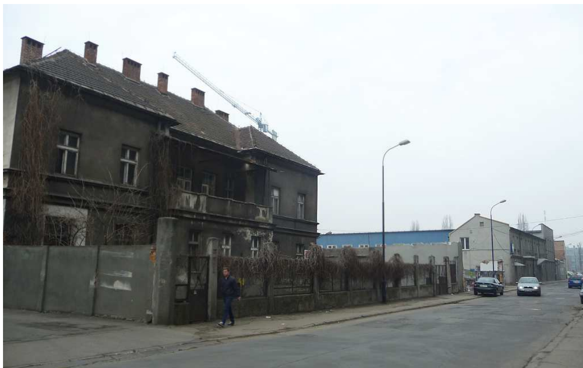
Fot. nr 500 (500-507). Budynek dyrekcji i gruzowisko po dawnej fabryce wyrobów metalowych: Fabryki Siatek, Mebli, Konstrukcji Żelaznych i Wyrobów Ornamentalnych Kutych Józefa Goreckiego, od 1920 Krakowskiej Fabryki Drutu i Wyrobów Żelaznych W. Kucharskiego, spod nr 9/Lipowa 10-12. (27.02.2014)
