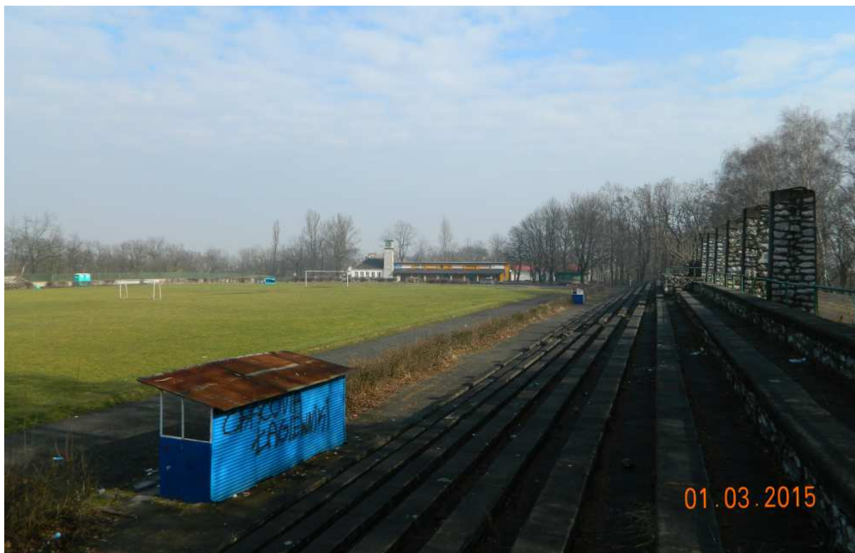
Fot. nr 206 (206-208). Ujęcia od strony stacji TVP Kraków i ulicy Krzemionki.
