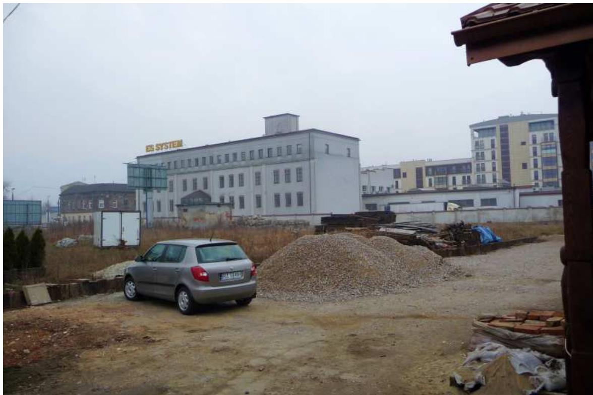
Fot. nr 470 (470-471). Pusty plac pod nr 13, który powstał po wyburzeniu kompleksu dawnej rzeźni. W tle, z prawej, nowa zabudowa ulicy Przemysłowej, a pośrodku budynek dawnej garbarni Progress spod nr 15, wybudowany w 1926 roku; z lewej narożny dom z ulicy Zabłocie 17. (27.02.2014)
