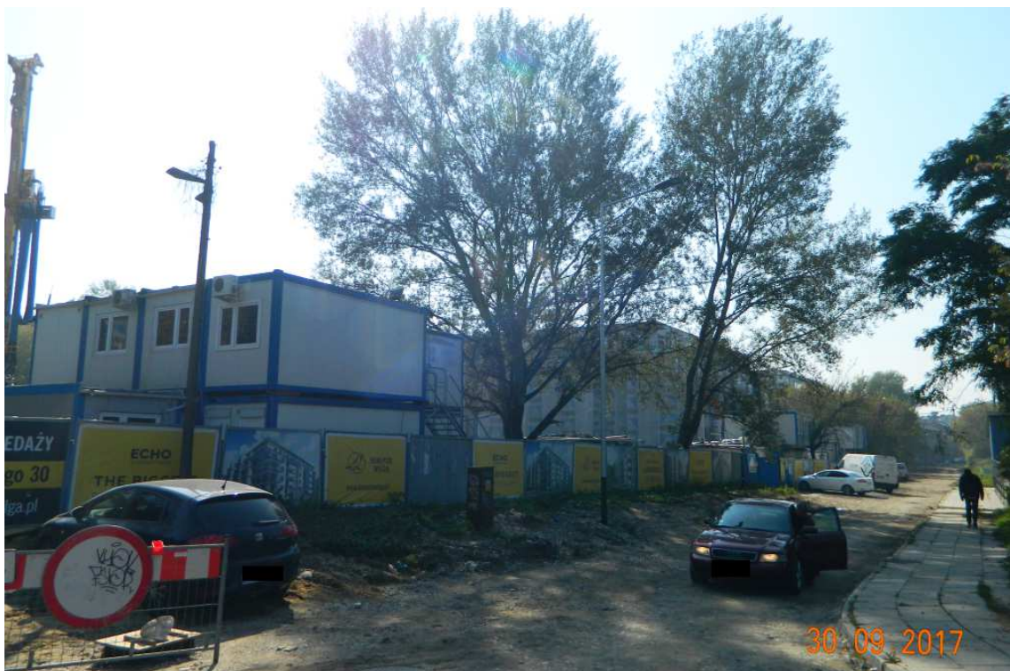
Fot. nr 75 (75-79). Trwa zabudowa przez firmę deweloperską ECHO ulicy Przedwiośnie w miejscu „poziomkowego sadu”, usytuowanego kiedyś we fragmencie od Mostu Retmańskiego do ulicy Spiskiej.
