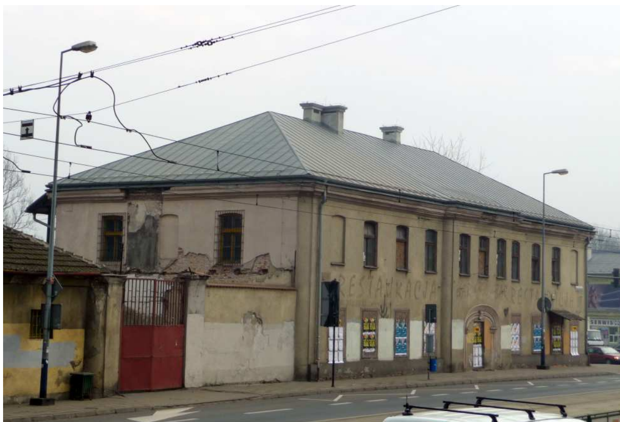
Fot. nr 361 (361-363). Stan sprzed remontu. (27.02.2014)
