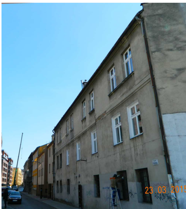
Fot. nr 303 (303-310). Wzdłuż ulicy Piwnej – widok z ulicy Józefińskiej w stronę placu Bohaterów Getta.
