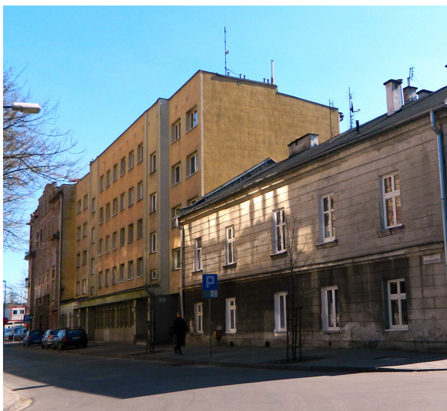
Nr 309. Fragment zabudowy ulicy powyżej ulicy Krakusa. (23.03.2015)
