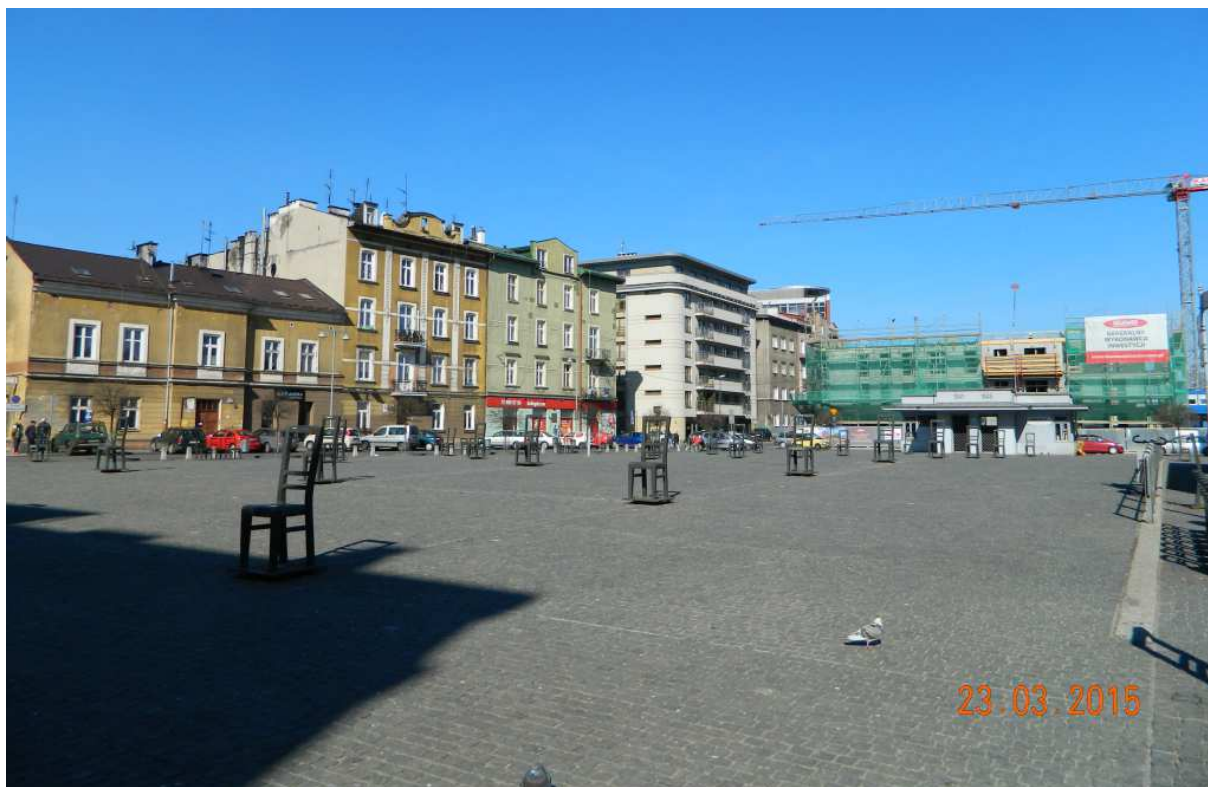
Fot. nr 400. Widok w stronę wylotu ulic: Piwnej i Nadwiślańskiej. Przy wylocie ulicy Piwnej trwa kolejna budowa. Plac Bohaterów Getta szybko się kurczy.
