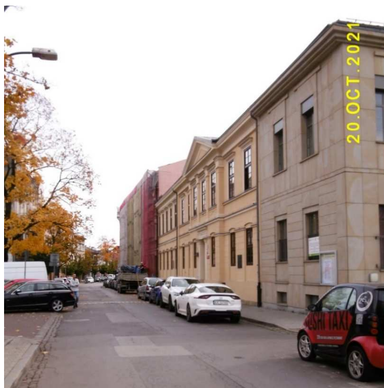
Fot. nr 281. Fragment zabudowy ulicy powyżej numeru 10.
