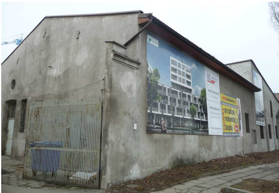
Fot. nr 487. Budynek z ulicy Zabłocie 37.
