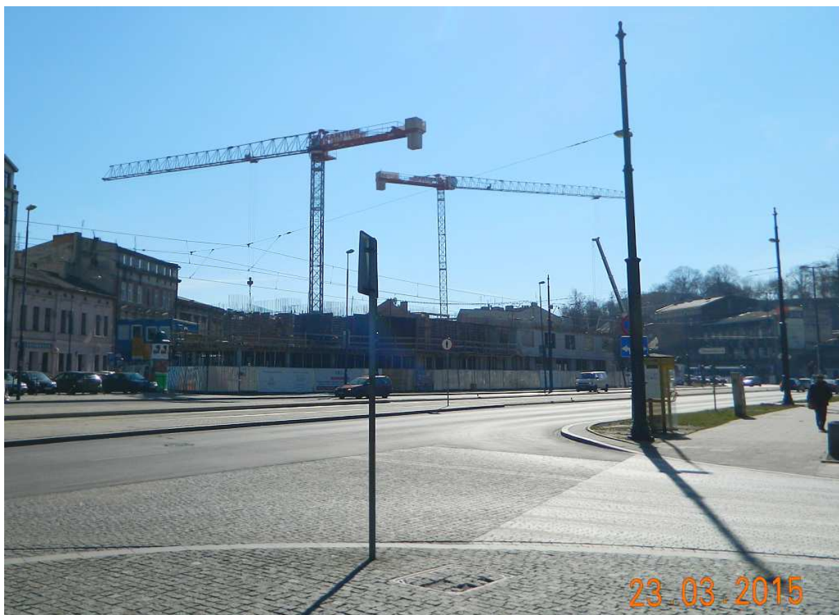
Fot. nr 387 (387-388). Trwa zabudowa fragmentu placu na styku ulic: Na Zjeździe, Józefińskiej i Lwowskiej. To cena za zamianę gruntów i utworzenie Parku Duchackiego.
