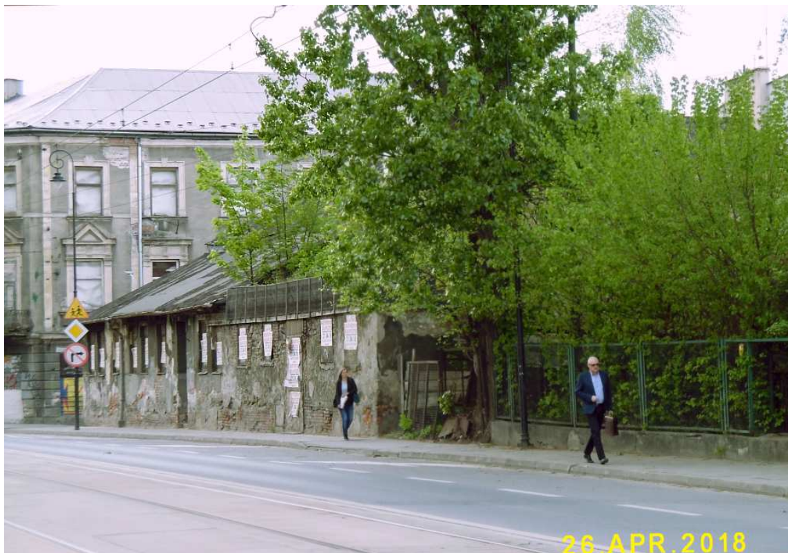
Fot. nr 356. Widok od strony ulicy Wielickiej.
