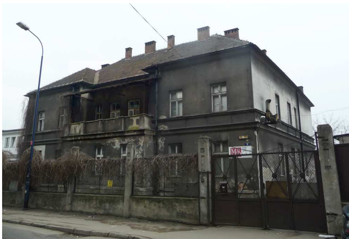
Fot. nr 503 (503-505). Fasada budynku dyrekcji dawnej Fabryki Wyrobów Metalowych, który powstał w latach 20. XX wieku po wcześniejszym przeniesieniu tu zakładu produkcyjnego z ulicy św. Wawrzyńca.
