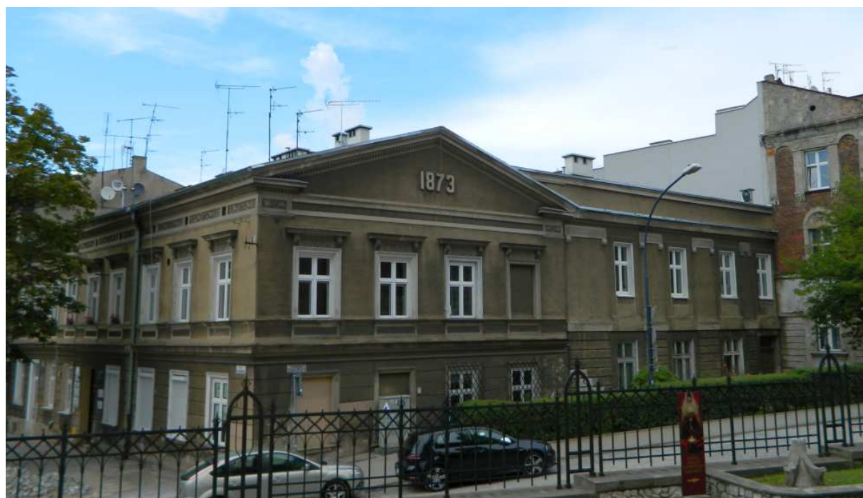
Fot. nr 111. Dom pod nr 4. (26.07.2014)
