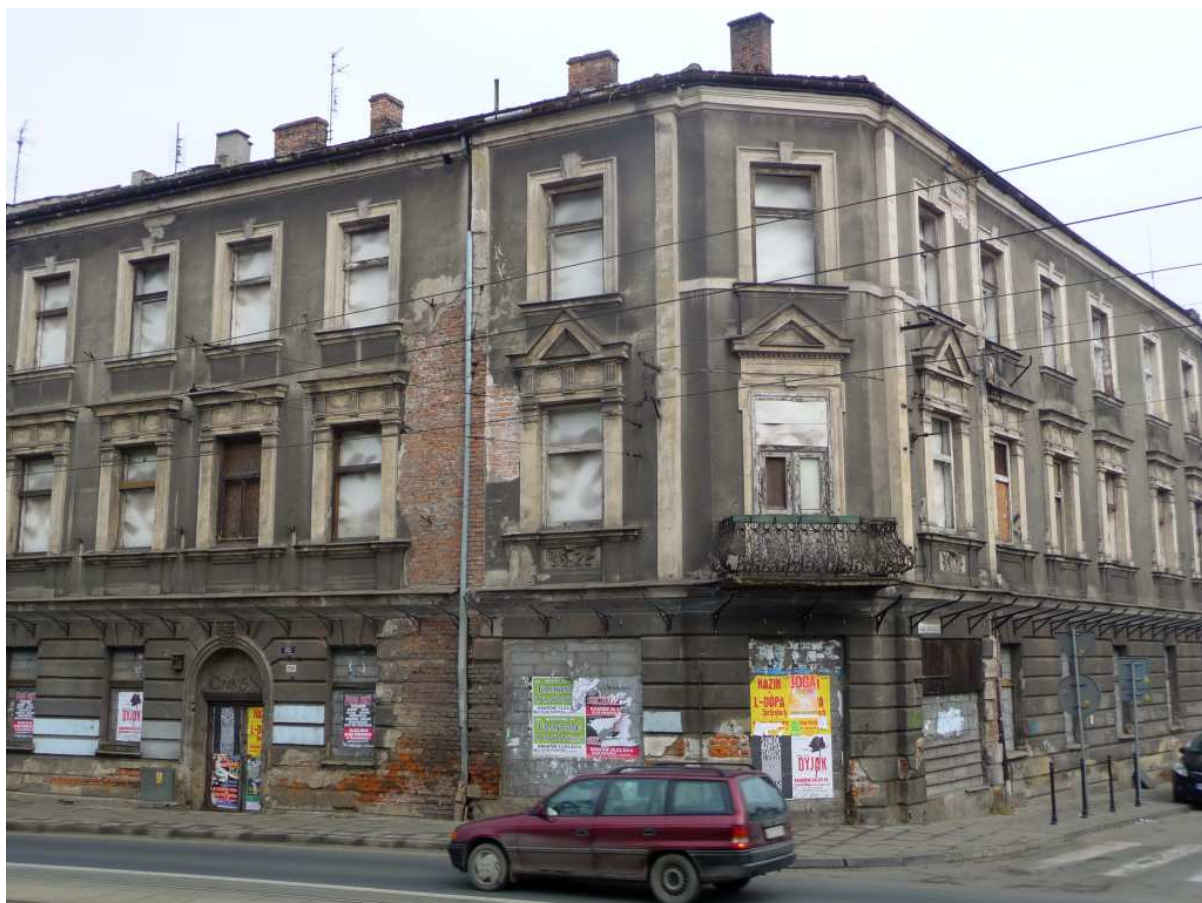
Fot. nr 348. Kamienica pod nr 45 w oczekiwaniu na remont. (27.02.2014)
