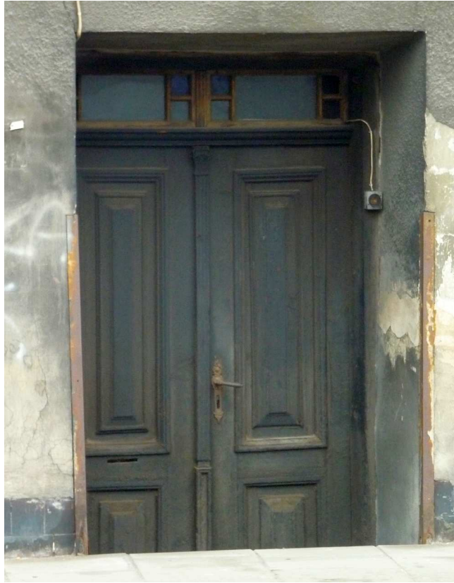
Fot. nr 450 (450-453). Detale obiektu. Zagłębione w stosunku do chodnika drzwi. (27.02.2014)
