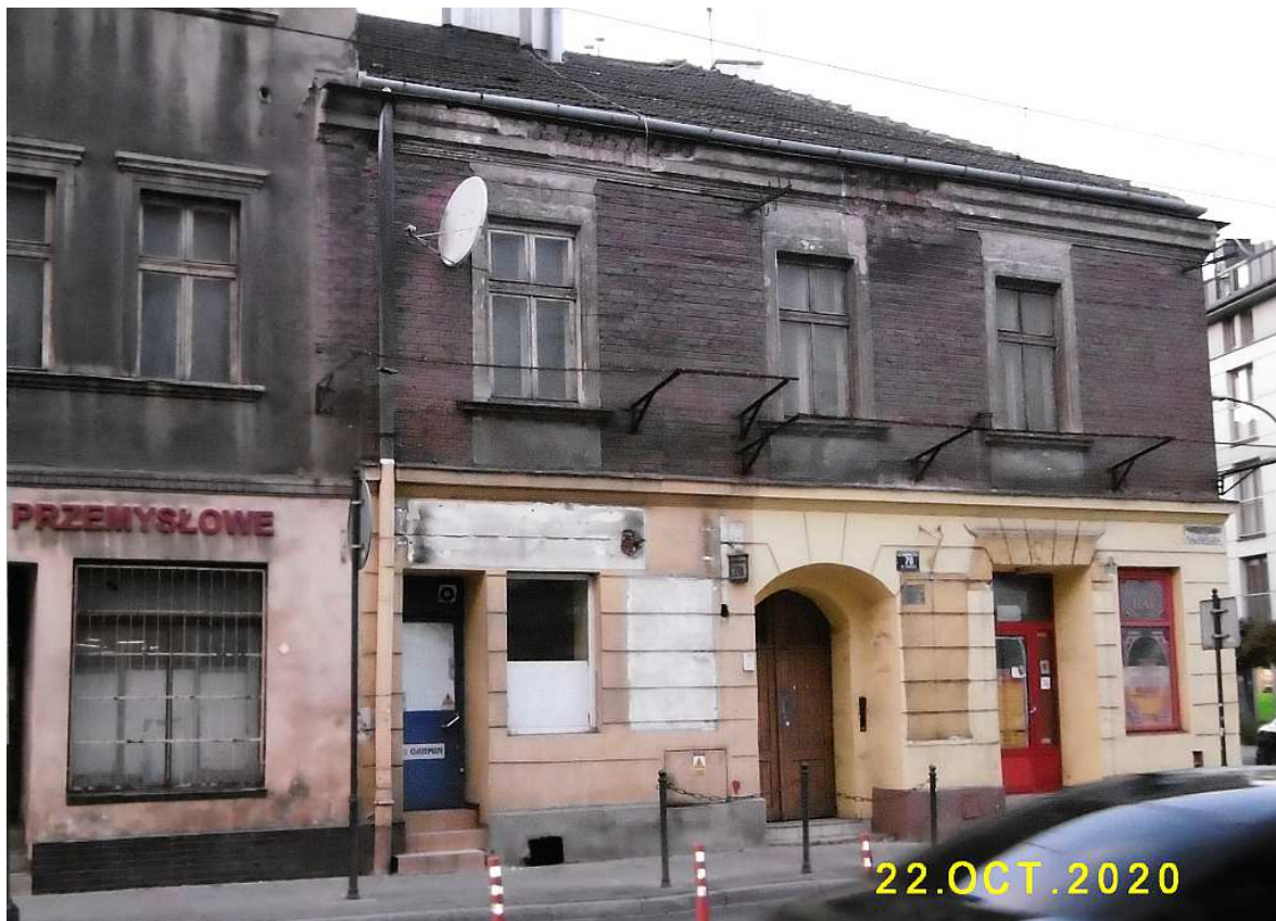
Fot. nr 64 (64-66). Dom pod nr 70 w narożu z ulicą Śliską.
