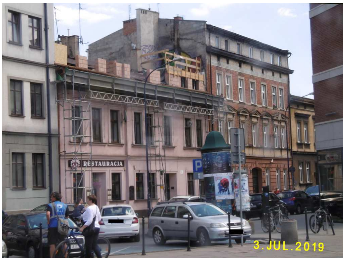
Fot. nr 421. Rozpoczyna się nadbudowa domu pod nr 4.
