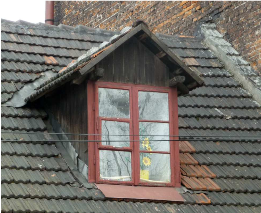
Fot. nr 452 (452-453). Facjatka w prawej części dachu.(27.02.2014)
