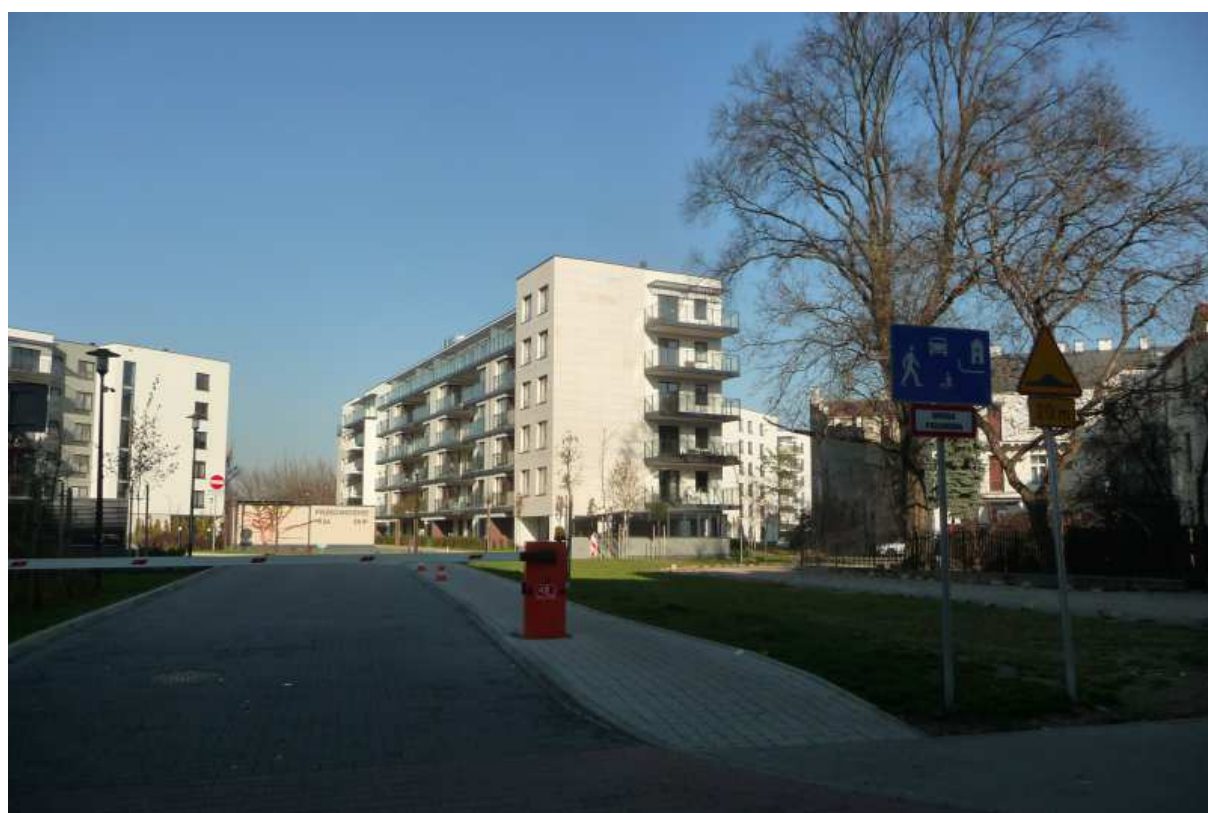
Fot. nr 80 (80-81). Widoki od strony ulicy Orawskiej. (11.11.2018)
