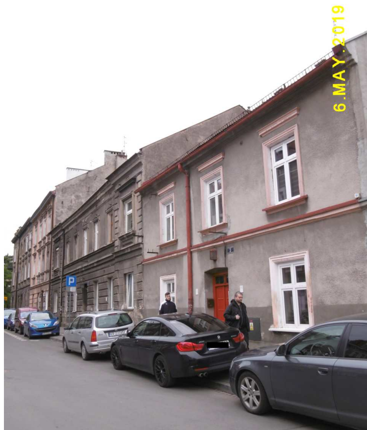
Fot. nr 417. Ulica Dąbrówki powyżej domu spod nr 3.
