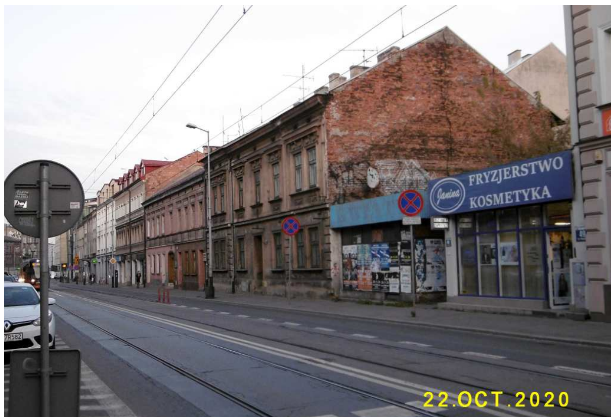
Fot. nr 43 (43-44). Fragment zabudowy poniżej numeru 49.
