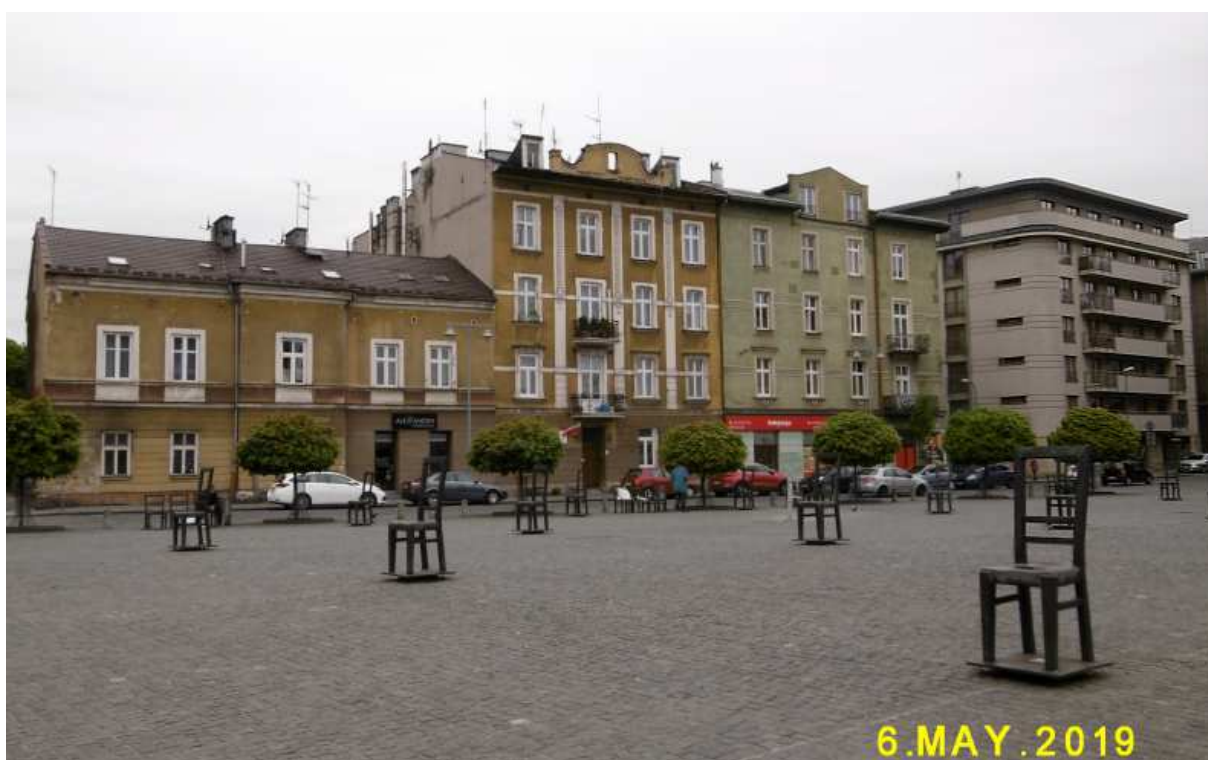
Fot. nr 401 (401-402). Zabudowa zachodniej pierzei placu o numerach: 4-6 w ujęciach od strony ulicy Lwowskiej.
