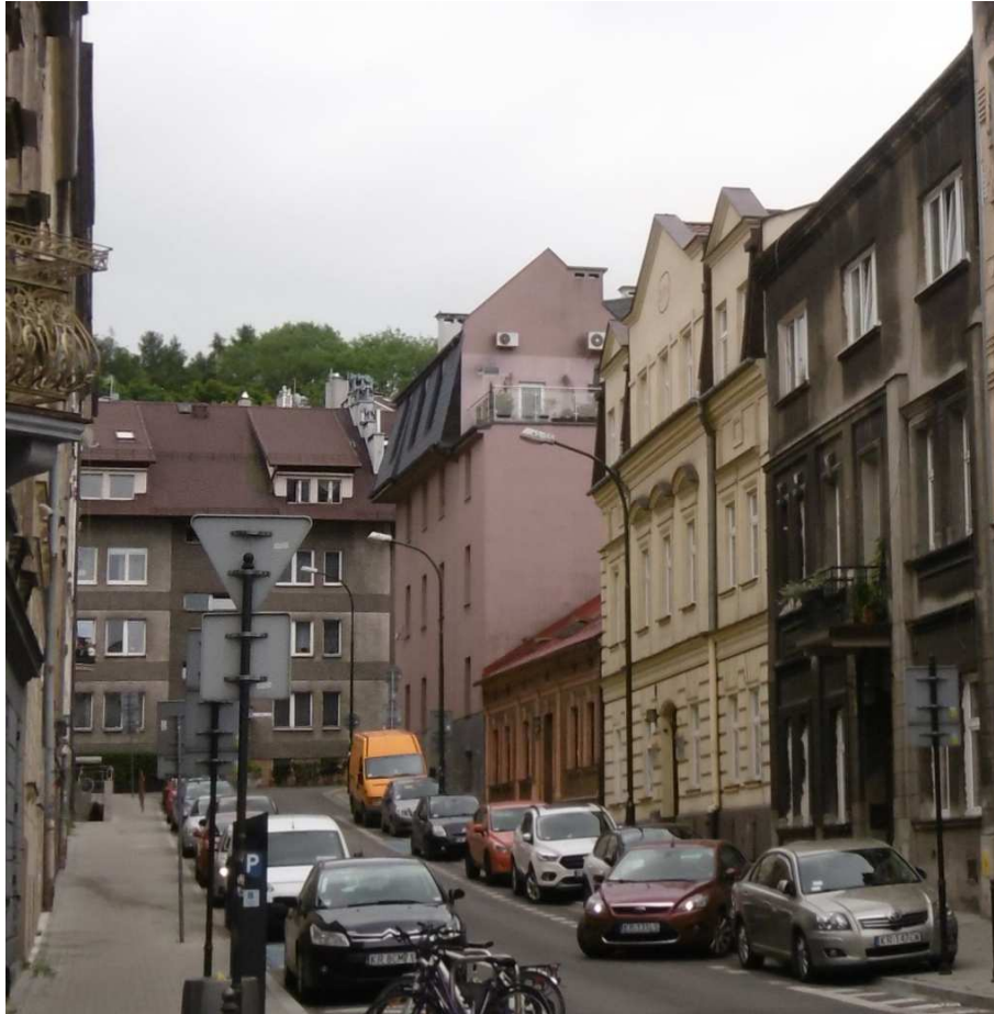
Fot. nr 34. Fragment zabudowy poniżej numeru 7. Trwa jeszcze parterowy dom pod nr 3.
