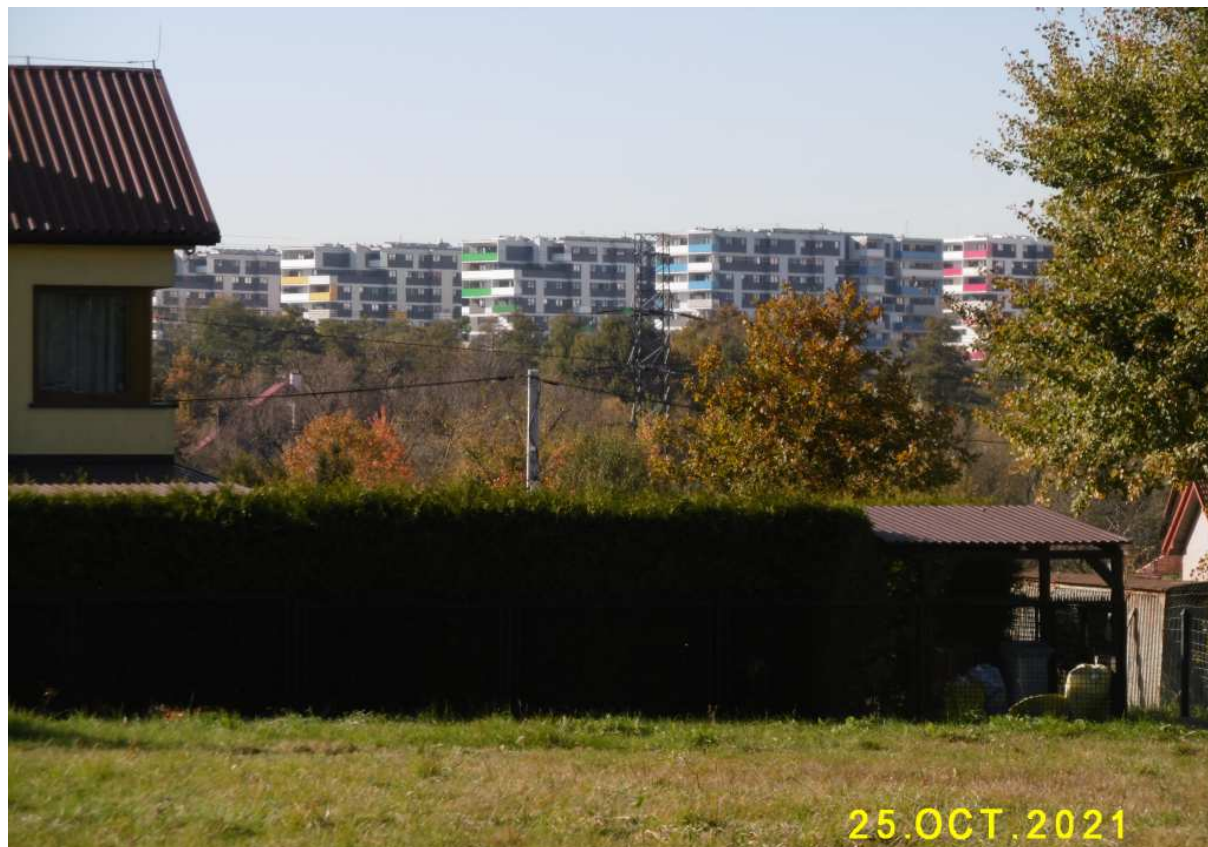
Fot. nr 268 (268-271). Trwa intensywna zabudowa terenu dawnych pól uprawnych, po roku 1990 ugorów, na przestrzeni pomiędzy potokiem Kliniec oraz ulicami: Czajną, Mokrą, Obronną i Przewiewną. Z nowymi blokami na osiedlu Piaski Nowe w tle.
