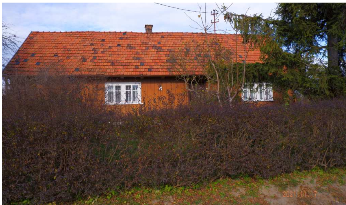
Fot. nr 336. Fasada z oryginalnymi oknami typu ościeżnicowego.
