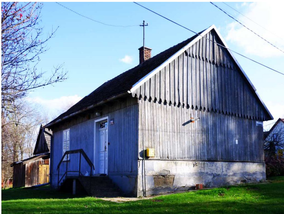
Fot. nr 324. Widok od strony ulicy Osterwy.
