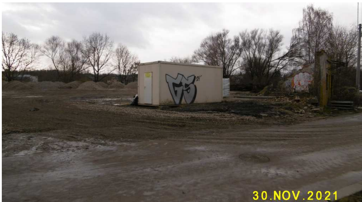
Fot. nr 212. Posesja przy ulicy Zakopiańskiej 63 i wyburzona współcześnie dawna zabudowa fabryczna. Widok z ulicy Do Wilgi.
