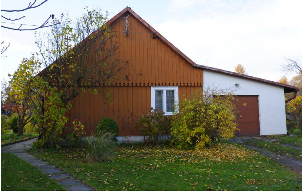
Fot. nr 337. Boczna ściana domu.
