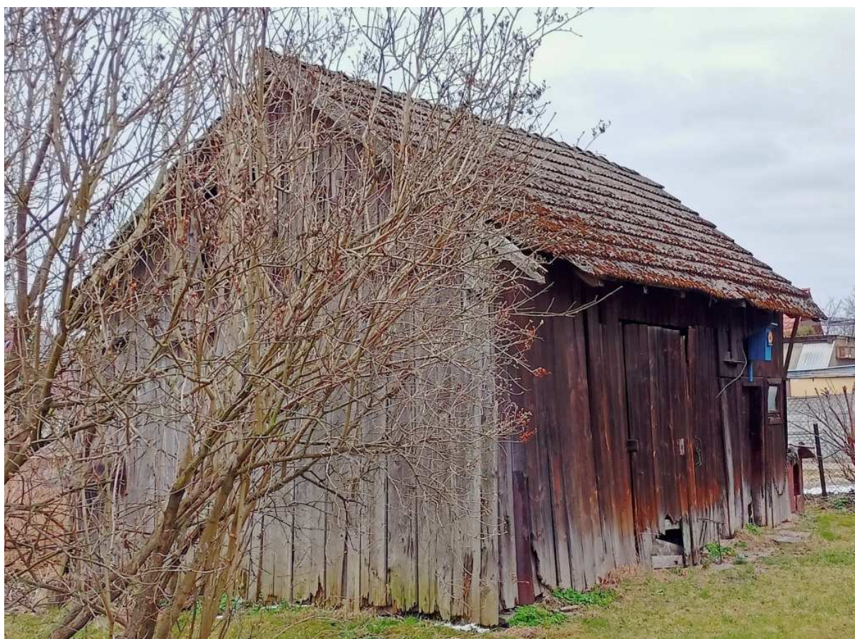
Fot. nr 264d. Widok od strony podwórka. (06.03.2022)
