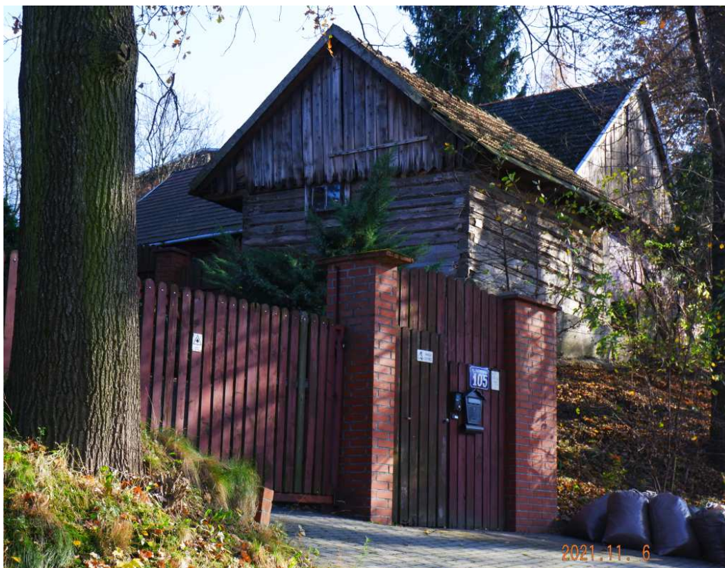
Fot. nr 303 (303-304). Budynek gospodarczy o konstrukcji zrębowej przy ulicy Tuchowskiej 105.
