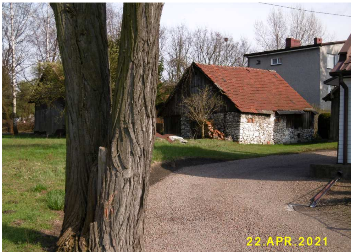
Fot. nr 230. Wykonana z kamienia wapiennego (zapewne) dawna stajnia.
