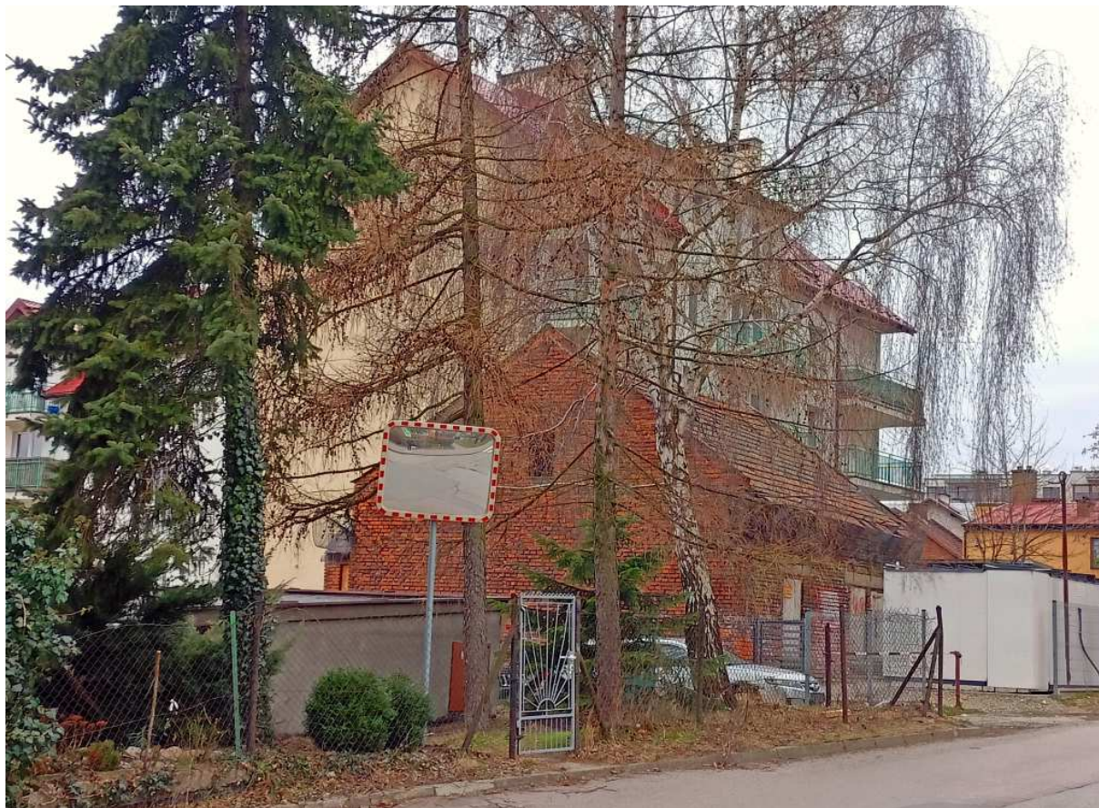
Fot. nr 264e. Fragment zabudowy ulicy Łużyckiej z ciągle stojącą jeszcze ruiną ceglanego domu pod nr 75a. (06.03.2022)
