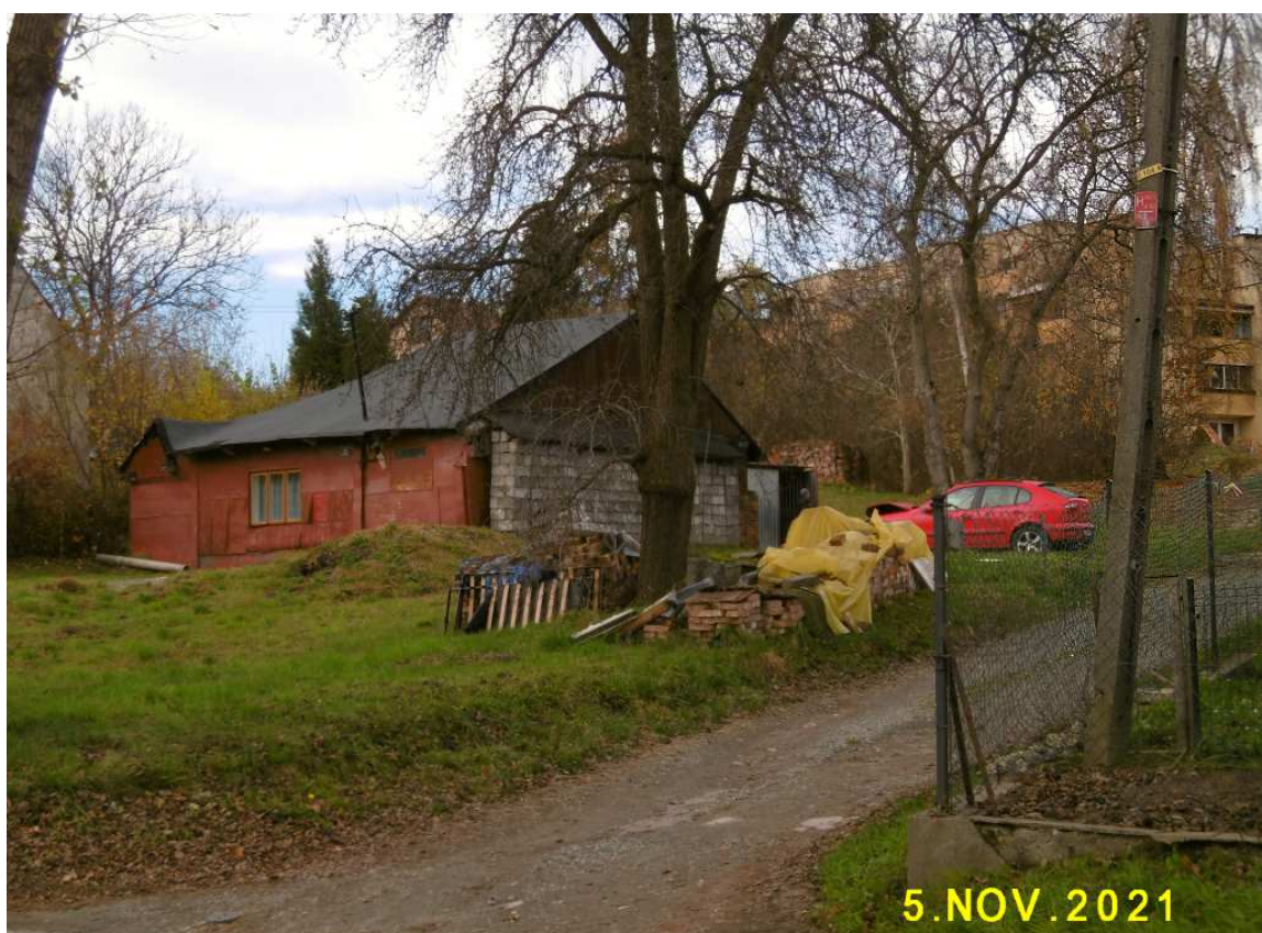
Fot. nr 274 (274-277). Około 150-letnia chałupa pod nr 44, której bielona fasada niedawno została obita pilśnią.
