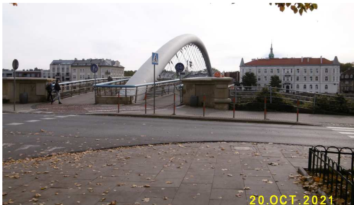
Fot. nr 44. Kładka o. Bernatka – widok z ulicy Mostowej.
