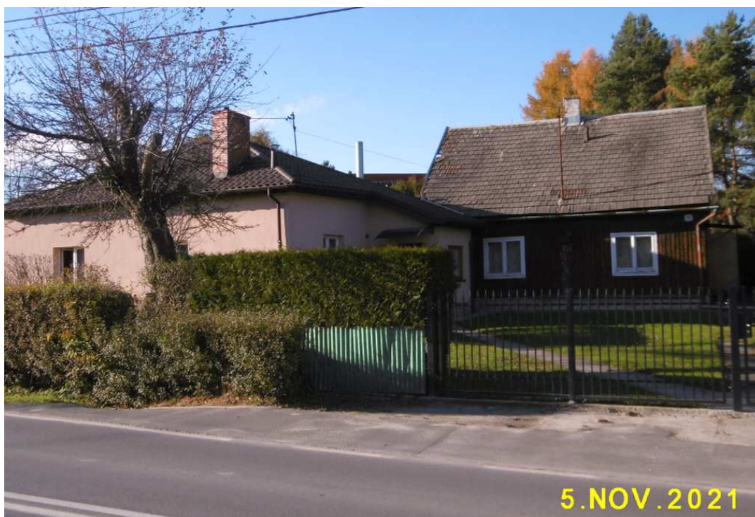
Fot. nr 283 (283-284). Niewielka chatka, która ciągle trwa pod nr 74.
