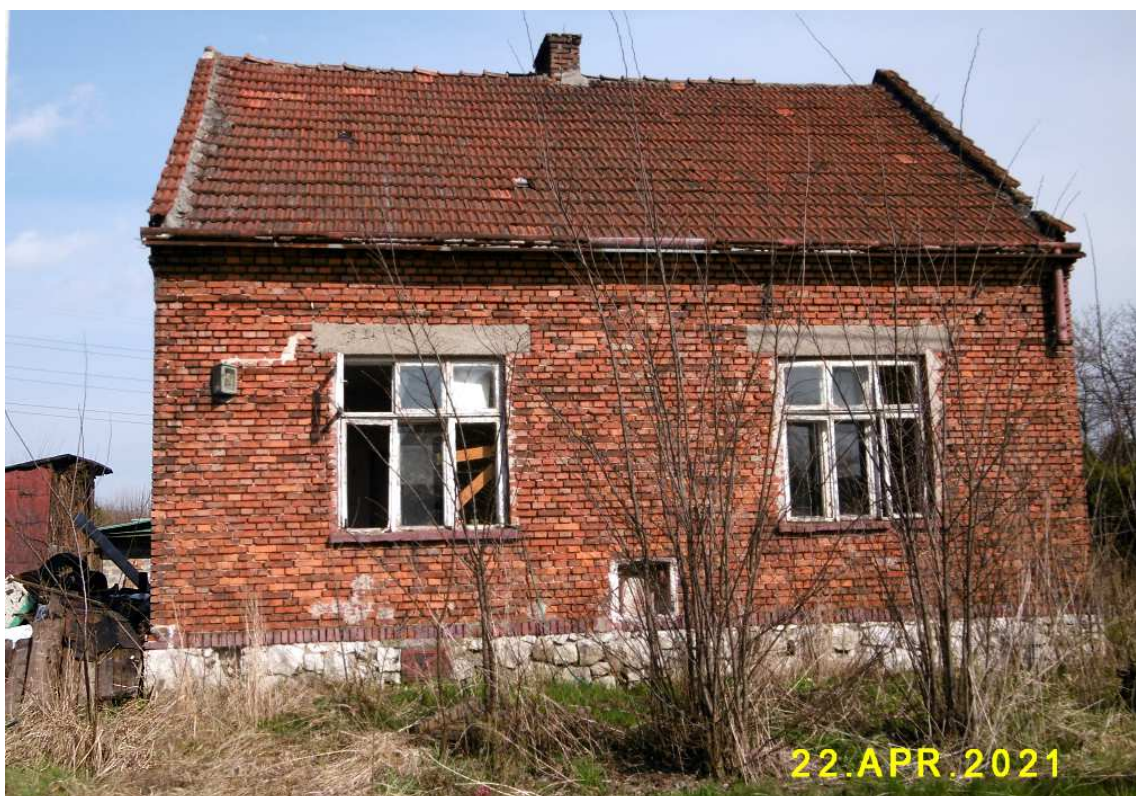
Fot. nr 258. Może ostatnie spojrzenie na fasadę.
