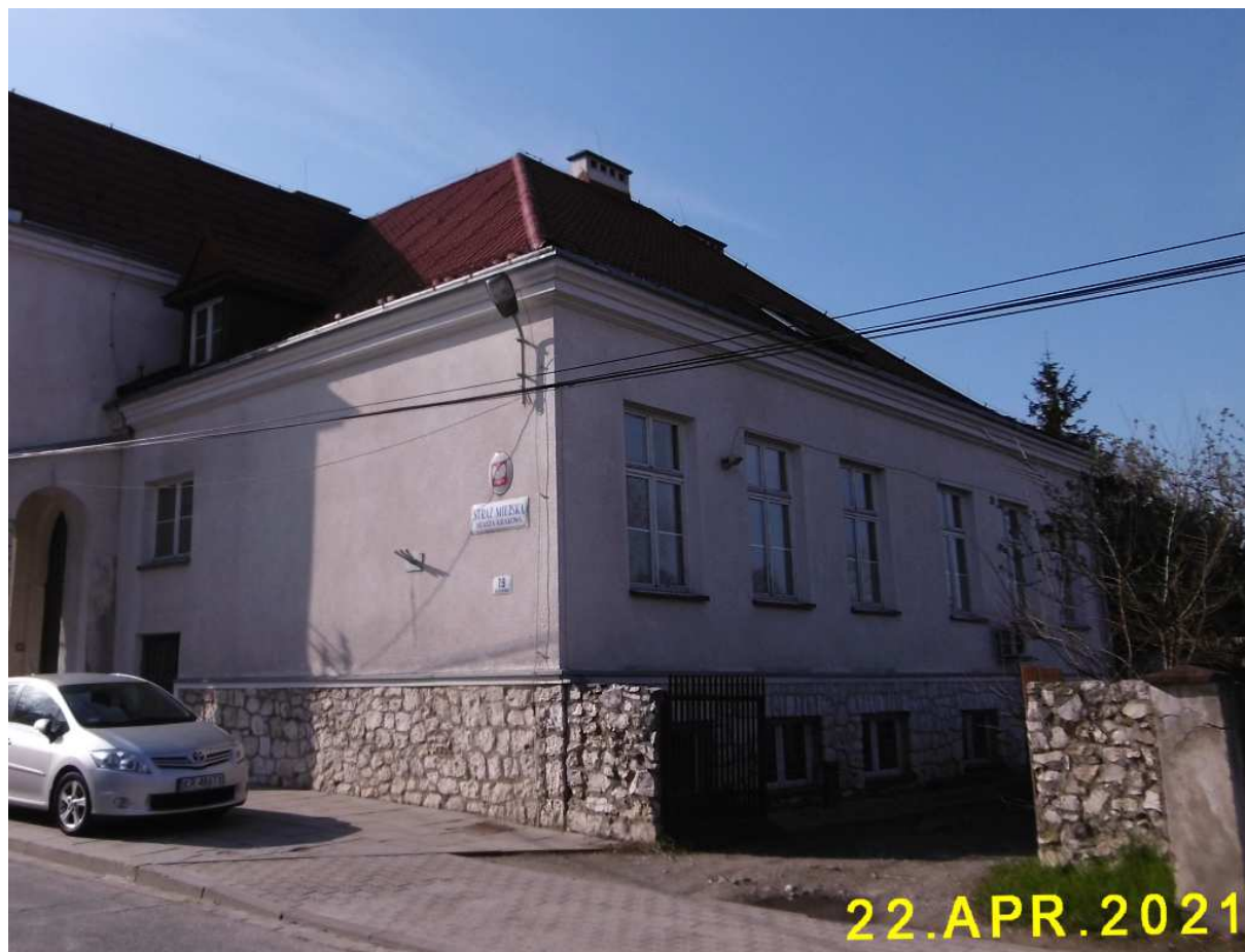
Fot. nr 232. Boczny fragment budynku.
