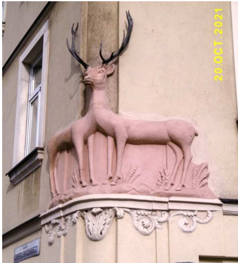
Fot. nr 68. Narożnik kamienicy spod nr 12, zwanej Pod Jeleniami.
