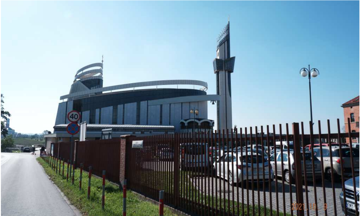
Fot. nr 172. Wieża widokowa przy bazylice mniejszej SBM przy ul. św. Faustyny 3.
