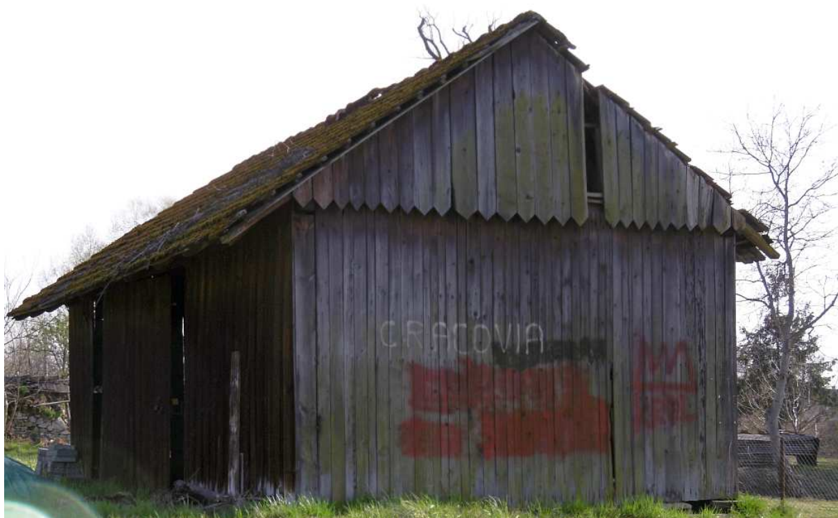
Fot. nr 260. Fragment od strony podwórka.
