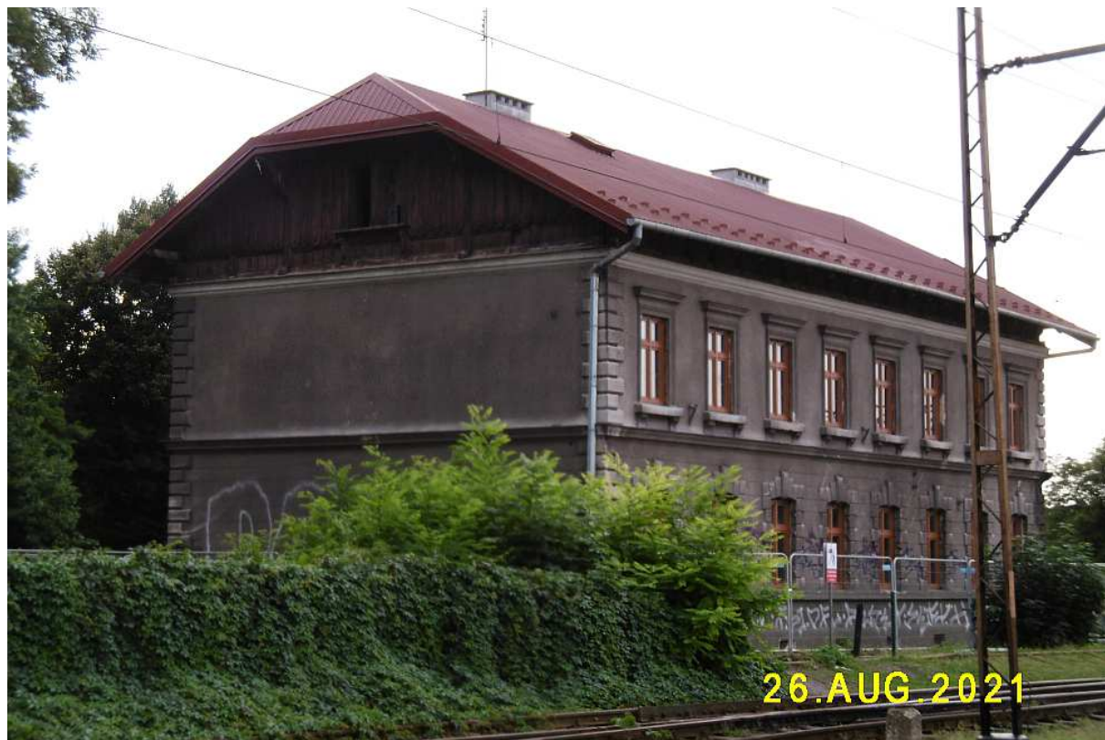
Fot. nr 103. Drugi galicyjski duchem budynek przy stacji PKP Płaszów z ulicy Prokocimskiej 2 (?).
