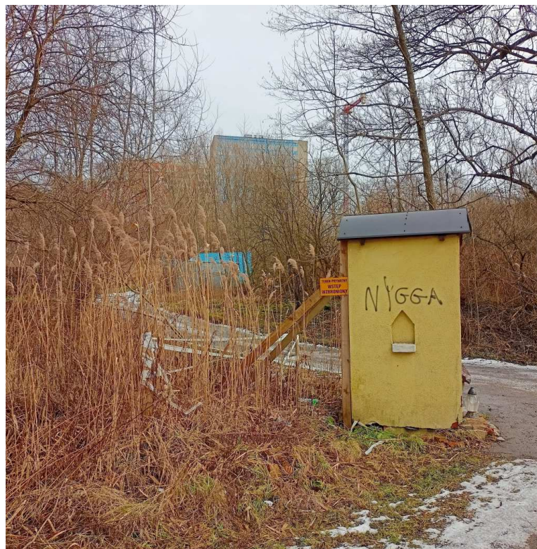
Fot. nr 267 (267-267b). Mocno skrzywiona do roku 2014 kapliczka, usytuowana w sąsiedztwie posesji przy ulicy Podlesie 29, obecnie odbudowana w kształcie identycznym jak dawny oryginał. (29.01.2022)
