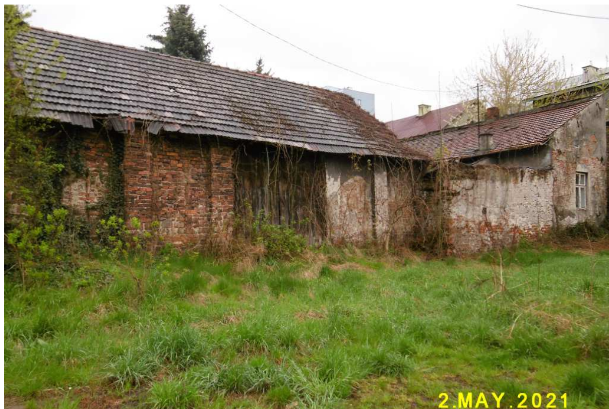
Fot. nr 129 (129-130). Tylna część dawnej zagrody przy ulicy Ściegiennego 54 w ujęciu z ulicy Żabiej.
