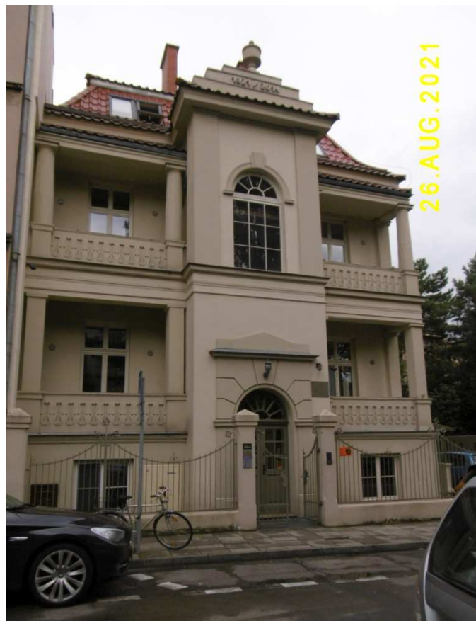
Fot. nr 15. Fasada stuletniego budynku, stojącego przy ulicy Zduńskiej 18.
