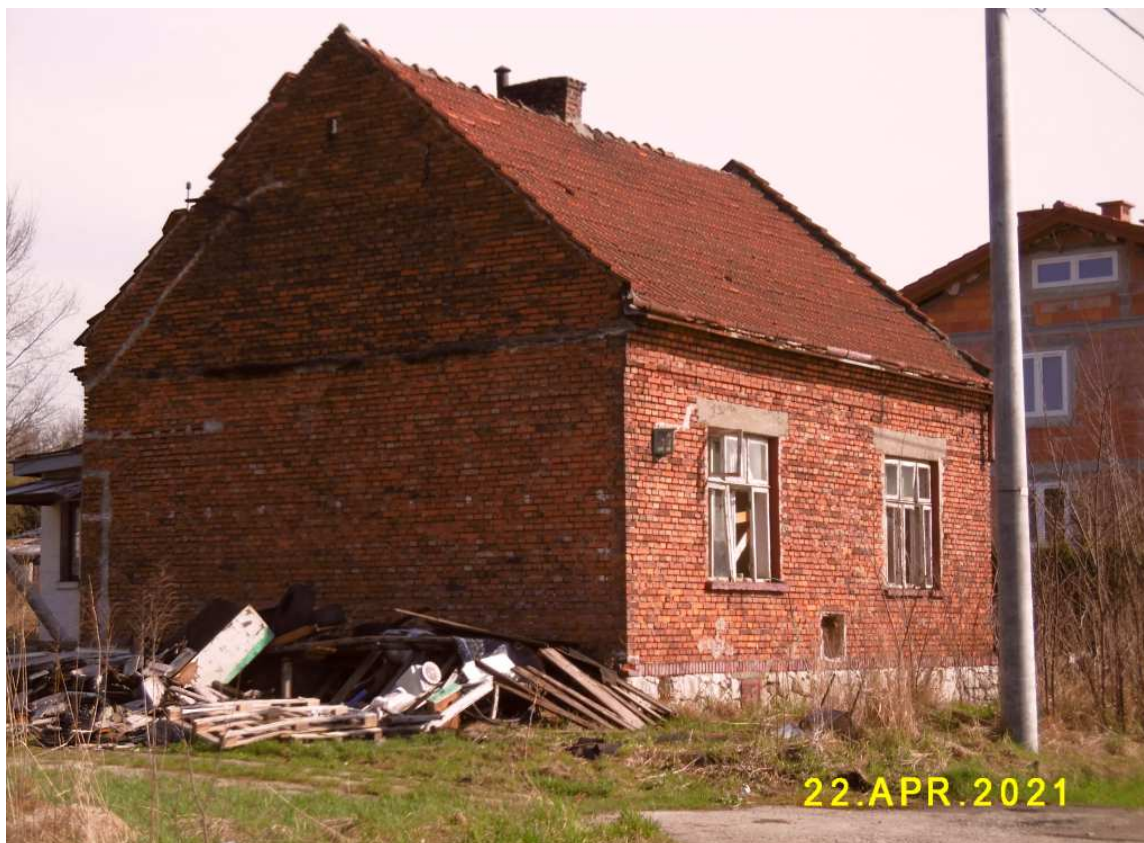
Fot. nr 257 (257-258). Dom z cegły z ulicy Myślenickiej 52, raczej już powojenny, w którym zachowały się jeszcze trzyczęściowe okna typuweneckiego, otwierane na zewnątrz, charakterystyczne dla tego okresu.
