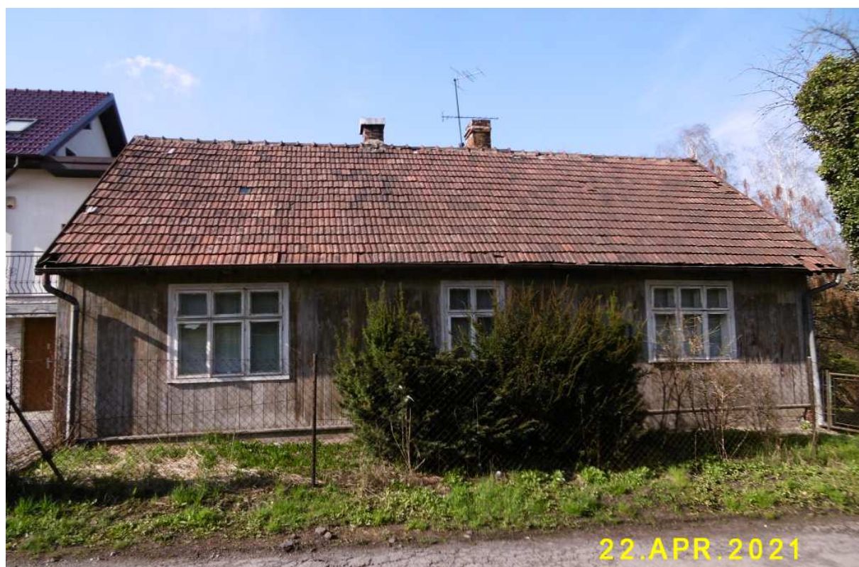
Fot. nr 234 (234-238). Zabudowa posesji z ulicy Cechowej 28. Tu około 90-letni dom.
