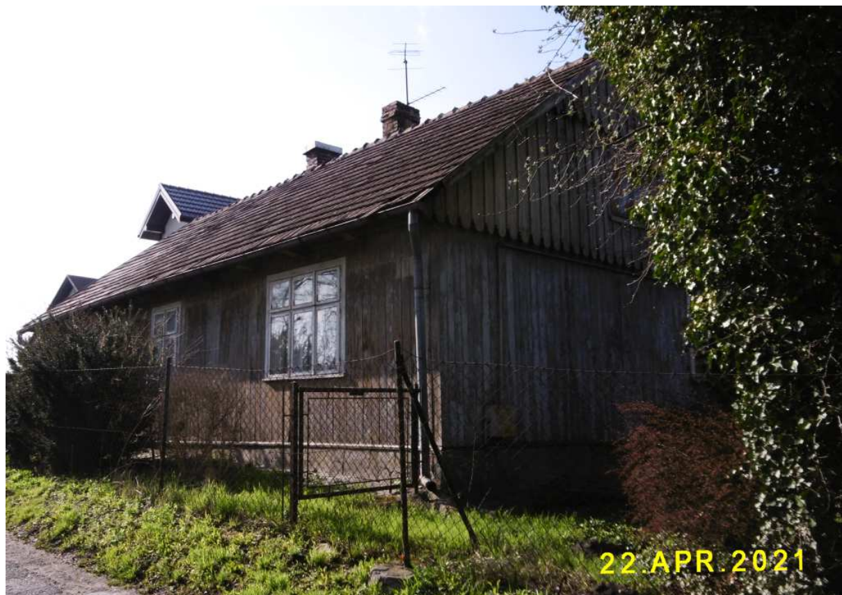
Fot. nr 235 (234-235). Fasada od strony ulicy Łężce.
