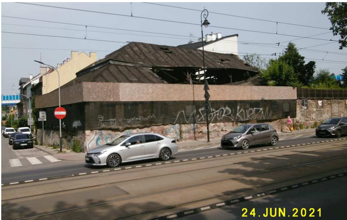
Fot. nr 81. Już chyba nic nie uratuje klasycystycznego dworku z łamanym dachem z końca XVIII wieku z ulicy Limanowskiego 47, zdegradowanego po pożarze.
