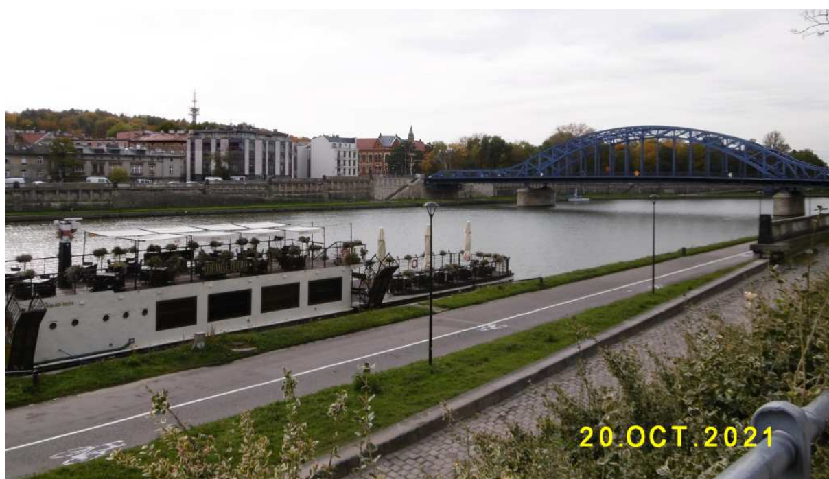
Fot. nr 43. Widok na IV. (dziś II.) Most im. J. Piłsudskiego.
