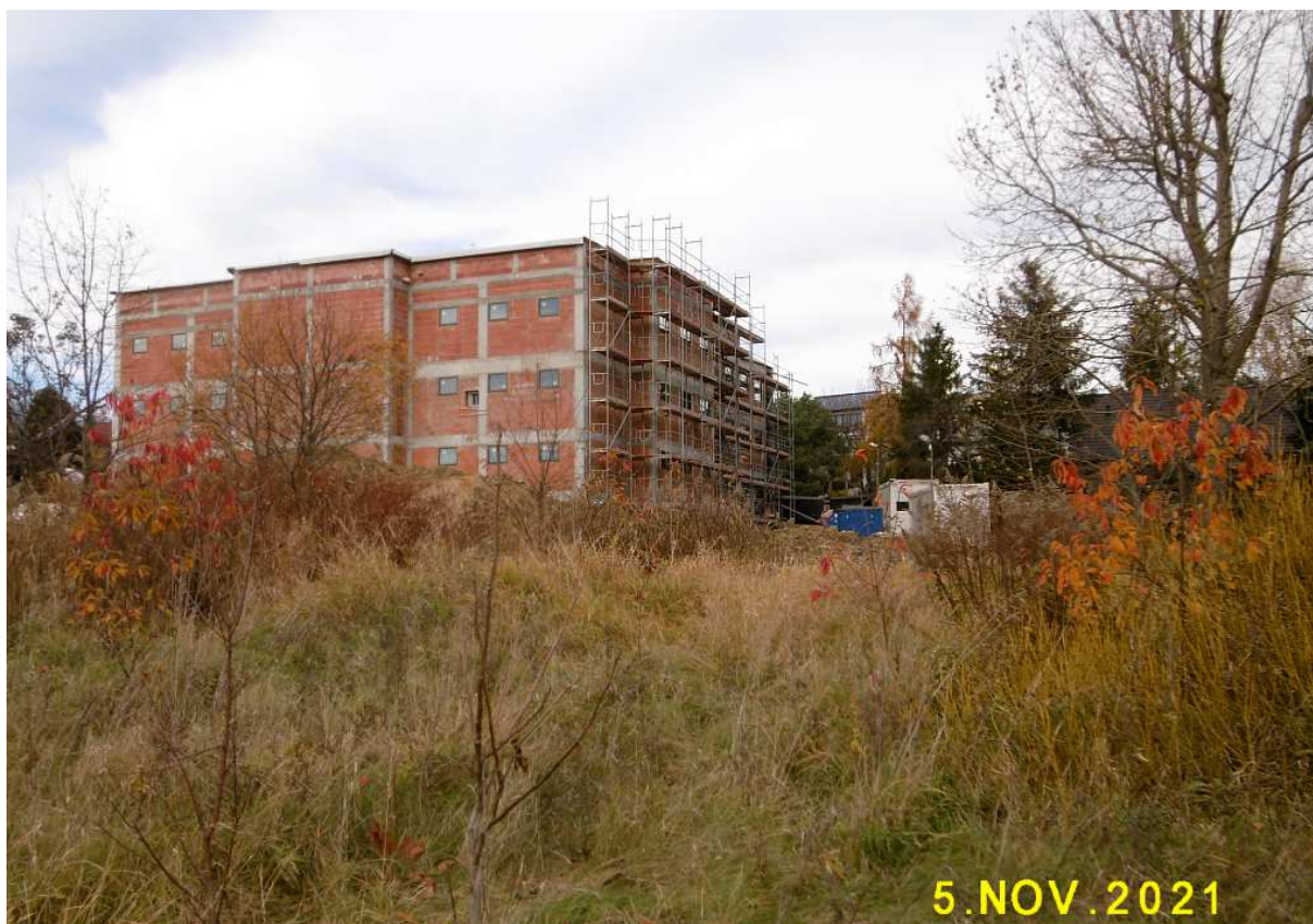
Fot. nr 280. Widok od strony autostrady.
