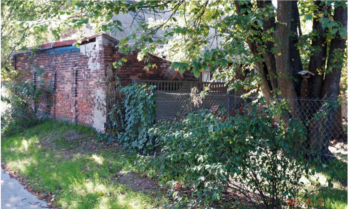
Fot. nr 206 (206-207). Próba dotarcia do tylnej części obiektu.
