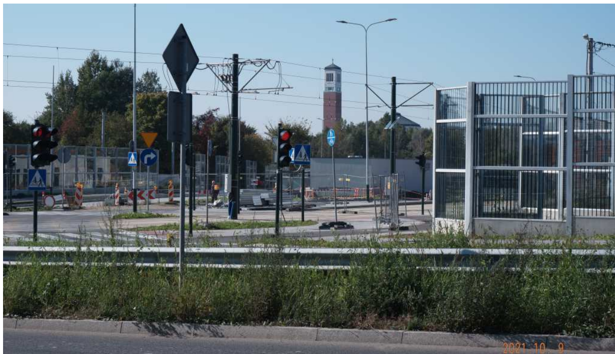
Fot. nr 132 (132-133). Na budowie „trasy Łagiewnickiej”, na przedłużeniu ulicy Witosa.
