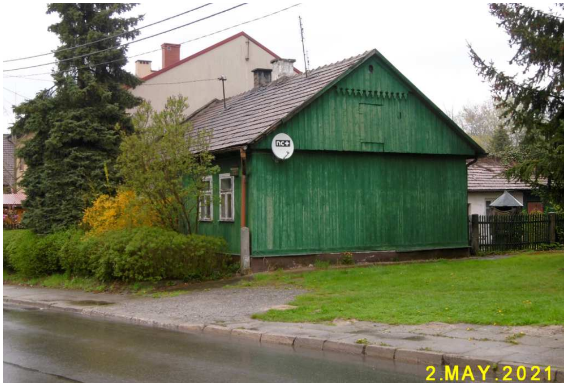
Fot. nr 124 (124-127). Zapewne około 90-letni dom z ulicy Ściegiennego 41.
