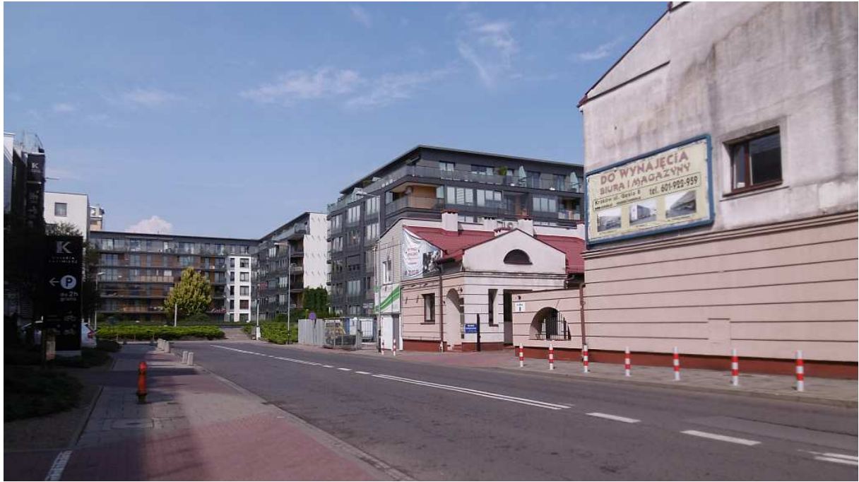
Fot. nr 28 (28-28a). Wzdłuż ulicy Gęsej, po której dawnej, typowo podmiejskiej zabudowie niewiele już pozostało. Widok ku blokowisku przy ulicy Masarskiej. (16.07.2021)
