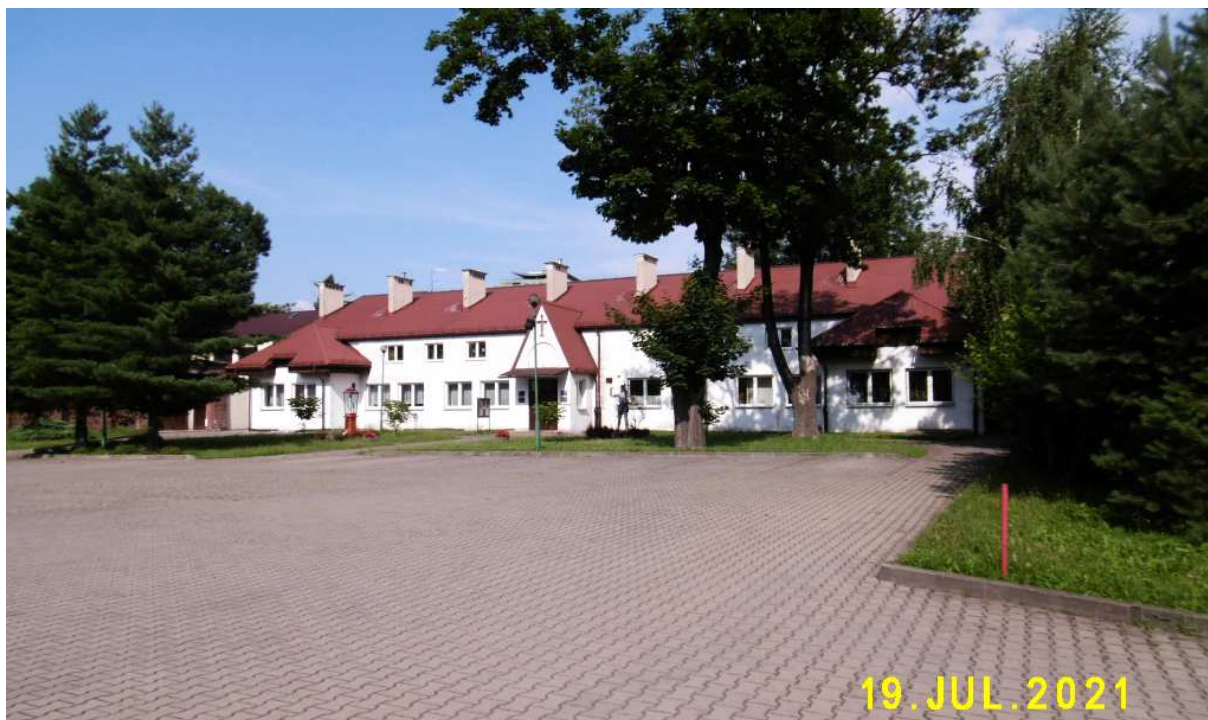
Fot. nr 72. Współczesny budynek przykościelnej parafii.
