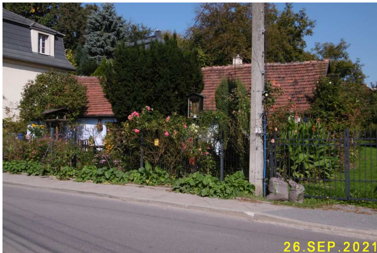
Fot. nr 348 (348-349). Niespełna 100-letni dom murowany spod nr 20.
