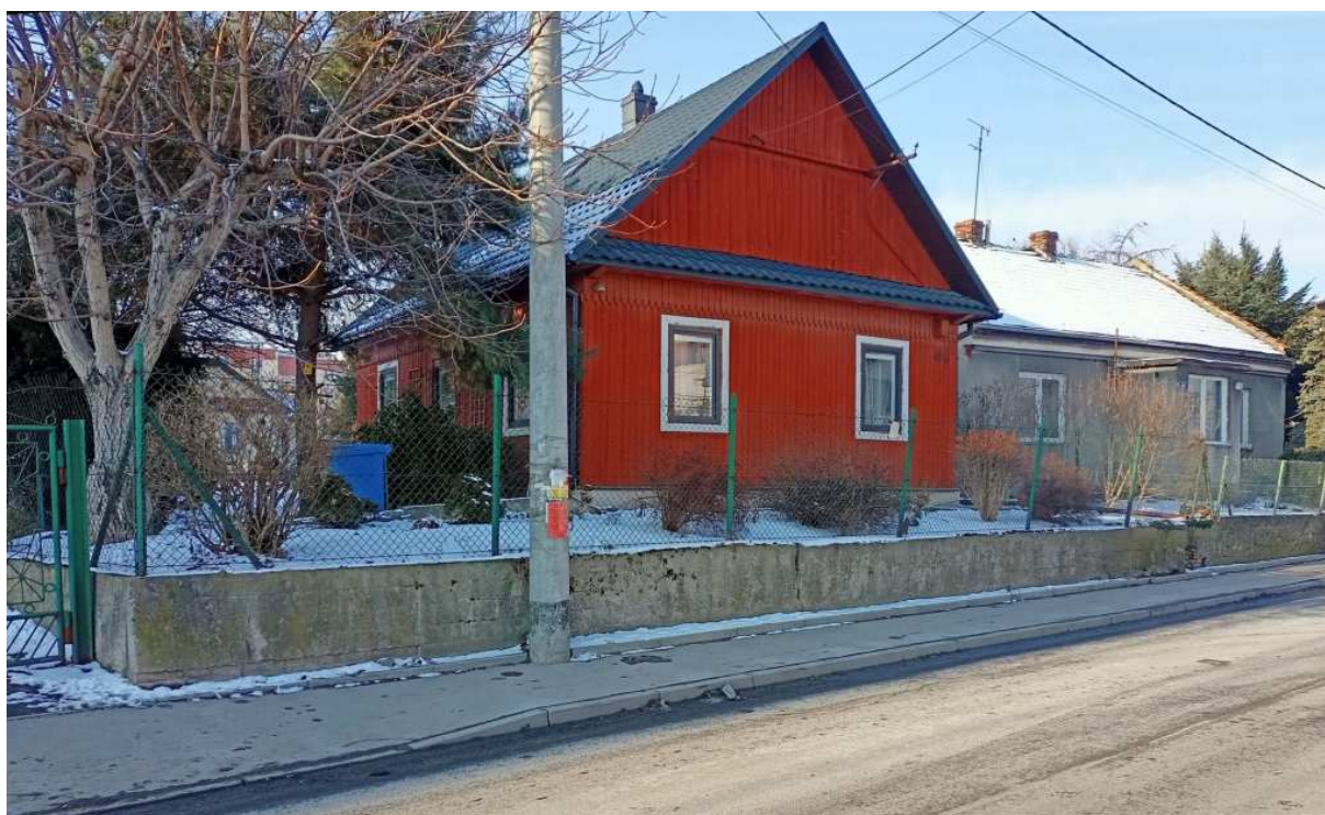
Fot. nr 301 (301-302). Niespełna 100-letni dom pod nr 45, gdzie również nie przetrwały dawne okna, które były jego ozdobą.
