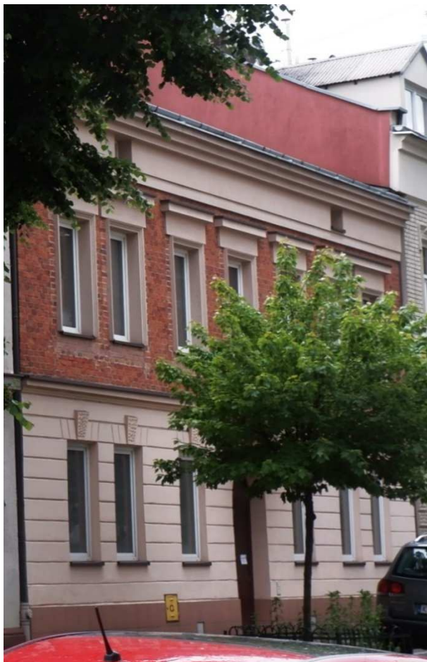
Fot. nr 226. Dom spod nr 7. Urok fasady zniszczyły bezpodziałowe plastiki. (30.05.2021)
