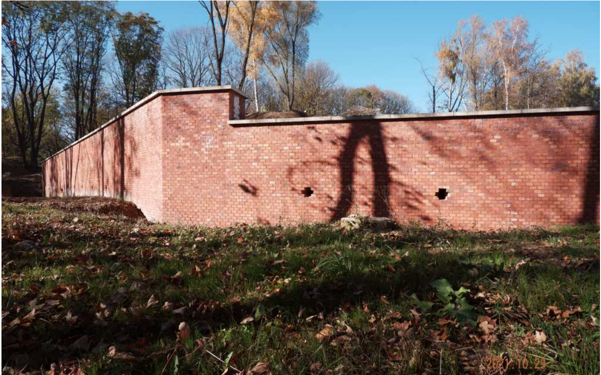
Fot. nr 294 (294-296). Trwają prace przy częściowej rekonstrukcji bastionu nr I.
