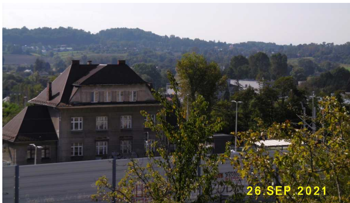
Fot. nr 392 (392-393). Budynki stacji PKP Kraków-Mydlniki.
