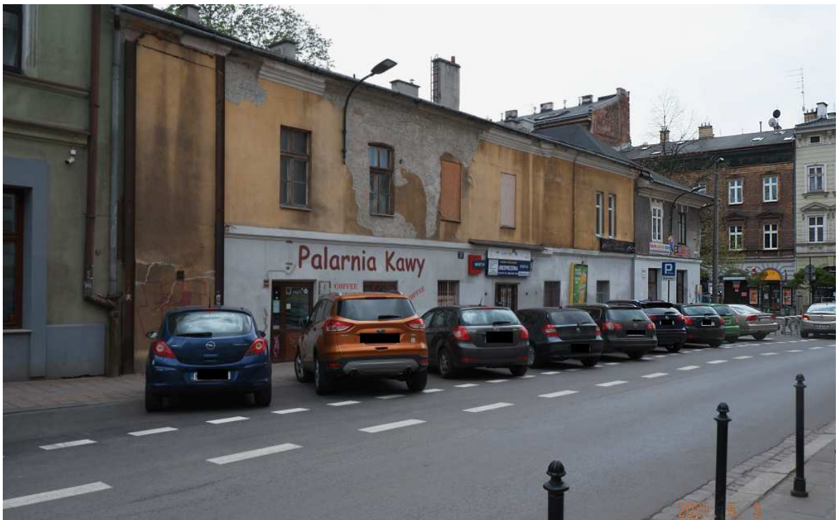
Fot. nr 117. Czekaający od lat na remont dom spod nr 26.
