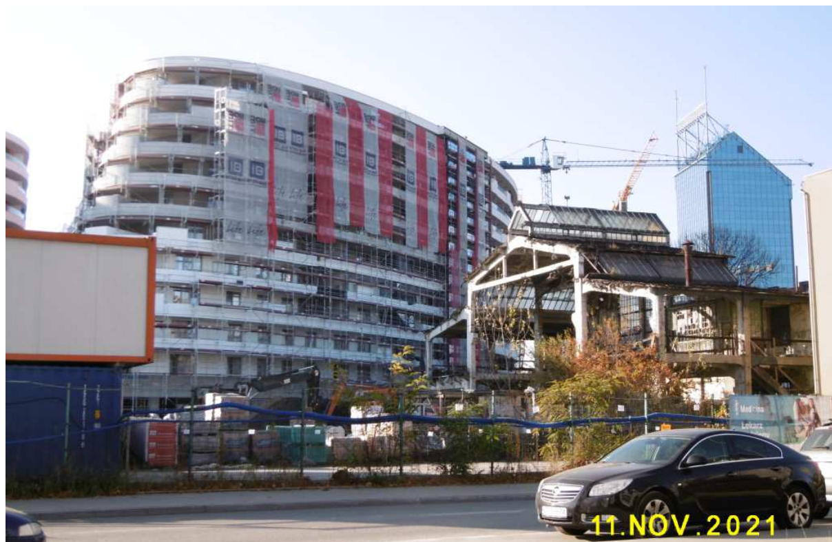
Fot. nr 32 (32-33). Współczesna zabudowa na terenie dawnej fabryki Zieleniewskiego. Widoki z ulicy Zieleniewskiego.
