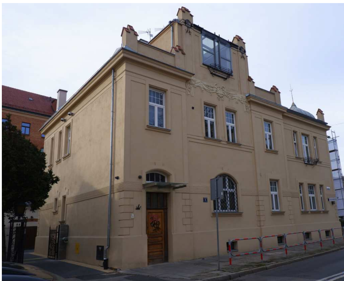
Fot. nr 77. Fasada od strony ulicy Czarnowiejskiej. (04.12.2021)
