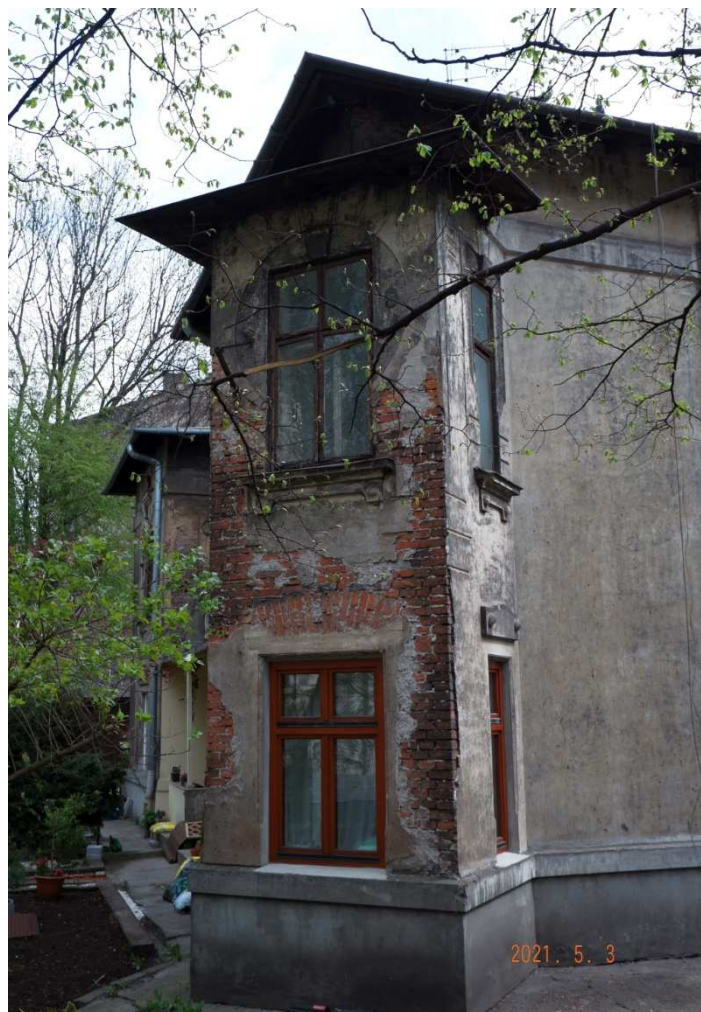
Fot. nr 146. Narożny wykusz z oryginalnymi jeszcze oknami I piętra
