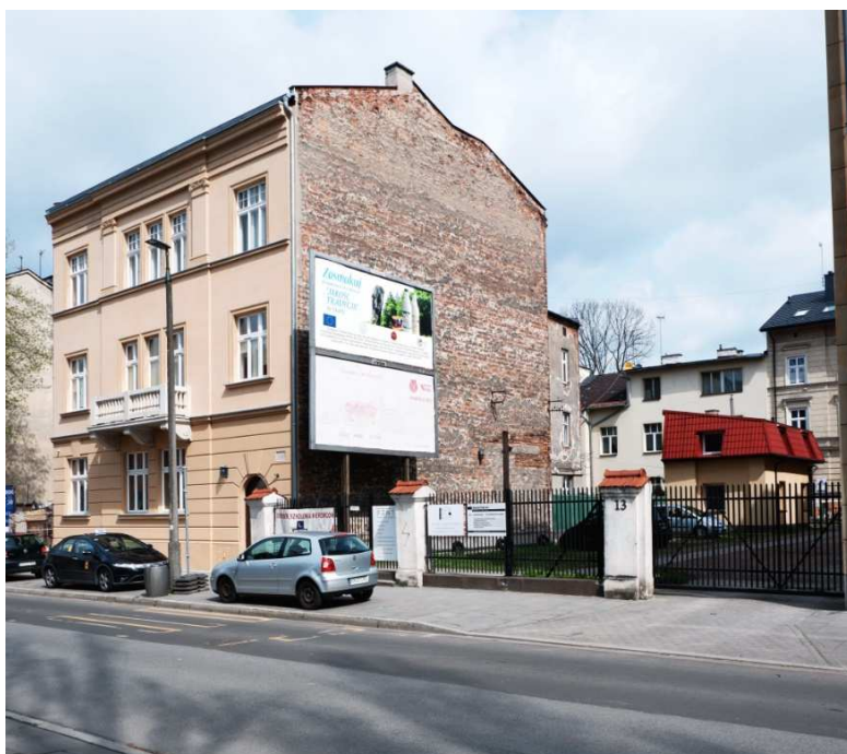
Fot. nr 87. Pusta posesja pod nr 13 i odnowiona kamienica spod nr 15. (03.05.2021)
