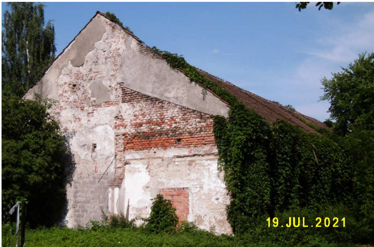
Fot. nr 59 (59-62). Budynek gospodarczy usytuowany na dziedzińcu wzdłuż muru.
