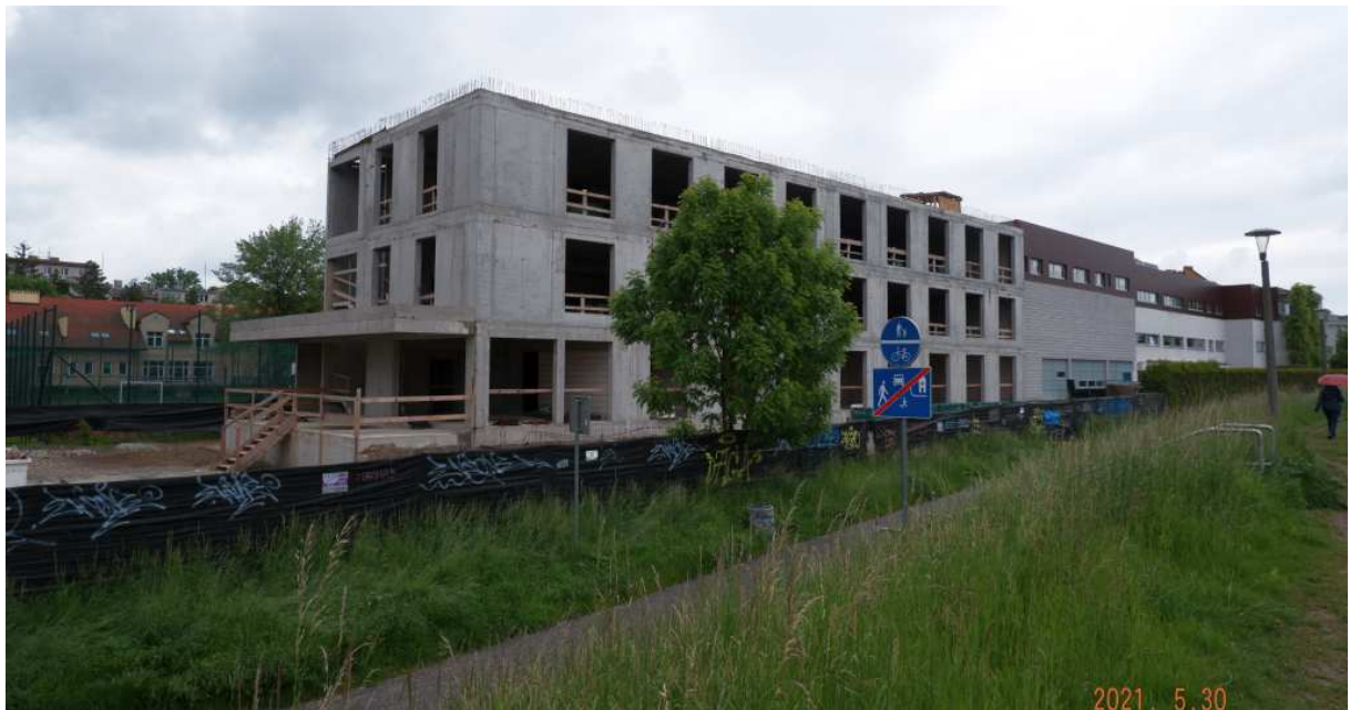
Fot. nr 275 (275-278). Wzdłuż ulicy Kasztelańskiej. Trwa zabudowa końcowego jej fragmentu.
