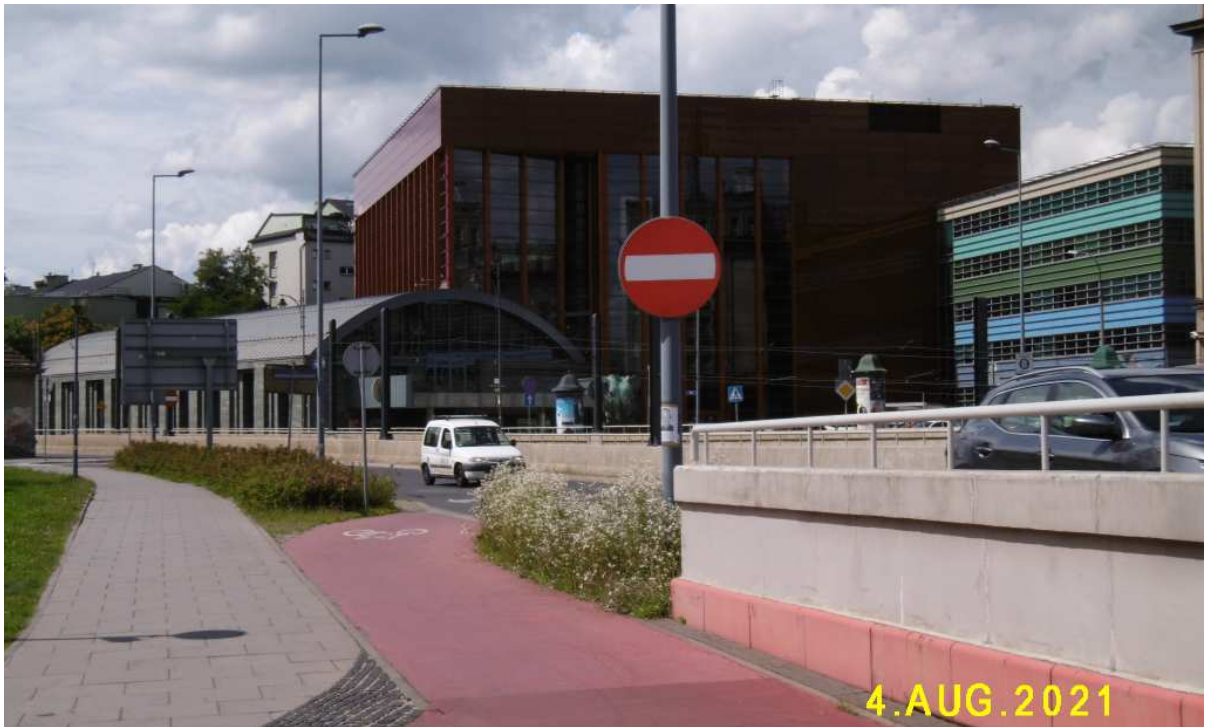
Fot. nr 13 (13-13a). Kompleks zabudowań Opery Krakowskiej pod nr 48, z przebudowanym na jego przedpolu dawnym Domem Żołnierza (z lewej).
