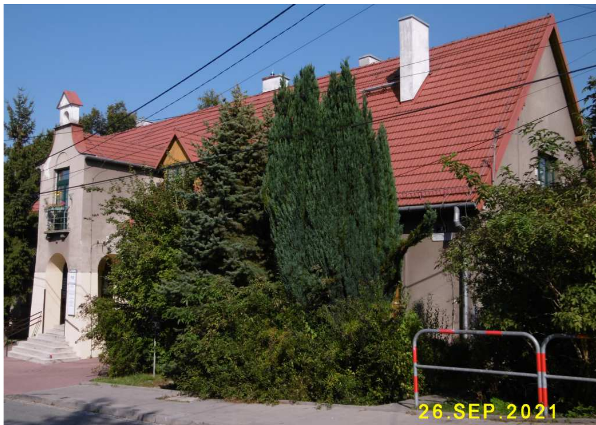
Fot. nr 336 (336-365). Wzdłuż ulicy Tetmajera. Fot. nr: 336-338. Budynek dawnej szkoły spod nr 2, wybudowany na początku XX wieku.
