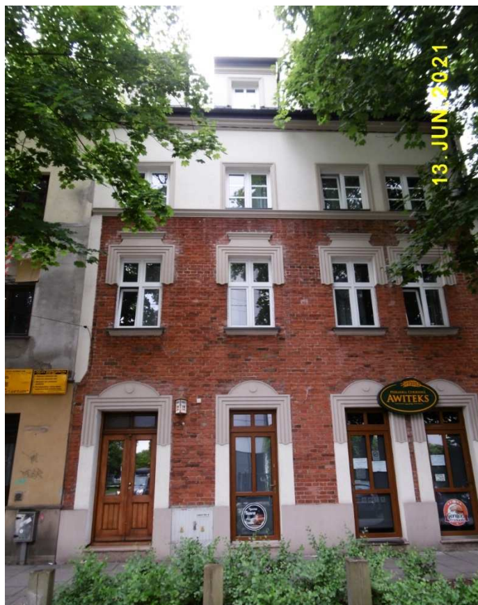
Fot. nr 204. W przypadku domu spod nr 12 również zaszyły widoczne zmiany w fasadzie.
