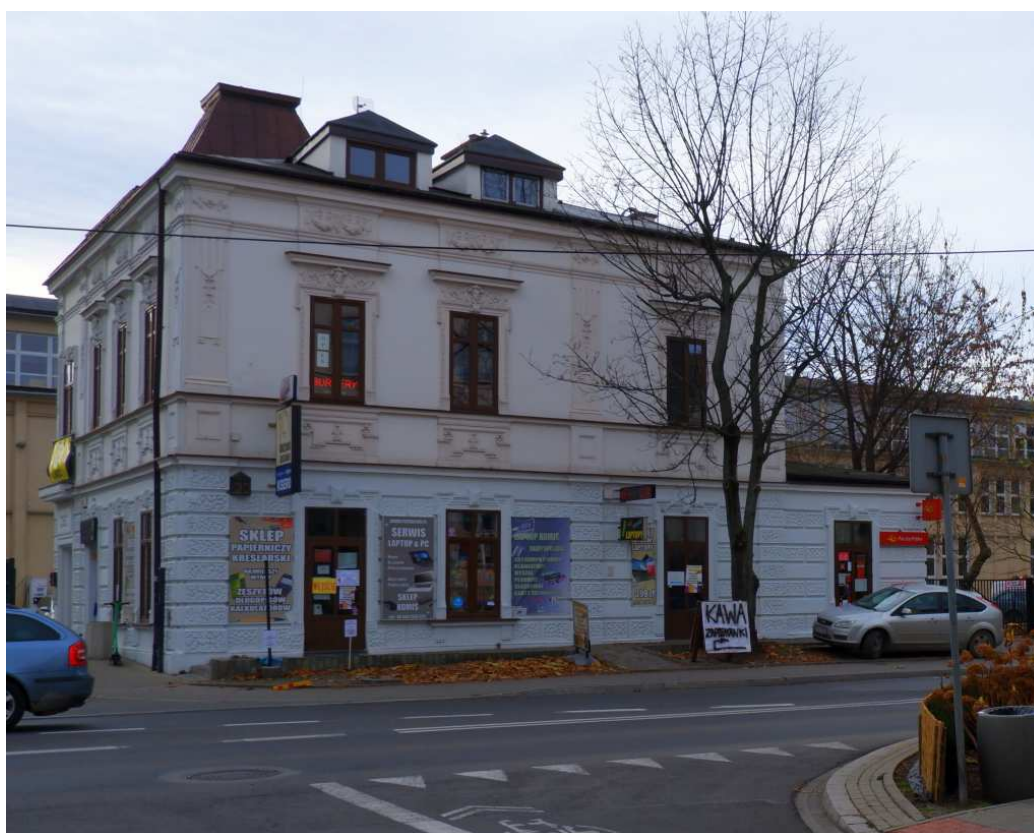
Fot. nr 191. Fasada obiektu. (04.12.2021)
