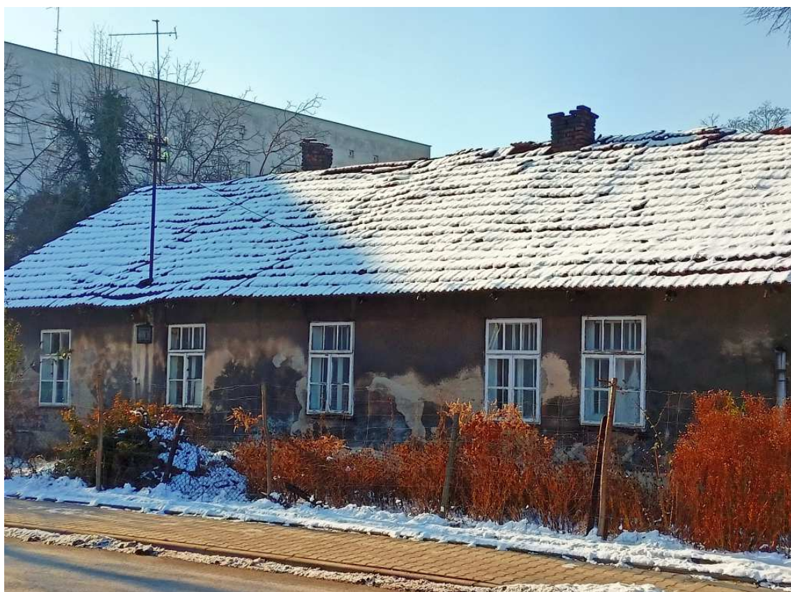
Fot. nr 295. Fasada murowanego domu wielorodzinnego z oryginalnymi oknami.
