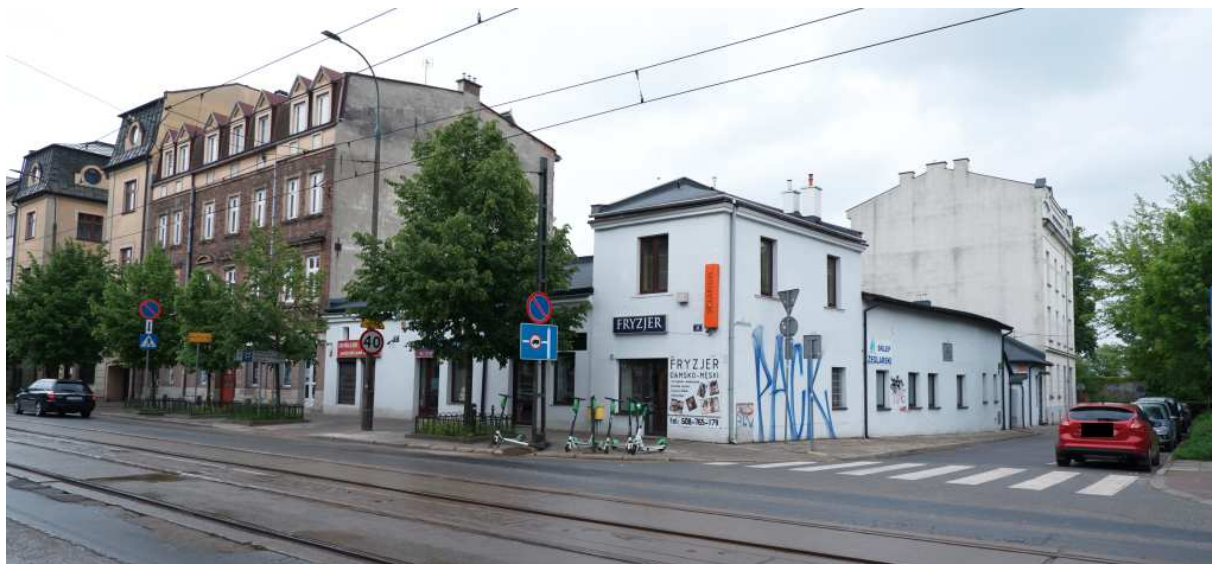
Fot. nr 256. Ciagle trwający parterowy dom pod nr 36. Widok na wylot ulicy Jaskółczej. (30.05.2021)
