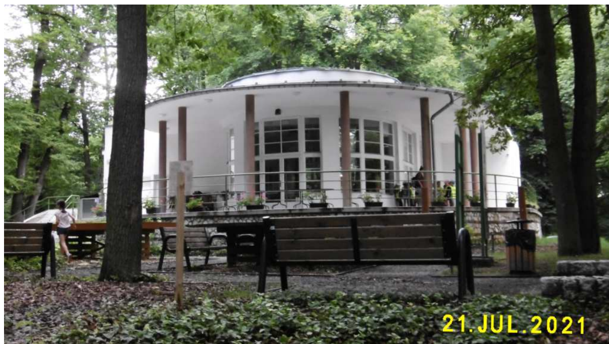
Fot. nr 310 (310-311). Odnowiony Pawilon Okocimski, obecnie przeznaczony na użytek Ośrodka Edukacji Ekologicznej Symbioza.
