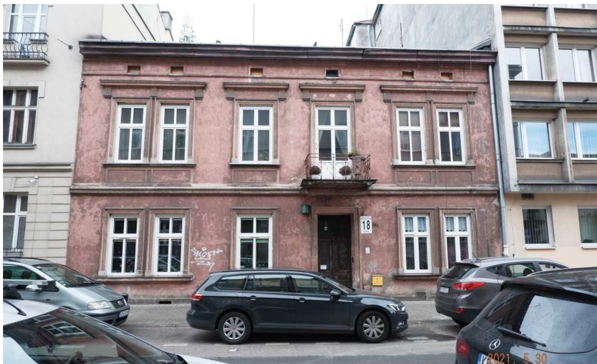
Fot. nr 236. Jednopiętrowy, typowo podmiejski dom spod nr 18 przy ulicy Borelowskiego.
