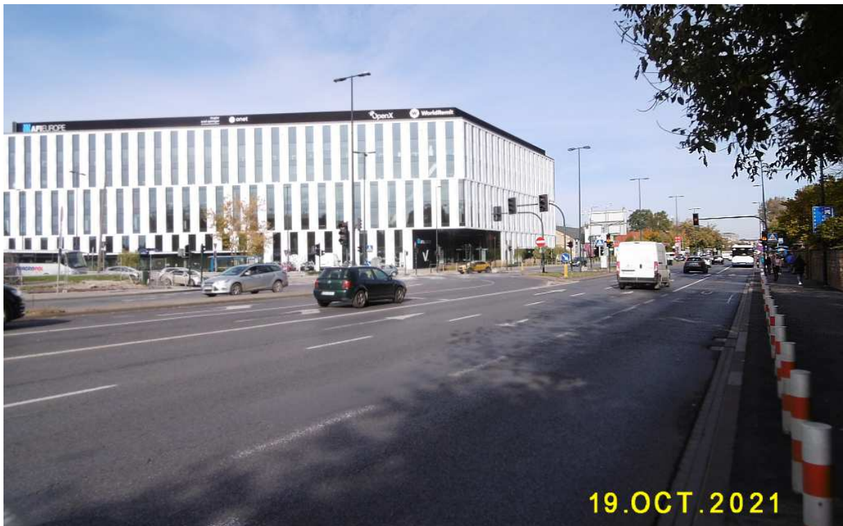
Fot. nr 23. Współczesna sceneria alei 29-Listopada we fragmencie na styku z ulicą Kamienną.
