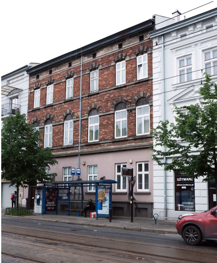
Fot. nr 261. Kamienica pod nr 46, gdzie nad oknami I piętra znajduje się dekoracja sgraffitowa z postaciami wybitnym Polaków, wpisana do rejestru zabytków. (30.05.2021)
