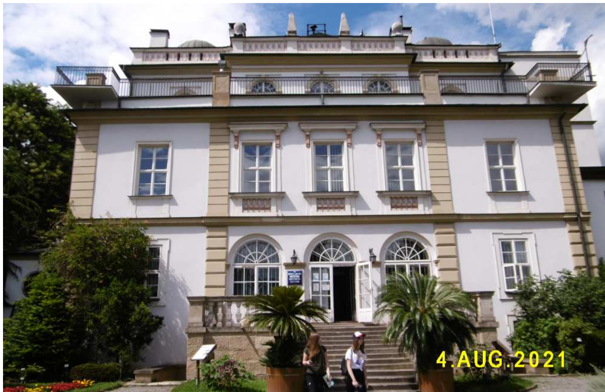
Fot. nr 14. Pochodzący z końca XVIII wieku (nadbudowany po połowie XIX wieku) klasycystyczny budynek dawnego Obserwatorium Astronomicznego w ujęciu od strony ogrodu. Pierwotnie, w XVII wieku, mieściła się tu willa Czartoryskich i ich ogród. W połowie XVIII wieku majątek odkupili Jezuici, ale utracili go po kasacie w roku 1773.
