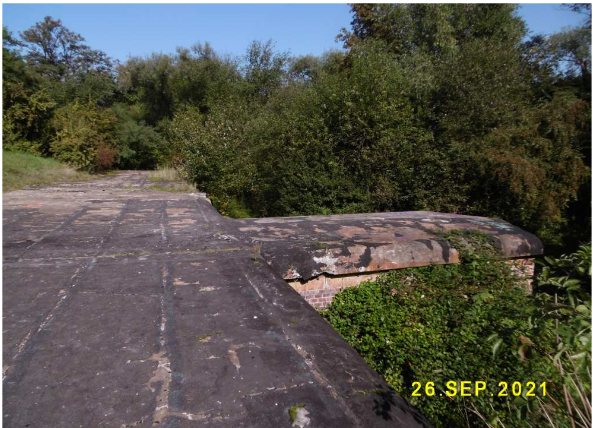
Fot. nr 387. Na dachu fortu.
