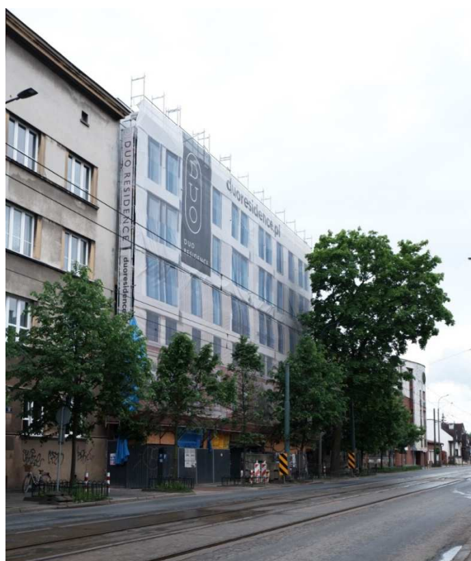
Fot. nr 265(265-267).Dramatycznie wygląda demolka urokliwej, liczącej 110 lat zabudowy we fragmencie o numerach: 60-66. Ściany zewnętrzne domów pod nr: 60-62 zostaną „wklejone” w fasadę powstającego tu czteropiętrowego apartamentowca. (30.05.2021)
