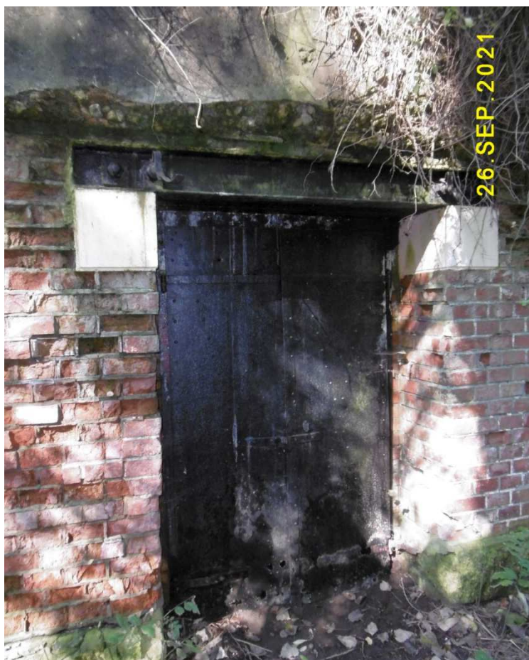
Fot. nr 361. Metalowe drzwi.
