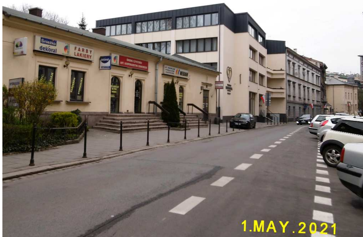
Fot. nr 124. Zabudowa ulicy poniżej parterowego domku o nr 11.
