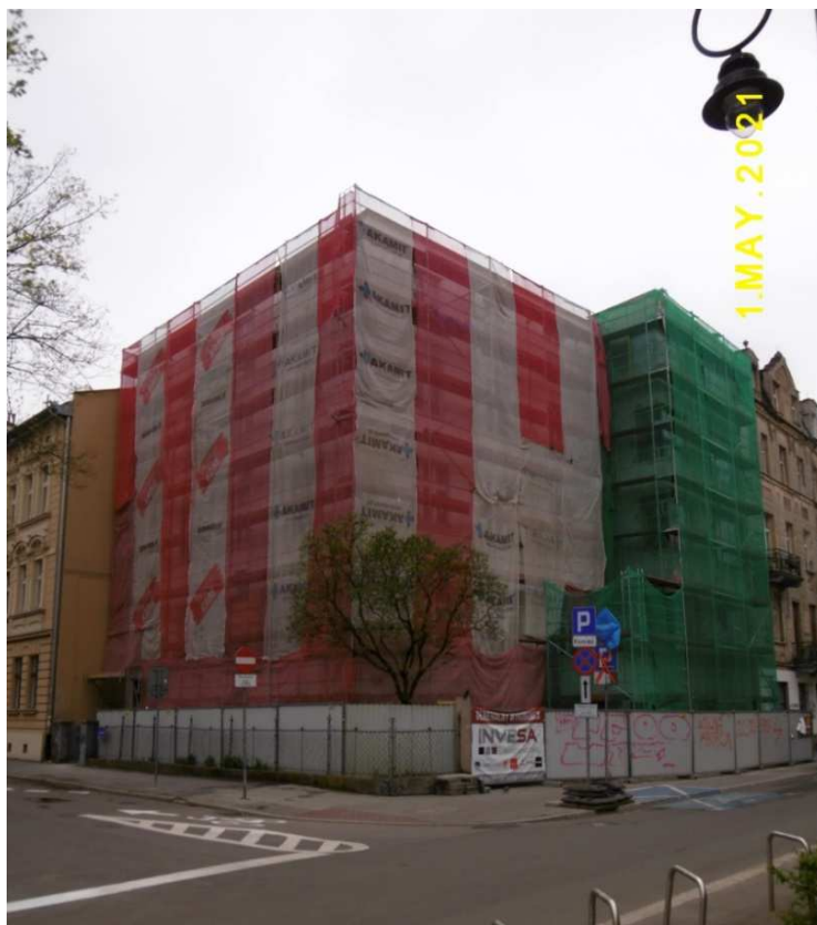
Fot. nr 109 (109-113). Zmiany w zabudowie: poseji pod nr 18, gdzie powstała nowa kamienica oraz narożnej kamienicy spod nr 16/Szujskiego 11, w której dobudowano piętro mieszkalne.
