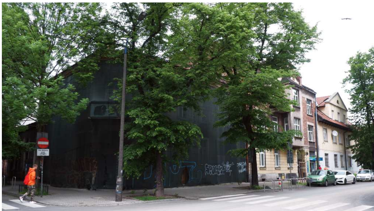
Fot. nr 230. Widok od strony ulicy Senatorskiej. Jaki los czeka ten dom? (30.05.2021)
