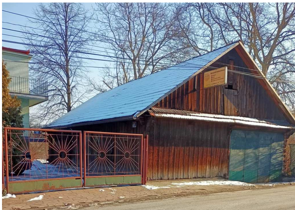
Fot. nr 305. Widok od strony podwórka.
