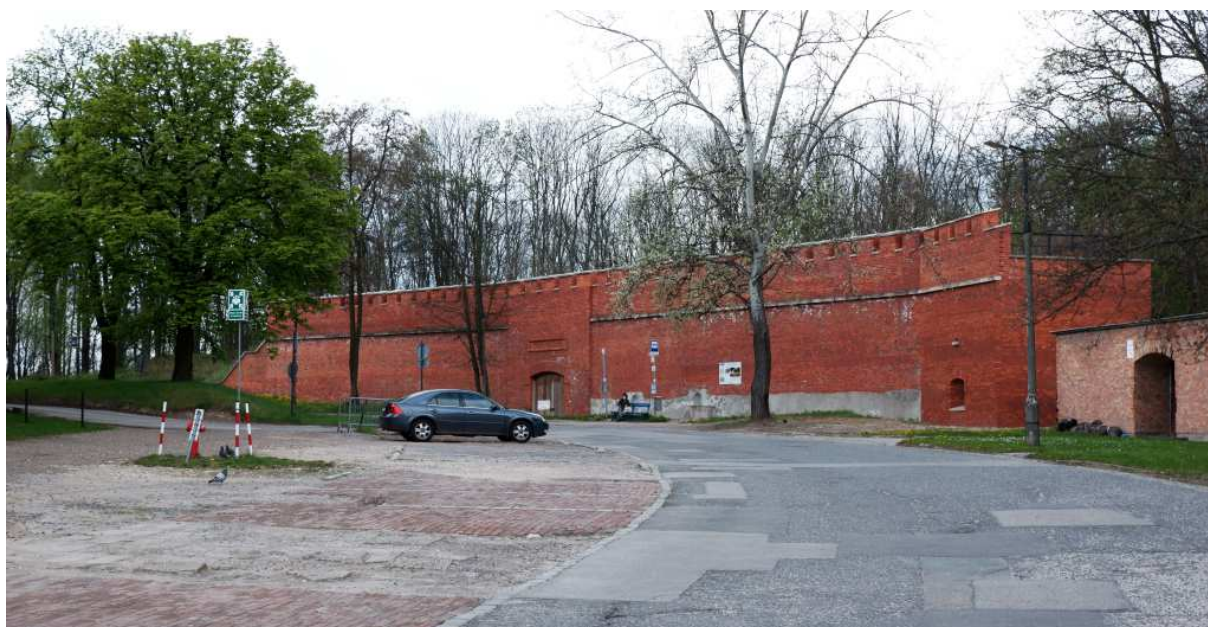
Fot. nr 283. Zrekonstruowana ściana wewnętrzna bastionu nr II. (08.05.2021)
