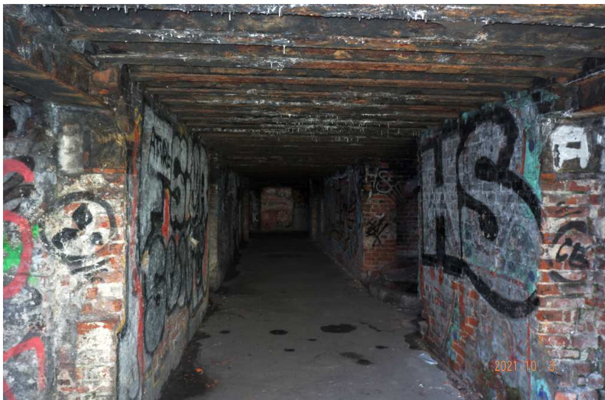
Fot. nr 382 (382-383). Korytarz przy wejściu.
