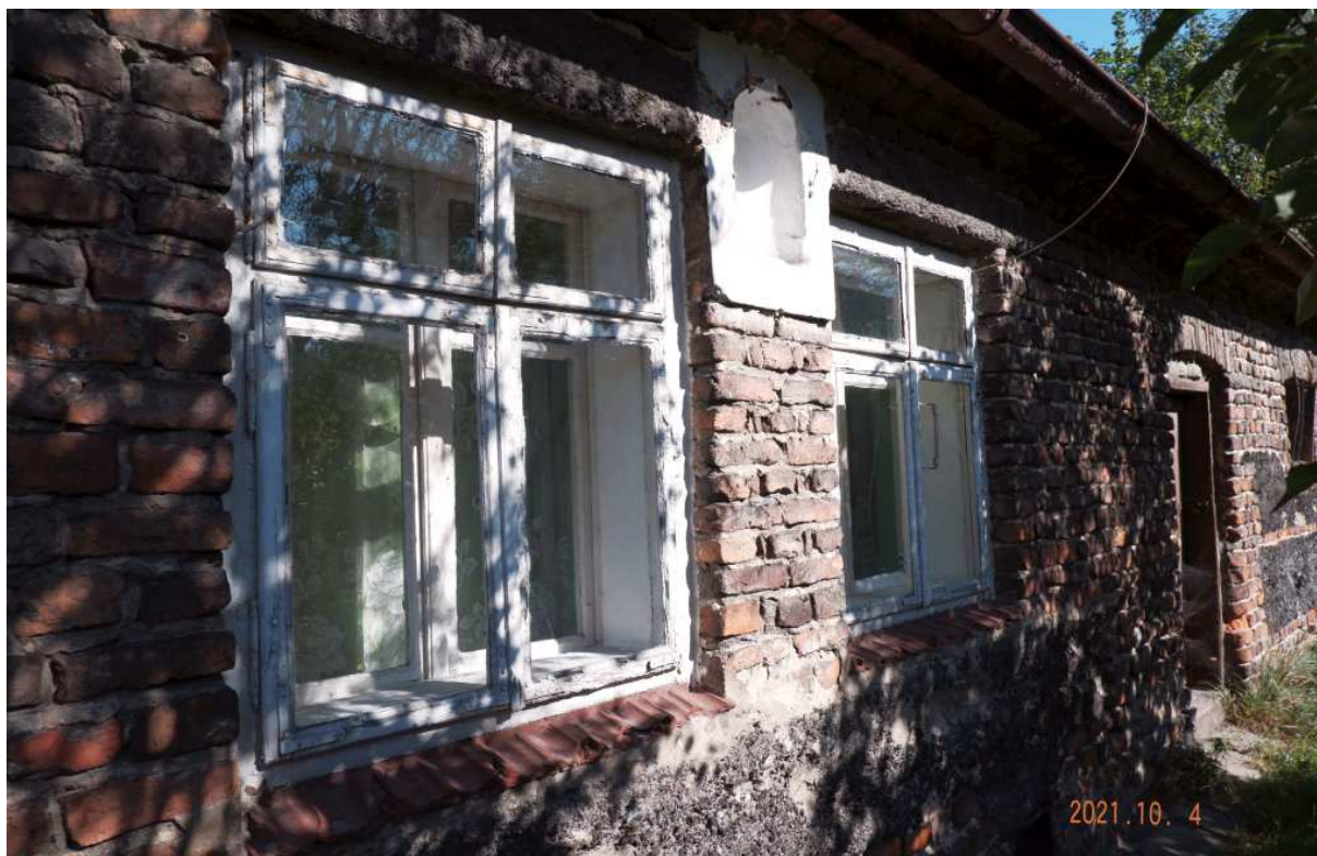
Fot. nr 320. Czteroskrzydłowe okna typu ościeżnicowego.
