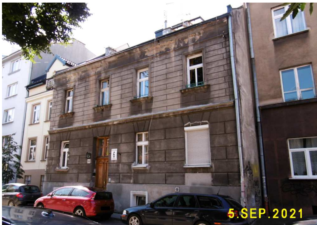
Fot. nr 227. Kolejny, ponad 100-letni relikw dawnej zabudowy Pólsia spod 6.
