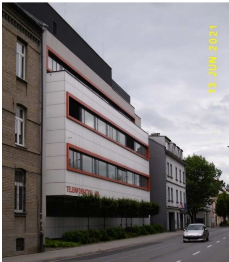
Fot. nr 200. Nowopowstały, w miejscu wyburzonej willi Tęcza, budynek pod nr: 72-74.
