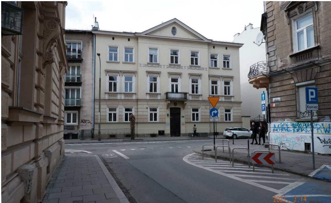
Fot. nr 162. Nadbudowany w okresie międzywojennym o jedno piętro dom przy ulicy Garncarskiej 5.
