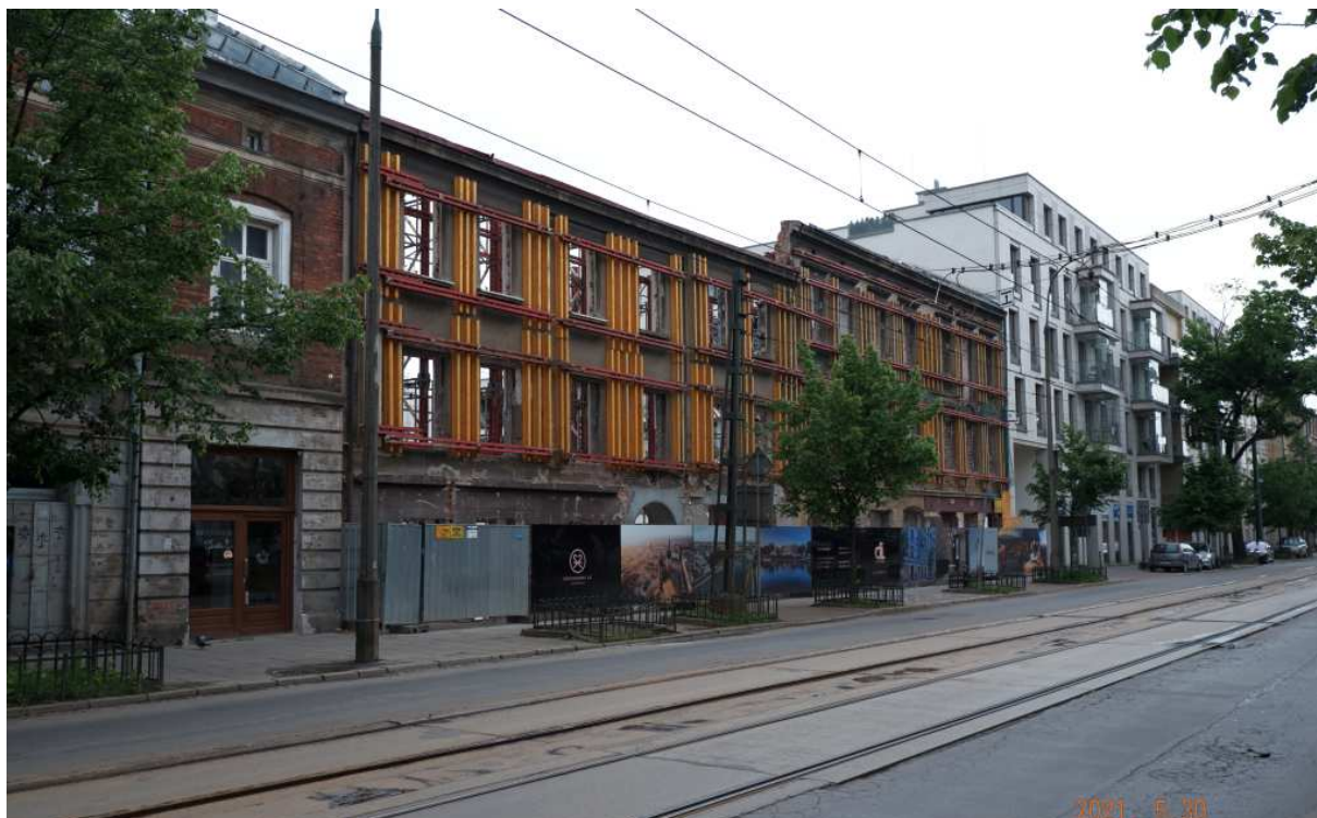
Fot. nr 244 (244-245). w miejscu kamienic pod nr 20-22 powstaje kolejna „wydmuszka”. W wielopiętrowy apartamentowiec zostaną „wklejone” frontowe ściany.
