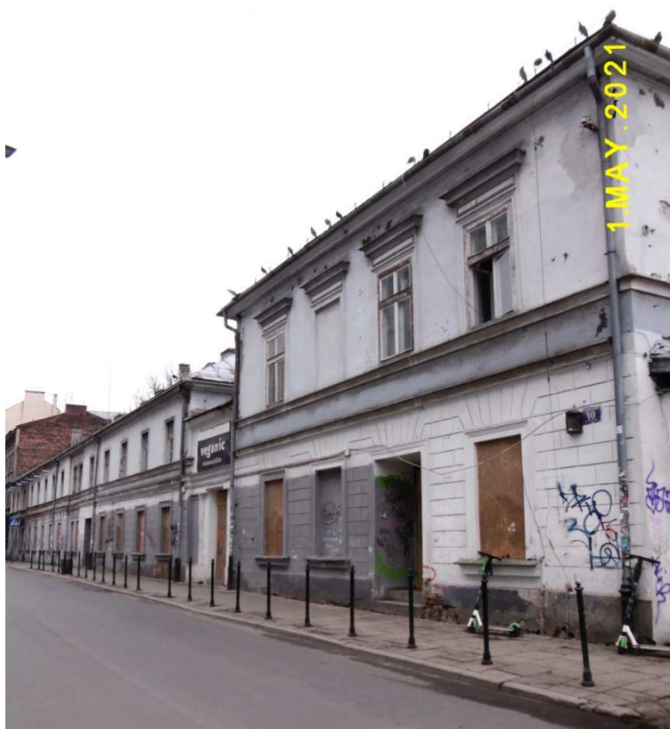
Fot. nr 101 (101-102). Budynki socjalne.
