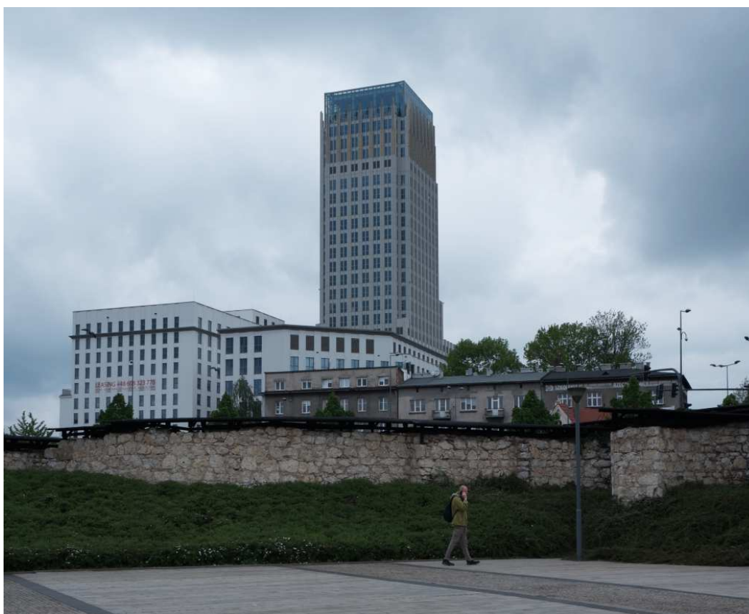
Fot. nr 24 (24-25). „Szkieletor” z ronda Mogilskiego w swym ostatecznym kształcie. Ujęcie spod fortu mogilskiego. (19.05.2021)
