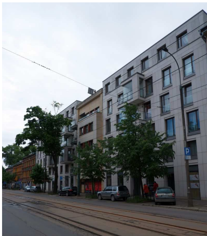
Fot. nr 246. Przerośnięty gabarytowo aparatamentowic pod nr 24, który totalnie zaburza dawną zabudowę Półwsia. Całe Półwsie, nie tylko przy ulicy Kościuszki, na zasadzie wolnej amerykanki szybko pnie się góry. Ale skoro ciągle brak MPZP.....(30.05.2021)
