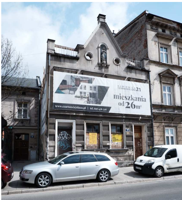
Fot. nr 80 (80-81). Dom spod nr 21, w którym MWKZ w trakcie jego przebudowy udało się uratować fasadę. (03.05.2021)
