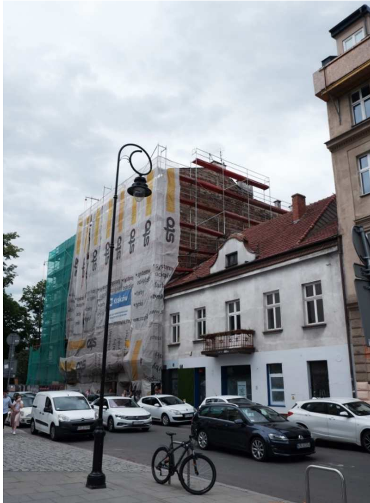
Fot. nr: 106-114. Wzdłuż ulicy Rajskiej. Fot. nr 106 (106-113). Fragment o numerach: 16/Szujskiego 11, 18, 20 i 22 na etapie remontu bądź przebudowy. Znikł unikatowy ogród wiszący pod nr 18. (01.05.2021)
