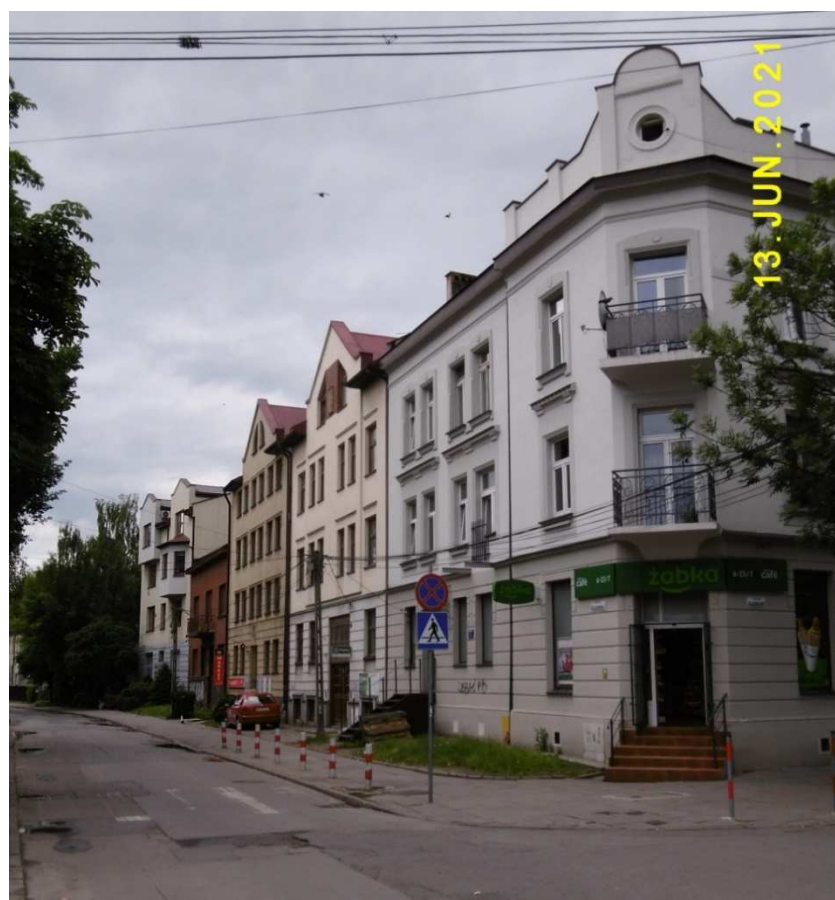
Fot. nr 207 (207-210). Wzdłuż ulicy Miechowskiej. Pierzeja o nieparzystych numerach – widok z wylotu ulicy Kawiory.
