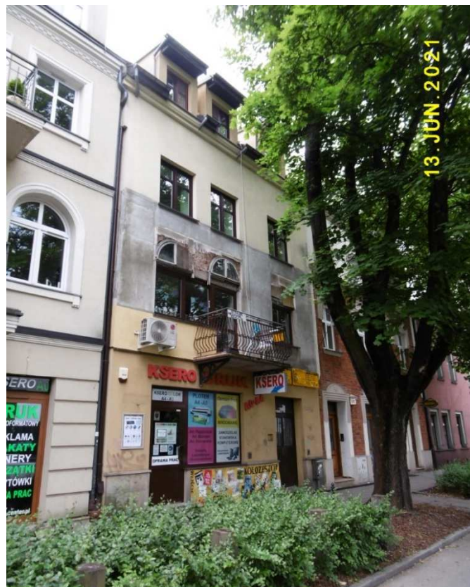
Fot. nr 203. Współcześnie zmodyfikowana fasada kamieniczki spod nr 10.
