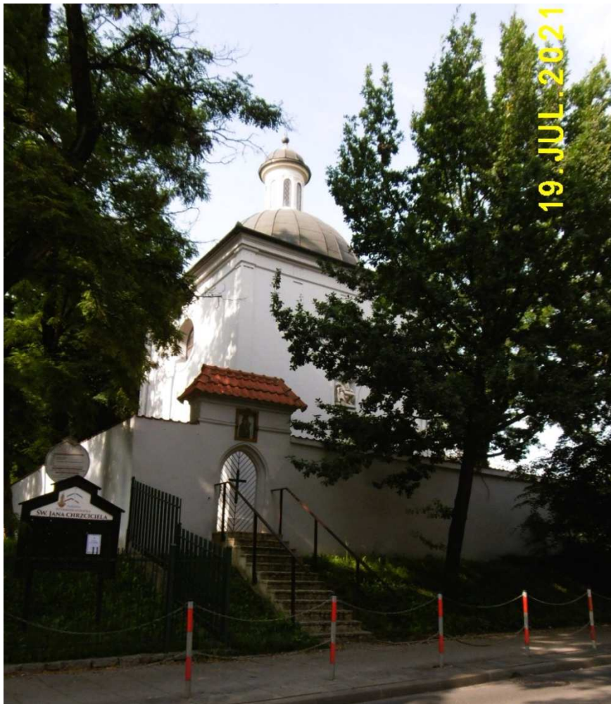
Fot. nr 51 (51-54). Zabytkowa kaplica p.w. św. Jana Chrzciciela i św. Jana Ewangelisty pod nr 117, która powstała w roku 1640.
