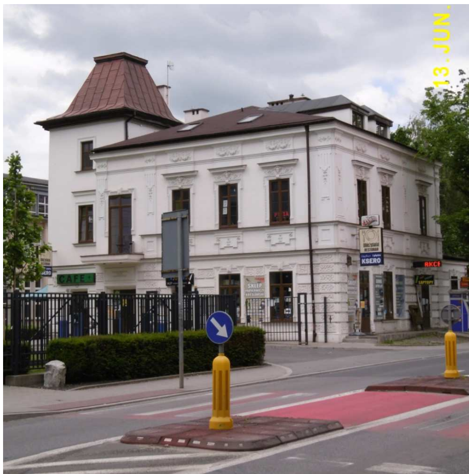
Fot. nr 192 (192-193). Widoki na tylną część budynku.
