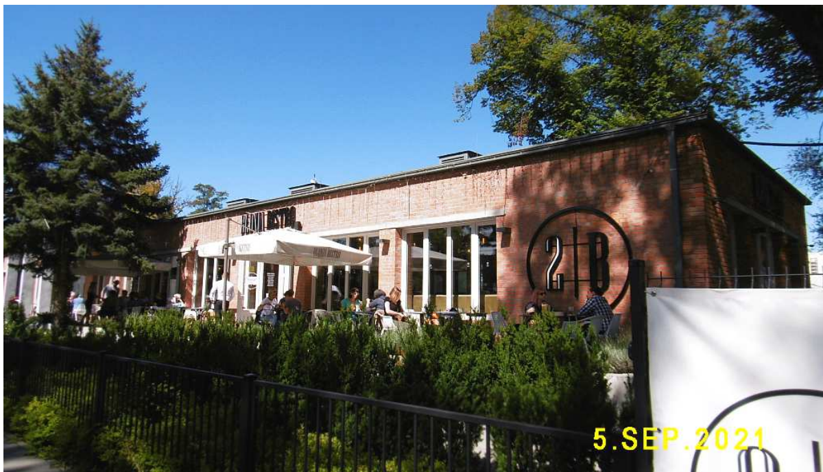
Fot. nr 213 (213-214). Pozostałości po dawnym zespole basenów Cracovii przy alei 3-Maja 55. W budynku dawnych szatni, który na szczęście przetrwał w dawnej szacie architektonicznej, funkcjonuje dziś Bistro Błonia.
