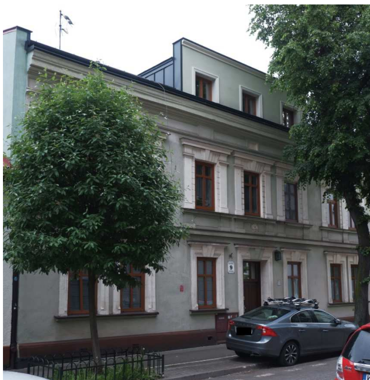
Fot. nr 225. Szpetnie nadbudowany o zwieńczenie nad piętrem dom pod nr 9. (30.05.2021)
