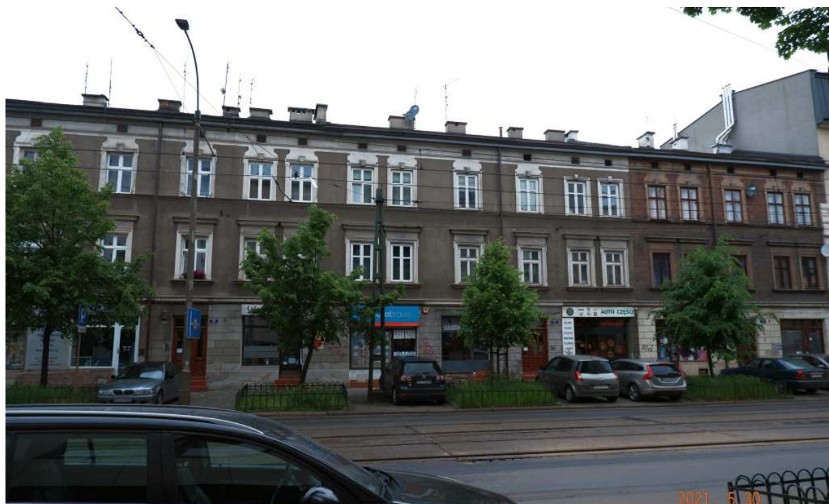
Fot. nr 249 (249-251). Ciągłe dwupiętrowa kamienica pod nr 23 i jej oryginalne detale.
