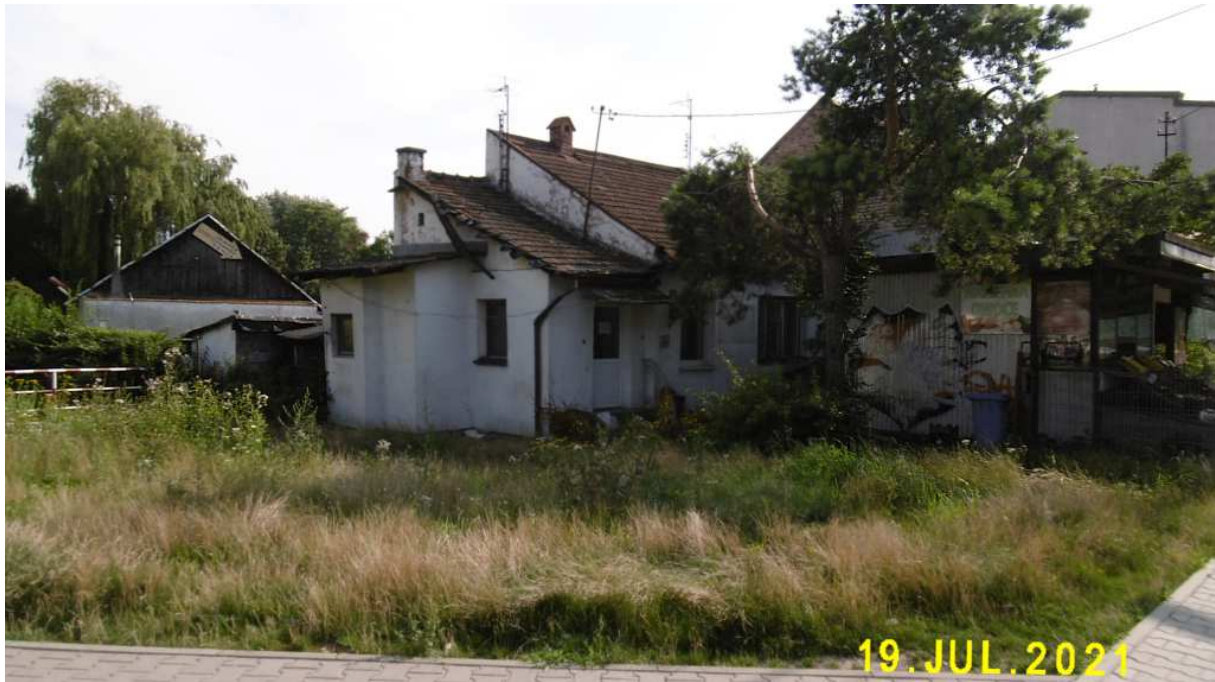
Fot. nr 48. Sielska jeszcze zabudowa na tyłach posesji pod nr 72.
