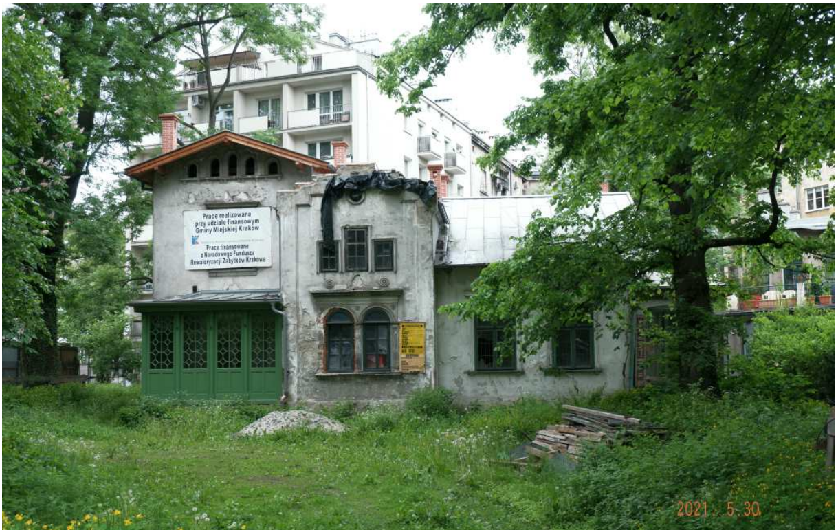
Fot. nr 173. Fasada willi od strony ulicy Morawskiego.
