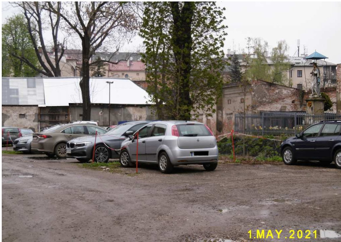
Fot. nr 149. Trwa renowacja ściany oficyny, w którą wkomponowana jest rokokowa figura.
