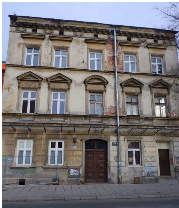
Fot. nr 83. Kamienica pod nr 19 w oczekiwaniu na odnowę elewacji. (04.12.2021)
