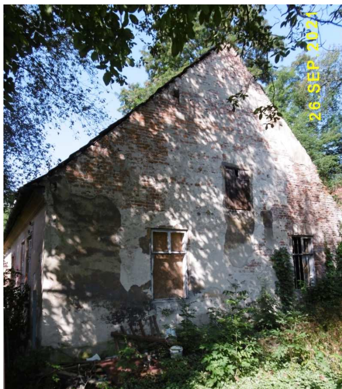
Fot. nr 343 (343-345). Murowany dom pod nr 6 z przełomu XIX i XX wieku.
