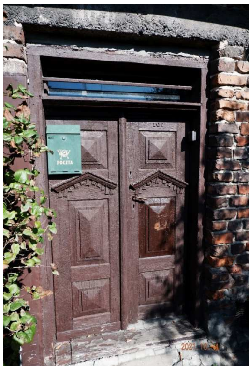
Fot. nr 319. Profilowane w drewnie drzwi.
