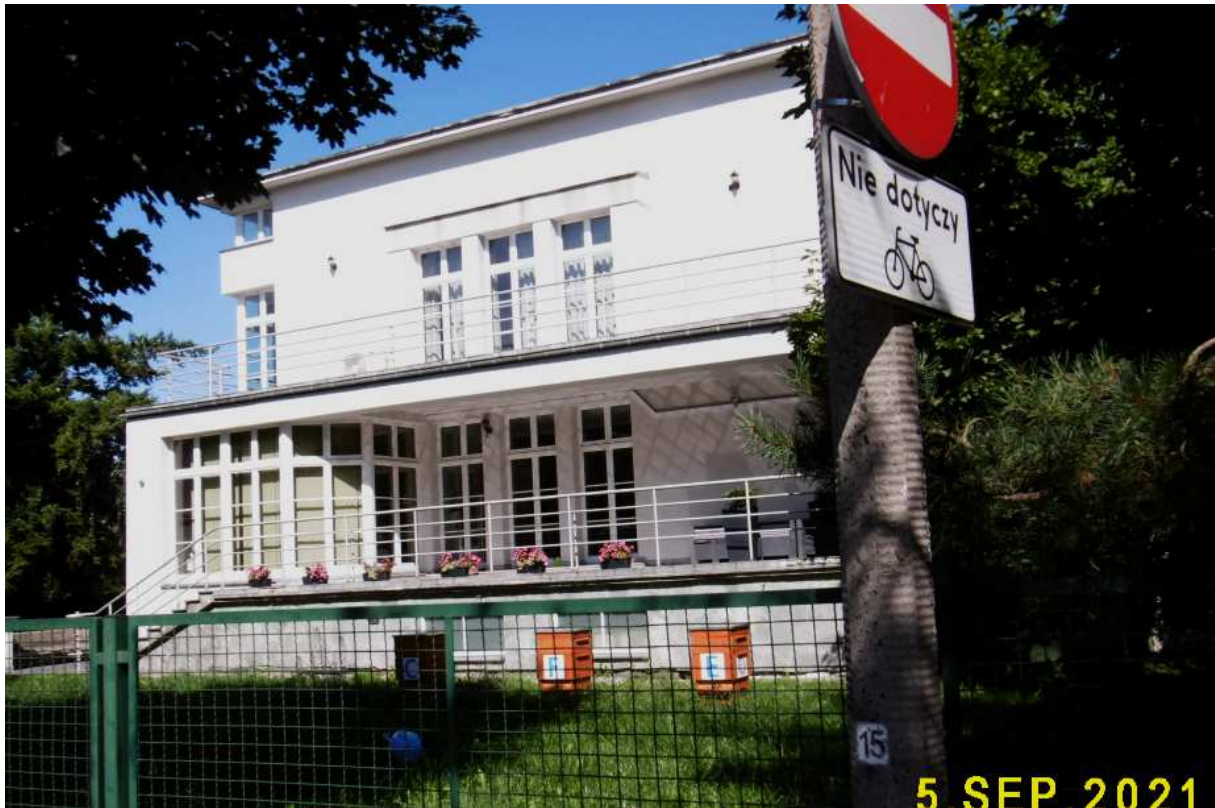
Fot. nr 216. Przykład przedwojennej zabudowy Cichego Kącila – willa z ulicy Domeyki 2 (przed wojną Pększyc-Grudzińskiego), która powstała w roku 1936 wg projektu Adolfa Szyszko-Bohusza. W tym czasie powstała cała zabudowa tej ulicy.
