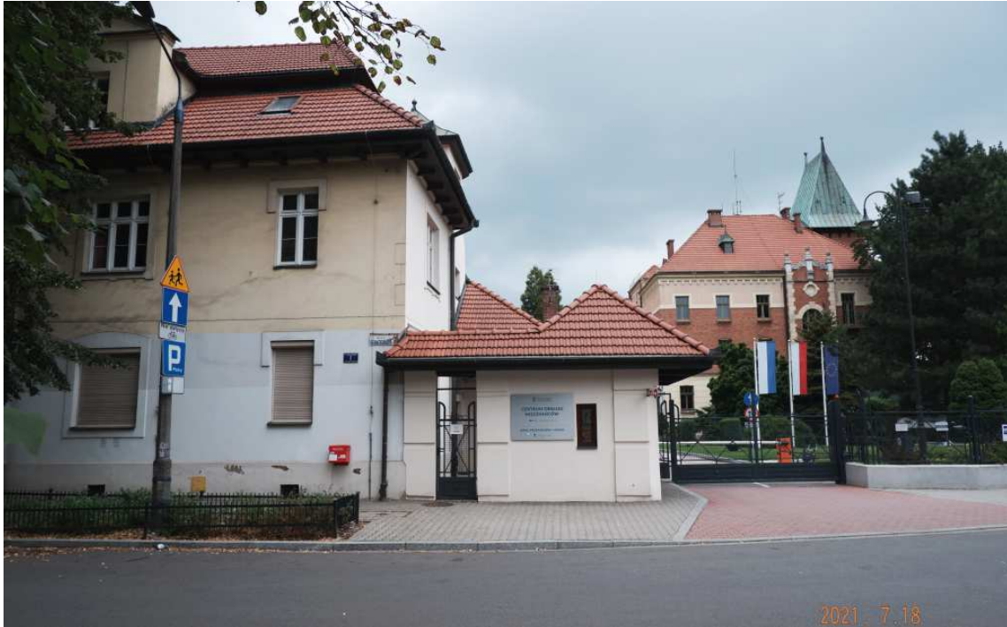
Fot. nr 232. Zespół zabudowy Miejskiego Przedsiębiorstwa i Kanalizacji (dawny Miejski Wodociąg Pompowy im. Franciszka Józefa) przy ulicy Senatorskiej 1/Łowieckiej 2, który powstał w latach 1911-13 wg projektu Jana Rzymkowskiego. (18.07.2021)
