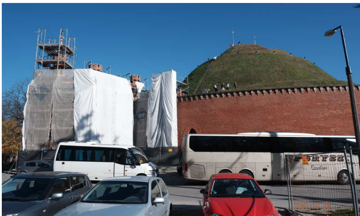
Fot. nr 299 (299-300). Kopiec Kościuszki i przylegająca do niego kaplica bł. Bronisławy na etapie renowacji.
