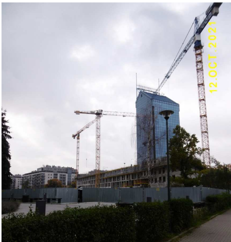
Fot. nr 30 (30-30a). Trwa zabudowa przestrzeni wokół „błękitka” PKO przy alei Pokoju.
