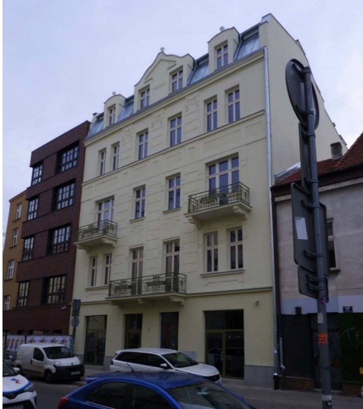
Fot. nr 108. Świeżo odnowiona fasada 100-letniej kamienicy pod nr 20. (04.12.2021)
