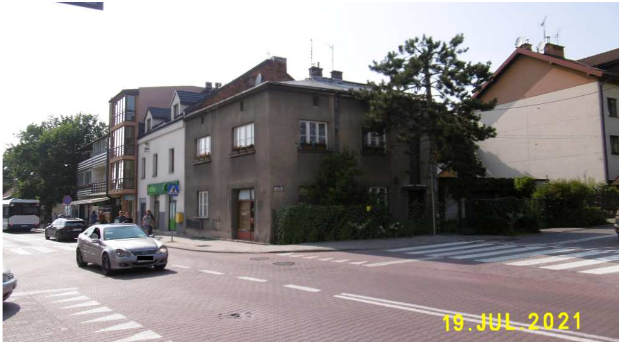
Fot. nr 50. W narożu z ulicą Naczelną. Fragment zabudowy ulicy poniżej numeru 101.
