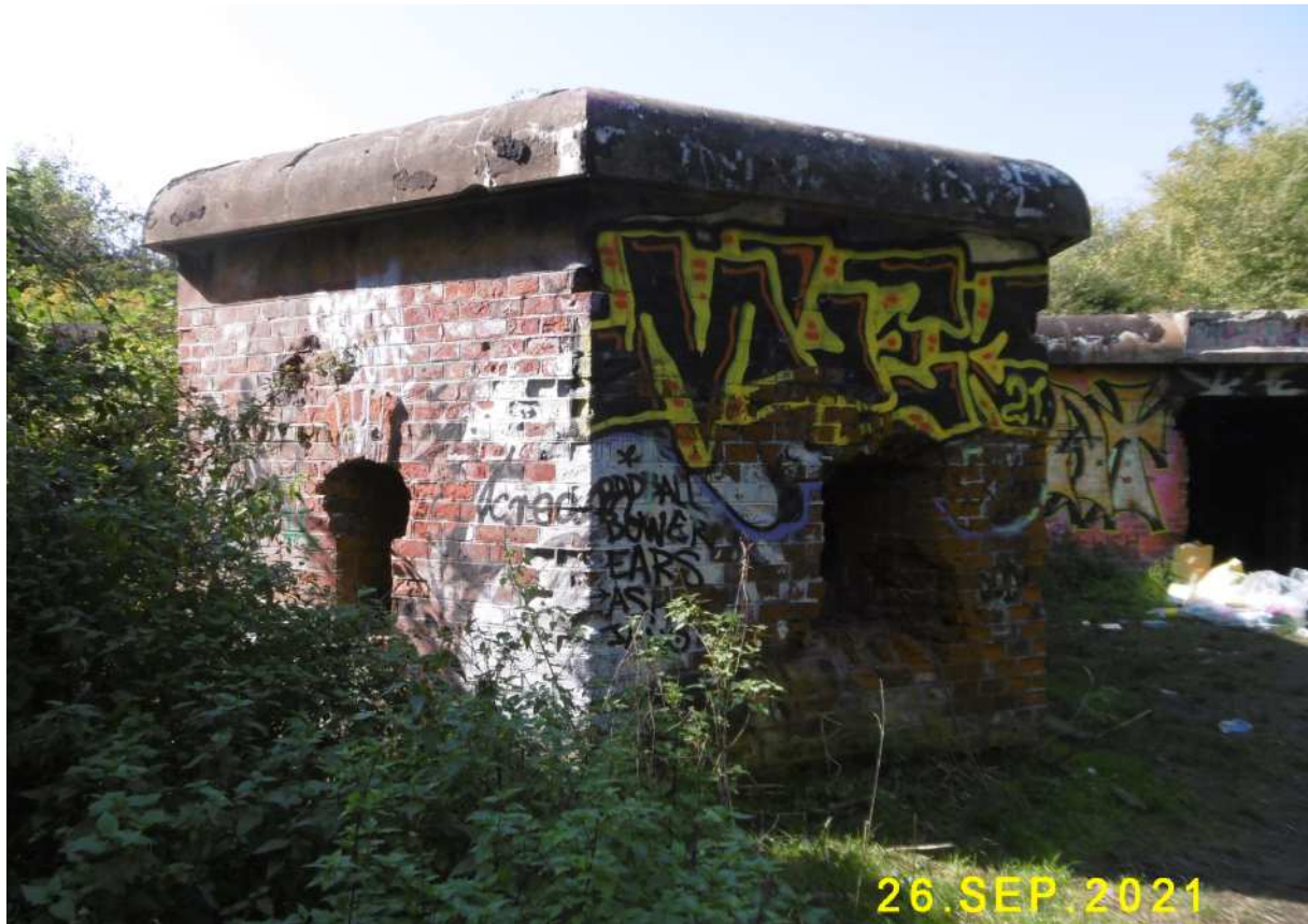
Fot. nr 378. Sponson przy wejściu.
