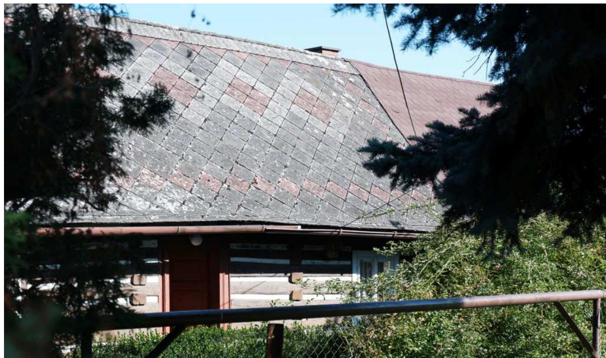
Fot. nr 305 (305-306). Jednotraktowa chałupa przy ulicy Nad Zalewem 1, wybudowana ok. 1900 roku przez Macieja Waligórę, wójta Woli Justowskiej, która ma szansę trafić do krakowskiego skansenu.
