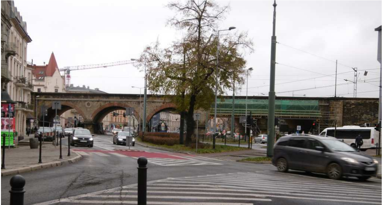
Fot. nr 6. Zabytkowy, wybudowany w roku 1863 wiadukt nad ulicą Grzegórzecką, któremu grozi rozbiórka i wybudowanie „od nowa”. (19.11.2021)
