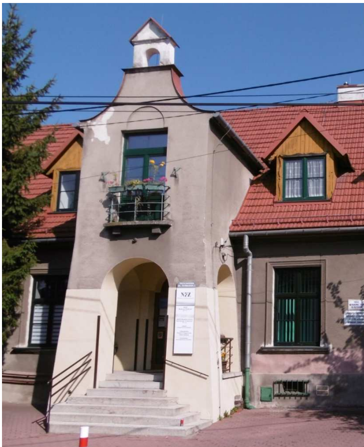
Fot. nr 338. Ryzalit przy wejściu. (26.09.2021)
