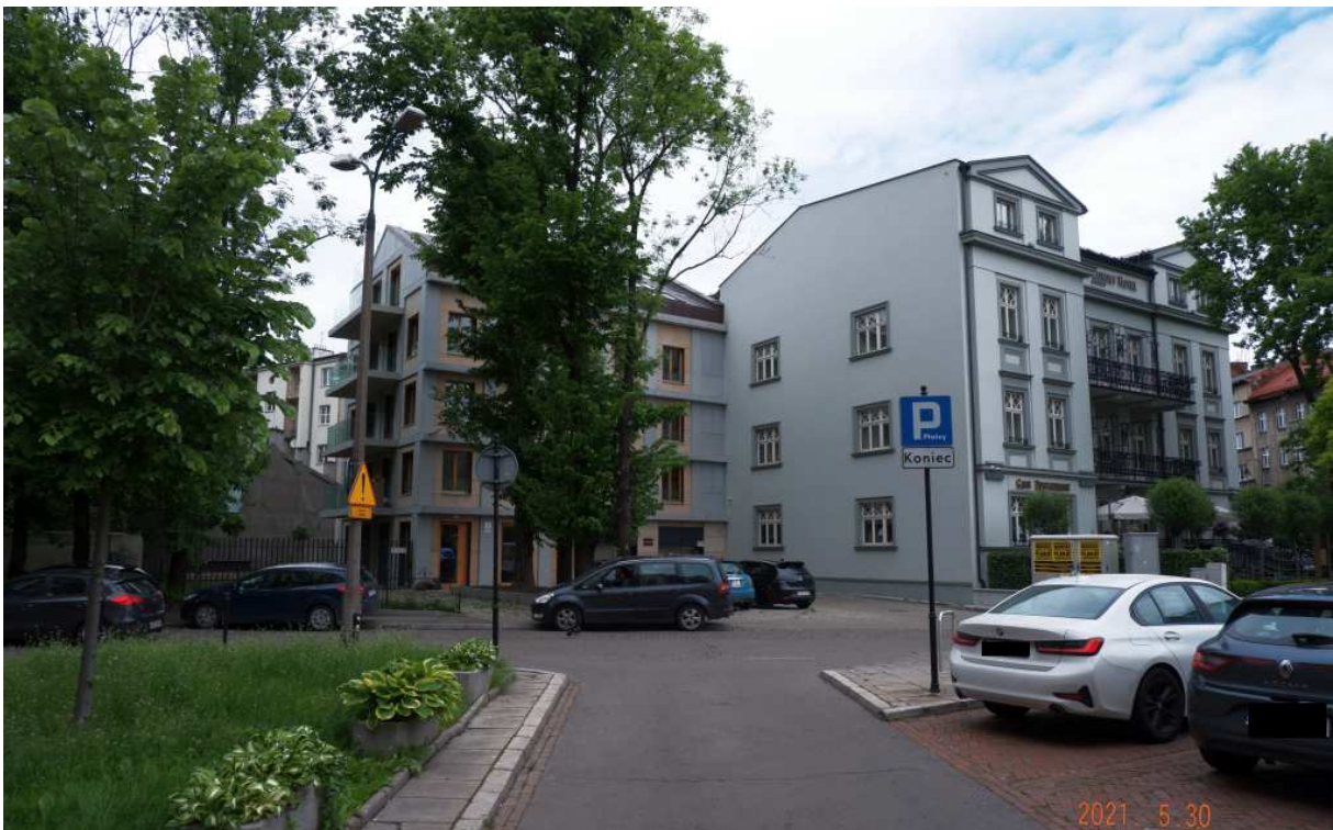
Fot. nr 175 (175-177). Bachleđa Luxury Hotel przy placu Kossaka 6, powstały z przebudowy willi Medyńskich, z której pozostały tylko zewnętrzne ściany. Można rzec, że mamy tu do czynienia z kolejną wydmuszką, która z zabytkiem ma niewiele wspólnego.
