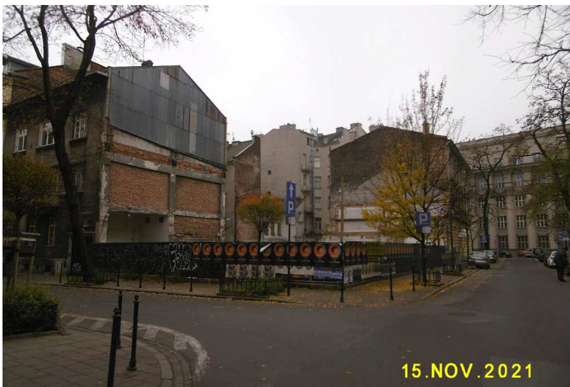
Fot. nr 5 (5-7). Pusta przestrzeń po wyburzonym właśnie jednopiętrowym domu z ulicy Librowszczyzna 3, gdzie na początku XX wieku mieściła się fabryka tutek Herliczki.
