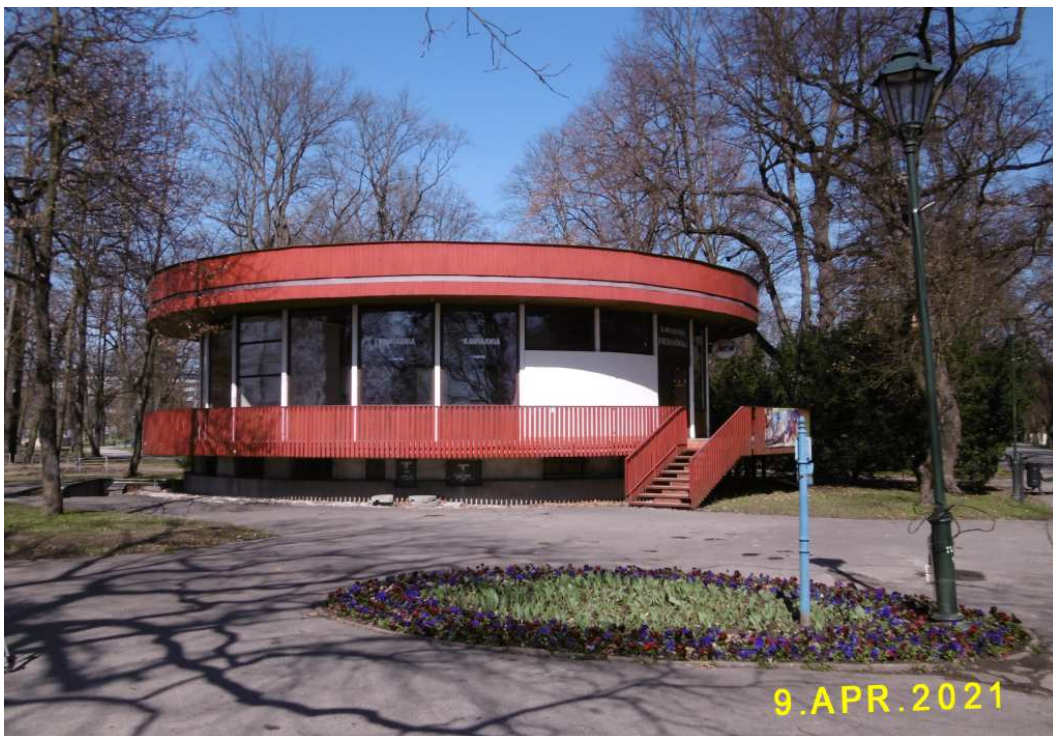
Fot. nr 211. W Parku Jordana. Jak przyszłość czeka okrągłak? Czy obecnie istniejący obiekt, znajdujący się w złym stanie technicznym, zostanie wyremontowany, czy w jego miejsce zostanie odtworzony drewniany oryginał z roku 1899, wyburzony pod koniec lat 60. XX. wieku? Ja oczywiście optuję za tym drugim rozwiązaniem.
