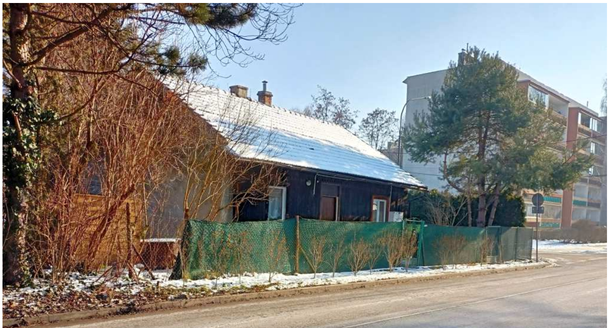
Fot. nr 299. Zapewne przedwojenny dom pod nr 68, którego fasadę zniekształciły współczesne okna.
