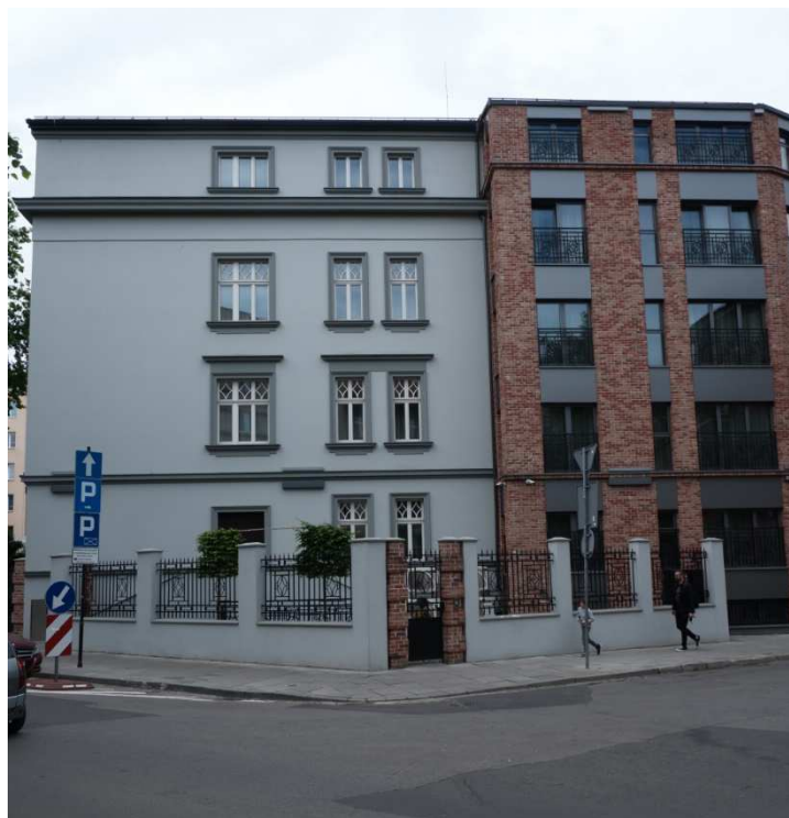
Fot. nr 177. Widok z ulicy Retoryka. (30.05.2021)
