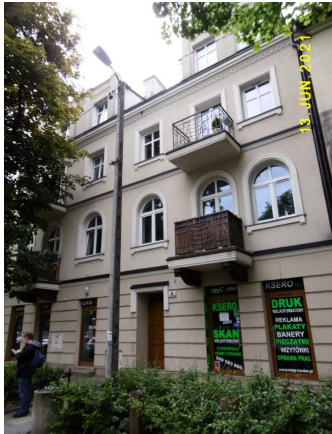
Fot. nr 202 (202-206). Ulica Kawiora a.d. 2021. Rozbudowana kamieniczka pod nr 8.
