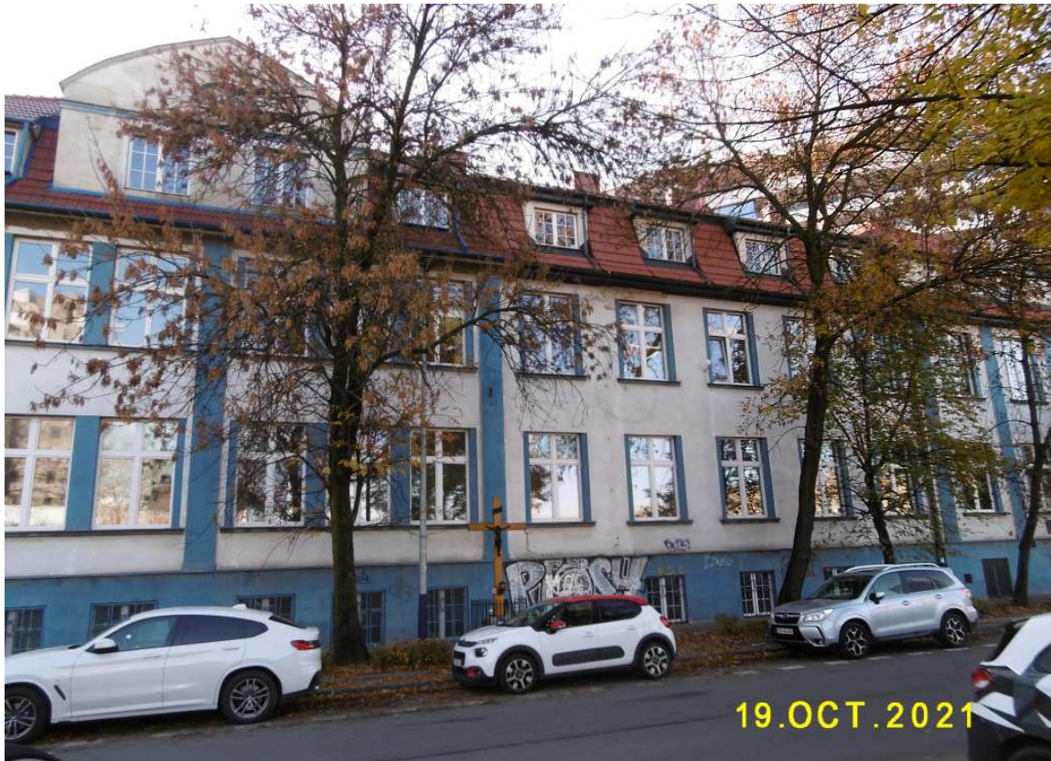
Fot. nr 31 (31-31a). Budynek administracyjny dawnej fabryki Zieleniewskiego z ulicy Grzegórzeckiej 69, który jest jedyną pamiątką materialną po tej znanej spółce akcyjnej.
