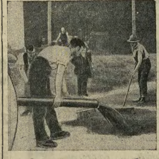
Inny sposób asfaltowania na zimno.
