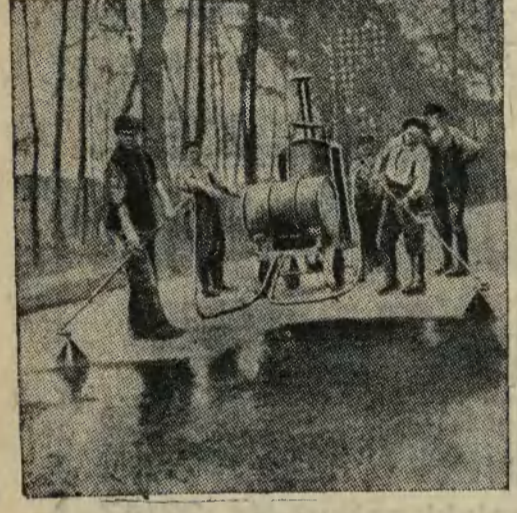
Polewanie drogi asfaltem wodnym.
