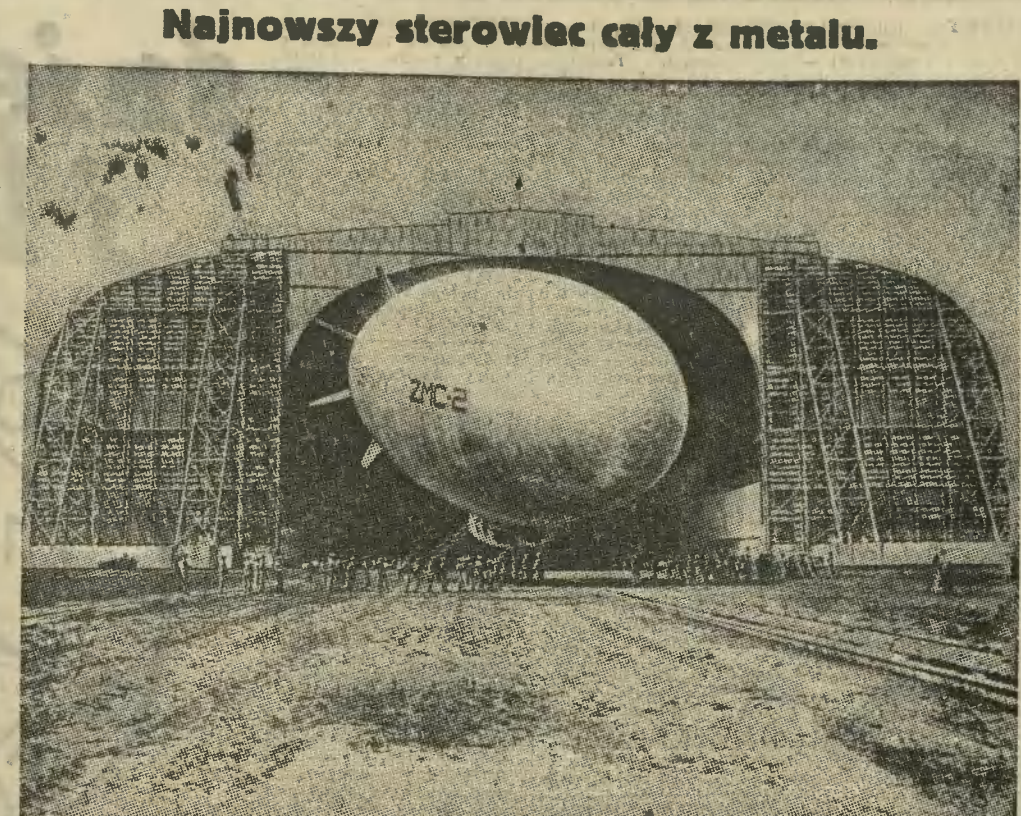
W Detroit (Stany Zjedn.) ukończono właśnie konstrukcję wielkiego sterowca dla marynarki amerykańskiej. Sterowiec jest cały z metalu i zostanie przewieziony do Lakehurst. Rycina przedstawia zdjęcie nowego sterowca na tle hangaru. Zwracamy uwagę na odmienny niż u „Zeppelinów” system sterów.
