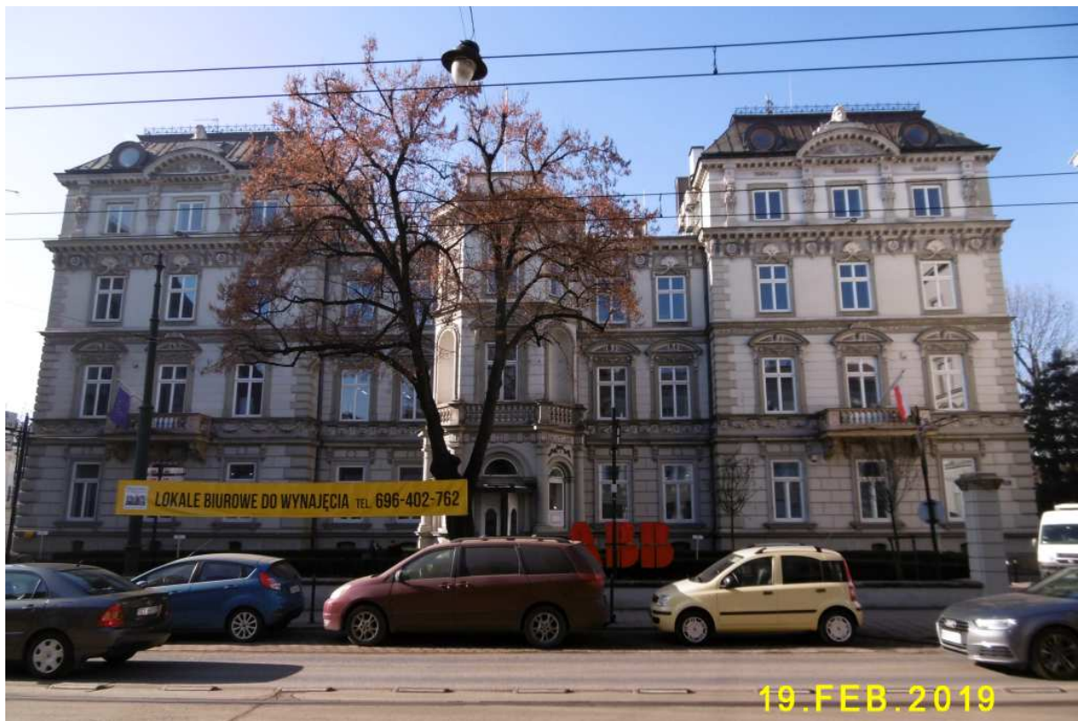
Fot. nr 177 (177-179). Pałac Pugetów przy ulicy Starowiślnej 13.
