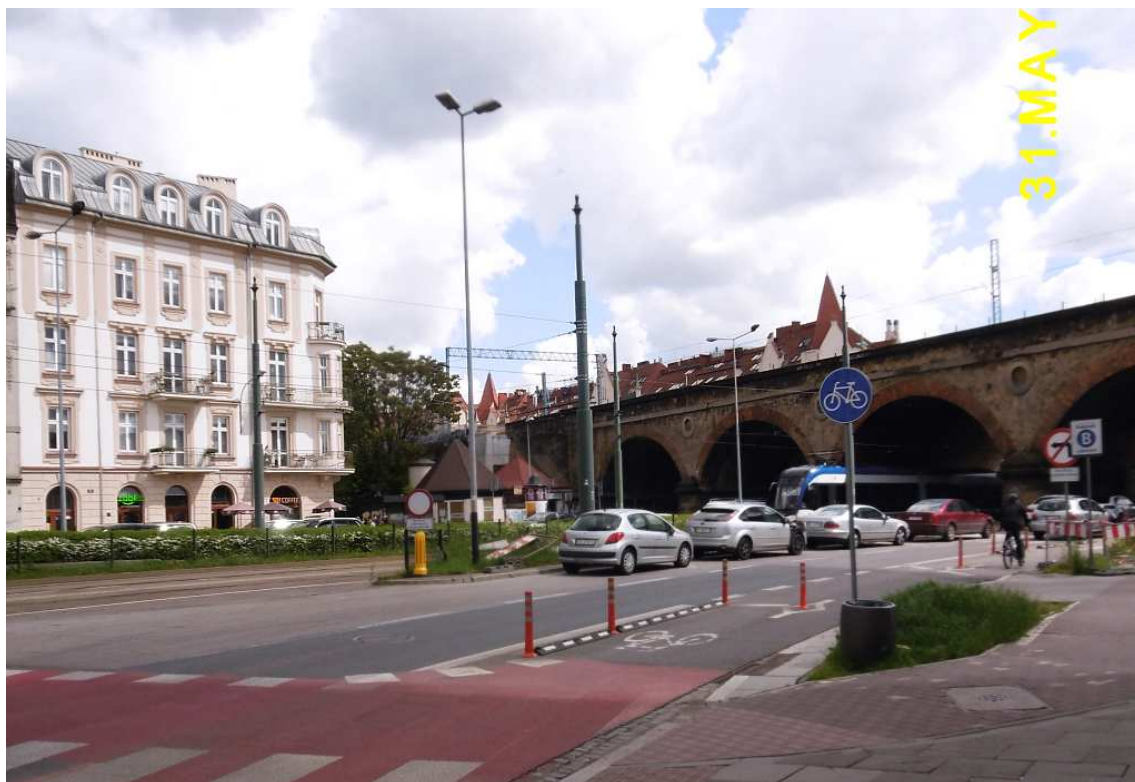
Fot. nr 261. Poszerzony wiadukt kolejowy pomiędzy ulicami: Dietla i Grzegórzecką
