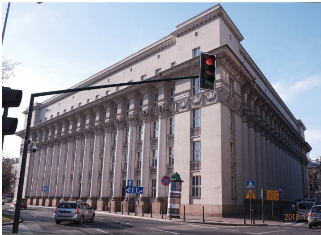
Fot. nr 236 (236-237). Opuszczony przez PKO gmach przy ulicy Wielopole 19-21. Co zastaniemy tu za kilka lat? Widok z ulicy Dietla.
