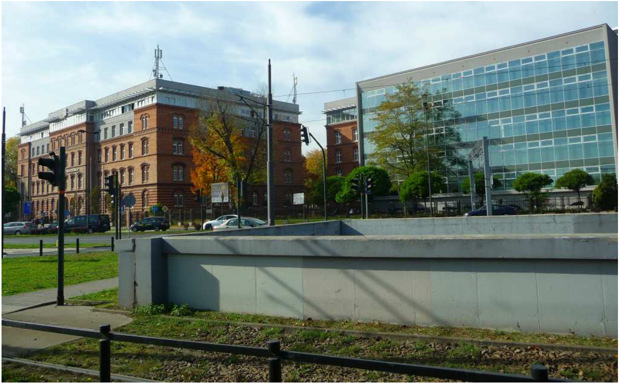
Fot. nr 1a. Fragment ulicy Warszawskiej z zabudowaniami PK. (18.10.2018)
