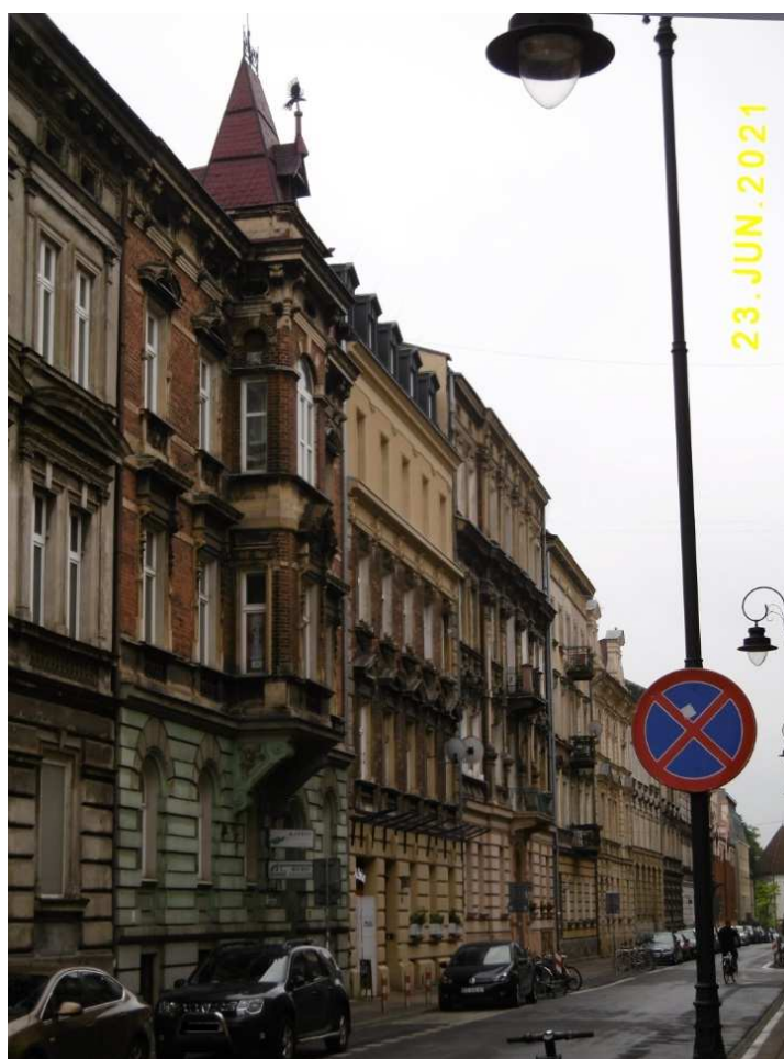
Fot. nr 350. Widok ulicy Radziwiłłowskiej. Ujęcie z ulicy Zamenhofs w stronę ulicy Kopernika.
