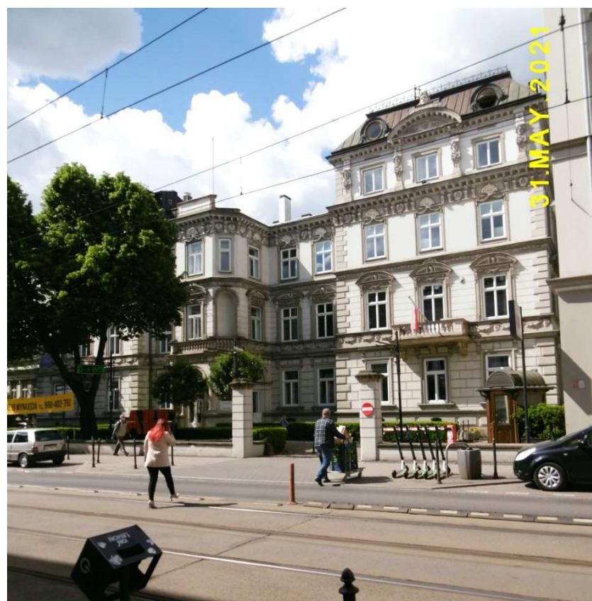
Fot. nr 254 (254-255). Fasada pałacu spod nr 13.
