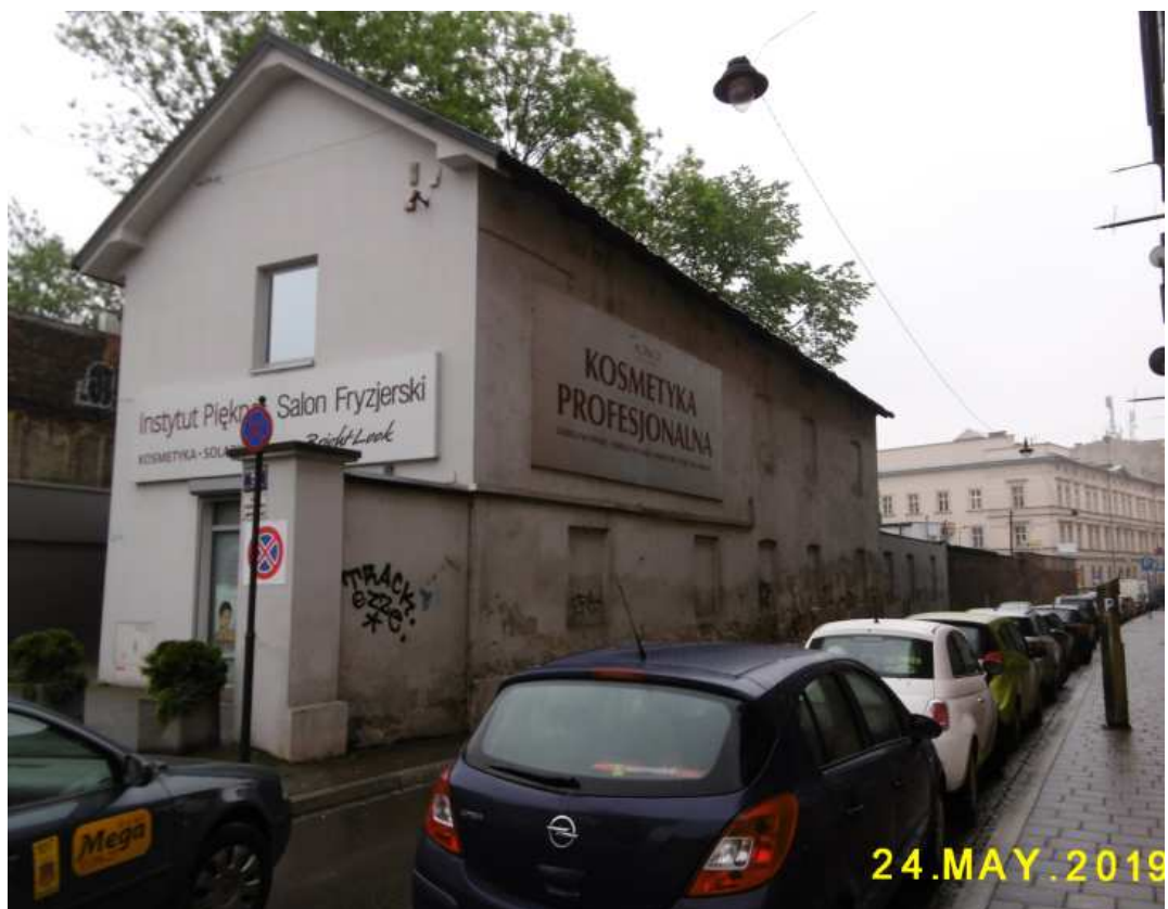
Fot. nr 35. Zabudowa końcowego odcinka ulicy Zacisze.
