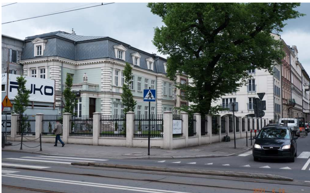
Fot. nr 318. Wyremontowany pałacyk z naroża ulic: Lubicz 42 i Ariańskiej 2. Powstał w latach: 1879-87 wg projektu Adolfa Opida.
