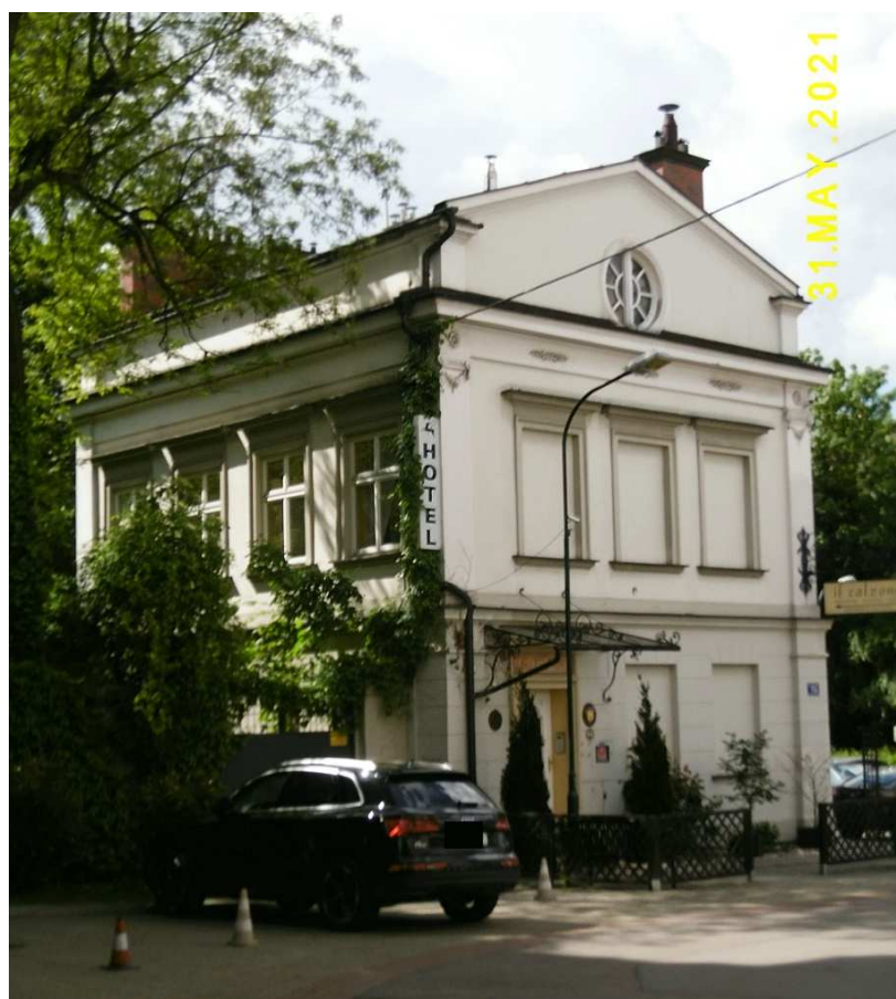
Fot. nr 256. Tylna część lewej oficyny pod nr 15a.
