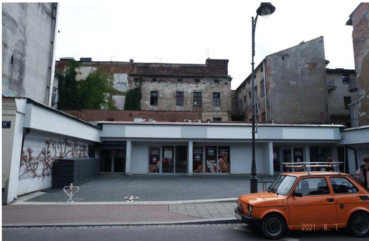
Fot. nr 106. Niska zabudowa i oficyny na tyłach posesji przy ulicy św. Filipa 14.
