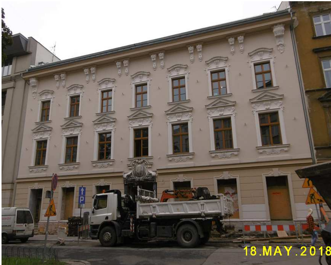
Fot. nr 126. Odnowiona po pożarze dyskoteki kamienica pod nr 15.
