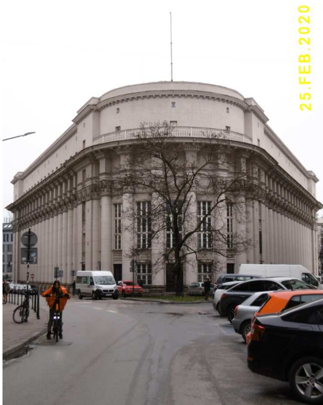
Fot. nr 239. Opuszczony gmach PKO przy ulicy Wielopole 19-21.
