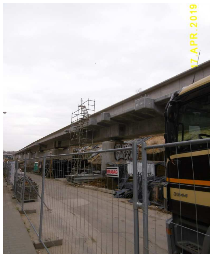
Fot. nr 211. Rozbudowa toru kolejowego w stronę Płaszowa – widok wzdłuż ulicy Blich.
