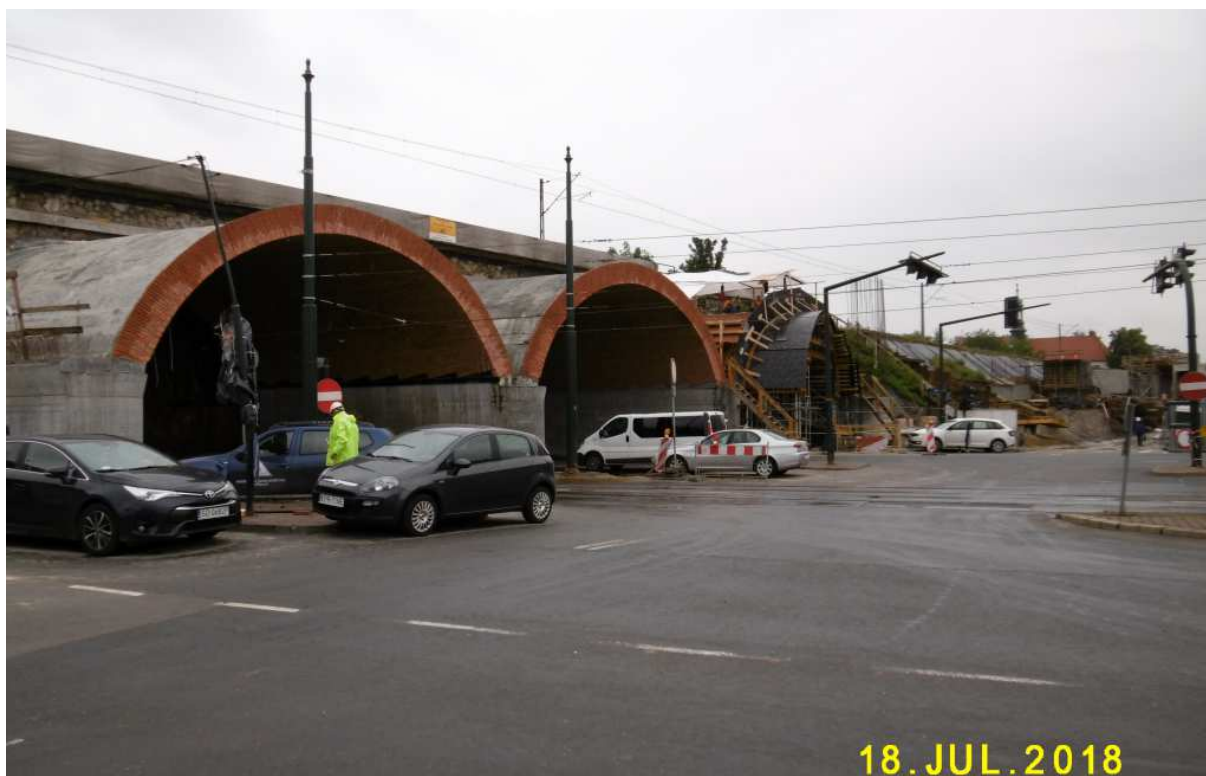
Fot. nr 162 (162-163). Rozbudowa ponad 150-letniego wiaduktu kolejowego nad ulicą Grzegórzecką.
