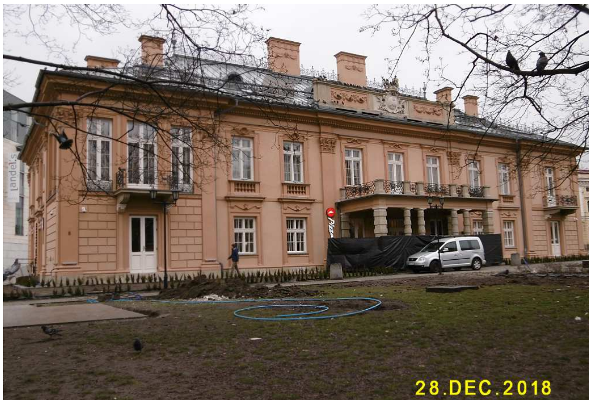
Fot. nr 180 (180-181). Pałac Wołodkowiczów z ulicy Lubicz 4 tuż po remoncie.
