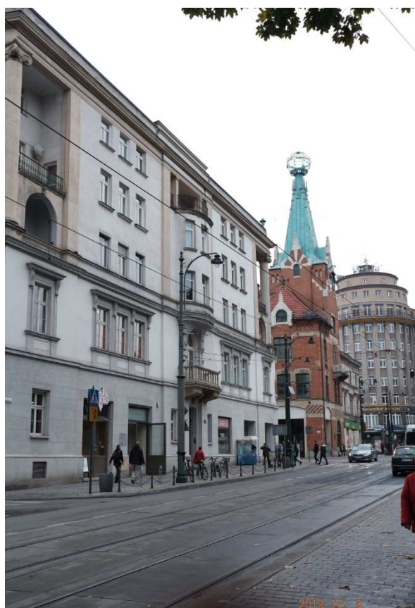
Fot. nr 65. Widok z ulicy Basztowej.
