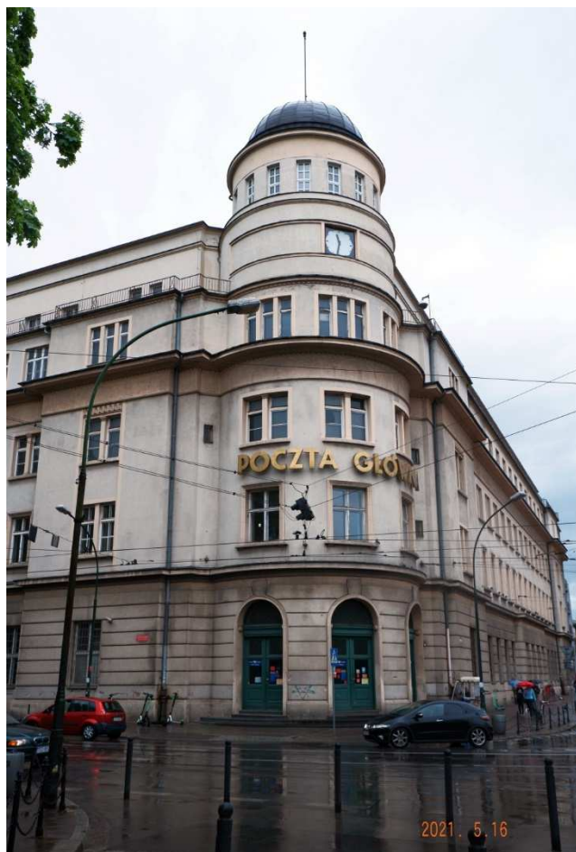
Fot. nr 264. Narożna wieża gmachu Poczty Głównej.
