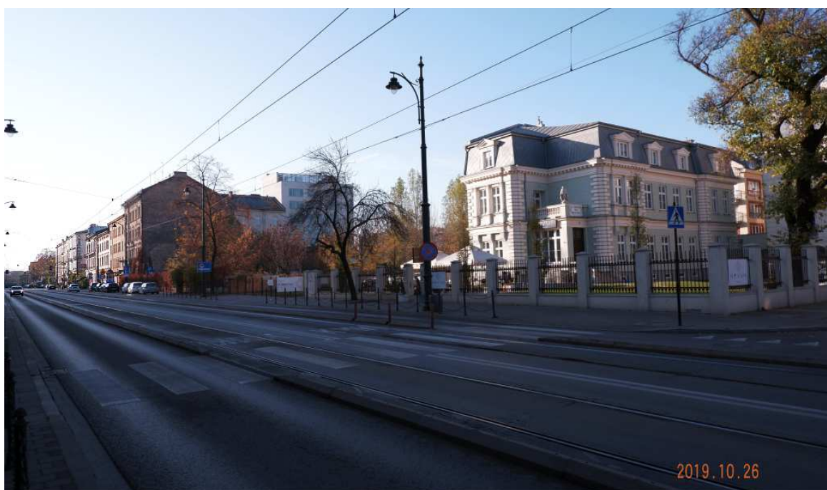
Fot. nr 227 (227-235). Wzdłuż ulicy Lubicz. Fragment zabudowy poniżej ulicy Ariańskiej. Pośrodku zakrzaczone poletko dawnego ogrodu firmy Freege.
