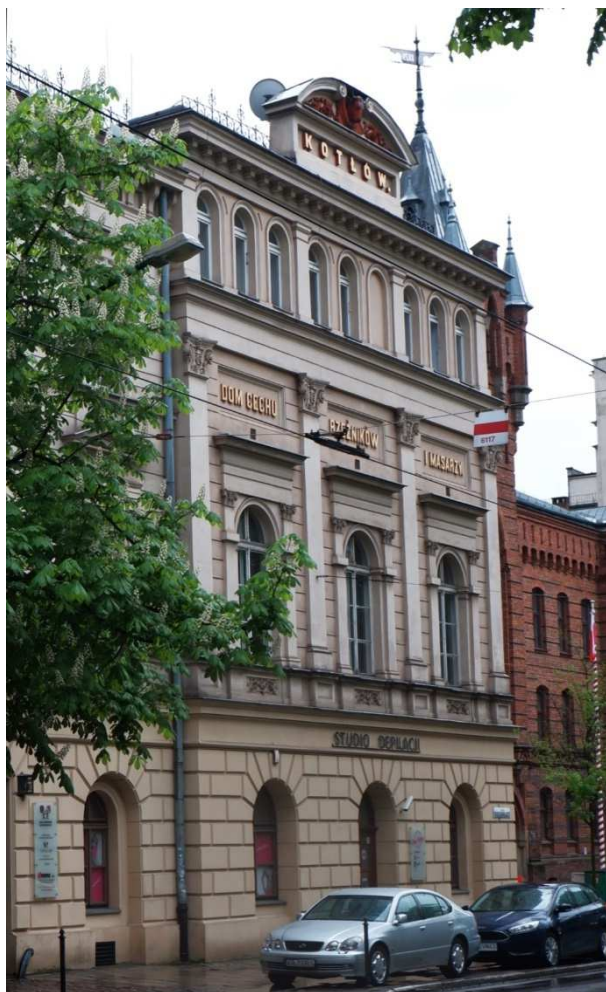
Fot. nr 269. Ryzalit w fasadzie budynku „Na Kotłowym” pod nr 18. (16.05.2021)
