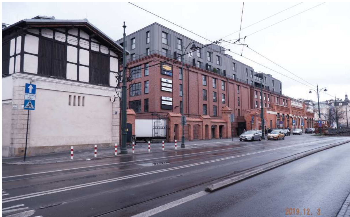
Fot. nr 234. Gigantyczne blokowisko pod nr 17, które powstało w miejscu krakowskiego browaru.
