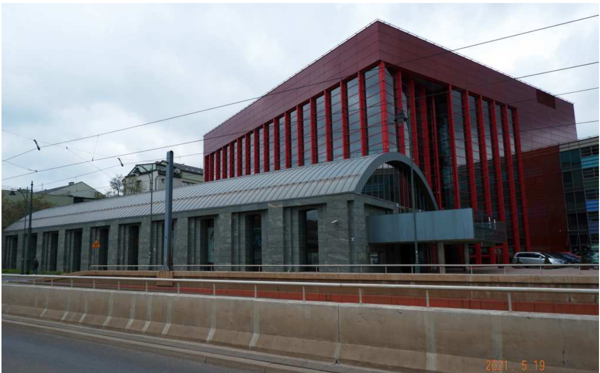
Fot. nr 316. Współcześnie wylukrowany budynek Operetki w dawnym Domu Żołnierza
