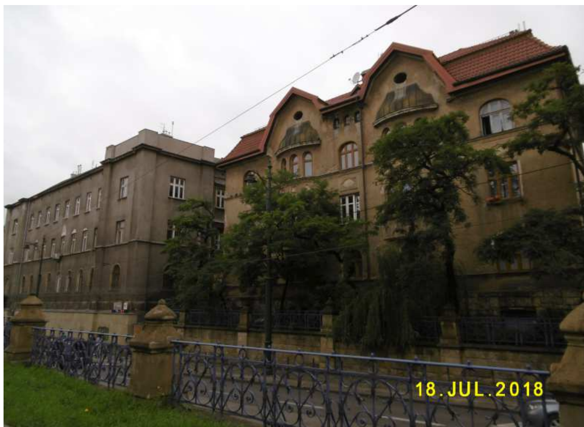
Fot. nr 145. Budynki kolejowe przy ulicy Lubicz 10-12.
