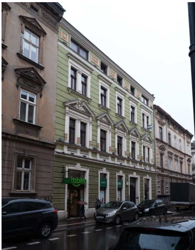
Fot. nr 286. Odnowiona kamienica przy ulicy Radziwiłłowskiej 27. (16.05.2021)
