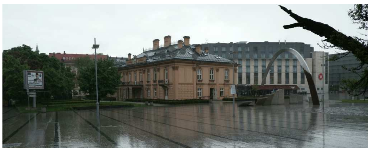
Fot. nr 290 (290-291). Pałac Wołodkowiczów przy ulicy Lubicz 4. (16.05.2021)
