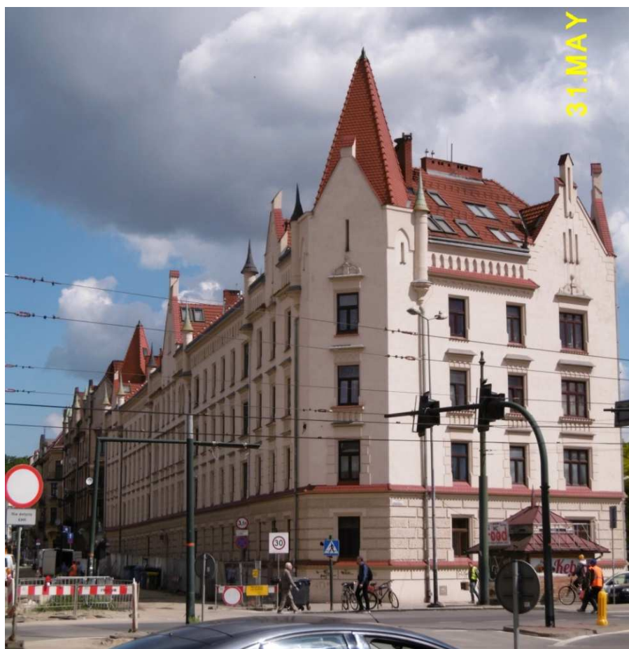
Fot. nr 262. Neogotyckie kamienice C.K. urzędników kolei przy ulicy Blich: 7-9.
