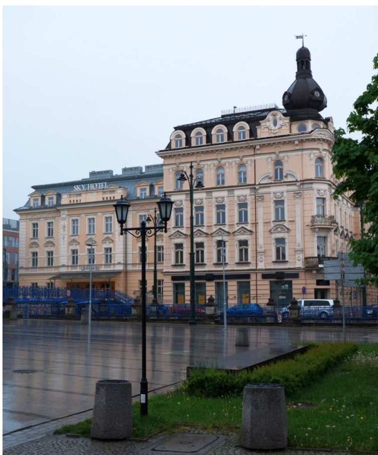
Fot. nr 288. Odnowione kamienice przy ulicy Lubicz: 7 i 9. (16.05.2021)
