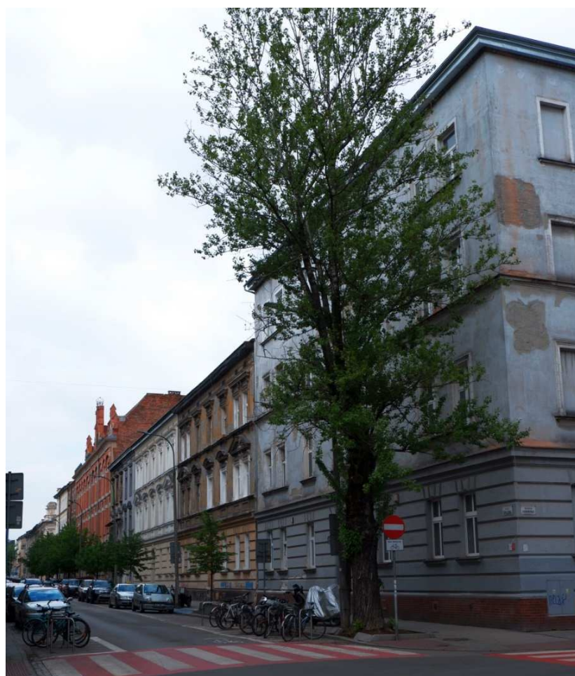
Fot. nr 308. Ulica Topolowa w ujęciu z ulicy Ariańskiej. (19.05.2021)
