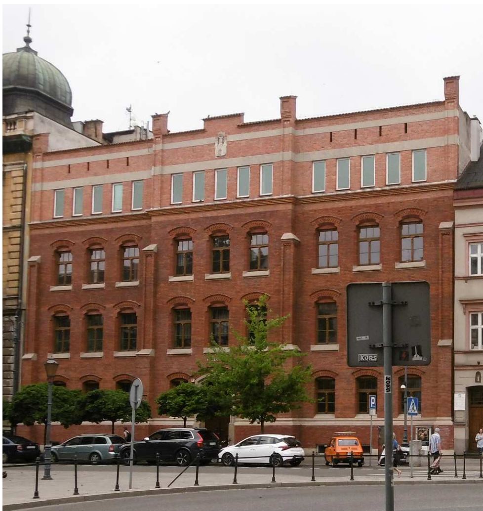
Fot. nr 90. Budynek szkolny spod nr 2. (23.06.2021)
