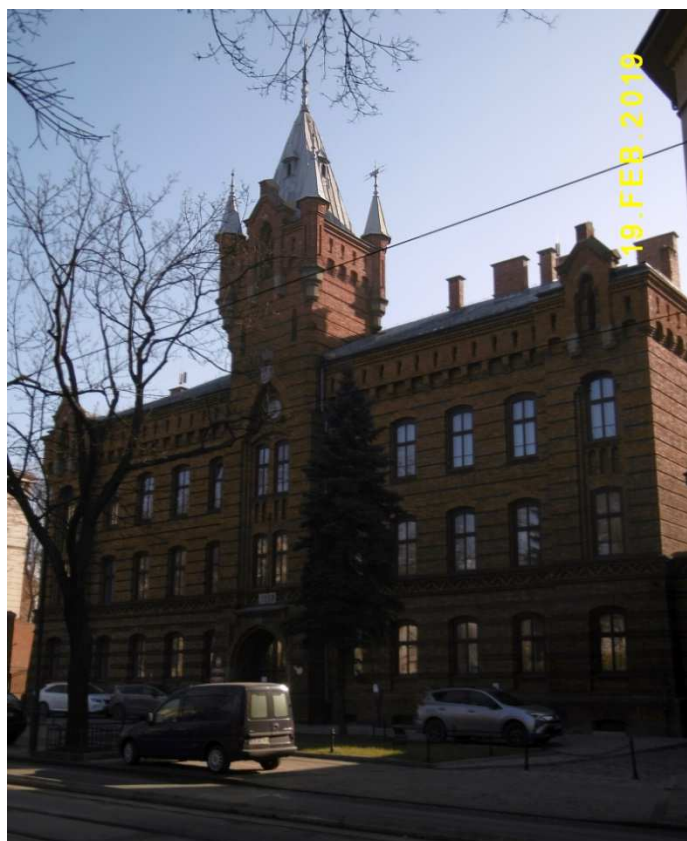
Fot. nr 169 (169-170). Budynek Straży Pożarnej pod nr 19.
