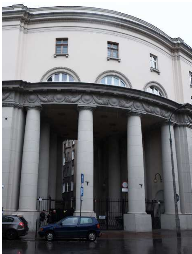
Fot. nr 279. Kolumnowa brama przy wejściu na podwórkę. (16.05.2021)
