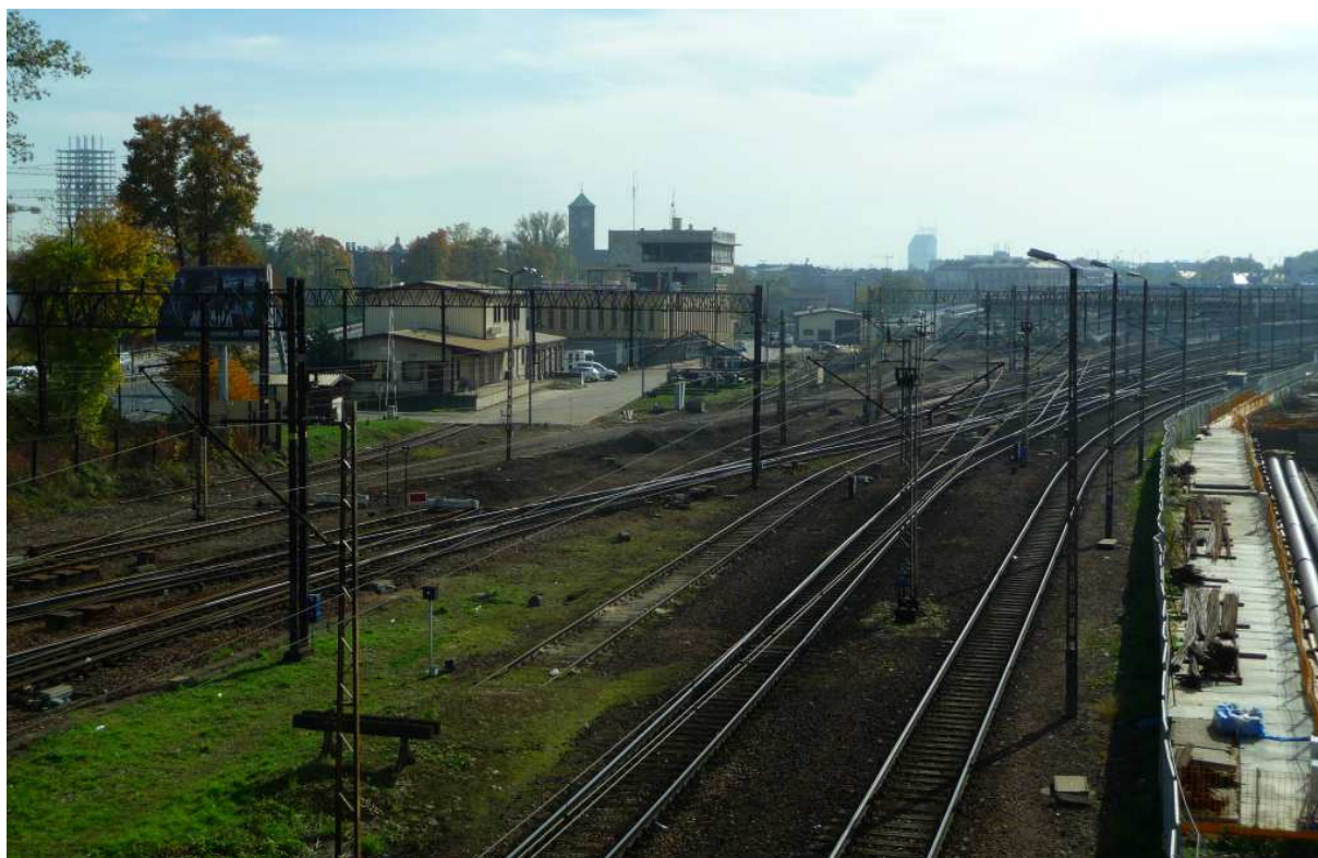
Fot. nr 121. W stronę Wesołej – widok z wiaduktu nad ulicą Warszawską. (18.10.2017)
