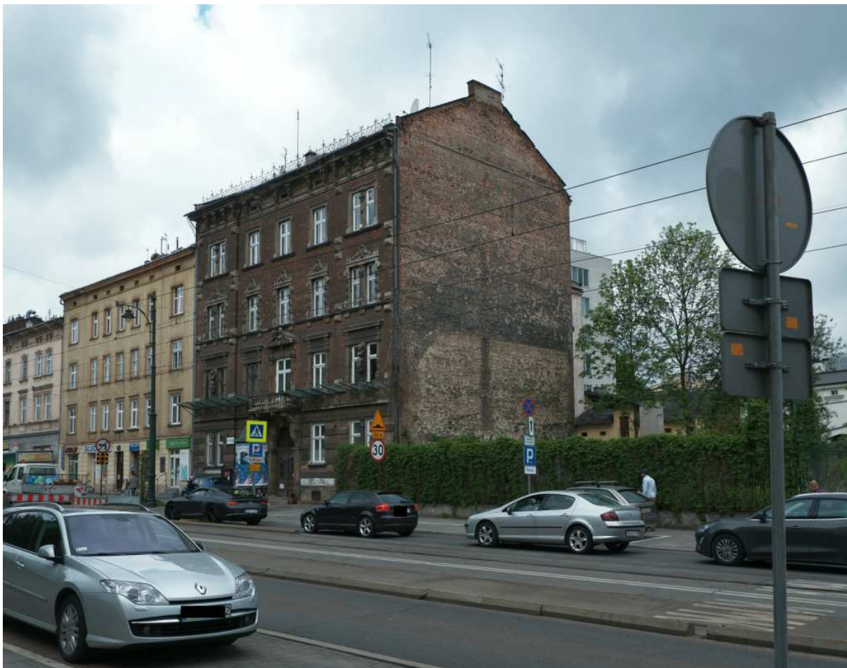
Fot. nr 320. Fragment zabudowy o numerach: 30-34. Pierwsza z prawej (nr 34) to kamienica Bujwidów, wybudowana w ostatniej dekadzie XIX wieku. (19.05.2021)
