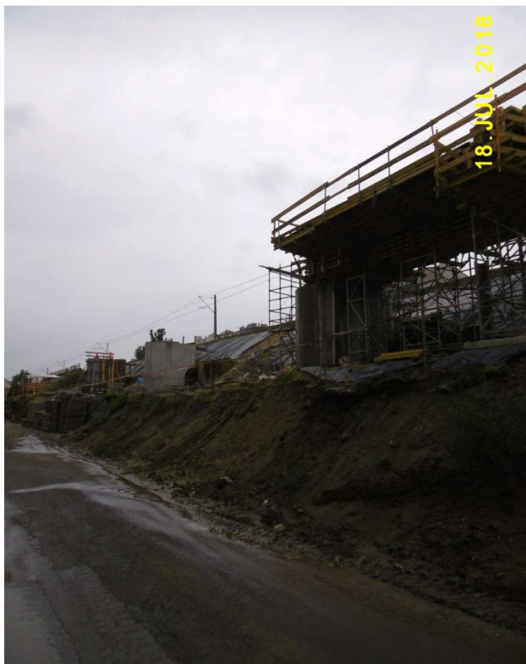
Fot. nr 160 (160-163). Trwa przebudowa nasypu kolejowego wzdłuż ulicy Blich.
