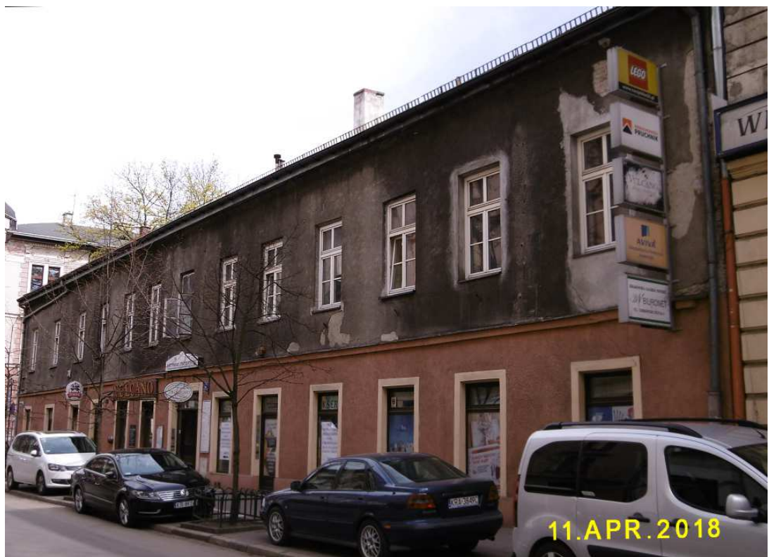
Fot. nr 127. Kolejny relikw niskej zabudowy Wesołej, tym razem z ulicy Librowszczyzna 3, który niebawem może zniknąć.
