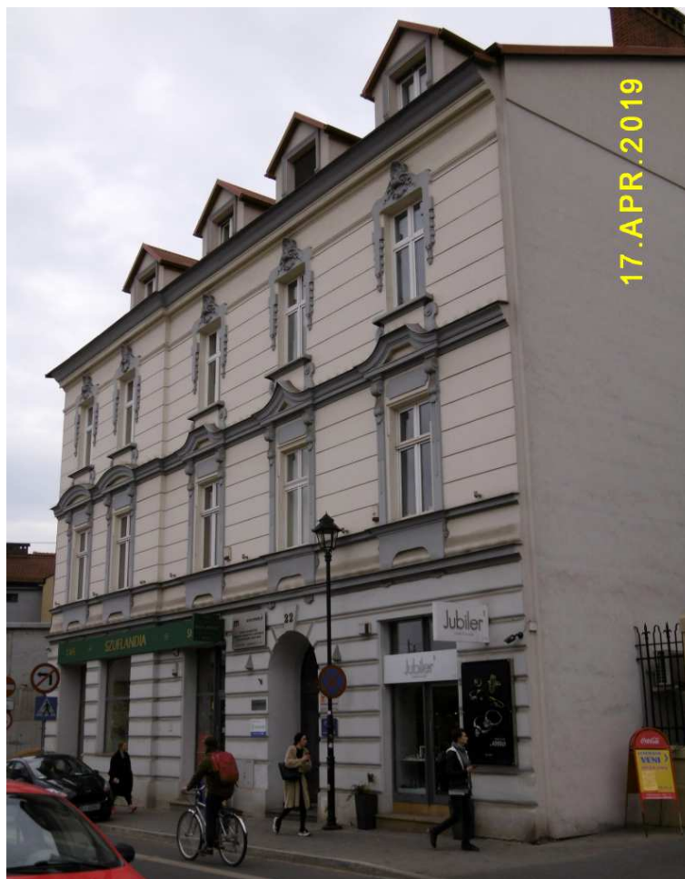
Fot. nr 208. Odnowiona kamienica pod nr 22.
