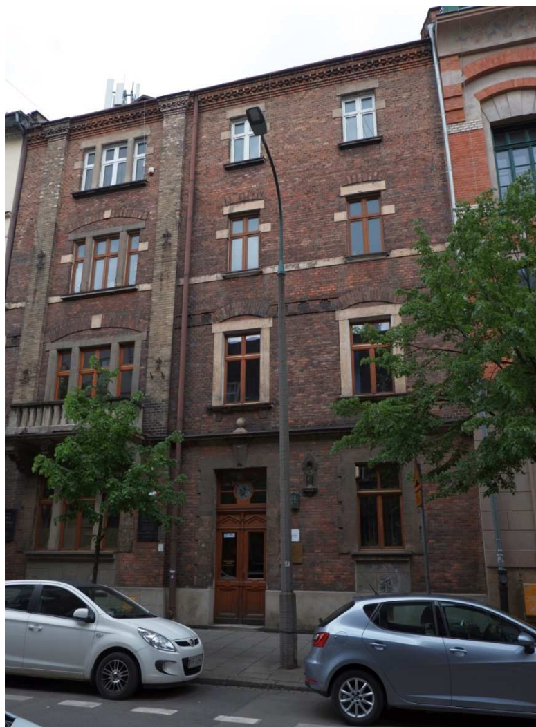
Fot. nr 303 (303-307). Kamienica przy ulicy Topolowej 18 autorstwa Jana Sasa-Zubrzyckiego i detale jej fasady. (19.05.2021)
