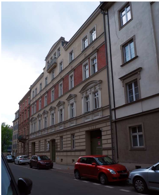
Fot. nr 309 (309-311). Zabudowa ulicy Ariańskiej. Odnowiona i podwyższona kamienica pod nr 6. (19.05.2021)
