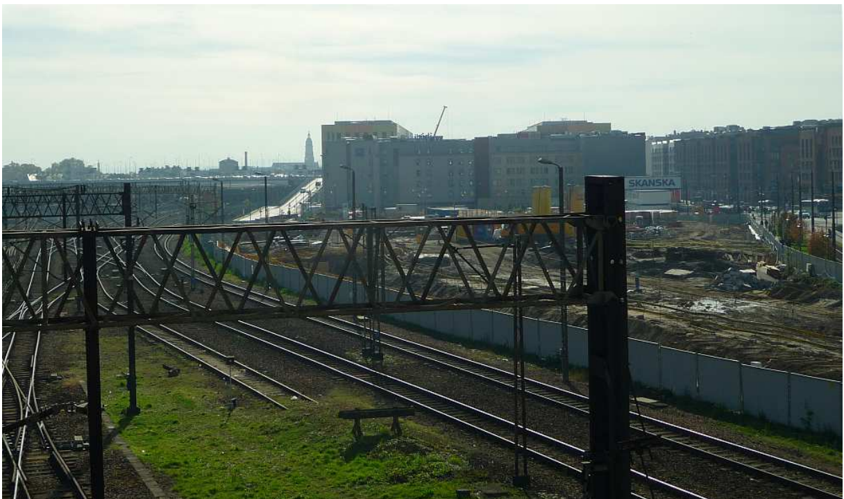
Fot. nr 2. Widok z wiaduktu nad ulicą Warszawską w stronę zabudowań ulicy Pawiej. (18.10.2018)
