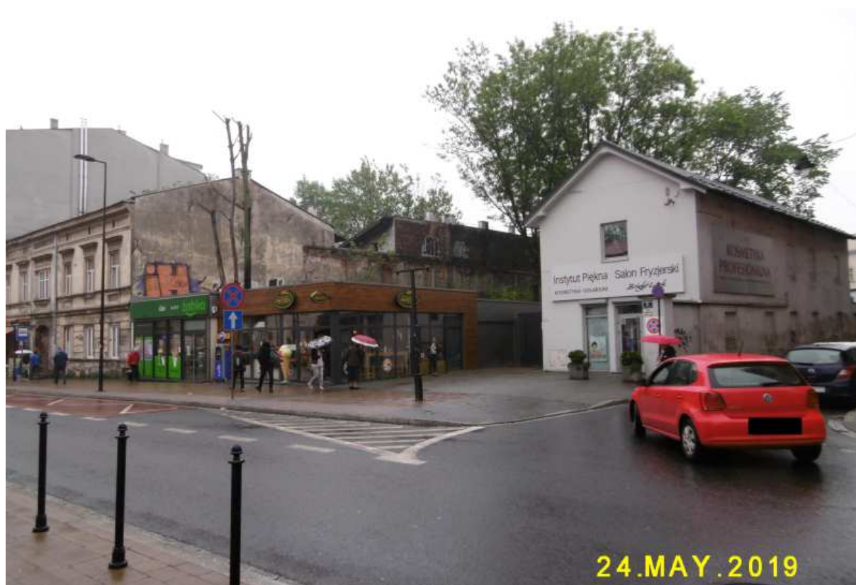
Fot. nr 34. Jak długo przetrwają te niskie budynki?
