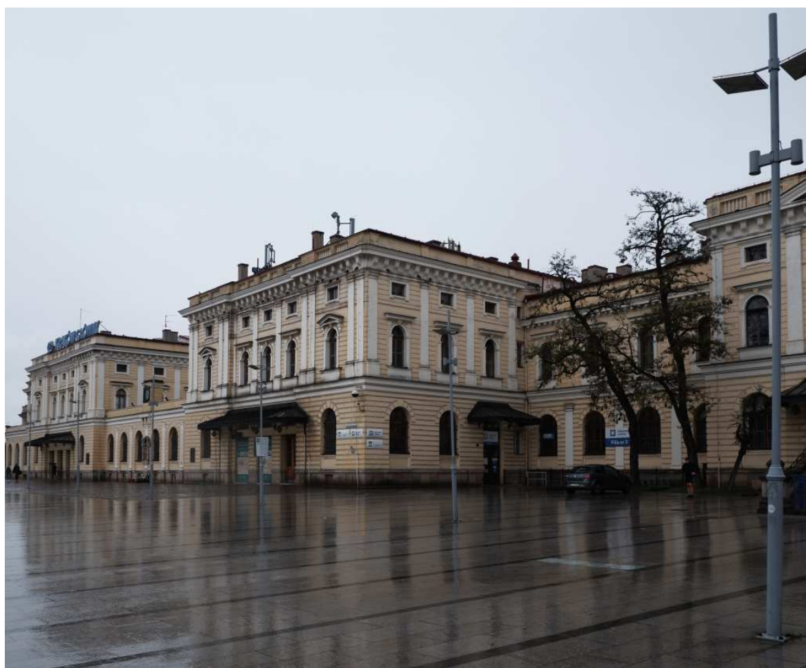
Fot. nr 292 (292-294). Dawny gmach Dworca Głównego (16.05.2021)
