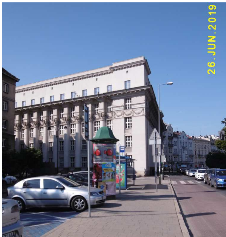
Fot. nr 214(214-215). Opuszczony gmach PKO z ulicy Wielopole 15 od strony ulicy Dietla.
