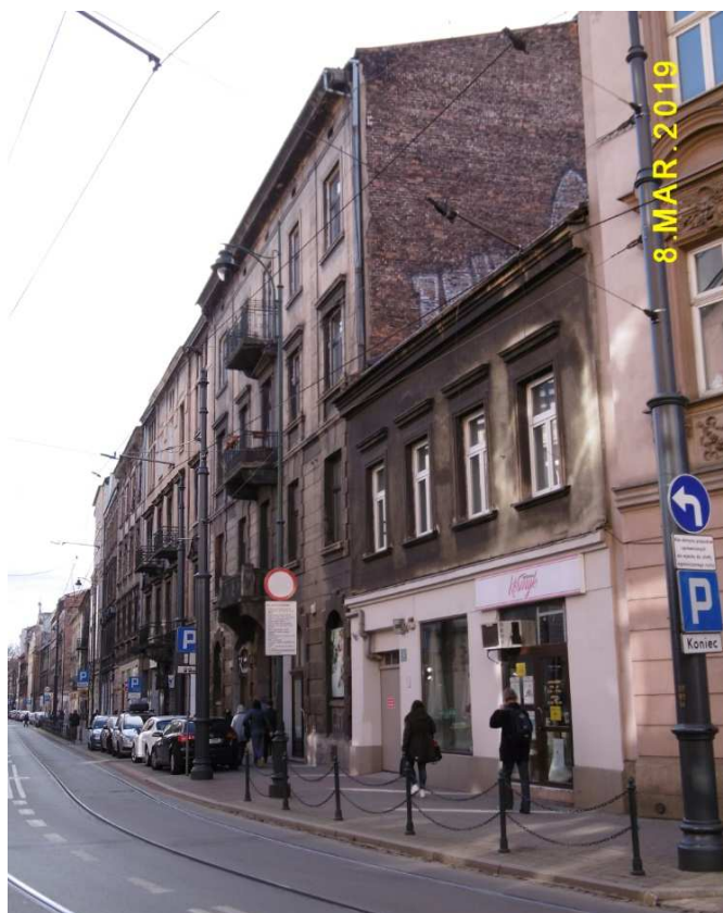
Fot. nr 47 (47-53). Wzdłuż ulicy Długiej. Tu widok w stronę ulicy Basztowej.
