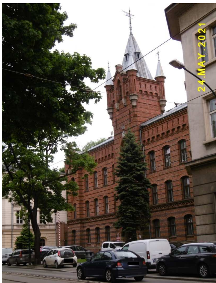
Fot. nr 266 (266-267). Budynek Straży Pożarnej pod nr 19.
