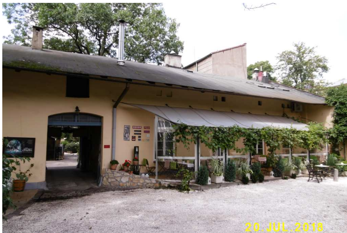
Fot. nr 134. Widok od strony podwórka.
