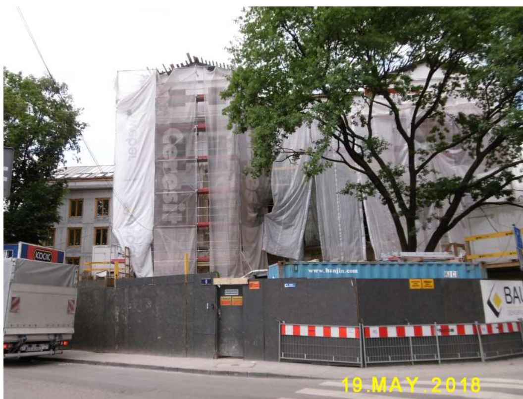
Fot. nr 323. Widok z placu Kossaka.
