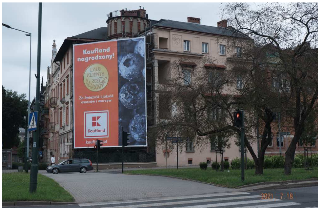
Fot. nr 395. Kamienica własna Władysława Ekielskiego z naroża alei Krasieńskiego 25 i Piłsudskiego 40, powstała w roku 1899.
