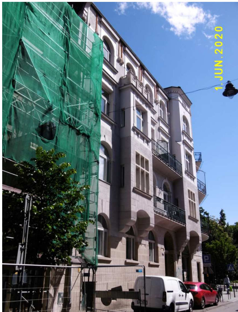
Fot. nr 61. Pełna jeszcze eklektycznego uroku kamienica pod nr 1.
