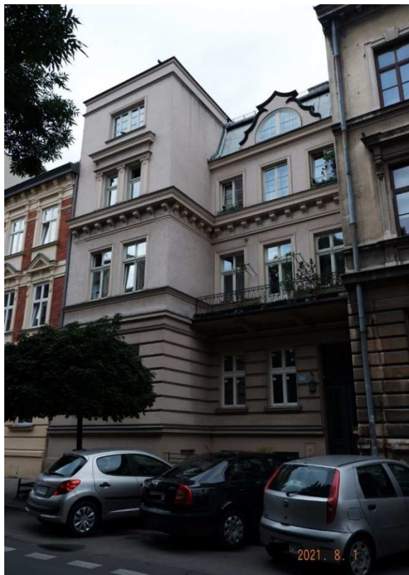
Fot. nr 278 (278-281). Powstała w roku 1895 kamienica z ulicy Sobieskiego 15.
