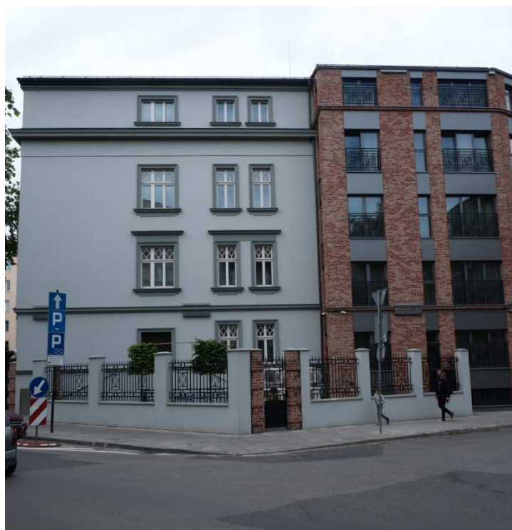
Fot. nr 372. Widok z ulicy Retoryka. (30.05.2021)
