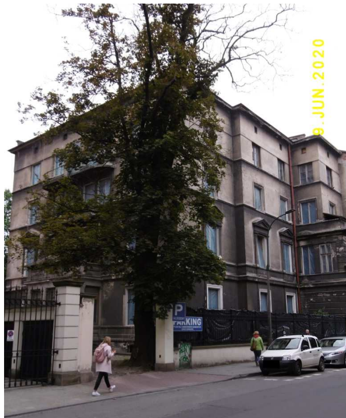
Fot. nr 19. W kamienicy pod nr 18 ciągle nie może ruszyć remont.
