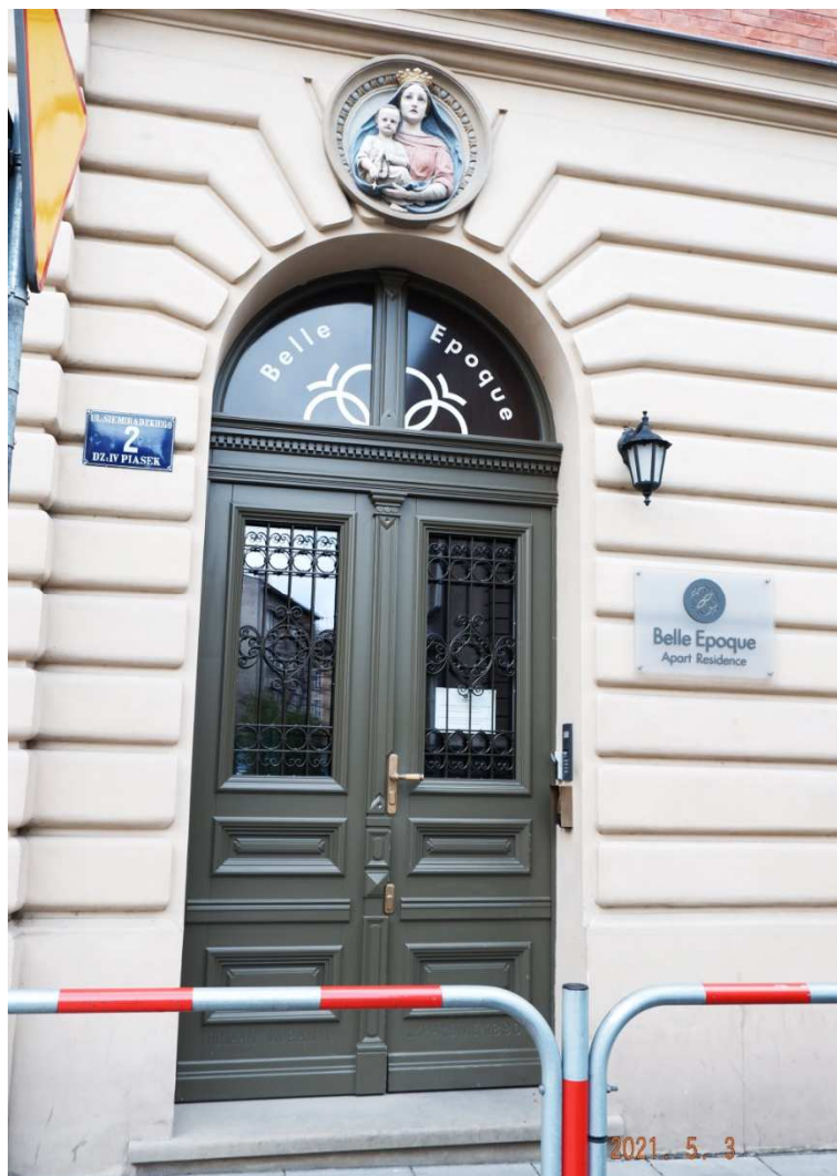
Fot. nr 182 (182-184). Oryginalne detale we fragmencie fasady od strony ulicy Siemiradzkiego 2. Pełne eklektycznego bogactwa drzwi.
