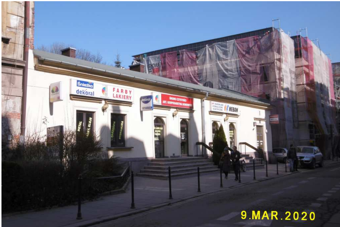
Fot. nr 66. Mocno zniekształcona już fasada parterowego domu spod nr 11.
