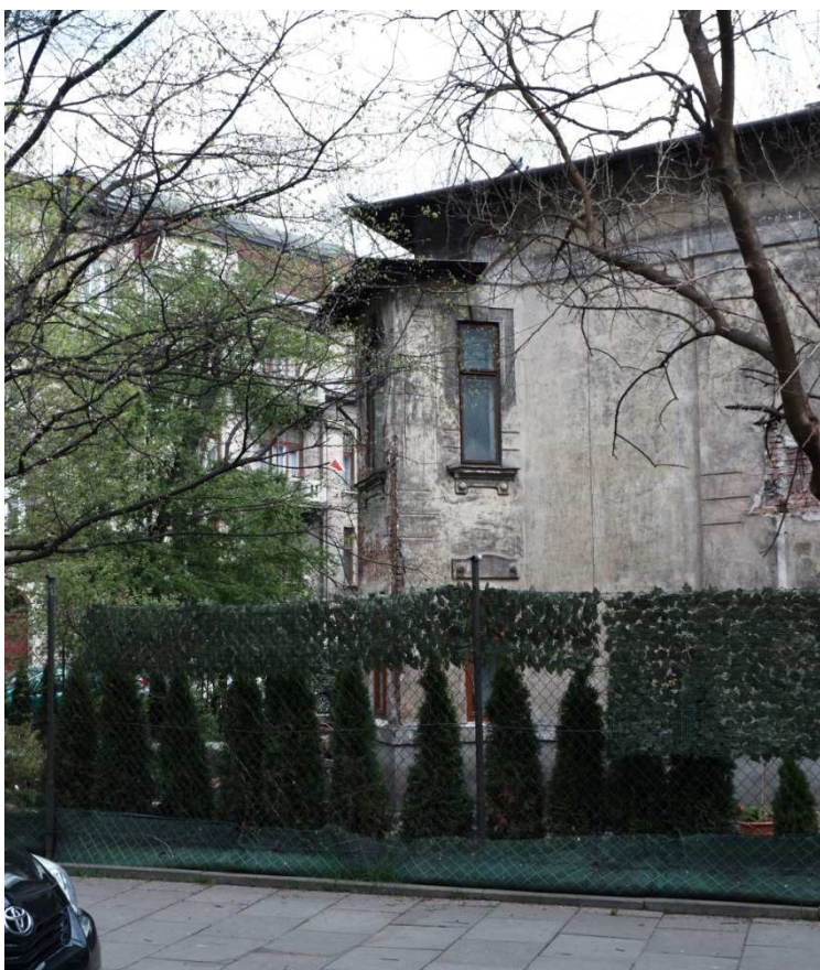
Fot. nr 143 (143-144). Narożny wykusz z oryginalnymi jeszcze oknami I piętra. (03.05.2021)
