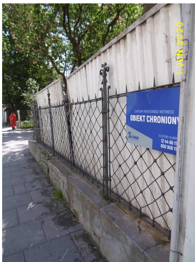
Fot. nr 91. Po dawnej, secesyjnej willi dr Kupczyka, która stała tu do połowy lat 30. zeszłego wieku, zostało tylko ogrodzenie. Ciekawe czy przetrwa?
