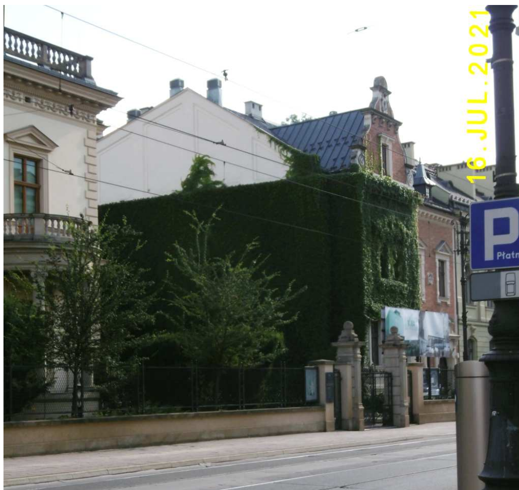
Fot. nr 396. Zielony płaszcz fasady domu przy ulicy Piłsudskiego 14, który został wybudowany w roku 1888 wg projektu Władysława Ekielskiego i Tadeusza Stryjeńskiego.
