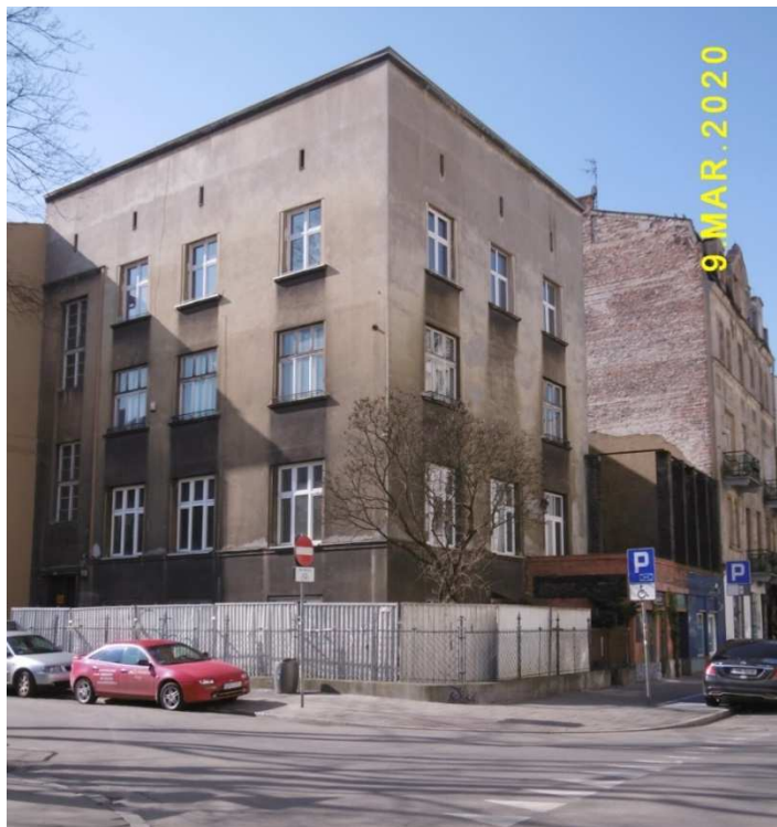
Fot. nr 83 (83-91). Kamienica spod nr 16/Szujskiego 11 na etapie przebudowy.
