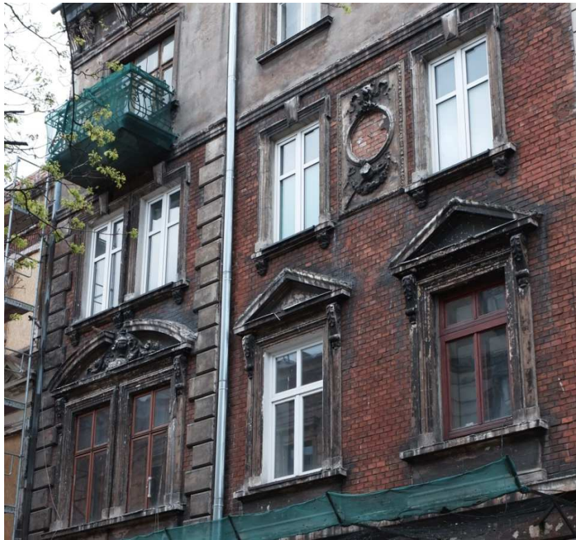
Fot. nr 188. Oryginalne dwa okna trwają jeszcze w lewej części pierwszego piętra. (03.05.2021)
