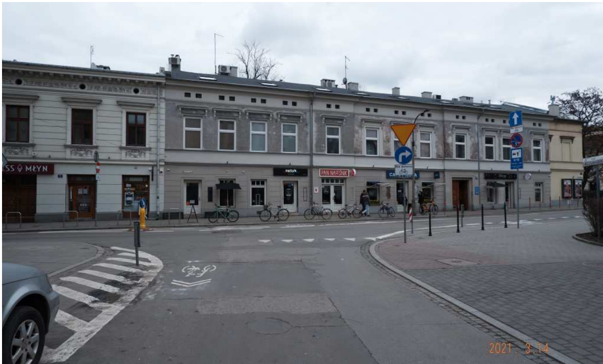
Fot. nr 108. Niska, XIX-wieczna zabudowa ulicy Dolnych Młynów we fragmencie o nr: 1-5.
