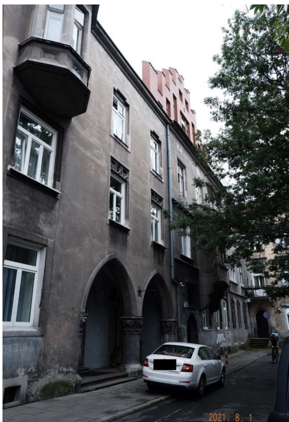
Fot. nr 281. Kamienica pod nr 16b, a w głębi budynek pod nr 16c.
