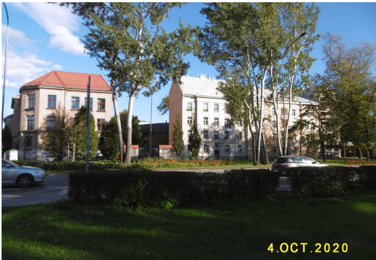
Fot. nr 99 (99-101). Wzdłuż alei Mickiewicza. Z prawej kamienice pod nr: 13-17.
