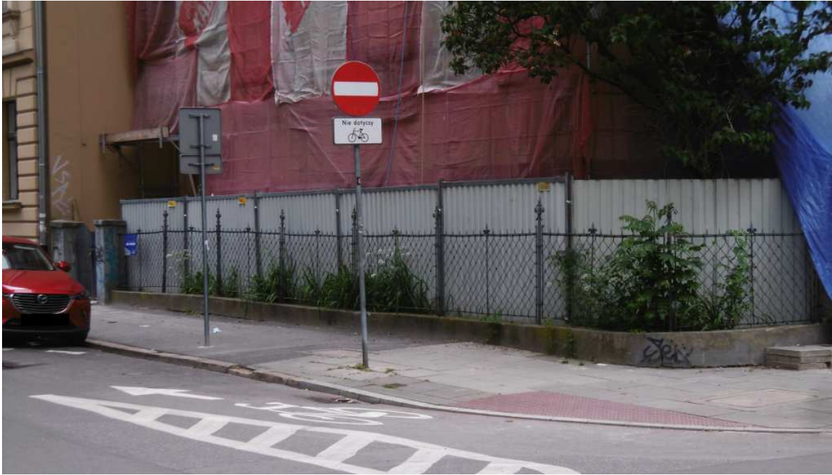
Fot. nr 152. Po dawnej, secesyjnej willi dr Bernarda Kupczyka, gdzie mieściło się sanatorium, która została tu wybudowana na początku XX wieku, pozostało tylko ogrodzenie. Czy choć ten detal przetrwa? (13.06.2021)
