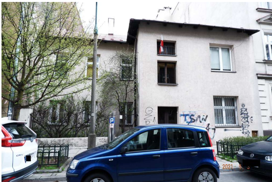
Fot. nr 194 (194-195). Znacznie zniekształcona już fasada domu z ul. św. Teresy 8, który w sposób typowy dla zabudowy z II połowy XIX jest nieco cofnięty w stosunku do ulicy.
