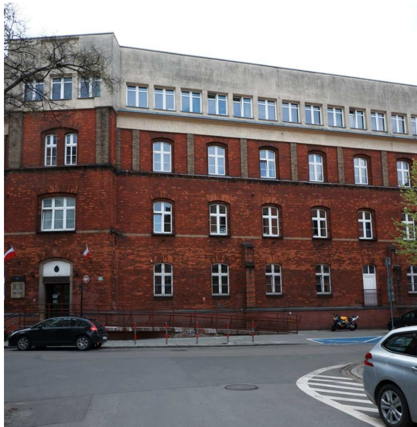
Fot. nr 219. Nadbudowa, która zniszczyła oryginalny kształt fasady.
