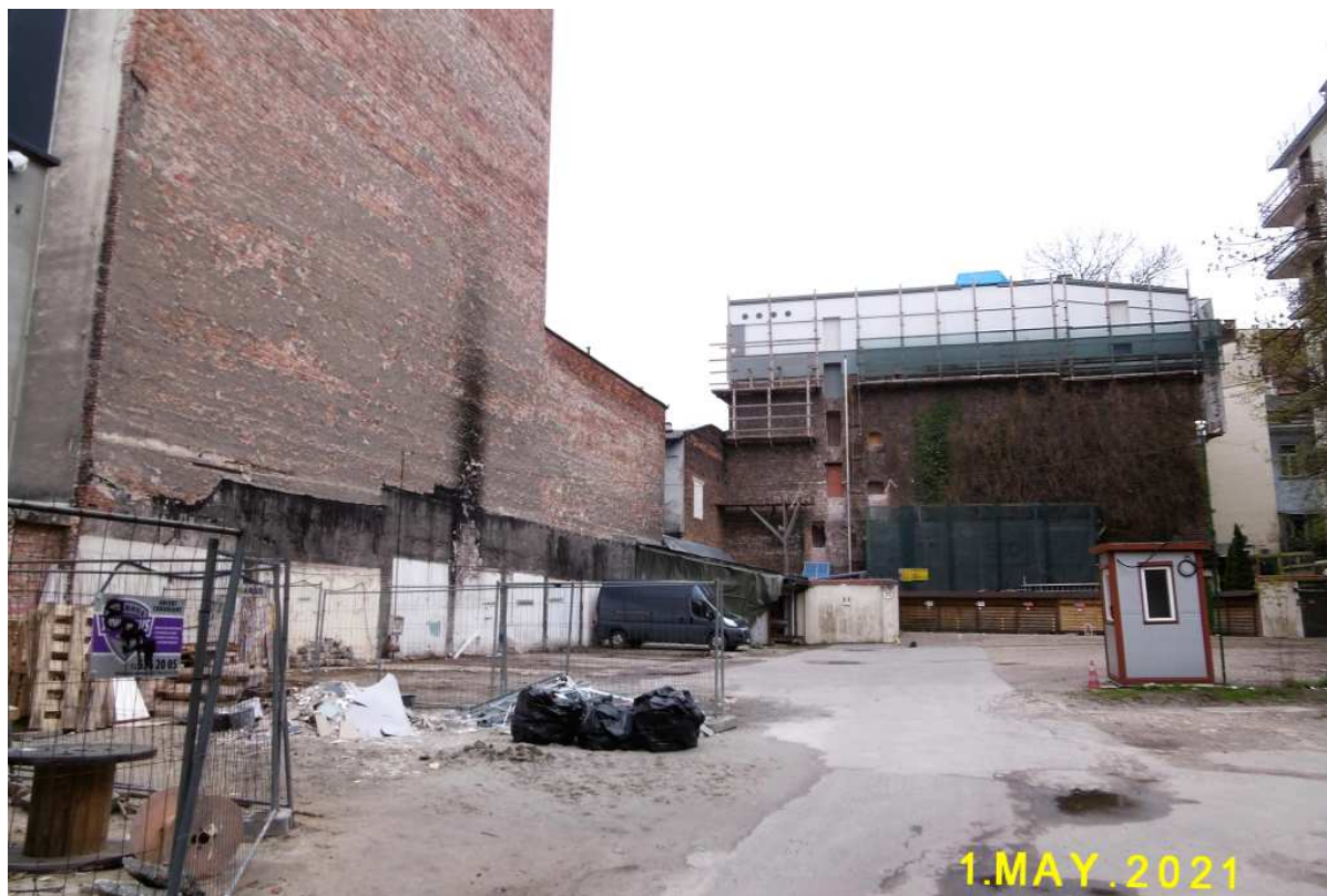
Fot. nr 162 (162-163). Nie ustają prace budowlane na rozległym, zielonym podwórku, ograniczonym zabudową ulic: Karmelickiej 13-17 i Garbarskiej 18-26.
