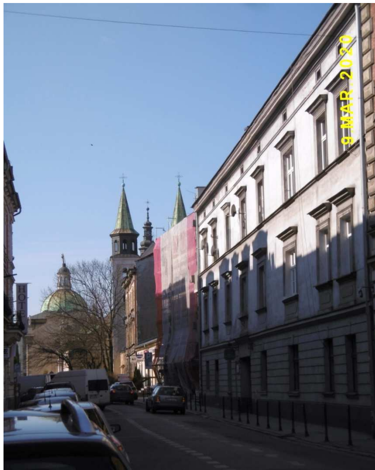
Fot. nr 67. Fragment zabudowy powyżej nr 7.
