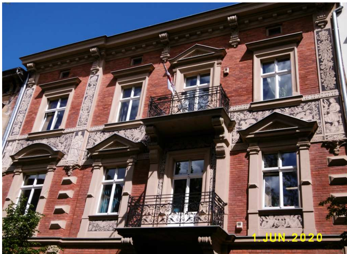
Fot. nr 50 (50-51). Niedawno odnowiona dekoracja sgraffitowa.
