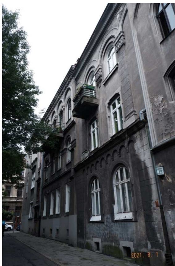
Fot. nr 279 (279-281). Zabudowa wnętrza w ulicy Sobieskiego pod nr: 14-16c, które wg GEZ powstały w latach 1911-12 wg projektu Ignacego Wentzla. Tu Kamienica pod nr 14.
