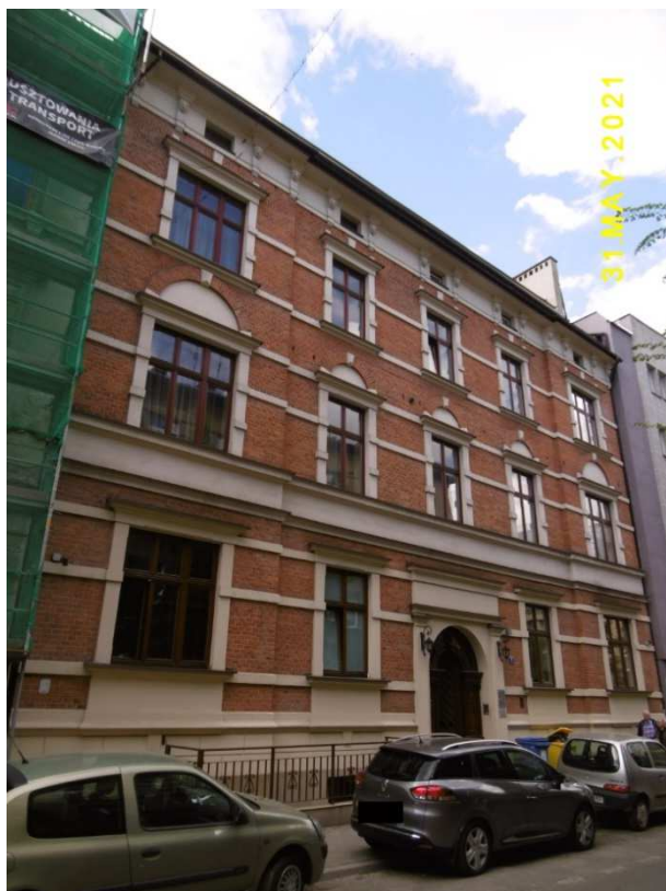
Fot. nr 383 (383-384). Wyremontowana kamienica z przełomu XIX i XX wieku z ulicy Zegadłowicza 4.
