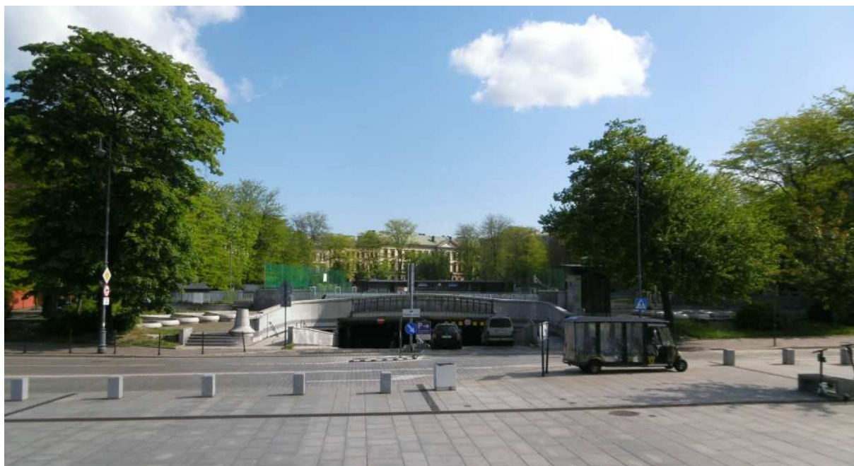
Fot. nr 361. Podziemny parking pod placem Na Groblach. (31.05.2021)
