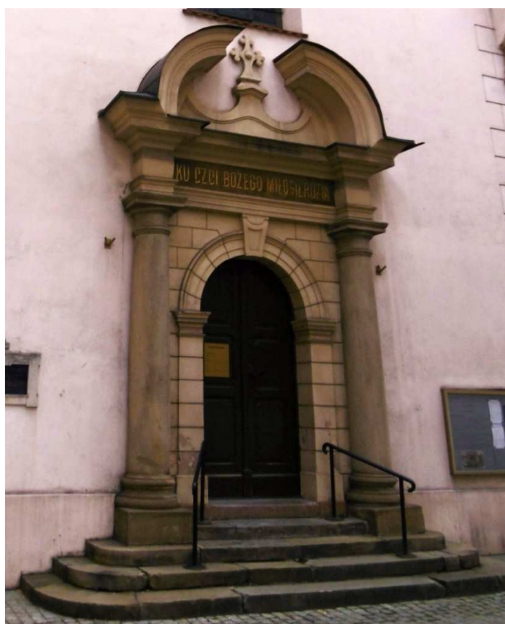
Fot. nr 386. Portal przy wejściu do kościoła.
