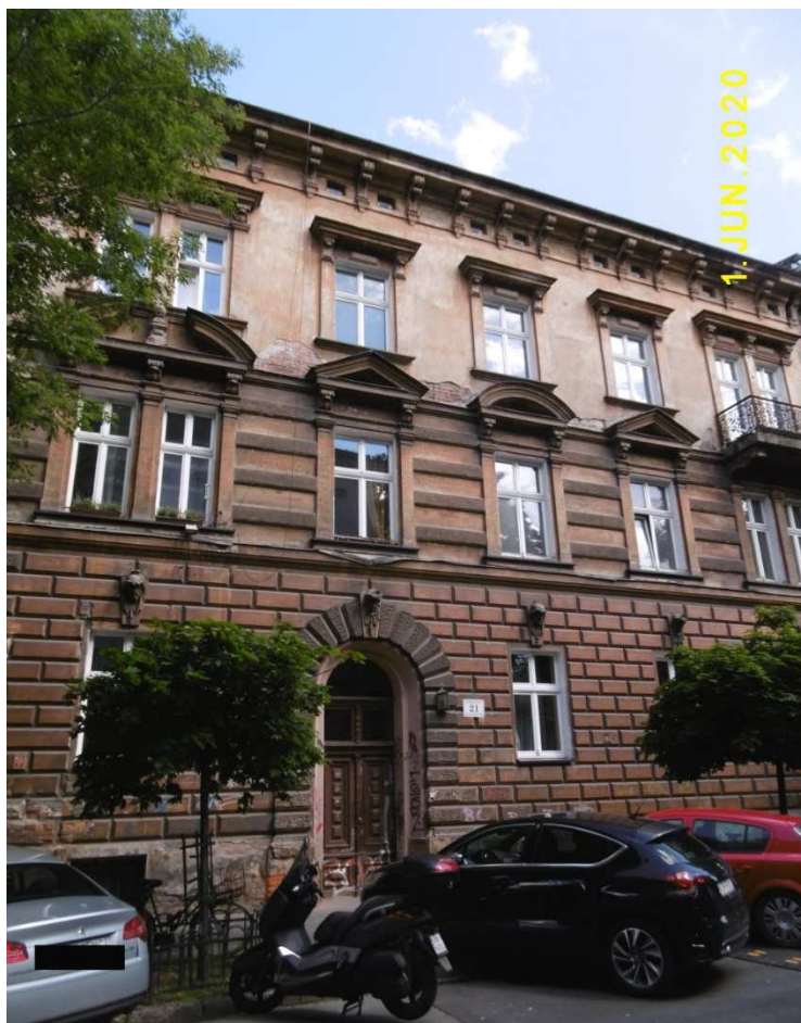
Fot. nr 46 (46-47). Kamienica pod nr 21, która czeka na renowację fasady.
