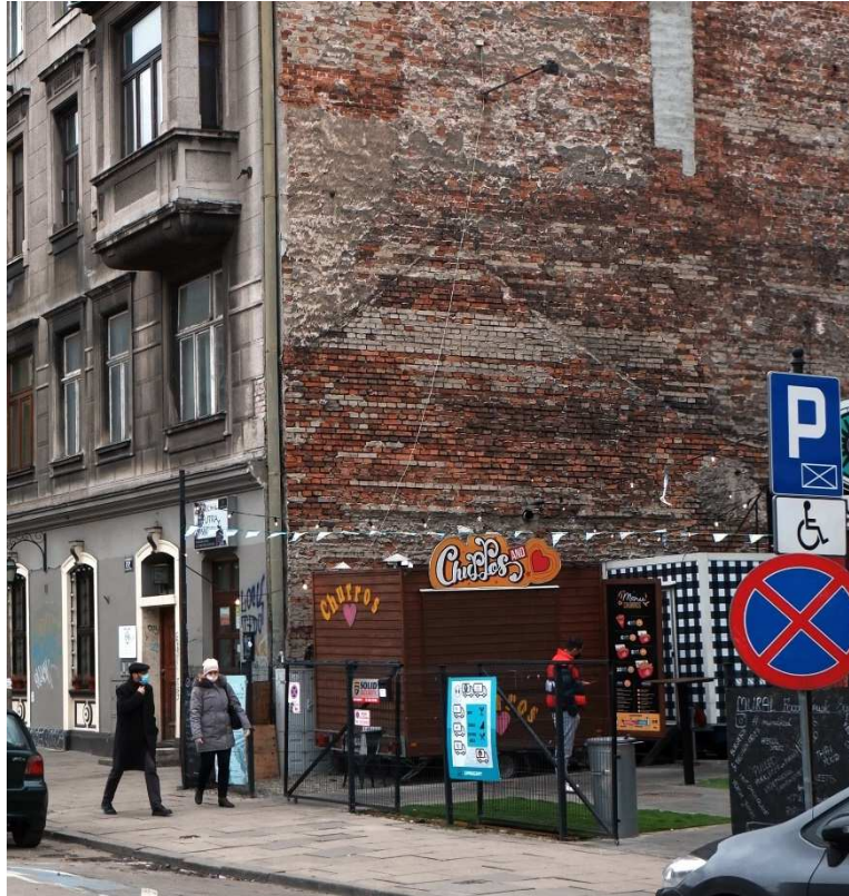
Fot. nr 106. Narys dachu parterowego domku Rzegocińskich spod nr 24, wyburzonego w roku 1980.
