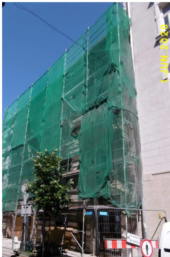
Fot. nr 59 (59-60). Dawna willa prof. W. Natansona pod nr 3 w trakcie remontu.
