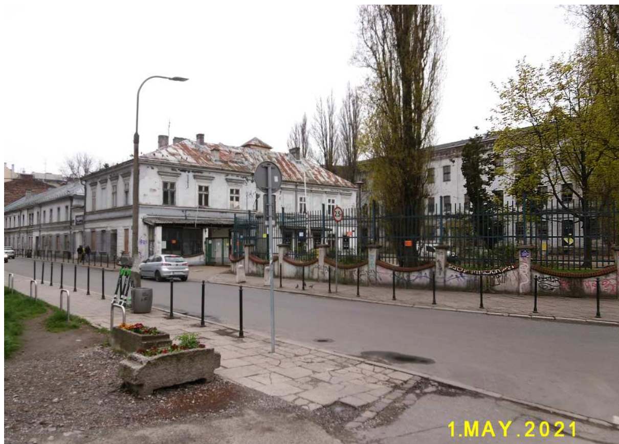
Fot. nr 125. Ujęcie od strony ulicy Czarnowiejskiej.
