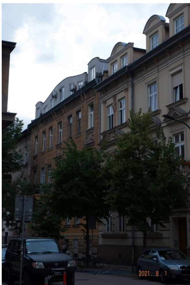
Fot. nr 277. Trudna do zaakceptowania nadbudowa kamienicy pod nr: 15 i 17.
