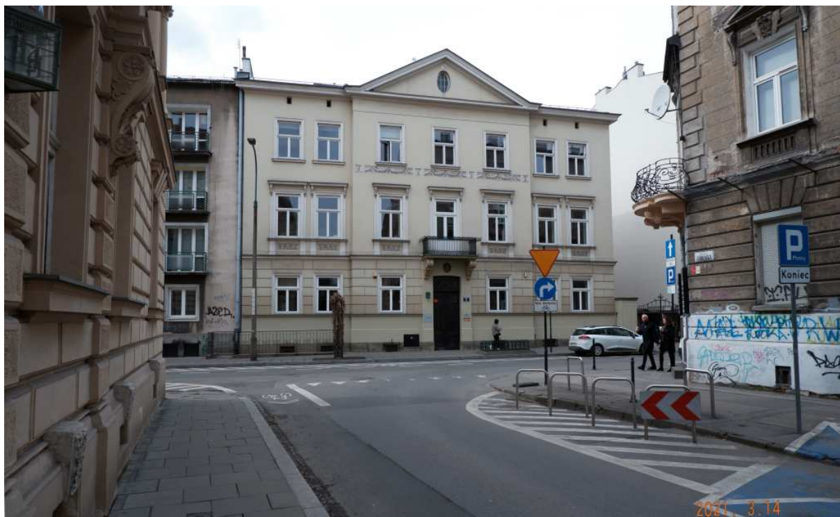
Fot. nr 250 (250-254). Zabudowa ulicy Garncarskiej. Nadbudowany w okresie międzywojennym o jedno piętro dom pod nr 5.
