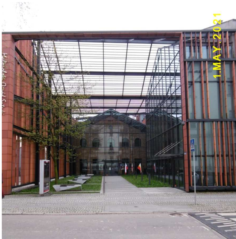
Fot. nr 153. Widok na fasadę Małopolskiego Ogródu Sztuki spod nr 12.
