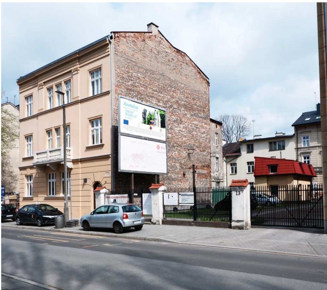
Fot. nr 131. Pusta posesja pod nr 13 i odnowiona kamienica spod nr 15. (03.05.2021)
