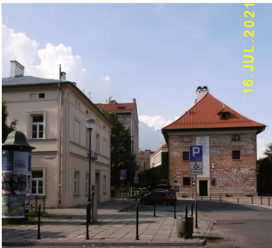
Fot. nr 307 (307-308). Zabytkowy, częściowo rekonstruowany spichlerz z placu Sikorskiego 6, powstały na przełomie wieków XVIII i XIX.
