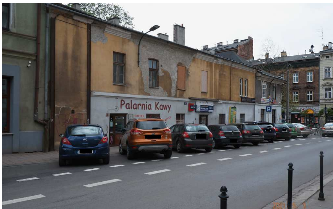
Fot. nr 157. Czekaający od lat na remont dom spod nr 26.
