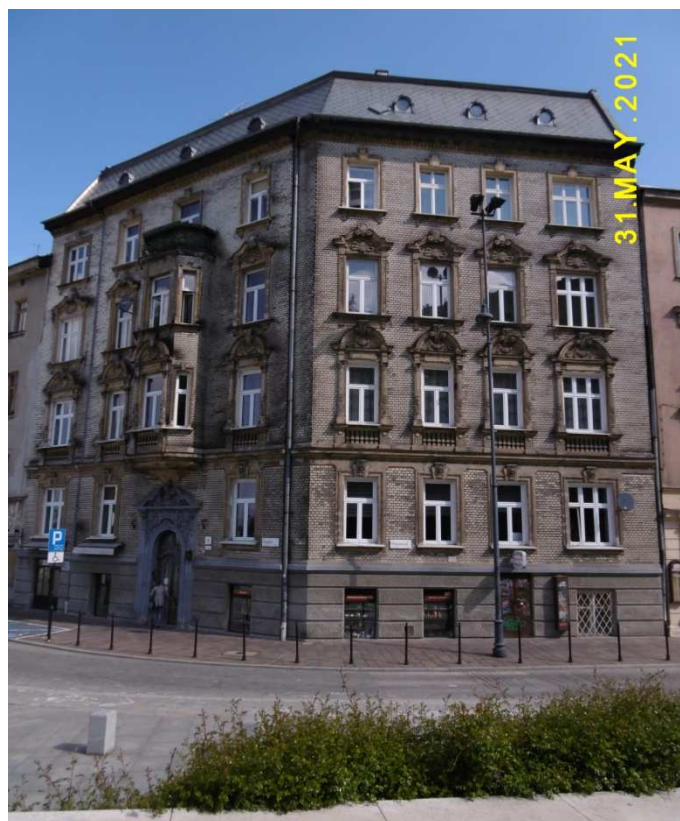
Fot. nr 360. Kamienica z ulicy Powiśle 12.
