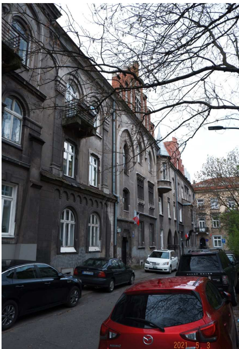
Fot. nr 207. Zabudowa wnętrza ulicy pod numerami 16. Na pierwszym planie historyzująca fasada kamienicy pod nr 16a; wg GEZ powstała w latach 1911-12 (proj. Ignacy Wentzel).
