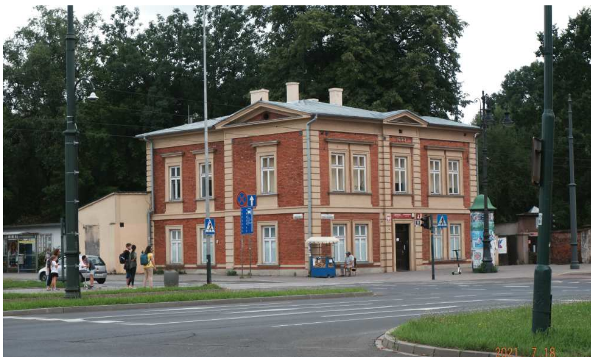
Fot. nr 317. Odnowiona, dawna Rogatka Wolska z ulicy Piłsudskiego 29, wybudowana wg projektu Henryka Żołdaniego w roku 1893. (18.07.2021)
