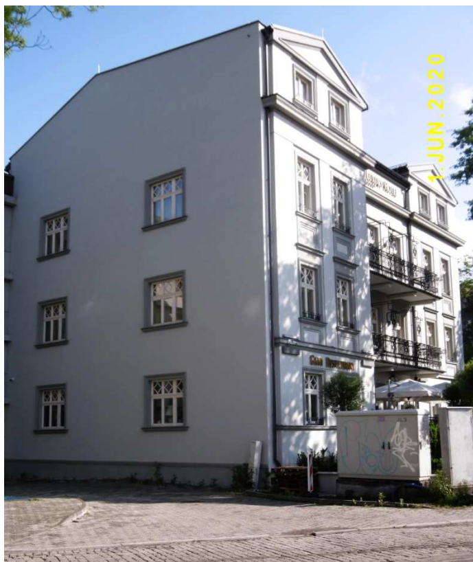
Fot. nr 337. Po dawnej willi zostały tylko zewnętrzne ściany – wewnątrz zostało wyprute.
