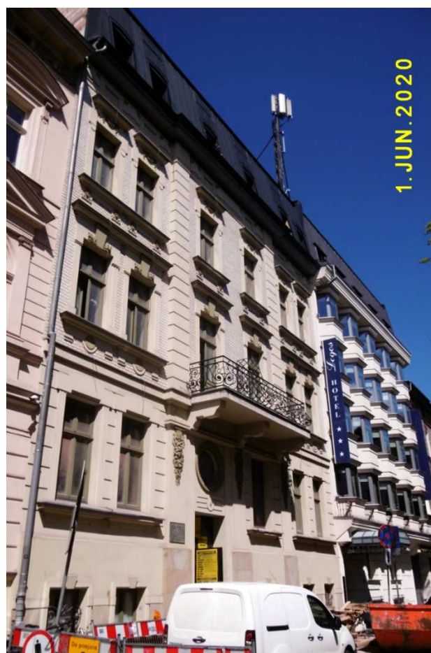
Fot. nr 23. Remont kamienicy pod nr 5.
