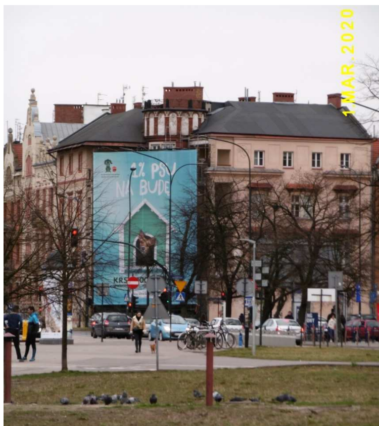
Fot. nr 332. Willa Ekielskich pod nr 40 z roku 1899, nadb. w latach 30. o jedno piętro.
