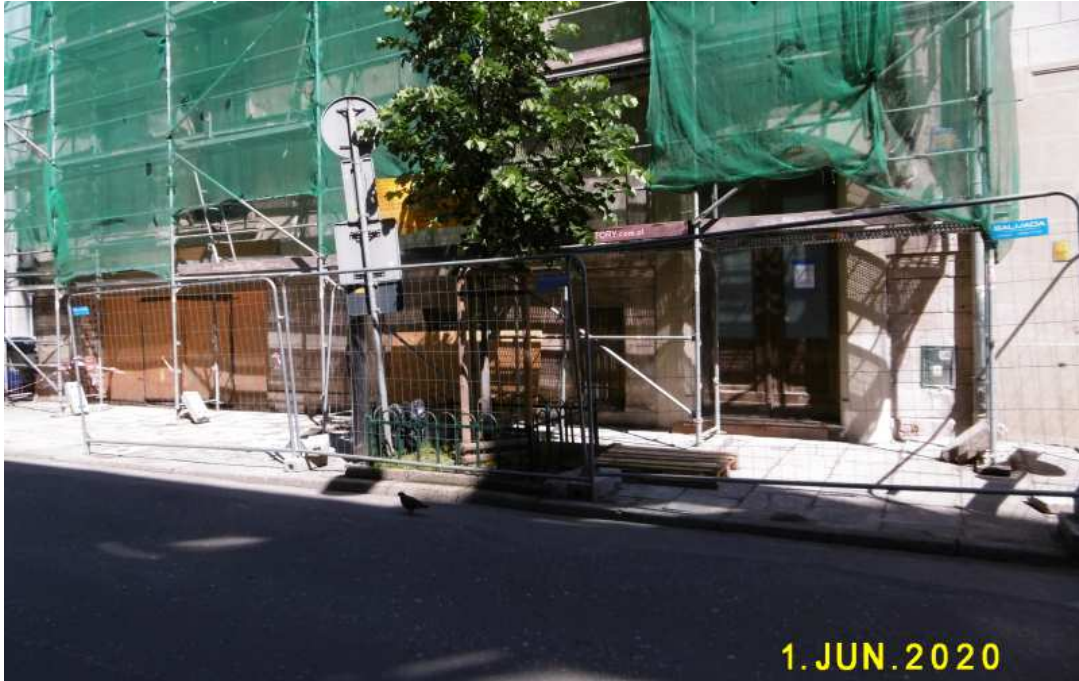
Fot. nr 60. Przebudowywanie parteru obiektu wpisanego do Rejestru Zabytków.
