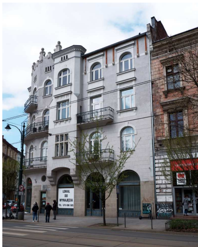
Fot. nr 241. Kamienica przy ulicy Podwale 4/Studenckiej 1, która powstała w miejscu tzw. „baszty Kościuszki”, wyburzonej w roku 1909. (03.05.2021)
