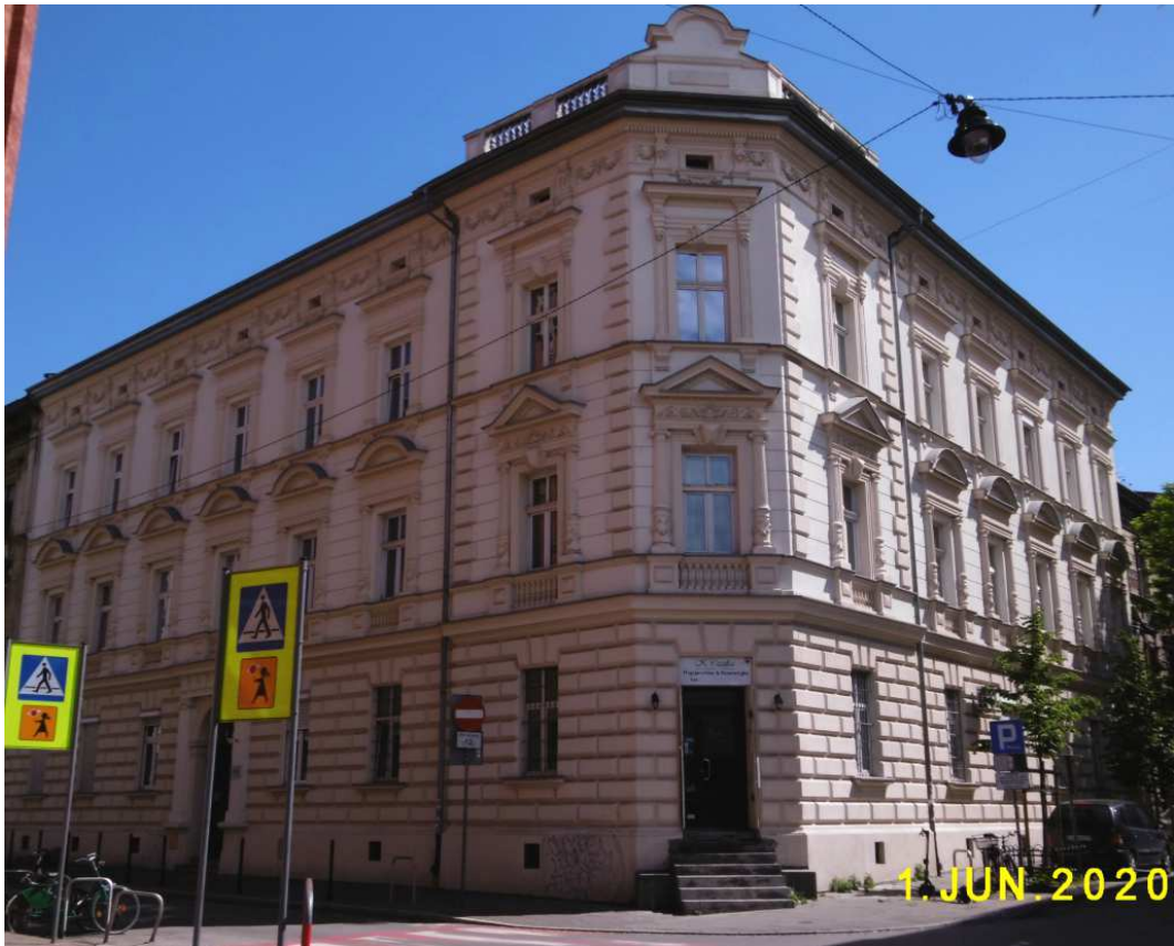
Fot. nr 58. Kamienica narożna pod nr 11.
