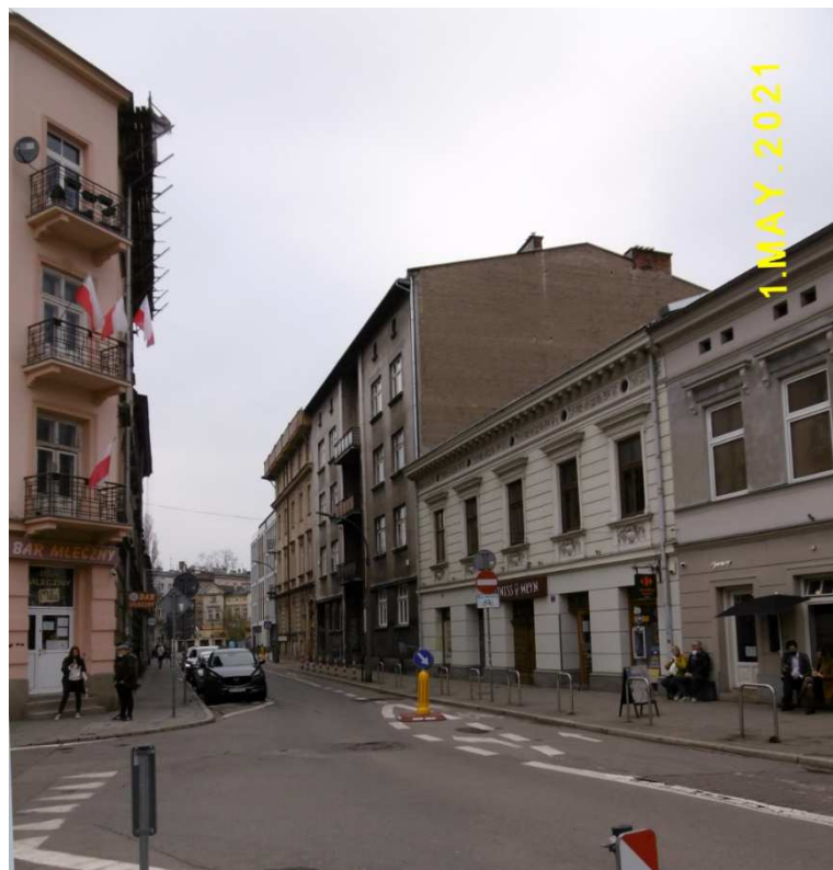
Fot. nr 117. Fragment zabudowy powyżej ulicy Czystej.
