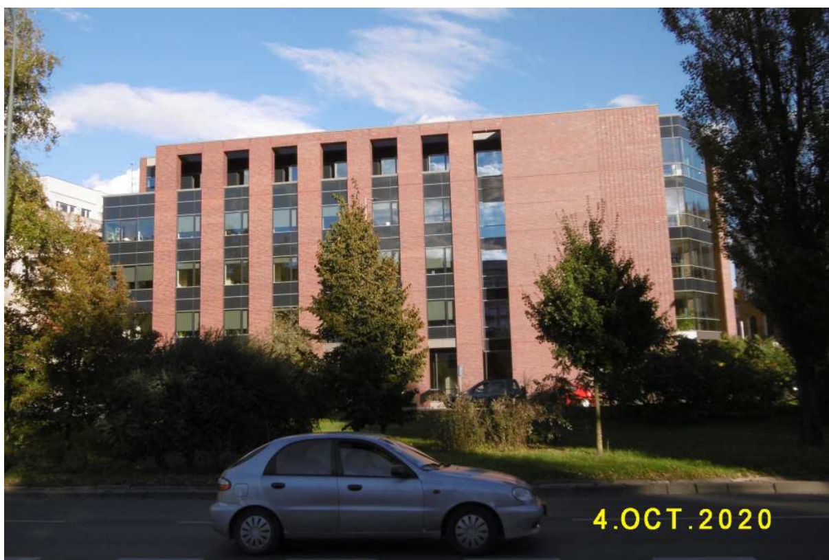
Fot. nr 101. Collegium Paderevianum pod nr 9 w swej nowej szacie architektonicznej.
