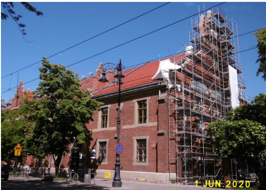
Fot. nr 36 (36-37). Sciana szczytowa Sokoła w trakcie kolejnej renowacji.
