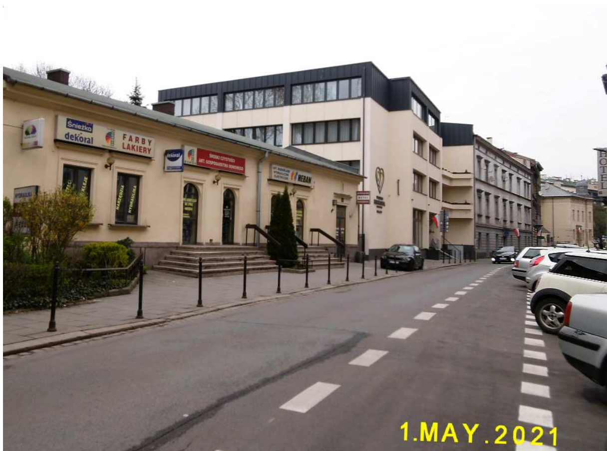
Fot. nr 165. Zabudowa ulicy poniżej parterowego domku o nr 11.
