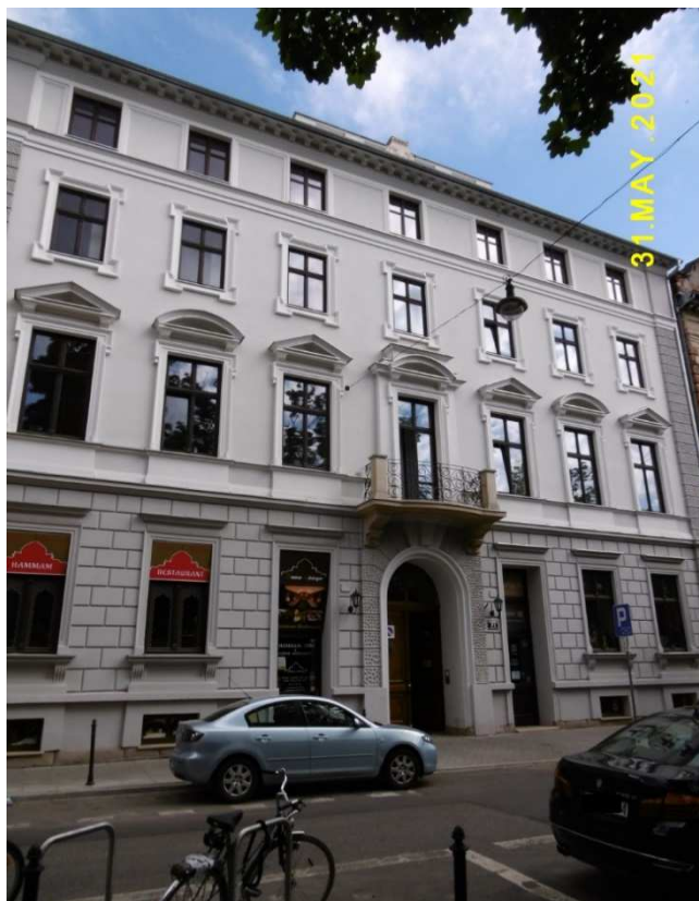
Fot. nr 388. Odnowiona kamienica z ulicy Smoleńsk 21.
