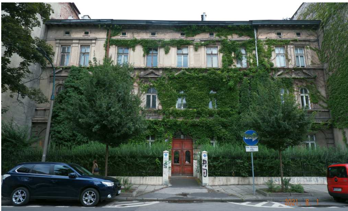
Fot. nr 274. Pokryta dzikim winem fasada kamienicy przy ulicy Łobzowskiej 41 (1897).
