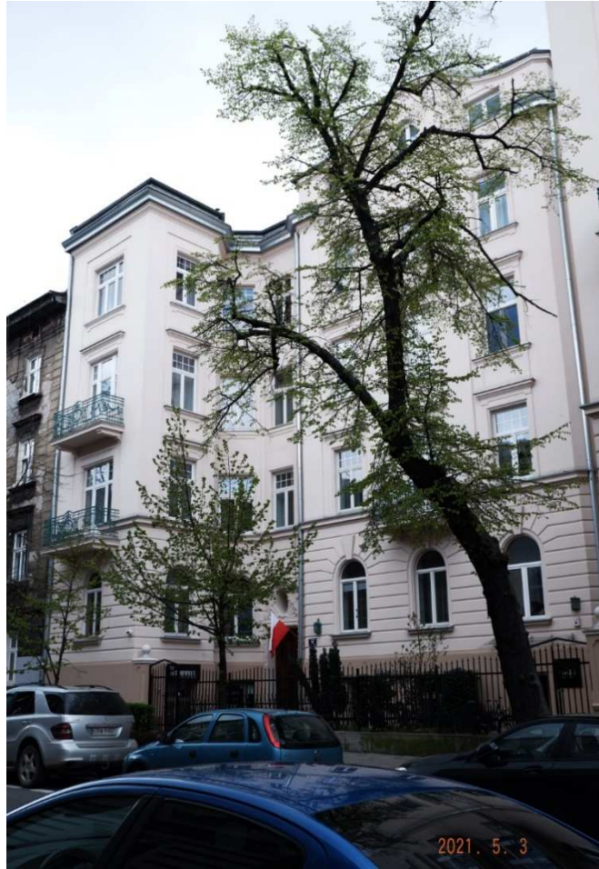
Fot. nr 190. Powstała pod koniec I dekady XX wieku kamienica z ulicy Szlak 11.
