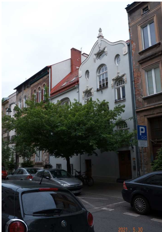
Fot. nr 375 (375-376). Kamienica pod numerem 5.
