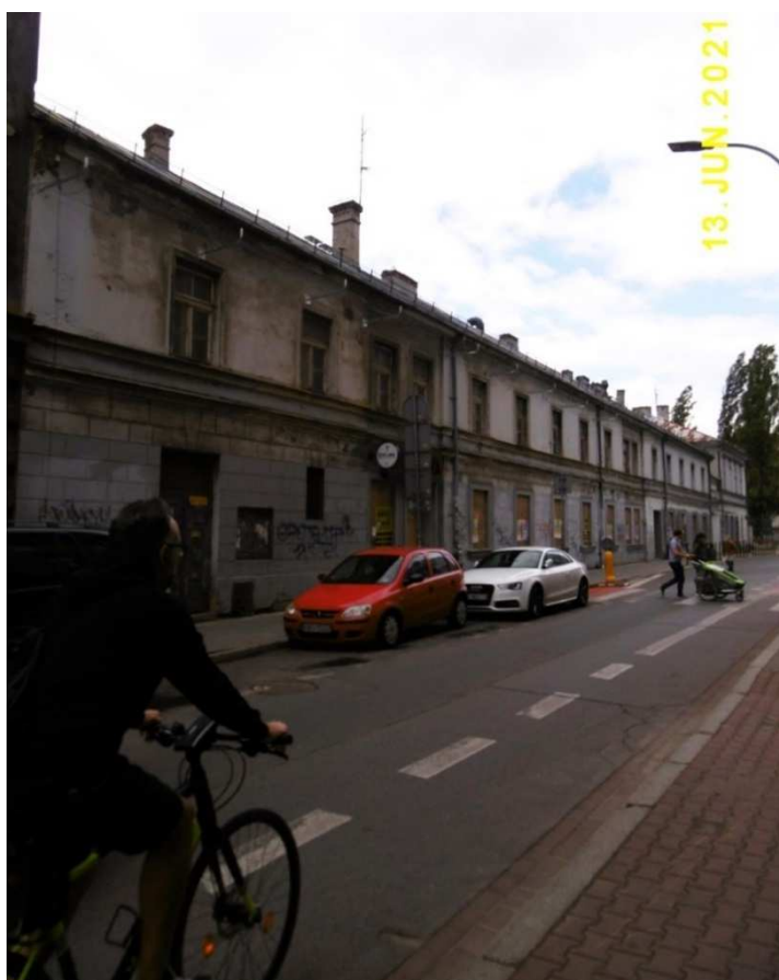
Fot. nr 121 (120-122). Dawny budynek socjalny.
