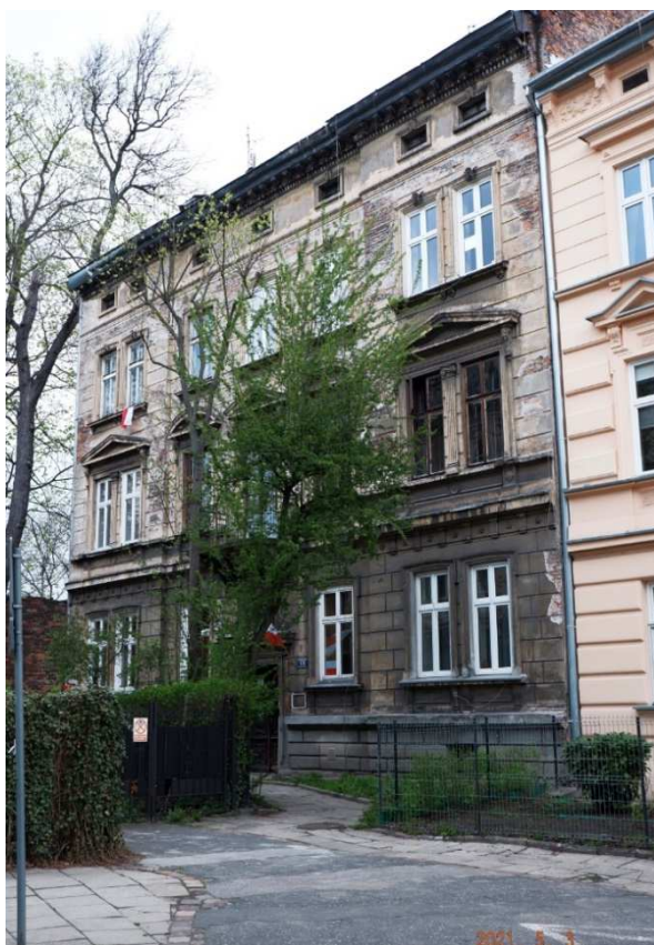
Fot. nr 215 (215-221). Migawki z ulicy Siemiradzkiego. Kamienica o numerze 13 z ogródkiem na jej przedpolu, który sięga po mur graniczny ogrodu Karmelitanek Bosych.
