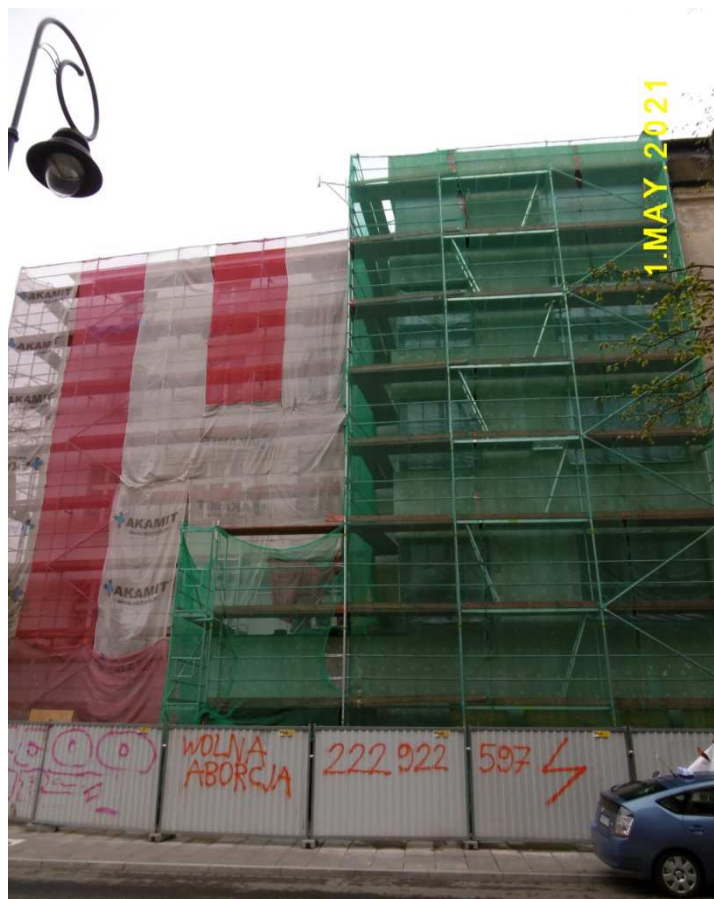
Fot. nr 150 (150-152). Trwa zabudowa poseji pod nr 18, połączona z przebudową narożnej kamienicy spod nr 16/Szujskiego 11.
