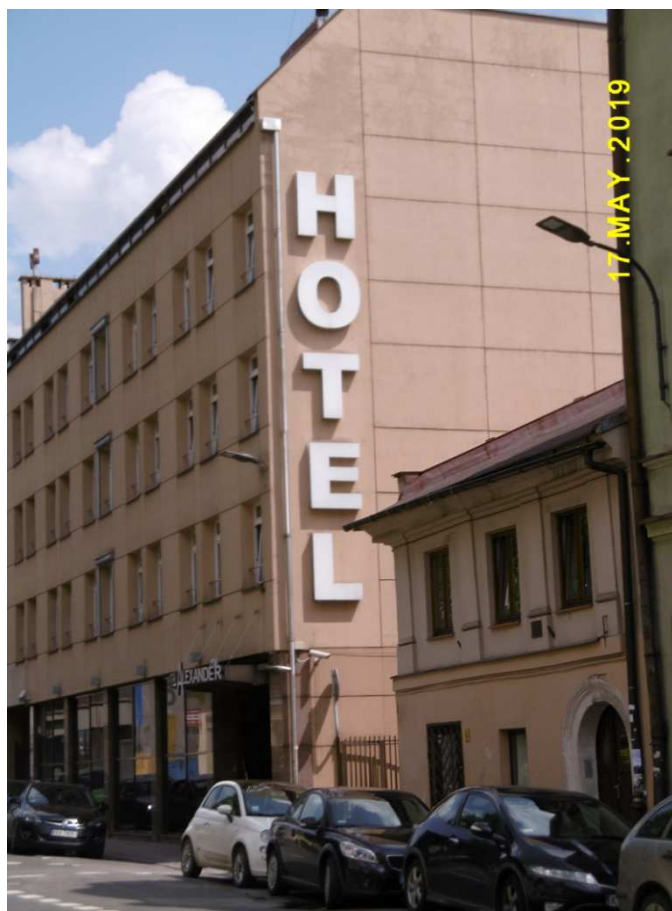
Fot. nr 439. Hotel pod nr 20 i blisko 200-letni dom spod nr 22, który niebawem zniknie.
