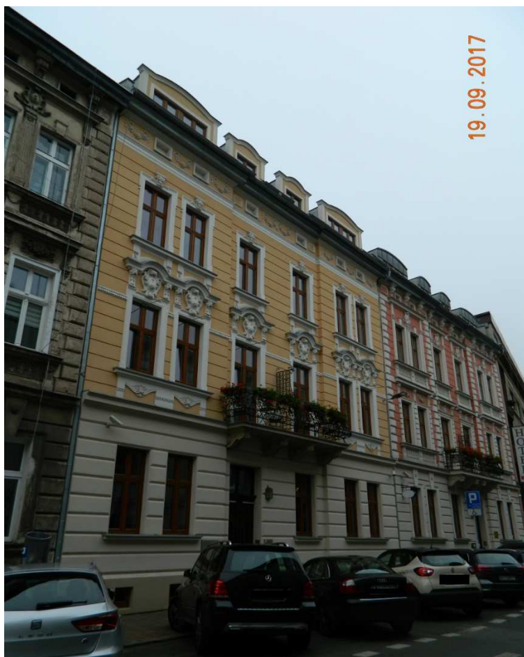
Fot. nr 258. Odnowiona kamienica z roku 1904 spod nr 4 (proj. Benjamin Torbe).
