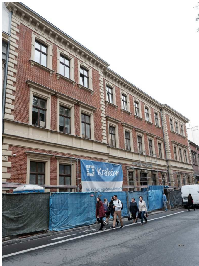
Fot. nr 590. Kamienica Izby Lekarskiej z ul. Krupniczej 11A na końcowym etapie remontu.
