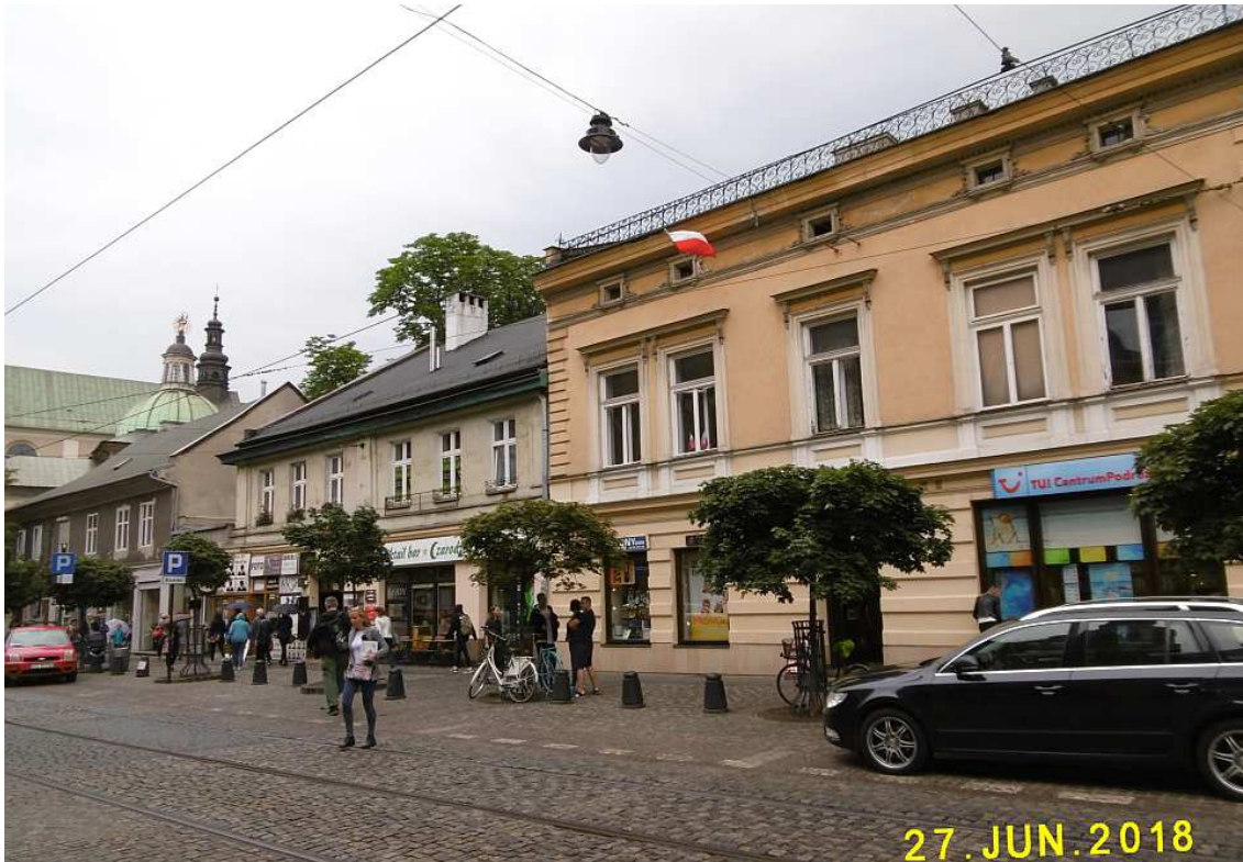
Fot. nr 367. Niska zabudowa, o typowo podmiejskim charakterze, która zachowała się pod nr: 13-17. Niestety w ewidencji zabytków figuruje tylko budynek pod nr 15.
