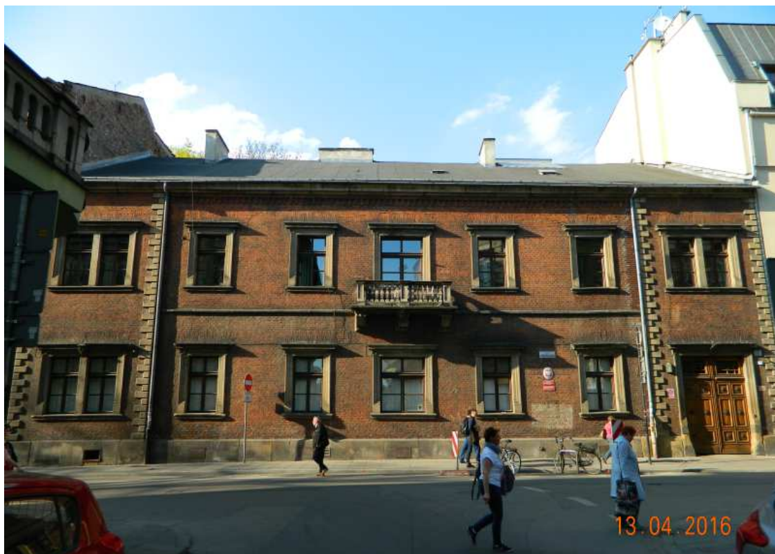
Fot. nr 44. Pałac Mieroszewskich a ulicy Krupniczej 11, zabytek, który wkrótce może zostać nadbudowany. W czasach PRL swoją siedzibę miał tu Urząd Miar i Wag.
