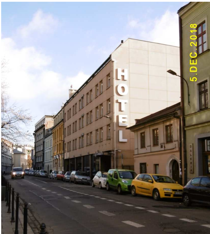
Fot. nr 395 (395-396). Wzdłuż ulicy Garbarskiej. Tu fragment zabudowy ulicy do nr 22.
