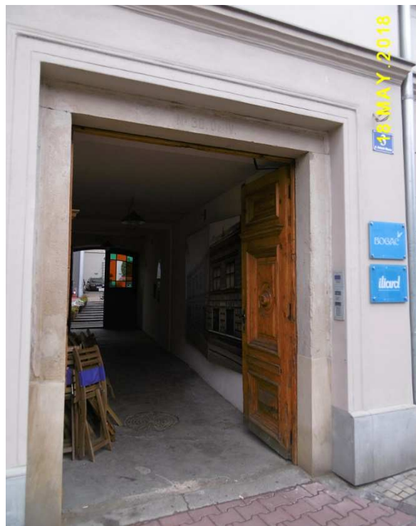
Fot. nr 338. Sień domu przy ulicy Dolnych Młynów 3.
