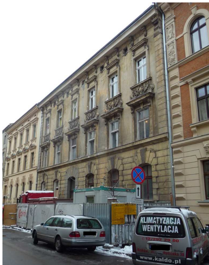
Fot. nr 311. Dawna kamienica Zollów spod nr 25 na etapie remontu. (22.01.2018)
