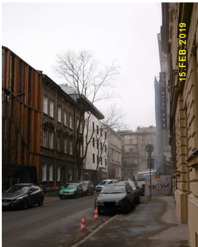
Fot. nr 429. Wzdłuż ulicy Szujskiego od strony ulicy Rajskiej.
