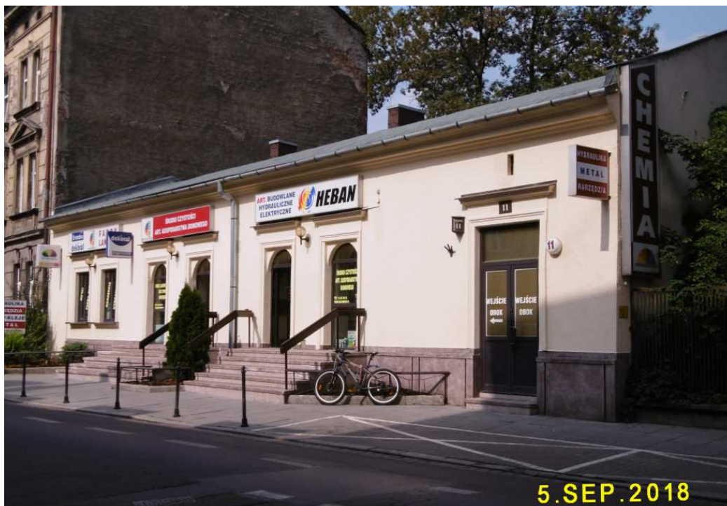
Fot. nr 359. Mocno zniekształcona fasada dawnego domu podmiejskiego z ulicy Garbarskiej 11.
