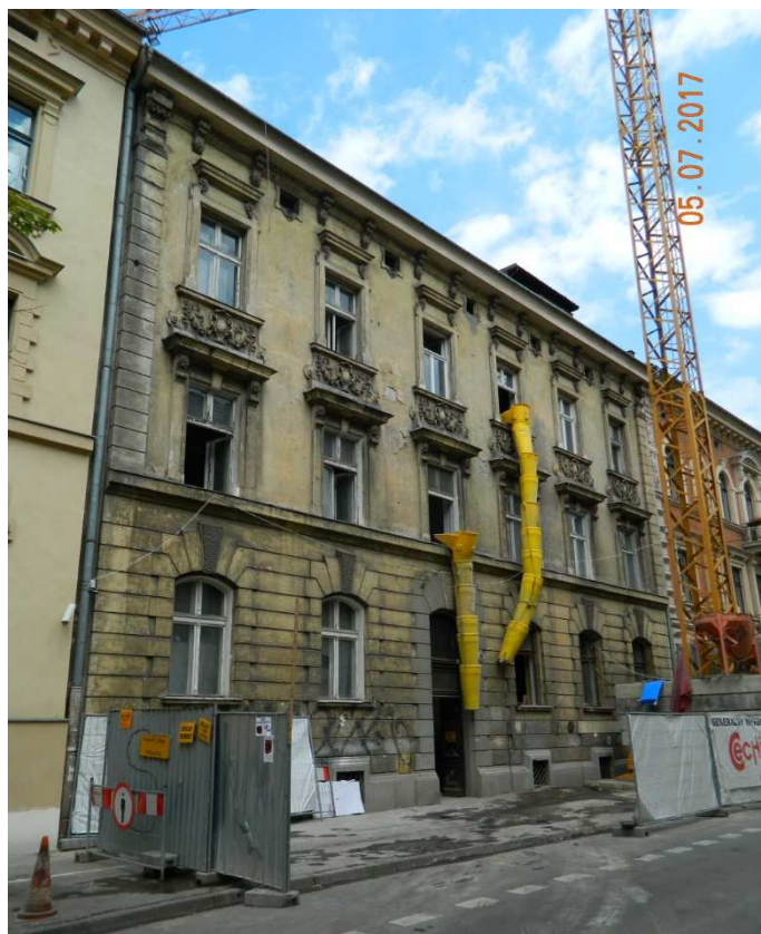
Fot. nr 201. Dawna kamienica Zollów spod nr 25 z lat 1891-93 (proj. W. Kaczmarski).
