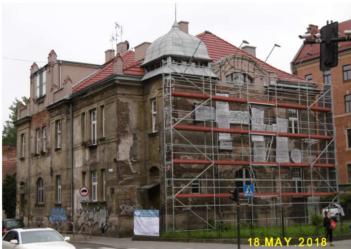
Fot. nr 355. Secesyjna willa spod nr 8 w początkowym etapie remontu.
