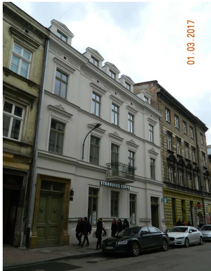
Fot. nr 158. Świeżo odnowiona i zgrabnie nadbudowana kamienica z ulicy Krupniczej 10.
