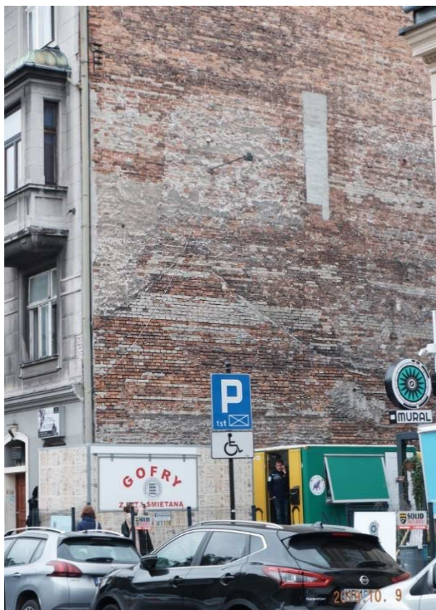
Fot. nr 587. Narys dachu parterowego domku Rzegocińskich (kiedyś nr 24) na bocznej ścianie Domu Literatów.
