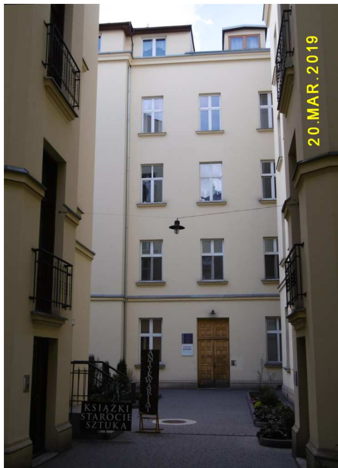
Fot. nr 487. Podwórko kamienicy. W tle oficyna.
