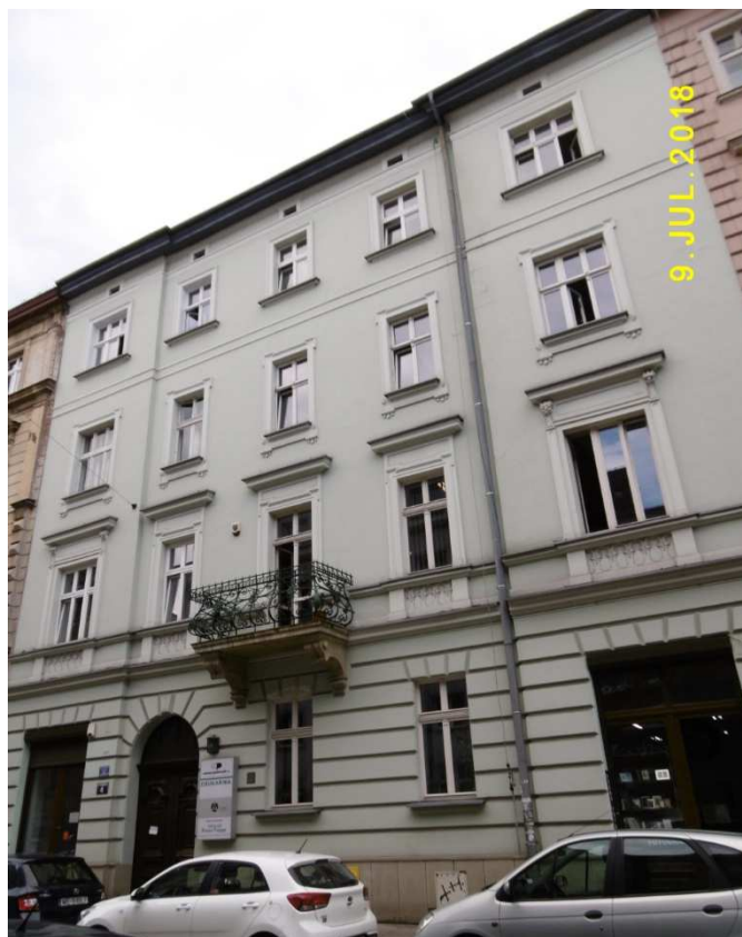
Fot. nr 384 (384-385). Świeżo odnowiona elewacja kamienicy z ulicy Studenckiej 4.
