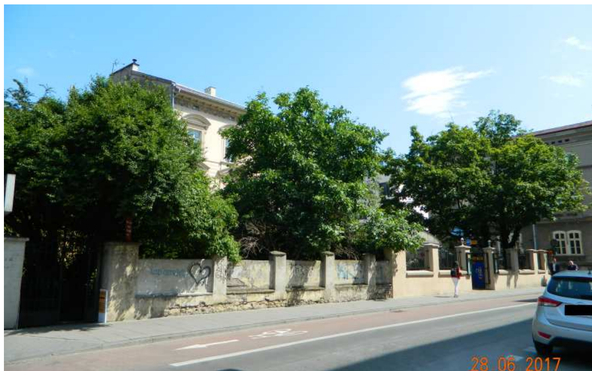
Fot. nr 216. Zielone, ogrodowe kiedyś przedpole budynków spod nr: 17 i 19.
