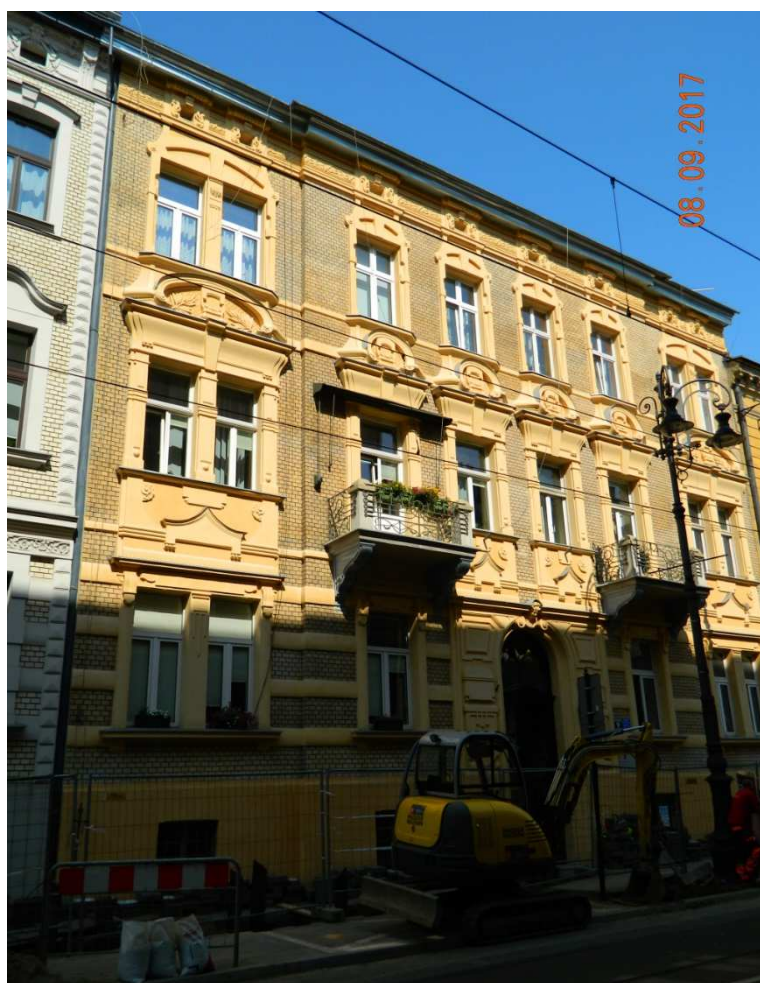
Fot. nr 184 (184-186). Kamienica spod nr 9 z lat 1903-1906. Autor projektu jak u poprzedniczki.
