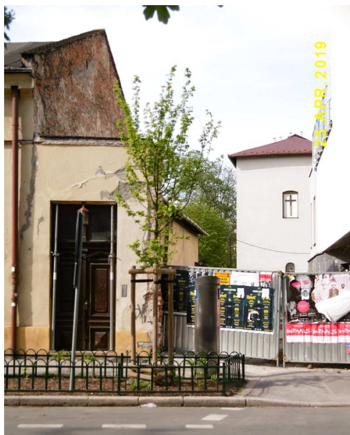
Fot. nr 506 (506-507). Widoki na dziedziniec z kaplicą w tle.
