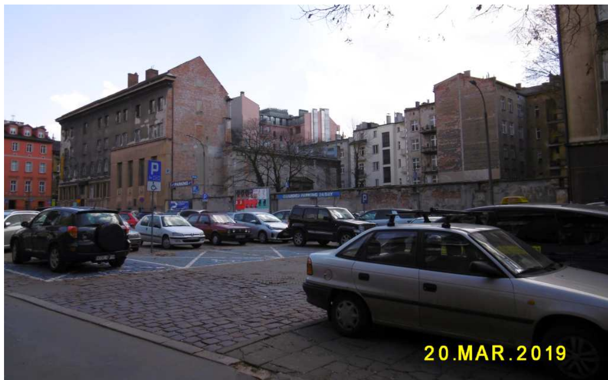
Fot. nr 504. Pusta przestrzeń na dziedzińcu Domu Kultury przy ulicy Krowoderskiej 8. Widok z ulicy Biskupiej.
