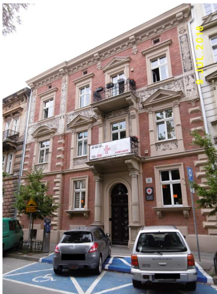
Fot. nr 388. Kamienica własna Sławomira Odrzywolskiego spod nr 19, która stanowi nieczęsty jeszcze wzorec efektywnej i fachowej restauracji fasady. Szczególnie trudne było przywrócenie dawnego piękna dekoracji sgraffitowej.
