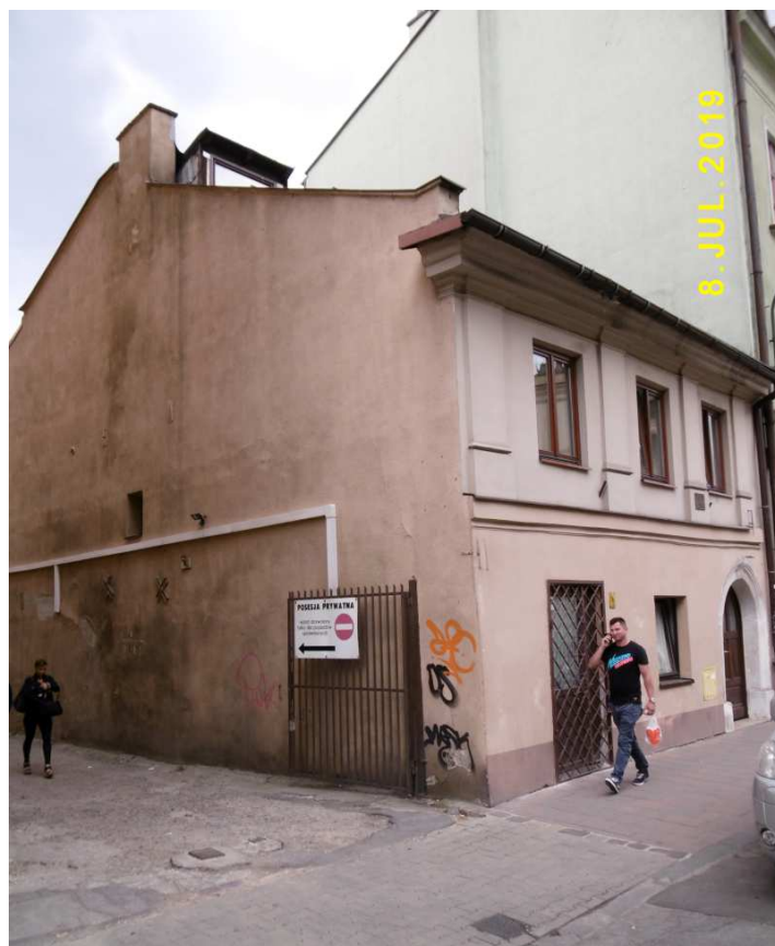
Fot. nr 552 (552-554). Prawie 100-letni dom pod nr 22, który niebawem zniknie.
