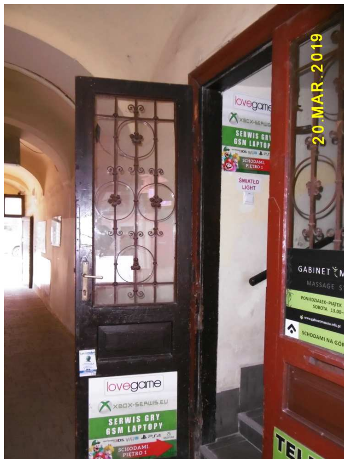
Fot. nr 441. Drzwi na klatce schodowej.
