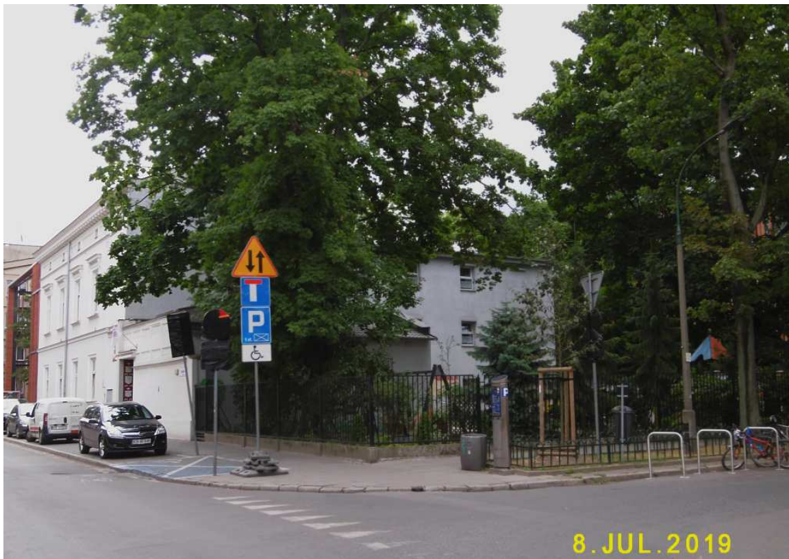
Fot. nr 536 (536-537). Budynek dawnej szkoły specjalnej nr 44 przy ulicy Rajskiej 14.
