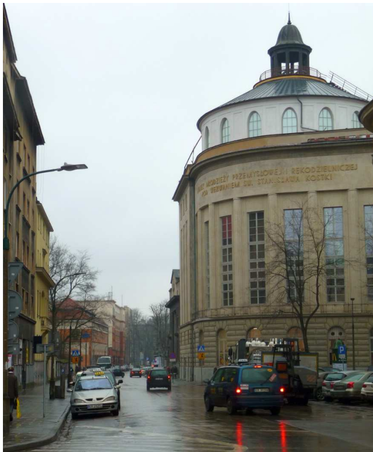
Fot. nr 315. Świeżo odnowiony budynek dawnej bursy księdza Kuznowicza. (12.01.2018)
