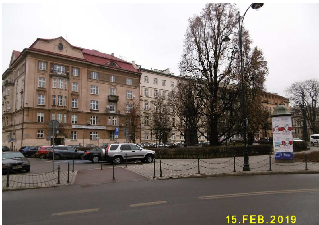
Fot. nr 407. Początkowy fragment zabudowy ulicy Basztowej.
