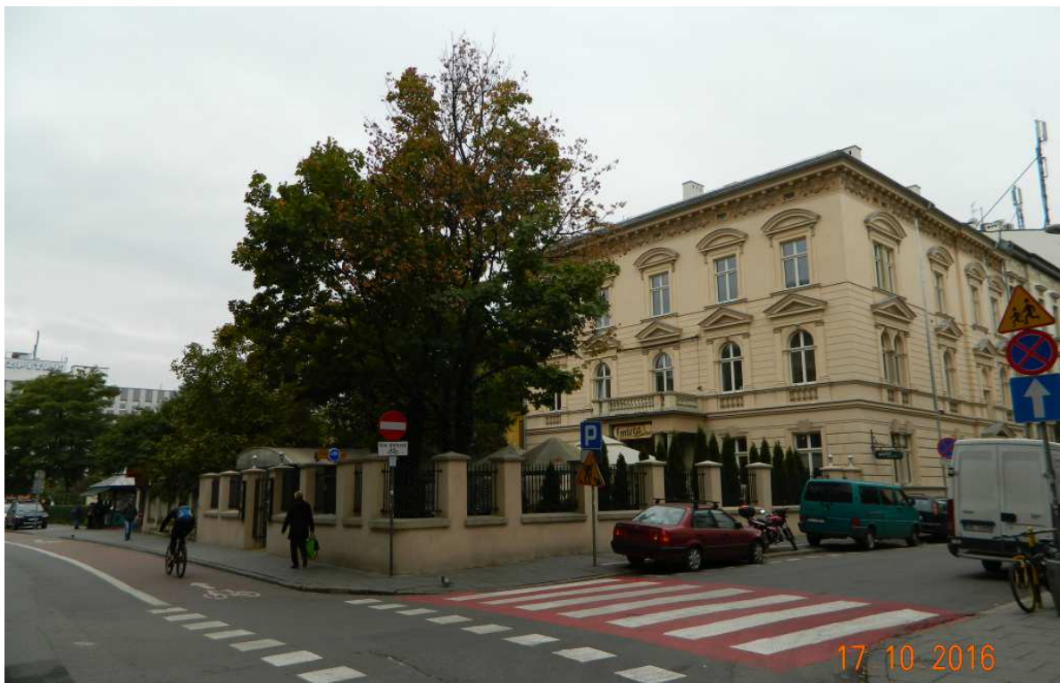
Fot. nr 121. Zielona, ogrodowa przestrzeń na przedpolu zabudowy Krupniczej o numerach 17-21. Do początku XX wieku po tym terenie płynęła Młynówka Królewska.
