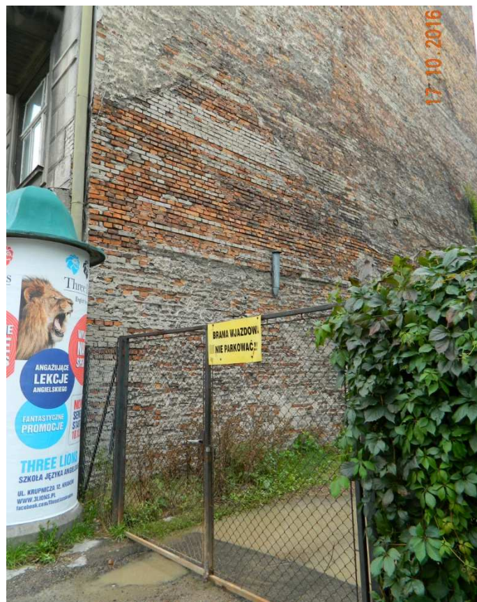
Fot. nr 119. Widoczny na ścianie bocznej Domu Literatów narys dachu parterowego domu malarza Witolda Rzegocińskiego z ulicy Krupniczej 24, który znikł ponad 30 lat temu.
