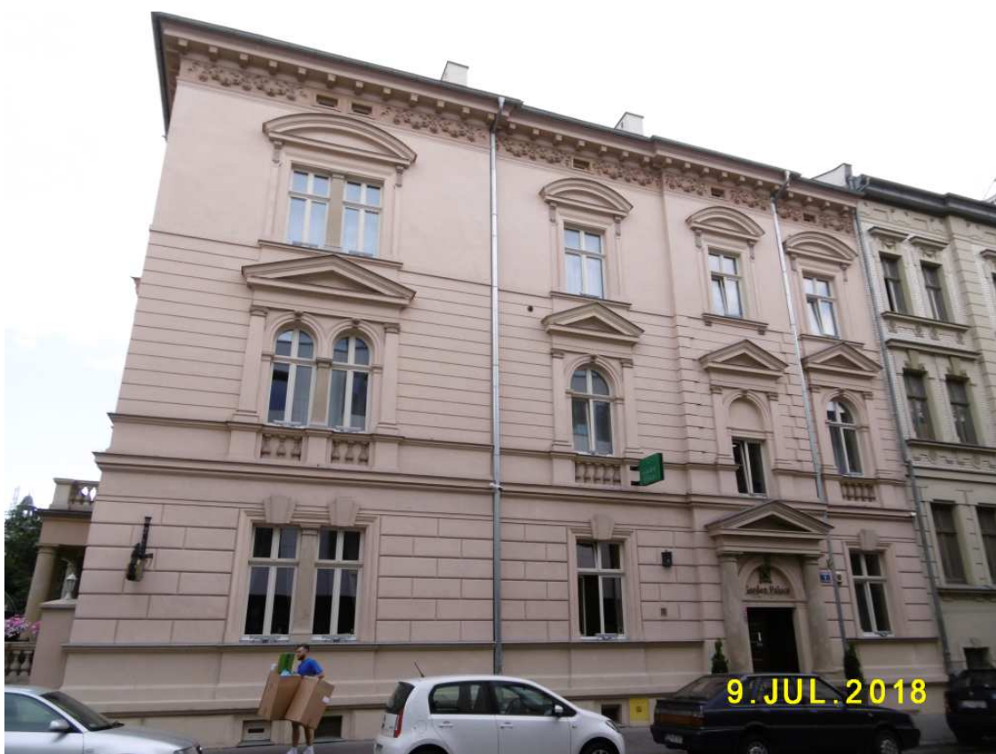
Fot. nr 376 (376-378). Kamienica przy ulicy Szujskiego 1 przerobiona na apartamentowiec Garden Palace.
