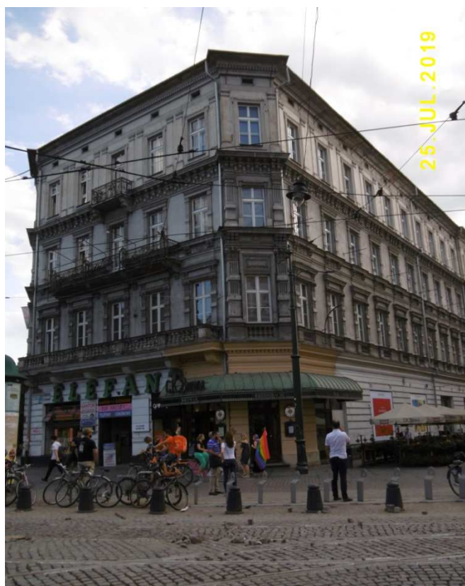
Fot. nr 550. Gmach z naroża ulic: Podwale i Krupniczej, w którego piwnicach w czasach PRL mieściły się Centralne Piwnice Win Importowanych.
