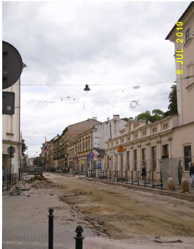
Fot. nr 545 (545-549). Kilka migawek ulicy Karmelickiej, na której trwa remont.
