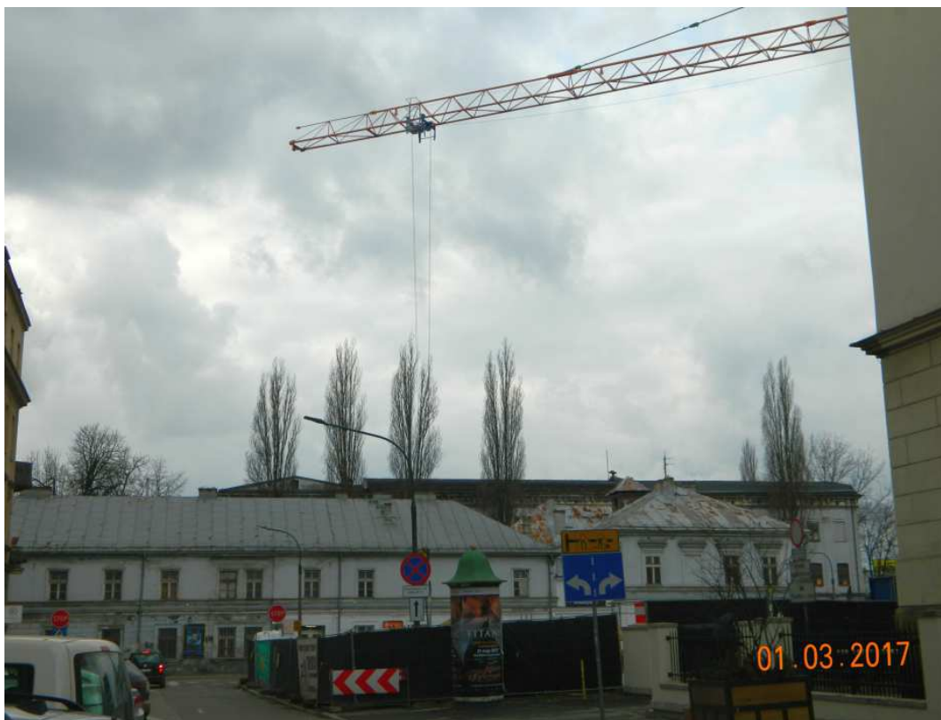
Fot. nr 154. Rzut okiem na budynki socjalne dawnych Krakowskich Zakładów Tytoniowych.
