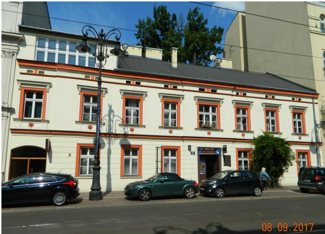
Fot. nr 176. Dawny dom Olgi Boznańskiej spod nr 21, który powstał w roku 1861 wg projektu Jacka Matusińskiego. Nad wejściem znajduje się dawna pracownia artystki.
