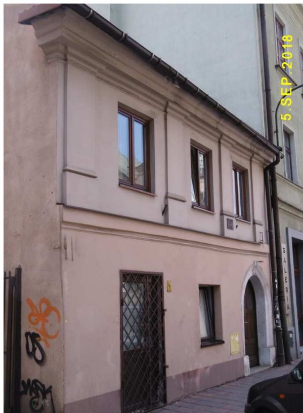
Fot. nr 362 (362-363). Blisko 200-letni domek spod nr 26, który niebawem może zniknąć, by dać miejsce pod rozbudowę sąsiedniego hotelu.
