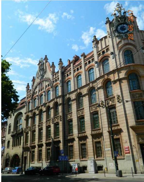
Fot. nr 193. Zabudowa ulicy Straszewskiego o numerach 28 i 29. Pod nr 28 dawny budynek NOT, który powstał w roku 1906 wg projektu Sławomira Odrzywolskiego, a na pierwszym planie budynek dawnej Szkoły Handlowej z lat 1904-1906.
