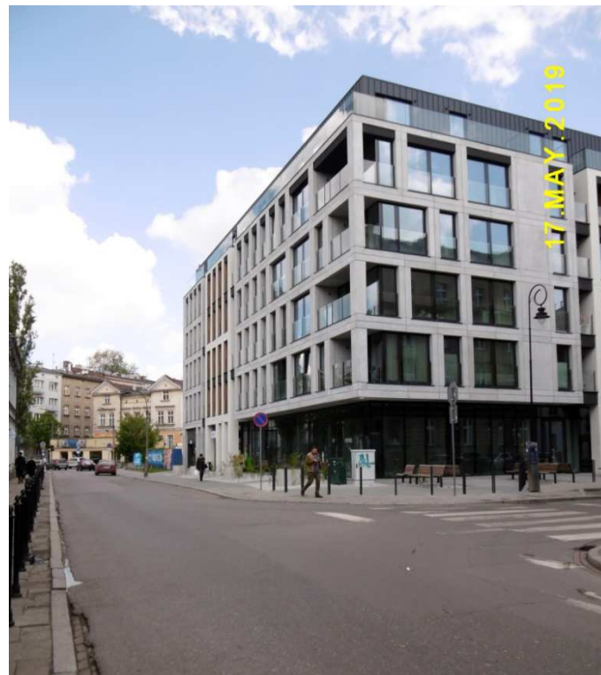
Fot. nr 462 (462-463). Nowa zabudowa przy ulicy Dolnych Młynów 11.
