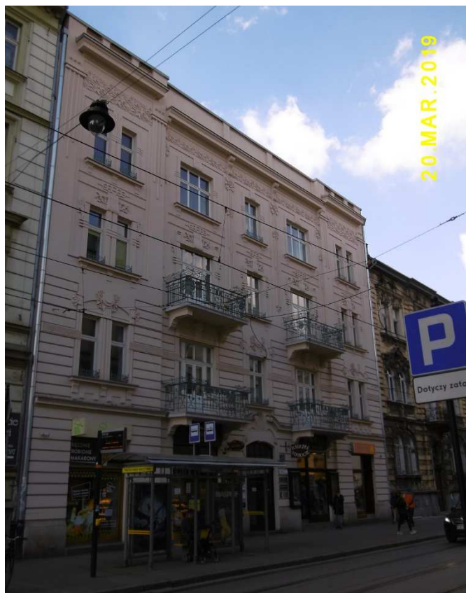
Fot. nr 481 (481-487). Secesyjna kamienica przy ulicy Karmelickiej 46 i jej detale.
