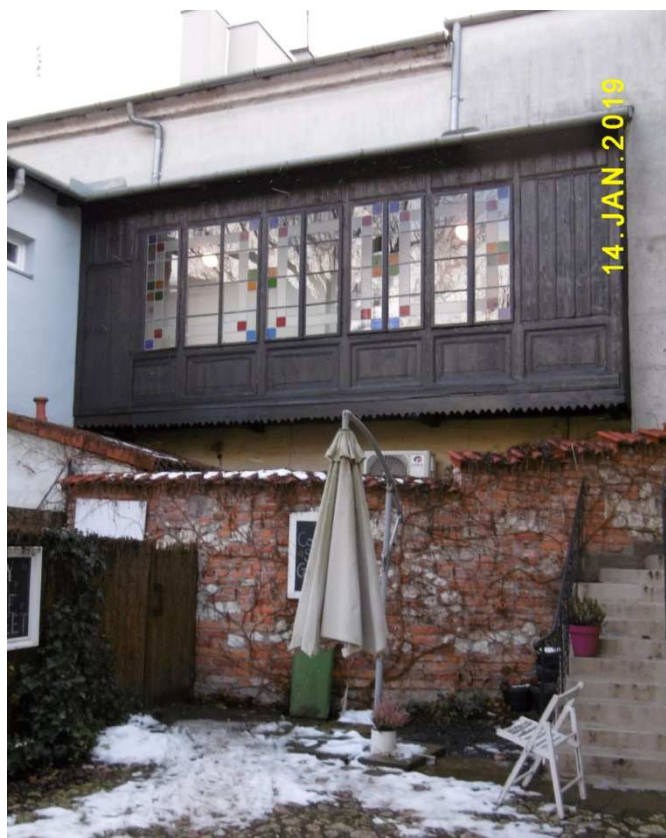
Fot. nr 425 (425-426). Podwieszane ganki.
