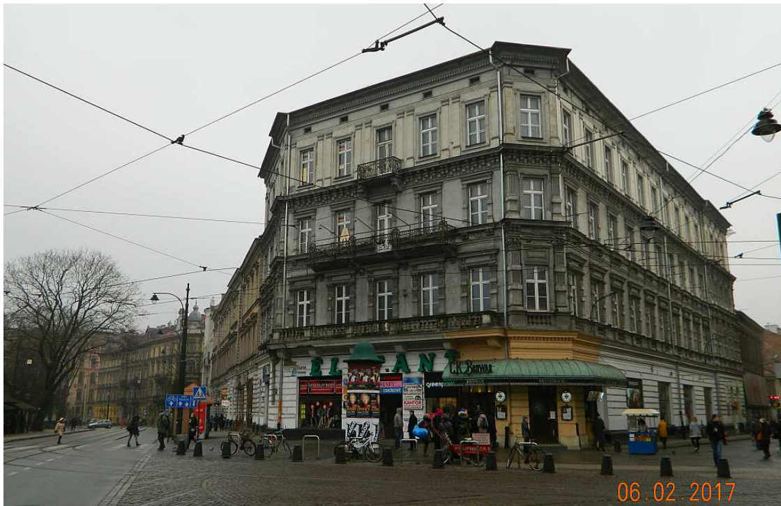
Fot. nr 130 (130-1131). Narożna kamienica z ulicy Podwale 7/Krupniczej 2.
