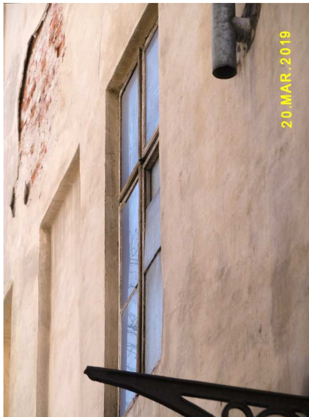
Fot. nr 470. Ponad stuletnie okno, które zachowało się w oryginale.
