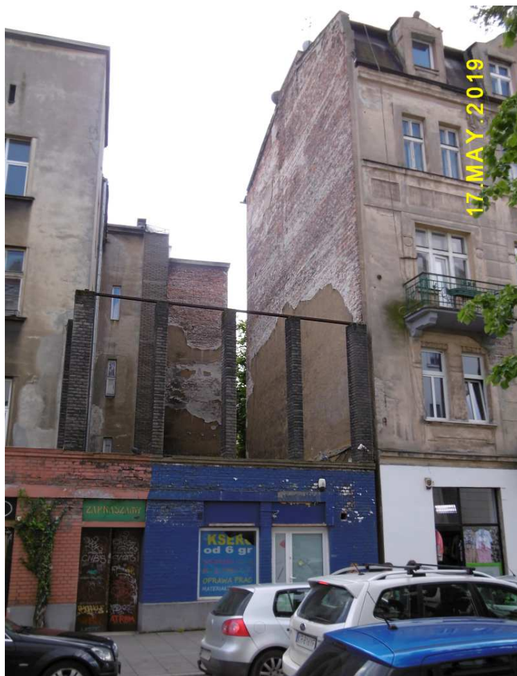
Fot. nr 455 (455-458). Kamienica z ulicy Rajskiej 22 i przylegający do niej (dawny) wiszący ogród. Zapewne ostatnie jego ujęcia.
