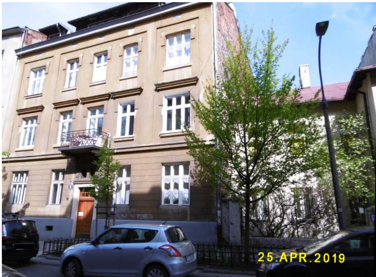
Fot. nr 510 (510-511). Fragment zabudowy ulicy św. Teresy o nr 8 i 10 (z lewej).
