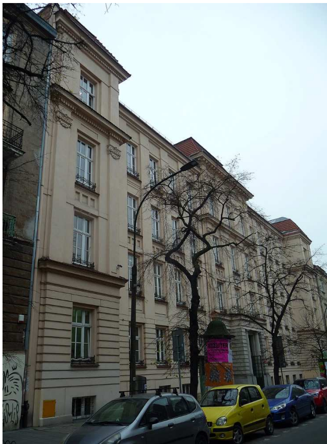
Fot. nr 267 (267-268). Budynek szkolny przy ulicy Szlak 9. (09.11.2017)
