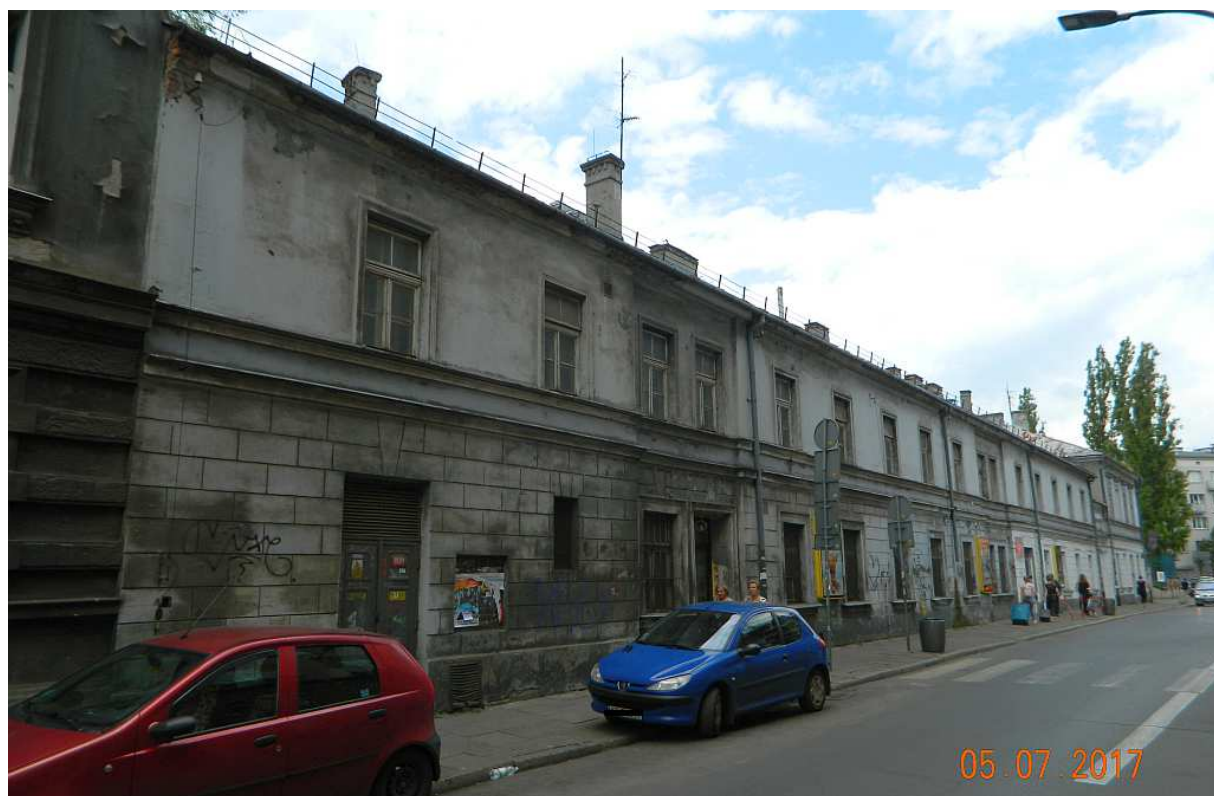
Fot. nr 228 (228-232). Budynek socjalny dawnych Krakowskich Zakładów Tytoniowych pod nr: 10-12, gdzie dziś niemal na „dziko” powstają kolejne lokale gastronomiczne.
