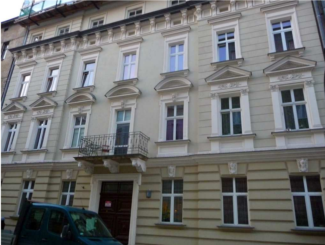
Fot. nr 423. Świeżo odnowiona kamienica pod nr 11, której fasada poraża różnorodnością typów okien. (19.02.2019)
