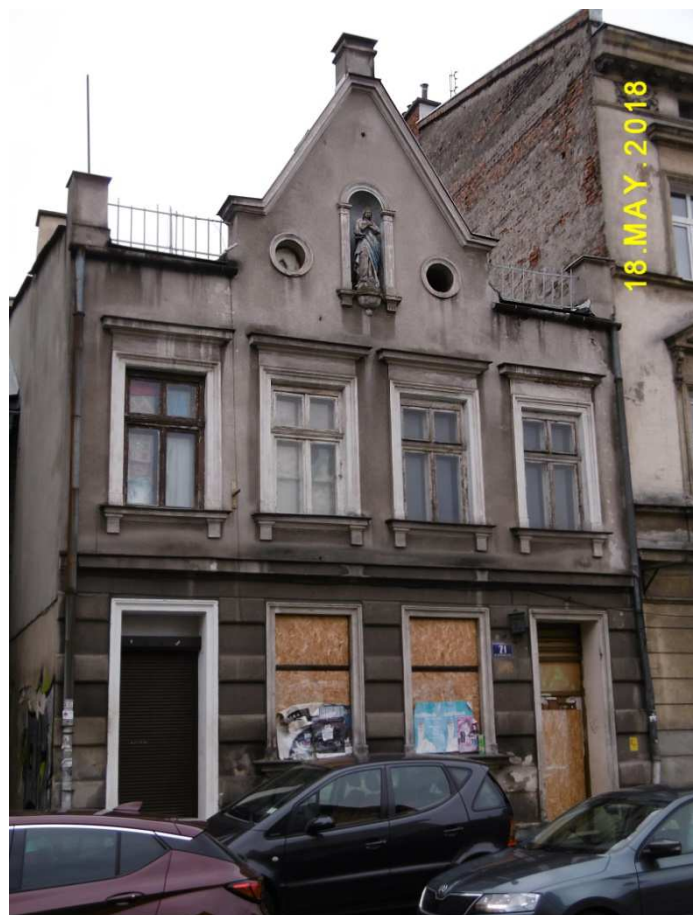
Fot. nr 353. Jak będzie wyglądał ten budynek spod nr 21 po remoncie?
