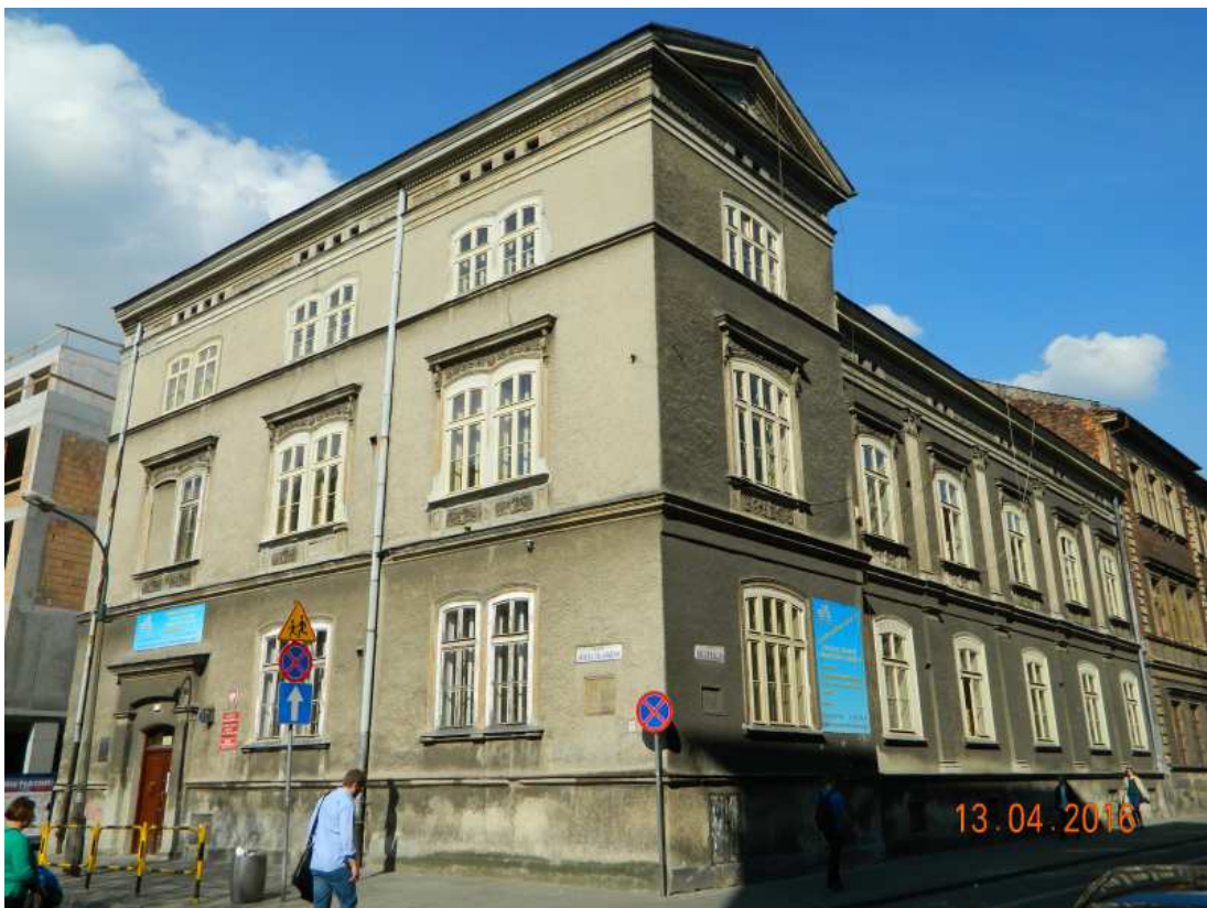
Fot. nr 47. Moja „buda” – dawna SP nr 6 z ulicy Szujskiego 2, obiekt o pomad 130-letniej tradycji edukacyjnej. Pod koniec lat 80, gdy ten budynek został rozbudowany na szkołę, mieściła się tu szkoła żeńska.
