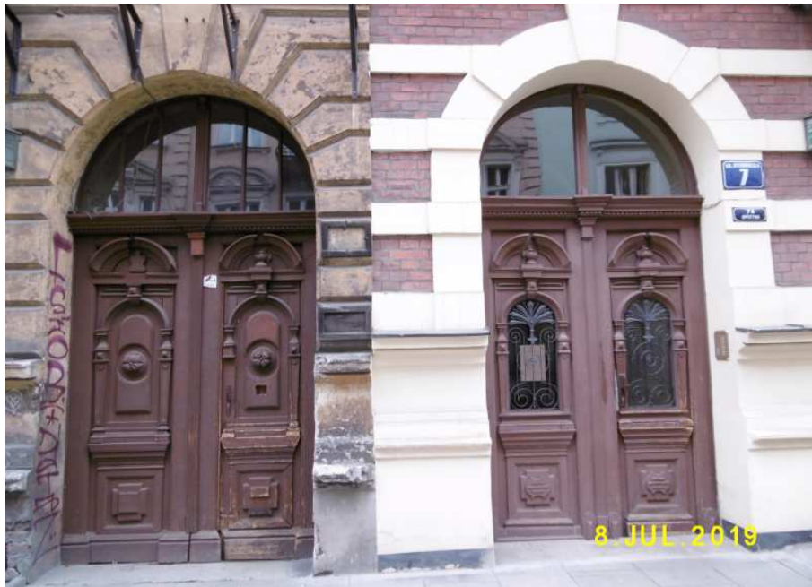
Fot. nr 531. Eklektyczne drzwi kamienic z ulicy Studenskiej: 7 i 9.
