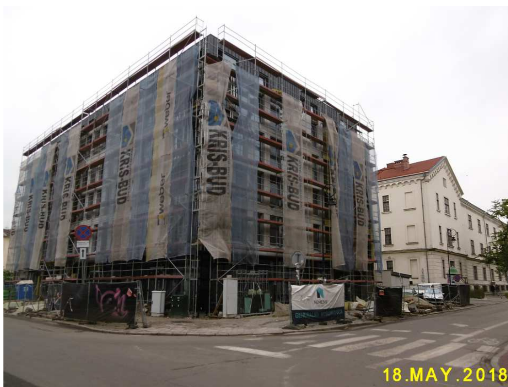
Fot. nr 346. Końcowy etap budowy giganta na styku ulic: Dolnych Młynów i Rajskiej.
