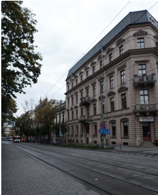
Fot. nr 567. W dół ulicy Basztowej – widok z wylotu ulicy Krowoderskiej.
