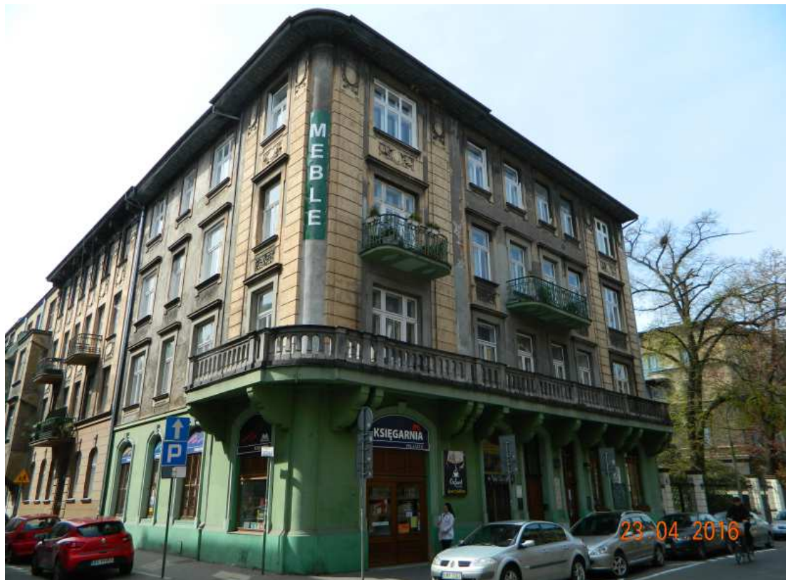
Fot. nr 43. Narożna kamienica na styku ulic: Krupniczej (nr 14) i Loretańskiej. W jej parterze od strony ulicy Krupniczej w czasach PRL mieściła się sala wykładowa dla uczestników kursów „nauki jazdy”, a przed budynkiem parkowały szkoleniowe samochody.
