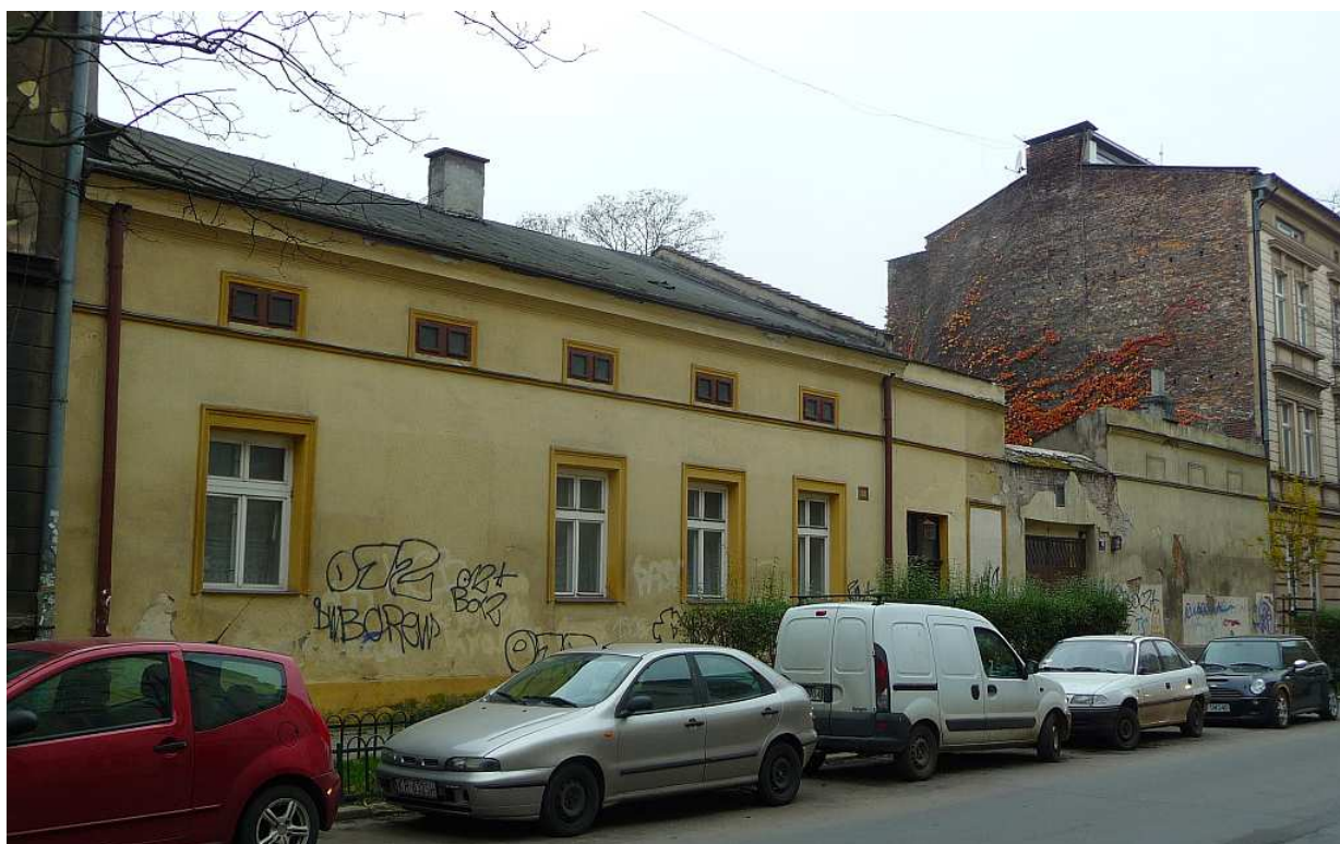
Fot. nr 266. Budynek dawnego przedszkola przy ulicy Krowoderskiej 38-40. (09.11.2017)
