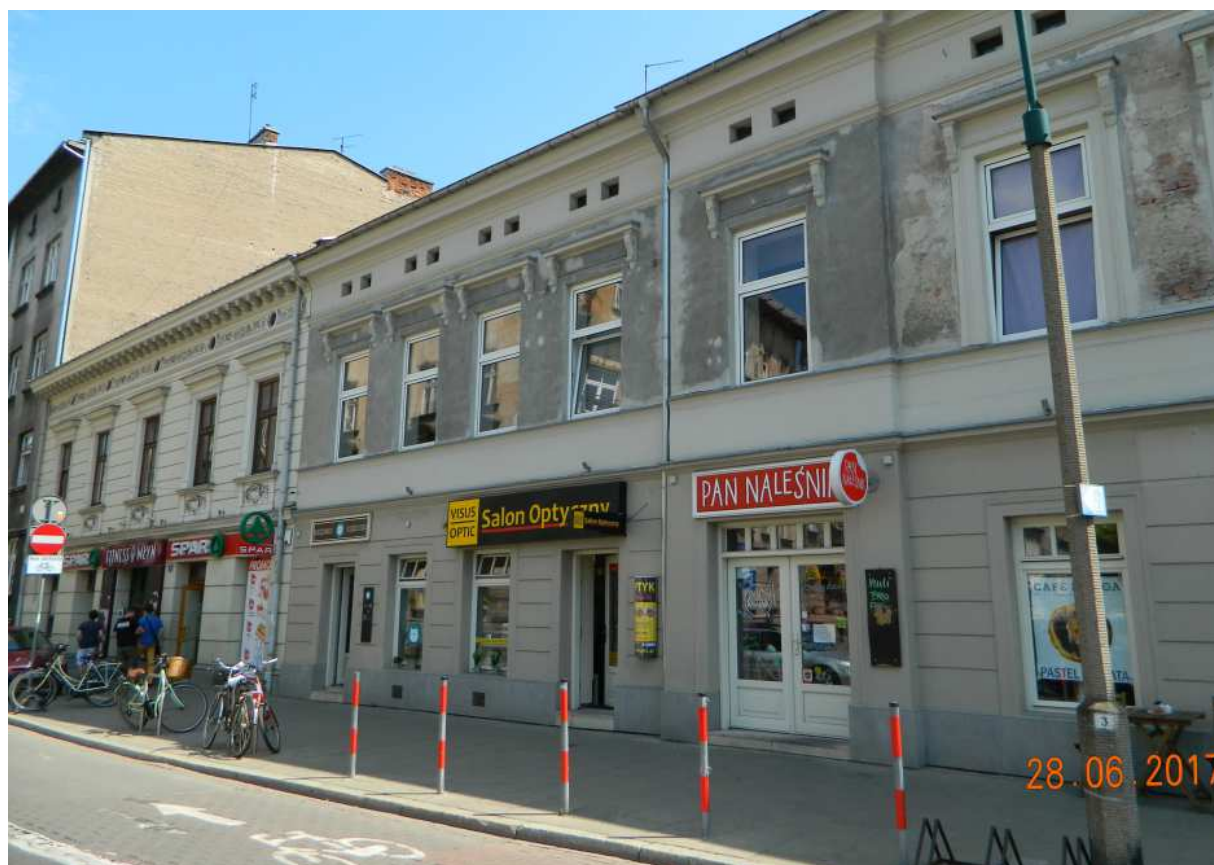
Fot. nr 227. Zabudowa pod nr 3 i 5, pochodząca z I połowy XIX wieku.
