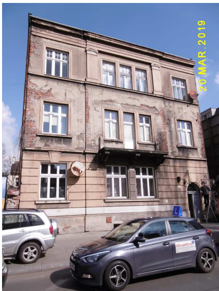
Fot. nr 472. Modernistyczna kamienica pod nr 15.
