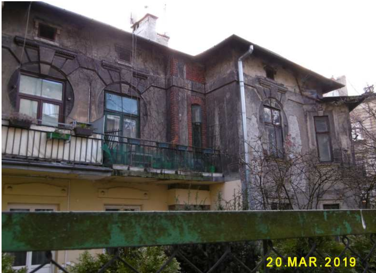
Fot. nr 479. Piętro fasady od strony ulicy Grabowskiego.
