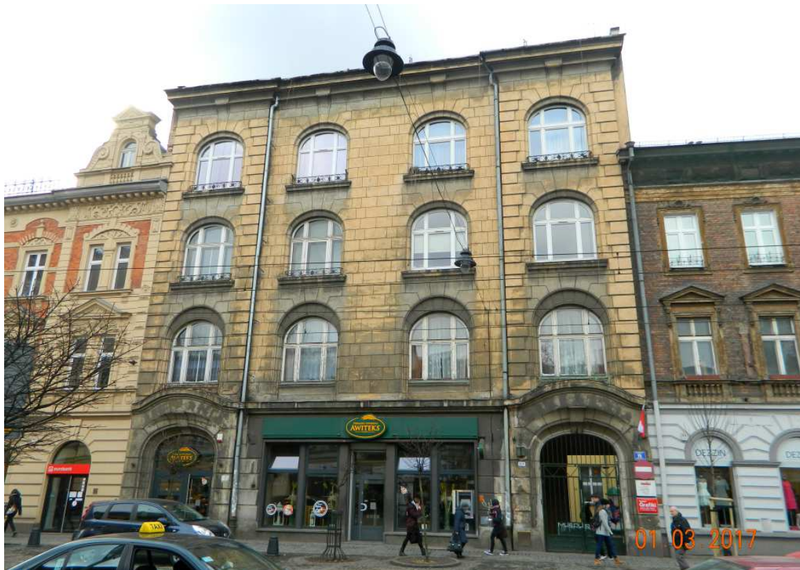
Fot. nr 140. Kamienica pod nr 16, która powstała w latach 1910-1911 wg projektu Wawrzyńca Karselera.
