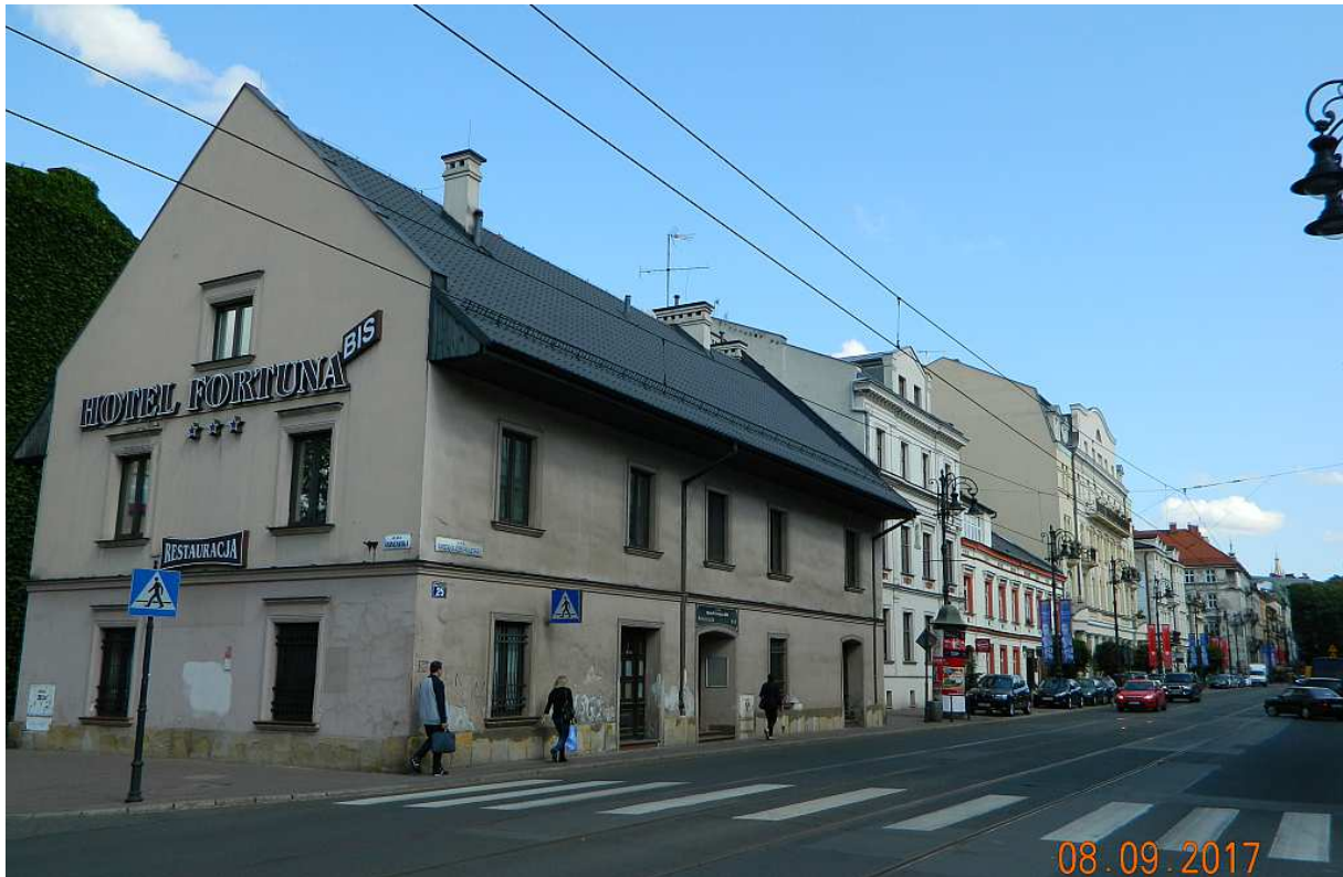
Fot. nr 173 (173-186). Widoki ulicy Piłsudskiego. Tu fragment o nieparzystych numerach od ulicy Garncarskiej w stronę Plant.
