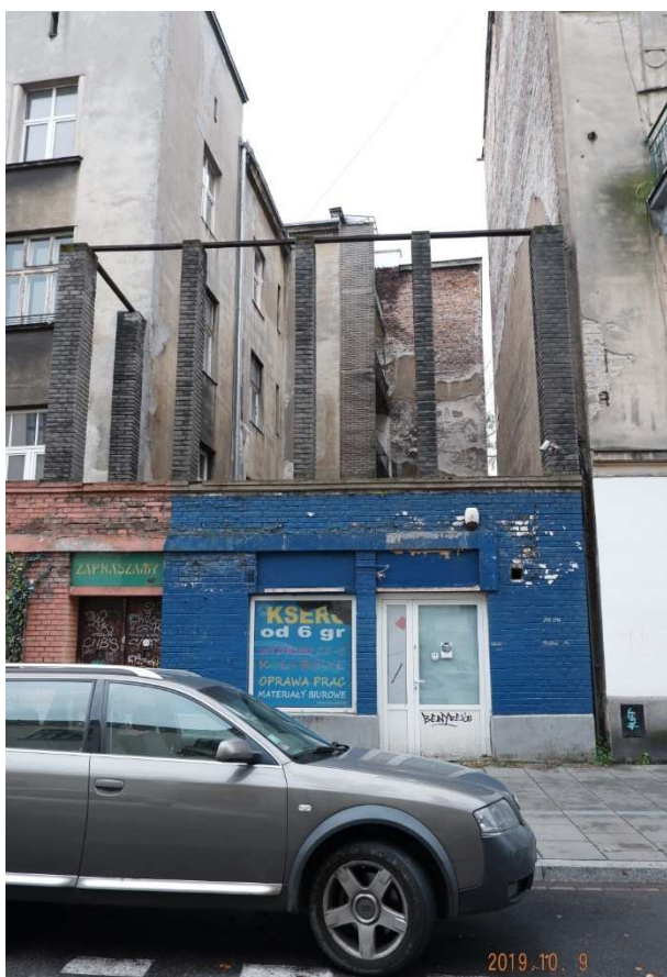
Fot. nr 578. Ostały jeszcze filary wiszącego (kiedyś) ogrodu przy kamienicy pod nr 20.
