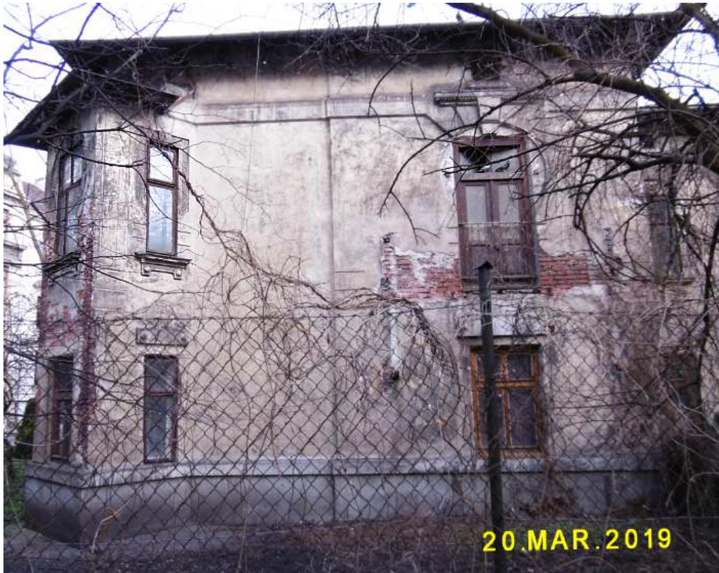
Fot. nr 477 (477-478). Wykusz w narożniku, a nim oryginalne okna I piętra.
