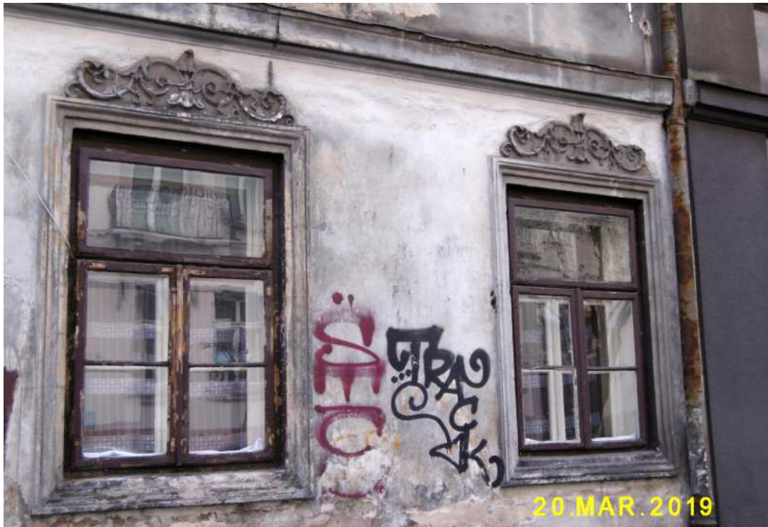
Fot. nr 493. Ostatnie oryginalne okna w prawej części parteru.
