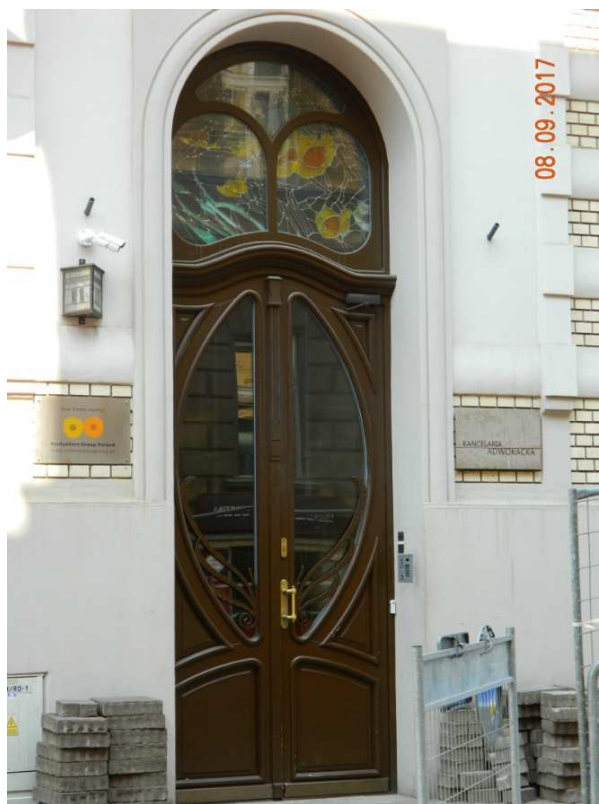
Fot. nr 182 (182-183). Udana próba odtworzenia dawnych drzwi i ich zwieńczenia w postaci witrażu.
