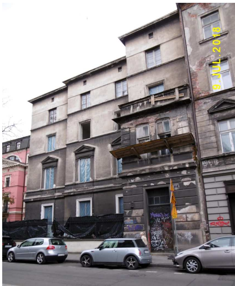
Fot. nr 379. Kamienica z ulicy Krupniczej 18 ciągle na etapie remontu.
