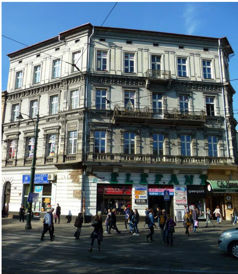
Fot. nr 269. Kamienica z naroża ulic: Podwale 7 i Krupniczej 2. (17.10.2017)
