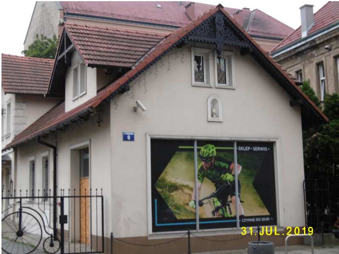
Fot. nr 535. Ciekawa brama niskiego domu z ulicy Czarnowiejskiej 8.
