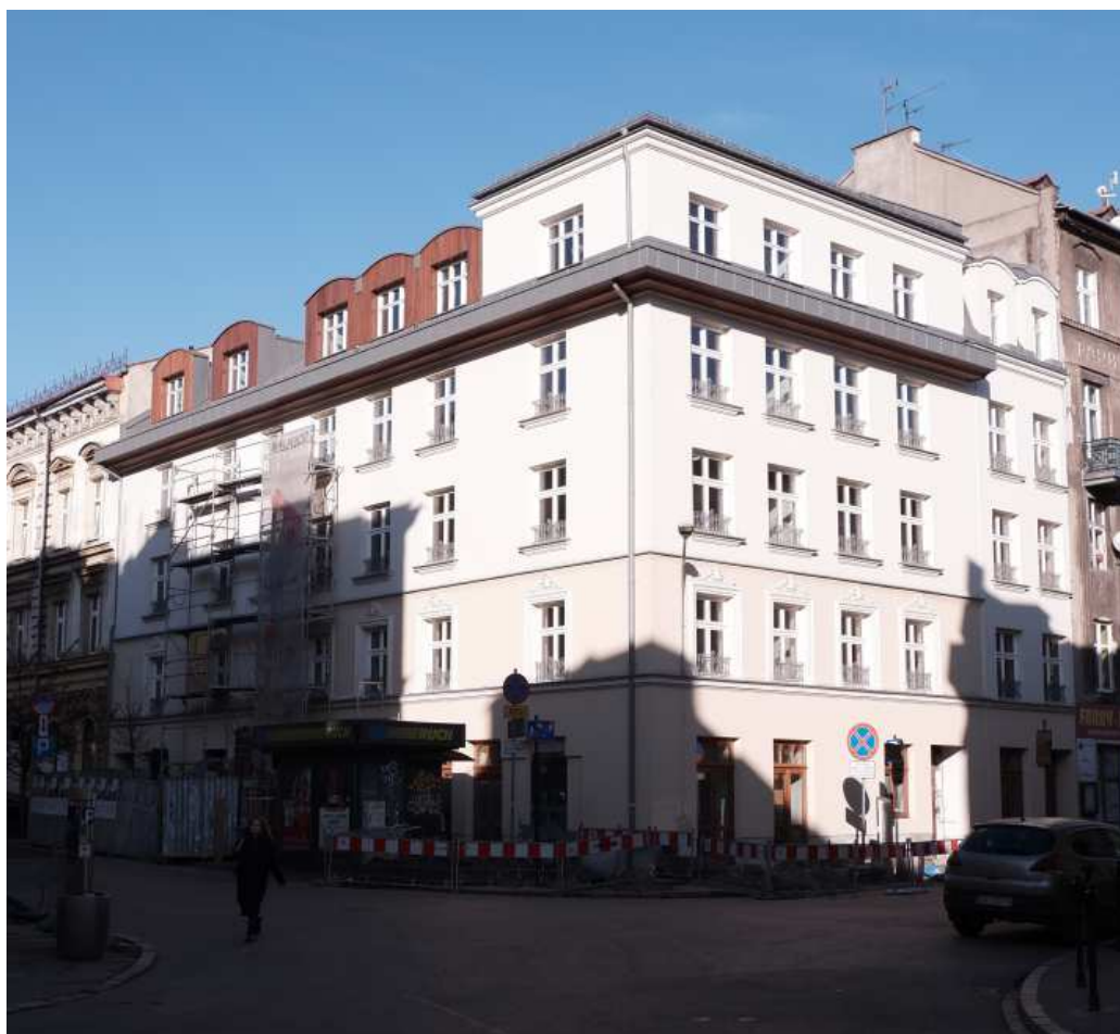
Fot. nr 377. Pretekstem do przesadnie wysokiej nadbudowy stał się pożar. (01.12.2019)
