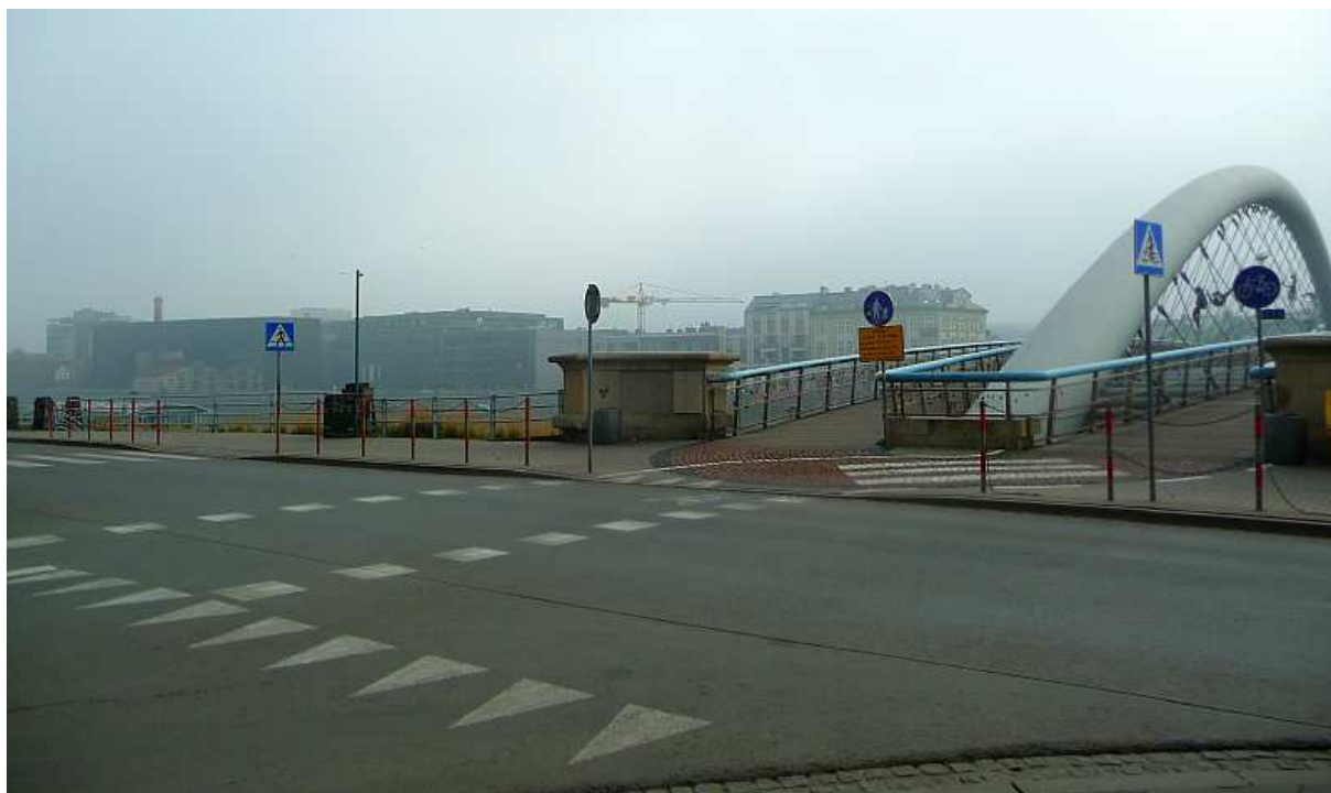
Fot. nr 299 (299-301). Kładka ojca Bernatka, która została zbudowana w miejscu starego mostu podgórskiego na jego zachowanych przyczółkach. (07.11.2018)
