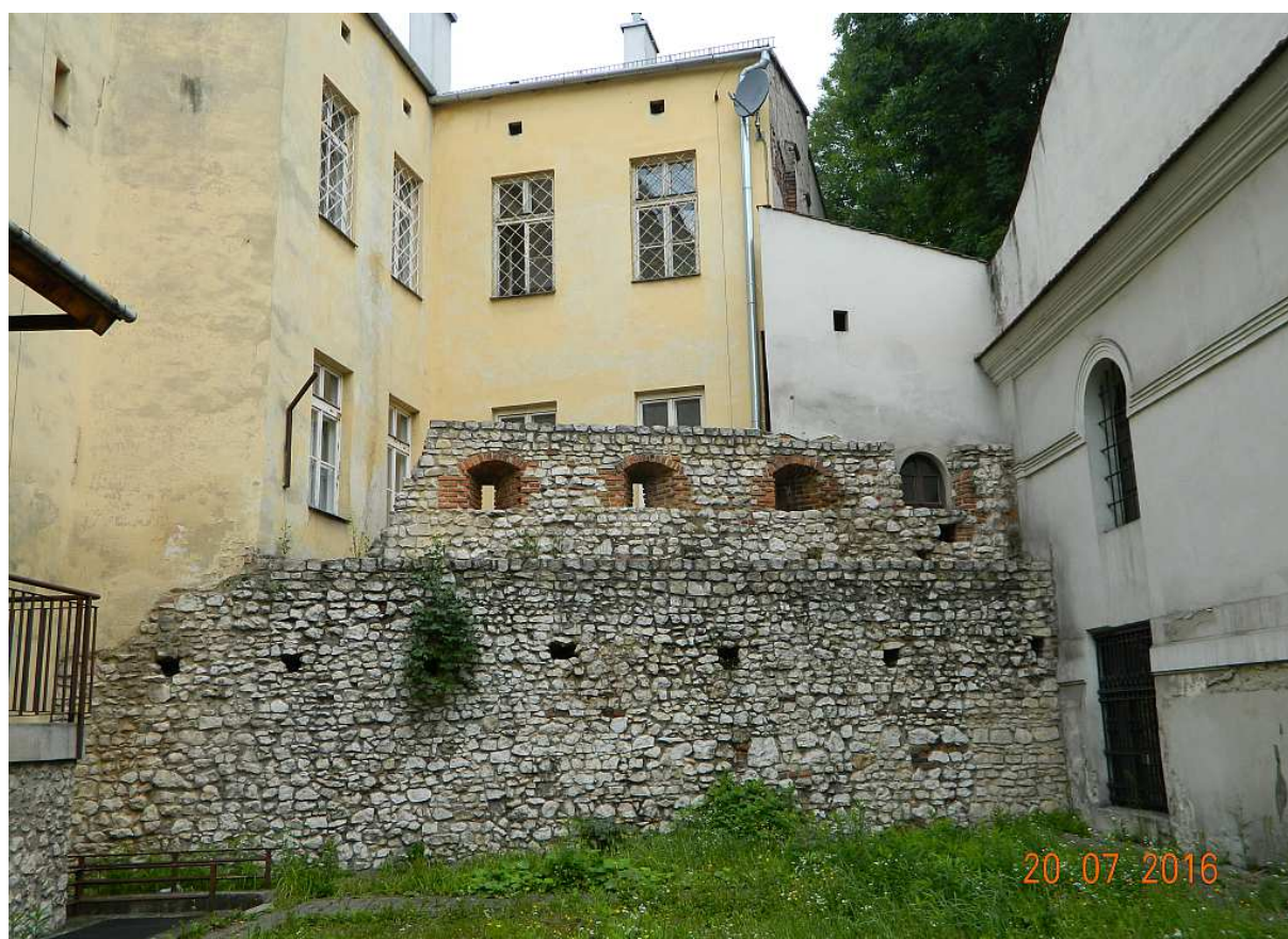
Fot. nr 157. Fragment średniowiecznego muru obronnego przy Bożnicy Kupa.
