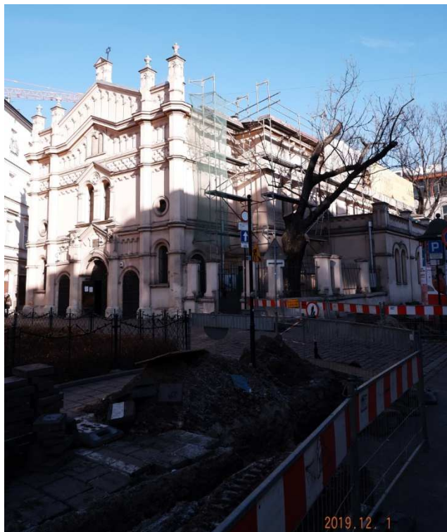
Fot. nr 374. Fasada bożnicy.
