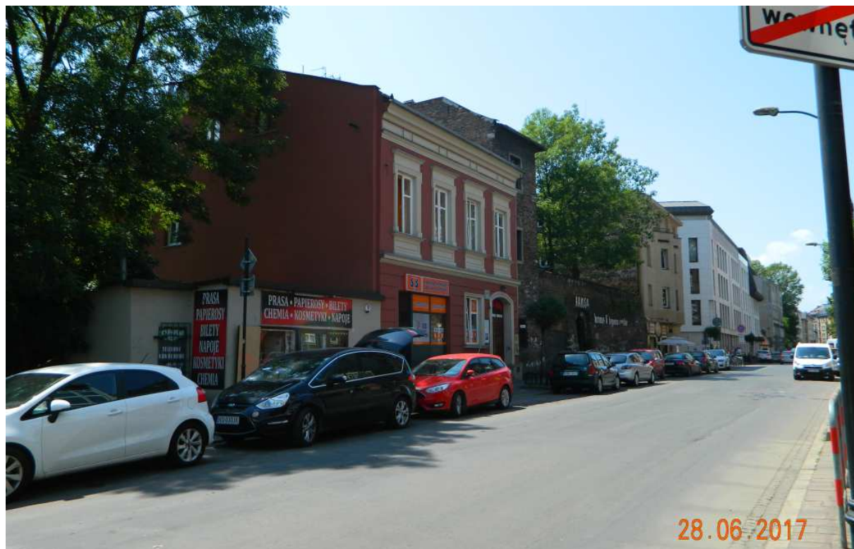
Fot. nr 178. Fragment ulicy Miodowej w ujęciu od strony ulicy Starowiśnej.
