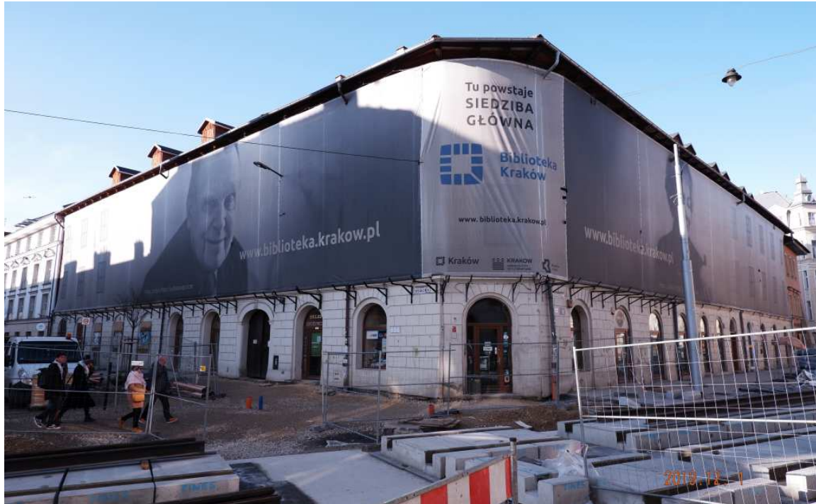
Fot. nr 389. Dawny Zajazd Kazimierski pod nr 21 na etapie remontu.
