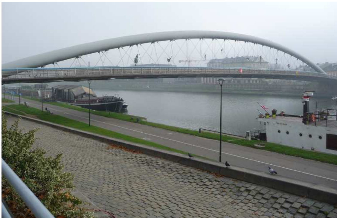
Fot. nr 301. W stronę ulicy Nadwiślańskiej. (07.11.2018)
