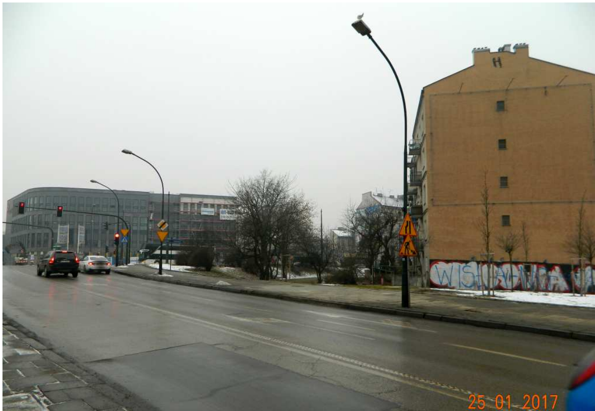
Fot. nr 168. Nowo zabudowany, końcowy fragment ulicy Starowiśnej w sąsiedztwie dawnych budynków elektrowni krakowskiej – widok z ulicy Podgórskiej.
