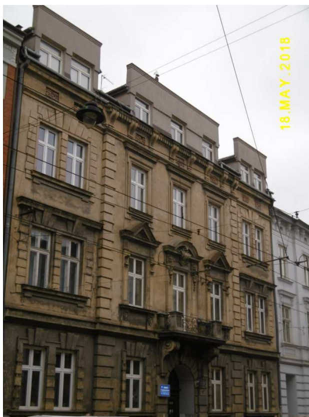
Fot. nr 191. Szpetna nadbudowa budynku pod nr 34.
