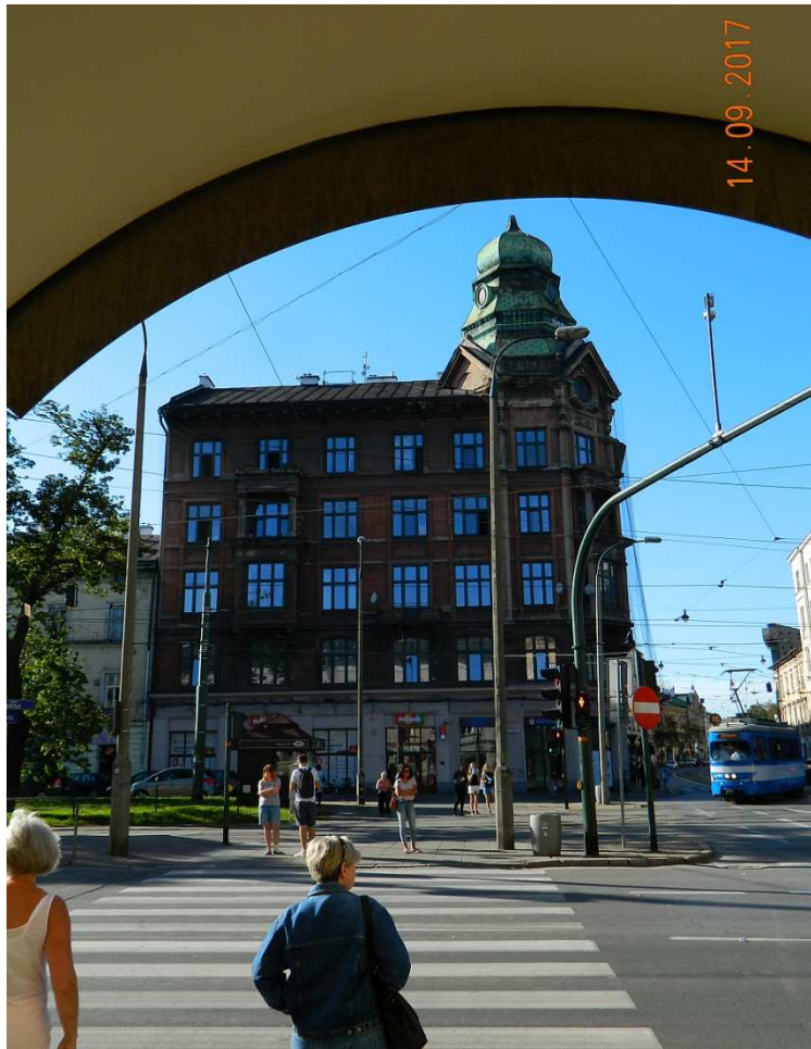
Fot. nr 7 (7-8). Oczekująca na kompleksowy remont kamienica Orensteina z ulicy Dietla 42, która powstała w latach 1911-1913 wg projektu Jana Zawiejskiego.
