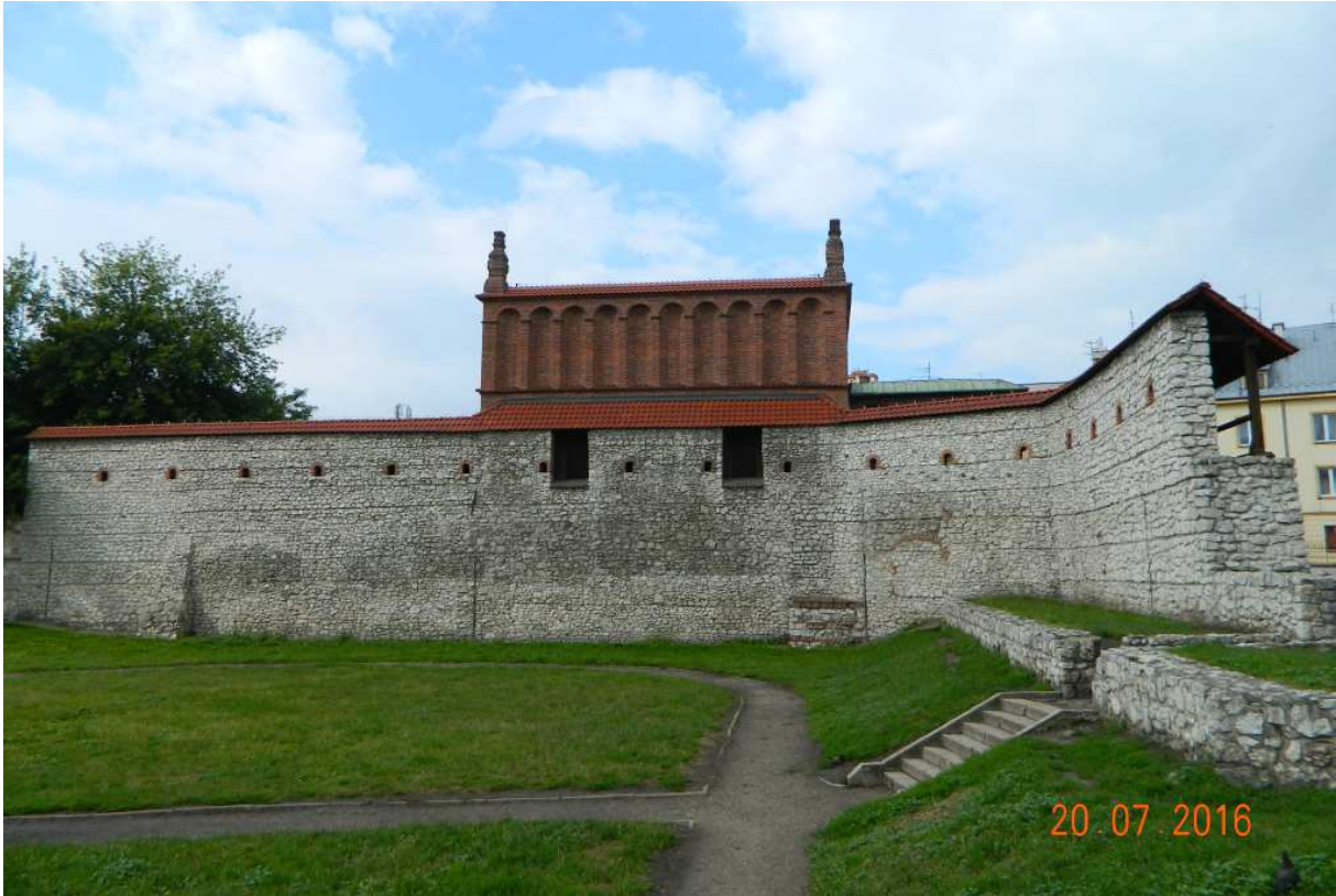
Fot. nr 110. Częściowo zrekonstruowany fragment muru obronnego Kazimierza w sąsiedztwie Starej Bożnicy – widok z ulicy Dajwór.
