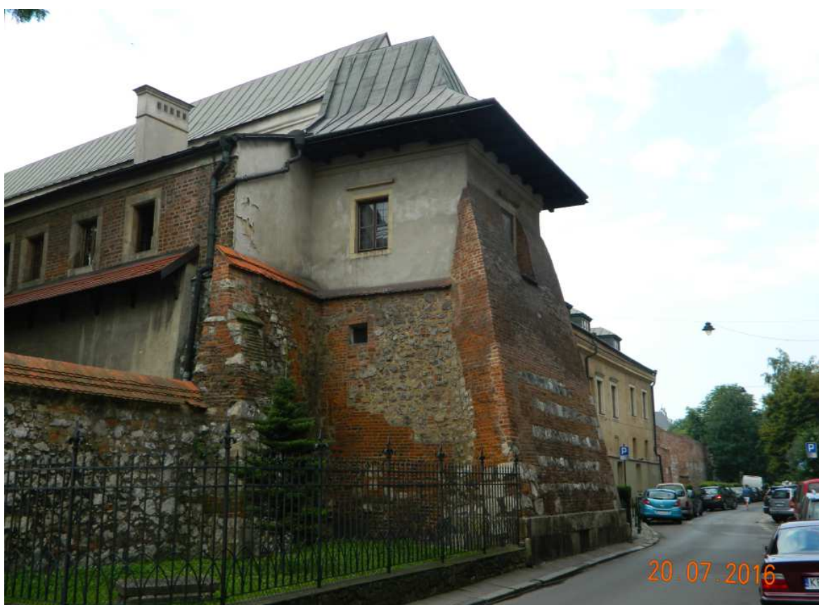
Fot. nr 139. Wzdłuż ulicy Paulińskiej – widok ze styku z ulicą Augustiańską. Na pierwszym planie dawna baszta w zespole murów obronnych Kazimierza (w tle).
