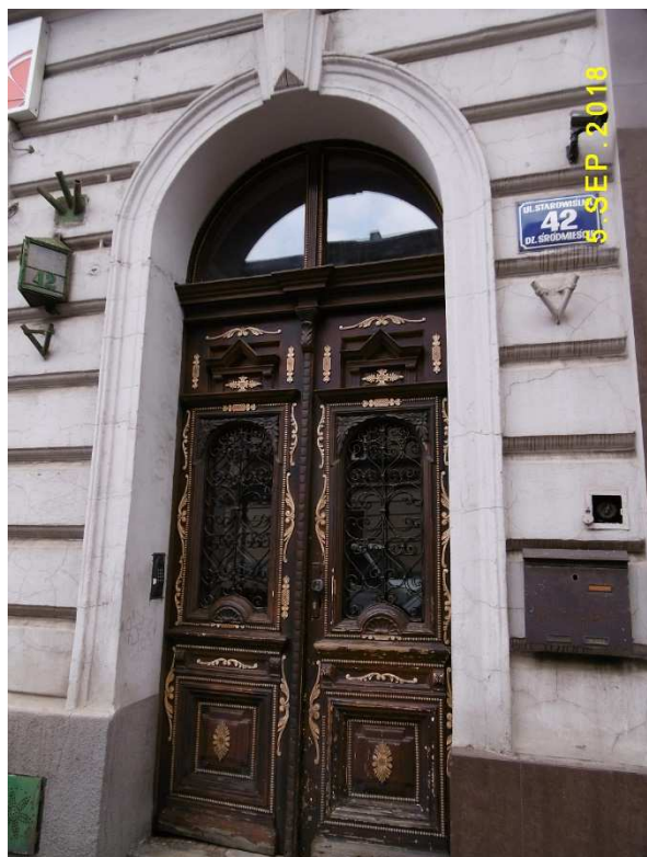
Fot. nr 225. Wzorcowo odrestaurowane drzwi kamienicy z ulicy Starowiśnej 42. Żeby jeszcze została odtworzona klamka.....
