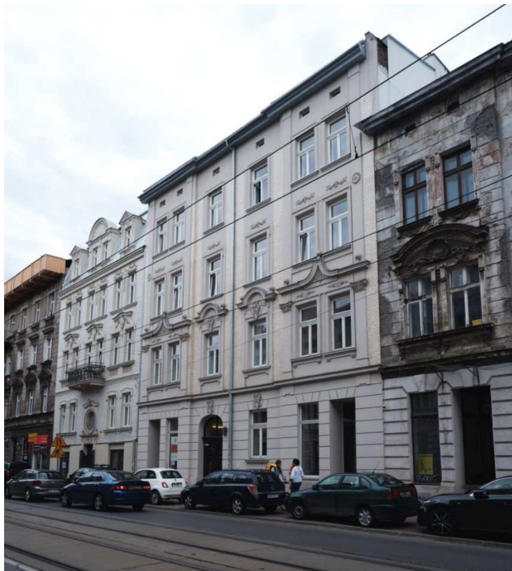
Fot. nr 478. Wyremontowane kamienice przy ulicy Starowiślniej 41 i 43. (01.08.2021)
