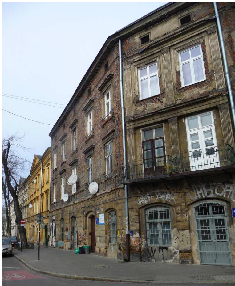
Fot. nr 289 (289-290). Migawki z ulicy Mostowej. Widoki ze styku z ulicą Trynitarską. Tu w stronę placu Wolnica. (07.11.2018)
