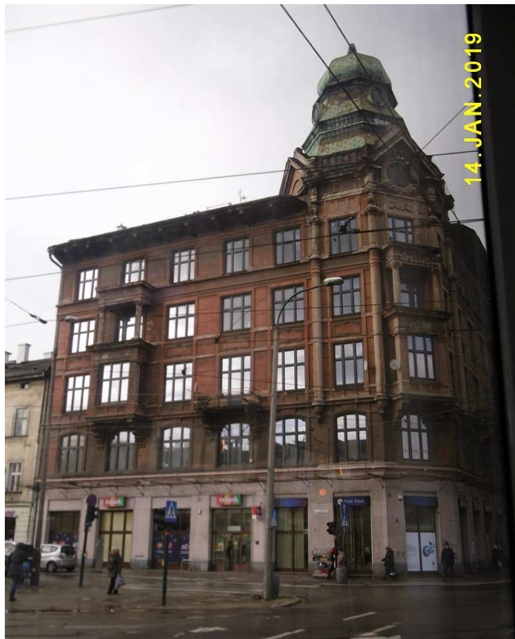
Fot. nr 27. Pełna architektonicznej ekspresji, choć pozbawiona iglicy, kamienica Ohrensteina z ulicy Dietla 42, która od lat nie może się doczekać sensownego remontu.
