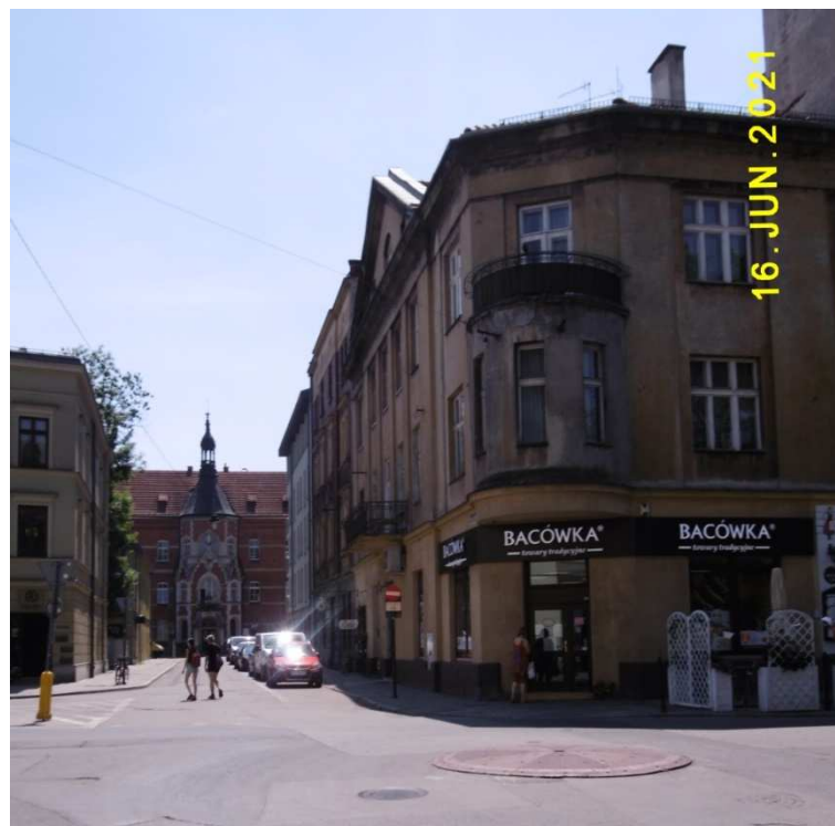
Fot. nr 437 (437-438). Z prawej kamienica przy placu Wolnica 12.
