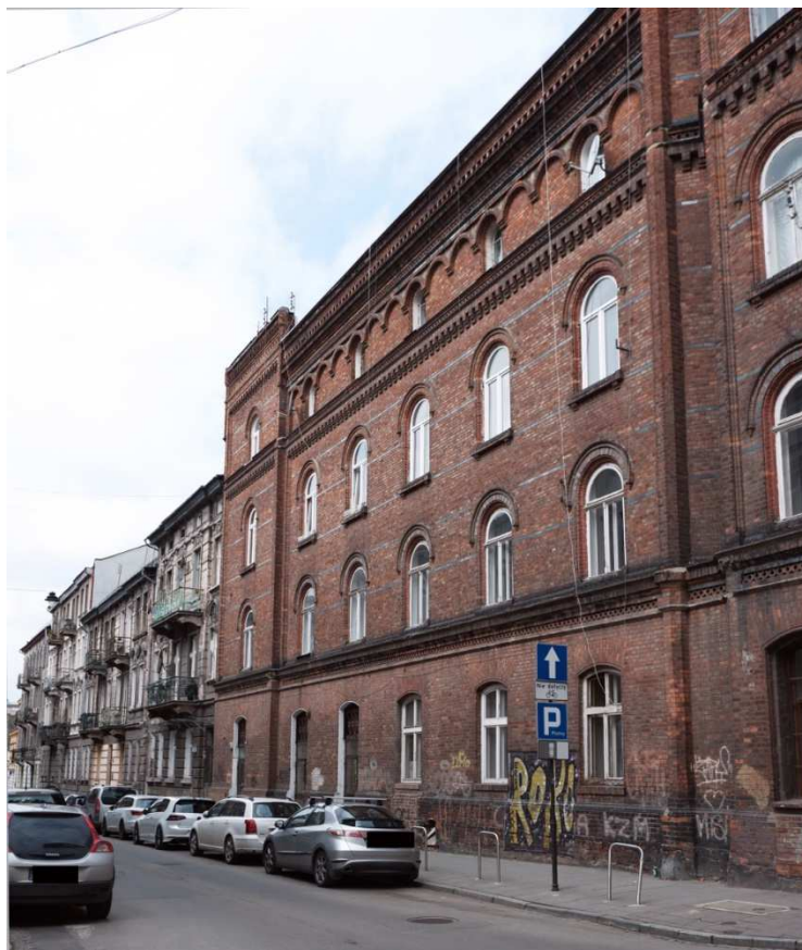
Fot. nr 51 (51-59). Wzdłuż ulicy Kołek. Widok z ulicy św. Anieszki. (25.04.2021)
