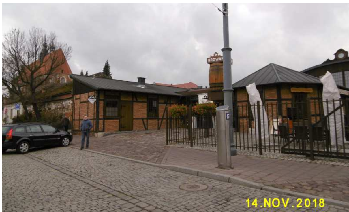
Fot. nr 273 (273-275). Zabudowania dawnej zajezdni tramwajowej przy ulicy św. Wawrzyńca 12.
