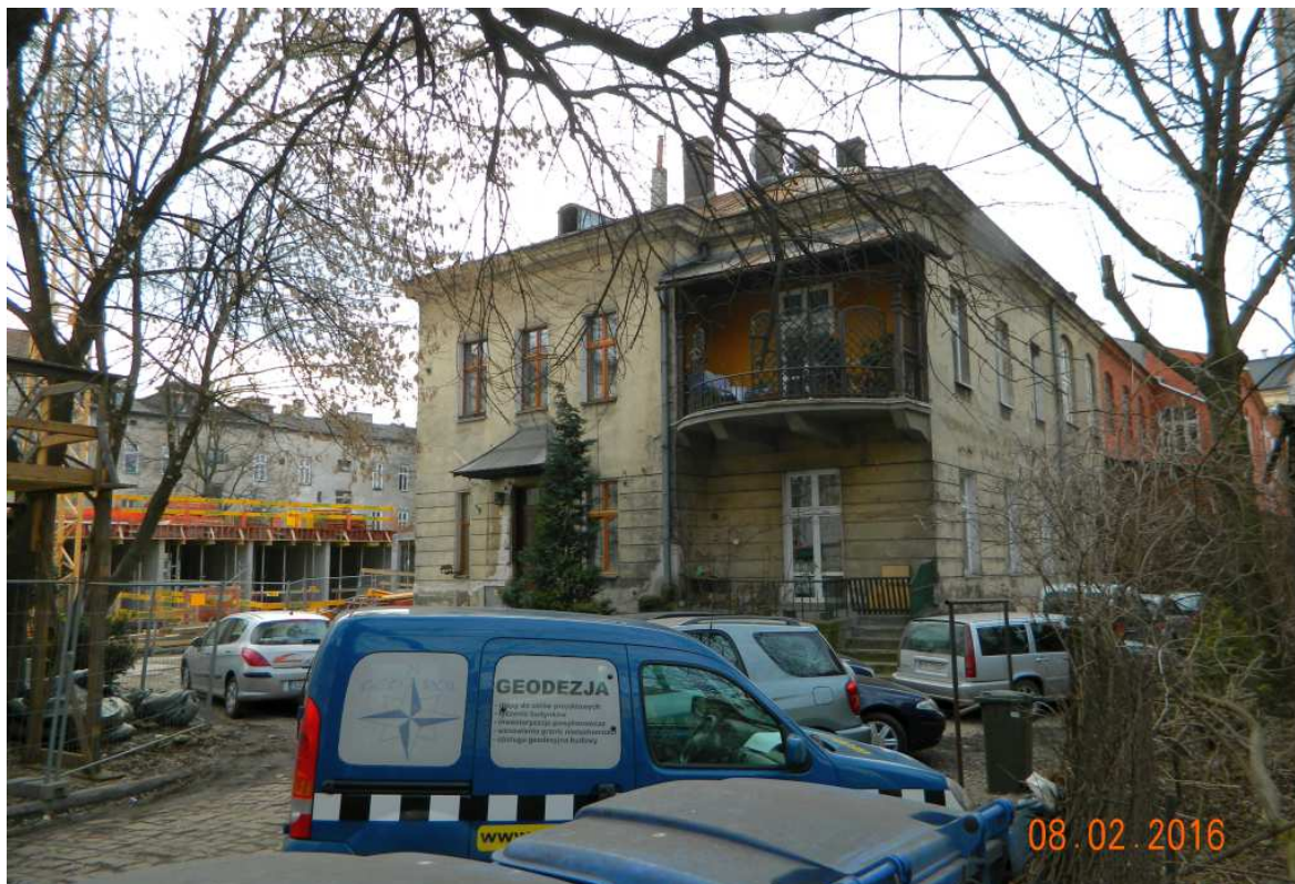
Fot. nr 73. Trwa zabudowa działki pod nr 91, usytuowanej w sąsiedztwie dawnej willi Zofii Stryjeńskiej przy ulicy Starowiślnej 89.
