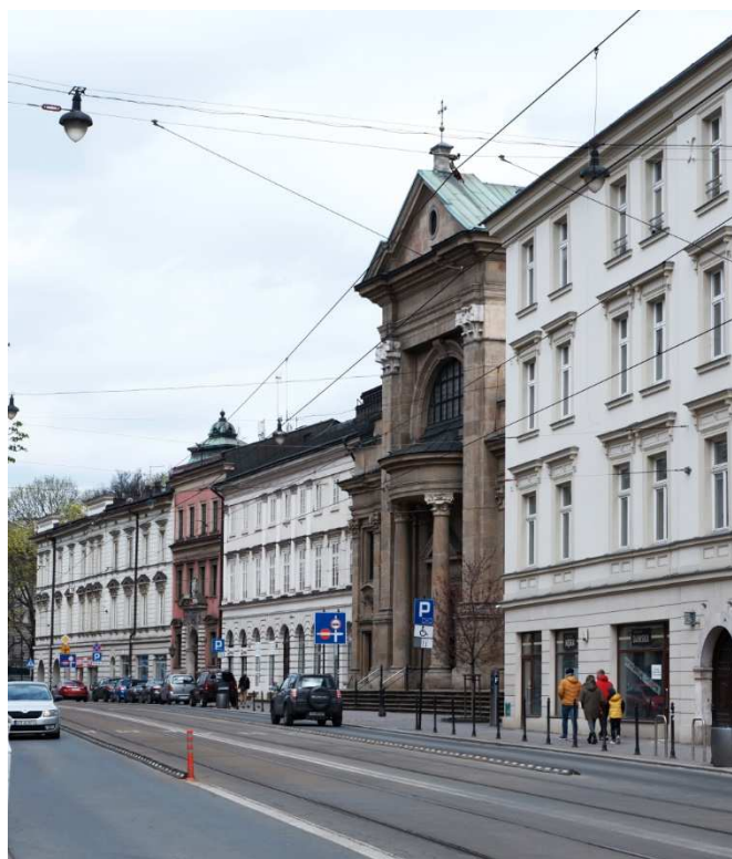
Fot. nr 45. Fragment zabudowy poniżej numeru 10. (25.04.2021)
