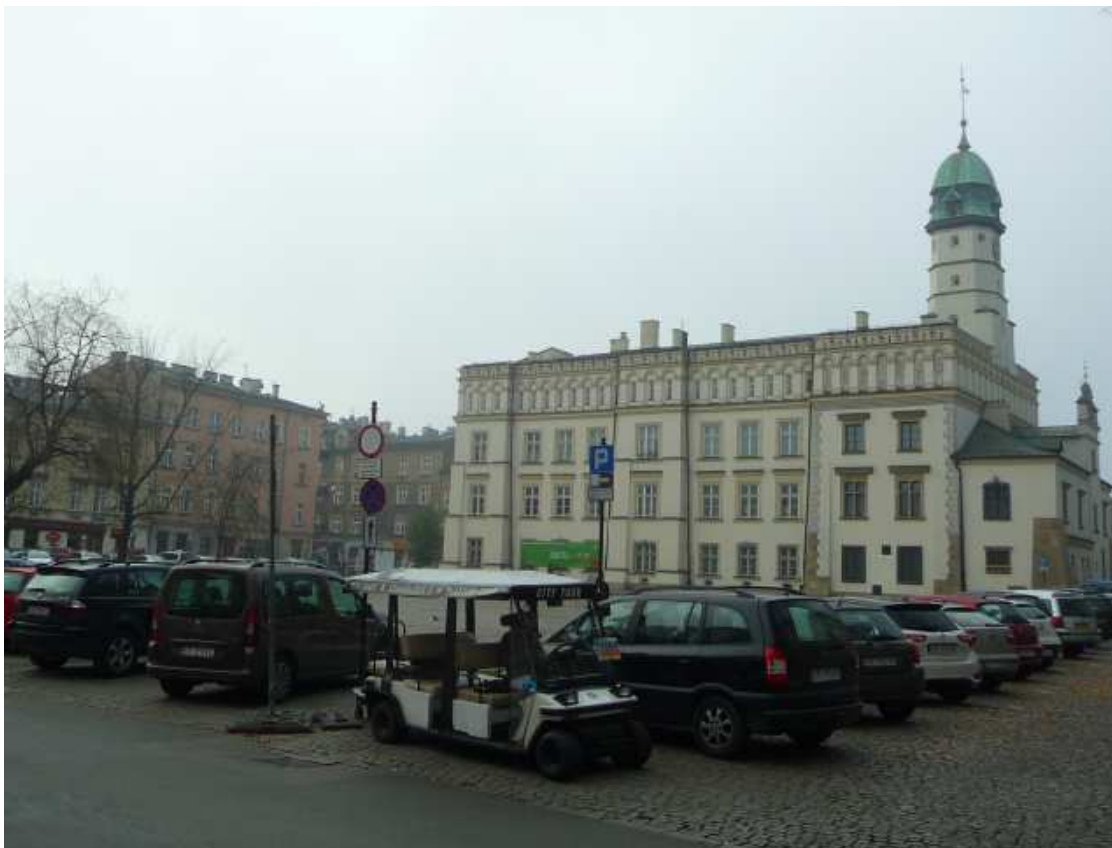
Fot. nr 285 (285-287). Ratusz kazimierski, rozbudowany w latach 1875-76 wg projektu Stefana Żołdaniego. (07.11.2018)
