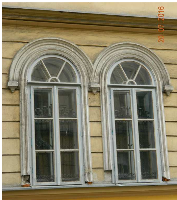
Fot. nr 146. Oryginalne okna parteru.
