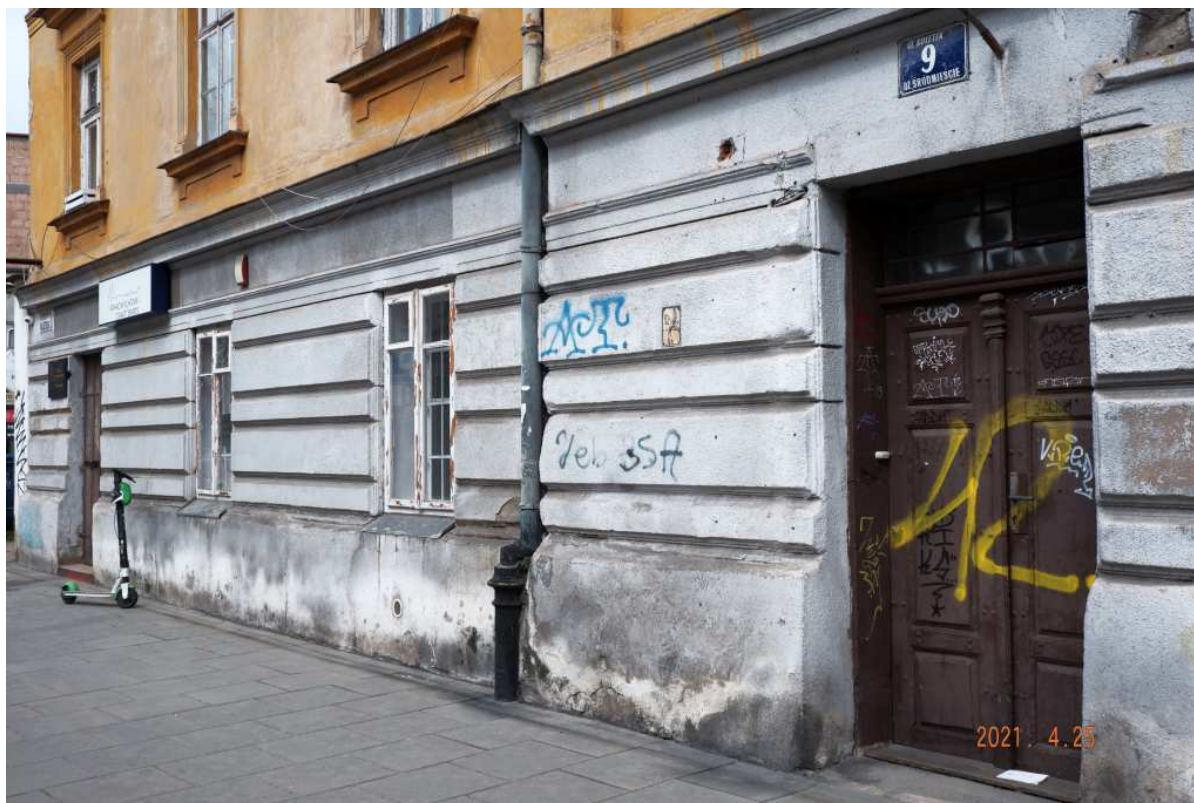
Fot. nr 56 (56-57). Parter z oryginalnymi drzwiami i niespotykanymi już oknami.
