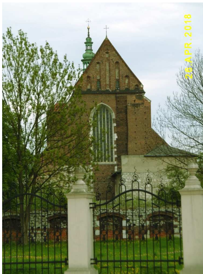
Fot. nr 210 (210-211). Zachodnia ściana szczytowa kościoła św. Katarzyny.
