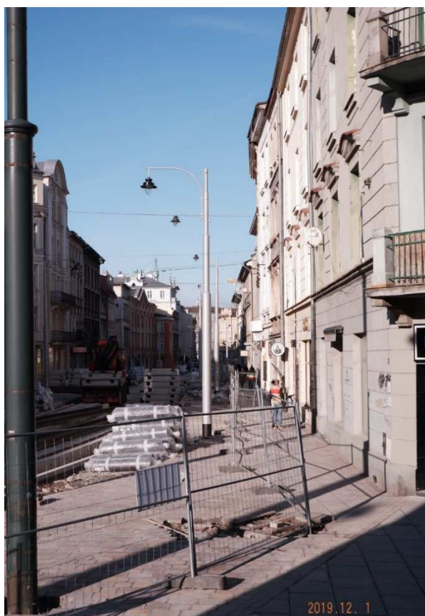
Fot. nr 387. Widok z placu Wolnica w stronę ulicy Dietla.
