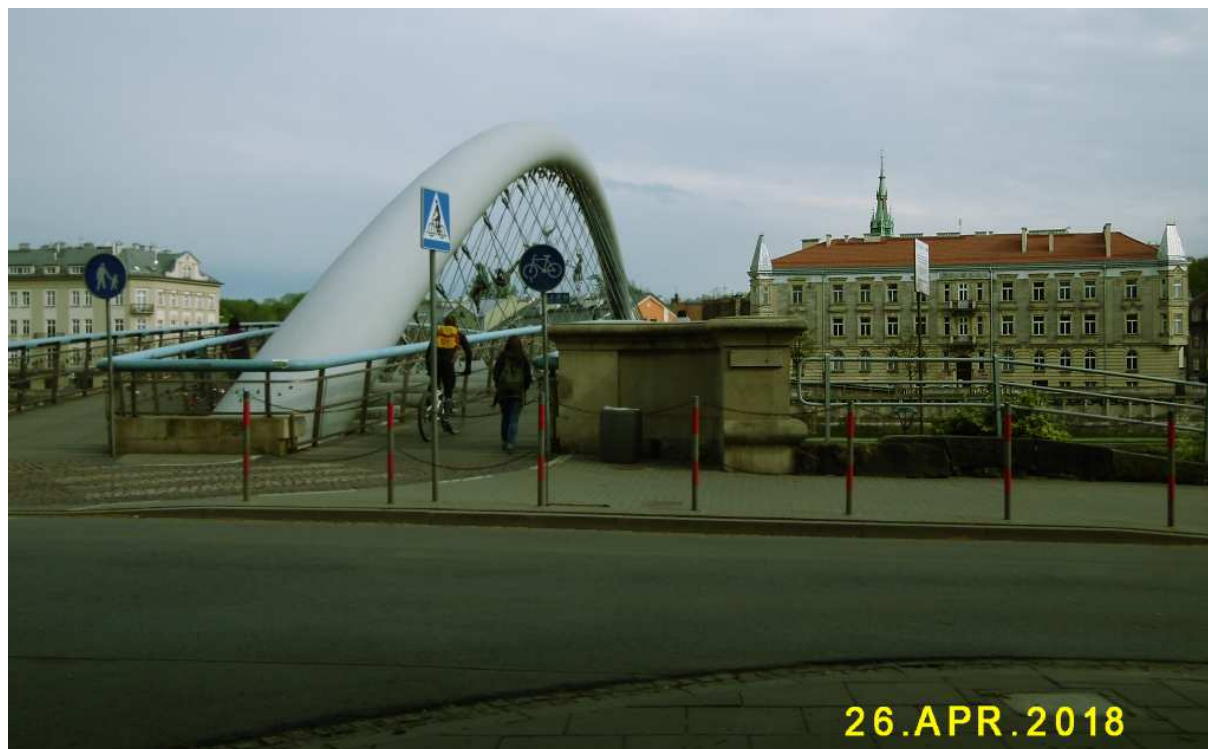
Fot. nr 223. Ponad kładką o. Bernatka w stronę Podgórze.
