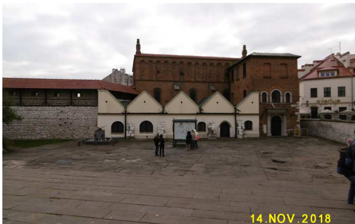
Fot. nr 245 (245-246). Stara Synagoga i przylegający do niej fragment muru obronnego.
