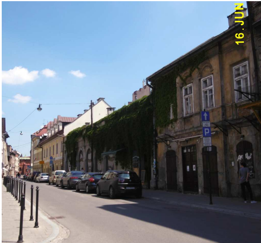
Fot. nr 468. Fragment zabudowy od nr 15 ku Starej Bożnicy (w tle).
