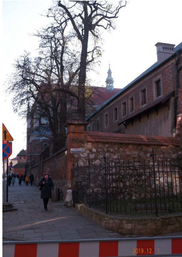
Fot. nr 406 (406-407). Wzdłuż ulicy Augustiańskiej i murów klasztoru Augustianów.
