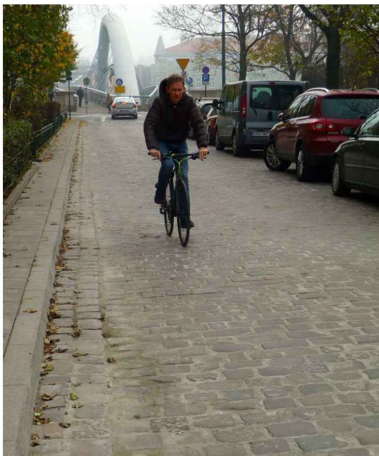
Fot. nr 298. Końcowy fragment ulicy Mostowej z kładką o. Bernatka w tle. Przetrwiała tu jeszcze tradycyjna nawierzchnia z kostki porfirowej. (07.11.2018)
