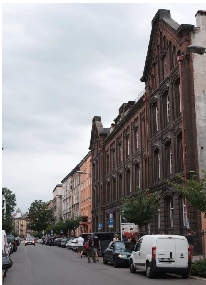
Fot. nr 475. Fragment zabudowy ulicy Miodowej poniżej budynku dawnej Szkoły Miejskiej im ks. Piramowicza, dziś SP nr 11, pod nr 36. (01.08.2021)
