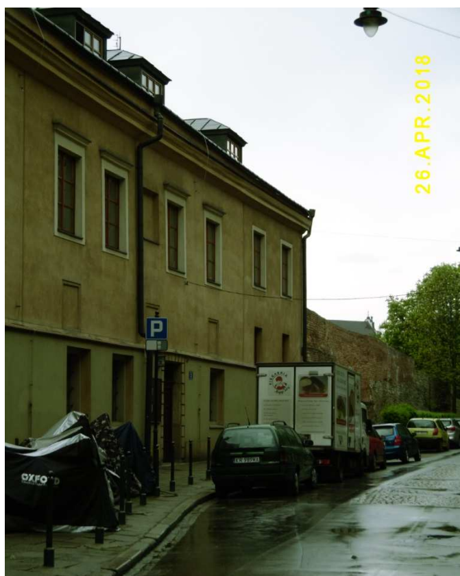
Fot. nr 195. Budynek klasztorny przy baszcie.
