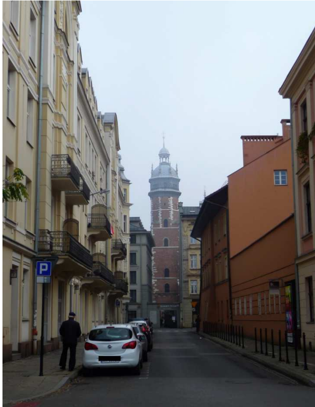
Fot. nr 341 (341-345). Różne ujęcia wieży i fasady kościoła Bożego Ciała od strony zachodniej. Fot. nr: 238-239 – ponad ulicą Skąteczną. (07.11.2018)
