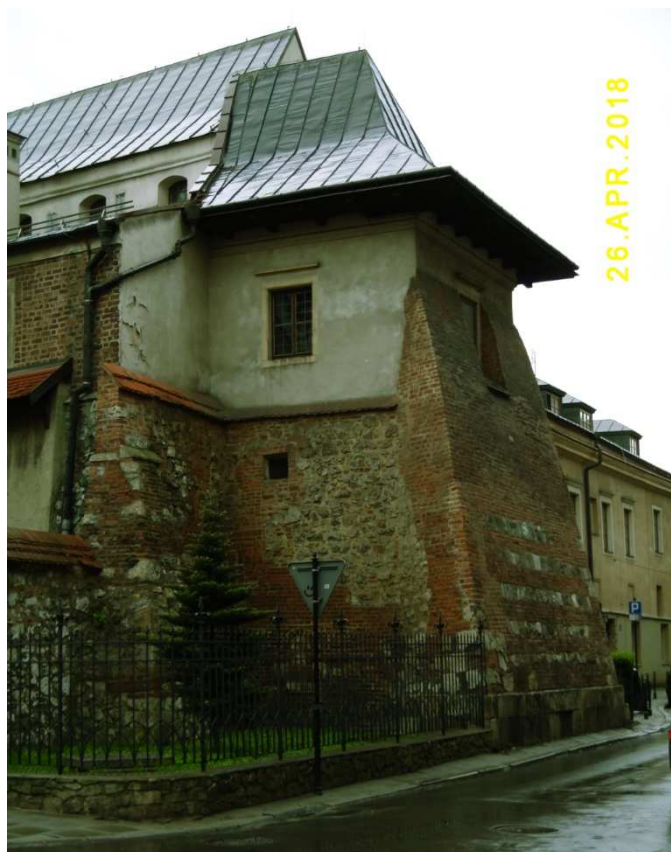
Fot. nr 194 (194-200). Wzdłuż ulicy Paulińskiej i fragmentów murów obronnych dawnego Kazimierza. Tu baszta obronna w narożu z ulicą Augustiańską.
