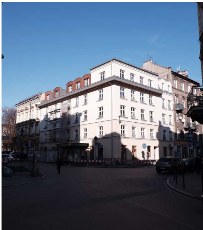
Fot. nr 376 (376-377). Nadbudowany o dwa piętra dom pod nr 10. (01.12.2019)
