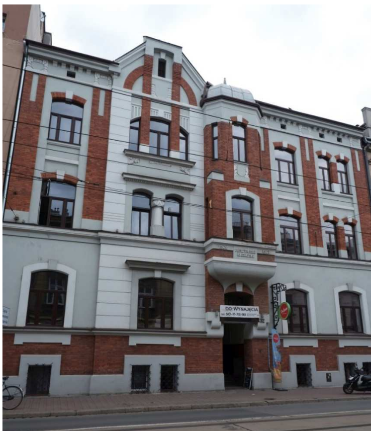
Fot. nr 479. Przykład solidnie odnowionej kamienicy z ulicy Starowiślniej 32. Ten ciekawy z uwagi na styl budynek z roku 1902 zaprojektował Ferdynand Liebling. (01.08.2021)
