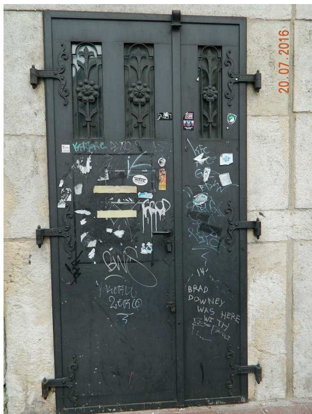
Fot. nr 156. Zrekonstruowane secesyjne drzwi.
