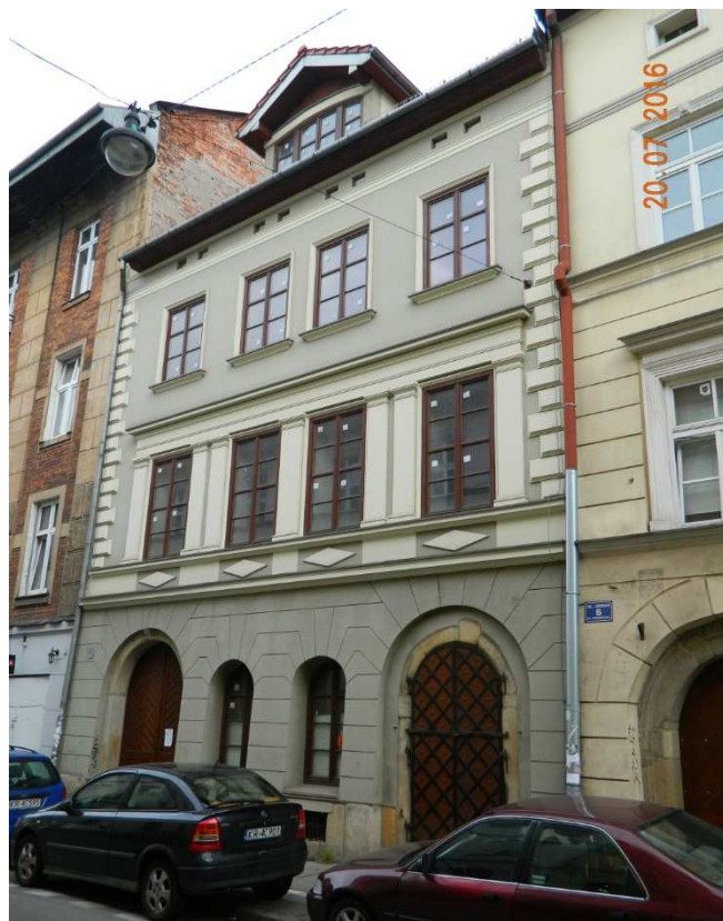
Fot. nr 125. Niedawno odnowiona kamieniczka z ulicy Józefa 4, zszpecona nadbudówką.
