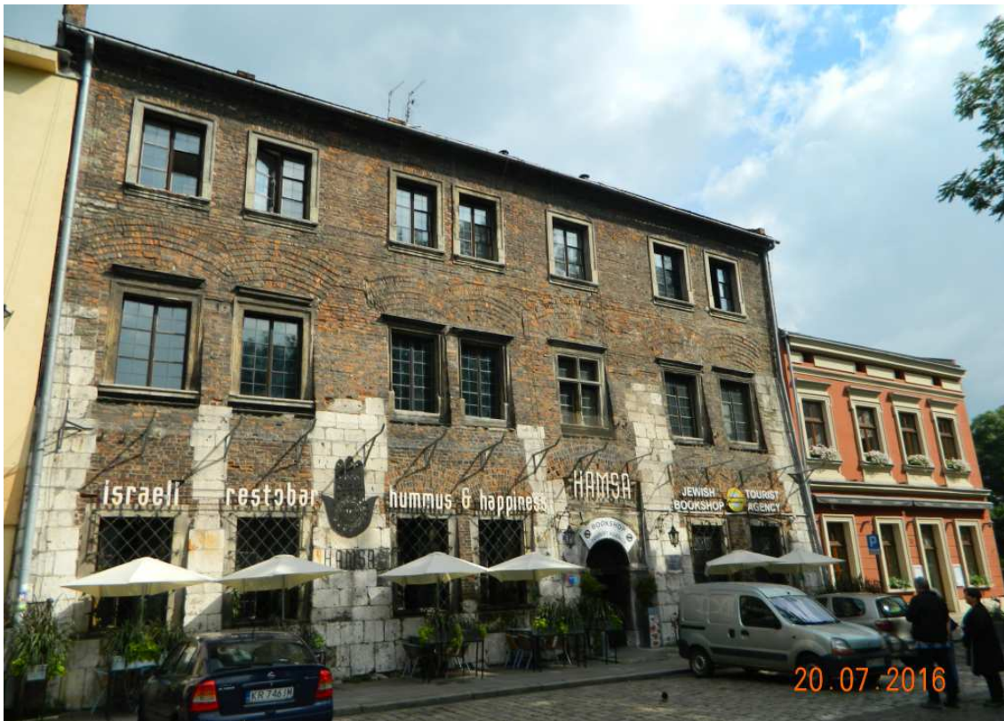
Fot. nr 92. Kamienica Landauów przy ulicy Szerokiej (właściwie Miodowej 41), zwana też pałacem Jordanów, która zamyka południową pierzeję tego placu.
