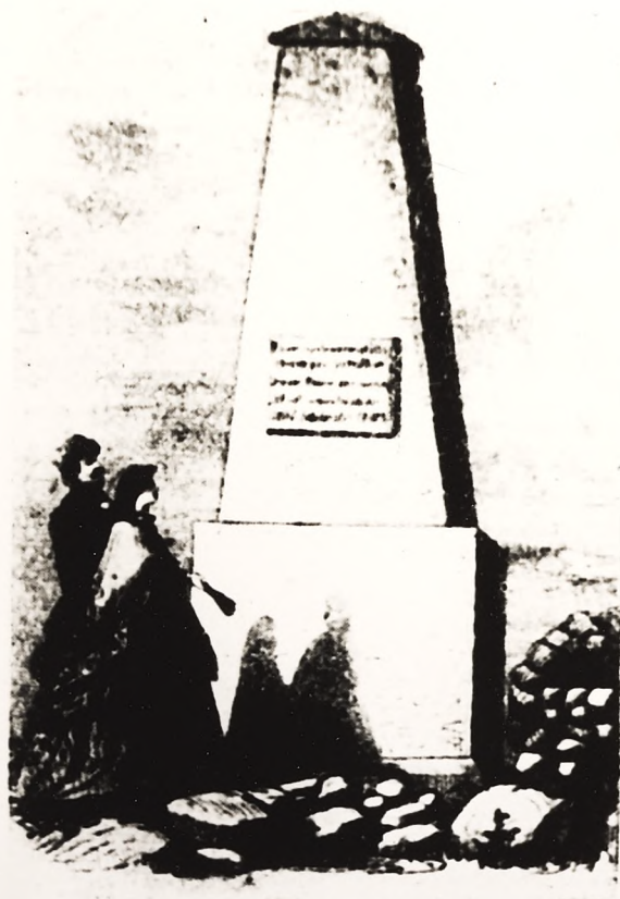
Pomnik na Babiej Górze na cześć pobytu arc. Jozefa w 1806 r., zniszczony w 1849 r.
