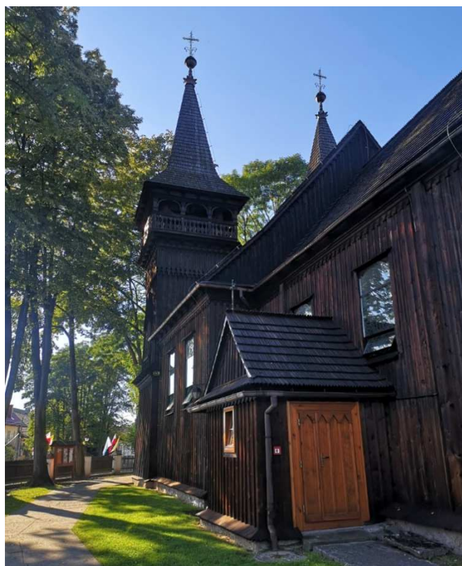
Fot. nr 176. Boczna ściana z kruchtą..
