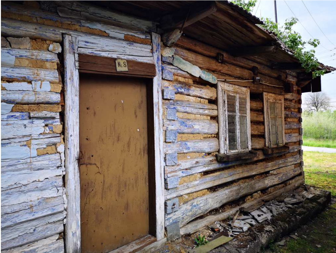
Fot. nr 225. Prawy fragment z częścią mieszkalną.
