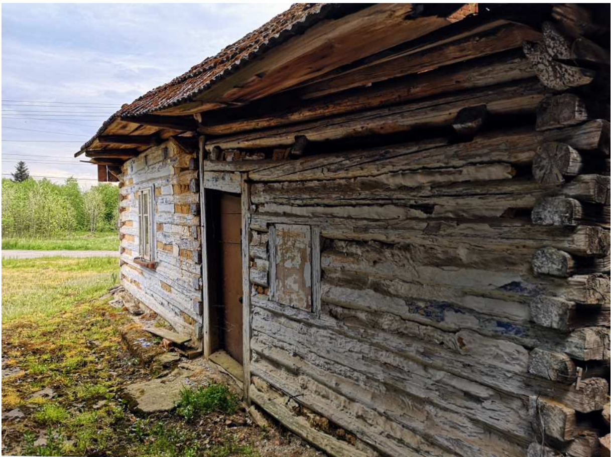
Fot. nr 220 (220-221). Elewacja północna. Tu detale konstrukcji zrębowej.
