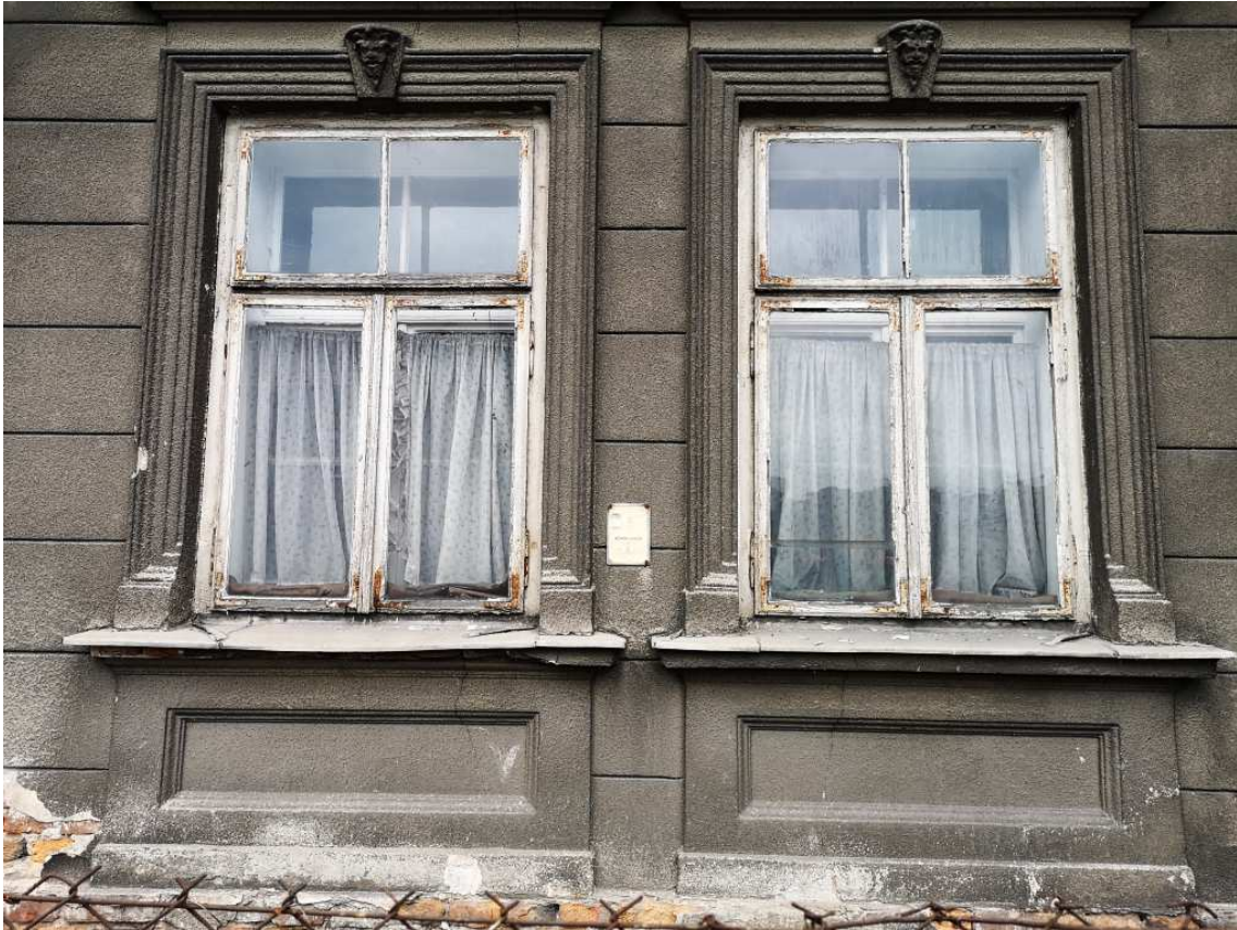
Fot. nr 165. Oryginalne okna trójskrzydłowe.
