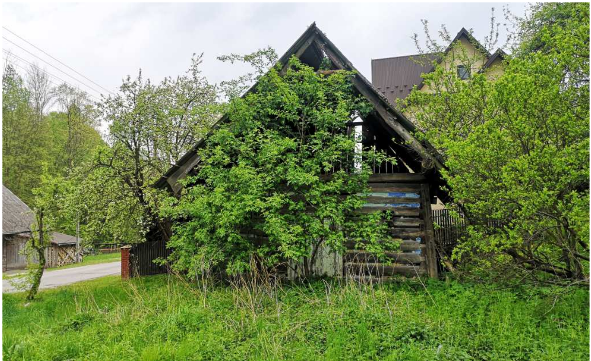
Fot. nr 316. Bielona kiedyś ściana szczytowa.
