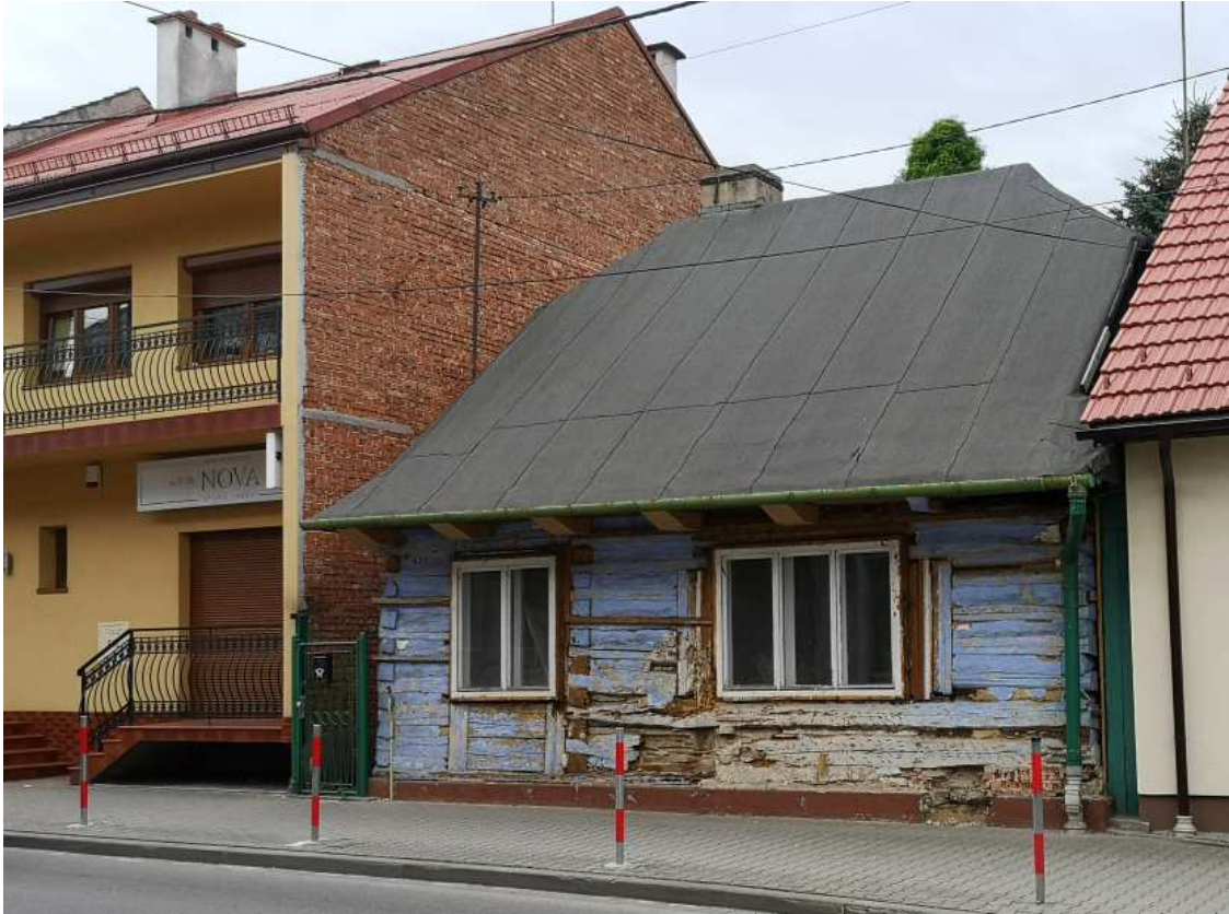
Fot. nr 157 (157-158). Chatka z ulicy Zamkowej 18, wpisana do GEZ. Stan przed remontem.
