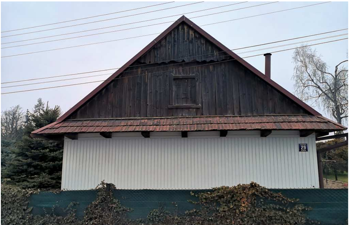
Fot. nr 200. Ściana szczytowa.
