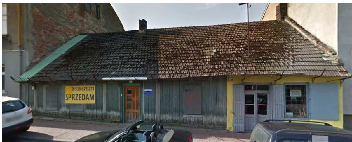
Fot. nr 156. Stan przed remontem (z Google).
