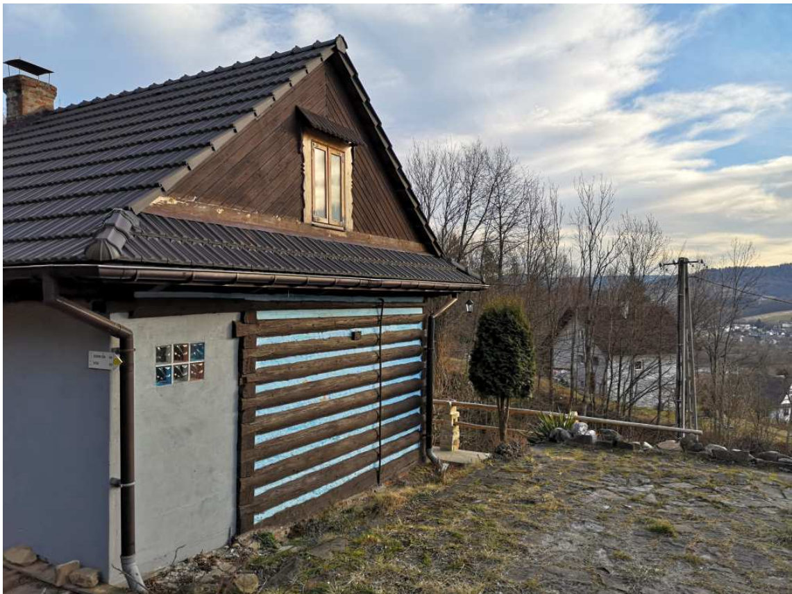
Fot. nr 354. Fragment oryginalnej ściany w domu usytuowanym powyżej obiektu o numerze 250, zapewne spod nr 491.
