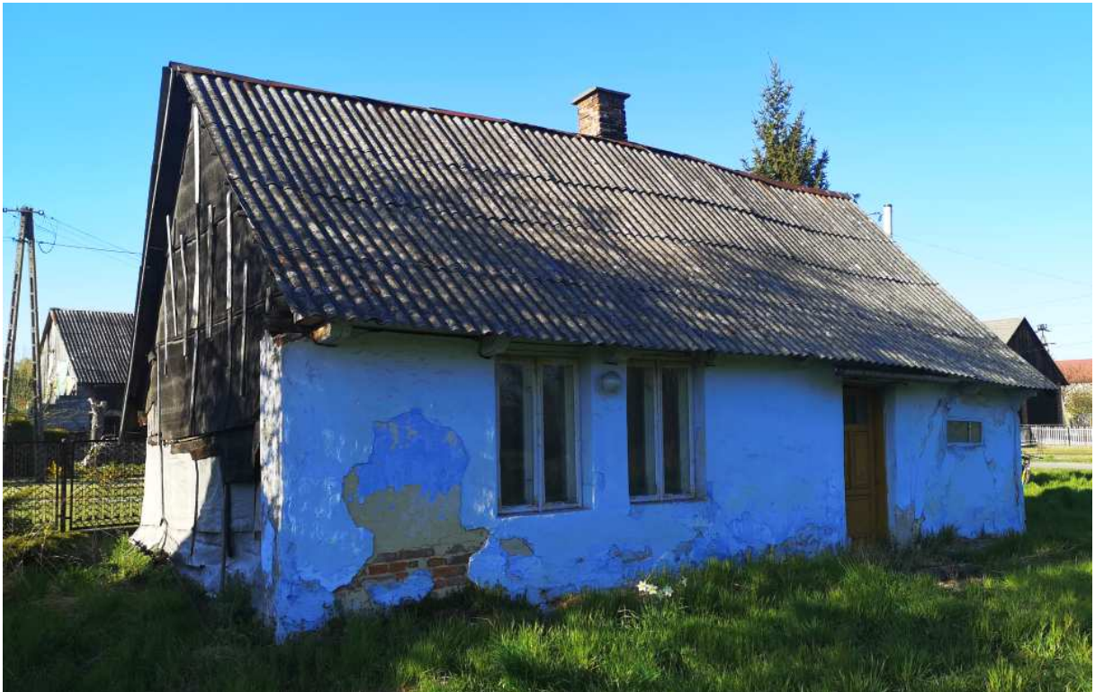
Fot. nr 126. Murowana już fasada domu.
