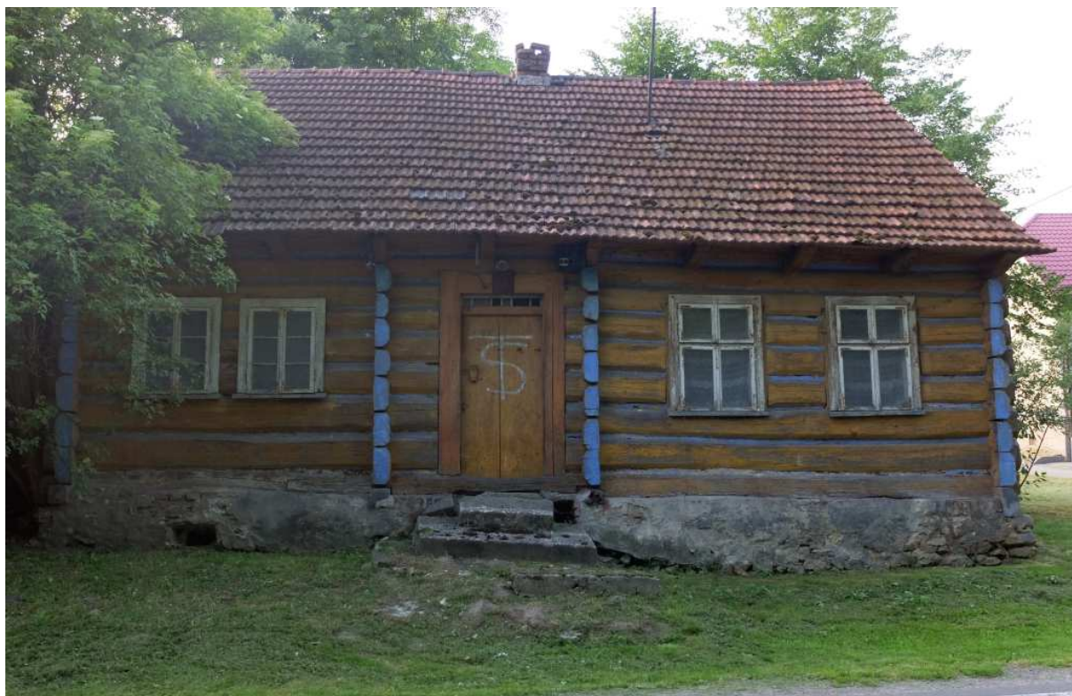
Fot. nr 137. Fasada dwutraktowego domu o konstrukcji zrębowej.
