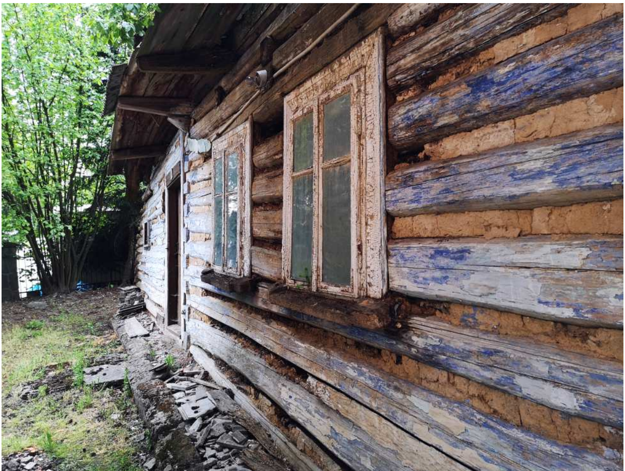
Fot. nr 224 (224-226). Elewacja południowa.
