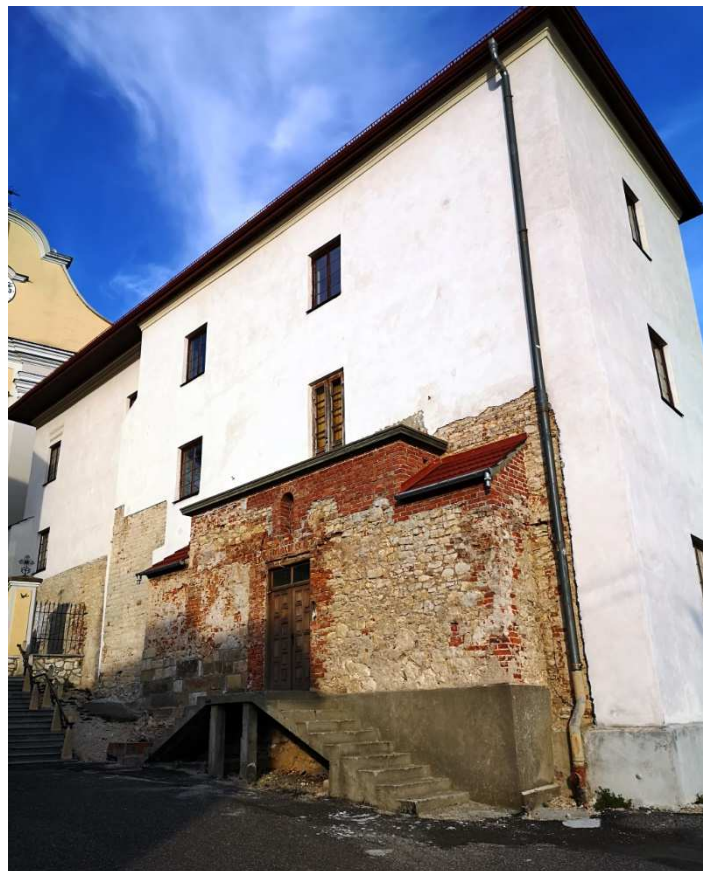
Fot. nr 62. Przebudowany budynek plebanii, który kryje fragmenty murów romańskiego palatium. W XIV wieku pełnił funkcję zamku obronnego.
