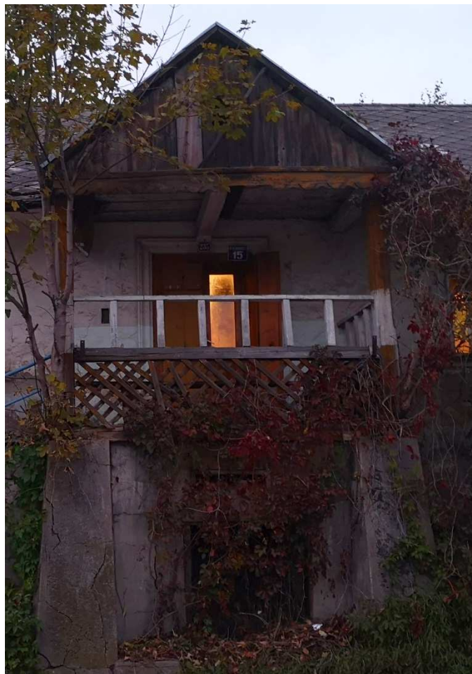
Fot. nr 262. Spojrzenie na odkryty, podparty drewnianymi kolumnami ganek.
