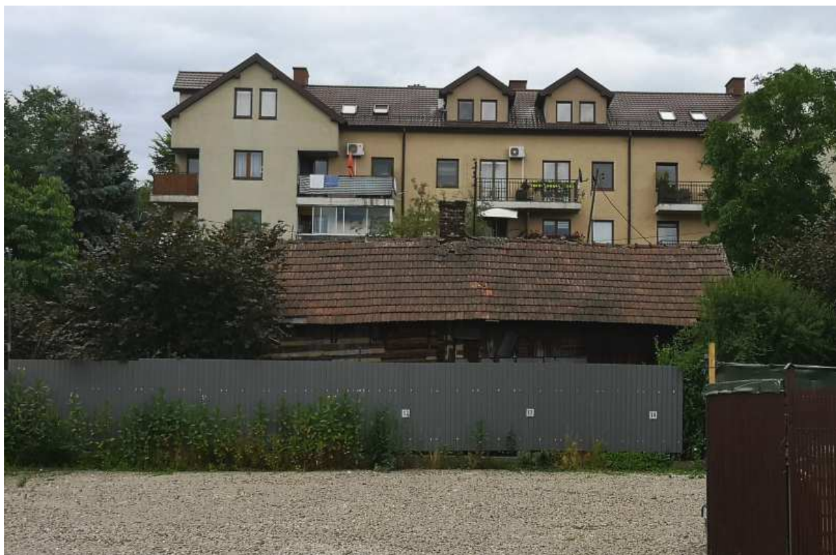
Fot. nr 152 (152-153). Drewniany dom o charakterze chałupy – tu widok z ulicy Kazimierza Wielkiego.
