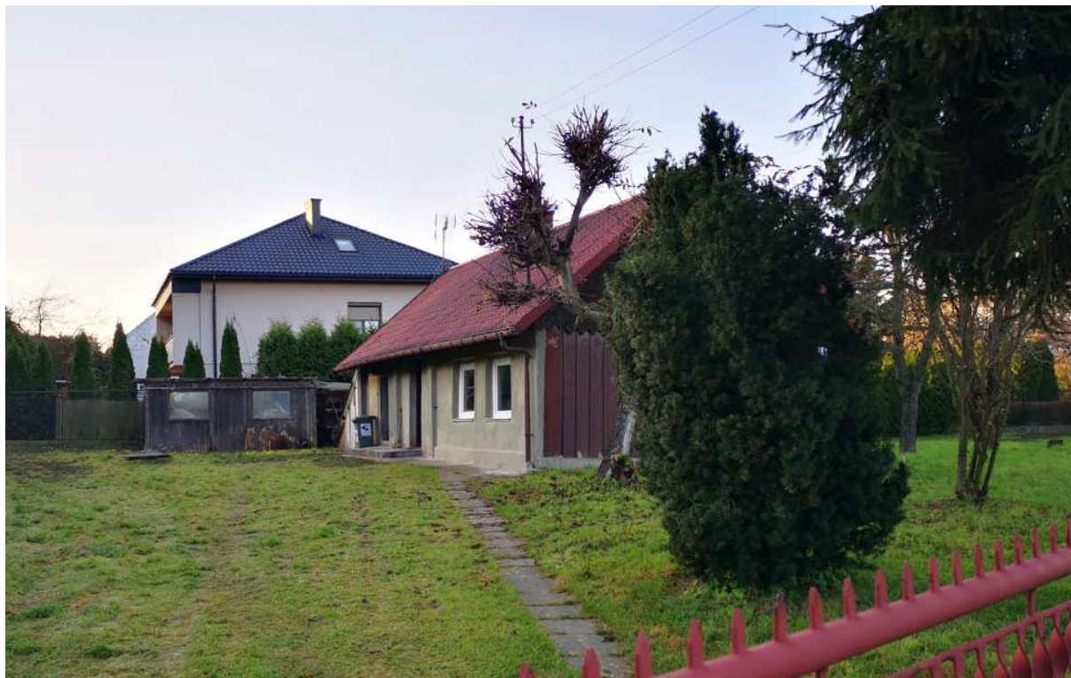
Fot. nr 49. Otynkowana tylna część.
