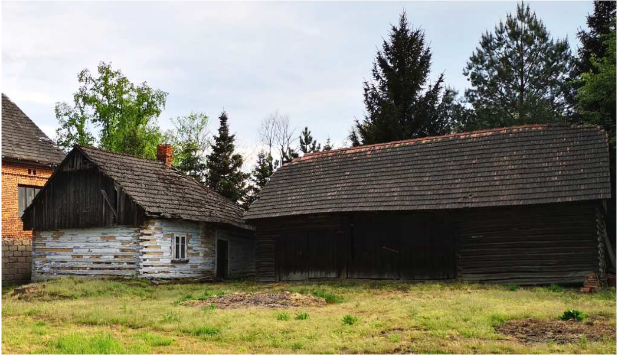
Fot. nr 219. Stodoła w układzie poprzecznym w stosunku do chałupy.
