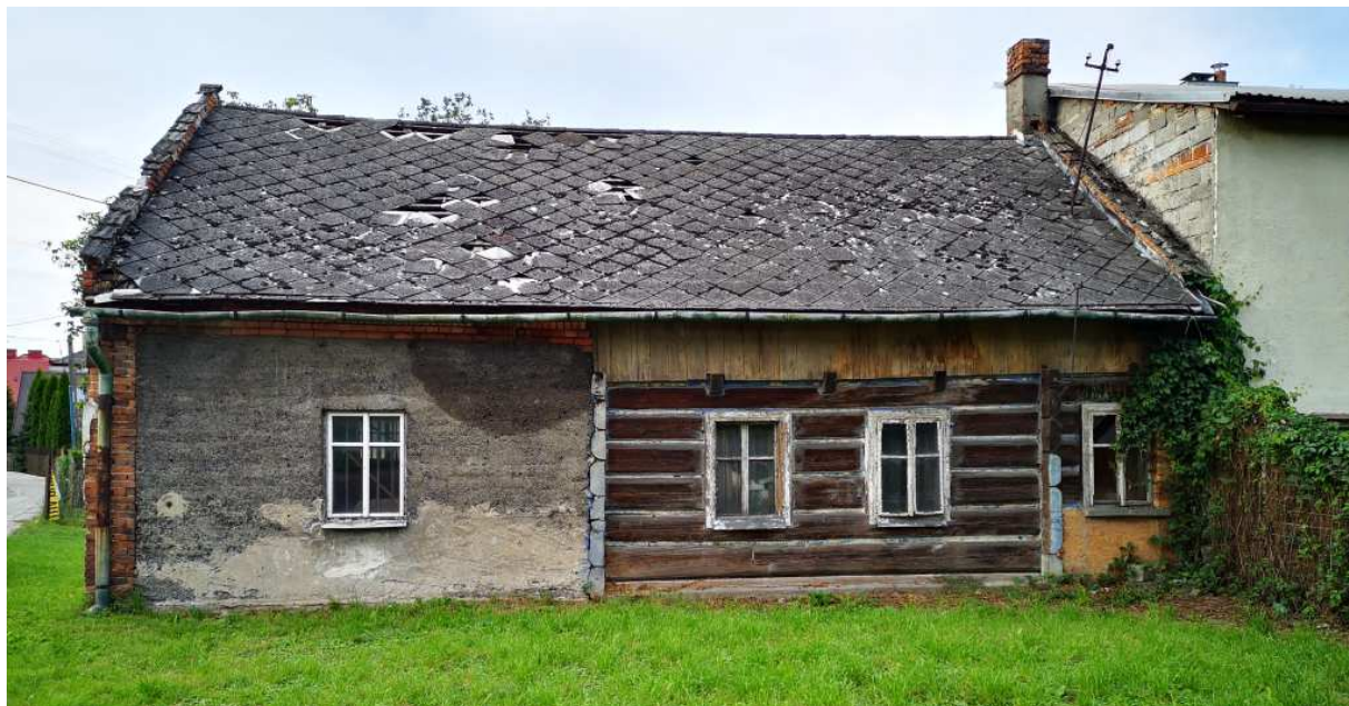
Fot. nr 91. Budynek mieszkalny: drewniano-murowany, spód nr 74.
