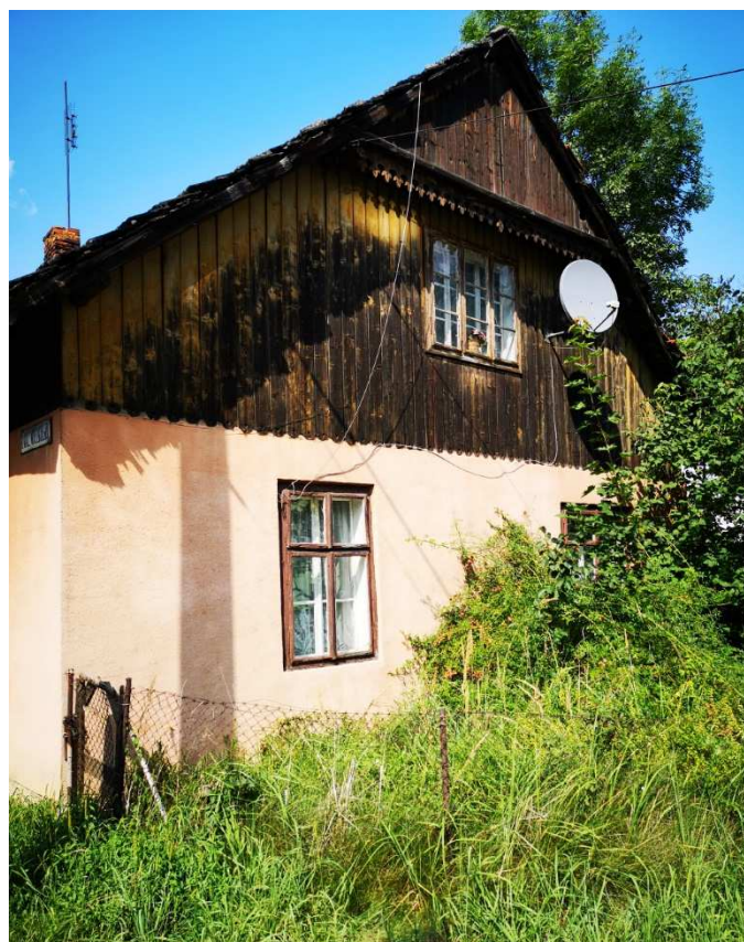
Fot. nr 150. Ściana szczytowa.
