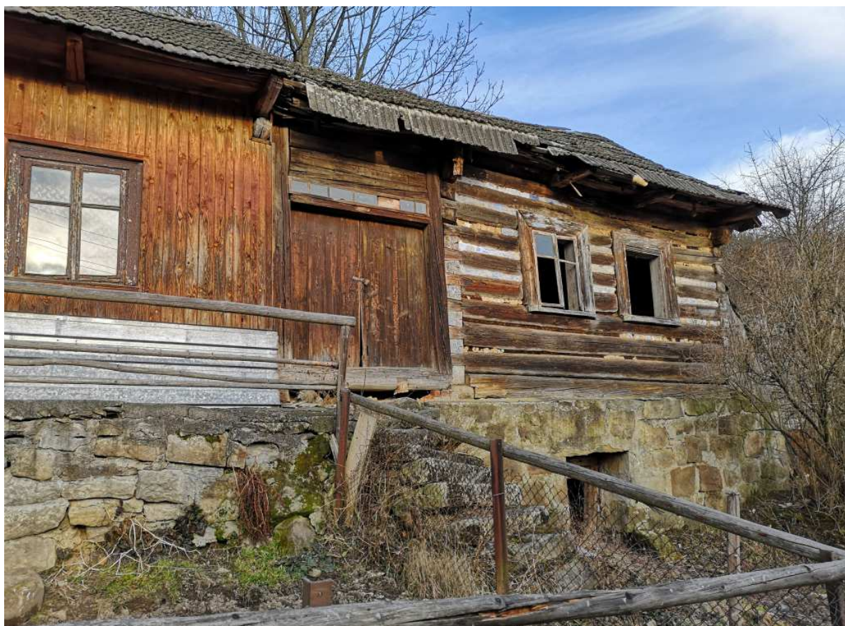
Fot. nr 356. Dom o konstrukcji zrębowej spod nr 842, który mógł powstać około roku 1900..
