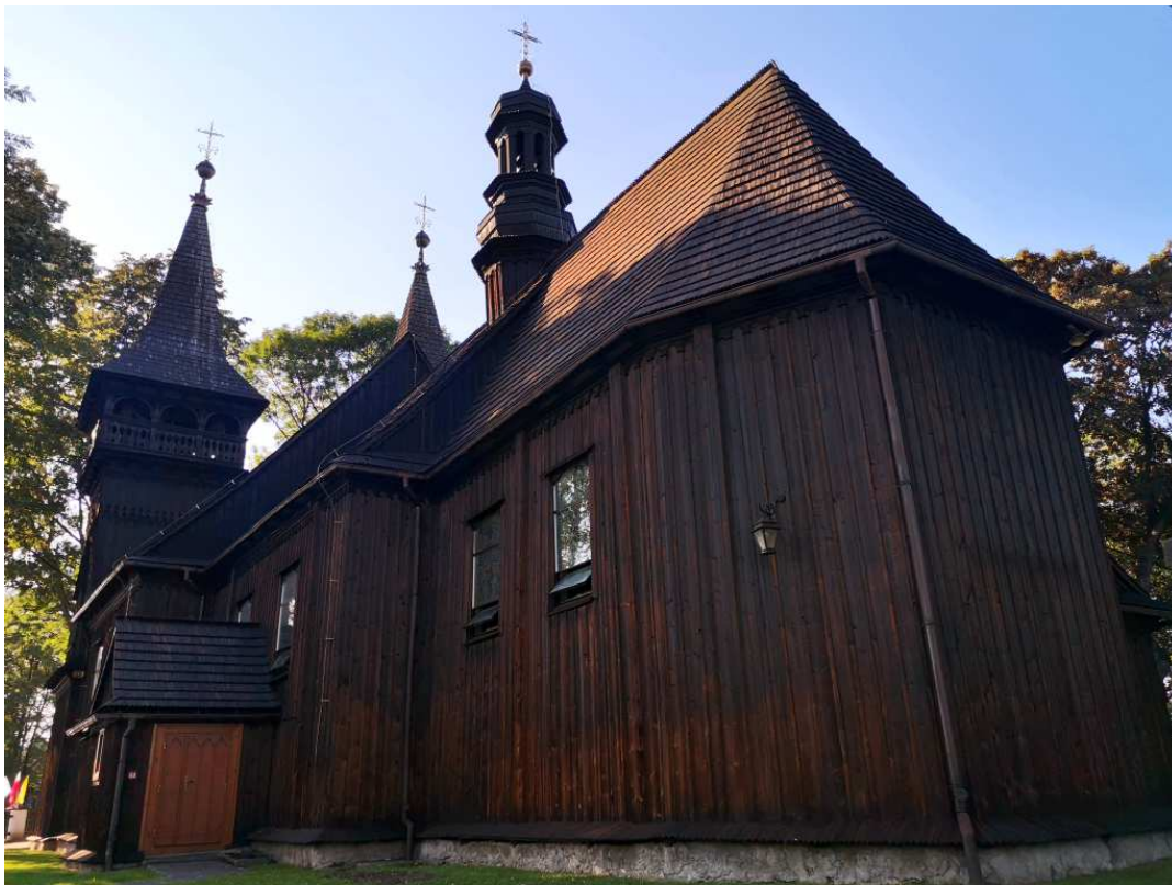
Fot. nr 175 (175-177). Kościół Narodzenia NMP z roku 1589, przebudowany w II poł. XVIII wieku, ujęty w Rejestrze Zabytków.
