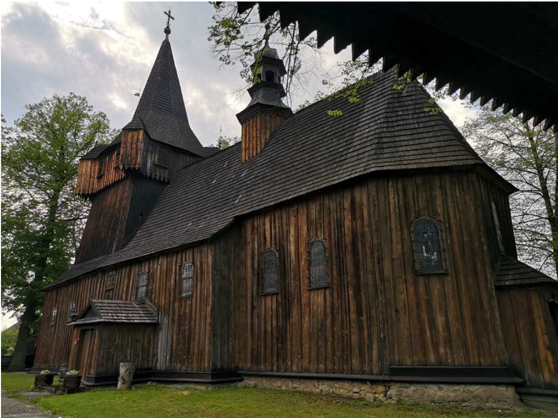
Fot. nr 216. Widok od strony prezbiterium.
