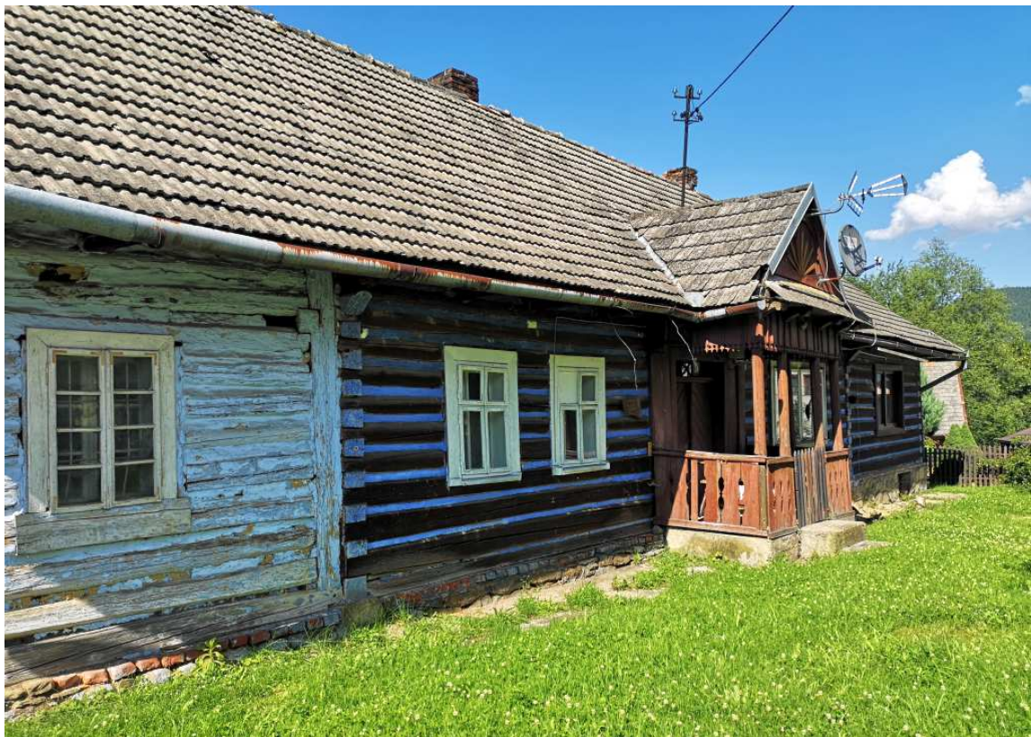
Fot. nr 368 (368-372). Dom z ozdobnym gankiem spod nr 143, wybudowany ok. 1900 roku.
