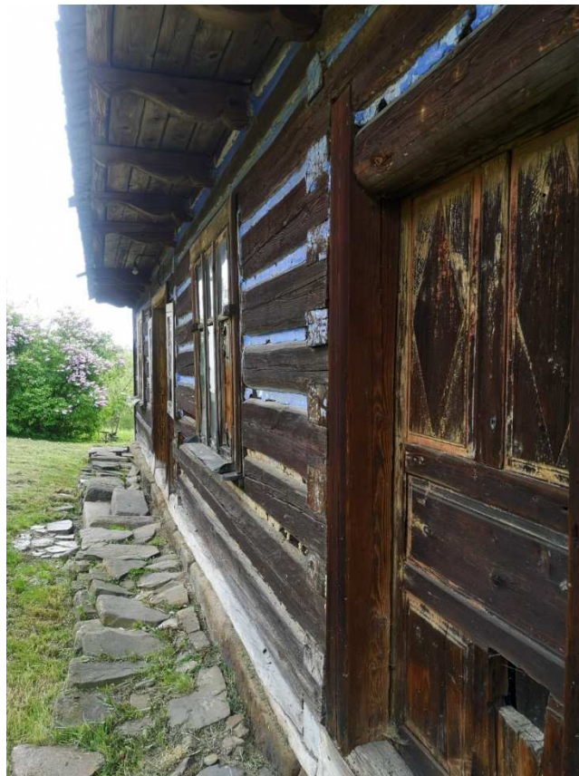
Fot. nr 382. Faktura ściany fasadowej.
