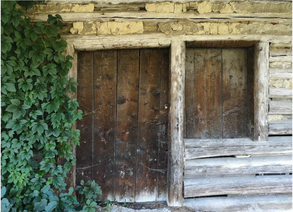
Fot. nr 287. Ściana fasadowa.
