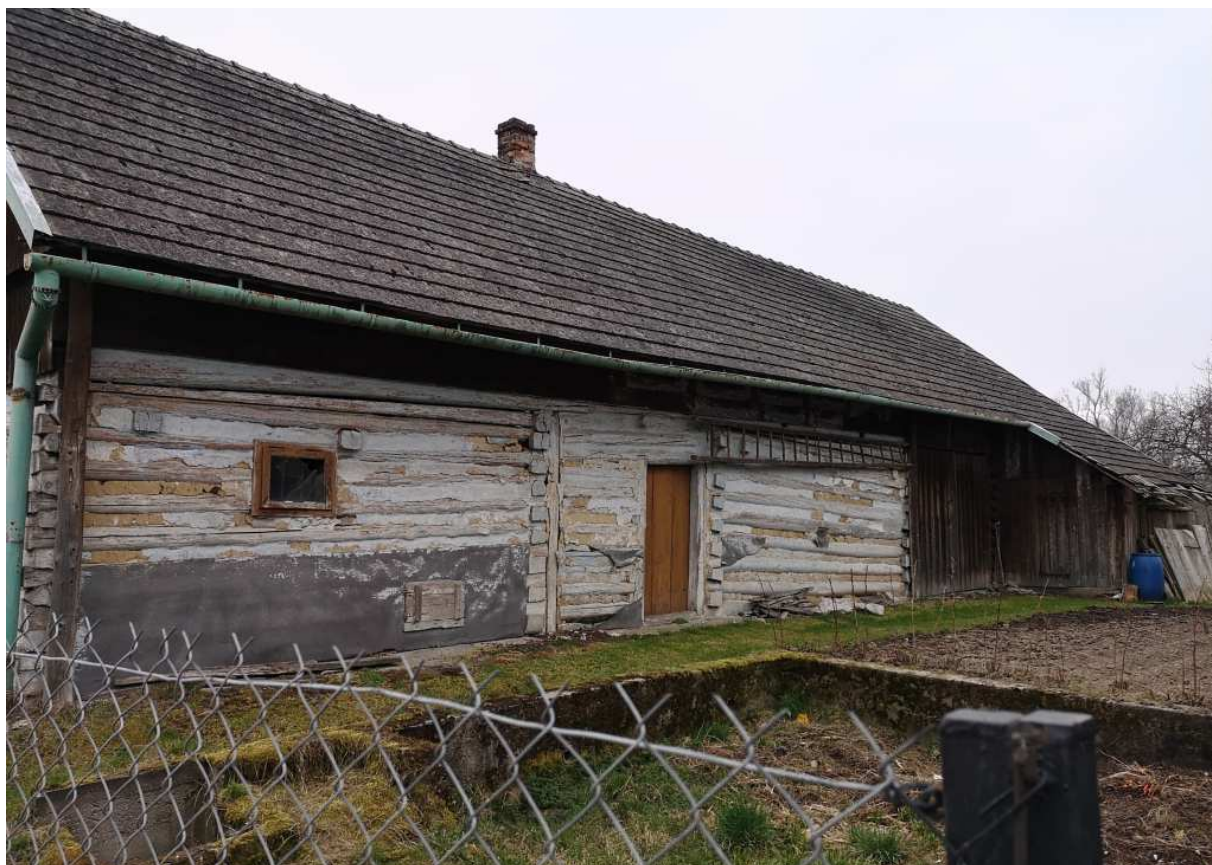
Fot. nr 189. Tył Obiektu.
