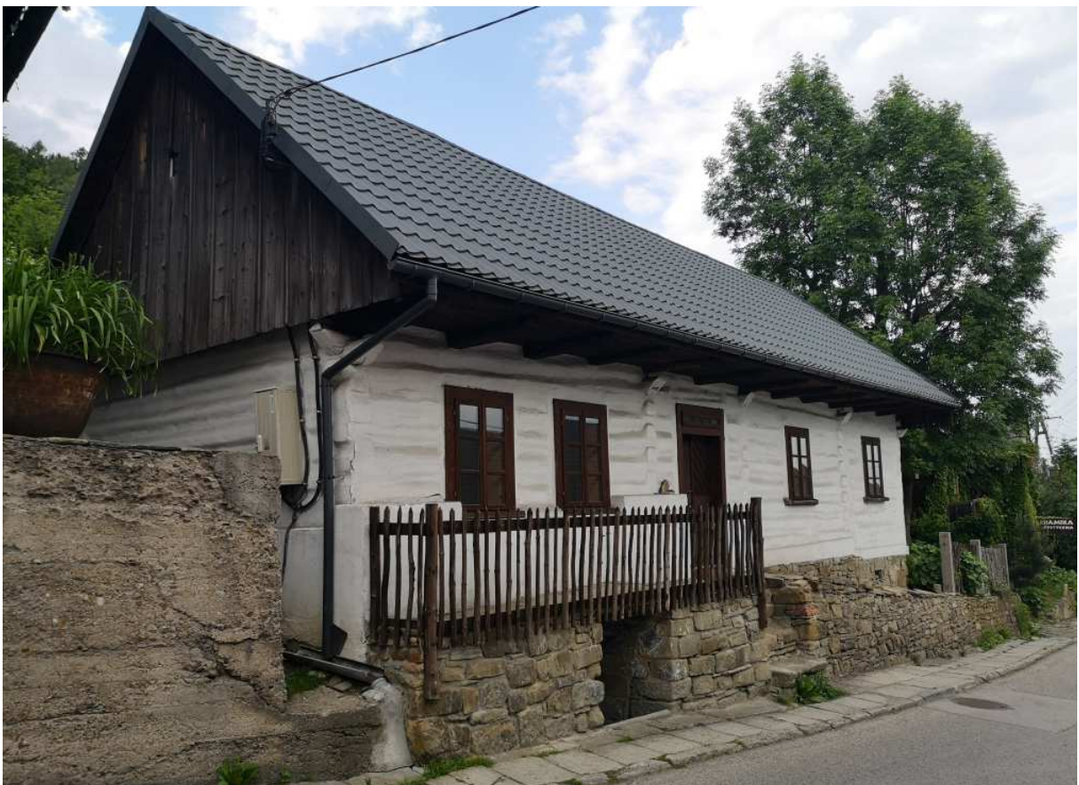
Fot. nr 444. Dom z ulicy Świętokrzyskiej 15 (99), wybudowany w roku 1855.
