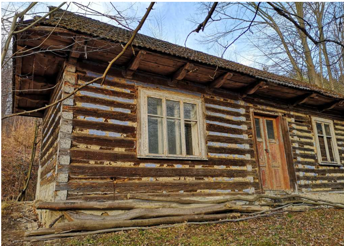
Fot. nr 348. Trzyczęściowe okno typu weneckiego.
