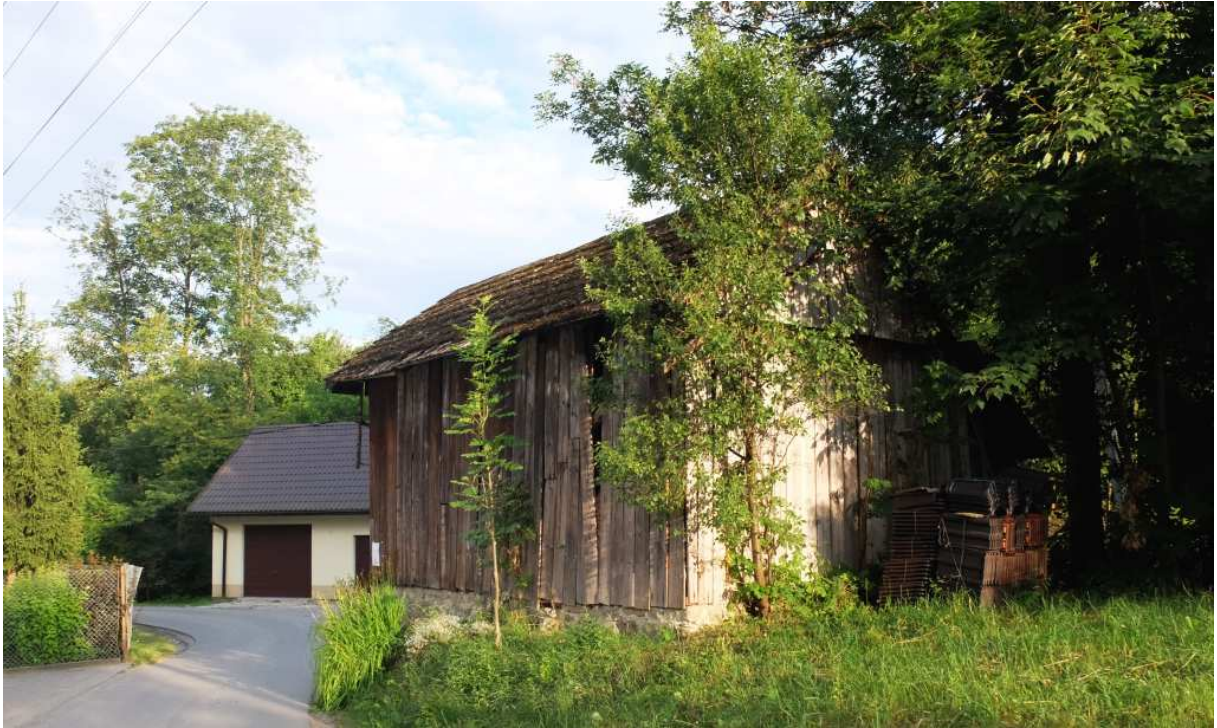
Fot. nr 341 (341-342). Podpiwniczona szopa na siano w sąsiedztwie posesji pod nr 611.
