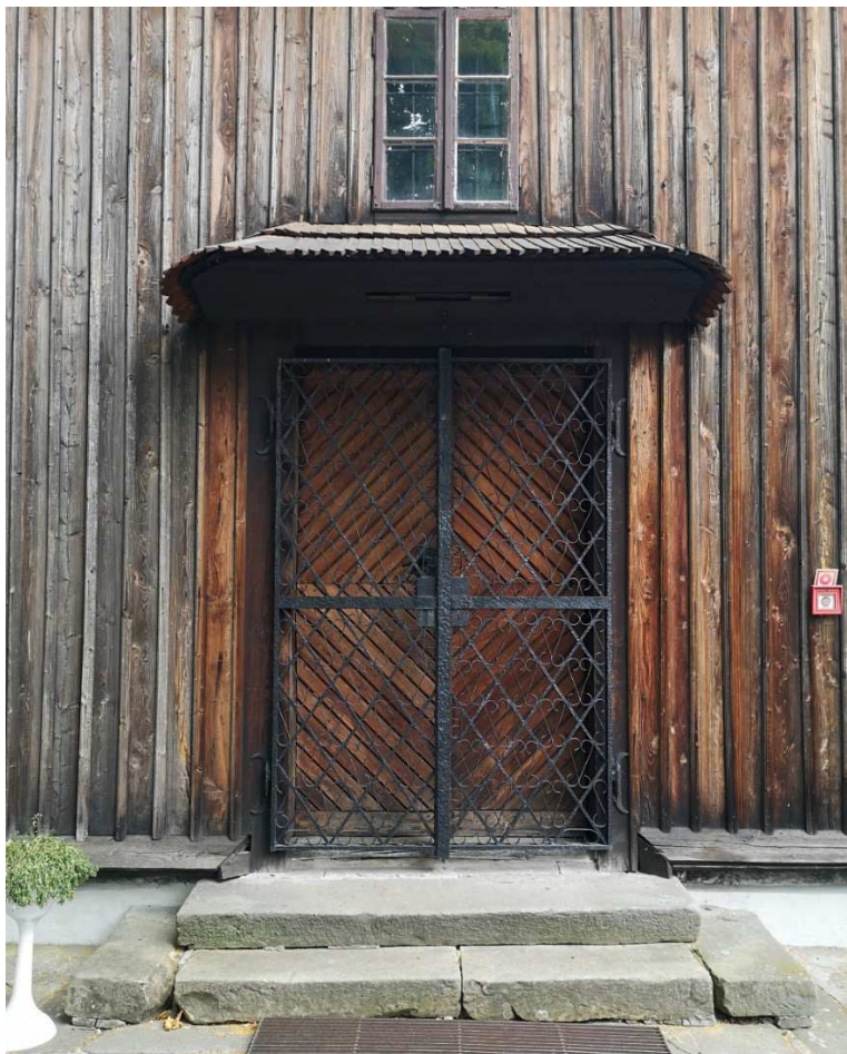
Fot. nr 8. Wejście do kościoła od strony zachodniej.
