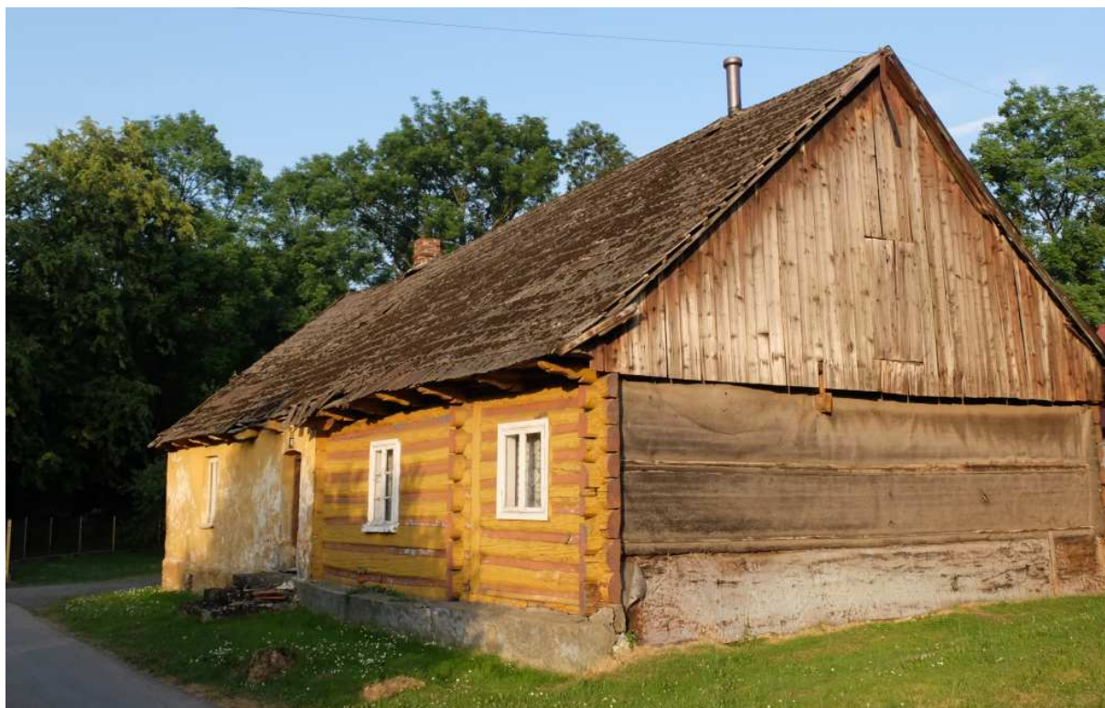
Fot. nr 139. Bliska oryginałowi fasada chałupy spod nr 40.
