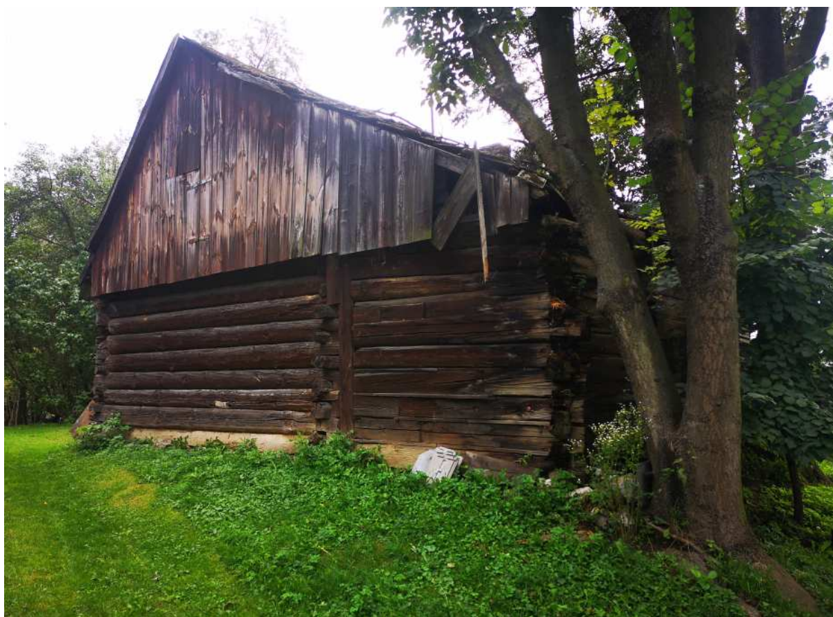
Fot. nr 96. Bok chałupy o konstrukcji zrębowej.
