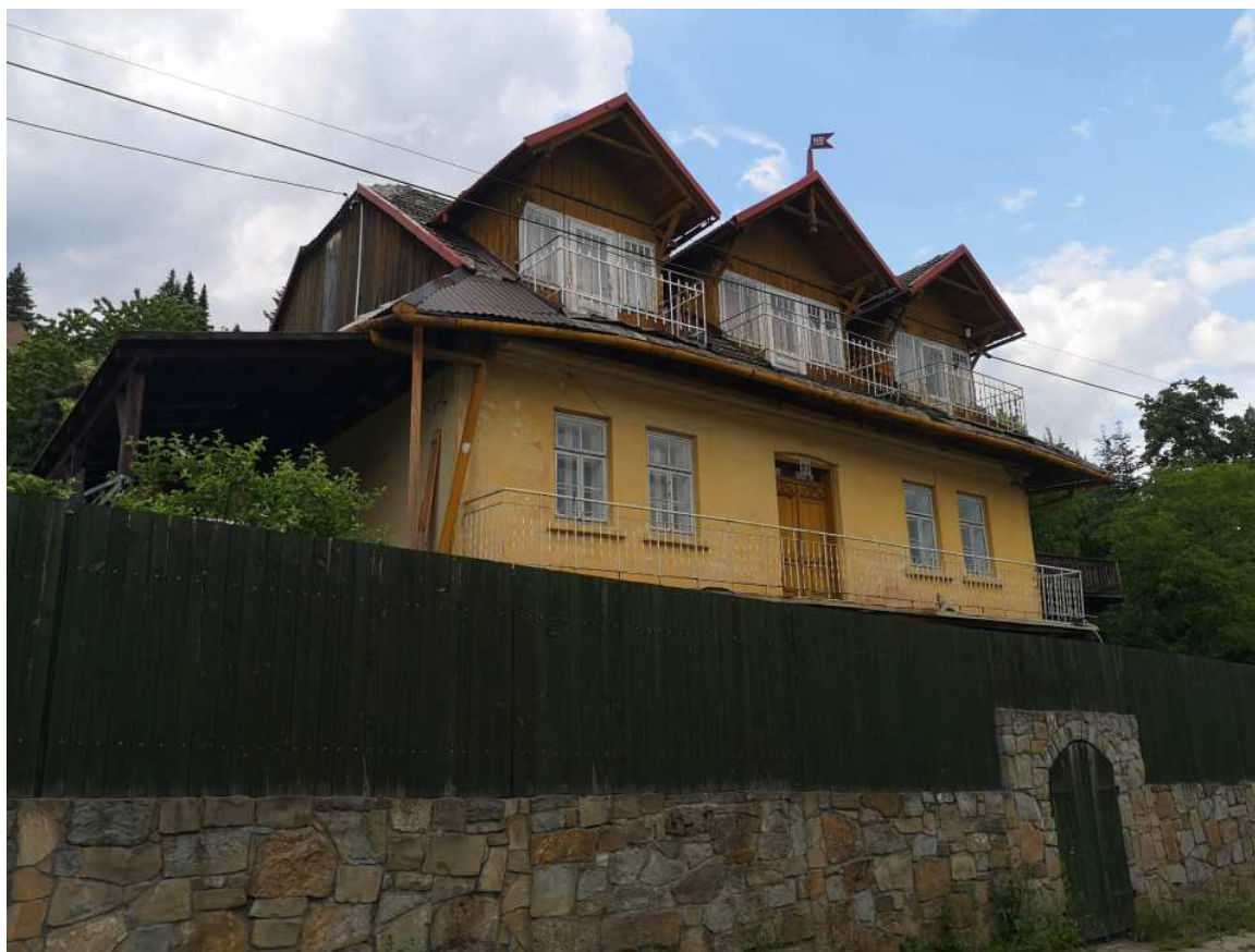
Fot. nr 447. Dom (willa) spod nr 41 (77), wybudowana w roku 1930 (data jej powstania widnieje na metalowej chorągiewce).
