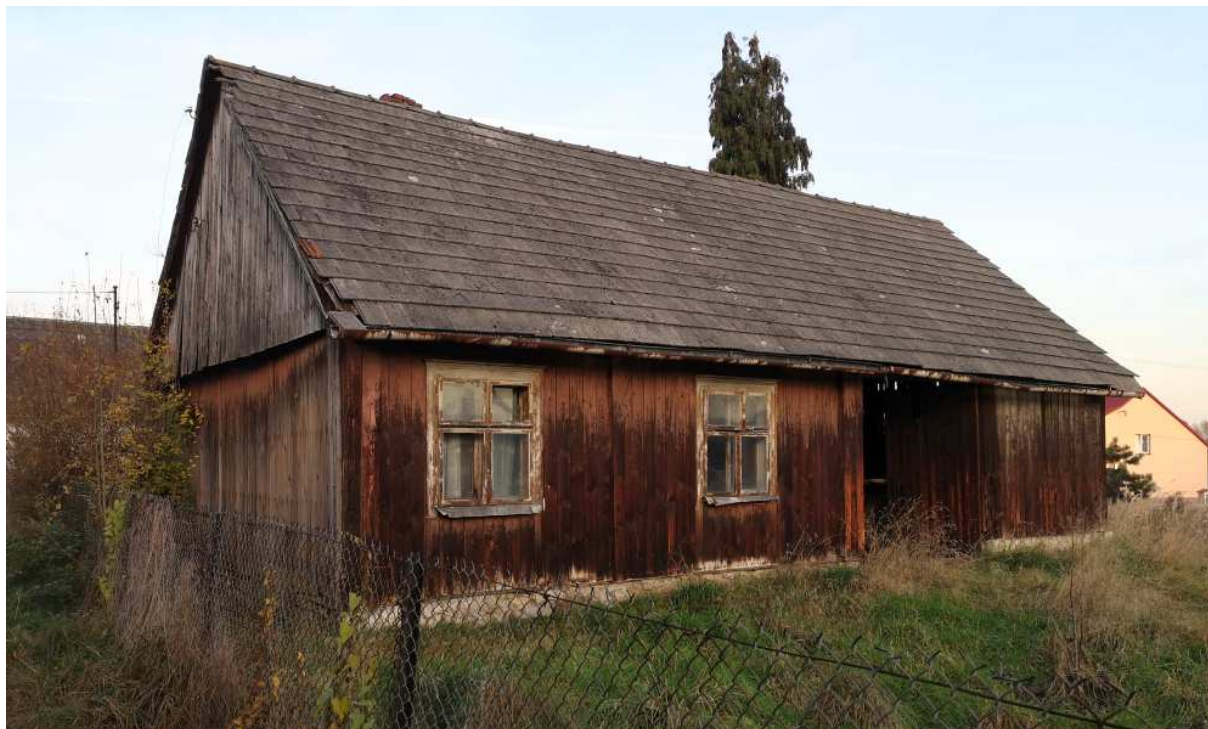
Fot. nr 73. Zapewne blisko 100-letni dom spod nr 180.
