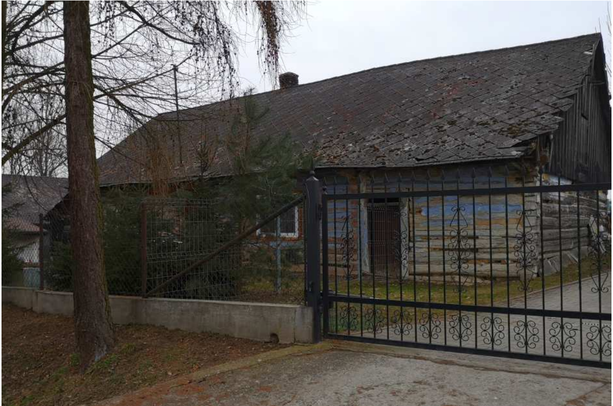
Fot. nr 209. Prawy narożnik z fakturą o konstrukcji zrębowej.
