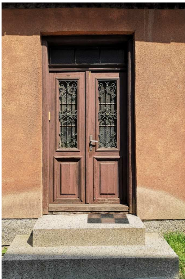
Fot. nr 151. Drzwi wejściowe.
