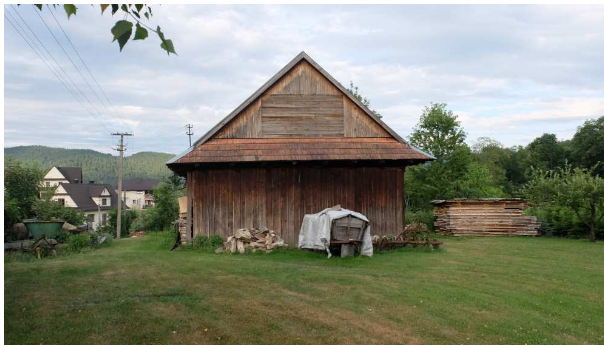
Fot. nr 334. Ściana boczna osłonięta okapem.
