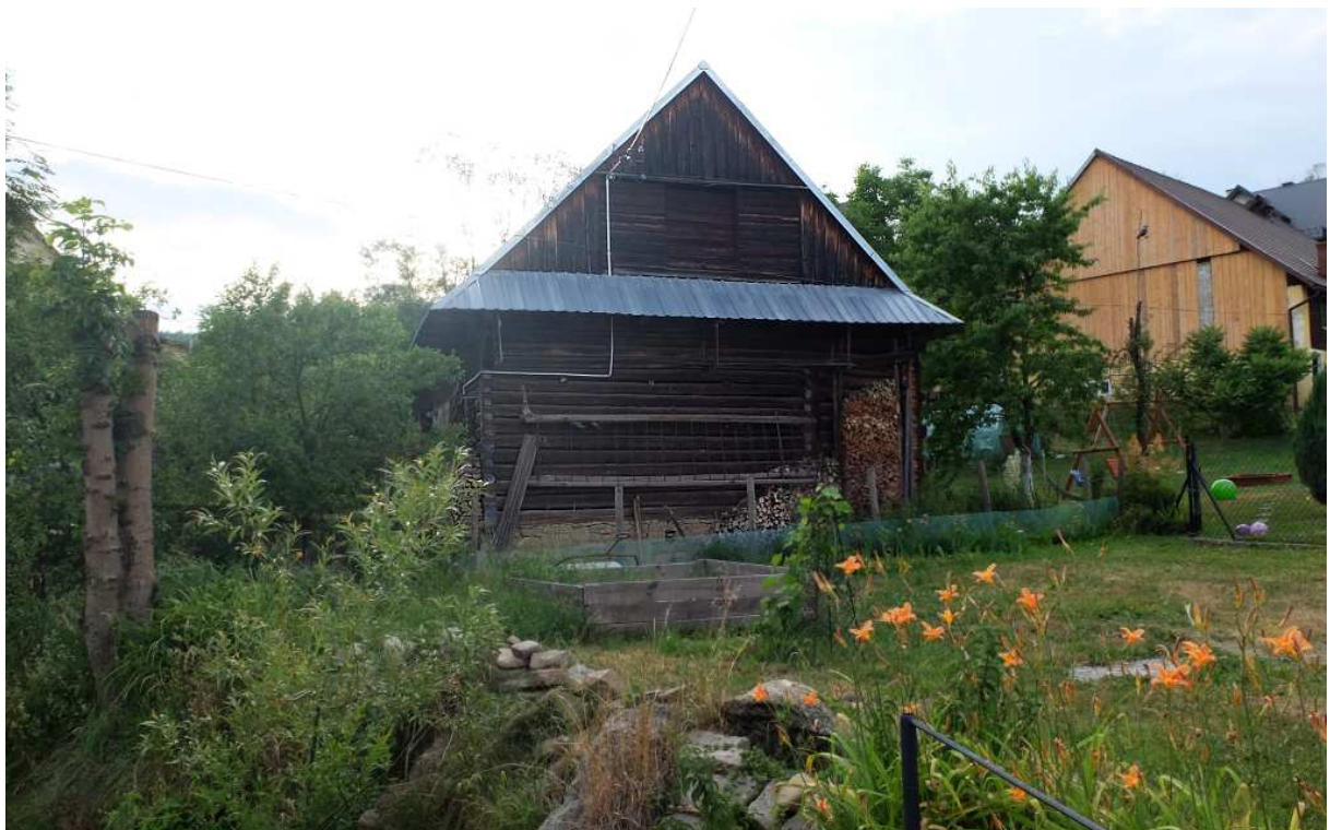
Fot. nr 340. Boczna ściana szczytowa.
