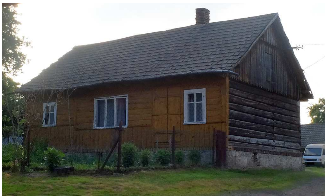
Fot. nr 134. Czyżby środkowe okno powstało w miejscu ganku?
