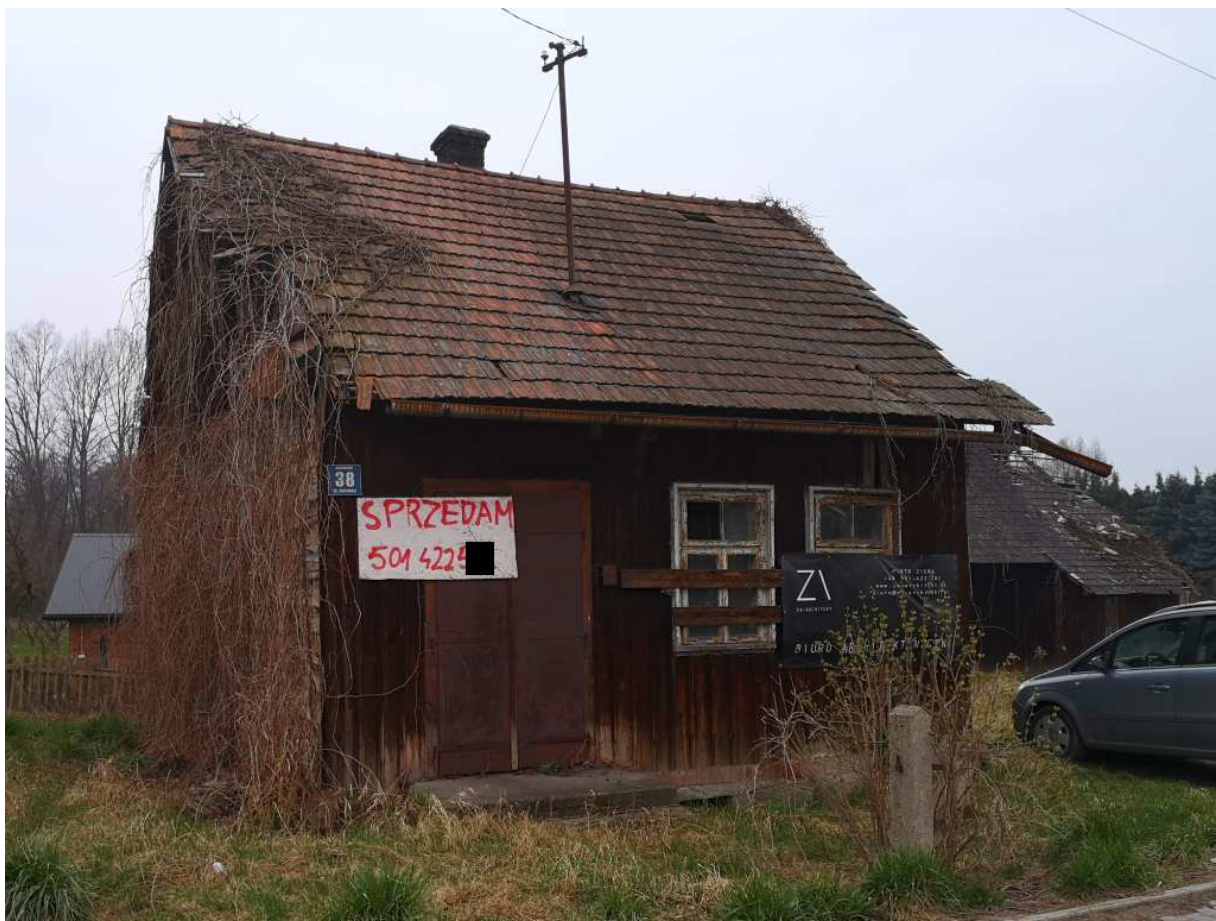
Fot. nr 192. Spojrzenie, może ostatnie, na fasadę.
