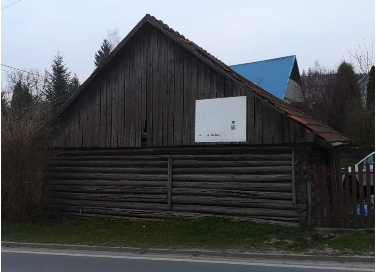
Fot. nr 197. Ściana szczytowa.
