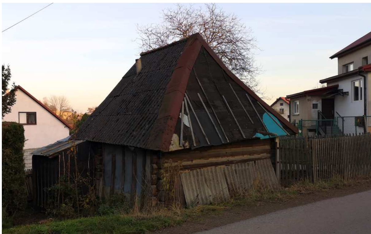
Fot. nr 66 (66-68). Chałupa o konstrukcji zrębowej spod nr 61.
