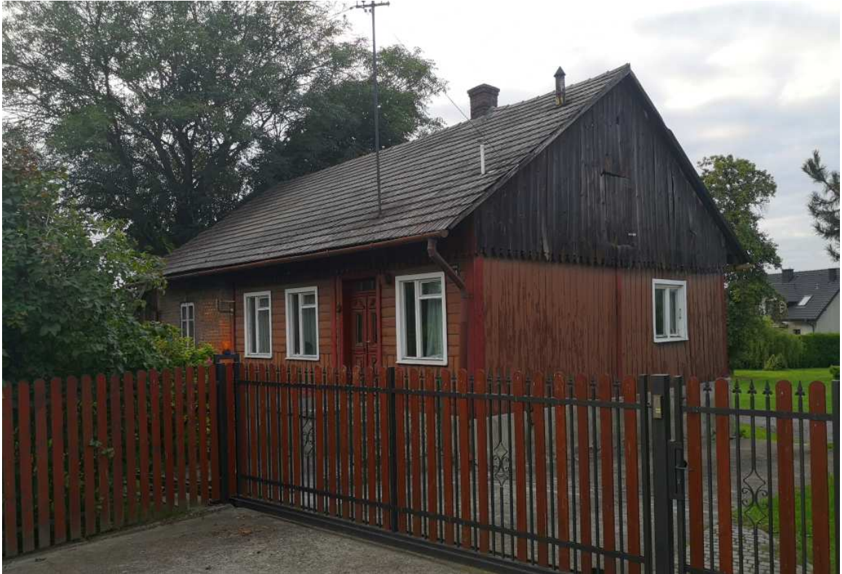
Fot. nr 93. Mocno zniekształcony wygląd fasady domu spod nr 110.
