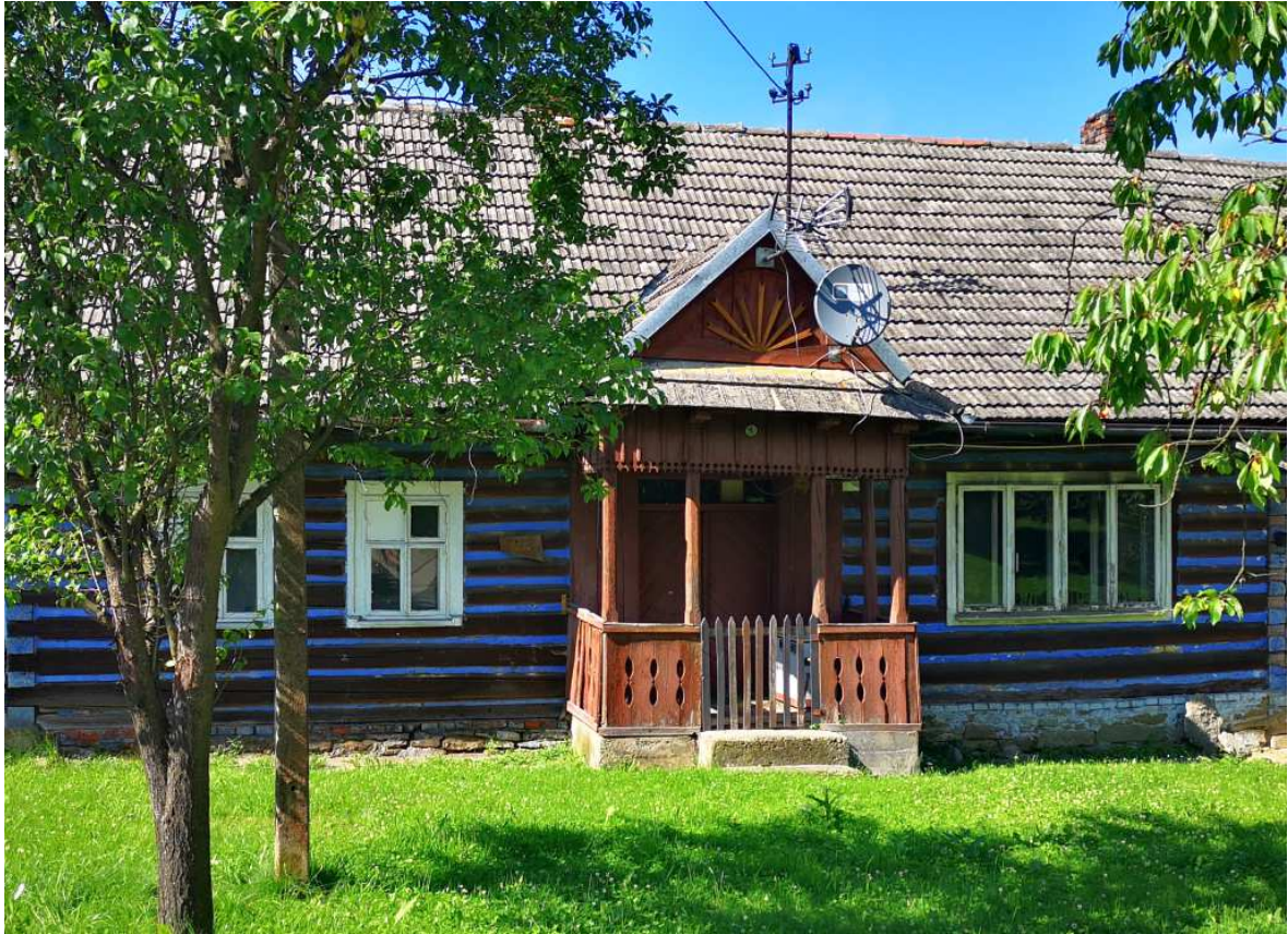
Fot. nr 369 (369-371). Detale fasady, w lewym fragmencie oryginalnej.
