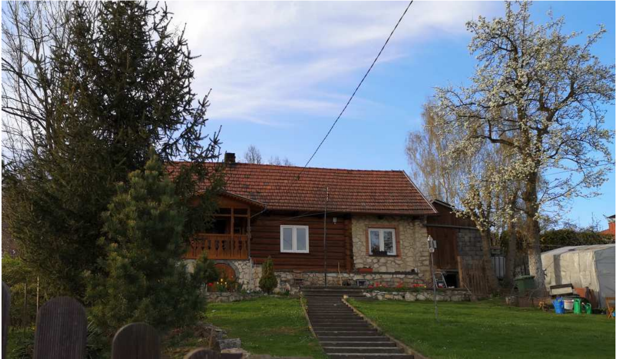
Fot. nr 53 (53-54). Zniekształcona już fasada domu spod nr 55, wybudowanego w roku 1921.
