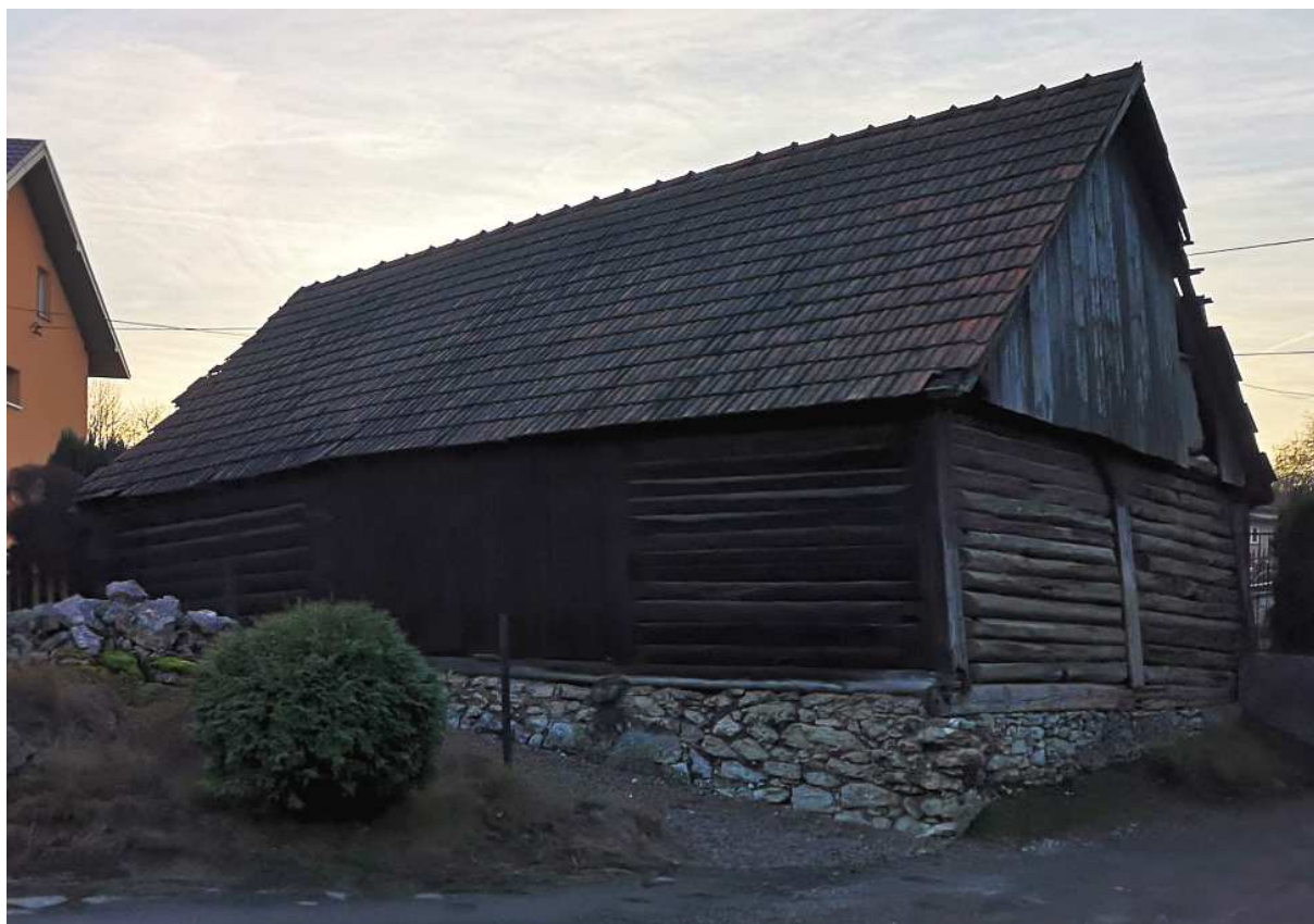
Fot. nr 71 (71-72). Stodoła przy domu pod nr 125.
