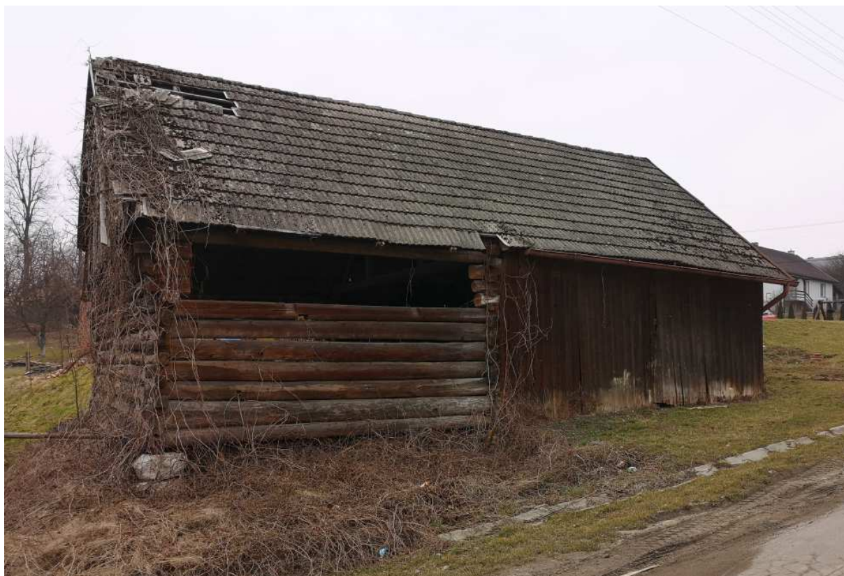
Fot. nr 203 (203-204). Stodoła o konstrukcji zrębowej z ulicy Zadworze Górne 50.
