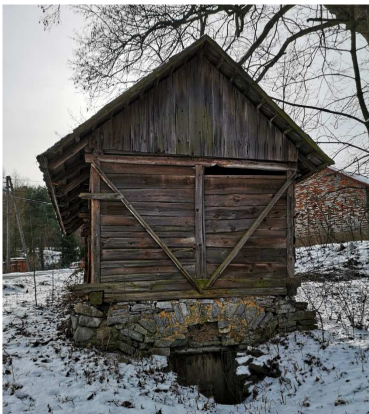
Fot. nr 21. Widok z boczną ścianą szczytową.
