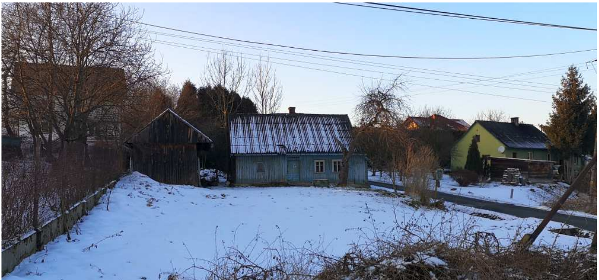
Fot. nr 244 (244-250). Zagroda spod nr 328 i jej detale.
