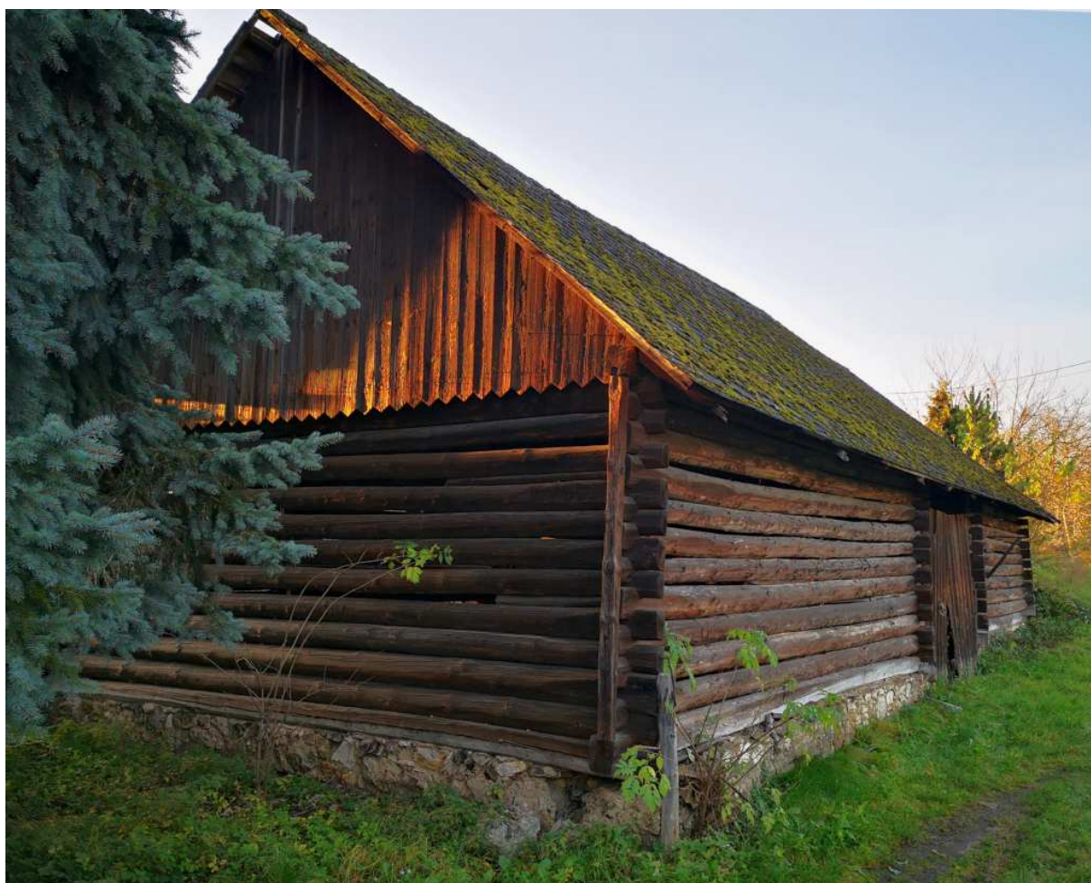
Fot. nr 56 (56-57). Widoki od strony podwórka.
