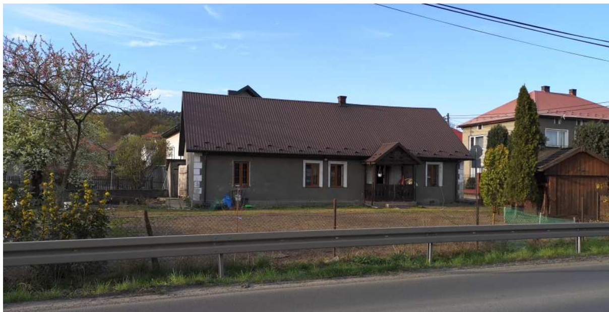
Fot. nr 51 (51-52). Całkowicie przebudowany dom spod 49A, z którego pozostał jedynie oryginalny ganek.
