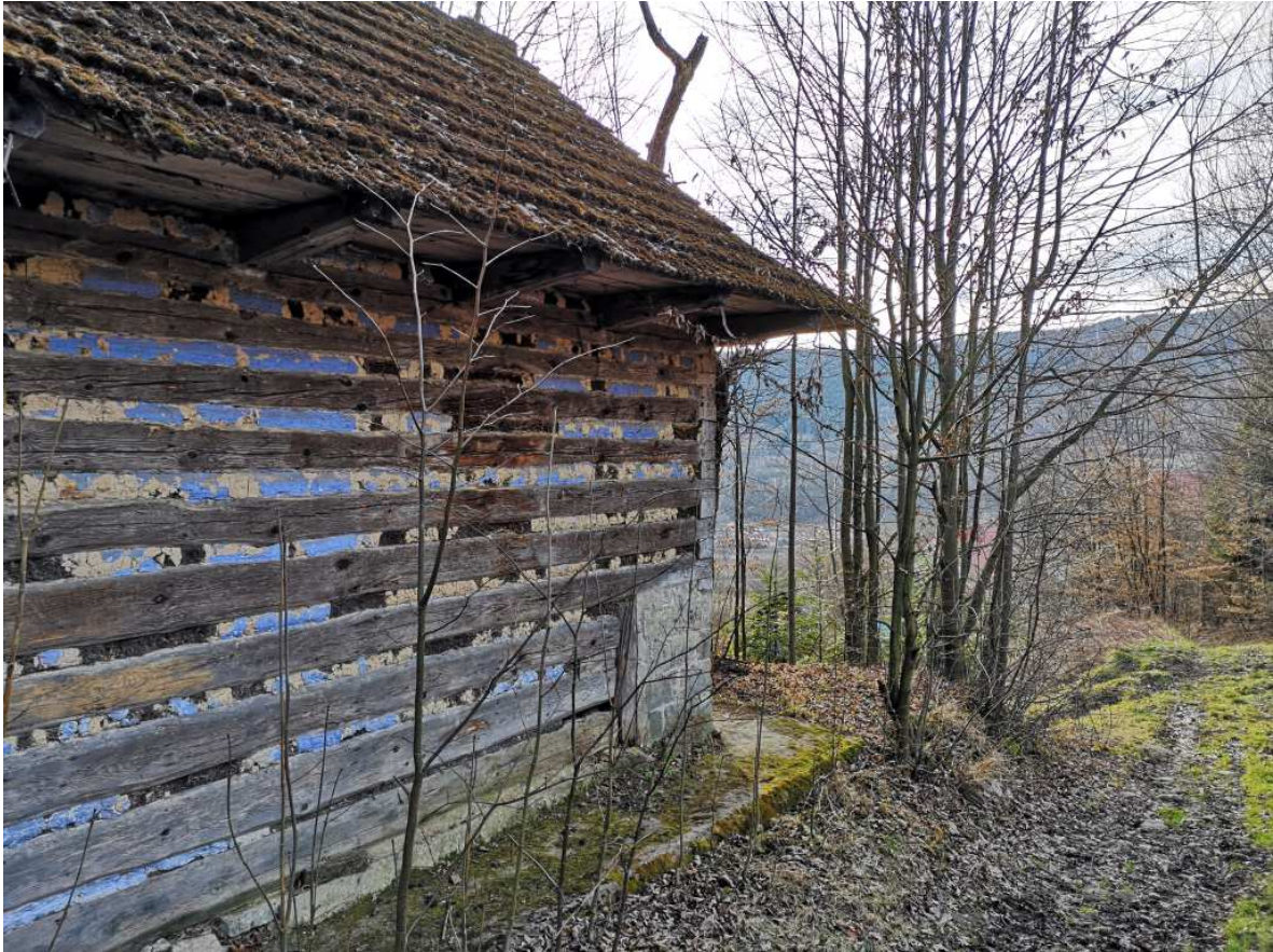
Fot. nr 351. Faktura ściany, z bielonym wypełnieniem pomiędzy belkami.
