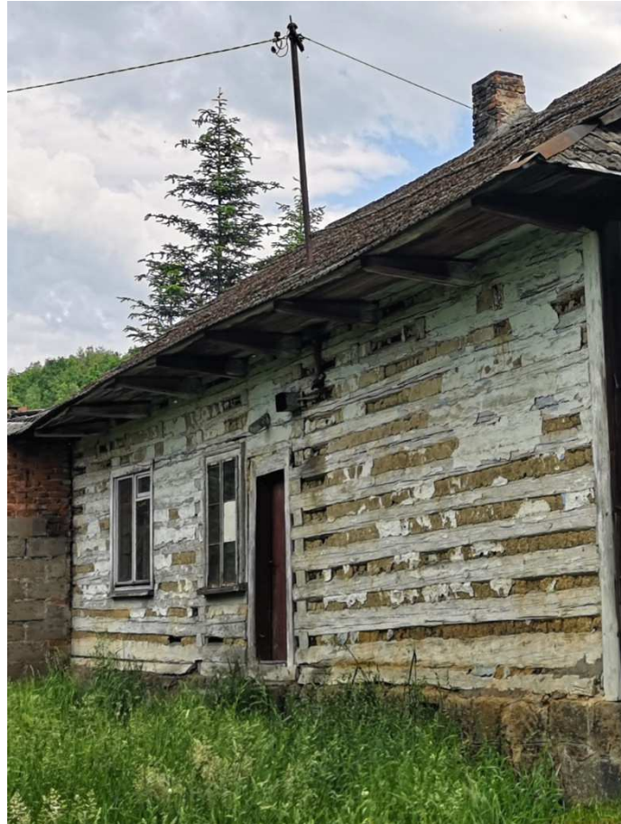
Fot. nr 279. Bliska oryginałowi ściana fasadowa.
