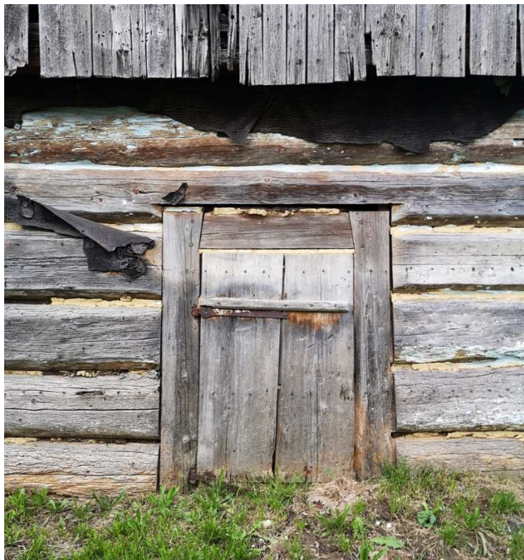
Fot. nr 105. Drzwi w ścianie szczytowej.
