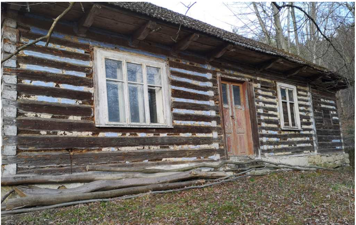
Fot. nr 346 (346-348). Fasada domu o konstrukcji zrębowej.
