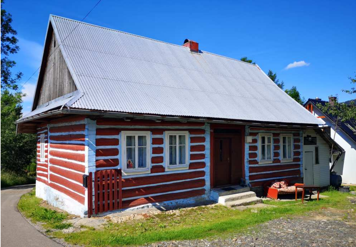
Fot. nr 373 (373-374). Przykładnie odnowiona chałupa spod nr 486, wybudowana ok. roku 1910, wpisana do GEZ.
