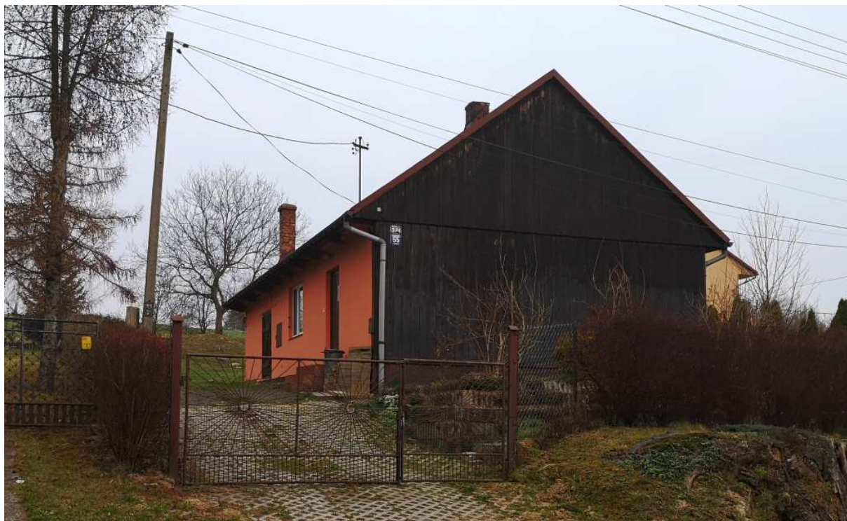
Fot. nr 186. Przebudowany dom z ulicy Podlesie 55.
