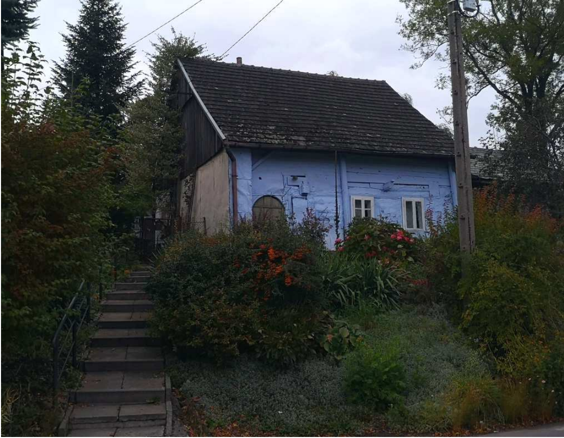
Fot. nr 263 (263-264). Bielona chłupa o konstrukcji przysłopowej, z archaicznym, półkolistym nadprożem nad drzwiami, z ulicy Bielowicza 17.
