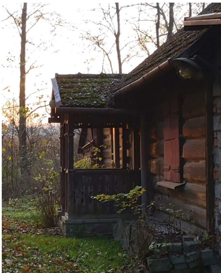
Fot. nr 74. Fasada domu, z gankiem na kształt portyku, spod nr 209.
