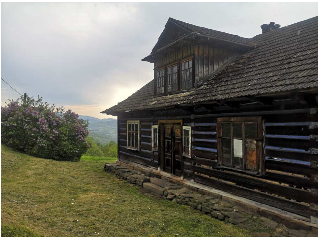
Fot. nr 380 (380-382). Lewy, mieszkalny fragment domu, z facjatką nad wejściem.
