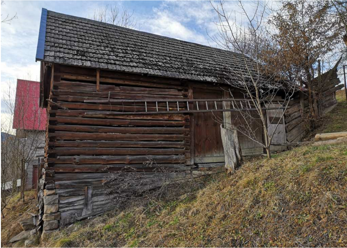
Fot. nr 353. Stodoła o konstrukcji zrębowej.
