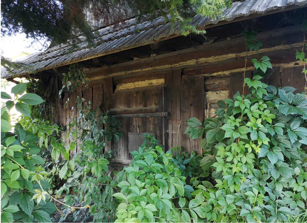
Fot. nr 291. Tylna ściana kuźni.
