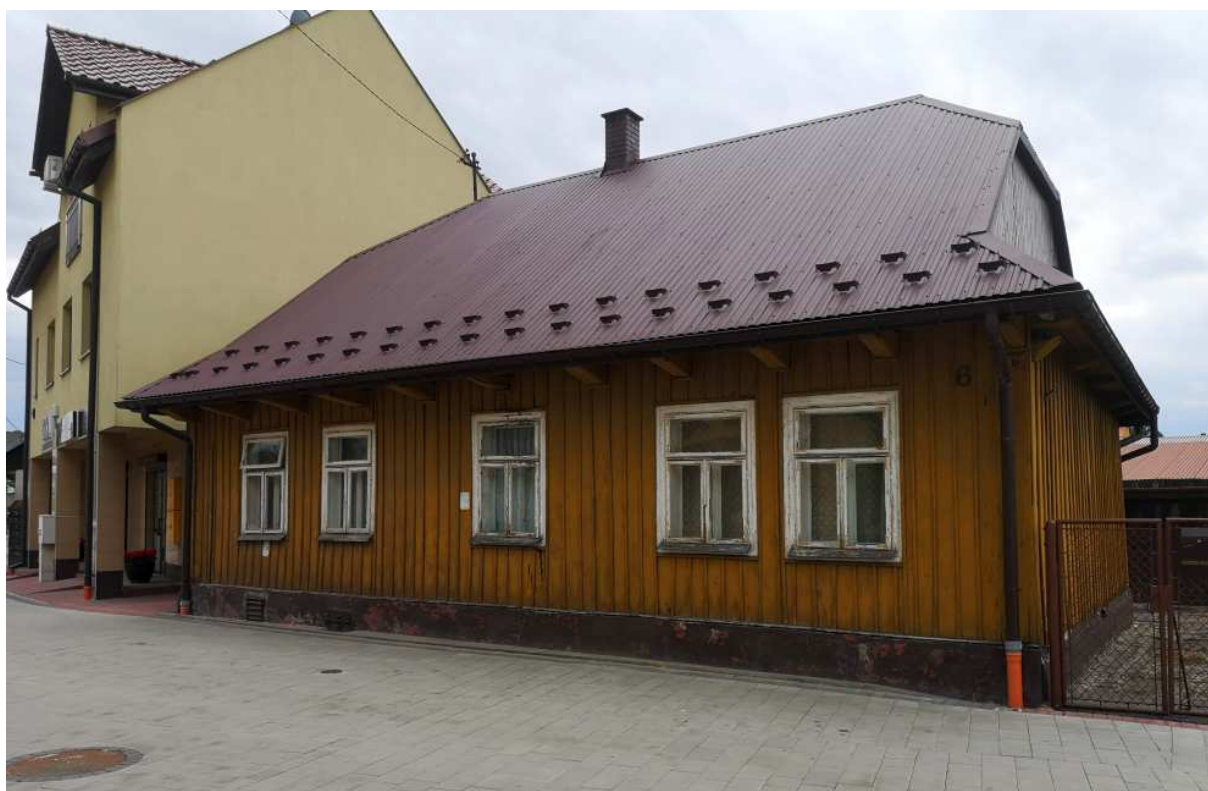
Fot. nr 148. Fasada z oknami trójskrzydłowymi, typowymi dla lat międzywojennych.
