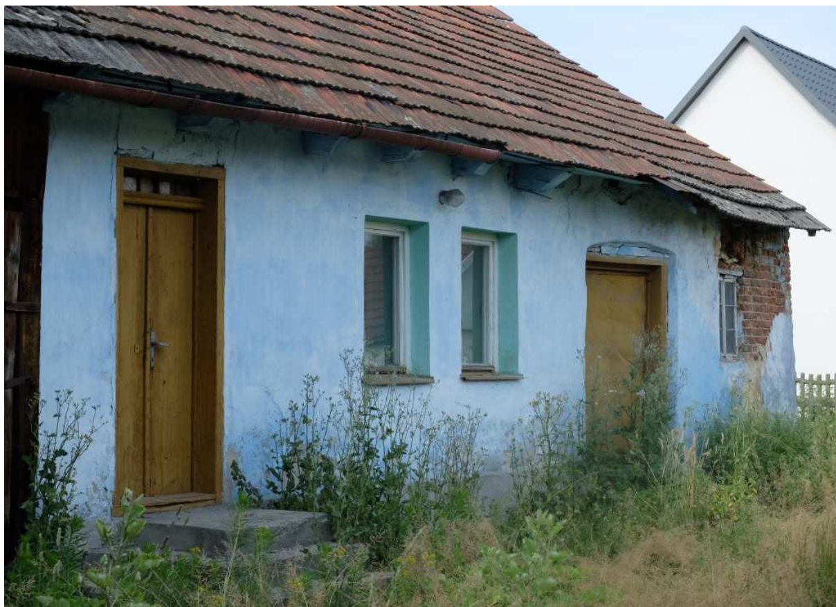
Fot. nr 109. Murowana już tylna część mieszkalna.
