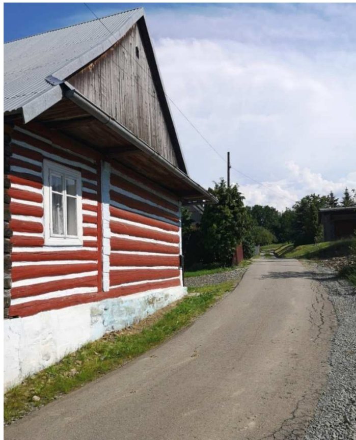
Fot. nr 374. Oryginalna ściana szczytowa z naprzemiennie malowanymi belkami i wypełnieniem.
