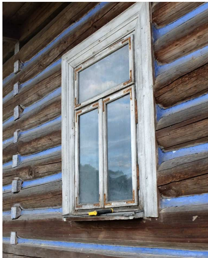
Fot. nr 330. Trójskrzydłowe okno, typowe dla dwudziestolecia międzywojennego.
