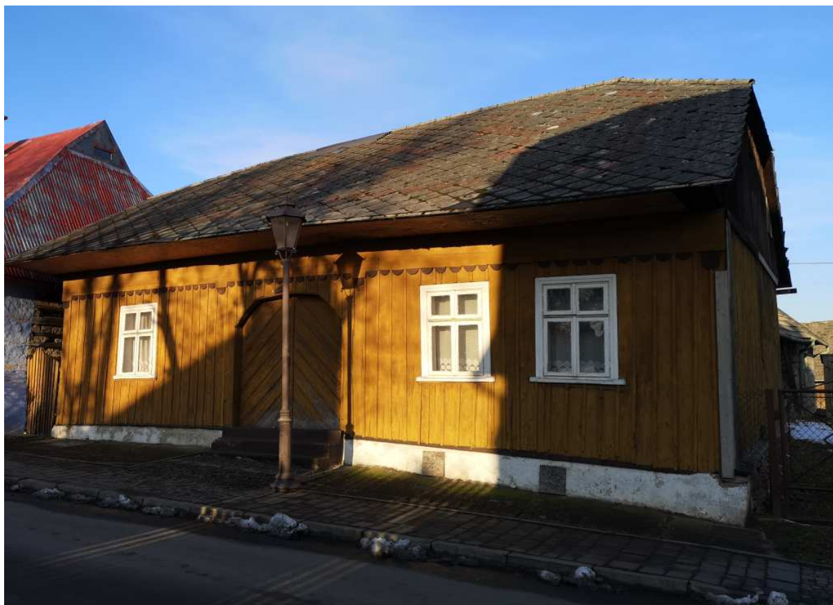
Fot. nr 421. Dom spod nr 5 (174), wybudowany w roku 1870.
