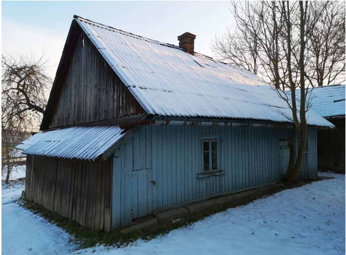
Fot. nr 248. Tylny fragment obiektu mieszkalnego.
