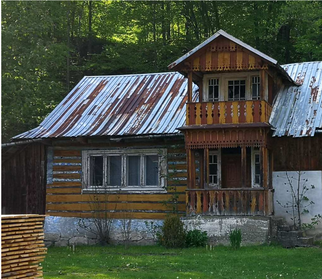
Fot. nr 325. Ganek – najcenniejszy, bo w pełni oryginalny detal domu.
