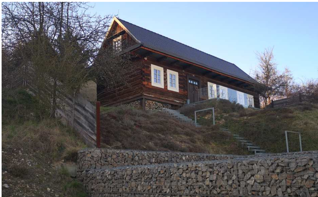
Fot. nr 43 (43-44). Współcześnie remontowany dom przy ulicy Krakowskiej 34.
