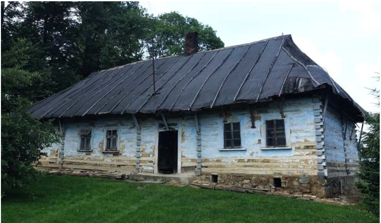
Fot. nr 258. Tradycyjnie bielona chałupa, zapewne XIX-wieczna, spod nr 30. Pod papą zapewne jeszcze strzecha. Nie mam pewności czy jeszcze istnieje.
