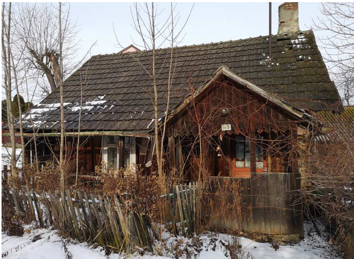
Fot. nr 24. Spojrzenie na fasadę.
