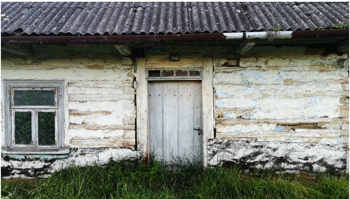
Fot. nr 270. Tradycyjnie bielona fasada oraz drzwi ze świetlikiem (oberlichtem).
