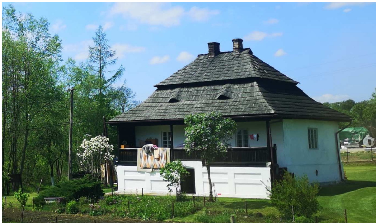
Fot. nr 239. Dawny lamus dworski z łamanym, okapowym dachem spod nr 2, pochodzący z II poł XVIII wieku, przebudowany na dwór mieszkalny.
