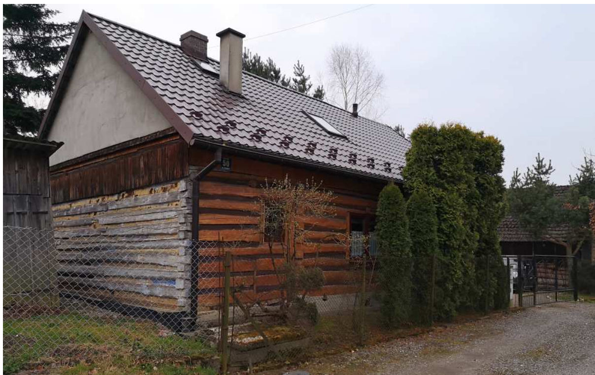
Fot. nr 187. Dawna chałupa o konstrukcji zrębowej, częściowo przebudowana, z ulicy Zadworze 50.
