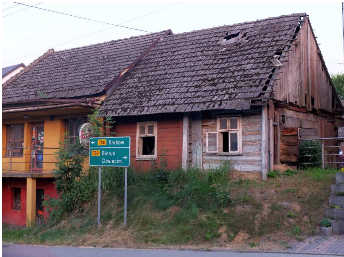
Fot. nr 89. Dom z ulicy Krakowskiej 175, któremu trudno wróżyć przetrwanie.
