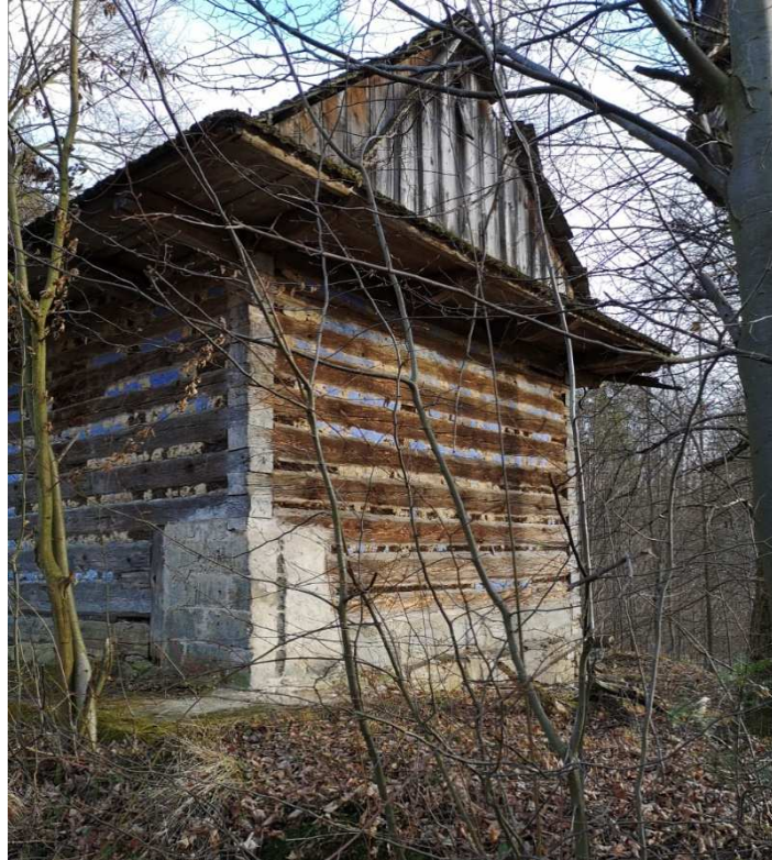
Fot. nr 349. Ściana szczytowa.
