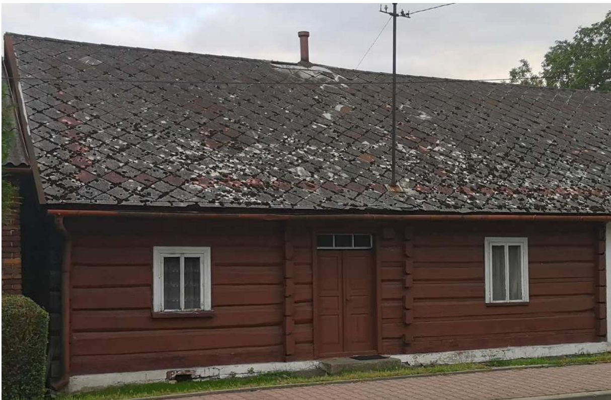
Fot. nr 112. Bliski oryginałowi fragment fasady chałupy spod nr 110.
