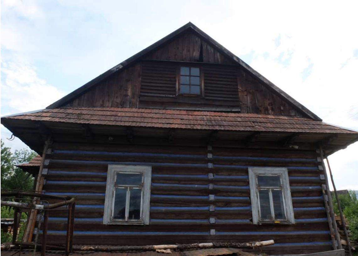
Fot. nr 329 (329-330). Ściana szczytowa z malowanym wypełnieniem pomiędzy belkami.
