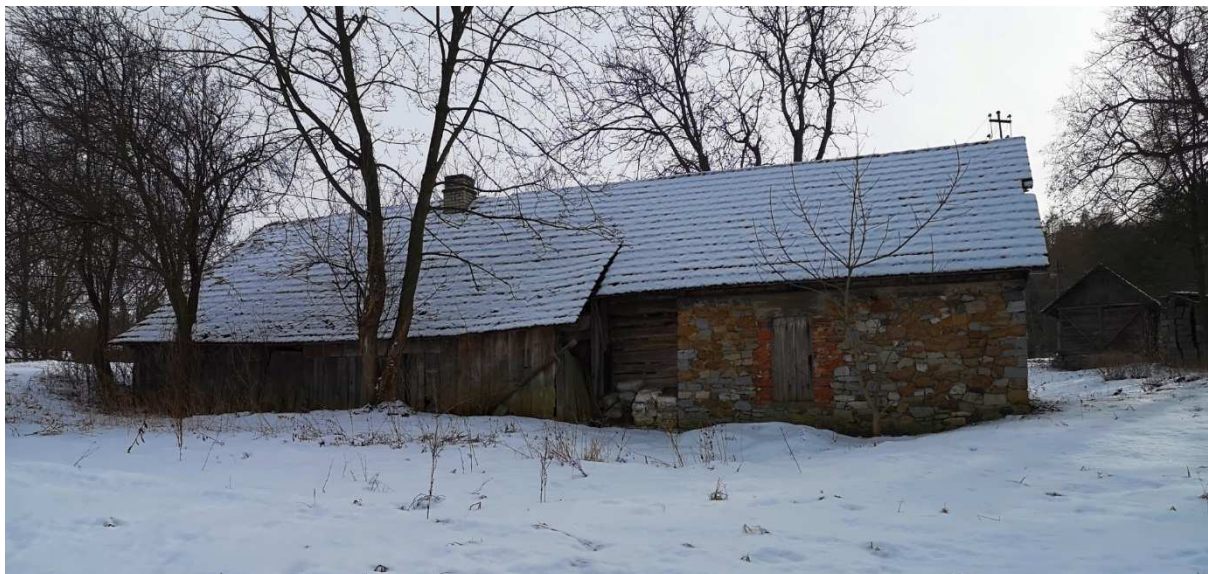
Fot. nr 15 (15-17). Tylna część kompleksu mieszkalno-gospodarczego, z drewnianą komorą.
