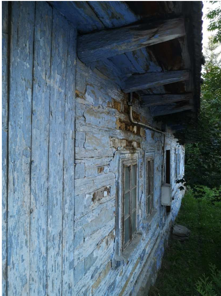
Fot. nr 281 (281-284). Bielona chałupa o konstrukcji zrębowej z ulicy Partyzantów 5, wybudowana zapewne w okolicy przełomu XIX i XX wieku lub nieco wcześniej i jej detale.
