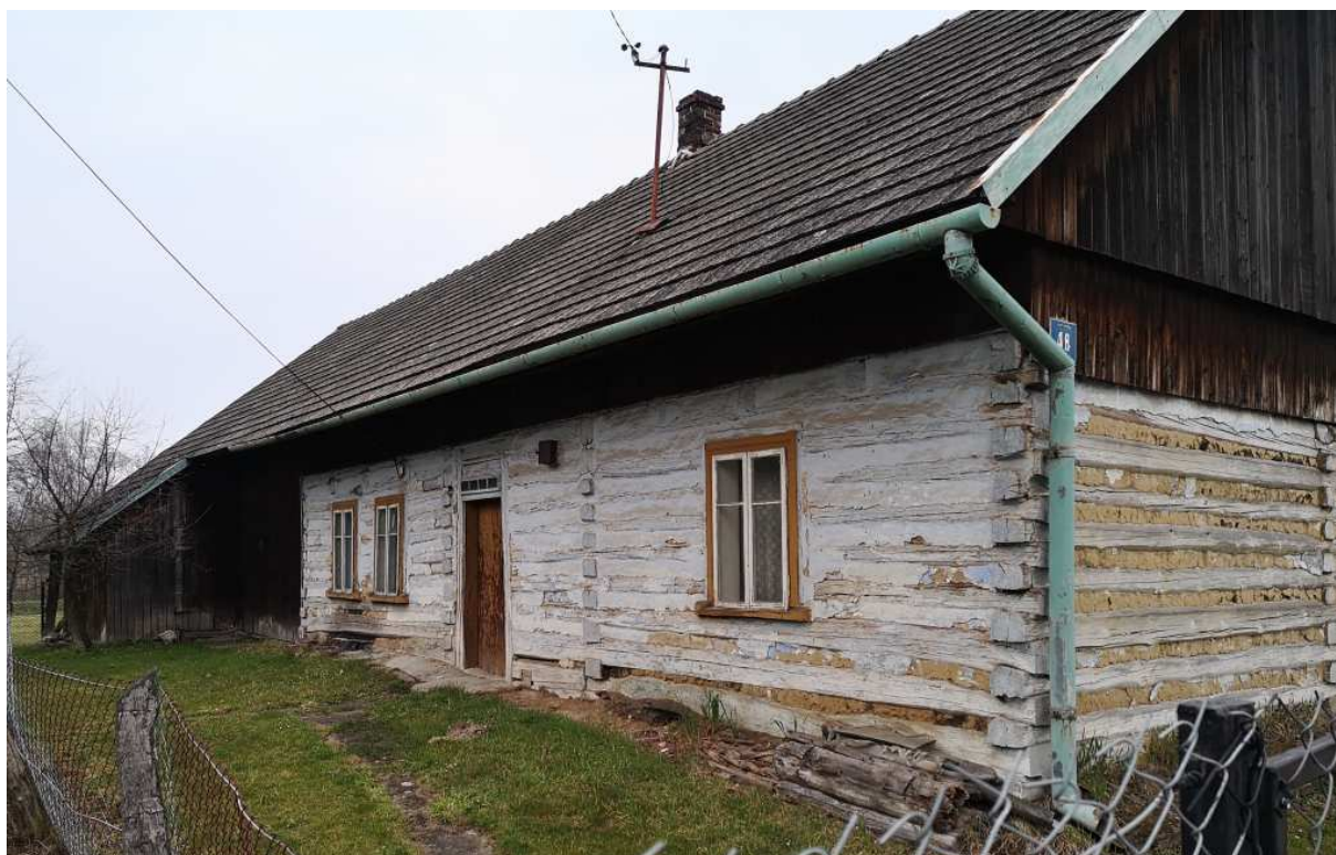
Fot. nr 188 (188-189). Oryginalna fasada chałupy o konstrukcji zrębowej z ulicy Zadworze 48, która mogła powstać nawet w II połowie XIX wieku. Do budynku mieszkalnego dołączona jest część gospodarcza, w tym stodoła.
