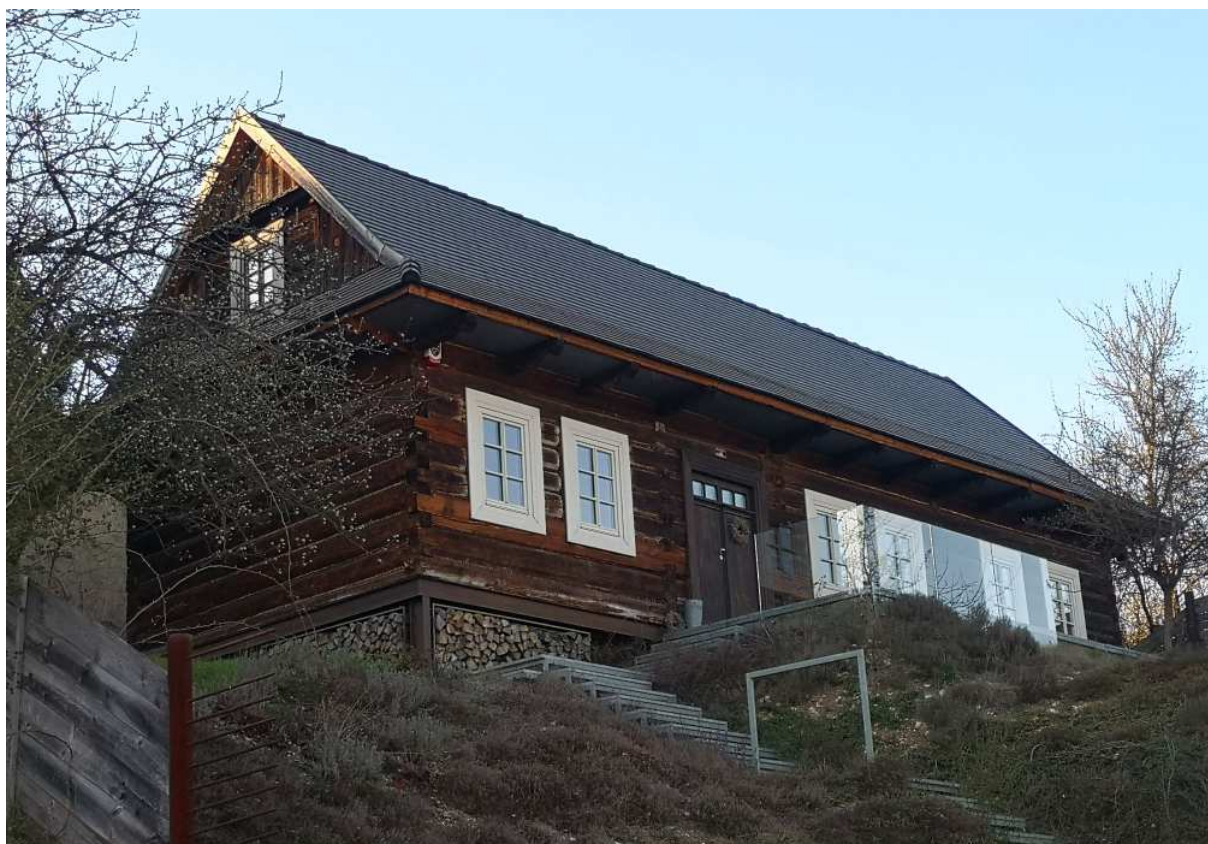
Fot. nr 44. Spojrzenie na fasadę.
