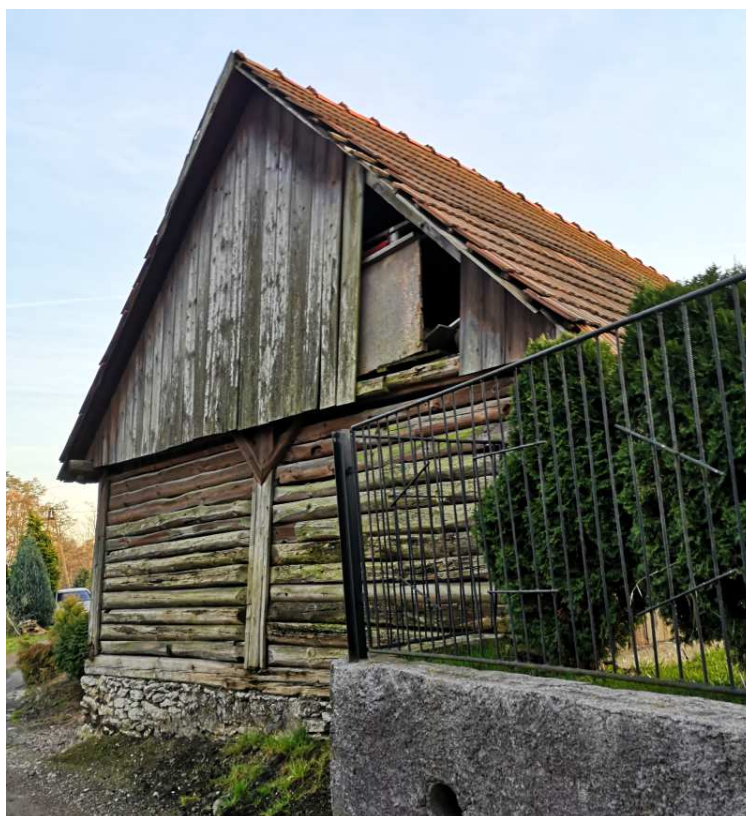
Fot. nr 72. Ściana szczytowa.
