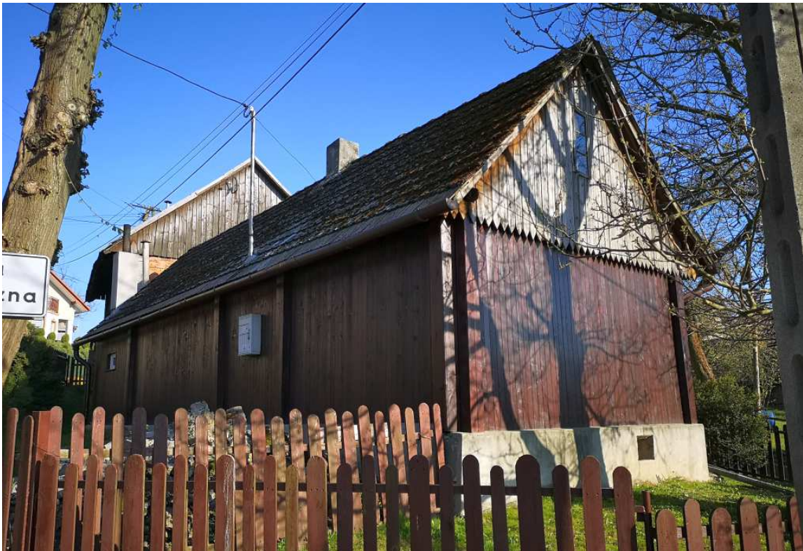
Fot. nr 130. Tylna część obiektu spod nr 33.
