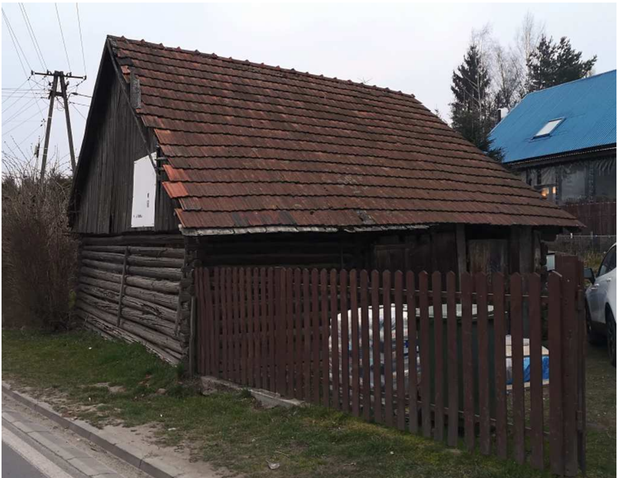
Fot. nr 196 (196-197). Stodoła o konstrukcji zrębowej z ulicy Zadworze 39.
