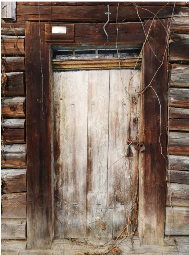
Fot. nr 12. Drzwi wejściowe..
