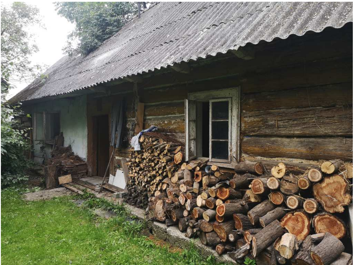
Fot. nr 98. Front budynku od strony podwórka.
