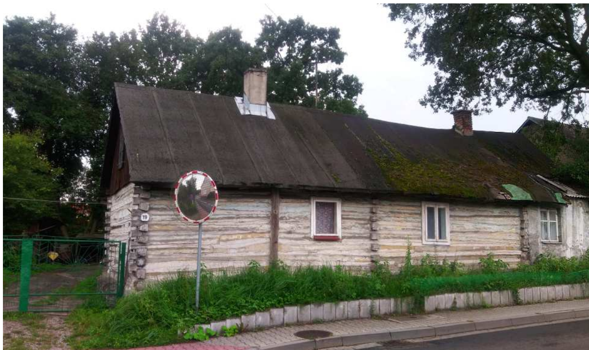
Fot. nr 39. Bliska oryginałowi chałupa z ulicy Chrzanowskiej 19.
