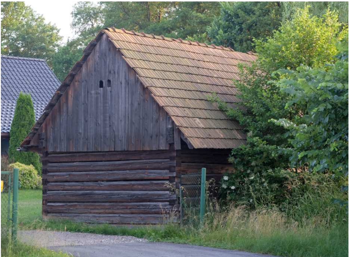
Fot. nr 124. Obora o konstrukcji zrebowej w zagrodzie pod nr 162.
