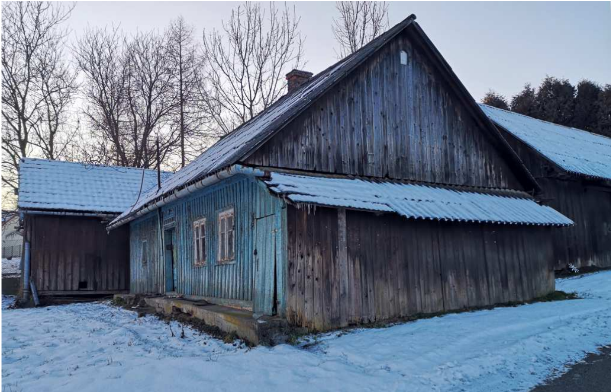
Fot. nr 246. Oszalowana deskami fasada chałupy. W tyle poprzecznie ustawiona stodoła.
