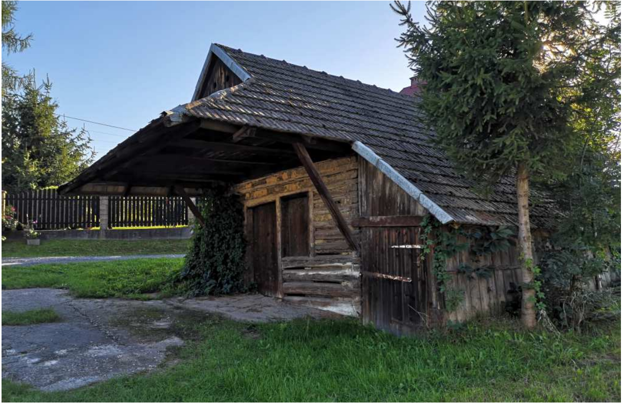
Fot. nr 285 (285-291). Kuźnia z początku XX wieku, z okapowym nadprożem, z ulicy Partyzantów 48 i jej detale. Sułkowice od dawna słynęły ze specjalizacji kowalskiej.
