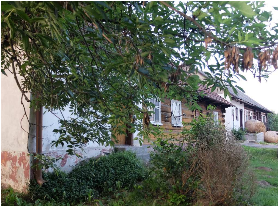
Fot. nr 114. Widok od strony dziedzińca. Z lewej dom spod nr 113, prawej obiekt pod nr 110.
