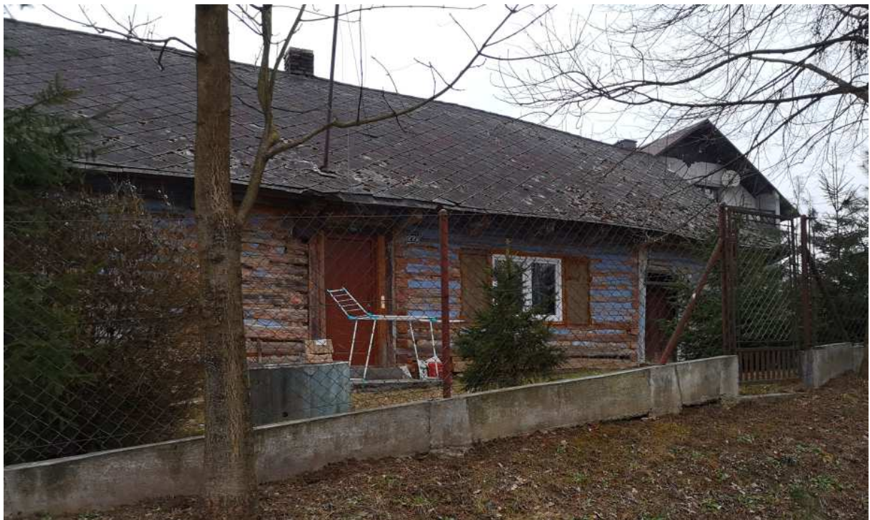
Fot. nr 208. Fragment fasady ze współczesnym oknem i drzwiami.
