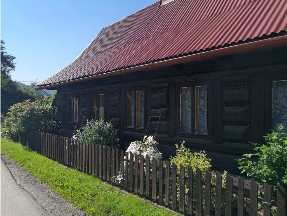
Fot. nr 367. Spojrzenie na fasadę.
