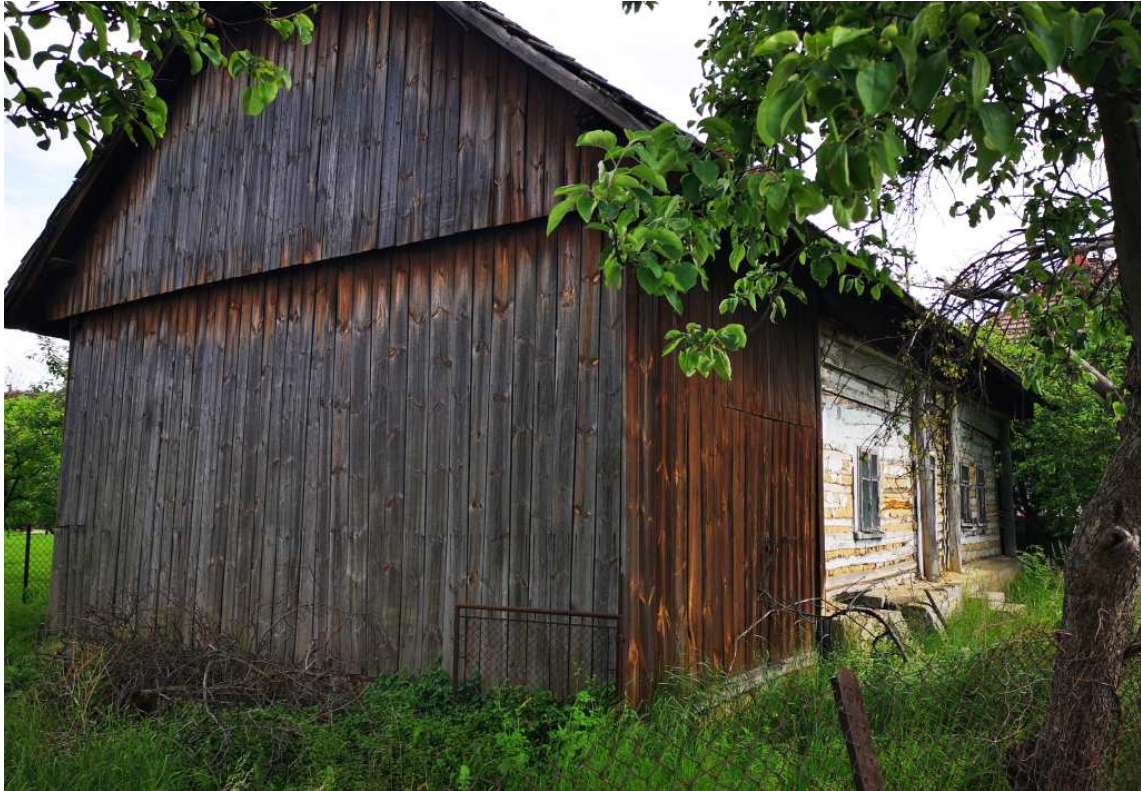
Fot. nr 274 (274-277). Chałupa o konstrukcji przysłopowej spod nr 10, zapewne z datowaniem z II połowy XIX wieku.
