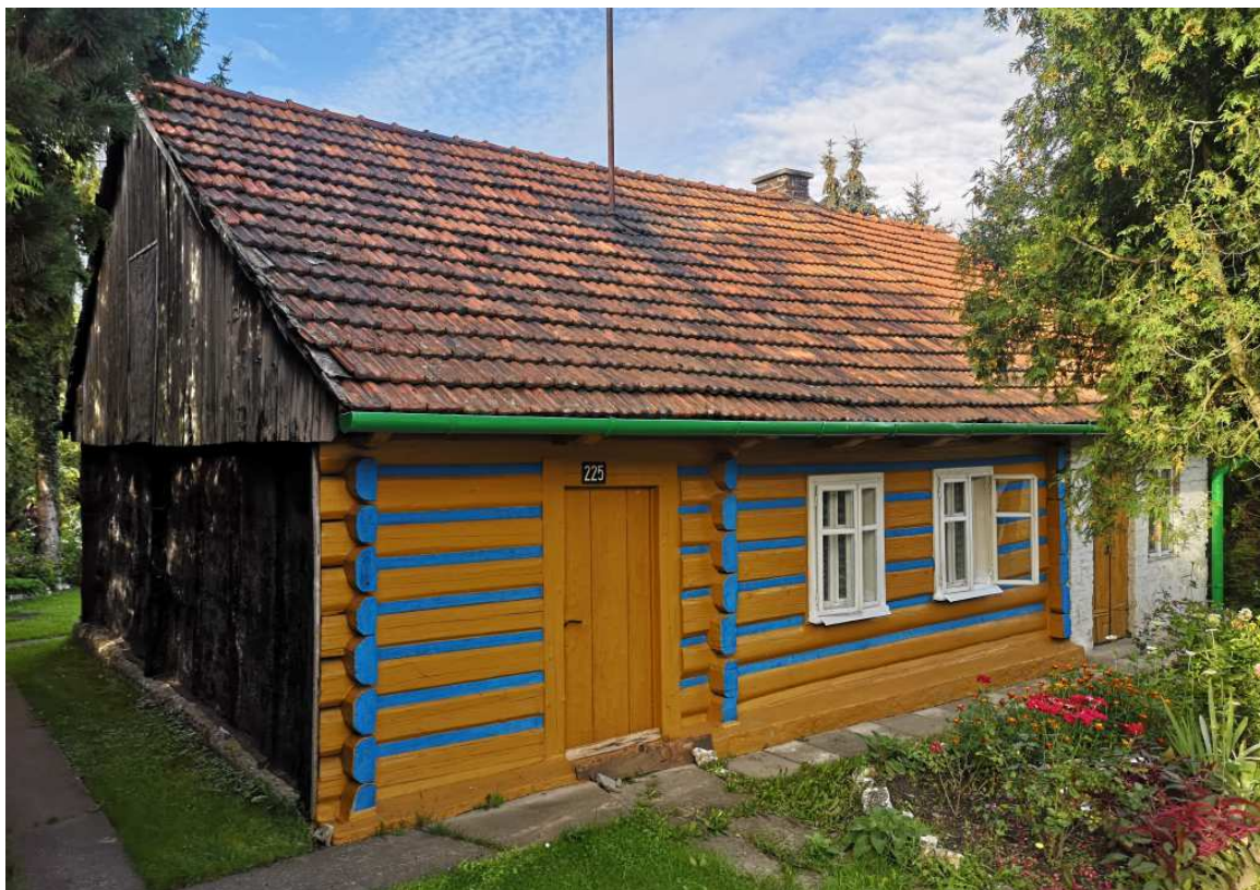
Fot. nr 83. Pięknie zadbana chałupa o konstrukcji zrębowej spod nr 225, wpisana do GEZ.
