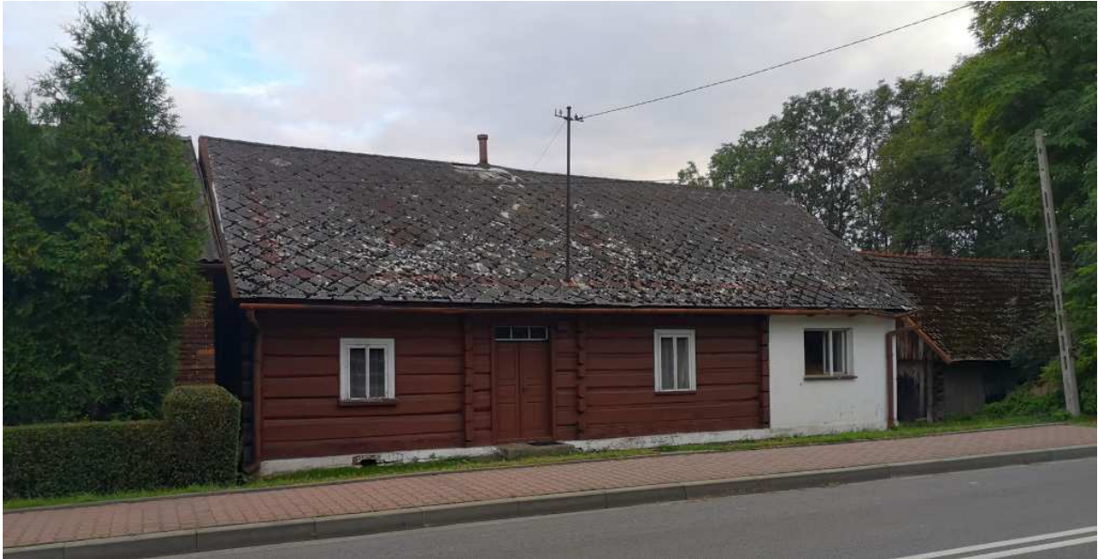
Fot. nr 111 (111-114). Dwie stojące obok siebie chałupy spod nr: 110 i 113 (z prawej).
