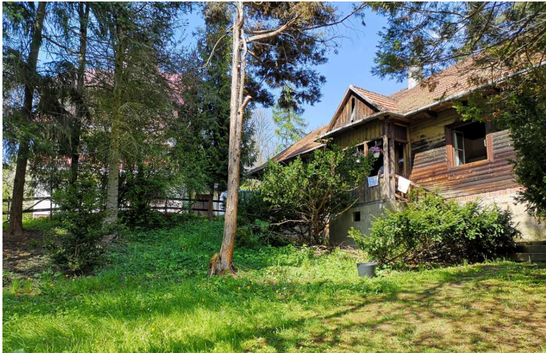
Fot. nr 304 (304-312). Stylowy dom z gankiem, usytuowany obok domu pod nr 884, wybudowany w roku 1938, remontowany w latach 70 i jego otoczenie.
