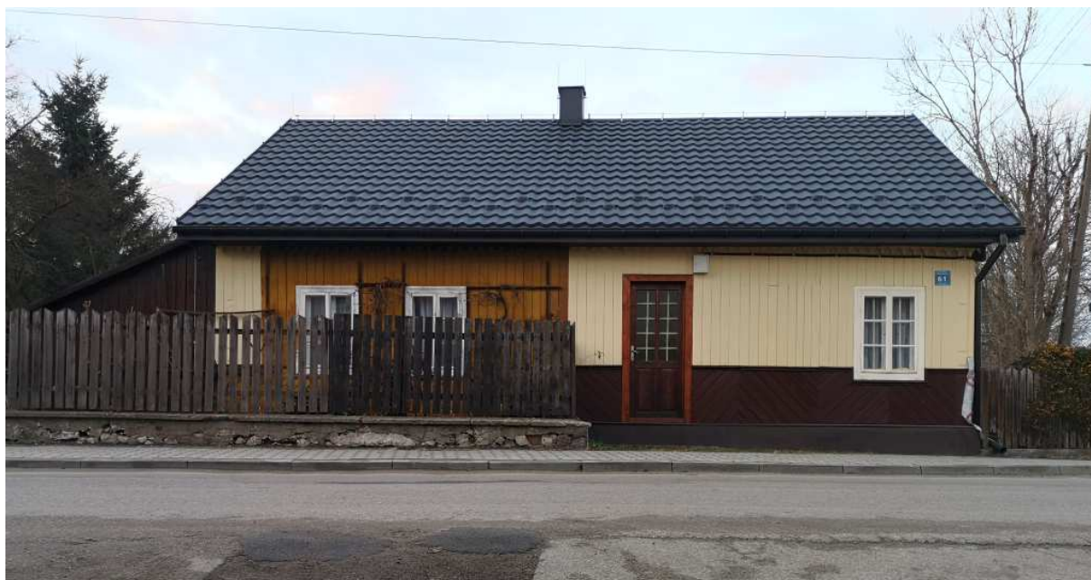
Fot. nr 144. Współcześnie zmodyfikowana fasada domu spod nr 85.
