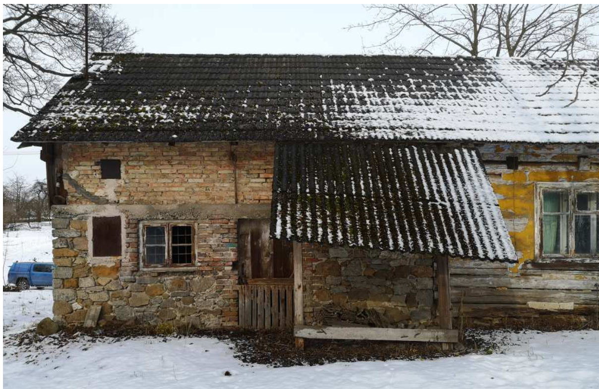
Fot. nr 13. Lewa część fasady z murowaną stajnią w narożu.
