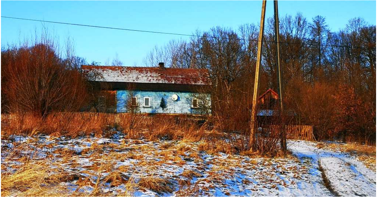
Fot. nr 243. Nowe okna w fasadzie niekorzystnie wpływają na jej wygląd.
