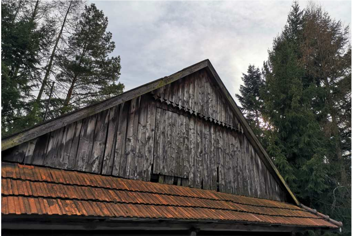
Fot. nr 307. Fragment ściany szczytowej na wysokości strychu.
