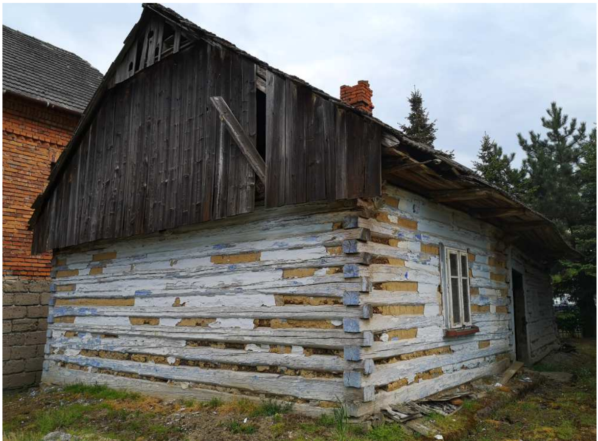
Fot. nr 222 (222-223). Ściana szczytowa.
