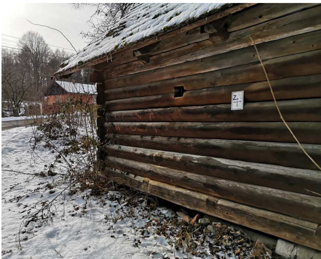
Fot. nr 20. Ściana spichlerza o konstrukcji zrębowej.
