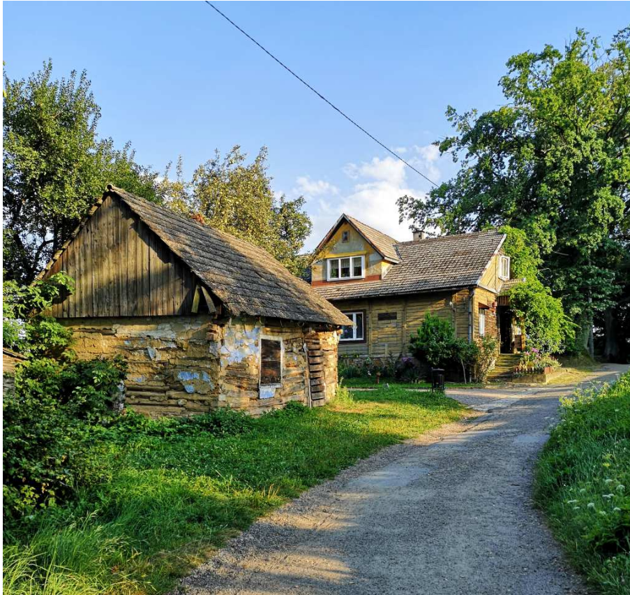
Fot. nr 397 (397-400). Na posesji przy ulicy Stare Miasto 3.
