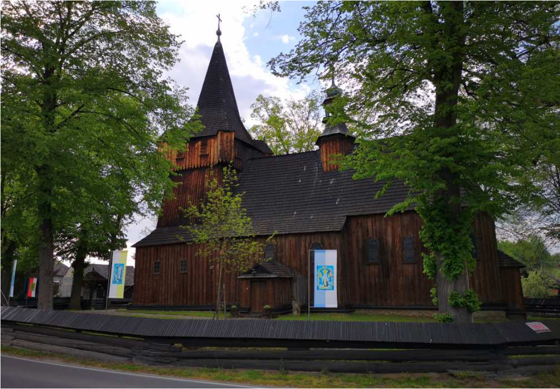
Fot. nr 215 (215-216). Kościół p.w. Wniebowzięcia NMP powstały na przełomie XV i XVI wieku, ujęty w Rejestrze Zabytków.
