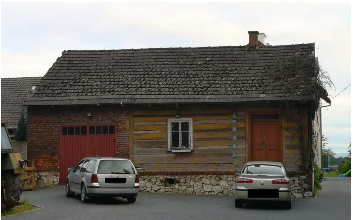
Fot. nr 94. Oryginalna część dawnej chałupy w prawym fragmencie domu przy ulicy Czenichowskiej.
