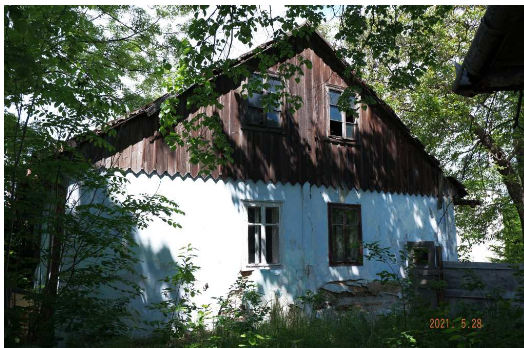
Fot. nr 388 (388-389). Ściana szczytowa.
