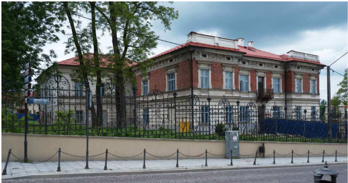
Fot. nr 446. Eklektyczny budynek szkoły przy ulicy Daniłowicza 12.
