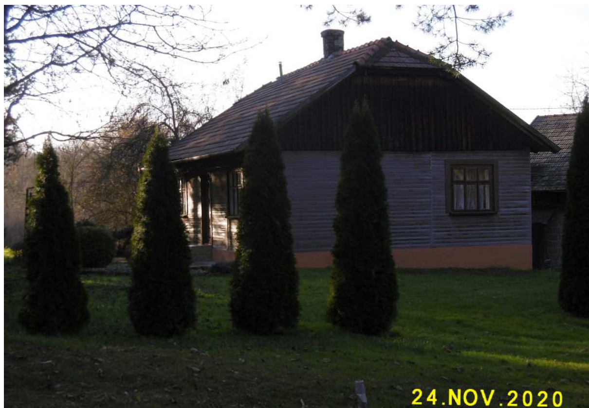
Fot. nr 241 (241-242). Współcześnie oszalowany dom drewniany o konstrukcji zrębowej i oknach typu weneckiego spod nr 9, który mógł powstać około roku 1930.
