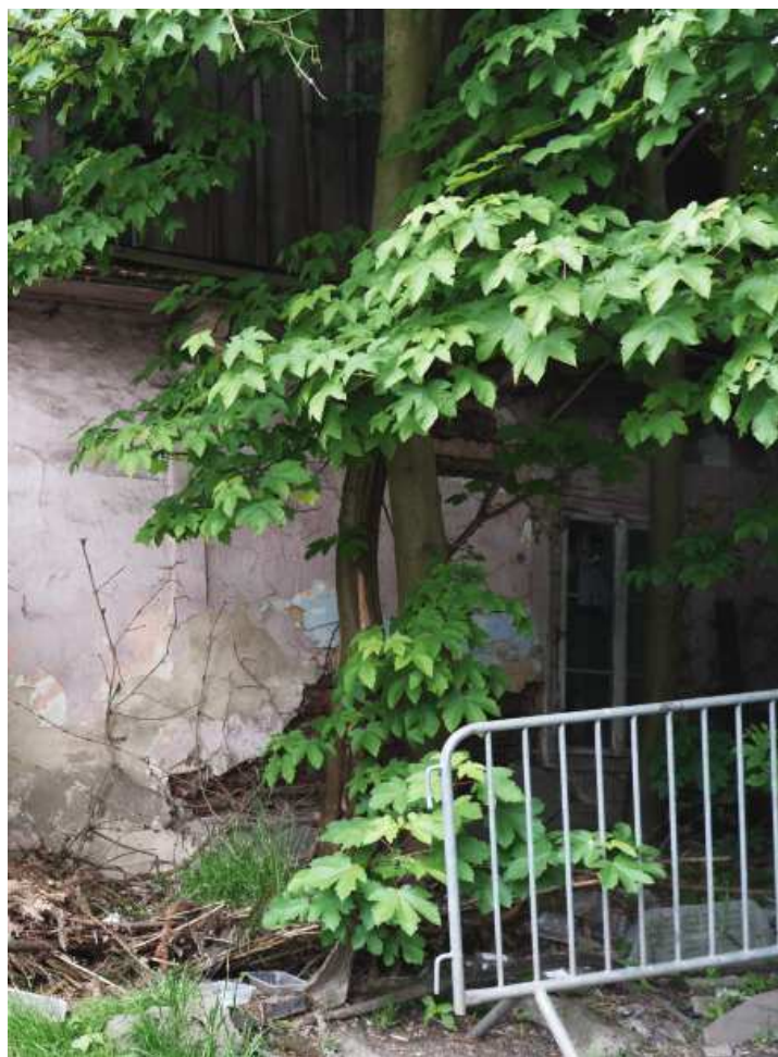
Fot. nr 413. Ściana boczna.
