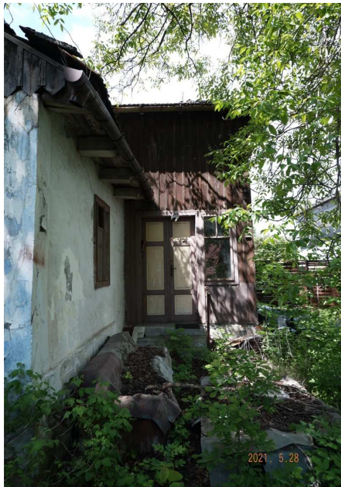
Fot. nr 390 (390-391). Tylna część z piętrowym gankiem.
