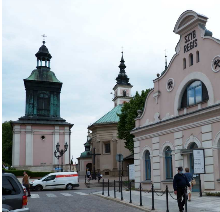
Fot. nr 439 (439-440). Szyb Regis KSW przy pl. Kosciuszki 9 i kościół p.w. św. Klemensa.
