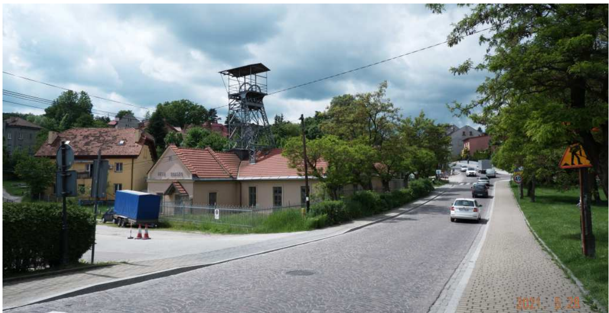
Fot. nr 406. Szyb Górsko KSW przy ulicy Górsko 14/16.
