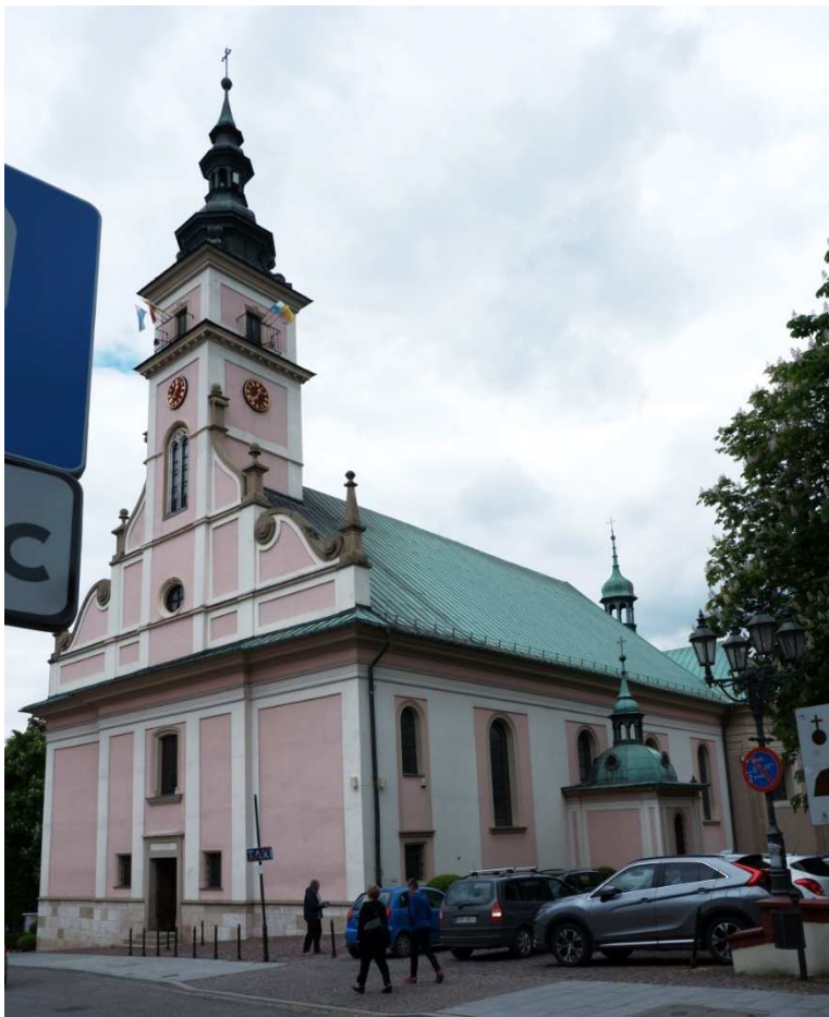
Fot. nr 442. Fasada od strony ulicy Zamkowej.
