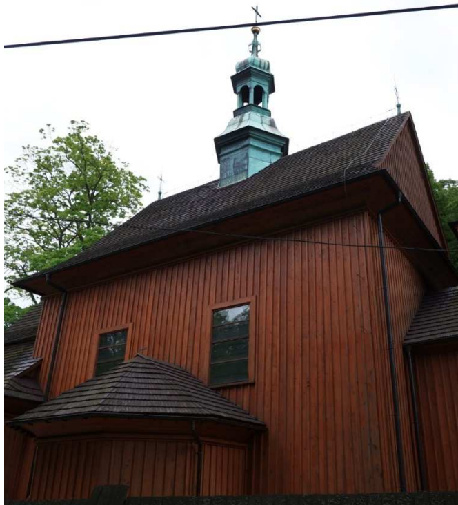
Fot. nr 423 (423-424). Południowa ściana z wejściem bocznym.
