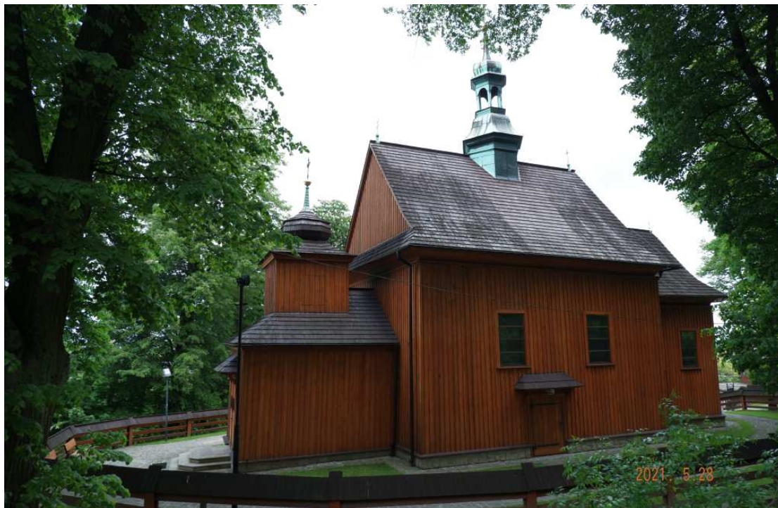
Fot. nr 421 (421-426). Zabytkowy kościółek p.w. św. Sebastiana, usytuowany przy ulicy św. Sebastiana 23, wzniesiony z modrzewia w roku 1581, przebudowany w XVIII wieku.
