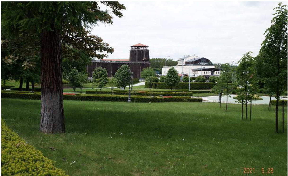
Fot. nr 448. Widok na solankową tężnię.
