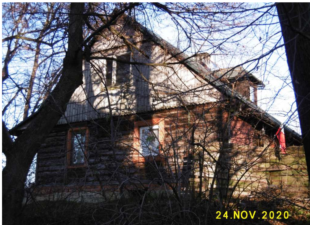
Fot. nr 227. Ściana szczytowa zapewne przedwojennego, drewnianego domu spod nr 72.
