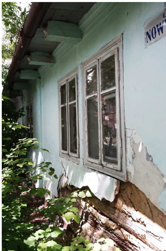
Fot. nr 387. Ściana fasadowa z oryginalnymi oknami typu ościeżnicowego. Spod białej polepy wyłania się drewniana faktura typu zrębowego. Szanse na przetrwanie maleją.
