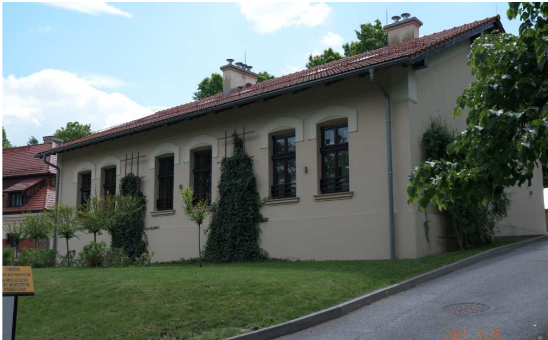
Fot. nr 396. Praktycznie wybudowany od nowa dom pod nr 2, będący dawnym budynkiem mieszkalnym pracowników KSW. z powstałego na początku XX wieku oryginału pozostała tylko ściana frontowa,
