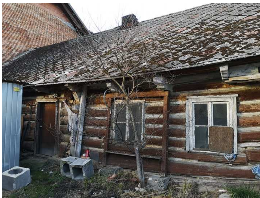
Fot. nr 24 (24-25). Detale fasady.
