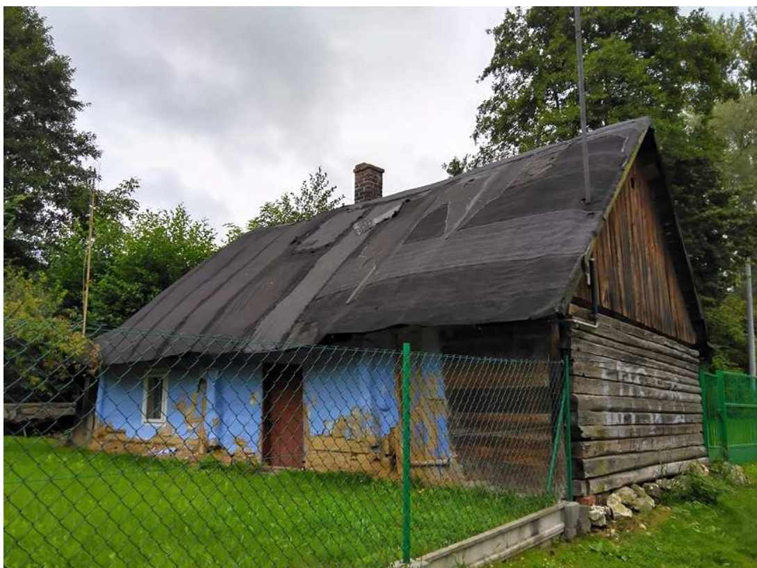
Fot. nr 293 (293-296). Chałupa przy wejściu do Dolinki przy ulicy Turystycznej 10A.
