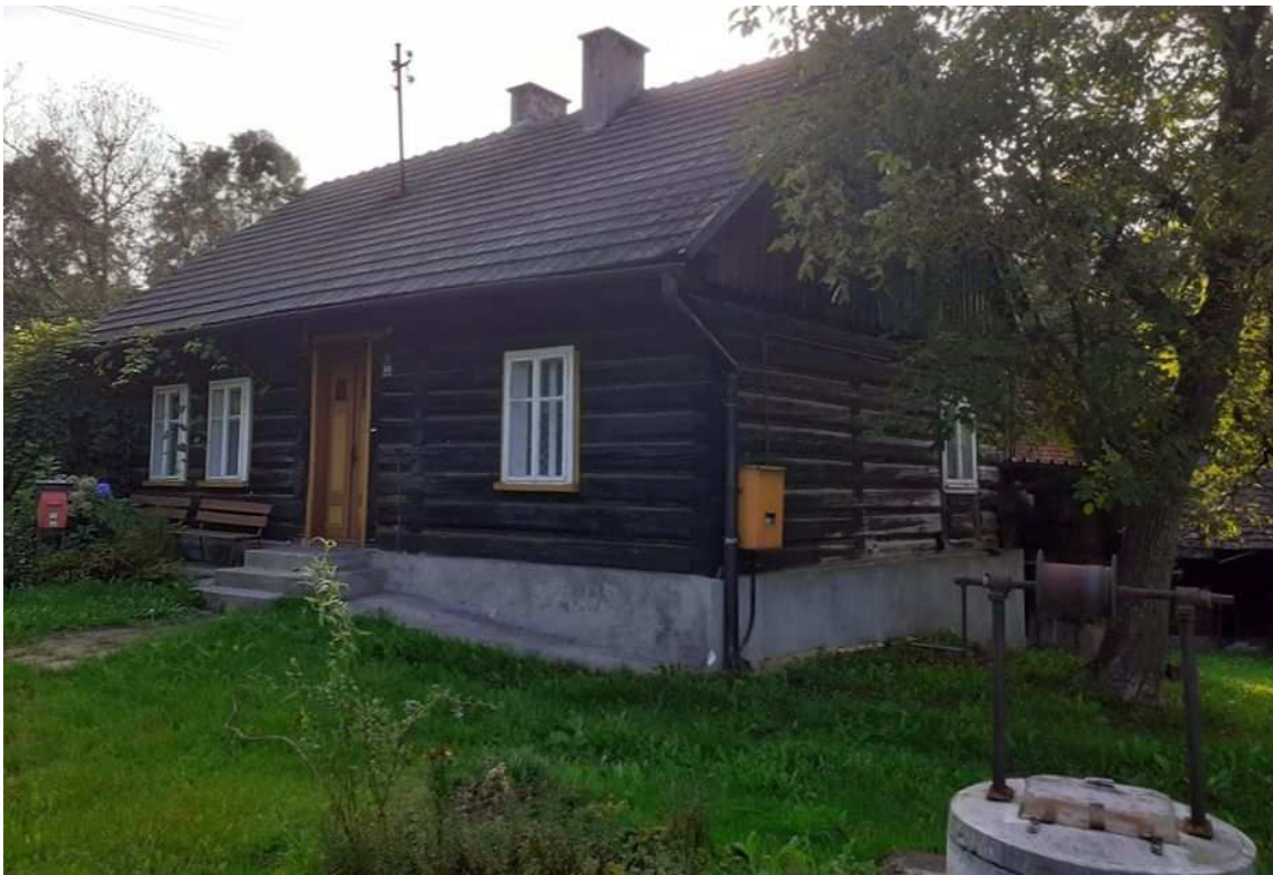
Fot. nr 322 (322-323). Chałupa zapewne z początku XX wieku z ulicy Bukowskiej.
