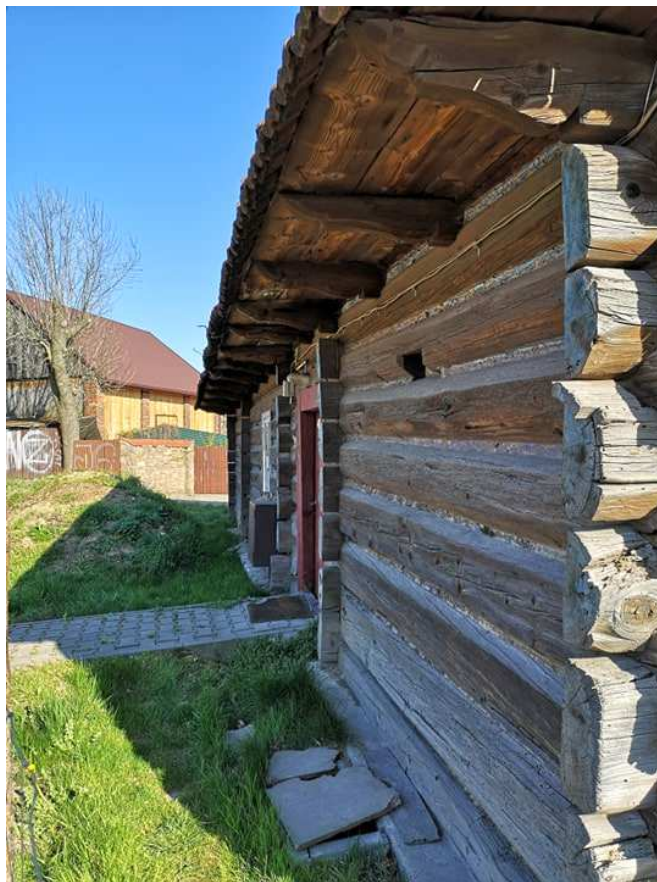
Fot. nr 100 (100-104). Ściana od strony drogi i jej detale.
