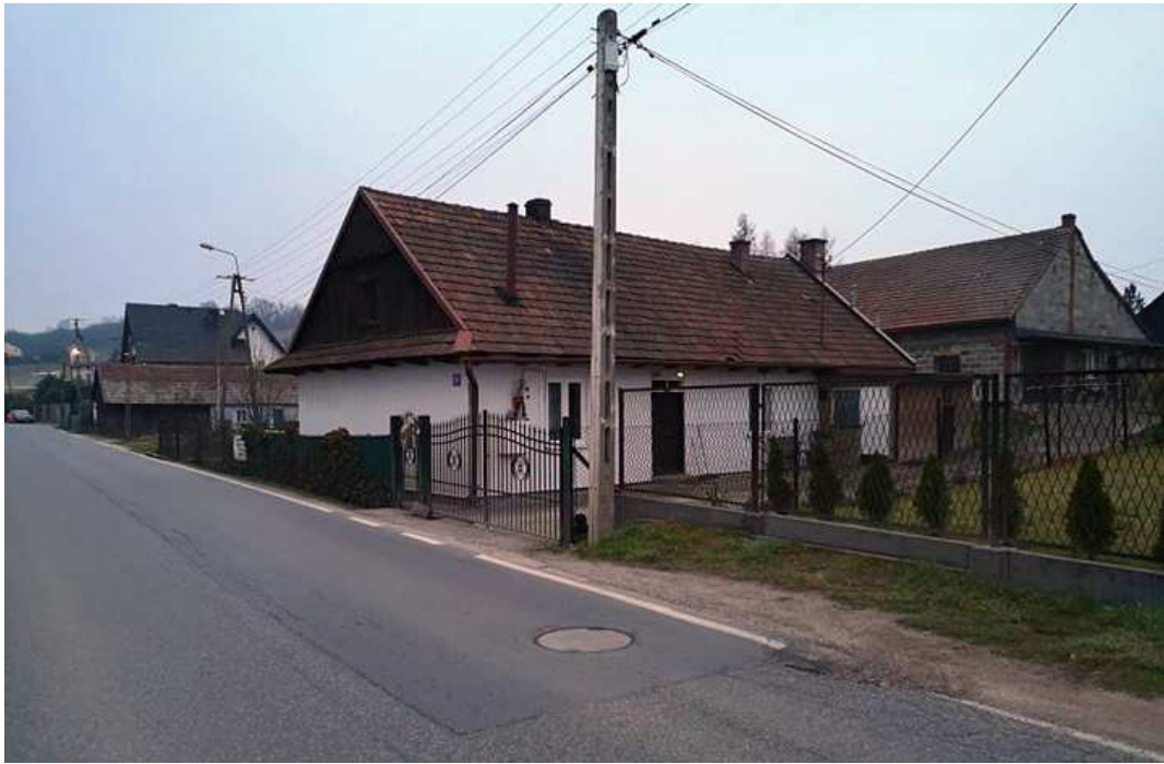
Fot. nr 208 (208-209). Bielona chałupa z ulicy Brzegi 29.
