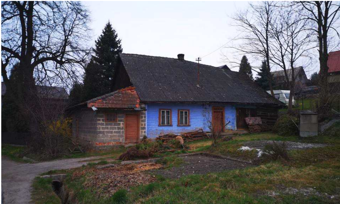
Fot. nr 215 (215-218). Chałupa we wspólnym korpusie ze stodołą spod nr 41. Kompleks mógł powstać na początku XX wieku.
