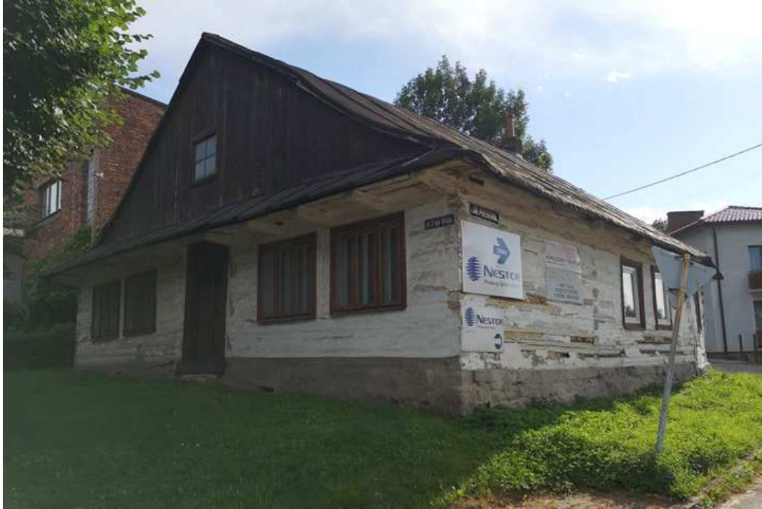
Fot. nr 237 (237-239). Ściana szczytowa.
