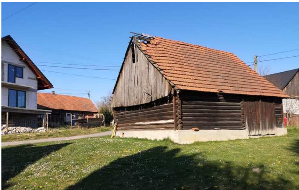
Fot. nr 108 (108-111). Usytuowana na tyłach posesji pod nr 2 stodoła i jej detale.
