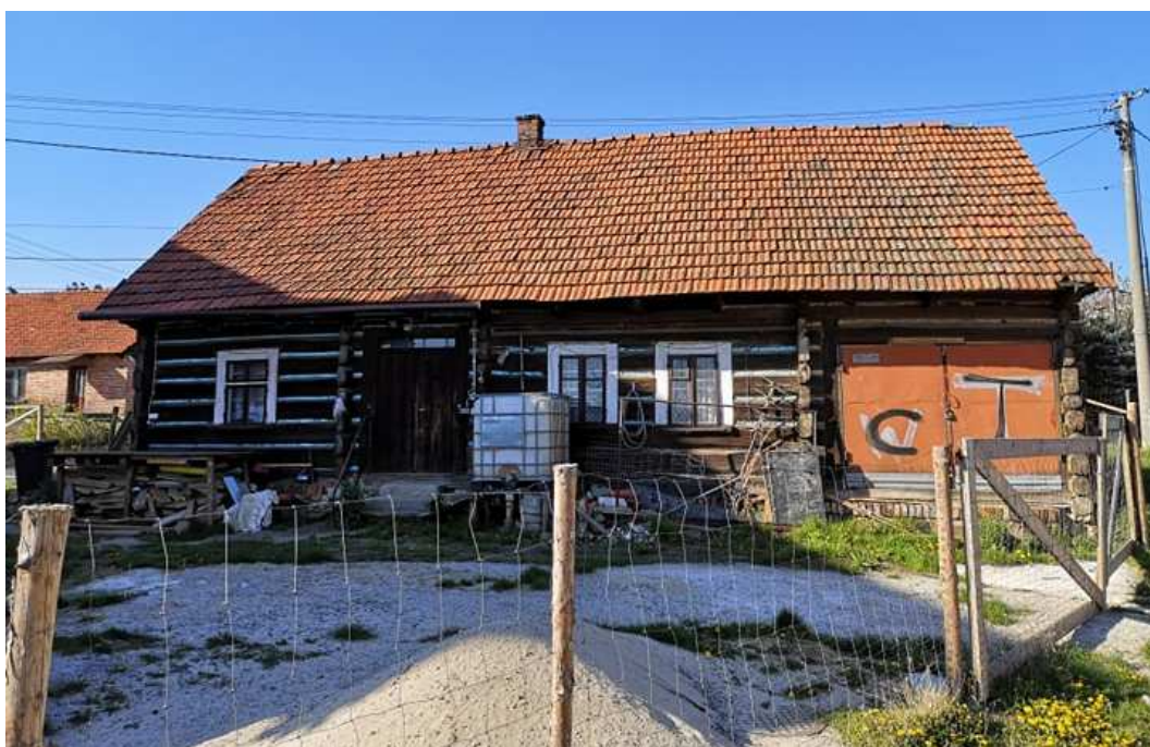
Fot. nr 106 (106-107). Fasada tej zapewne półtoratraktowej chałupy od strony podwórka.
