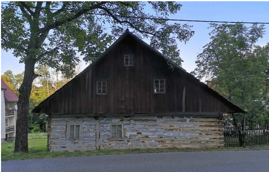
Fot. nr 268 (267-269). Ściana szczytowa.
