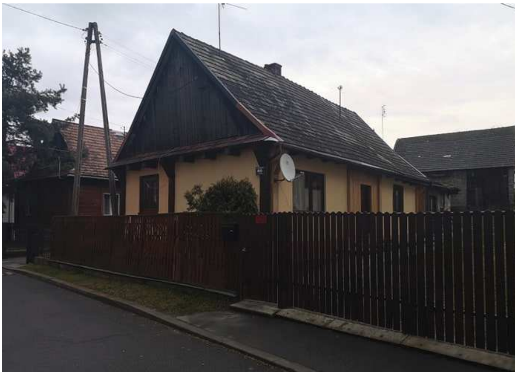
Fot. nr 85 (85-86). Dom przy ulicy Majówny 40, w którym drewniana faktura została ukryta pod tynkiem.
