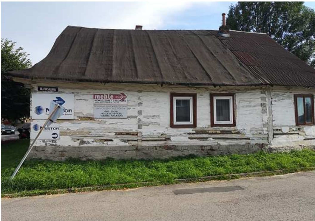
Fot. nr 240 (240-241). Front chałupy z wymienionymi już oknami.
