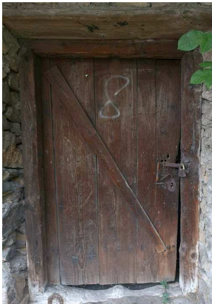
Fot. nr 37 (37-38). Oryginalne drzwi i ich zamknięcie.
