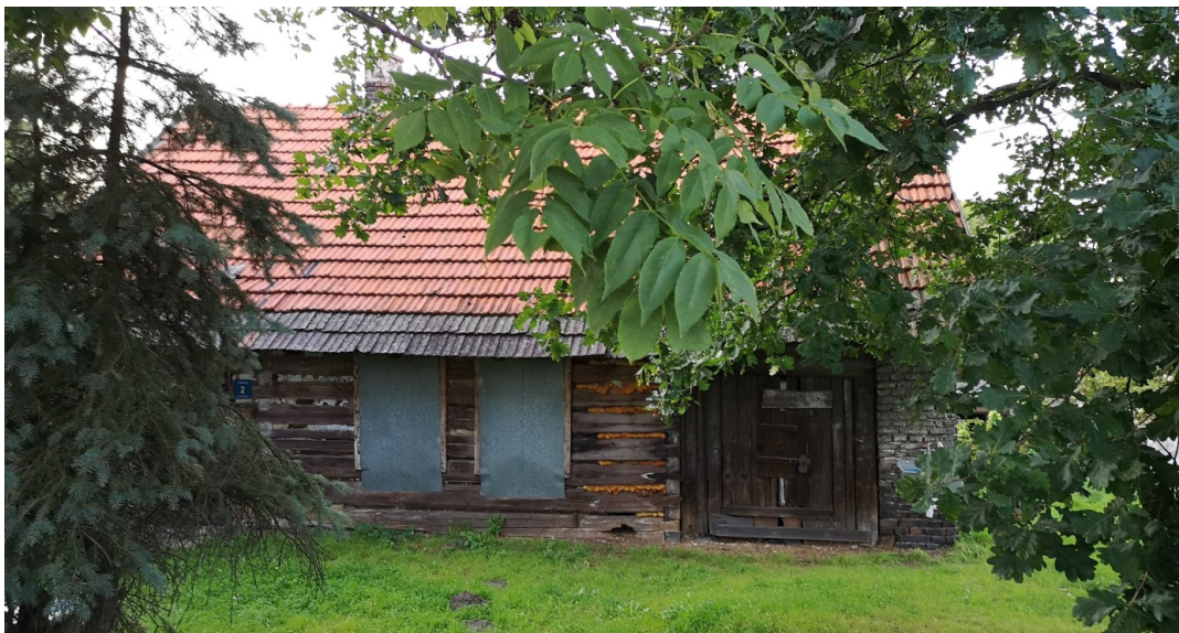
Fot. nr 168 (168-169). Chałupa spod nr 2, usytuowana w sąsiedztwie kaplicy.
