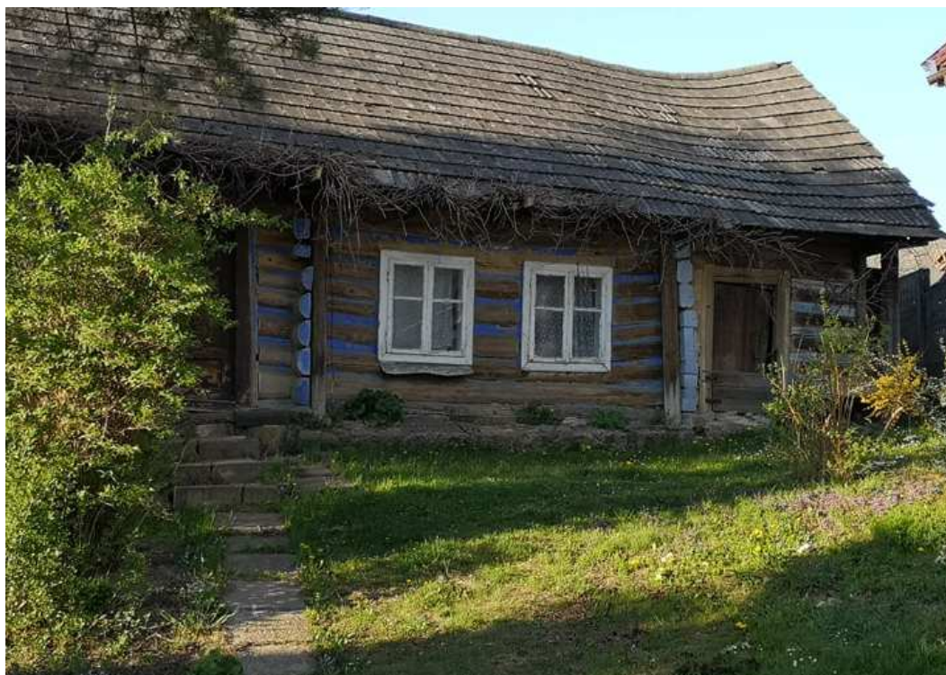
Fot. nr 132 (132-133). Detale frontowej ściany.
