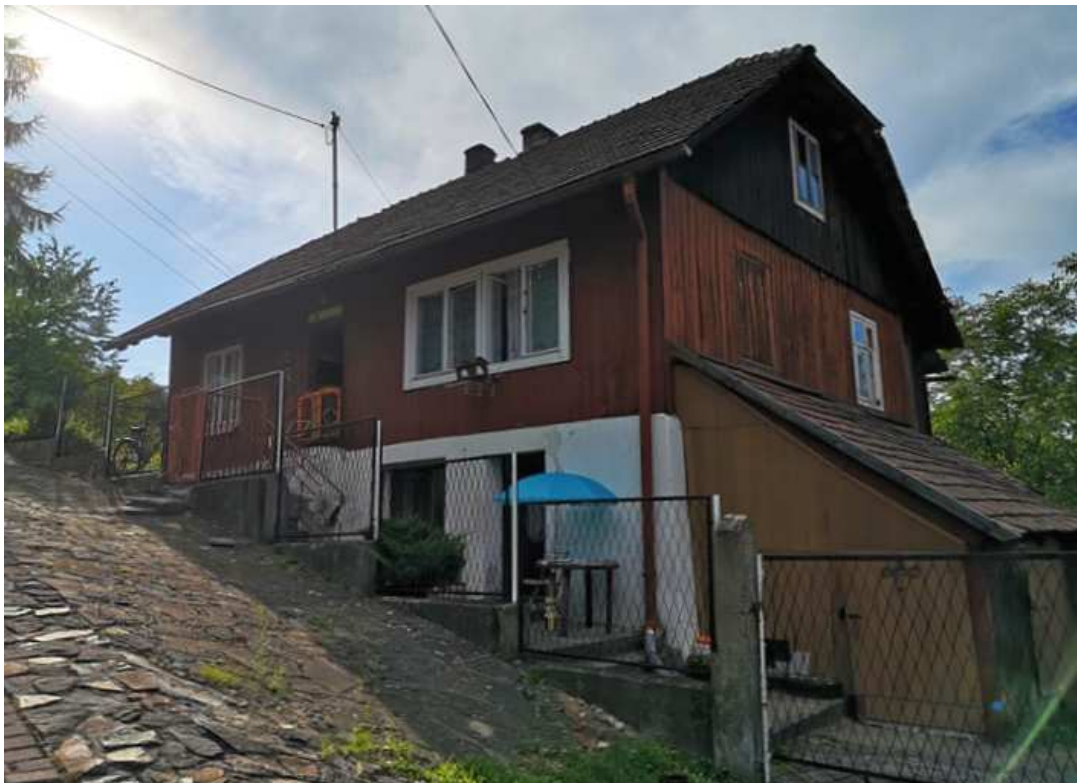
Fot. nr 254 (254-255). Przedwojenny dom o znacznie przekształconej już fasadzie.
