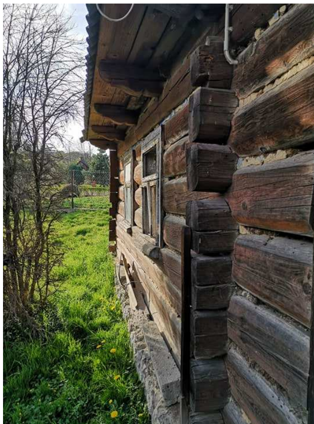
Fot. nr 45 (45-46). Okna w fasadzie.
