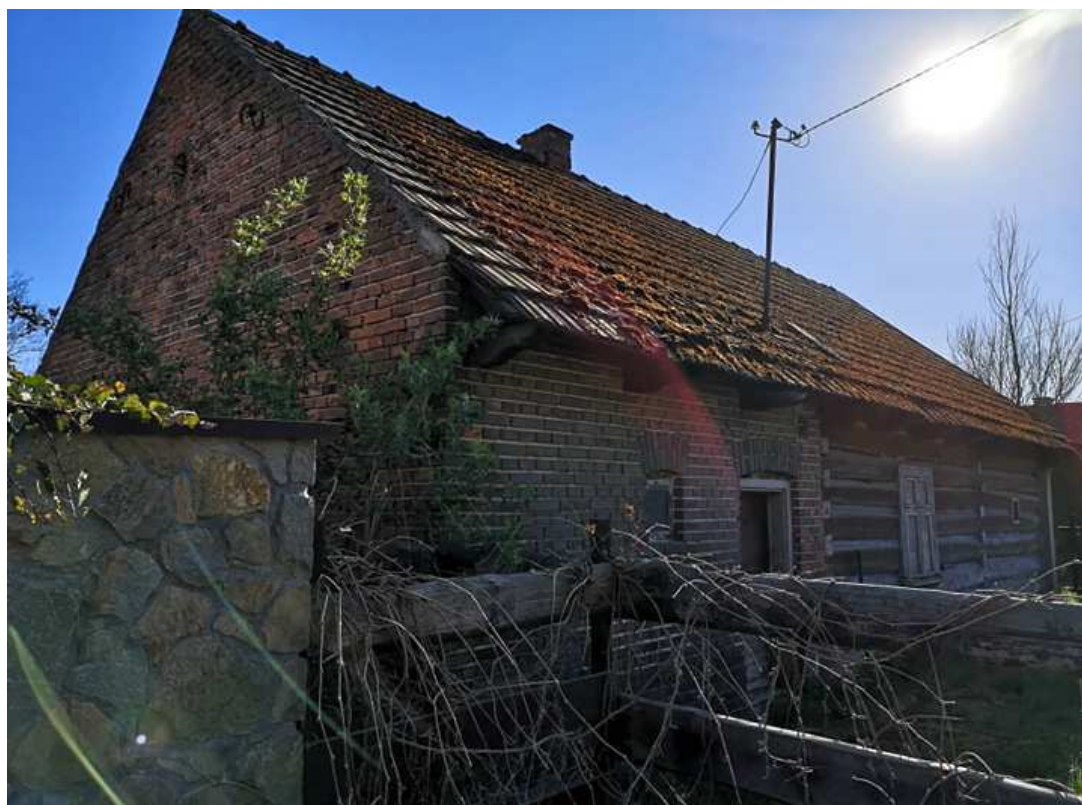
Fot. nr 112 (112-115). Drewniana chałupa z dobudowaną do niej z cegły stajnią o nieustalonej lokalizacji.
