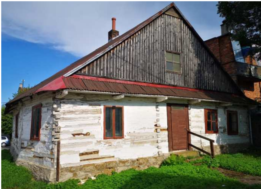
Fot. nr 242 (242-243). Druga ze ścian szczytowych.
