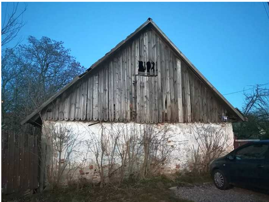
Fot. nr 89 (89-90). Zapewne przedwojenny, murowany dom z ulicy Jantarowej 14.
