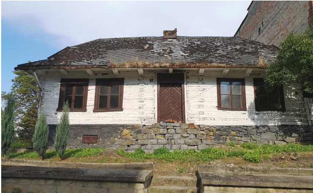
Fot. nr 245 (245-246). Frontowa ściana.
