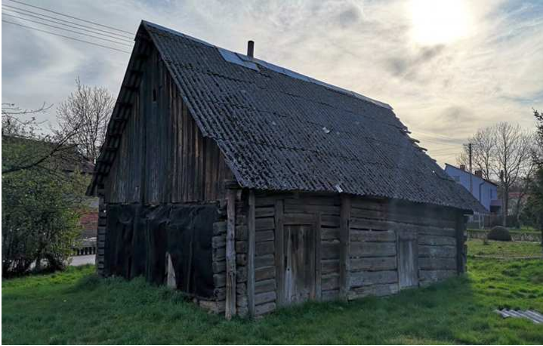
Fot. nr 51 (51-55). Ściana szczytowa i tylna część chałupy.
