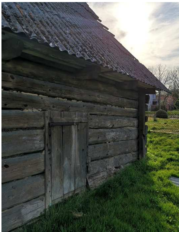
Fot. nr 54 (54-55). Drzwi od części gospodarczej.
