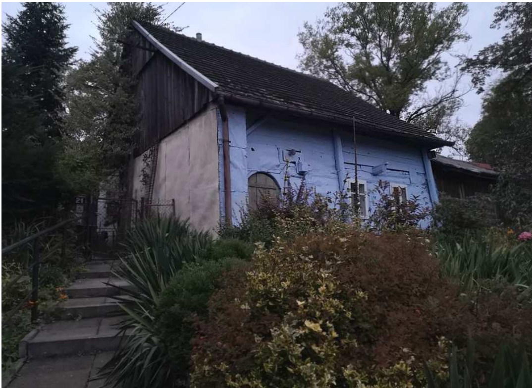
Fot. nr 289 (289-292). Archaiczna chałupa z ulicy Franciszka Bielowicza 21. Obiekt o konstrukcji przysłopowej z półkolistym odrzwiem.
