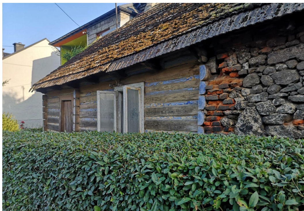
Fot. nr 173 (173-174). Oryginalne drzwi i nieco późniejsze okno.
