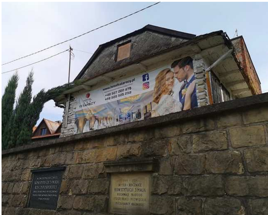
Fot. nr: 244-262. Wzdłuż ulicy Bernardyńskiej. Fot. nr 244 (244-247). Bielona, ponad stuletnia chałupa z dachem okapowym spod nr 5.
