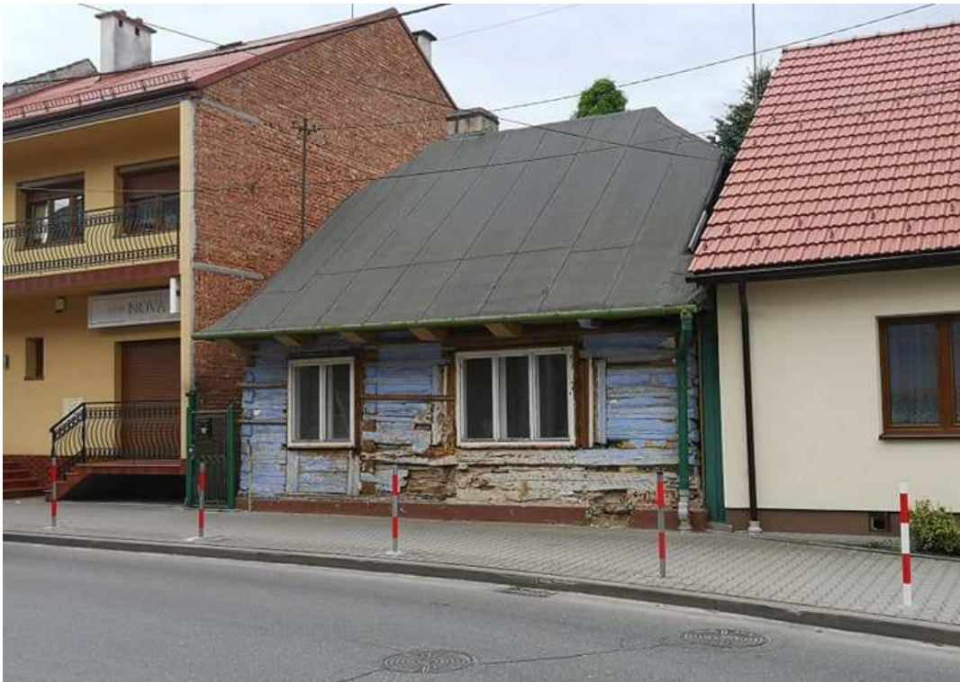
Fot. nr 198 (198-201). Archaiczna chatka z ulicy Zamkowej 18. Fot. nr: 198-200. Stan sprzed remontu.
