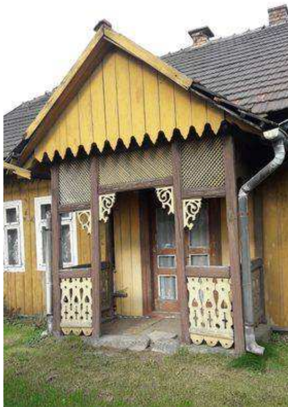
Fot. nr 317. Profilowany w drewnie ganek.
