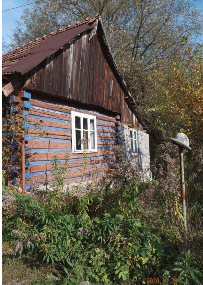
Fot. nr 252 (252-253). Ściana szczytowa i dobudowany do niej z pustaków tylny fragment.
