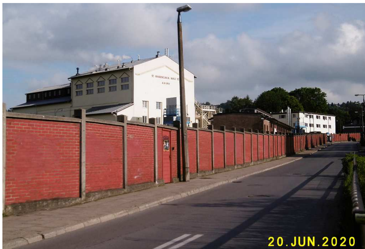
Fot. nr 25 (25-27). Zabudowania KS Wieliczka w ujęciach wzdłuż ulicy Matejki. Fot. nr 25 (25-26). Z budynkiem dawnej warzelni z lewej.
