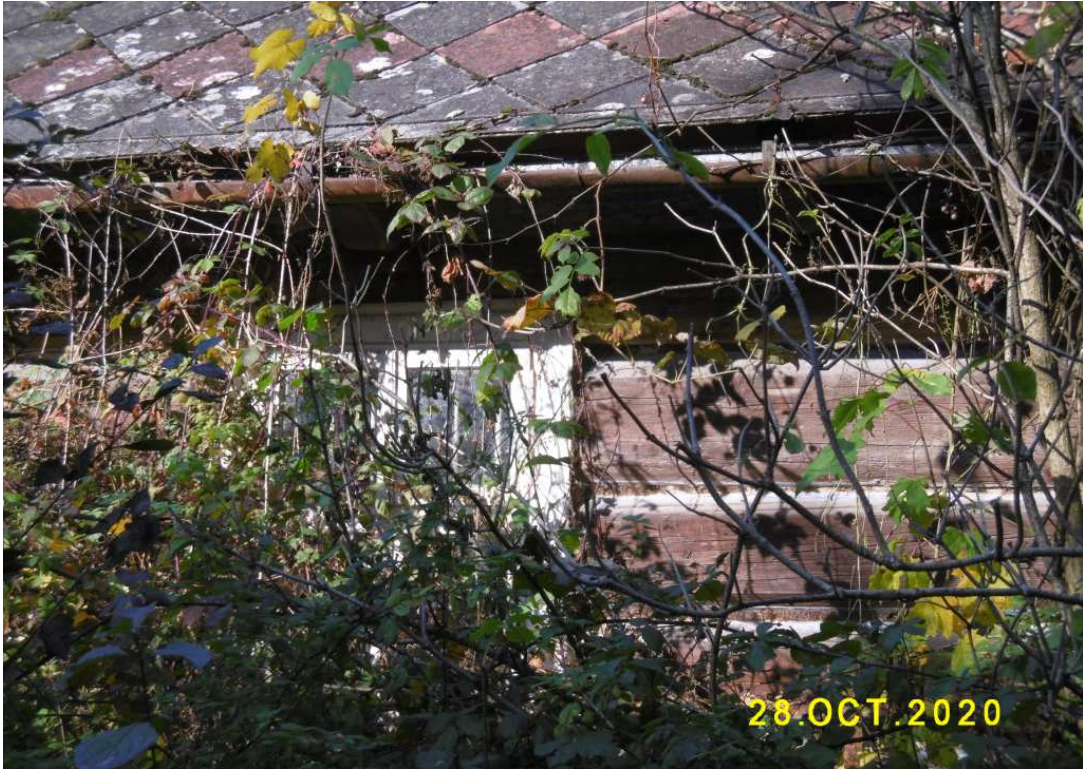
Fot. nr 274. Oryginalne okno w prawym fragmencie.
