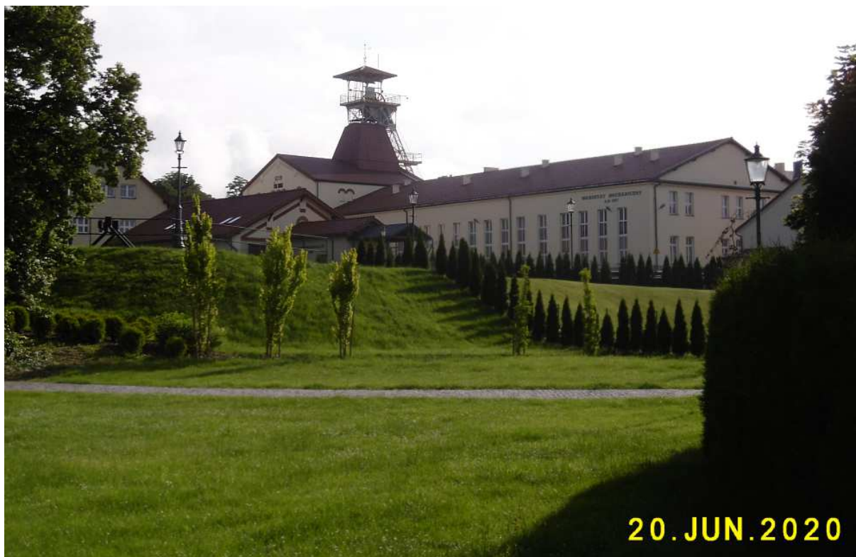
Fot. nr 14. Szyb św. Kingi i zabudowania warsztatu mechanicznego.
