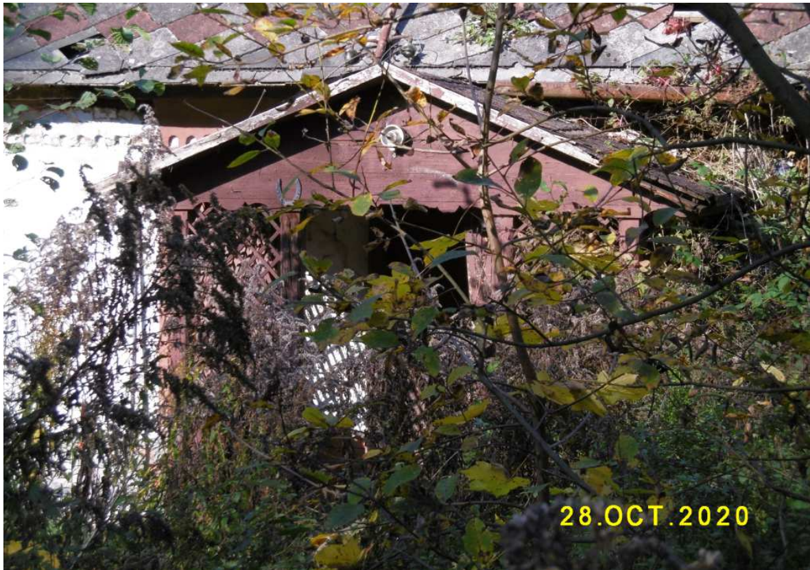
Fot. nr 276. Profilowany w drewnie ganek.
