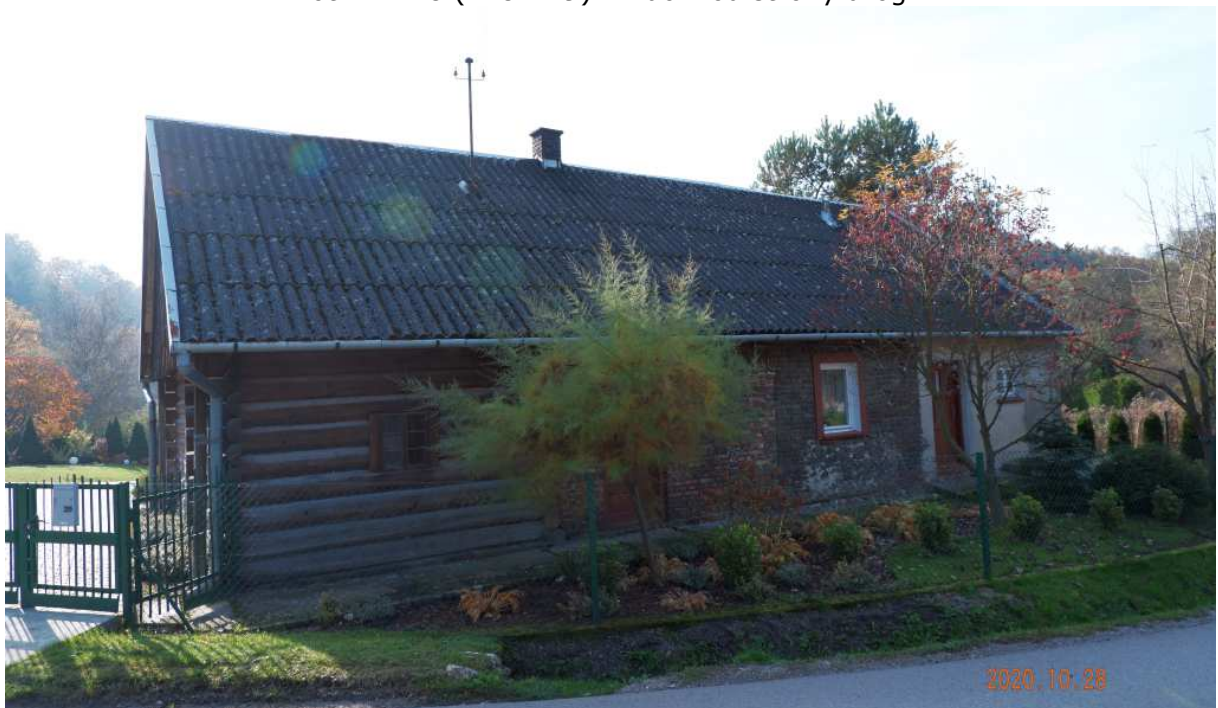
Fot. nr 249. Prawy fragment dobudowany bądź przebudowany na murowany.
