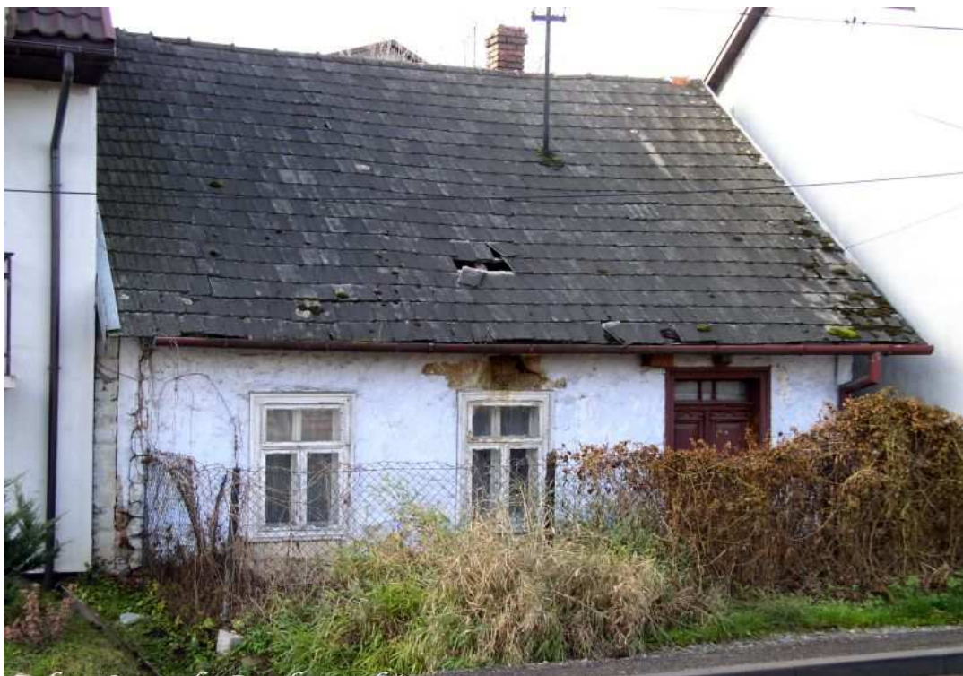
Fot. nr 1a. Wyburzona właśnie gdowska chałupa pod nr 16 przy ulicy Krakowskiej wg stanu z grudnia roku 2008.
