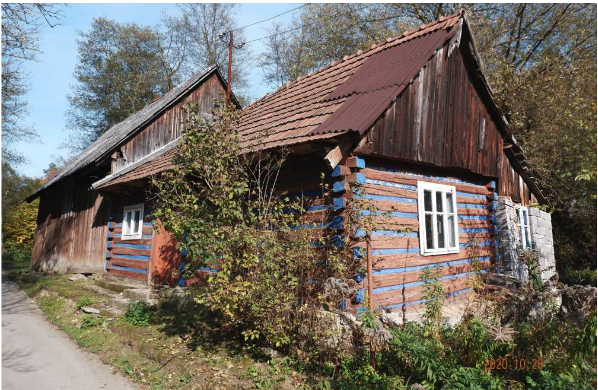
Fot. nr 251 (251-261). Niezwykłej urody, zapewne jeszcze XIX-wieczna, jednotraktowa chałupa pod nr 205, do której we wspólnym korpusie przylega stodoła.
