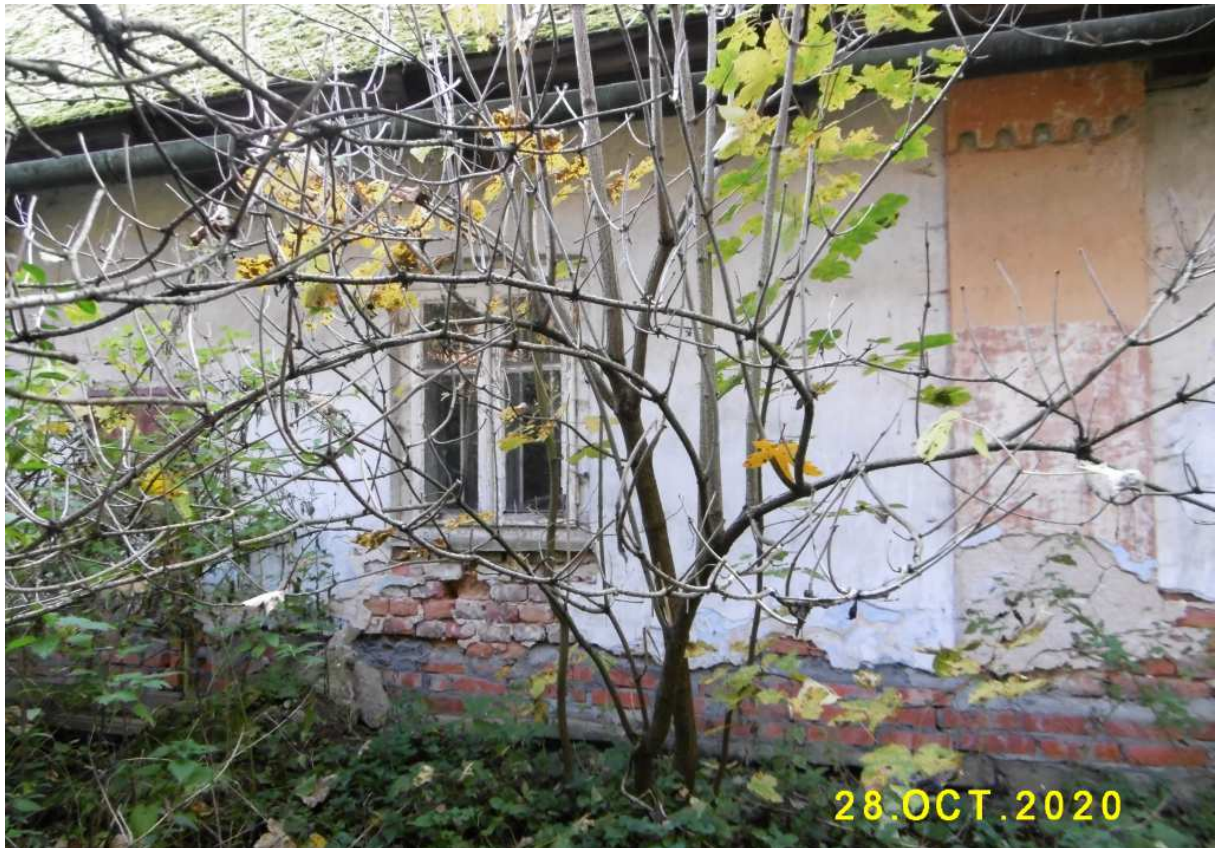
Fot. nr 272. Oryginalne okienko typu ościeżnicowego.
