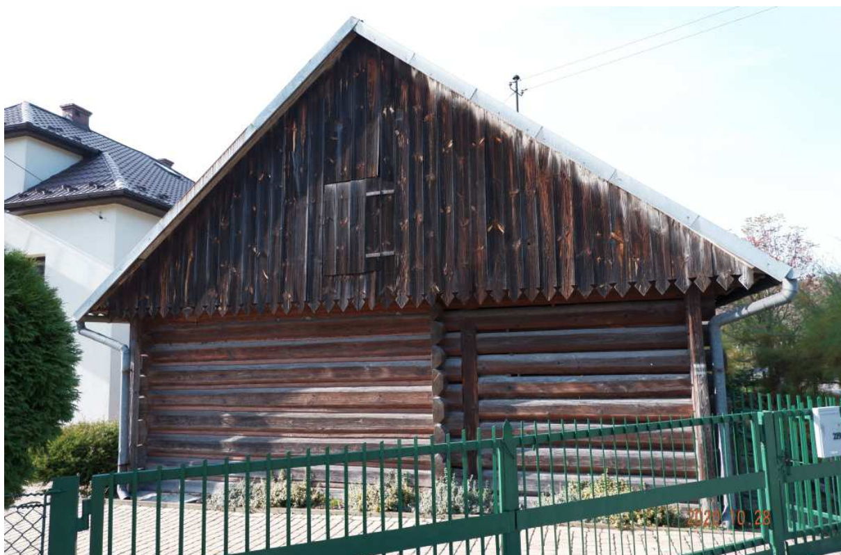
Fot. nr 247. Ściana szczytowa.
