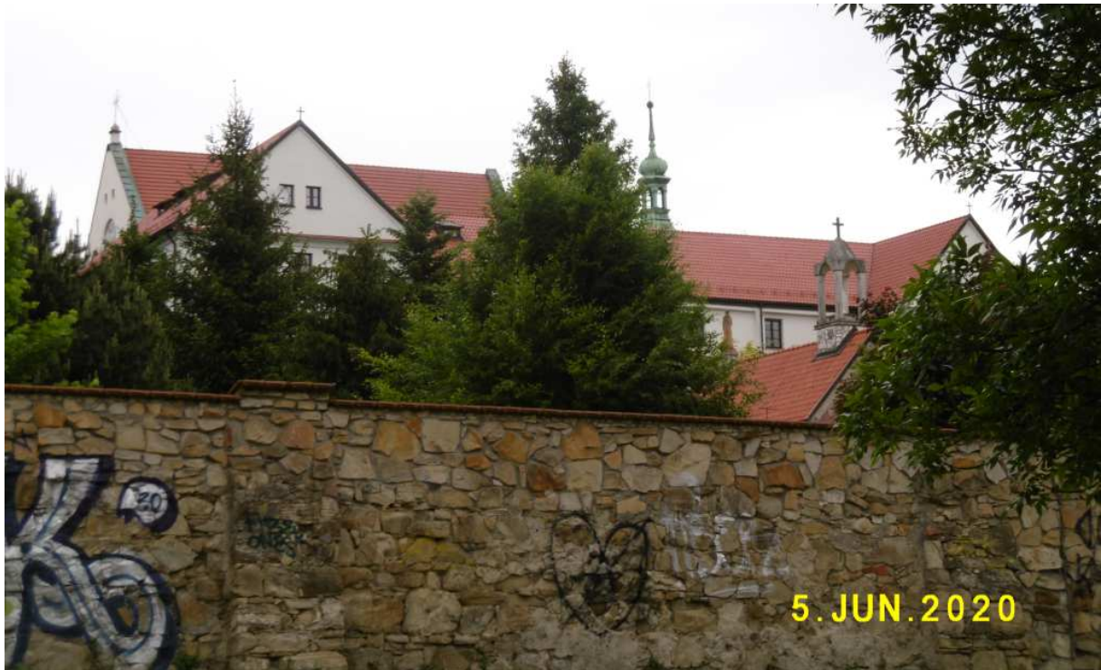
Fot. nr 6 (6-7). Widoki od strony torów kolejowych.
