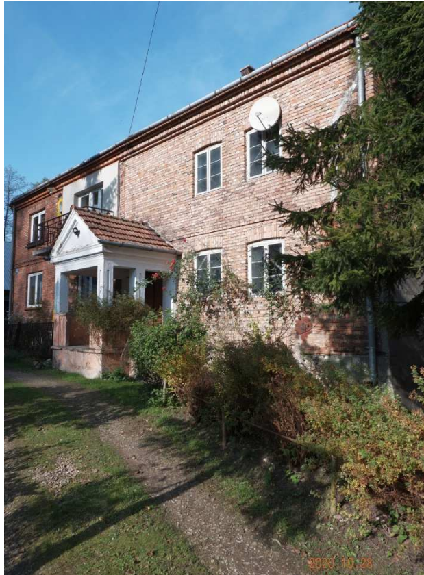
Fot. nr 310 (310-312). Murowana zagroda pod nr 118.
