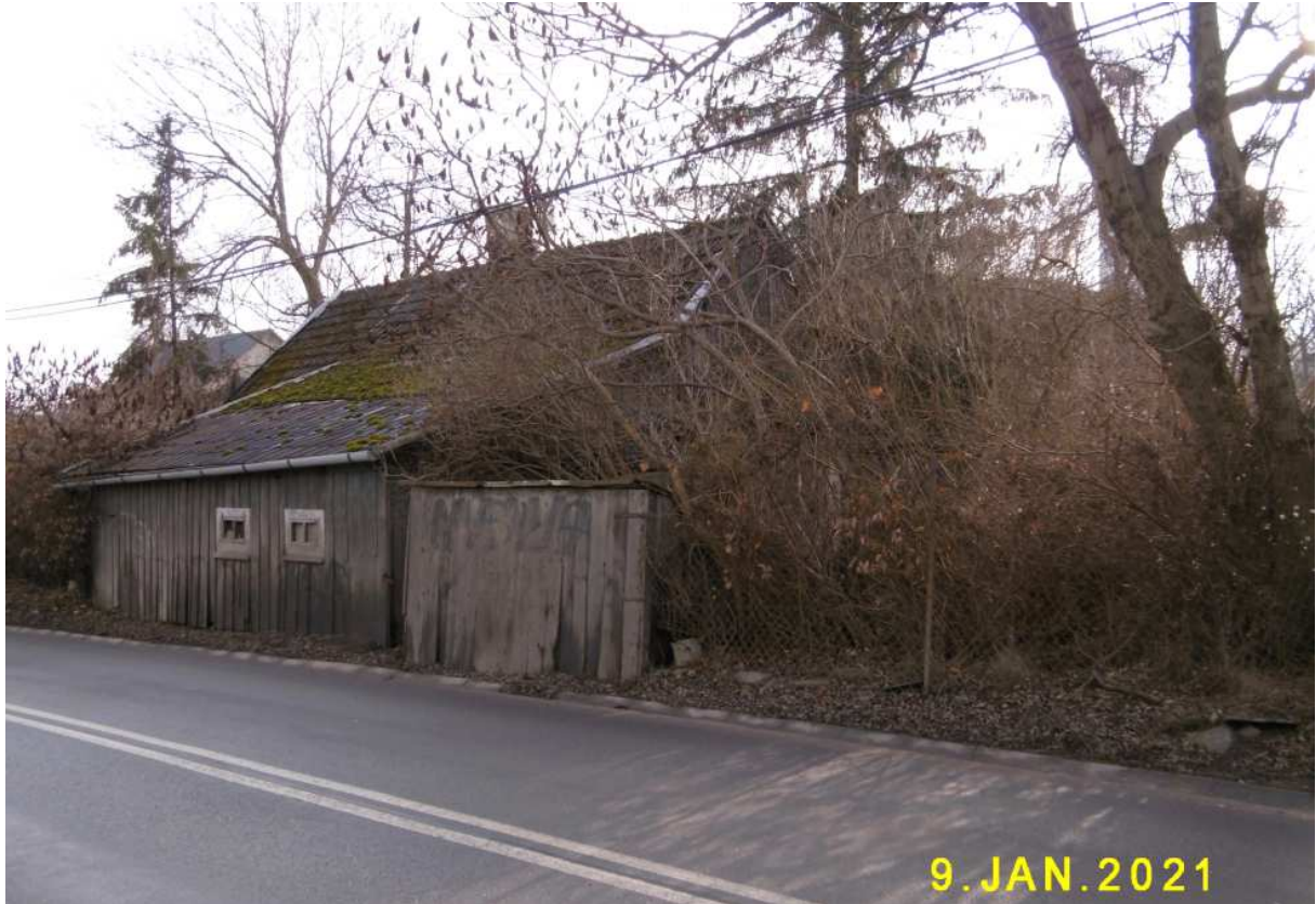
Fot. nr 346. Tylna część do budowy od strony ulicy.
