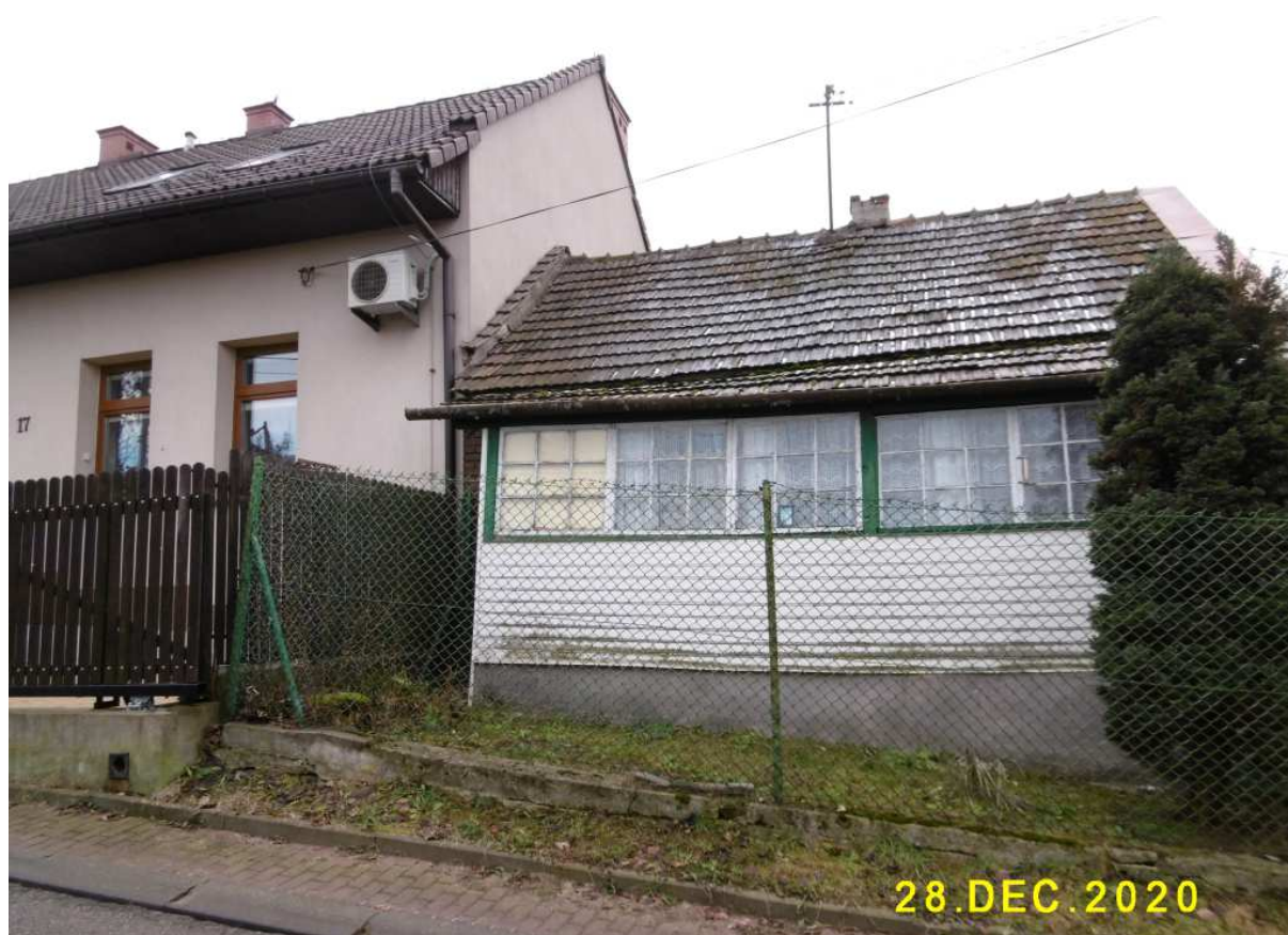
Fot. nr 144. Weranda od strony ulicy.
