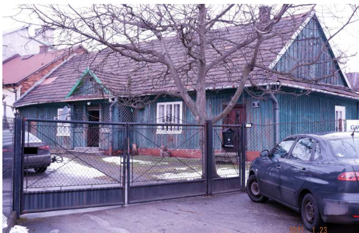
Fot. nr 449 (449-453). Rozległy dom wielorodzinny z ulicy Gwarnej 26. Ten oszalowany obiekt z ozdobnym gankiem mógł powstać na przełomie lat 20/30 zeszłego wieku. Tylna część od stony ulicy Pochyłej równie barwna i ciekawa.
