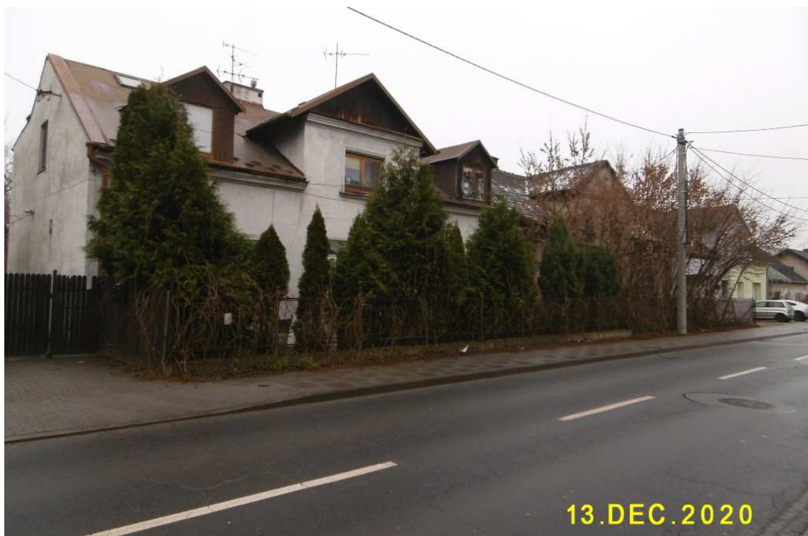
Fot. nr 211. Trzy domu o numerach: 61, 63 i 65, pochodzące z I ćwierci XX wieku. Wszystkie budynki są parterowe, z dobudowanym facjatkami.
