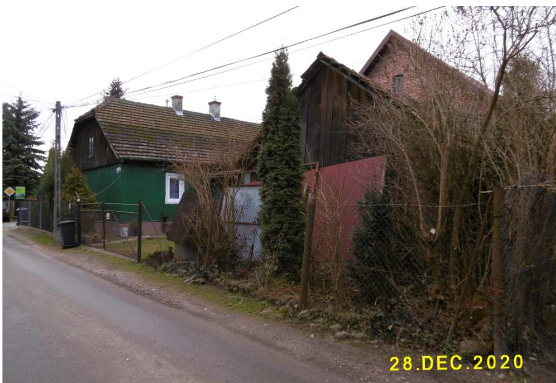
Fot. nr 109. Widok od strony podwórka.
