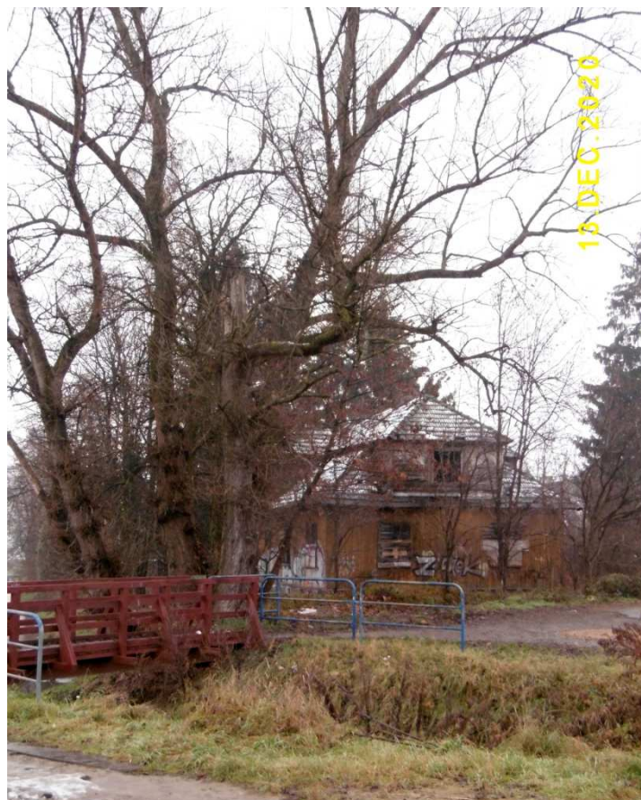
Fot. nr 236 (236-242). Kilka ujęć zrujnowanej, przedwojennej willi z ulicy Czechowicza 10, która dogorywa od kilkunastu lat. Tu widok od strony torów kolejowych.
