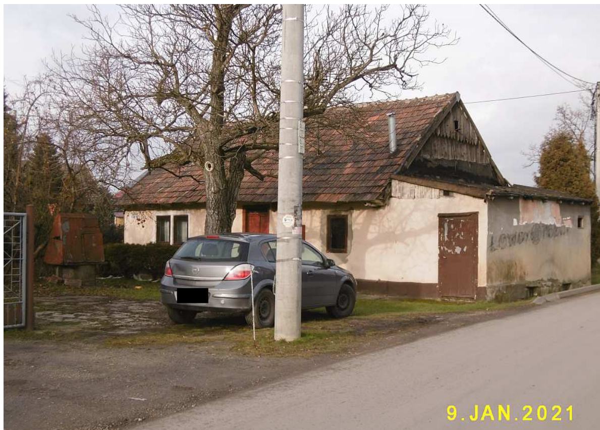
Fot. nr 330. Dawna chałupa przy ulicy Obronnej 12, w której niedawno wymieniono oryginalne okna.
