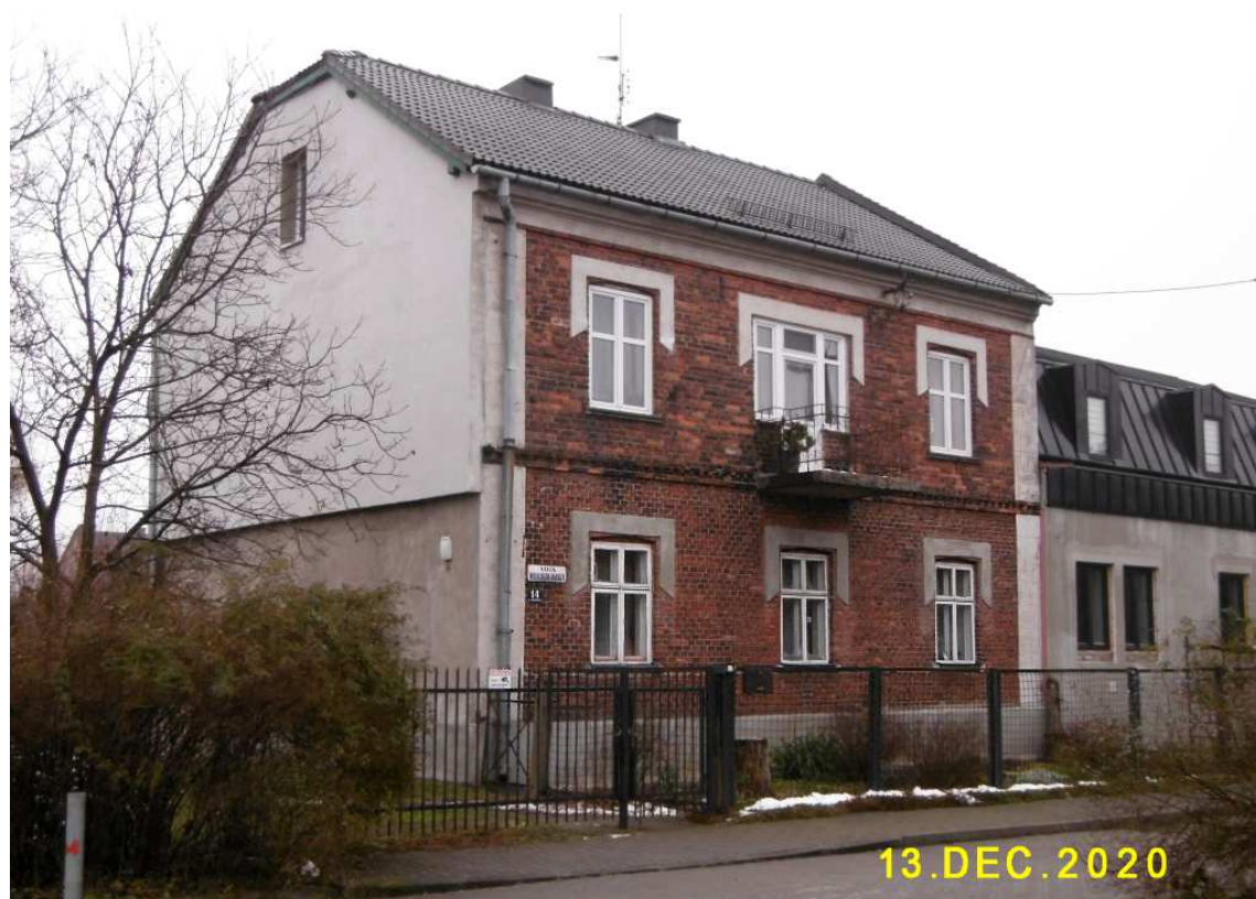
Fot. nr 221. Zapewne ok. 100-letnia kamieniczka z ulicy Darasza 14.
