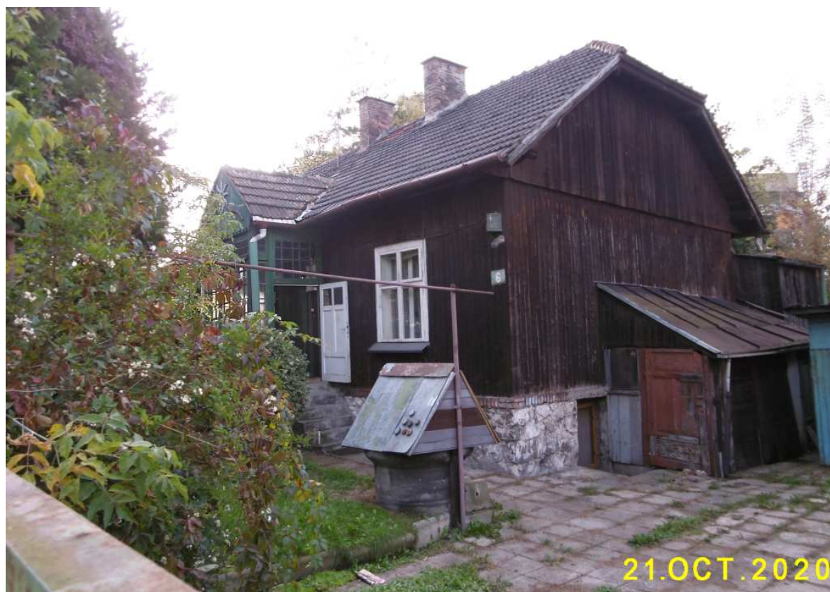
Fot. nr 189 (189-191). Relikt przedwojennej zabudowy Prokocimia przy ulicy Niedzickiej 6.
