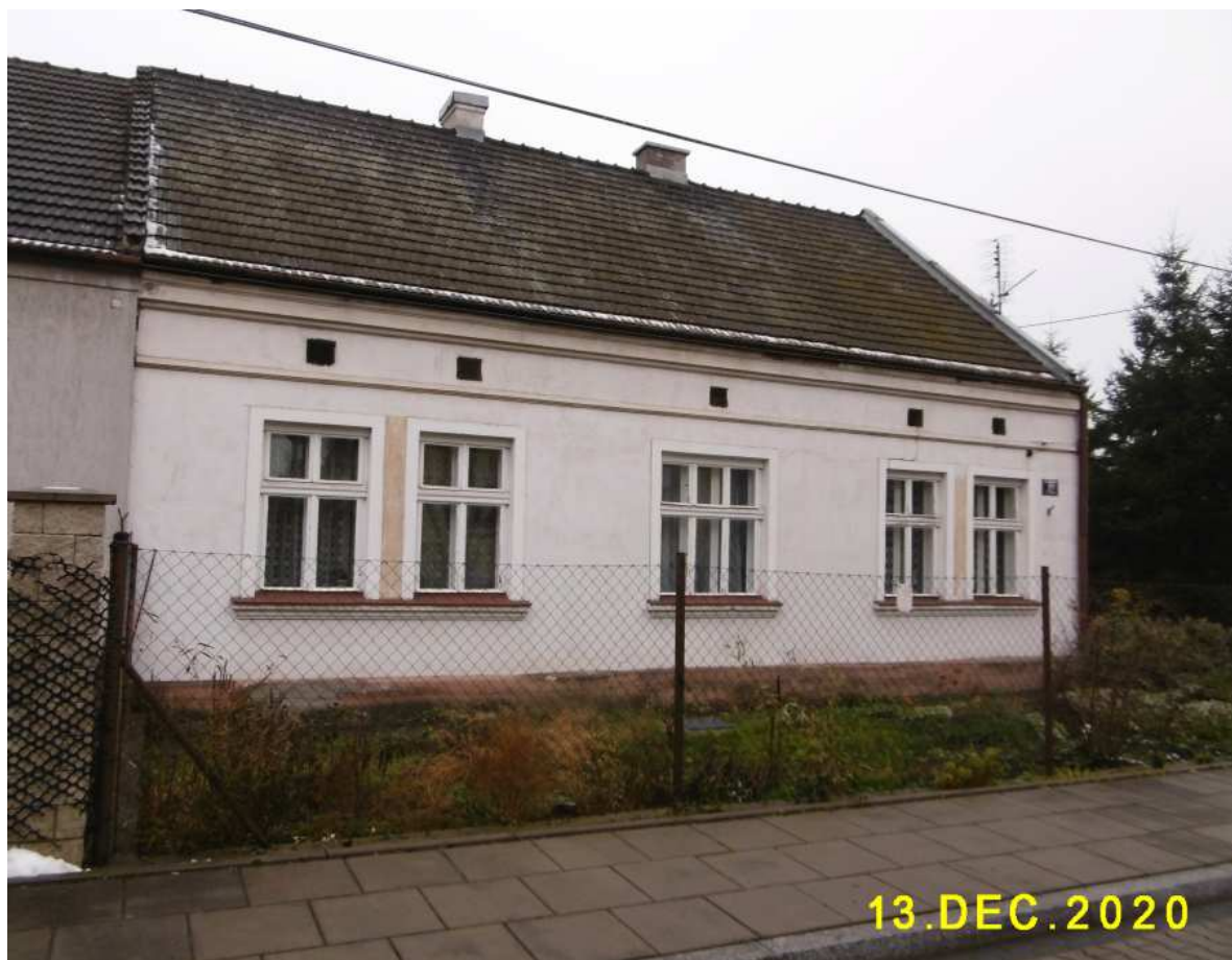
Fot. nr 235. Zapewne przedwojenny, murowany dom wielorodzinny z ulicy Solarzy 21.
