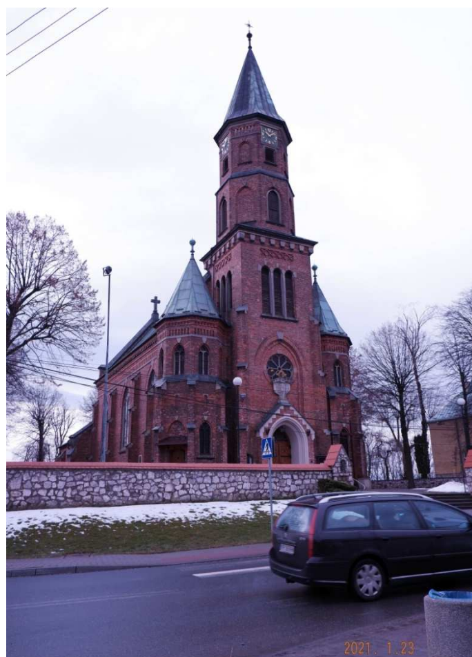
Fot. nr 383 (383-447). Wzdłuż ulicy Cechowej. Tu kościół parafialny pod nr 144.
