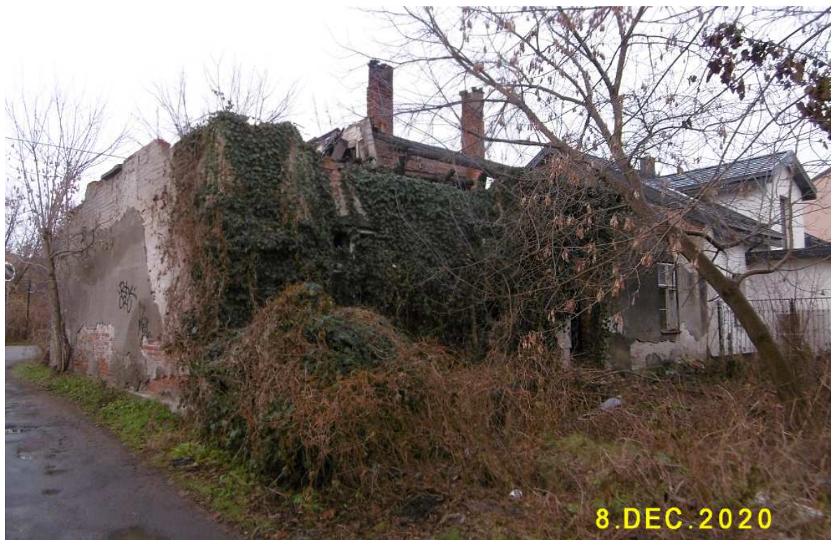
Fot. nr 207. Widok od strony podwórka z ulicy Wojnickiej.
