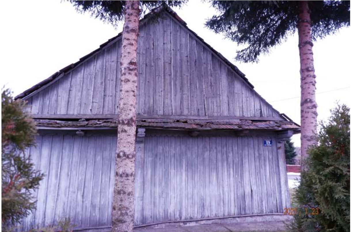
Fot. nr 470. Oszalowana ściana szczytowa.
