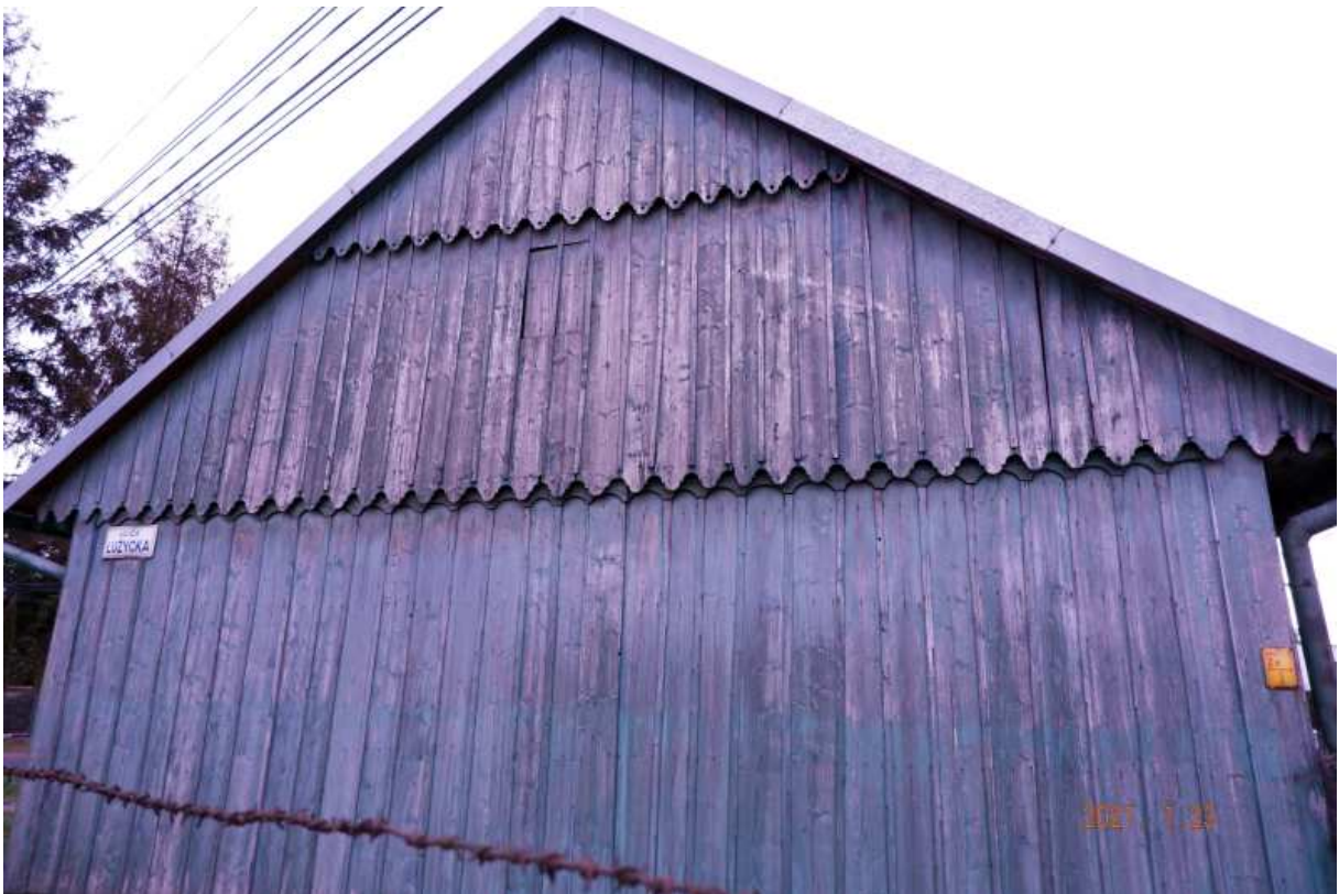
Fot. nr 409. Ściana szczytowa od strony ulicy Łużyckiej.
