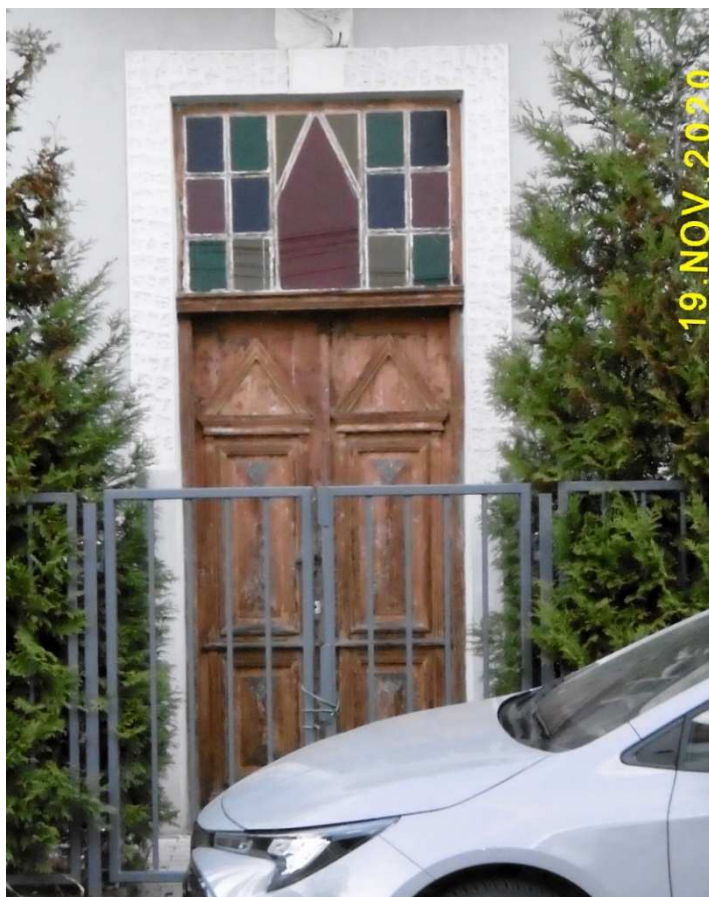
Fot. nr 43a. Oryginalne drzwi wejściowe.
