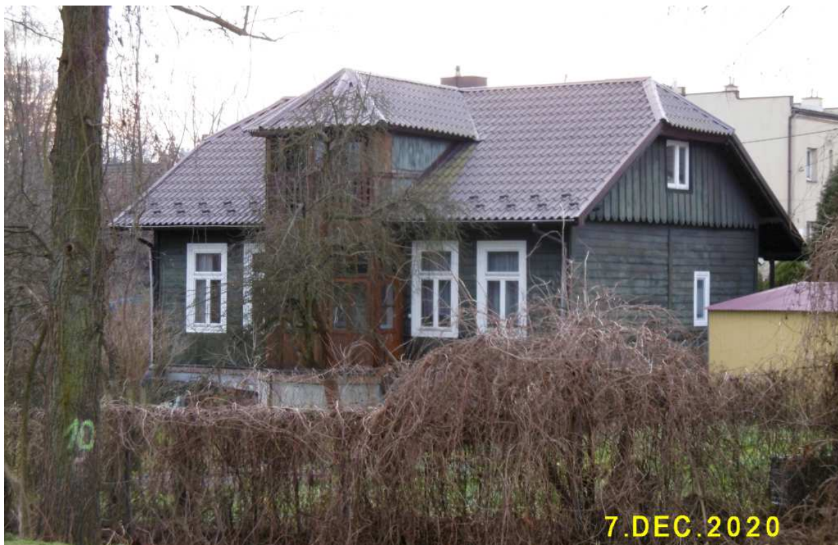
Fot. nr 292 (292-295). Zapewne niespełna 100-letnia willa z ulicy Przecinek 3 i jej detale. Widok od strony torów kolejowych.
