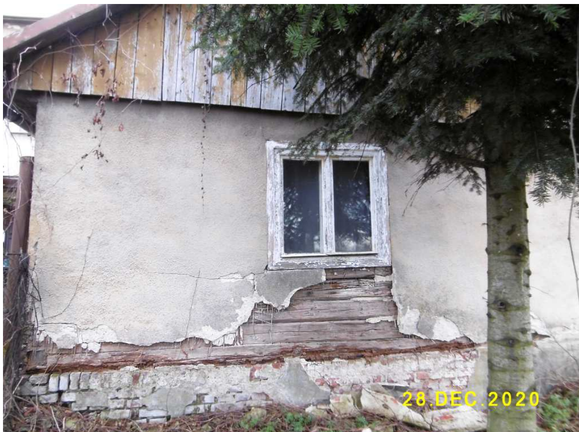
Fot. nr 142. Drewniana faktura ścian o konstrukcji zrębowej wyglądająca spod tynku.
