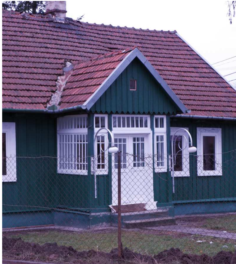
Fot. nr 405 (405-406). Oszklony ganek, który najwyraźniej przetrwał.
