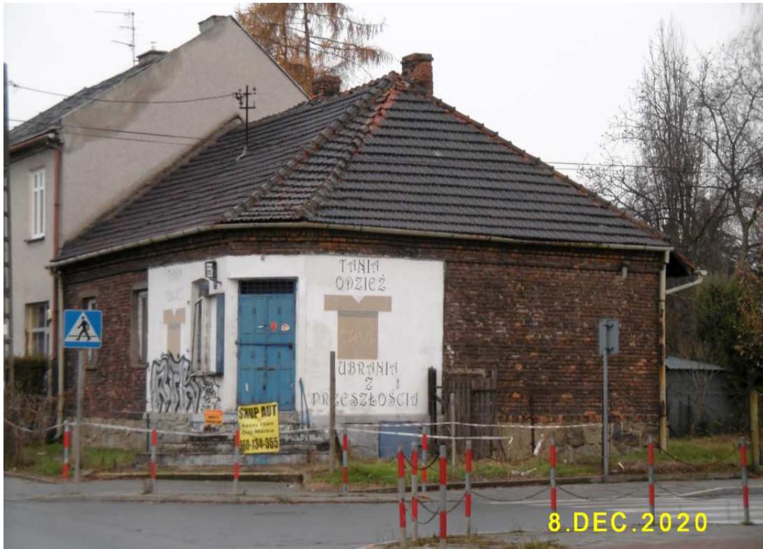
Fot. nr 228. Zapewne przedwojenny dom z pomieszczeniem posklepowym spod nr 93.
