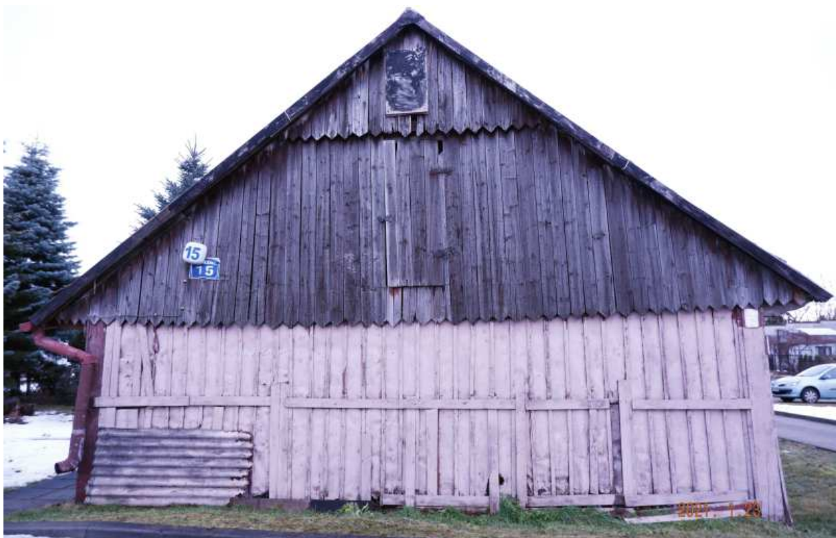
Fot. nr 467. Ściana szczytowa od strony ulicy.
