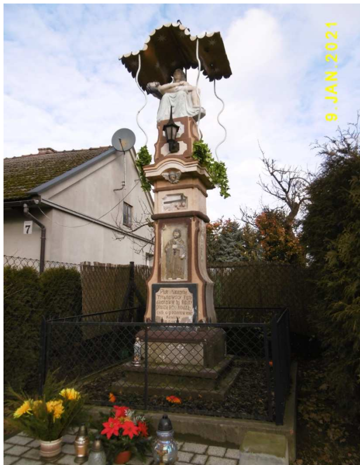
Fot. nr 357 (357-360). Kapliczka słupowa z Piętą w zwieńczeniu na posesji pod nr 7.
