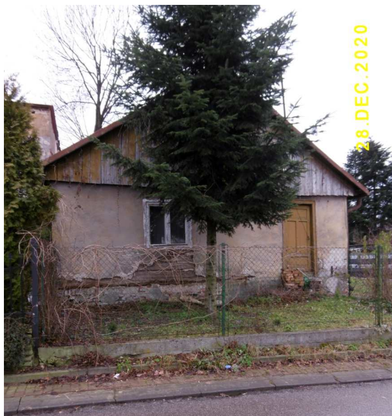
Fot. nr 141 (141-142). Ściana szczytowa od strony ulicy.
