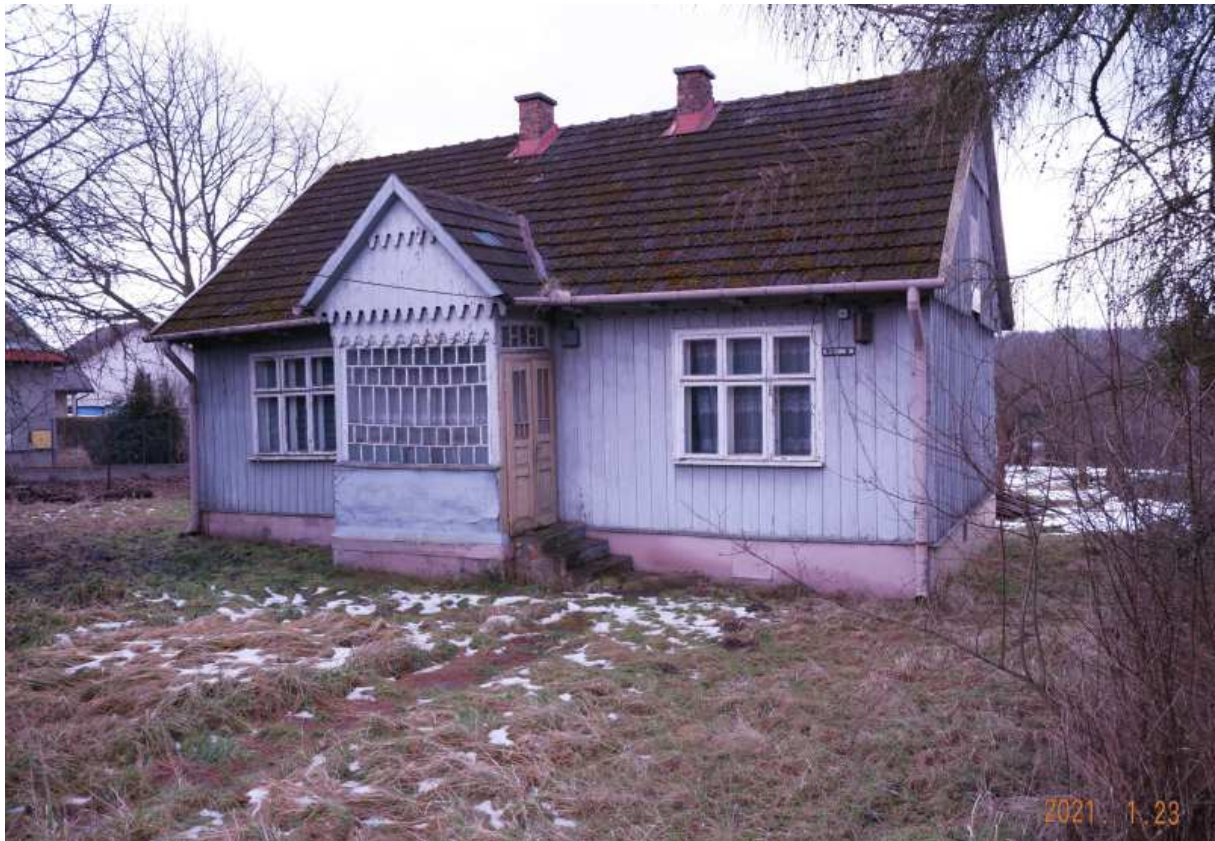
Fot. nr 432 (432-433). Oszalowany dom z oszklonym gankiem i weneckimi oknami w fasadzie spod nr 80, który powstał zapewne w latach 20. XX wieku.
