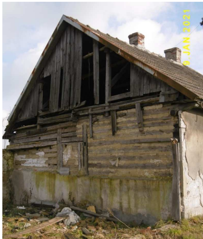
Fot. nr 343. Boczna ściana z odkrytą drewnianą fakturą konstrukcji zrębowej.
