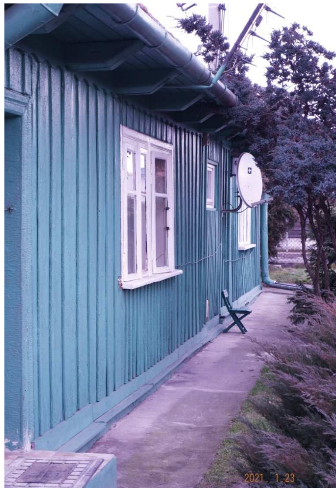
Fot. nr 429. Detale fasady, w której zachowały się oryginalne okna typu ościeżnicowego.
