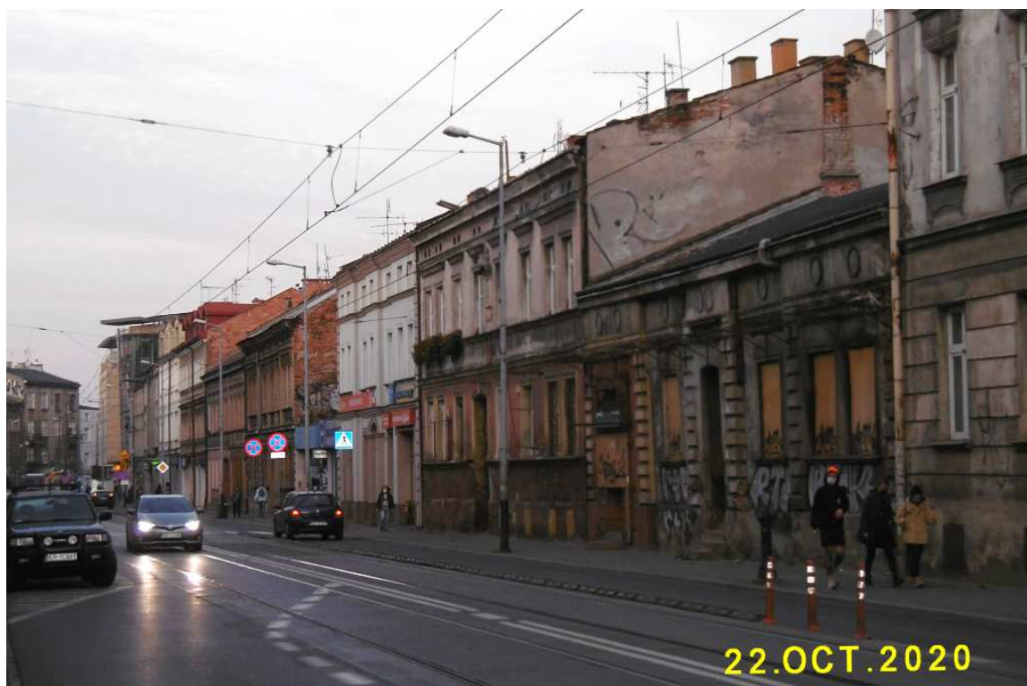
Fot. nr 46 (46-58). Wzdłuż końcowego odcinka ulicy Kalwaryjskiej. Fot. nr: 46 i 47 - zabudowa poniżej parterowego domu o numerze 55, która powstała w ostatnich dwóch dekadach XIX wieku.
