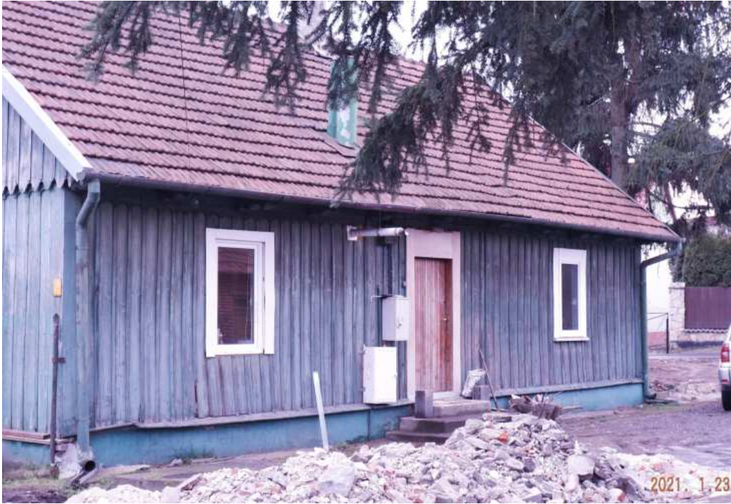
Fot. nr 410. Widok od strony podwórka.
