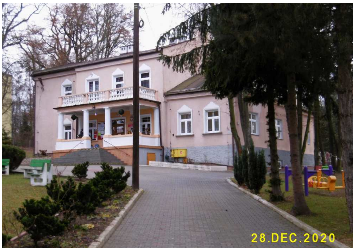
Fot. nr 130 (130-131). Nowy dwór Bemów przy ulicy Estońskiej 2, gdzie dziś mieści się przedszkole.
