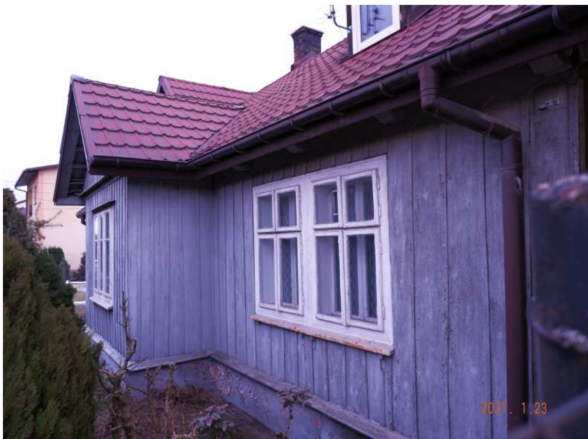
Fot. nr 423 (423-424). Oszalowany, drewniany dom z gankiem spod nr 91. Obiekt, który nadal posiada oryginalne okna typu skrzynkowego, został wybudowany w roku 1919.
