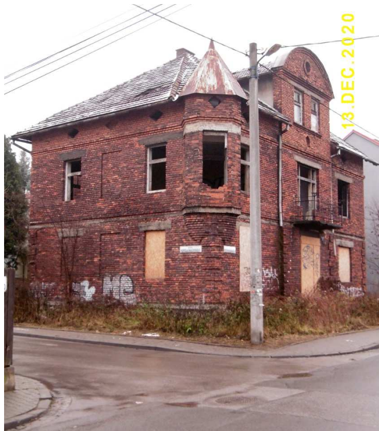
Fot. nr 226. Postępująca ruina modernistycznej willi spod nr 12.
