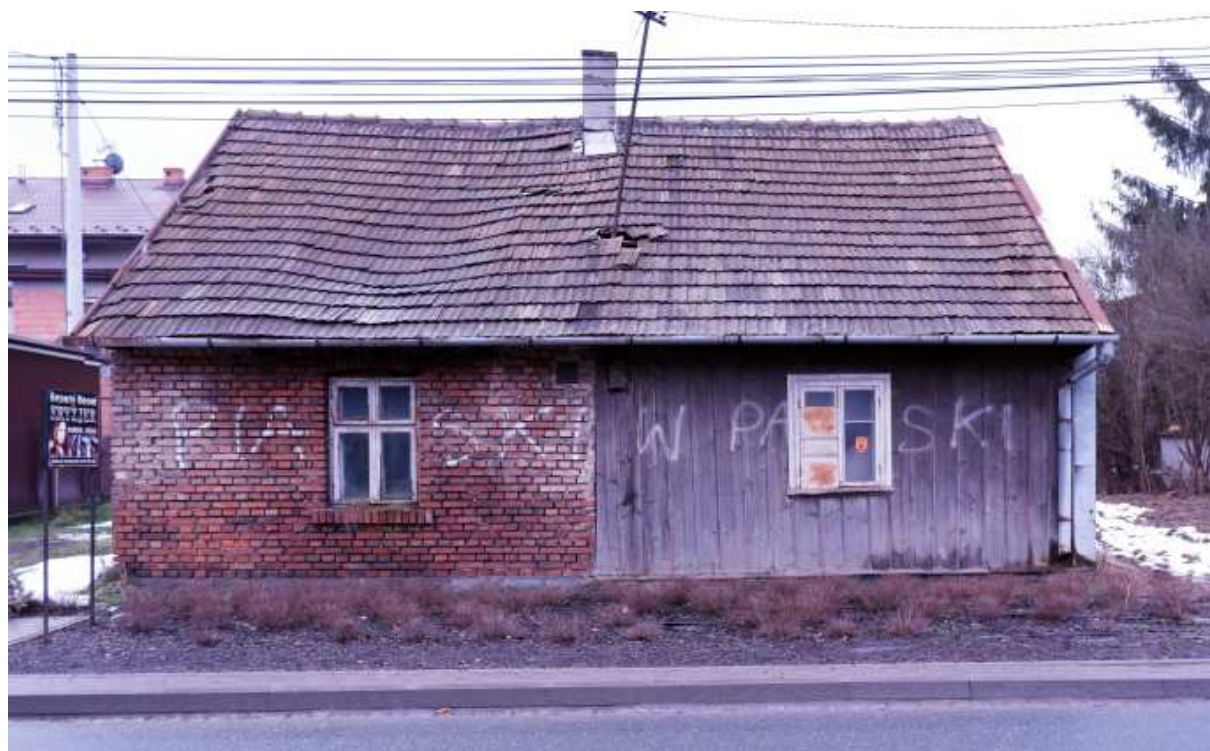
Fot. nr 396. Fasada obiektu. Lewa, murowana część późniejsza, zapewne przedwojenna.
