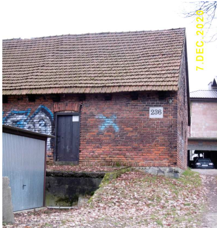
Fot. nr 284. Ceglana część gospodarcza.
