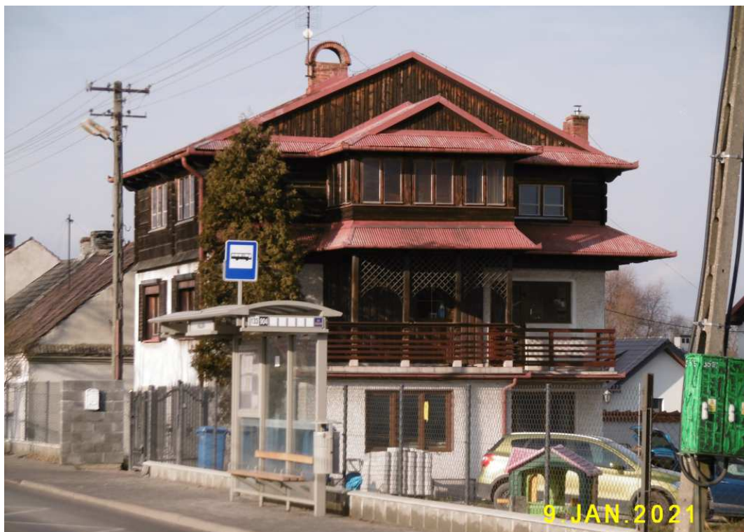
Fot. nr 336 (336-338). Zapewne przedwojenna willa drewniana spod numeru 47, z loggią widokową w jej bocznej ścianie, nawiązująca do zabudowy kurortowej.
