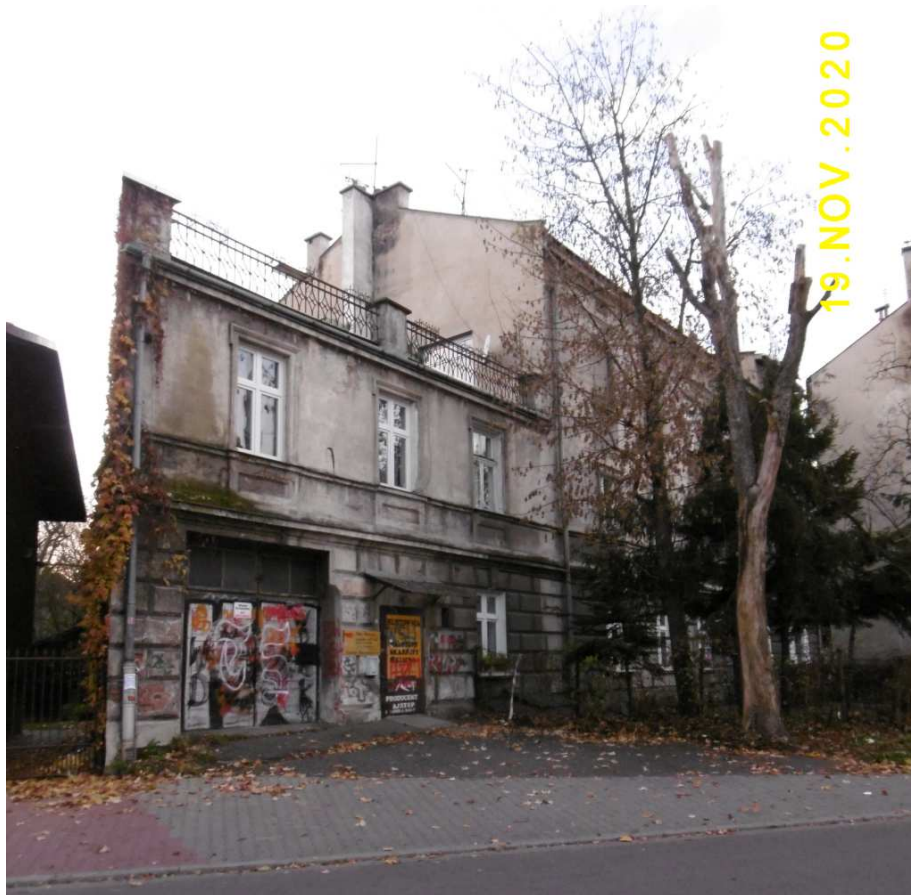
Fot. nr 9 (9-11). Wzdłuż ulicy Barskiej. Tu dom pod nr 41, wybudowany pod koniec XIX. wieku.
