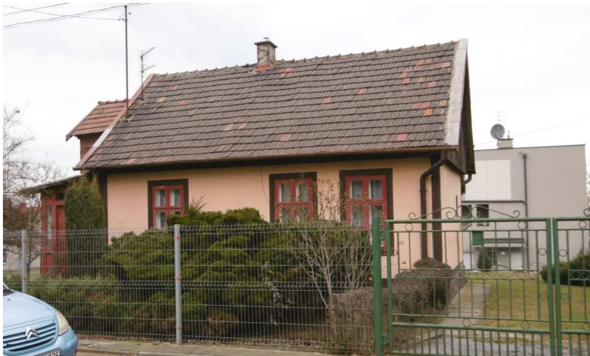
Fot. nr 138. Fasada domu.
