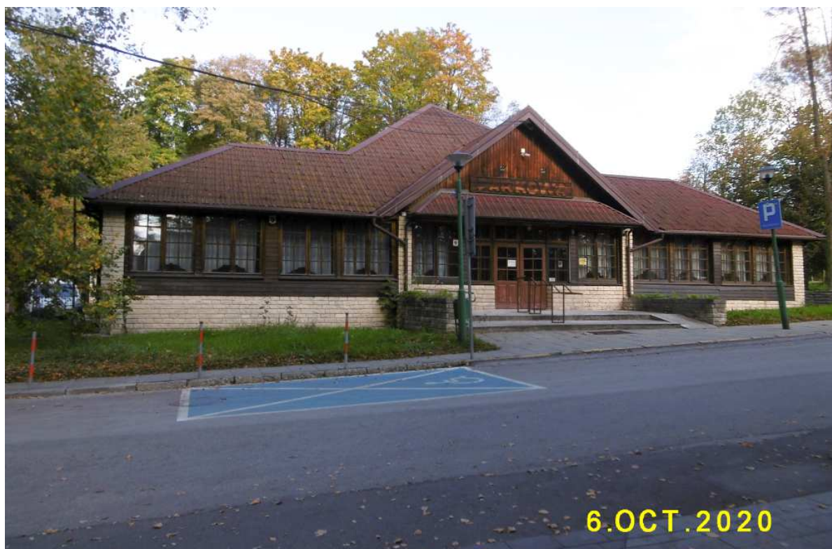
Fot. nr 538. Nieczynna od zeszłego roku restauracja Parkowa w Parku Zdrojowym
