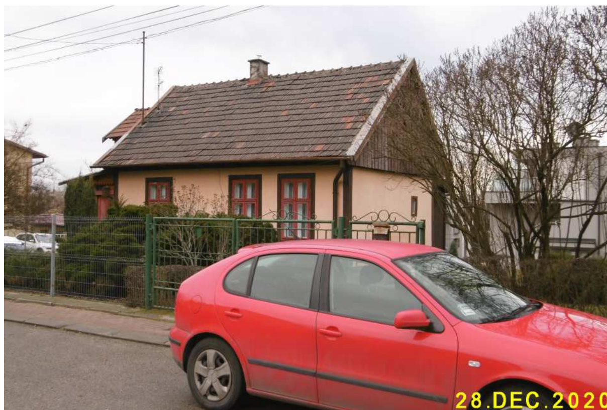
Fot. nr 137 (137-144). Wzdłuż ulicy Ossowskiego. Fot. nr: 137-139. Przykładnie zadbane, przedwojenny dom spod nr 12.
