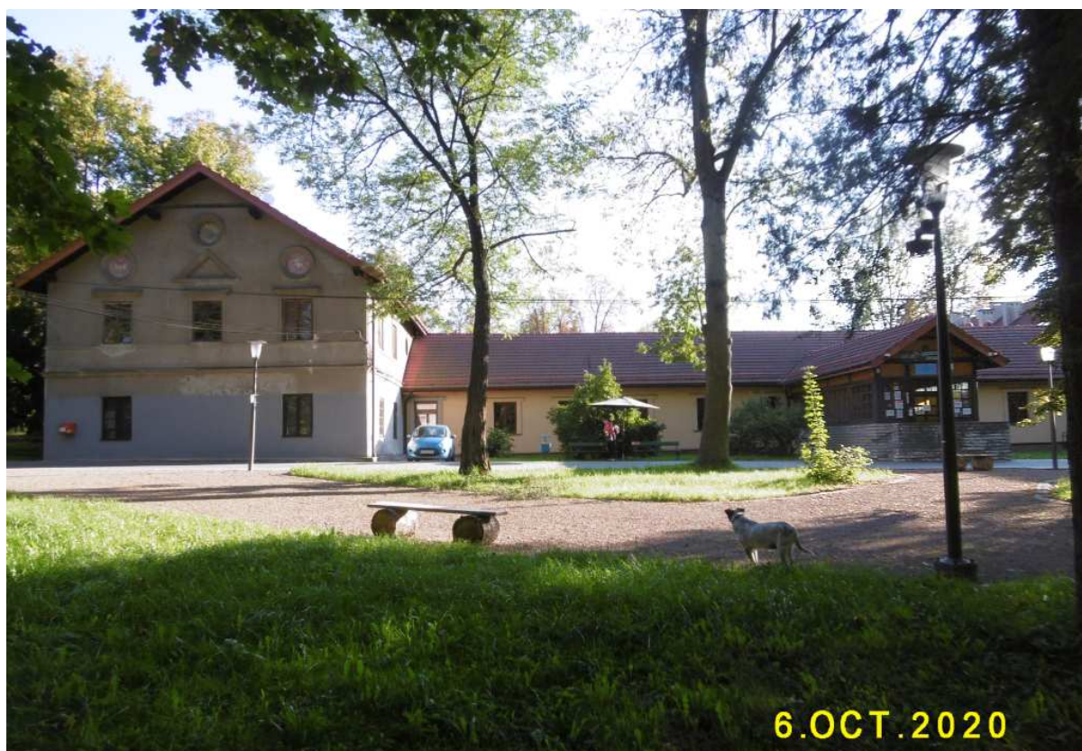
Fot. nr 539 (539-551). Kilkanaście ujęć klasycystycznego Domu Zdrojowego, usytuowanego przy ulicy Kąpielowej 70, który powstał w roku 1860.
