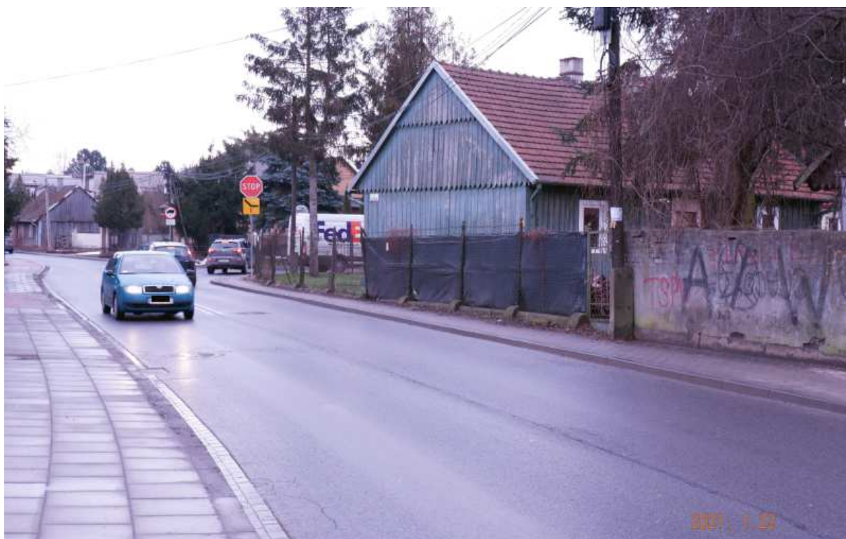
Fot. nr 403. Widok z ulicy Łużyckiej.
