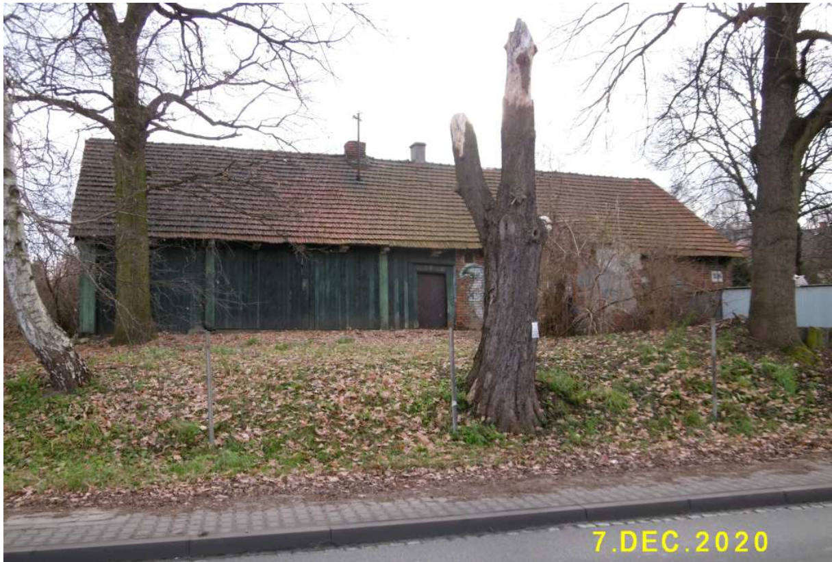
Fot. nr 285. Frontowe ustawienie w stosunku do ulicy.
