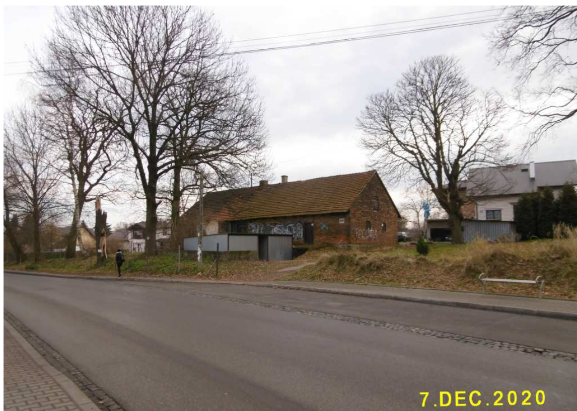
Fot. nr 283 (283-289). Rozległy dom mieszkalny spod nr 236, z murowaną częścią gospodarczą w jednym korpusie, w narożu z ulicą Mała Góra. Fot. nr: 283-287 – widoki z ulicy.
