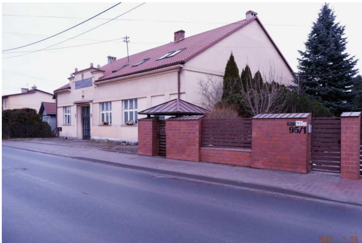
Fot. nr 420 (420-422). Dom Cechu Rzeźników i Wędliniarzy pod nr 93. Budynek powstał w roku 1932. Ubój bydła i wyrabianie wędlin było obok rolnictwa podstawowym od wieków zajęciem Piaszczan.
