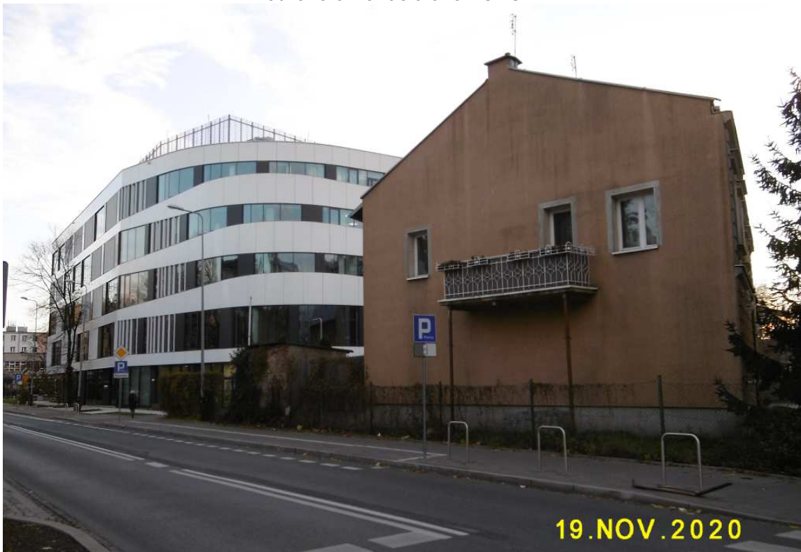
Fot. nr 17. Wzdłuż ulicy Bułhaka.
