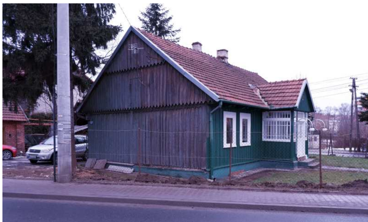
Fot. nr 407. Ściana szczytowa od strony ulicy Cechowej.
