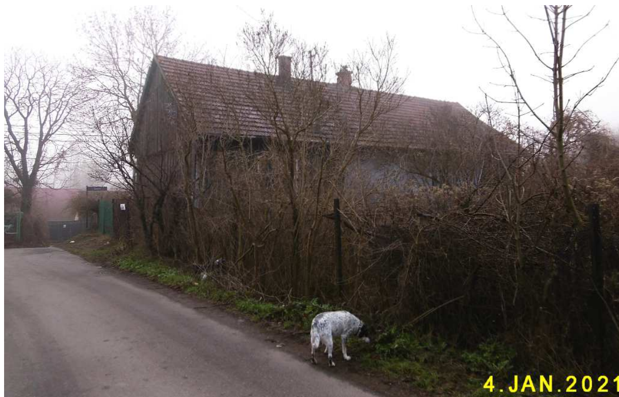
Fot. nr 308. Próba uchwycenia fasady domu, którą zasłoniły chaszczce, z ulicy Błotnej.
