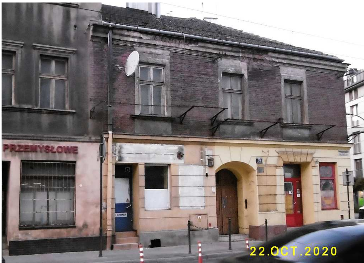
Fot. nr 53 (53-58). Zabudowa fragmentu ulicy Kalwaryjskiej powyżej ulicy Śliskiej. Tu dom pod nr 70, który został wybudowany pod koniec XIX wieku.
