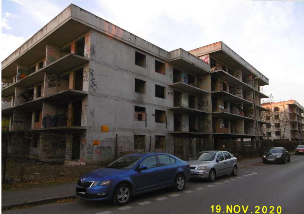
Fot. nr 20. Straszące od lat betonowe szkielety w początkowym fragmencie ulicy.
