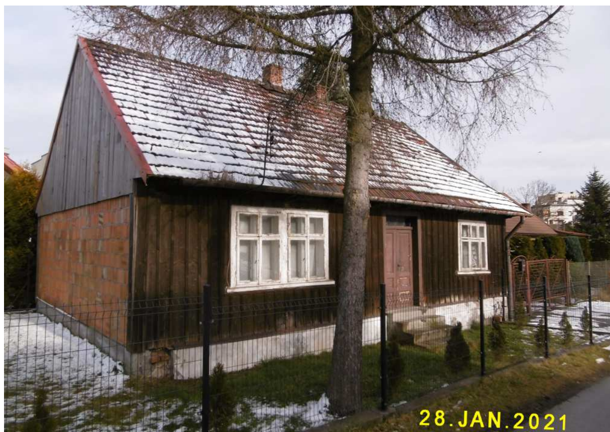
Fot. nr. 478a (478a-487c). Fasada domu.
