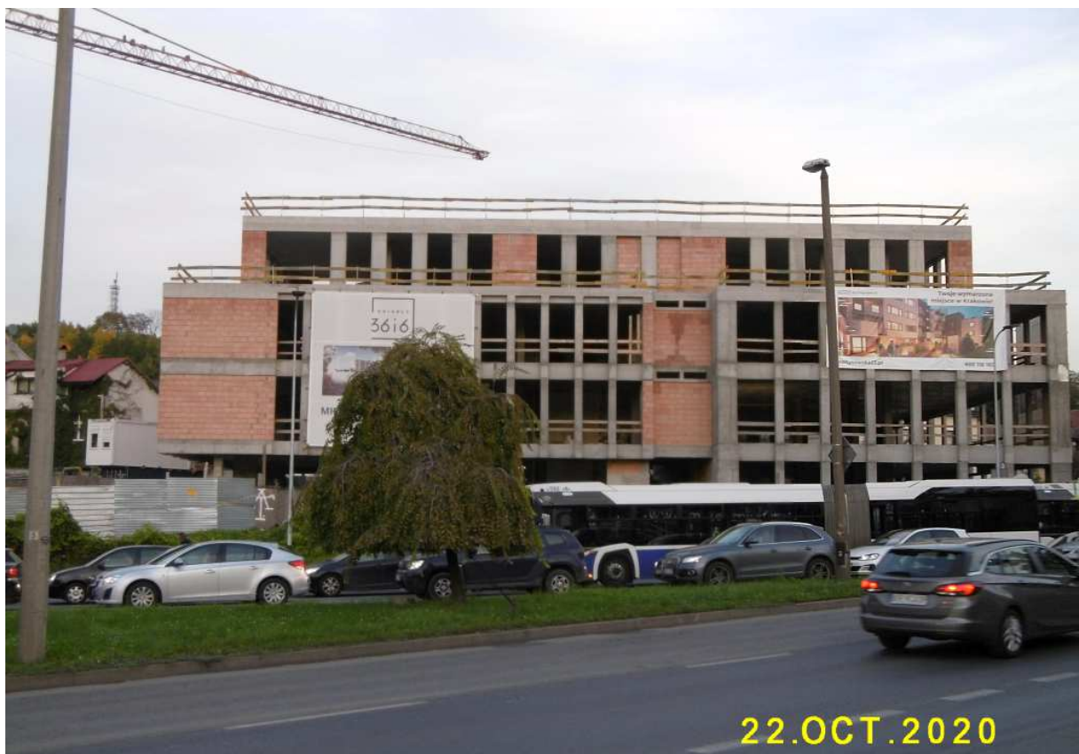
Fot. nr 65. Nowo powstający budynek na początku ulicy Kamieńskiego, który powstaje w miejscu 100-letnich, drewnianych willi.
