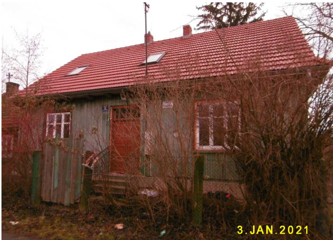
Fot. nr 310 (310-312). Będący w trakcie remontu dom pod nr 12.
