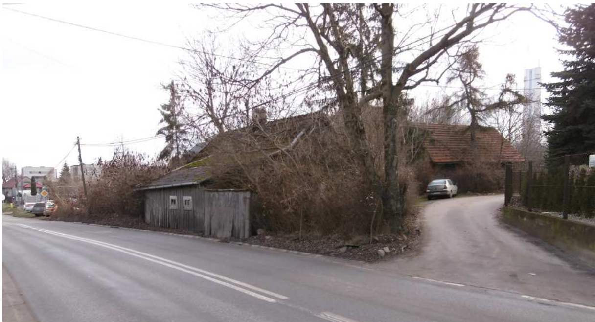
Fot. nr 347. Na styku ulic: Rżackiej i Biernata z Lublina. W tle wieża ciśnięń rurociągu Raba.
