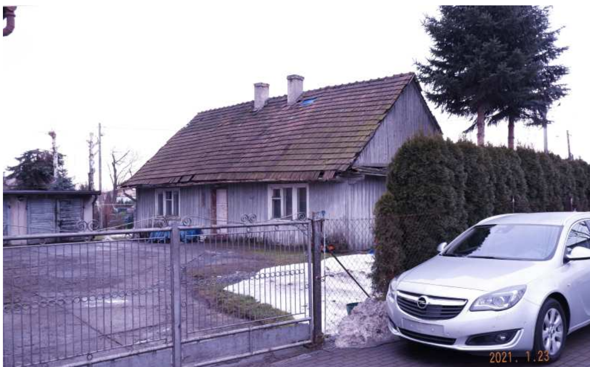
Fot. nr 469 (469-471). Popadający od lat w ruinę, blisko stuletni dom spod nr 19. Tu widok od strony podwórka.
