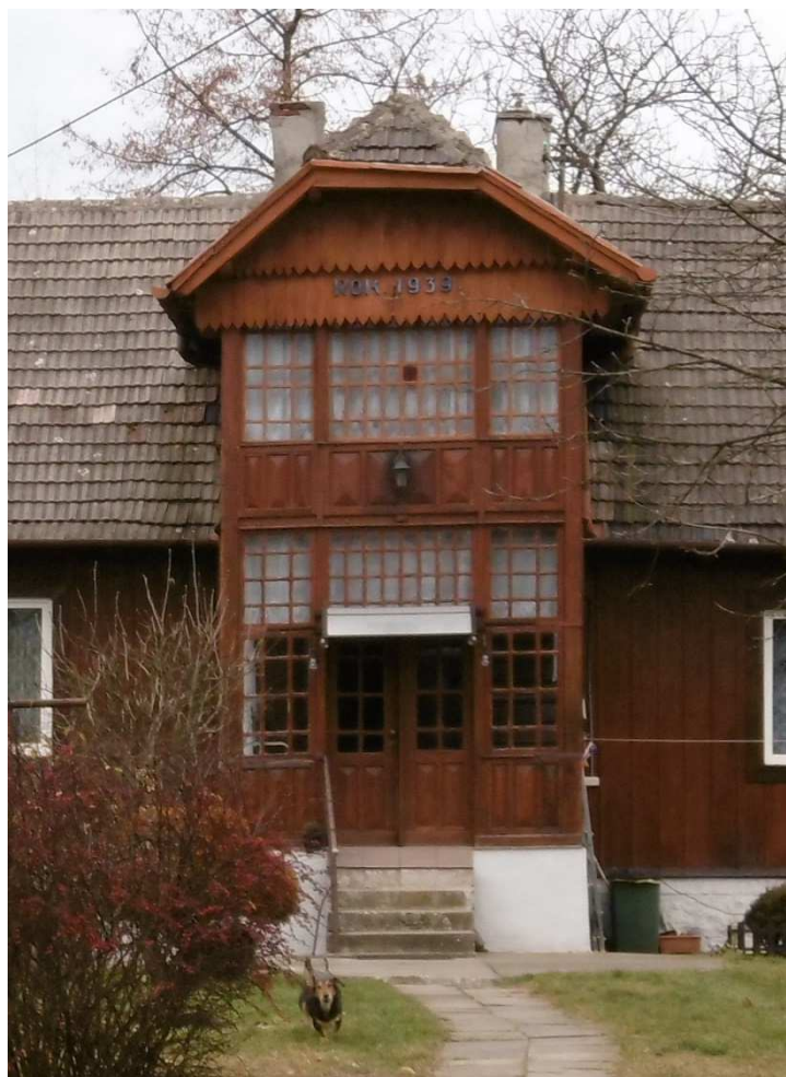
Fot. nr 146. Oszklony ganek z galeryjką, a na nim data budowy obiektu – 1939.
