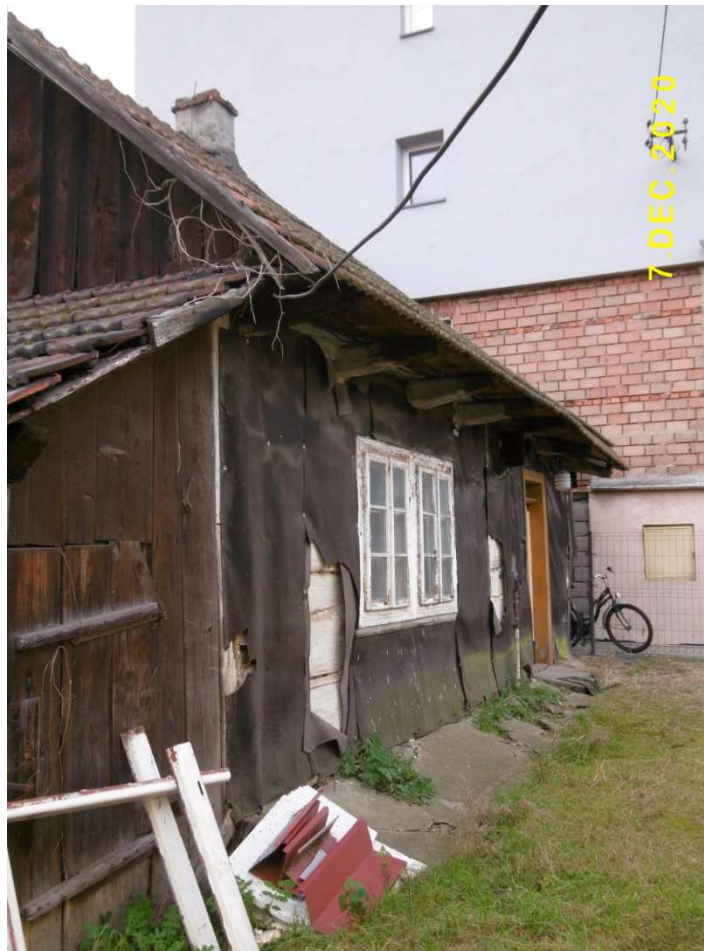
Fot. nr 277 (277-278). Fragment od strony podwórka.
