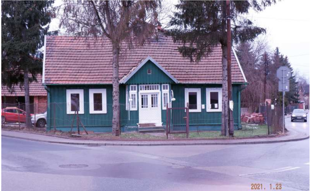
Fot. nr 404 (404-407). Fasada domu na etapie remontu. Niestety drewniane okna typu ościeżnicowego zostały zamienione przez bezpodziałowe plastiki.
