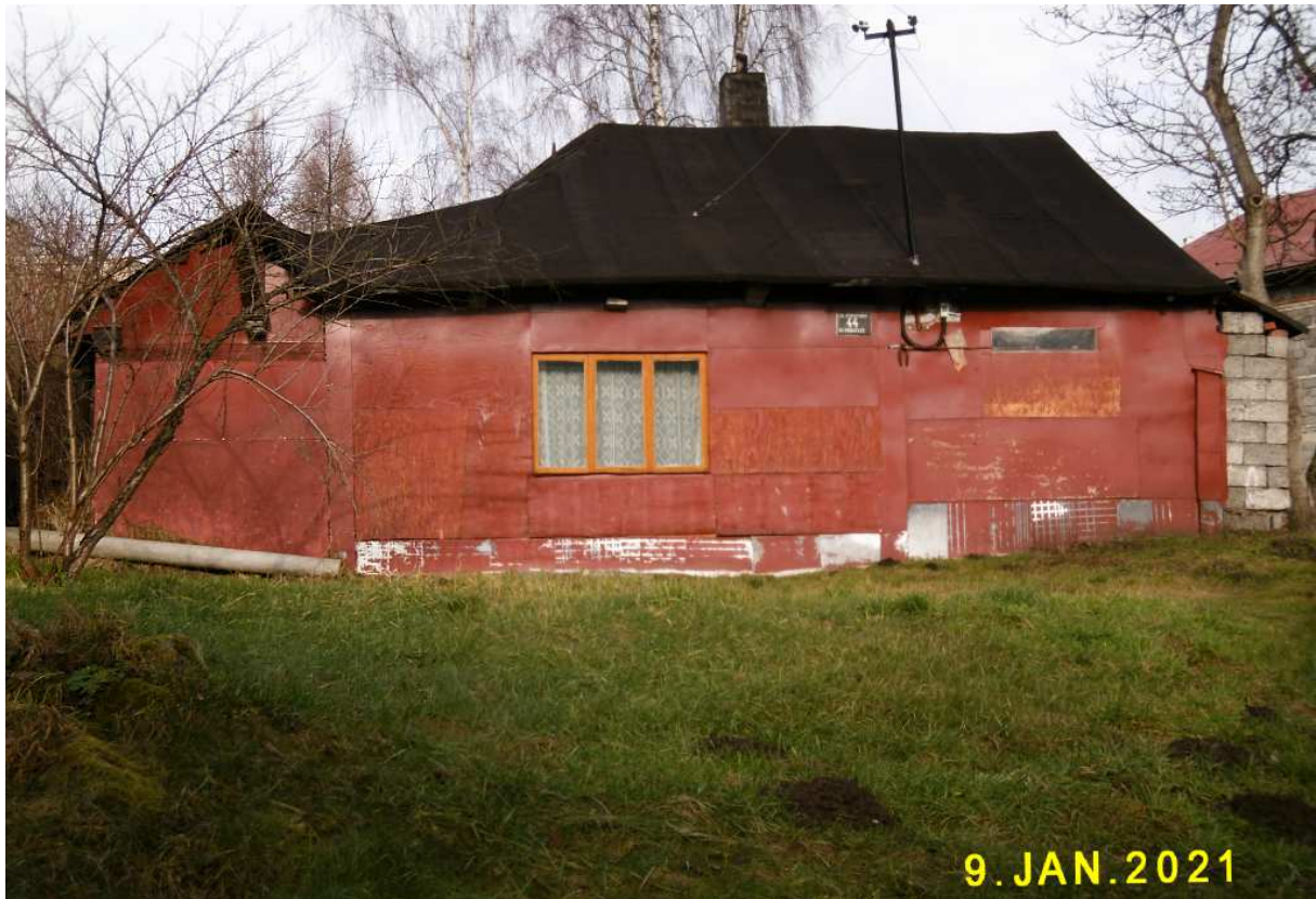
Fot. nr 530. Obita dziś pilśnią fasada, pod którą znajduje konstrukcja zrębowa.
