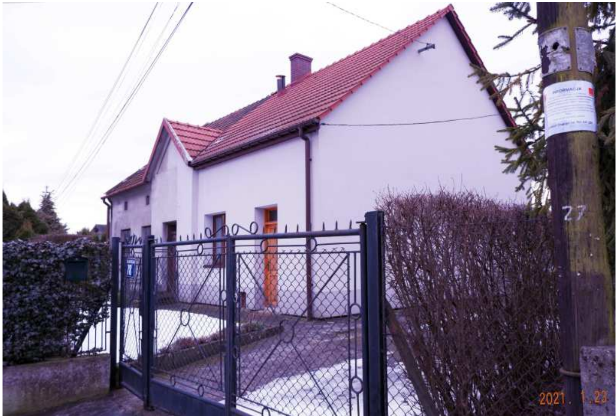
Fot. nr 497 (497-498). Zapewne przedwojenny dom murowany pod nr 78. Oryginalny jest lewy fragment domu.
