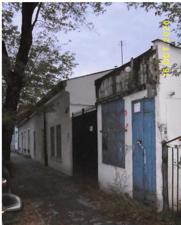
Fot. nr 78 (78-80). Dom pod nr 24 i przylegający do niego dawny sklepik.
