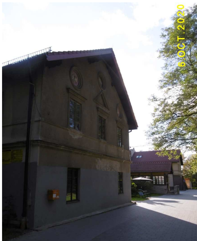
Fot. nr 544 (544-546). Środkowy fragment budynku.
