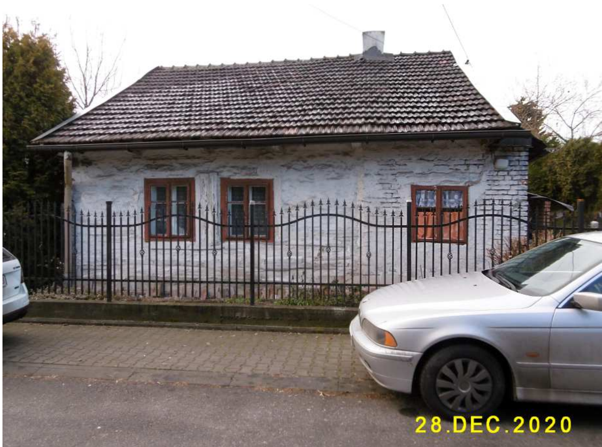
Fot. nr 106. Fasada chałupy, z dobudowanym z cegły prawym fragmentem.
