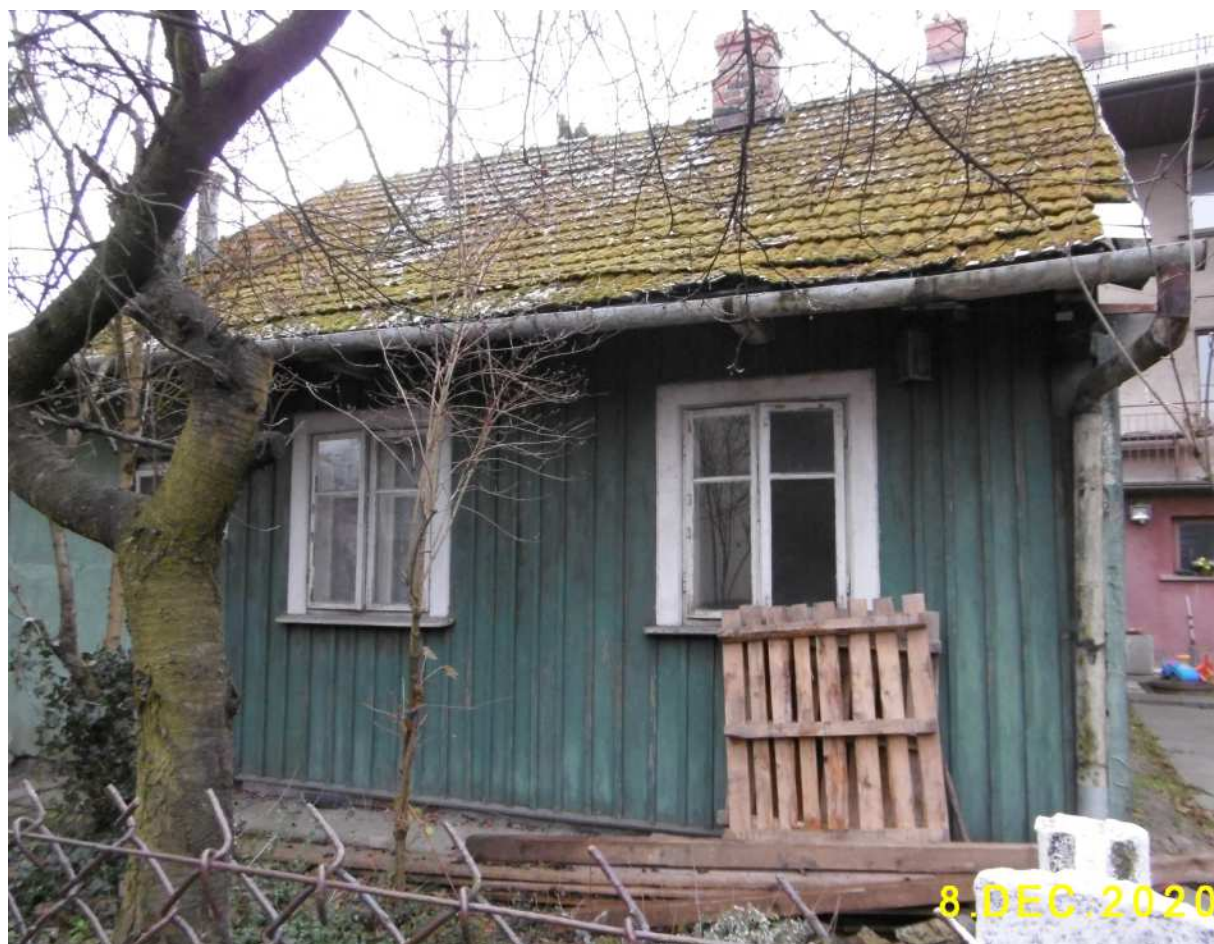
Fot. nr 256. Oryginalne okna szalowanego frontu, które ułatwiają datowanie.
