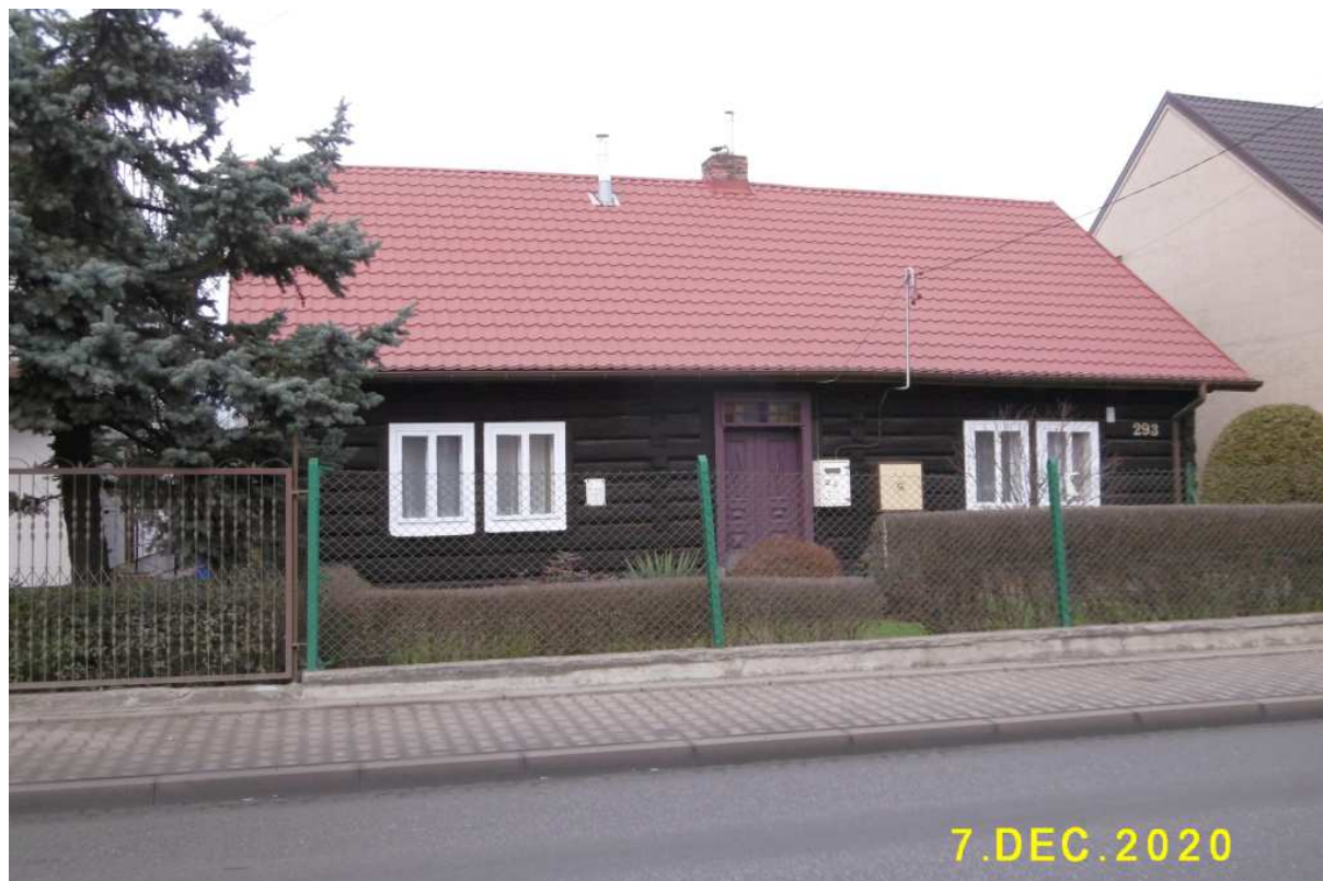
Fot. nr 290 (290-291). Przykładnie zadbana, drewniana chałupa spod nr 293, wybudowana ok. roku 1910 i jedynie jej okna, choć drewniane, nie są oryginalne.
