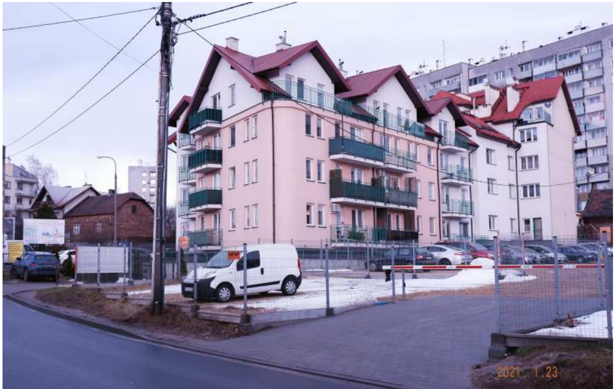
Fot. nr 486. Współczesna zabudowa ulicy pod nr 73c. Kiedyś stała tu zrujnowana chałupa.
