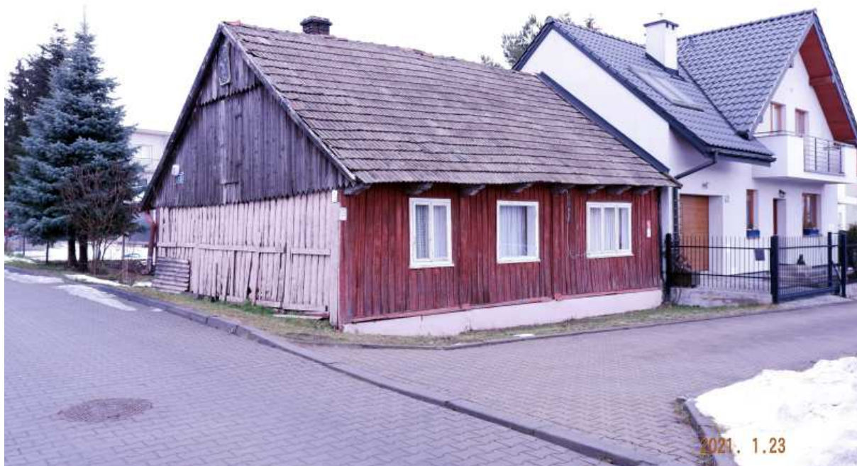
Fot. nr 468. Szalowana fasada chałupy, w której nie ma już oryginalnych okien.
