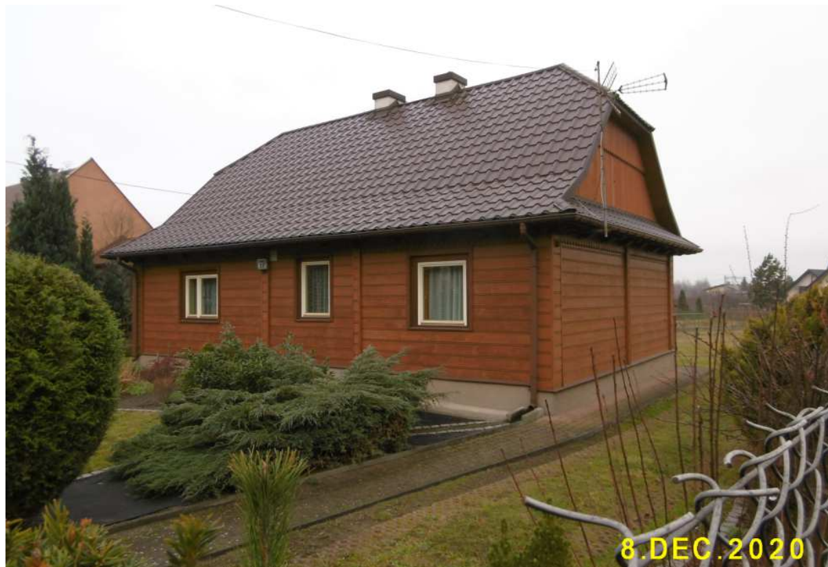
Fot. nr 249. Przebudowany współcześnie dom pod nr 17, w którym zachował się dach naczółkowy.
