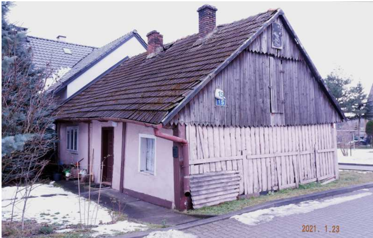
Fot. nr: 466-471. Wzdłuż ulicy Ukośnej. Fot. nr 466 (466-468). Około 100-letnia chałupa spod nr 15.
