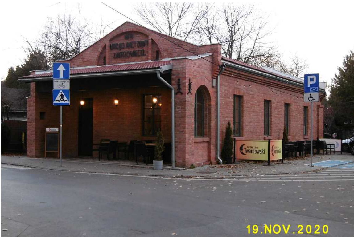
Fot. nr 33 (33-35). Pięknie odnowiona roгатka zakrzowiecka pod nr 45 (w narożu z ulicą Szwedzką), gdzie dziś znajduje się Bistro Pan Twardowski. Obiekt powstał około roku 1880 w linii dawnych fortyfikacji rdzenia Twierdzy Kraków.
