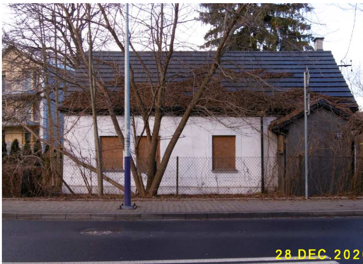
Fot. nr 85. Opuszczony dom pod 36.
