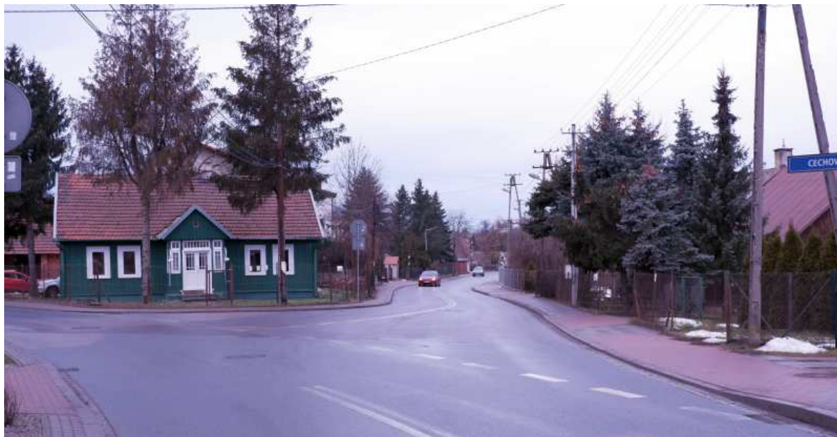
Fot. nr 402 (402-410). Drewniany dom w zagrodzie pod nr 101, zlokalizowany na cyplu utworzonym przez ulice: Łużycką i Cechową. Powstał w roku 1934. (23.01.2021)
