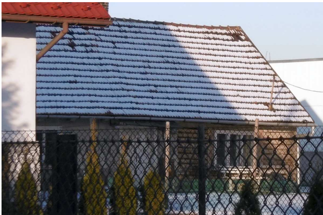
Fot. nr 393a. Prawy fragment ściany frontowej o konstrukcji zrębowej.
