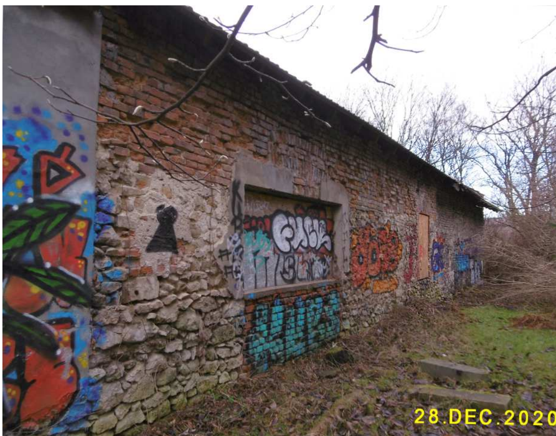
Fot. nr 125. Widok od strony podwórka.
