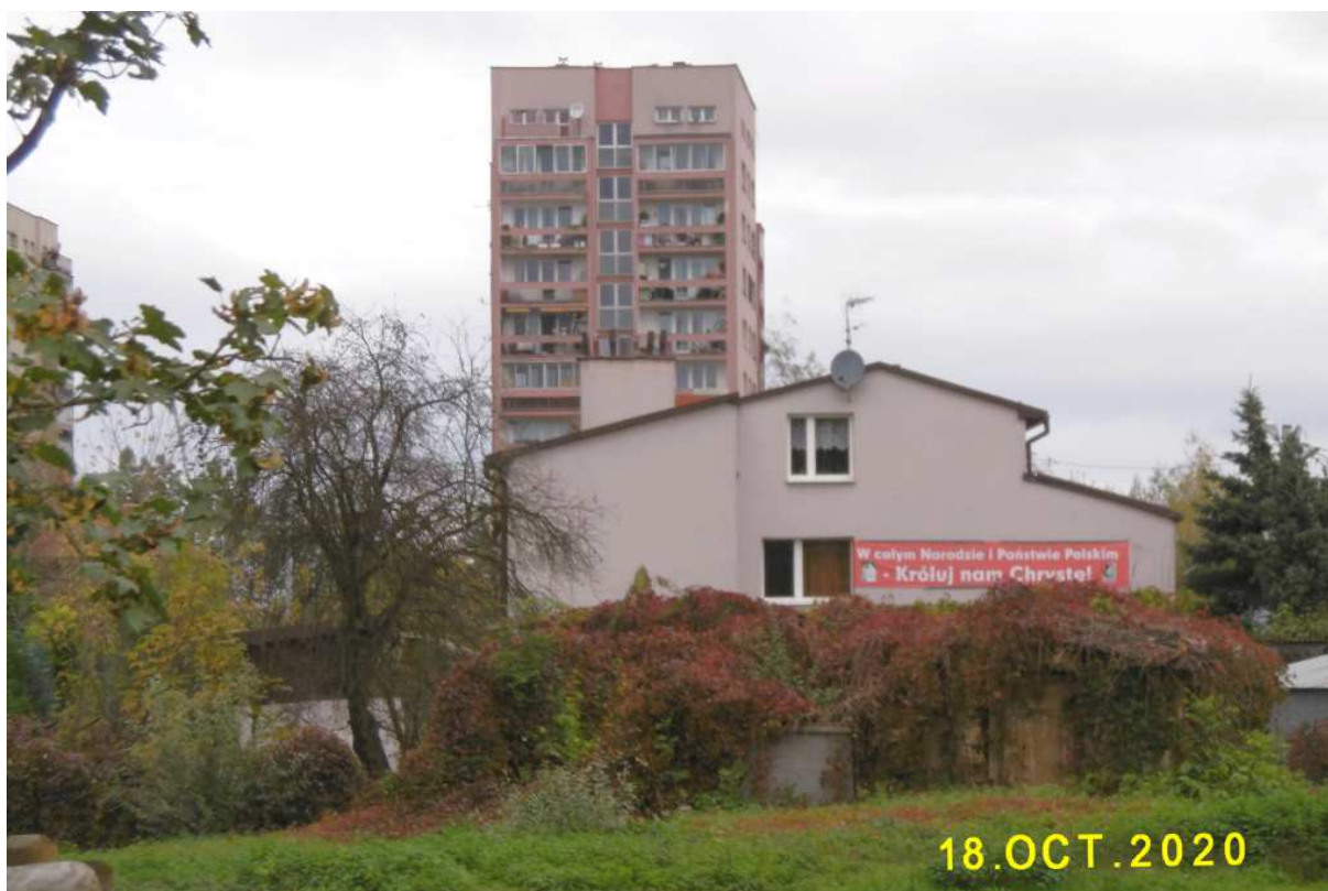
Fot. nr 177. Zarośnięta winem ruina chałupy przy dawnej ulicy Jesiennej 5.
