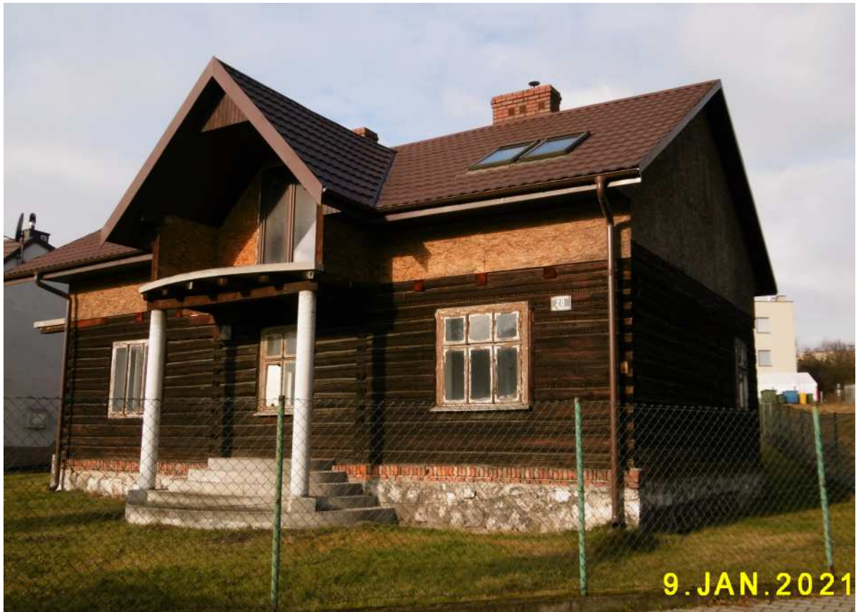
Fot. nr 518 (518-519). Próba współczesnej przebudowy domu spod nr 30, który zapewne powstał w latach 30. XX wieku.
