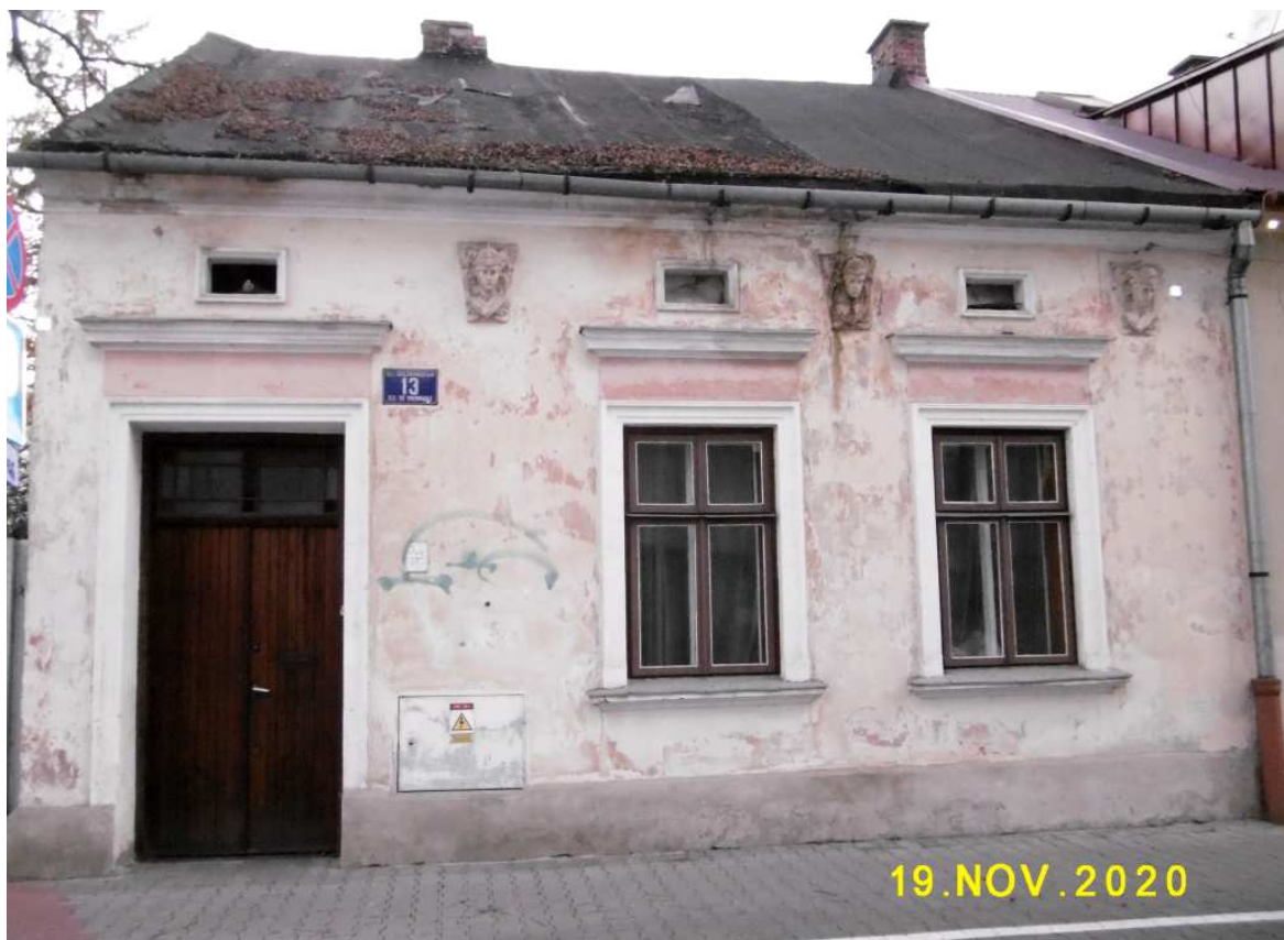
Fot. nr 7. Oryginalna fasada domu.
