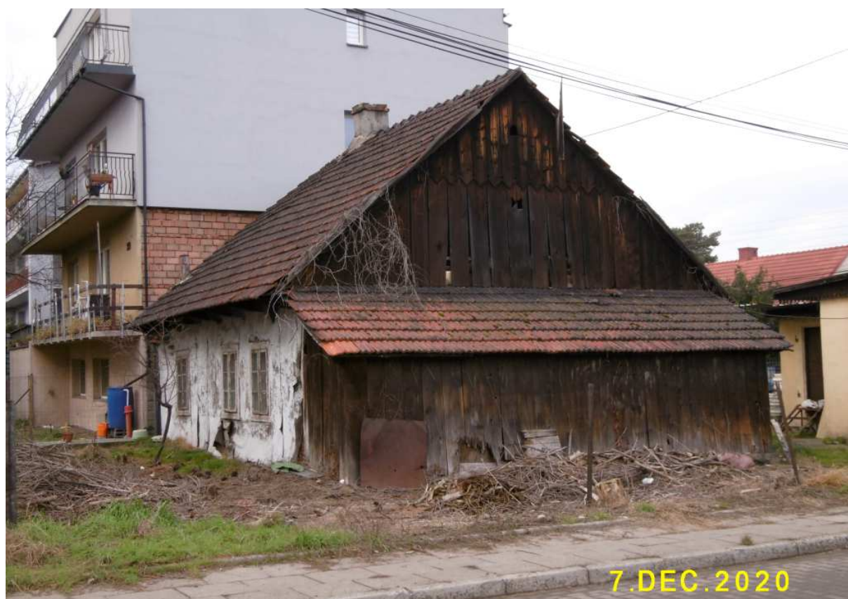
Fot. nr 275 (275-276). Ściana szczytowa i drewniana komórka od strony ulicy Laskowej.
