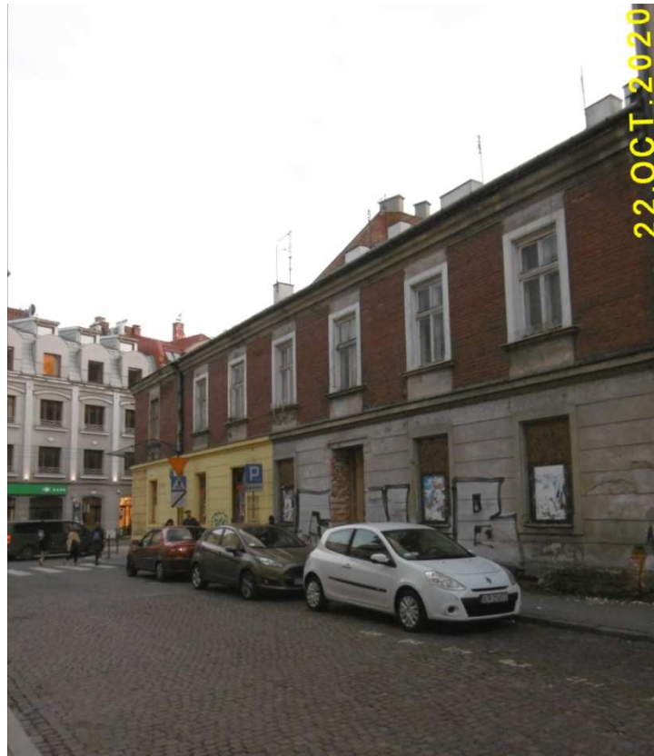
Fot. nr 52 (52-53). Kamieniczka z ulicy Kalwaryjskiej 70 - fragment wzdłuż ul. Śliskiej.
