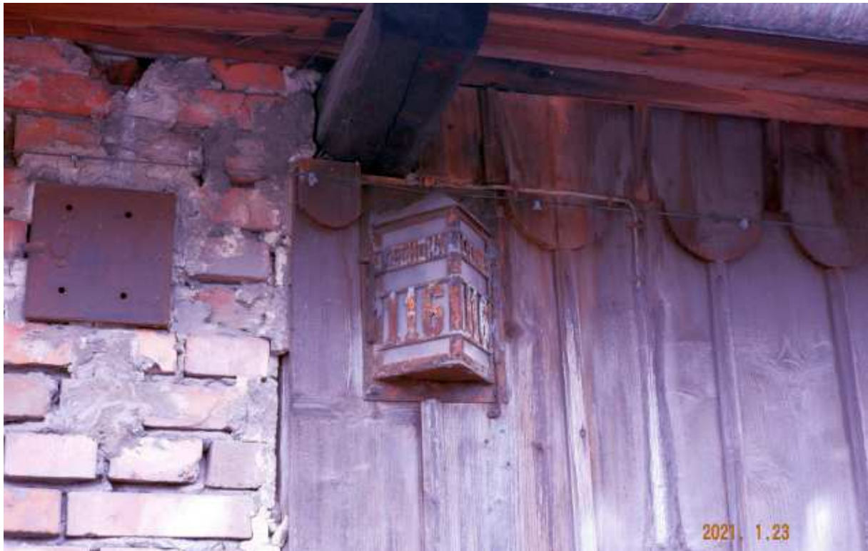
Fot. nr 397. Tzw. „latarnia policyjna” z podświetlanym numerem domu i detale drewnianego szalunku.
