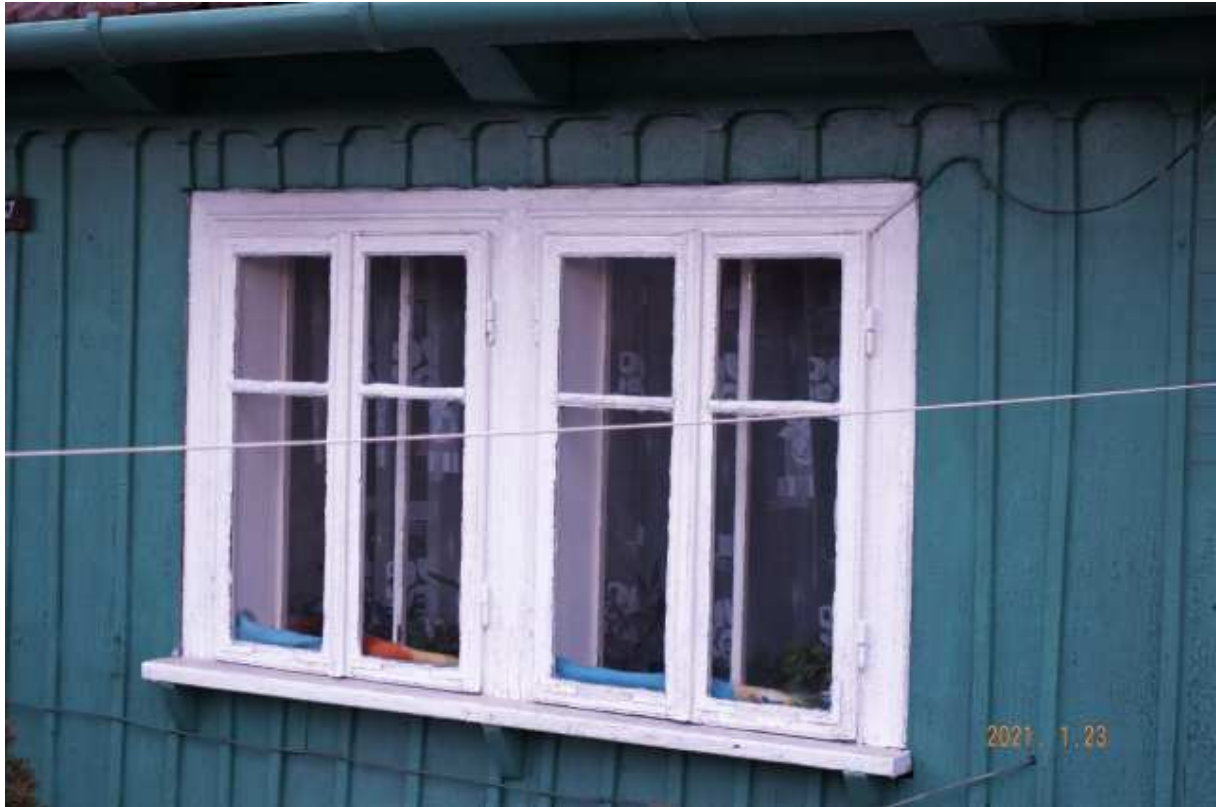
Fot. nr 430. Okna, które ułatwiają datowanie obiektu.
