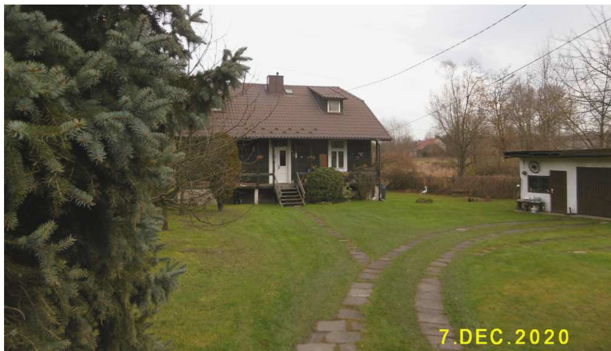
Fot. nr 295. Widok od strony wjazdu z ulicy Przecinek.
