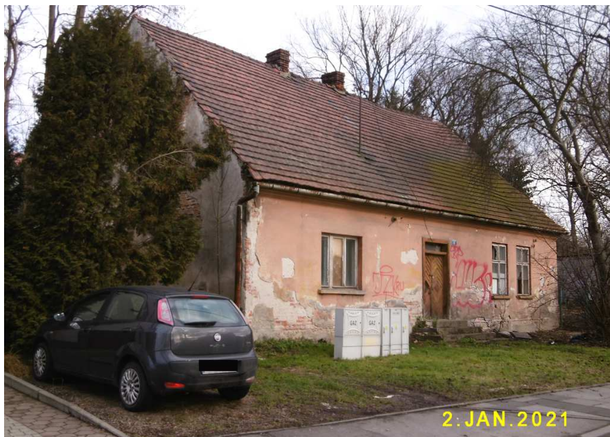
Fot. nr 186. Fasada obiektu.
