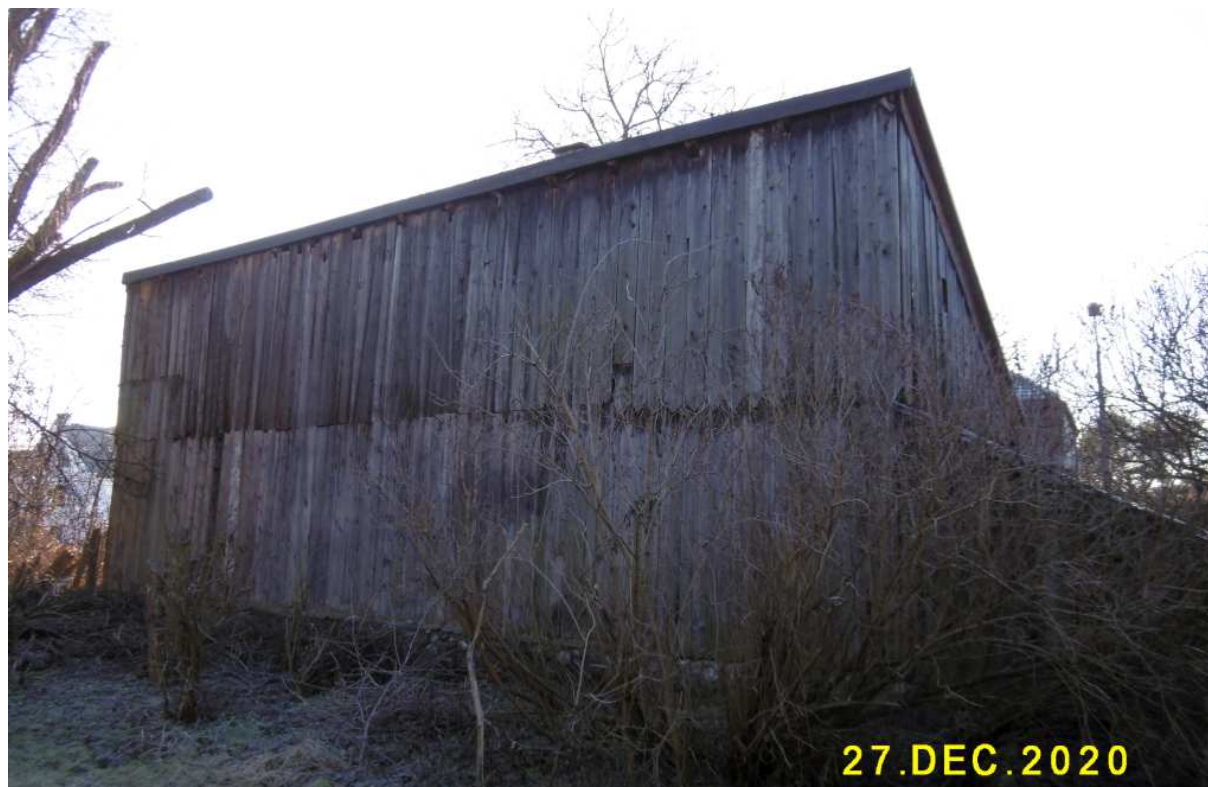
Fot. nr 169. Tylna ściana domu.
