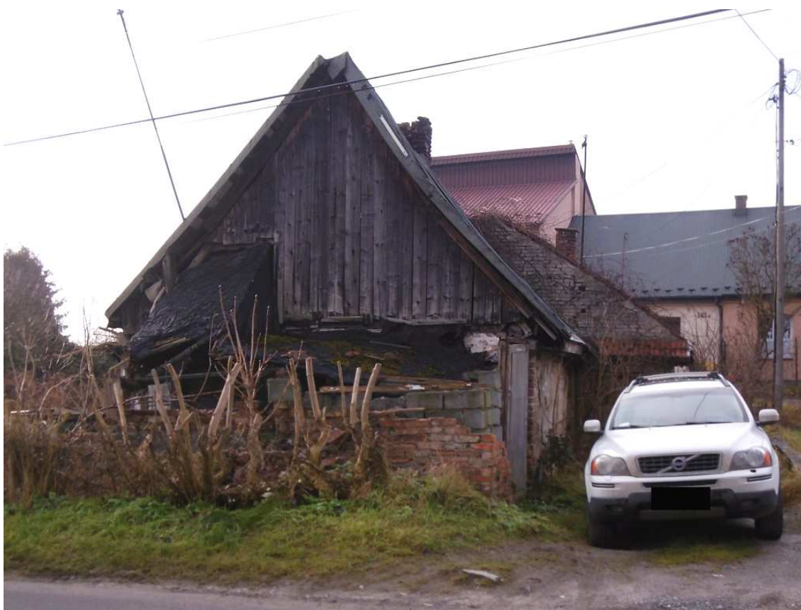
Fot. nr 279. Ściana szczytowa od strony ulicy.
