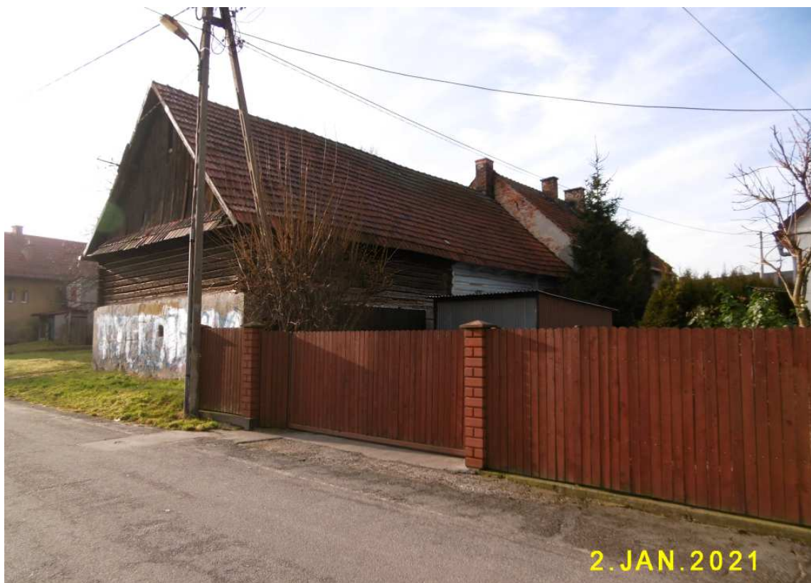
Fot. nr 256. Widok od strony podwórka.
