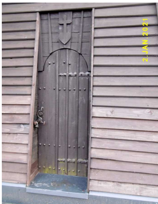
Fot. nr 212 (212-213). Drzwi dzwonnicy i jej detale.
