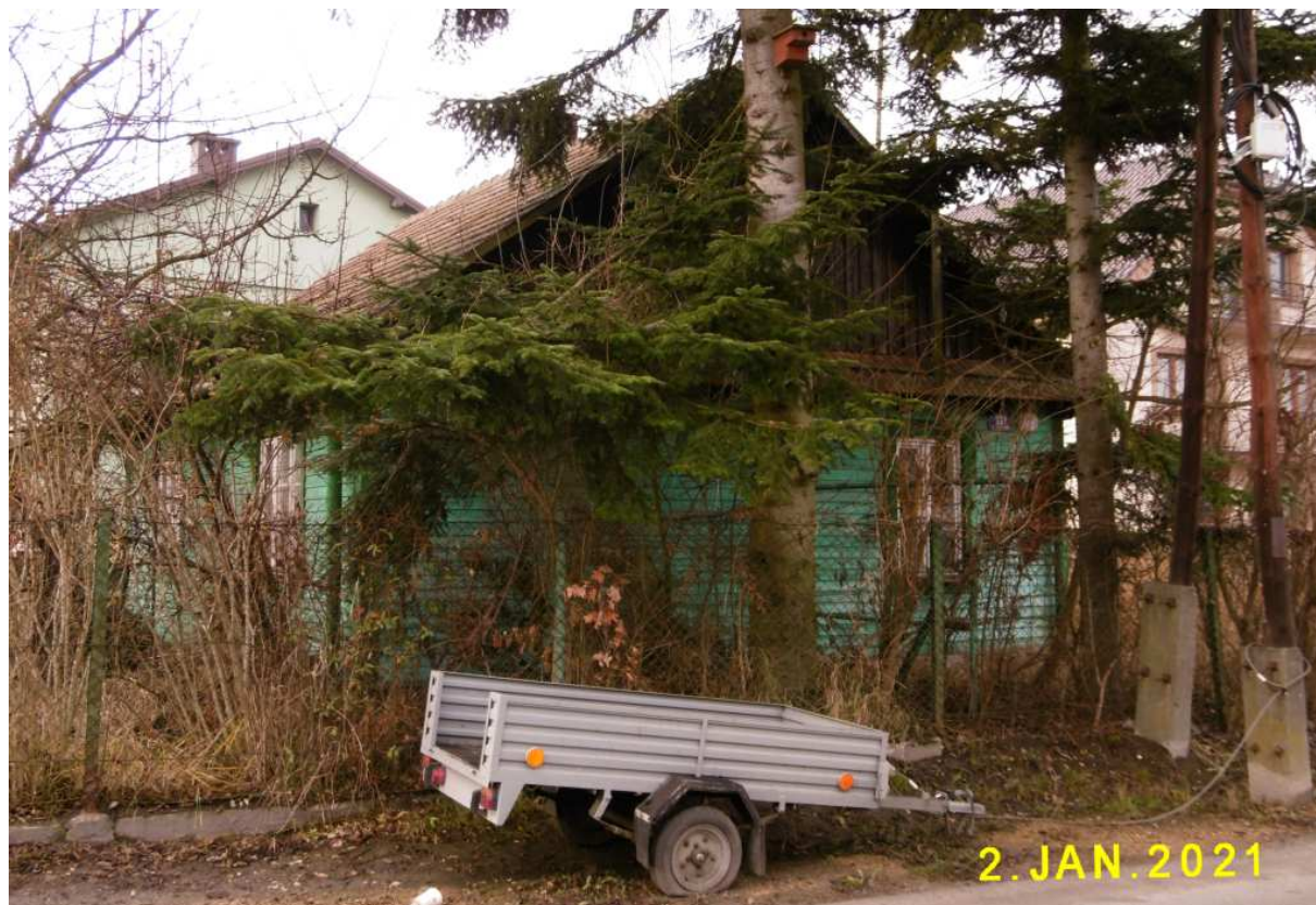
Fot. nr 275. Ukryta za drzewami ściana szczytowa od strony ulicy.
