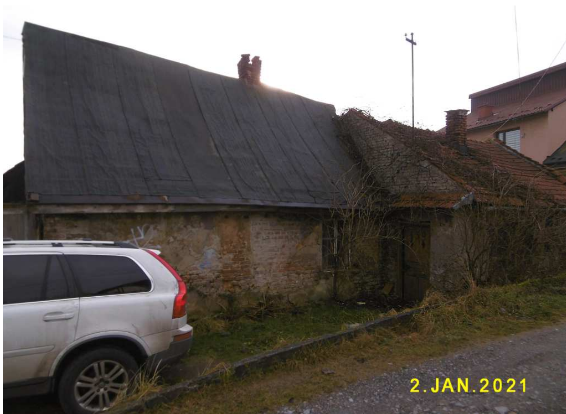
Fot. nr 280. Tylna część domu i przylegającej do niego zapewne gospodarczej dobudówki.
