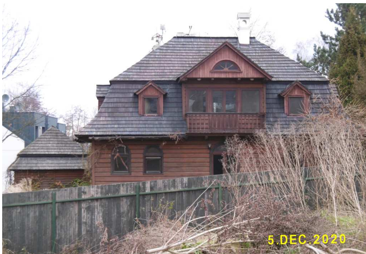
Fot. nr 85 (85-86). Zapewne przedwojenna, stylizowana willa z ulicy Chełmskiej 12.
