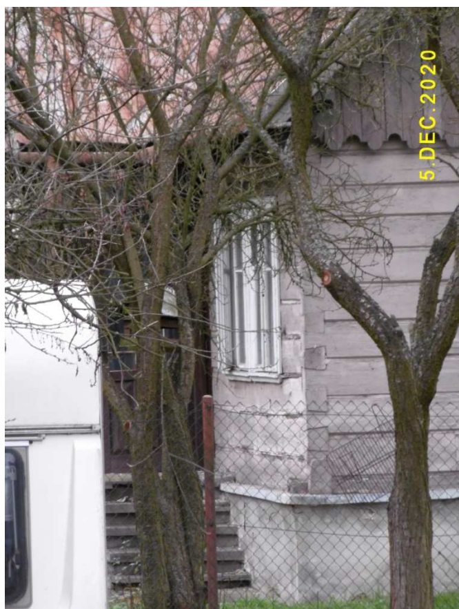
Fot. nr 101. Oryginalne okna ościeżnicowe.
