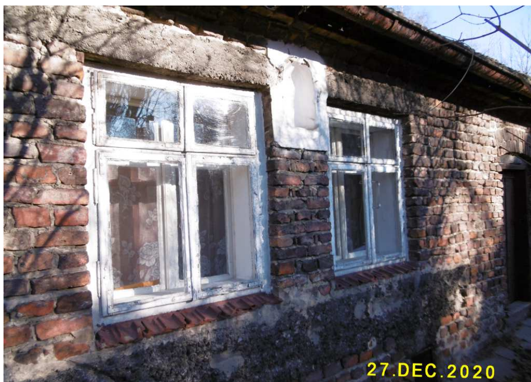
Fot. nr 162. Oryginalne okna typu ościeżnicowego.
