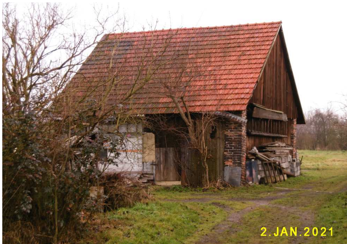
Fot. nr 273. Bliska oryginałowi stodoła na posesji pod nr 144.
