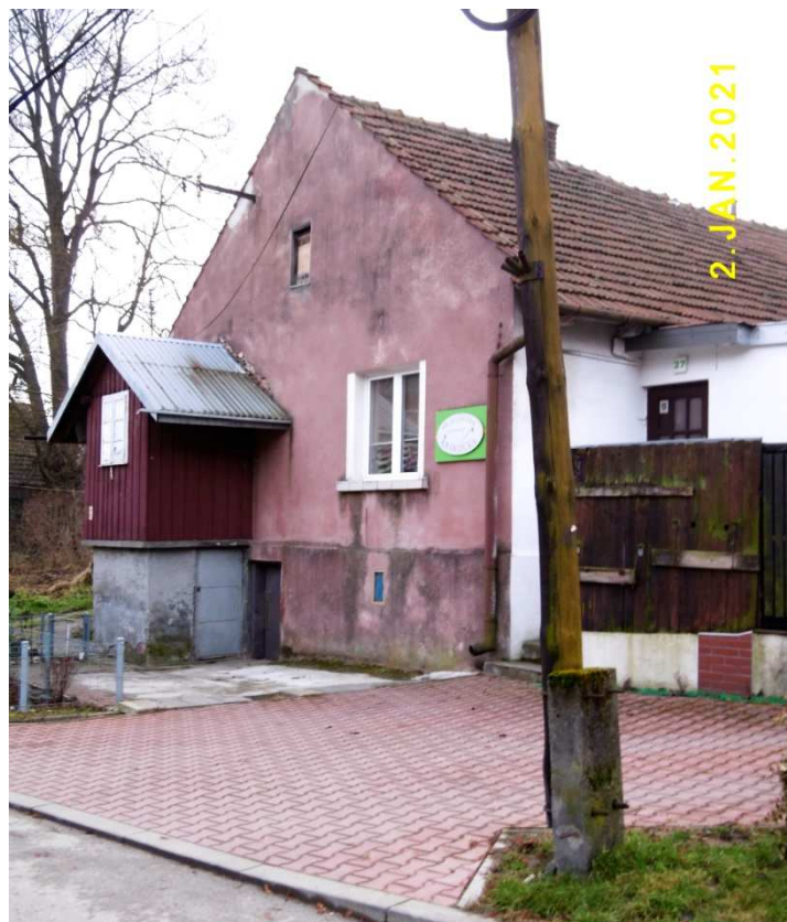
Fot. nr 217 (217-219). Murowany, zapewne przedwojenny dom z gankiem pod nr 27.
