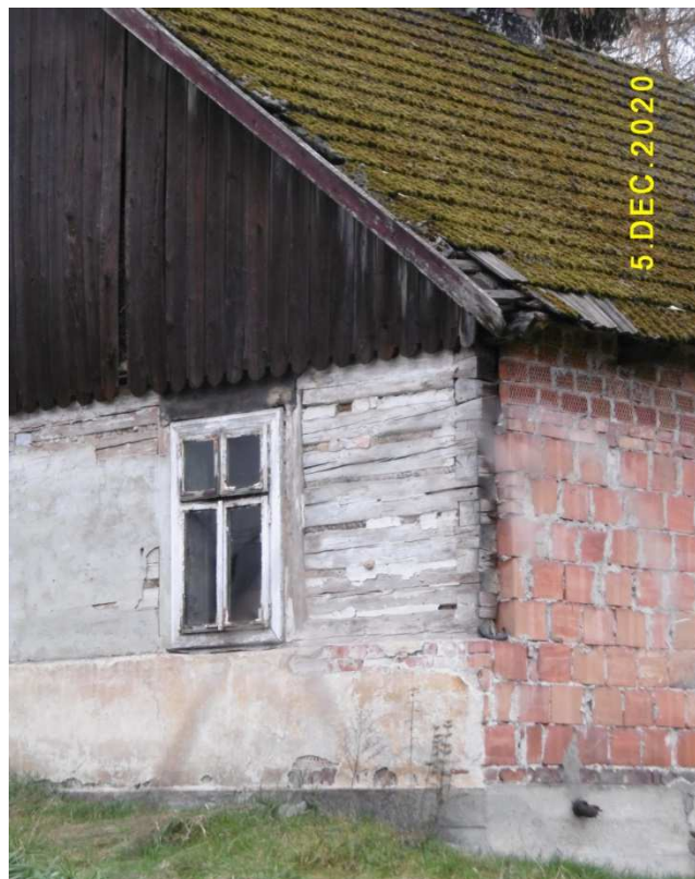
Fot. nr 43. Oryginalne okno w bocznej ścianie szczytowej.
