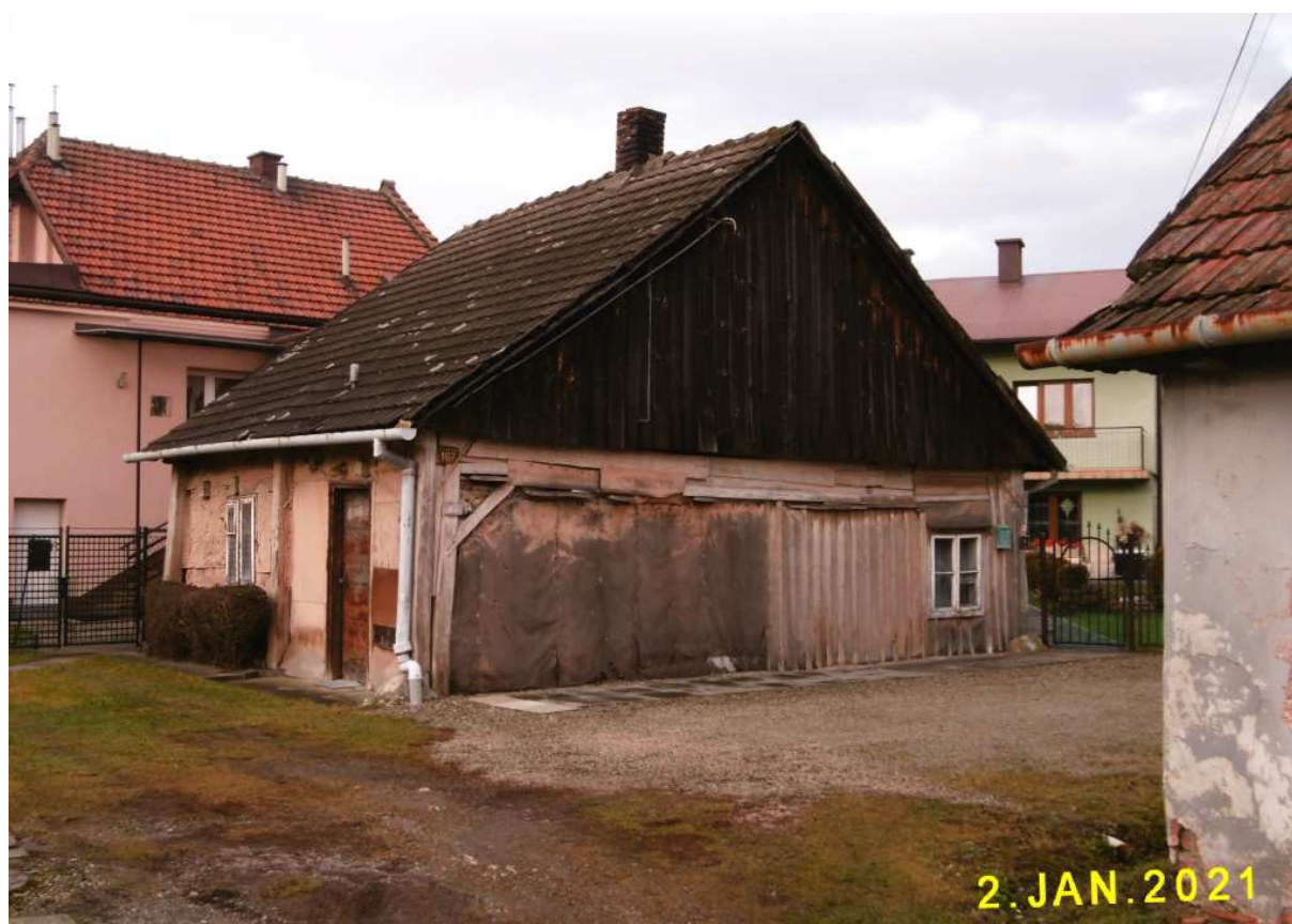
Fot. nr 266 (266-268). Archaiczna chałupa pod nr 107, która mogła powstać nawet na przełomie XIX i XX wieku. Z prawej strony przylegał do niej jakiś budynek gospodarczy.
