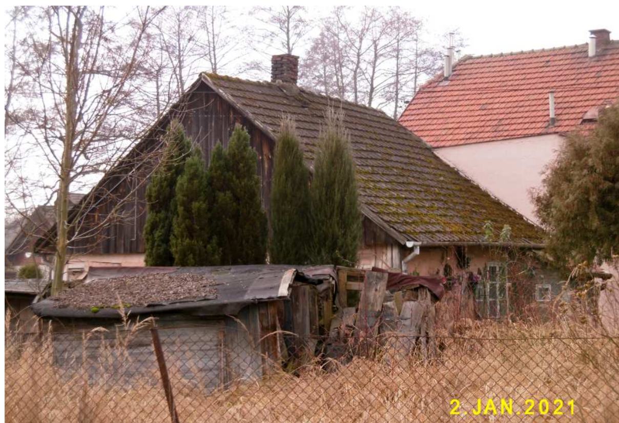
Fot. nr 268. Widok na tylną część od strony podwórka.
