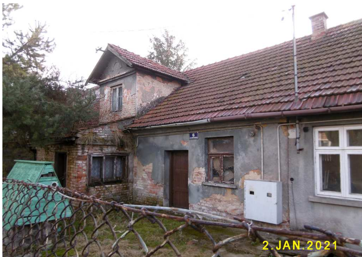
Fot. nr 240 (240-241). Fasada domu.
