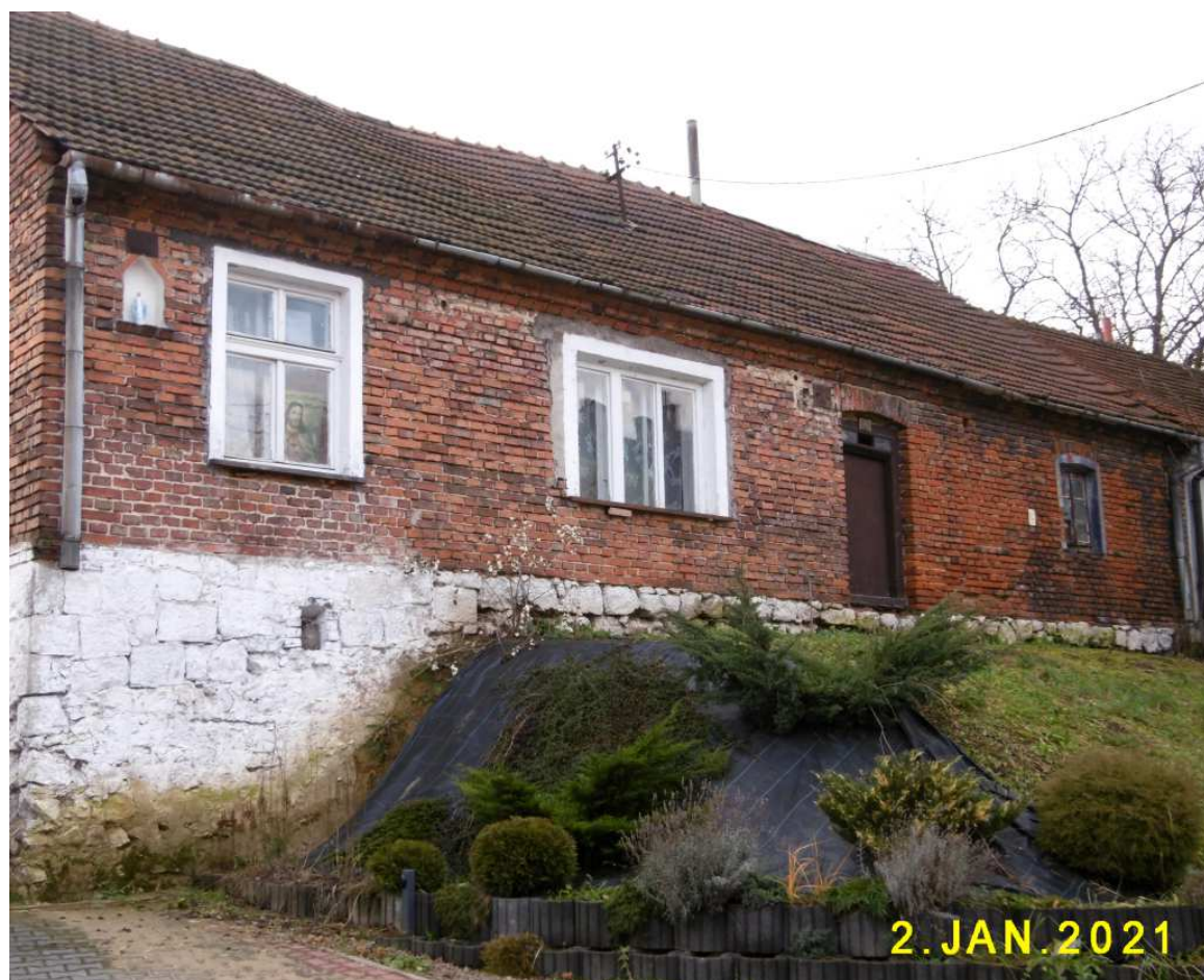
Fot. nr 226 (226-227). Bliski oryginałowi ceglany dom pod nr 13.
