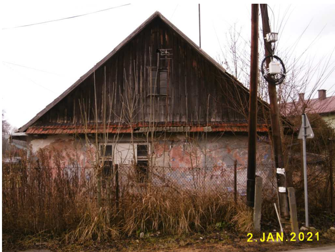
Fot. nr 270. Szczytowa ściana od strony ulicy.
