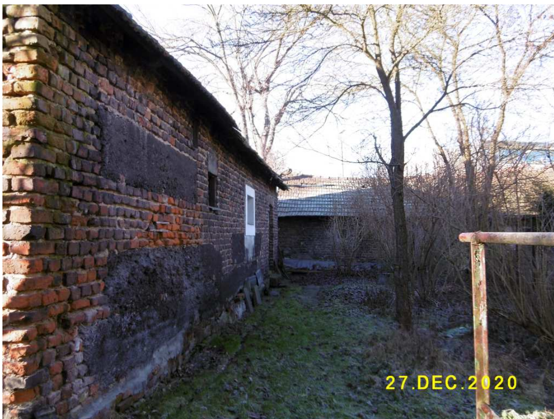
Fot. nr 166. Ściana budynku od strony podwórka z widoczną w tle częścią gospodarczą.
