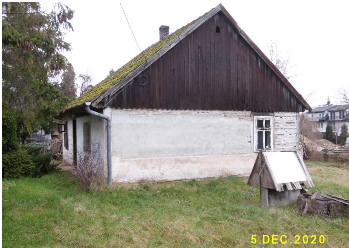
Fot. nr 38 (37-41). Fasada od strony ulicy i jej detale.
