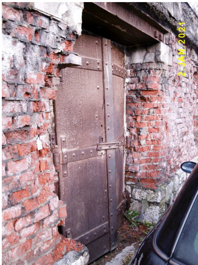
Fot. nr 287. Metalowe drzwi.
