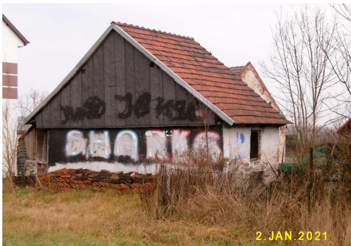
Fot. nr 272. Ruina zapewne przedwojennego domu pod nr 144.
