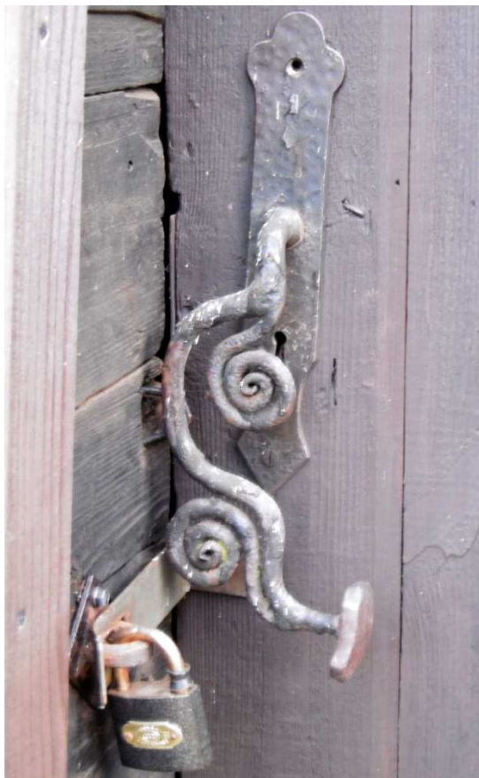
Fot. nr 213. Oryginalna klamka i okucie drzwi.
