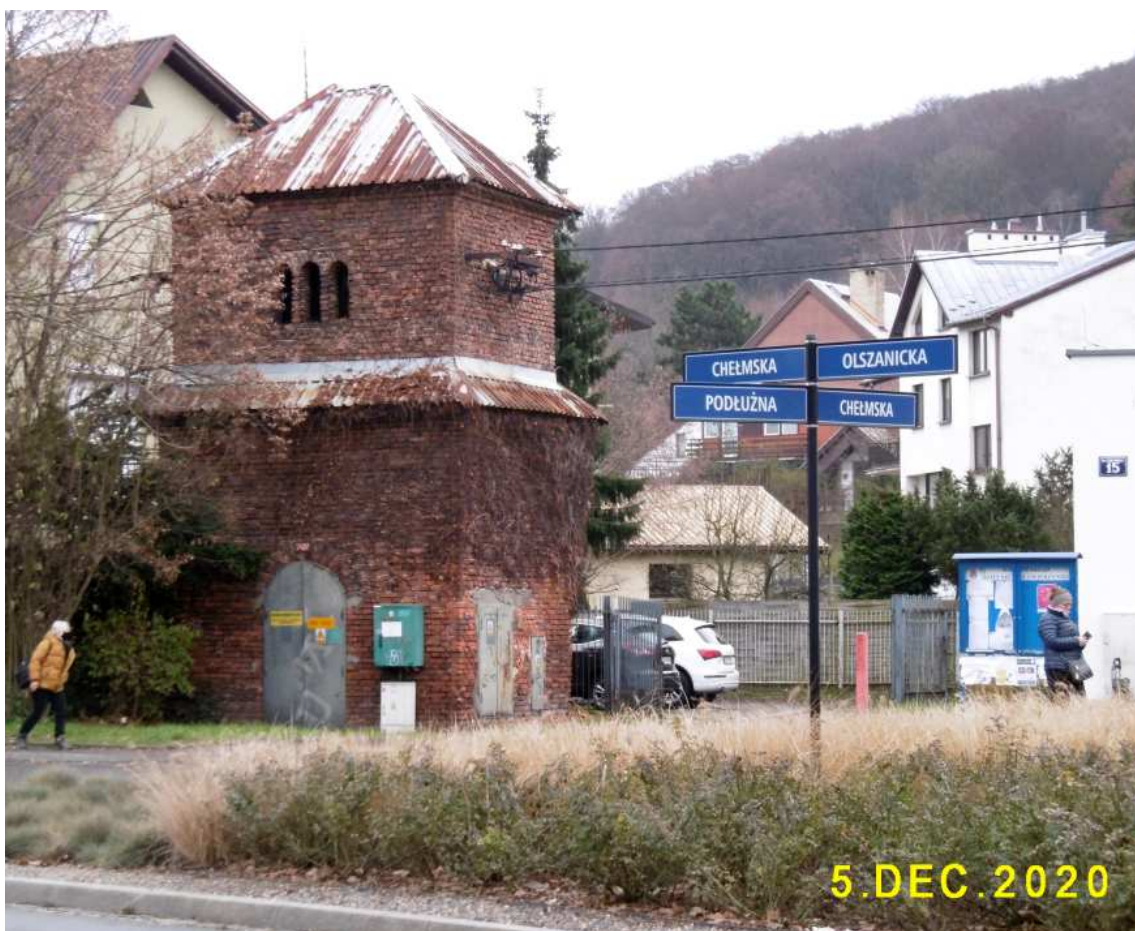
Fot. nr 87 (87-88). Stacja transformatowa z lat 30., ciekawy przykład małej architektury.
