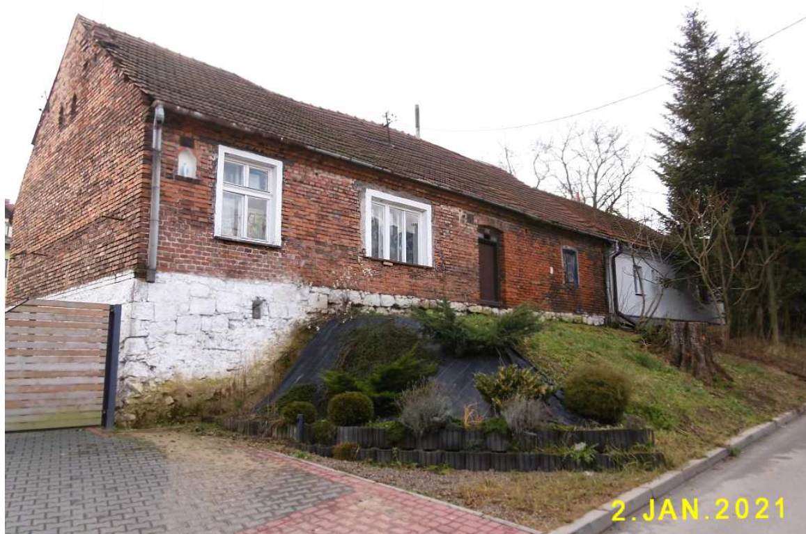
Fot. nr 225 (225-227). Przedwojenny kompleks budynków murowanych pod nr: 13 i 15.
