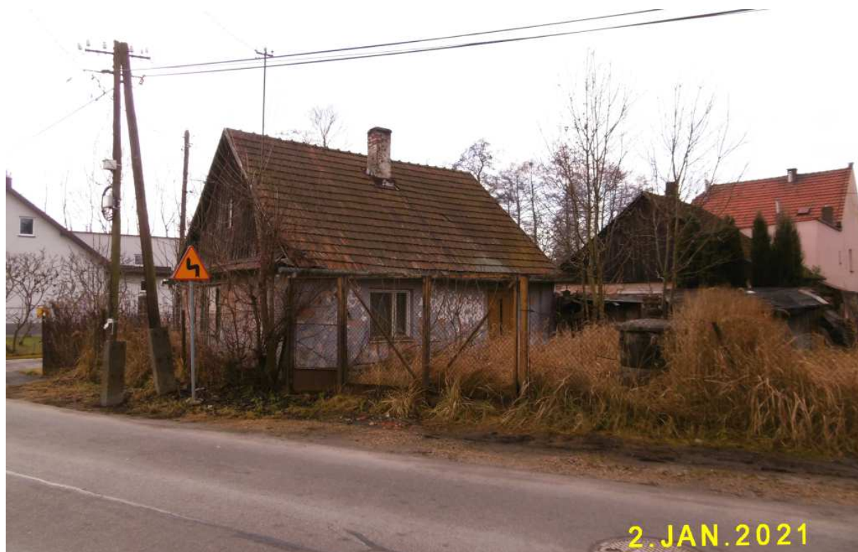
Fot. nr 271. Widok na tylną część domu ze współczesnym już oknem.
