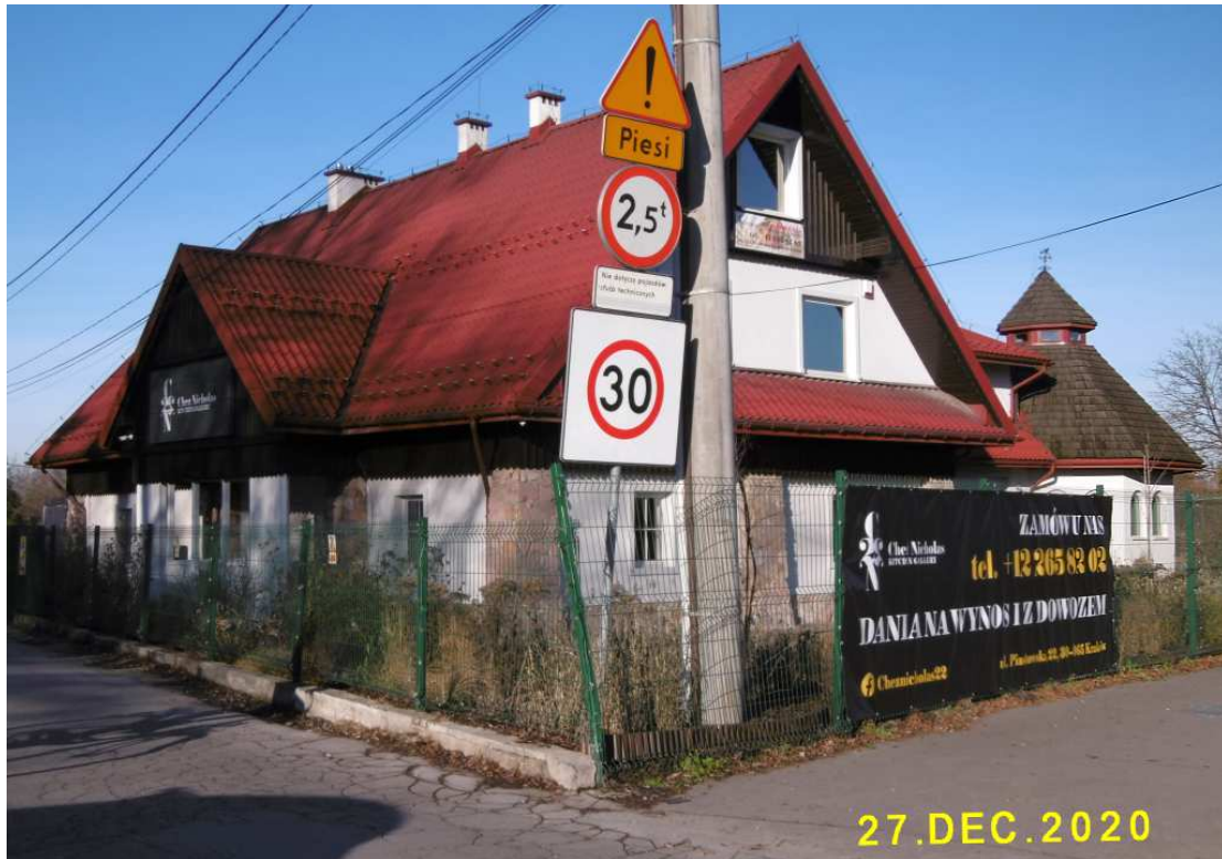
Fot. nr 119. Stylizowany budynek restauracji Chez Nicolaz przy ulicy Piastowskiej 22, powstały w miejscu karczmy Pod Blachą.
