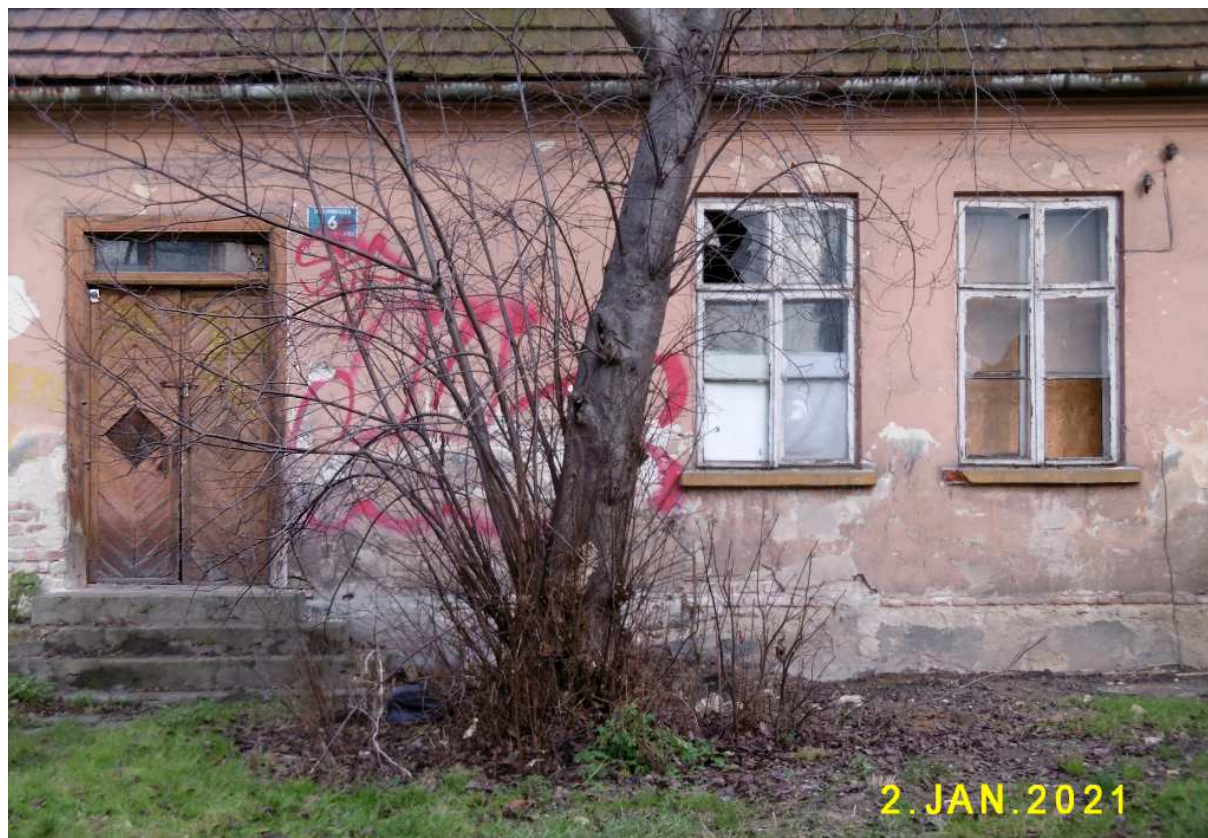
Fot. nr 187. Oryginalne okna typu ościeżnicowego w prawym fragmencie.
