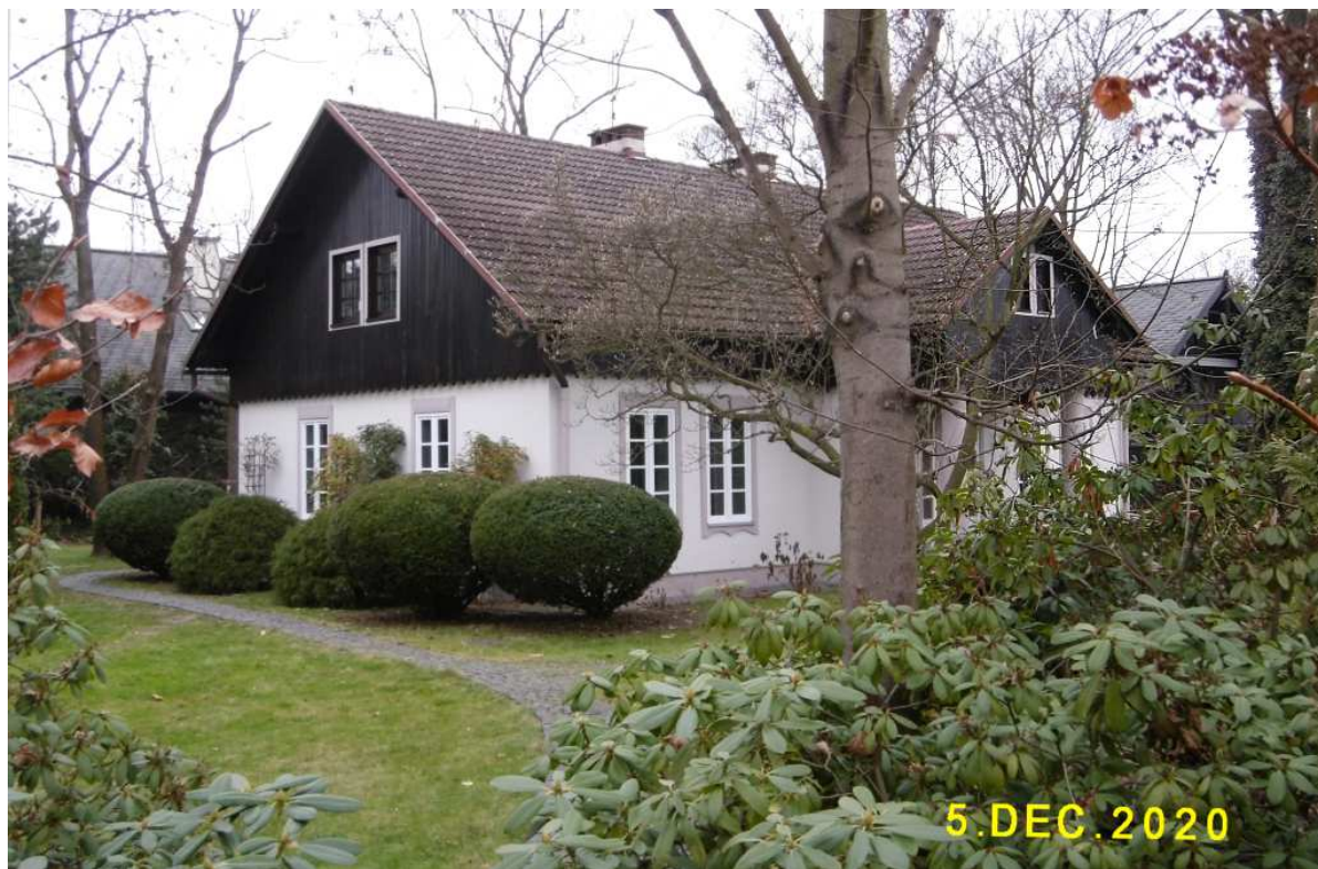
Fot. nr 13 (13-15). Przykładnie odnowiony dworek przy dawnym folwarku przy ulicy Jesionowej 12, który powstał po roku 1850. To przykład solidnej odnowy bliskich ruinie obiektów.
