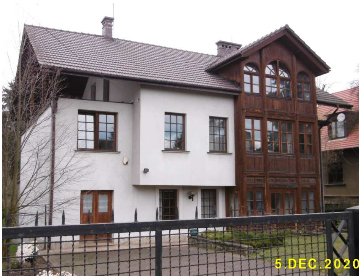
Fot. nr 10. Zachowany w fasadzie oryginalny ganek na kształt ryzalitu.
