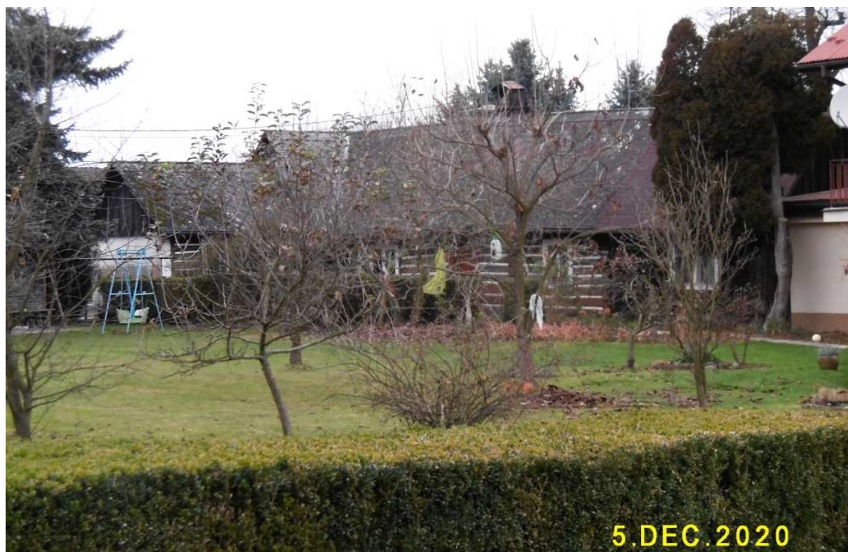
Fot. nr 25 (25-35). Zagroda z chałupą i budynkami gospodarczymi przy ulicy Nad Zalewem 1, pochodząca z ok. 1900 roku. Tu trudna do uchwycenia fasada chałupy od strony ulicy Królowej Jadwigi.
