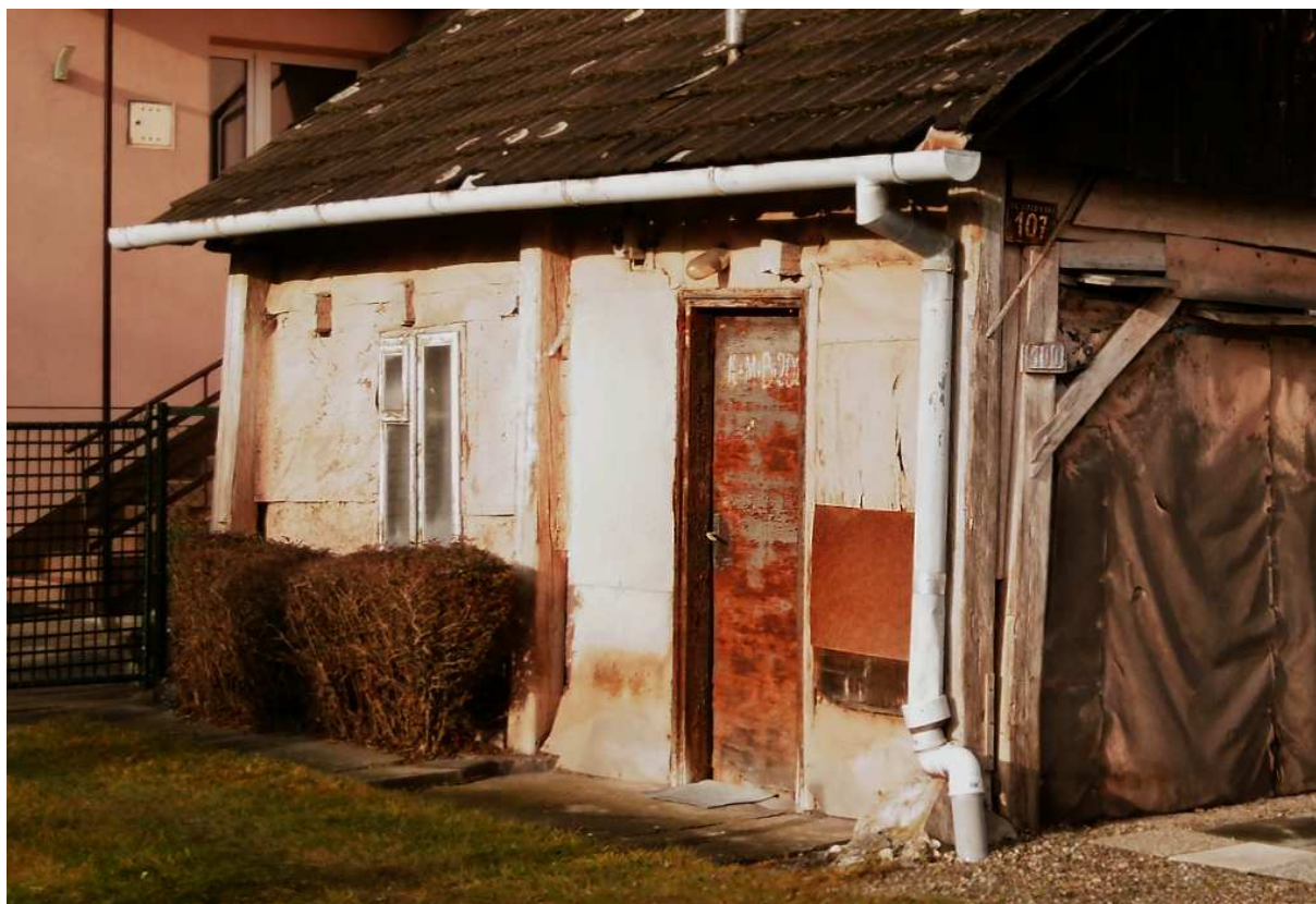
Fot. nr 267. Obita pilśnią fasada z oryginalnym oknem wyposażonym w lufcik.
