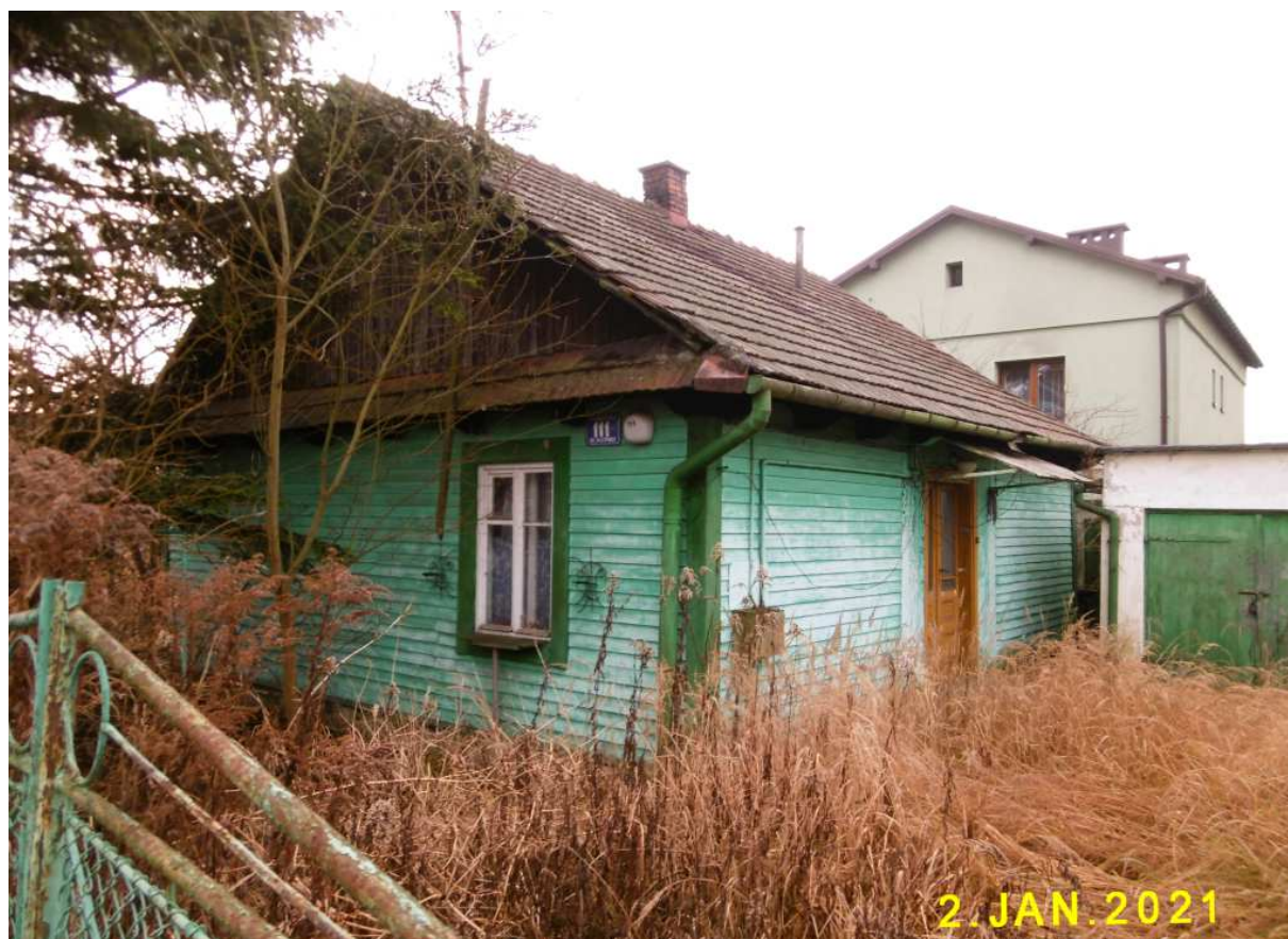
Fot. nr 276 (276-277). Tylna część domu.
