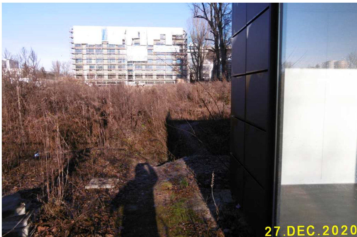
Fot. nr 111. Nowy gigant powstający w sąsiedztwie stadionu Wisły.
