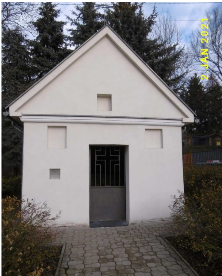
Fot. nr 178 (178-182). Kapliczka p.w. św. Jakuba, wybudowana w roku 1867, posadowiona w bliskości posesji pod nr 4 i jej detale.
