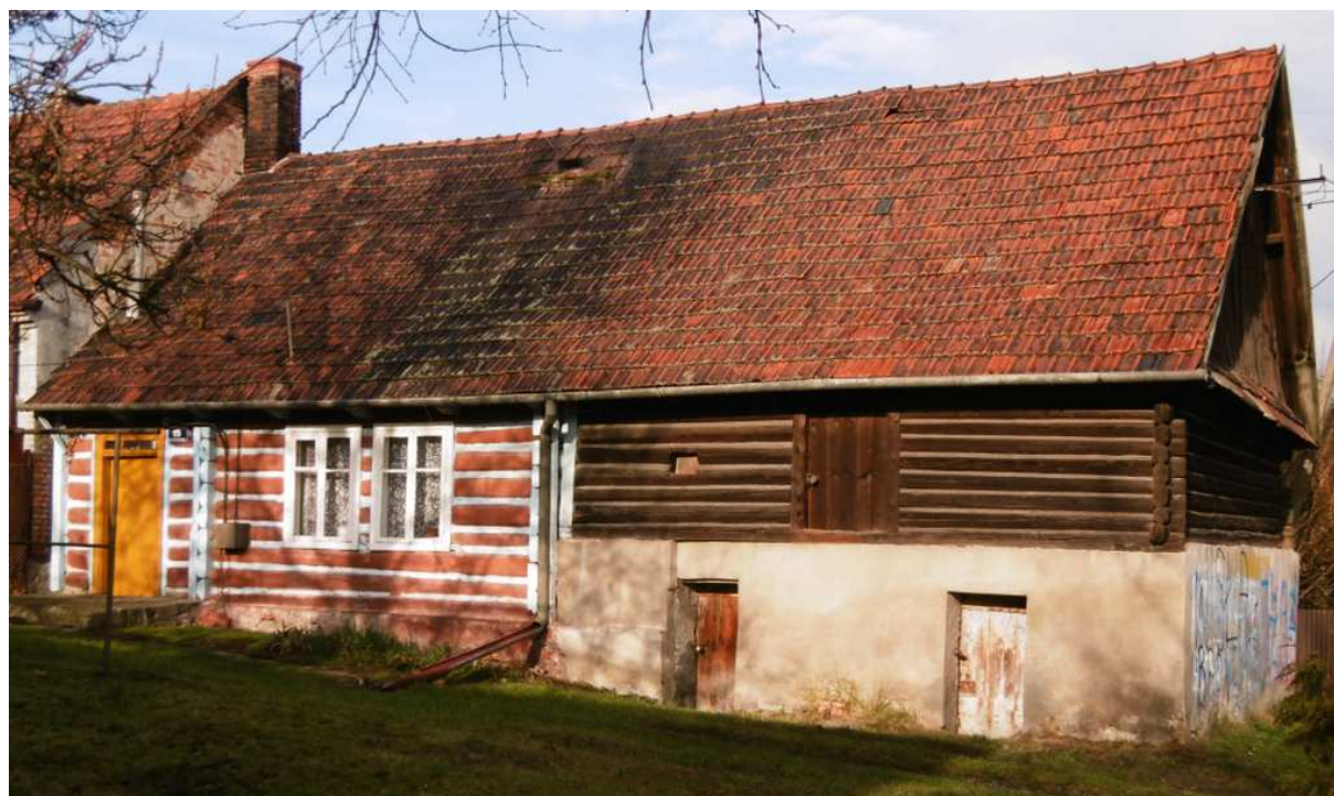
Fot. nr 252 (252-256). Doskonale zachowana chałupa z końca XIX wieku spod nr 15. W jednym korpusie obok części mieszkalnej, która pierwotnie rozciągała się też na lewo od sieni i stanowiła chałupy dwutraktowej, znajduje się też stodoła i stajnia.
