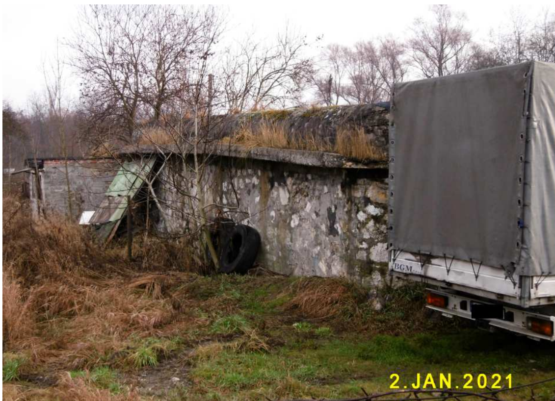
Fot. nr 288. Tylna część bunkra.
