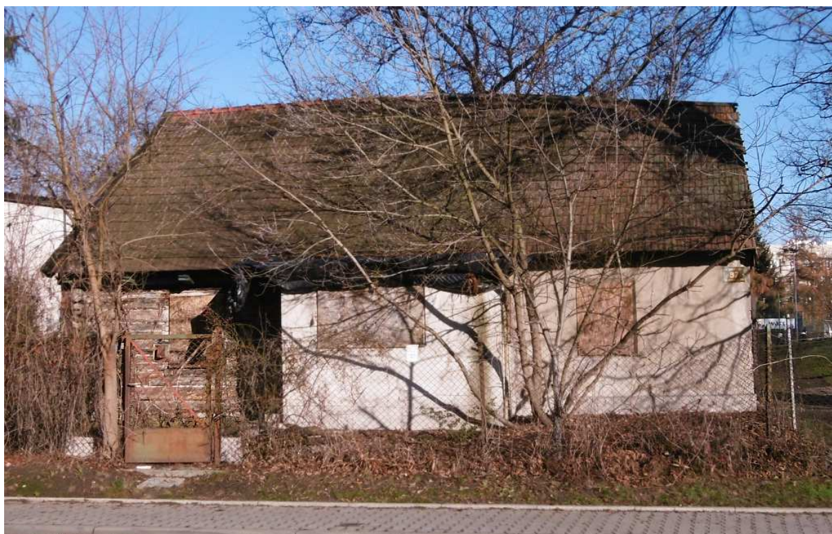
Fot. nr 172. Fasada obiektu.
