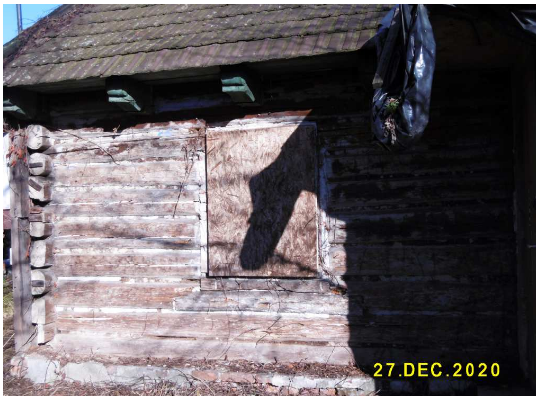
Fot. nr 173 (173-174). Lewy fragment z oryginalną, drewnianą fakturą w układzie zrębowym.
