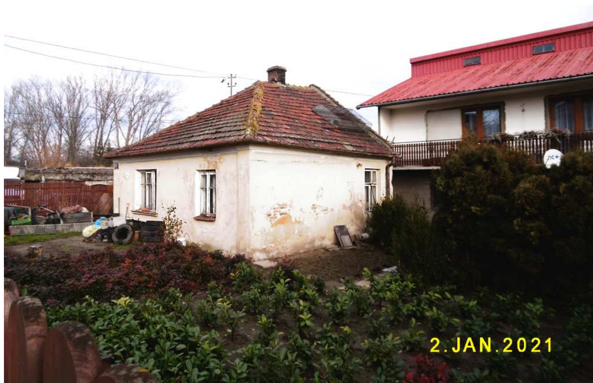
Fot. nr 282 (282-283). Zapewne jeszcze przedwojenny, murowany dom pod nr 172.
