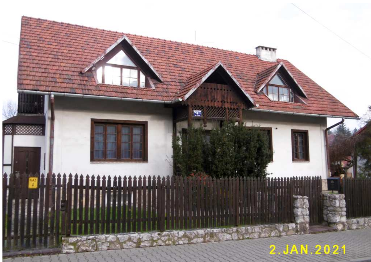
Fot. nr 224. Ażurowy ganek przy wejściu do obiektu.
