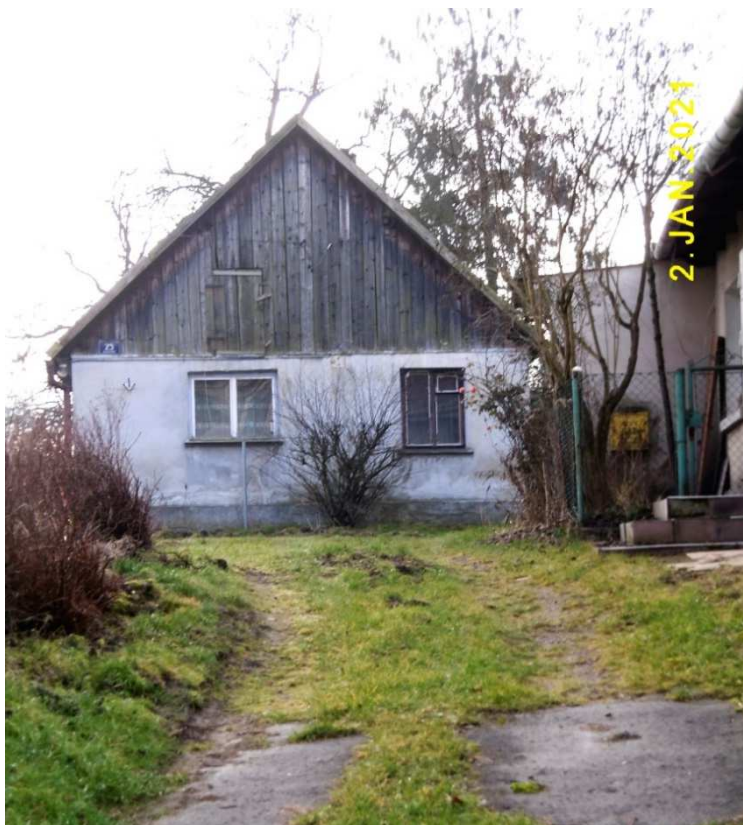
Fot. nr 220. Ściana szczytowa starej chałupy pod nr 25.
