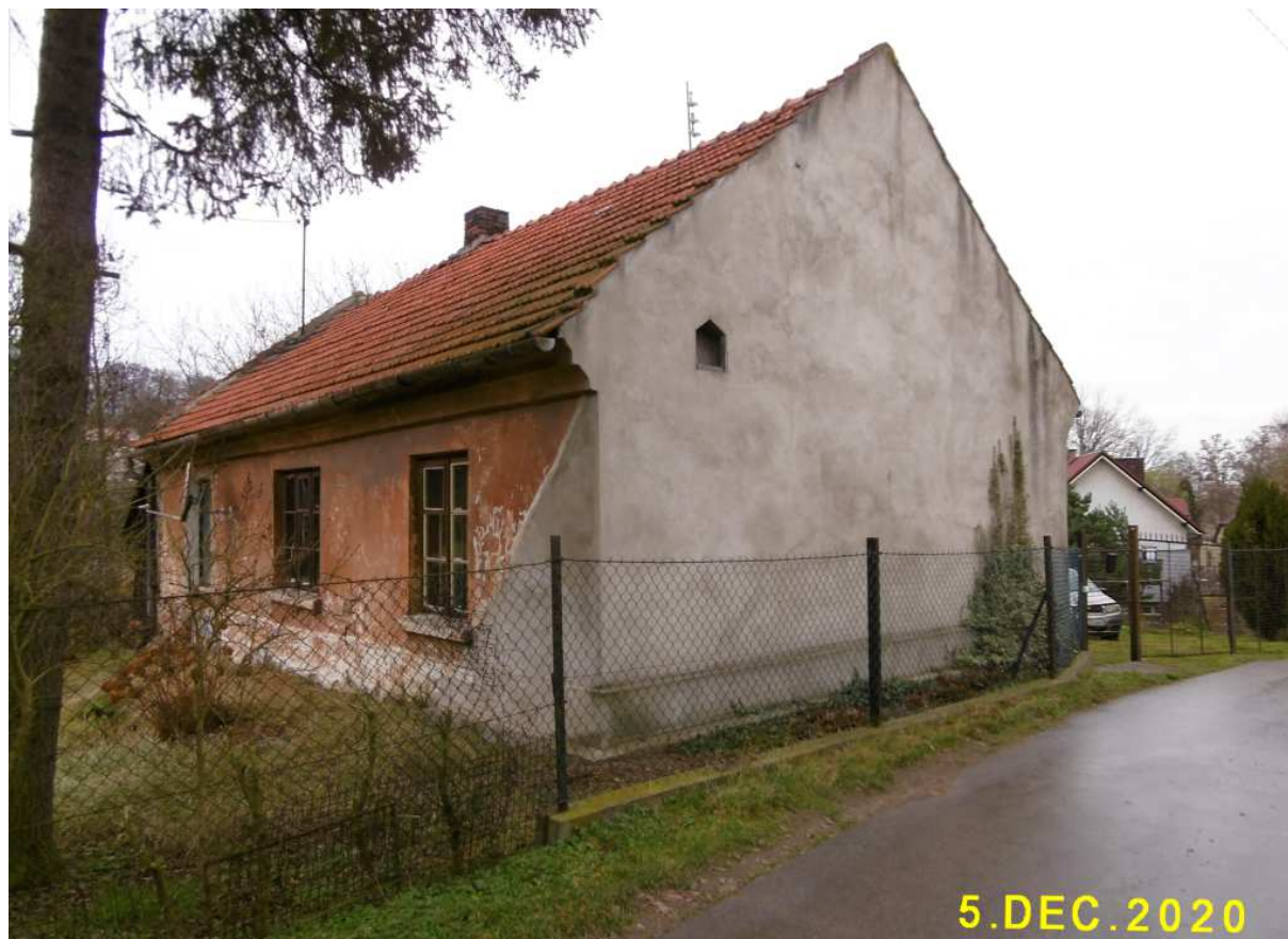
Fot. nr 108 (108-109). Może jeszcze przedwojenny dom murowany z ulicy Oświęcimskiej 14.
