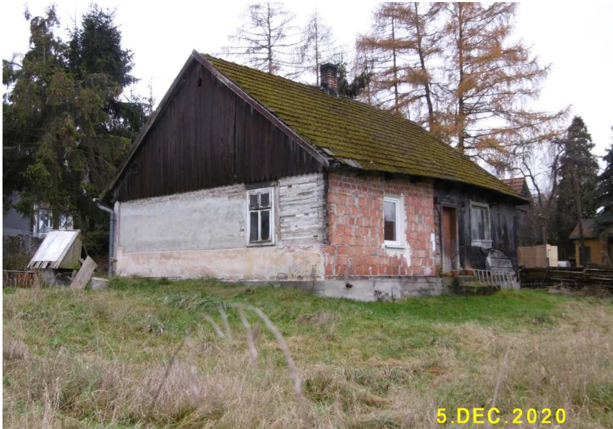
Fot. nr 42(42-43). Ujęcia od strony podwórka, gdzie jak widać trwa przebudowa chałupy.
