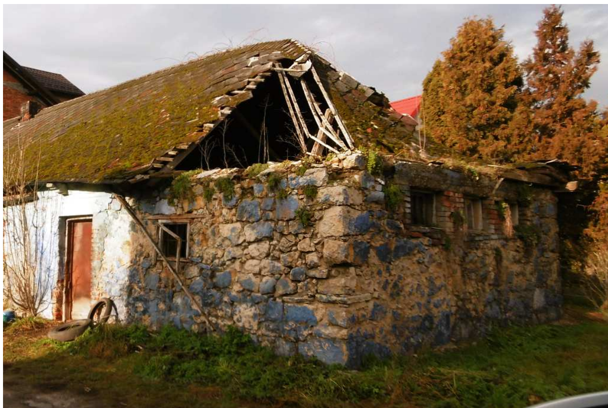
Fot. nr 130. Zrujnowany, kamienny budynek dawnej stajni, która powstała w czasie okupacji niemieckiej.
