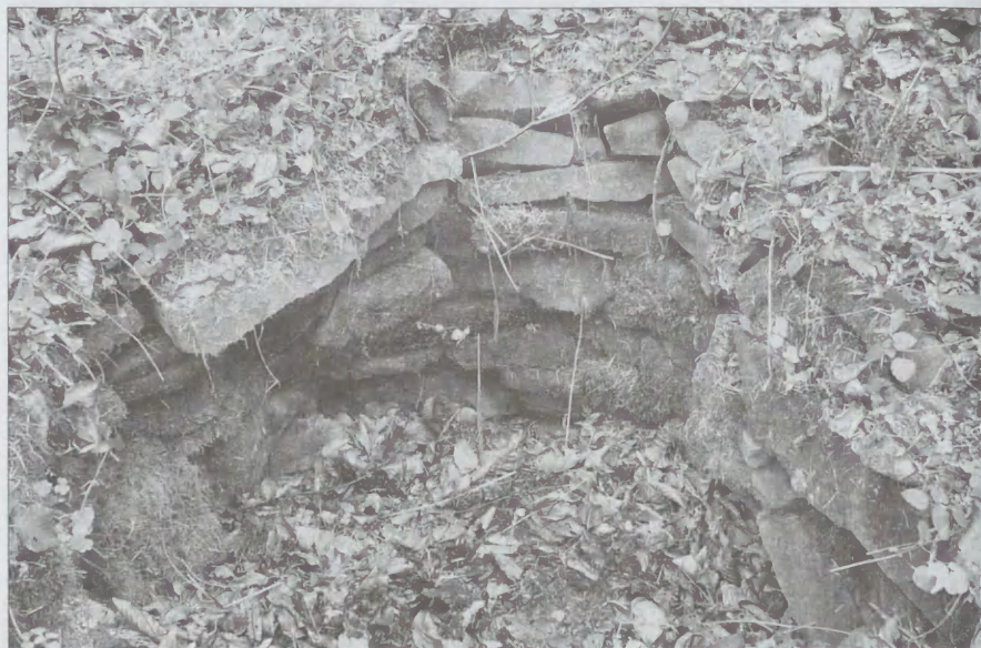
Ocebrowanie studni przy domu na Świniarkach
