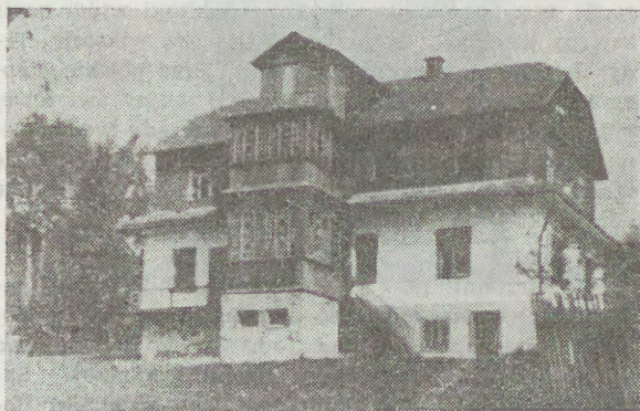
Dom S. i J. Obertaczów w Orawce „Stacja Sabina”
