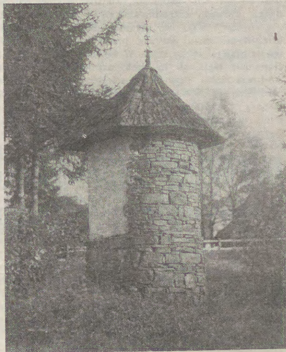
Kapliczki przydrożne na Skalnym Podhalu zawdzięczają niepowtarzalny swój urok materiałom budowlanym i zdobniczym: miejscowemu kamieniowi, daszkom z gontów i krzyżom kutym w żelazie tatrzańskim. Smukłość budowy i jej proporcja znakomicie wiąże się z krajobrazem.
