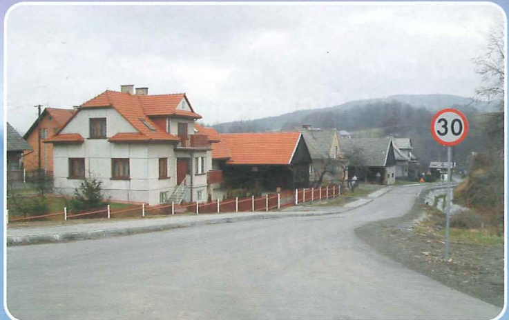
Październik - nowa ulica łącząca ul. Partyzantów i Kowalską
