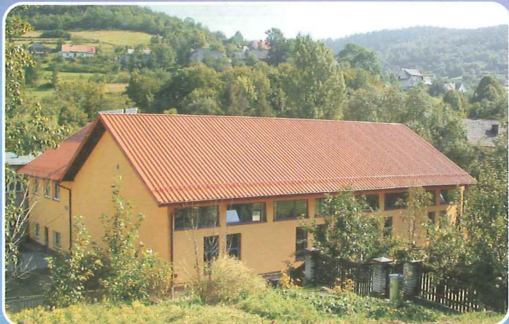
Wrzesień - oddanie do użytku nowego budynku sali gimnastycznej w Harbutowicach
