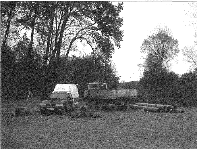
Budowa kanalizacji przy ul. Polnej
