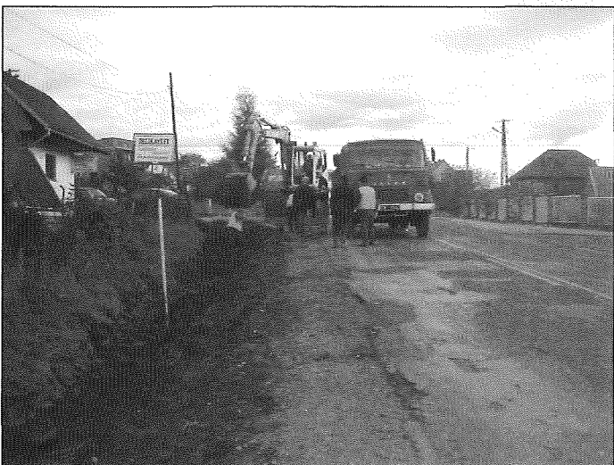
Budowa chodnika do granicy z Jawornikiem rozpoczęta
