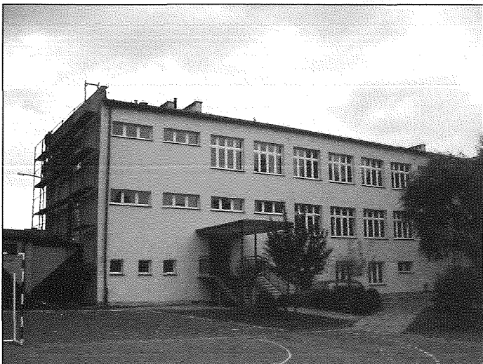
Nowa okna w szkole; obecnie wykonuje się docieplenie i elewację
