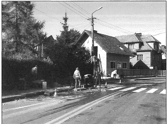
Bezpieczne przejście dla pieszych obok WDT
