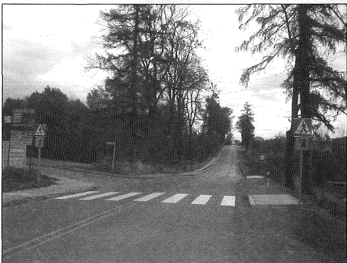
Jedno z kilku nowych przejść dla pieszych z przystankiem PKS
