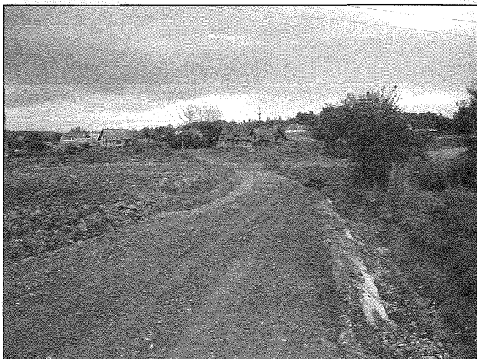
Droga Brzezina przygotowana do asfaltowania
