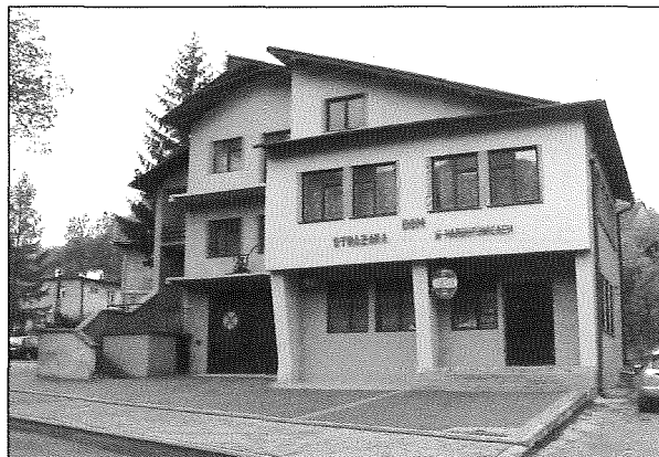
Wyścielenie brukowe przed strażnicą w Harbutowicach
