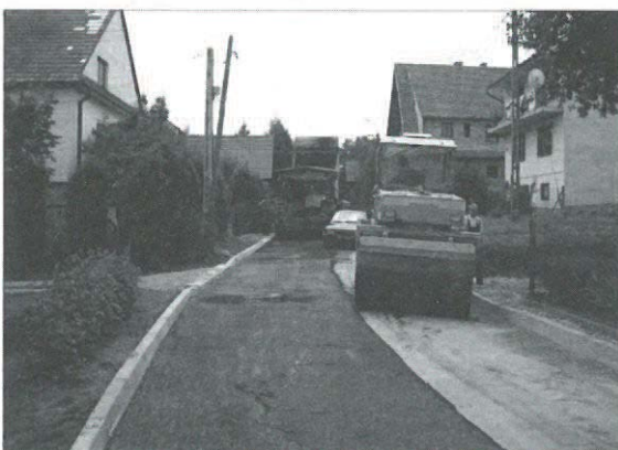
Zagumnie: odbudowa drogi
