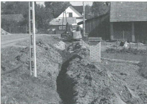
Rudnik: budowa sieci wodociągowej
