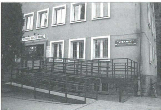
Ośrodek Zdrowia: podjazd dla osób niepełnosprawnych
