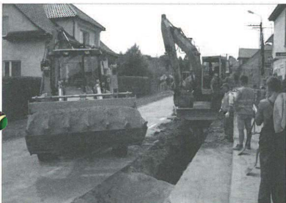
Budowa kanalizacji na ul. 11 Listopada
