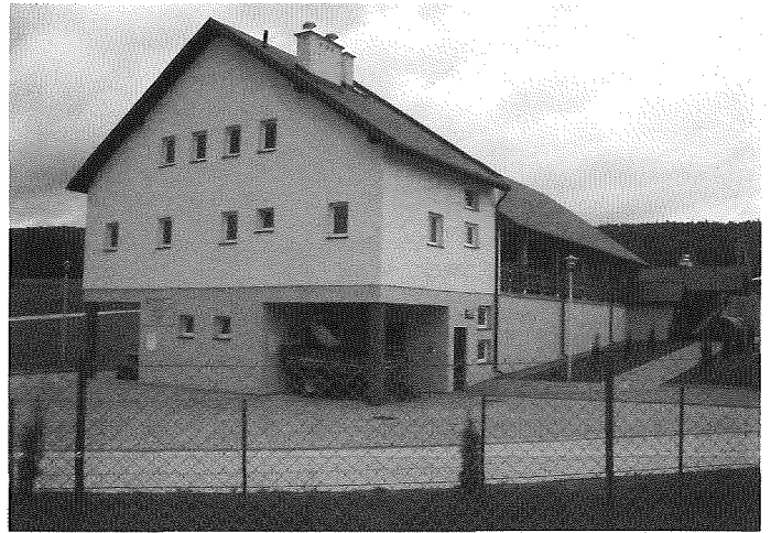
Nowa oczyszczalnia ścieków
