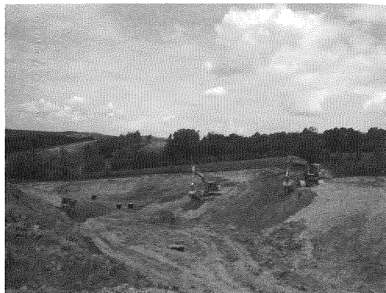
Kształtowanie czaszy składowiska
