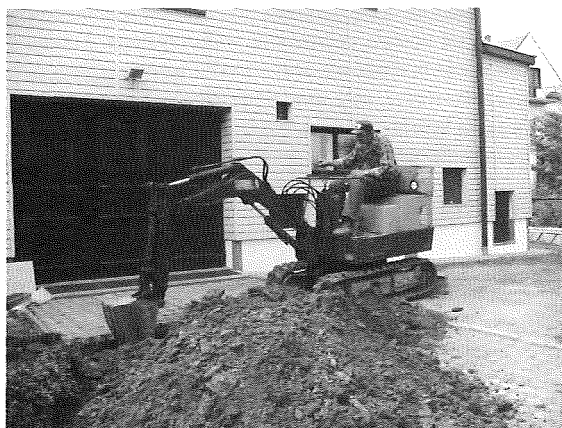
Nowe podłączenia do sieci kanalizacyjnej
