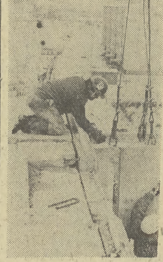
Na budowie nowych domów w Nowej Hucie
