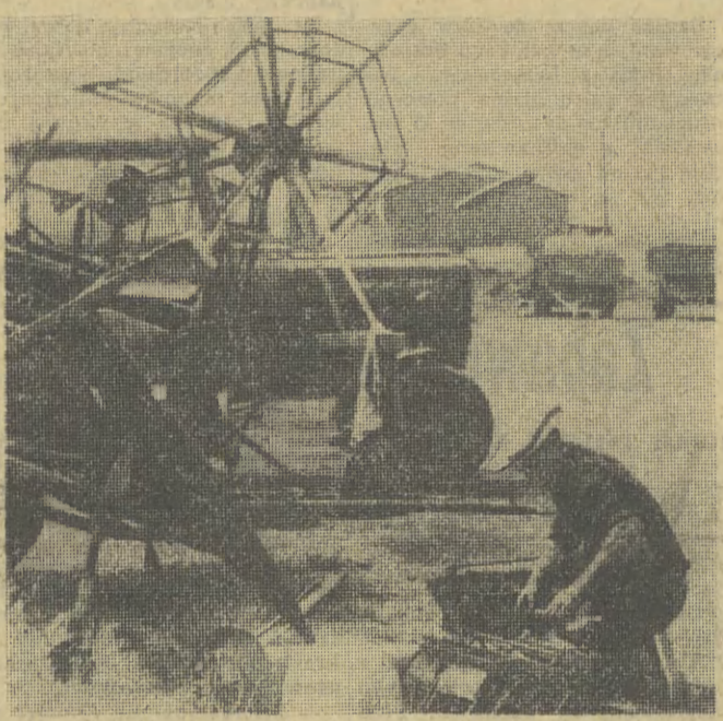
Wczoraj w Międzykółkowej Bazie Maszynowej w Mnikowie rozpoczęto dopiero przy pomocy pogotowia technicznego POM z Krysiniowa remont jednej znowopółzalki typu „Warta”.
