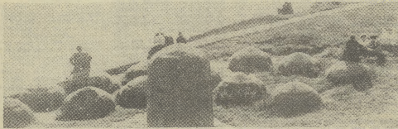
Bunkry strzelnicze nad Wisłą i kopuły do tych bunkrów. Nie zdążyli już ich Niemcy ustawić na ulicach Krakowa.
