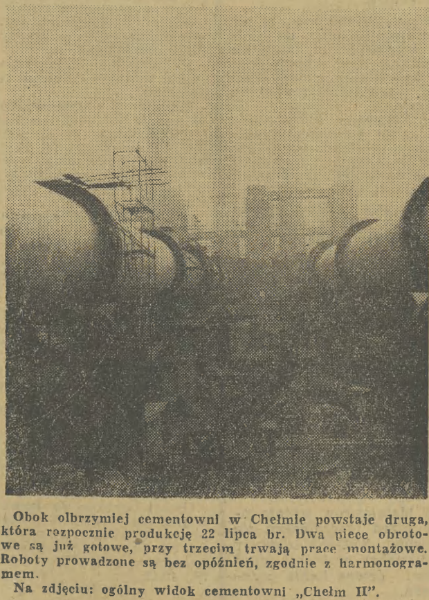
Obok olbrzymiej cementowni w Chełmie powstaje druga, która rozpocznie produkcję 22 lipca br. Dwa piece obrótowe są już gotowe, przy trzecim trwają prace montażowe. Roboty prowadzone są bez opóźnień, zgodnie z harmonogramem. Na zdjęciu: ogólny widok cementowni „Chełm II”. CAF — Trembecki
