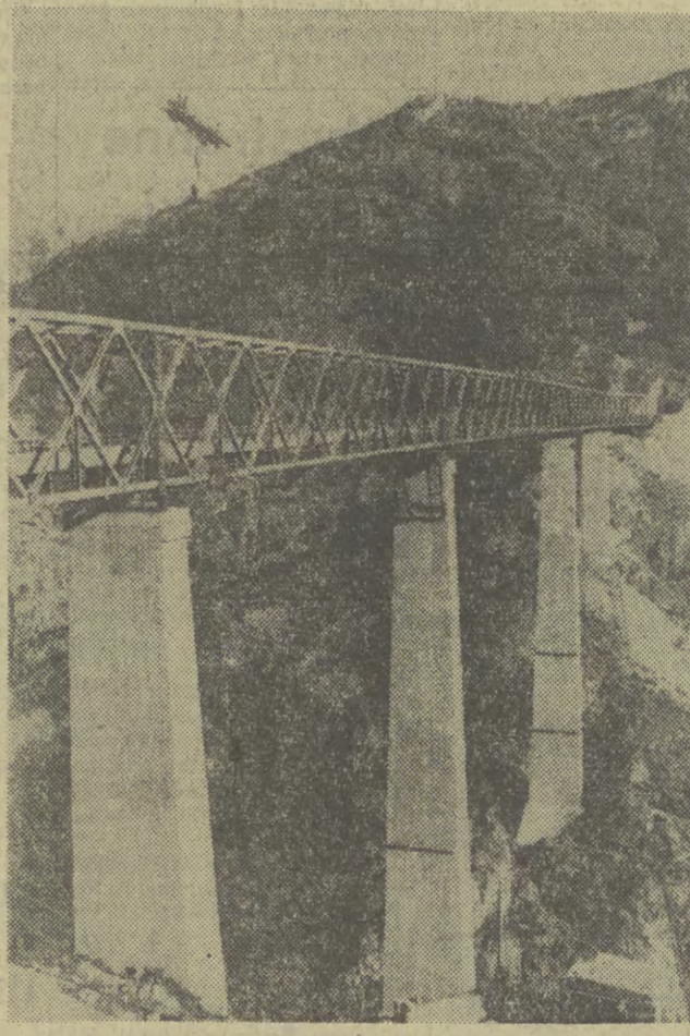
Jugosłowiańskie przedsiębiorstwo Mostogradnja z Belgradu ukończyło budowę mostu kolejowego nad rzeką Mała w okręgu Montenegro. Most ma 500 m długości i jest wsparty na 4 filarach, z których 2 środkowe mają po 150 m wysokości.
