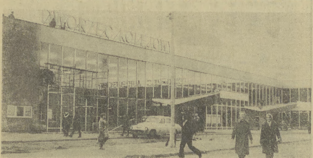
30 grudnia ub. r. oddano w Olsztynie do użytku nowy dworzec kolejowy i autobusowy. Budowa dworca trwała dwa lata. Na zdjęciu: ogólny widok dworca. CAF — Moroz
