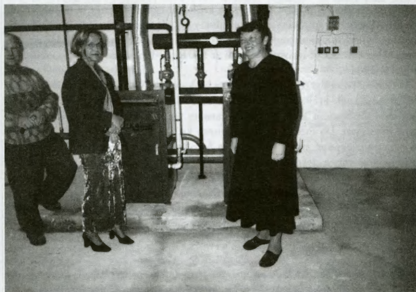
kotłownia w przedszkolu
