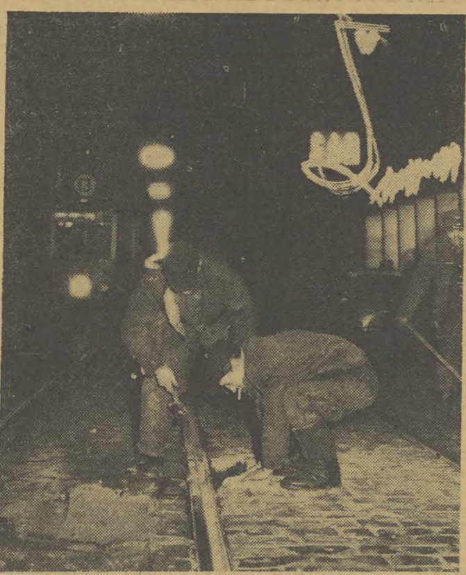
Jeżeli piękna szyna tramwajowa, to natchmiast trzeba uszkodzenie naprawić bez względu na porę dnia czy nocy. Na zdjęciu: pogotowie techniczne MFK przy pracy. Fot. A. Piotrowski
