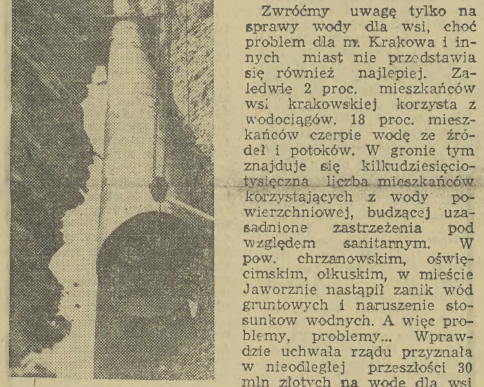
Budowa ciągu wody pitnej dla regionu Chrzanów — Trzebiatna — Trzebiatka. Fot. Otto Link
