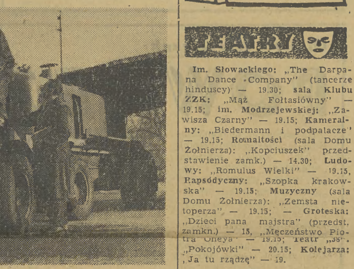
Zakłady Naprawcze Sprzętu Drogowego „Madro-1" w Wrocławiu produkują obecnie dwa rodzaje maszyn drogowych - koty do bitumu o pojemności 1.500 l i koty do asfaltu o pojemności 1.800 l. Na zdjęciu: koty do asfaltu na rynek krajowy. Fot. CAF
