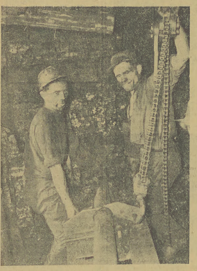
Przekladka na ścianie, gdzie jest duże ciśnienie, nie należy do rzeczy łatwych. Załoga oddziału III każdego dnia udowadnia, że realizuje podjęte zobowiązanie. Na zdjęciu: montaż przenośnika pancernego na ścianie w oddziale III Kopalni „Janina”.
