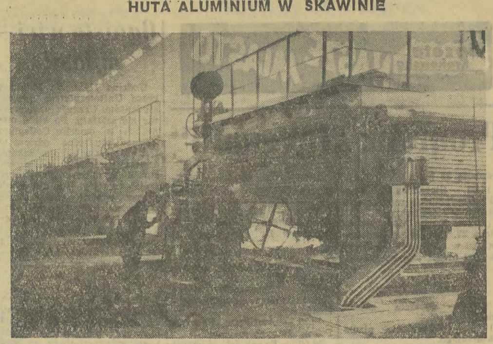
Na zdjęciu: wylewanie metalu z wanny elektrolizyjnej za pomocą kadzi próżniowej. Przy pracy: Franciszek Zaremba i Witold Duraski.
