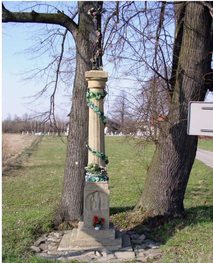
Fot nr: 255 (255-258). Neogotycka kapliczka na Dłużyznach w sąsiedztwie drogi biegnącej z Gdowa do Łapanowa i jej detale. (04.04.2009)
