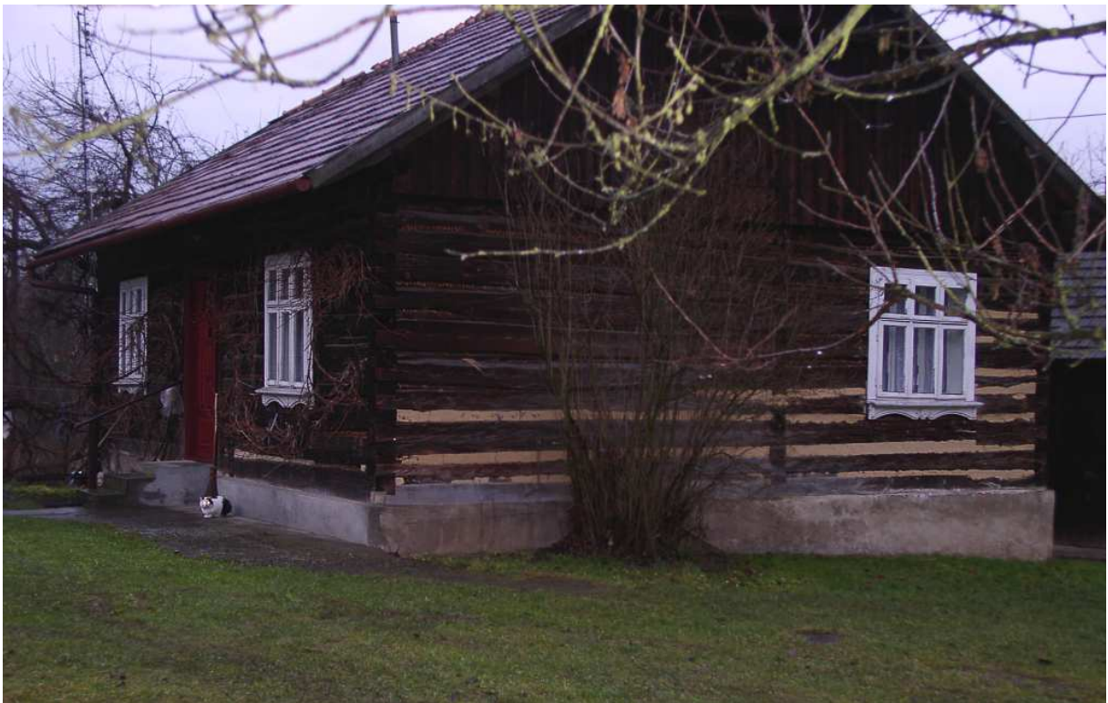
Fot. nr 308 (308-316). Dom spod nr 9, zlokalizowany przy drodze na Wólkę, jak tu zwie się Wołę Zręczyczką, przysiółek Zręczyc z dworem Feillów pośrodku. (21.12.2008) Fot. nr: 308-314. Stan z przełomu lat 2008/2009 z odkrytymi ścianami typu zrębowego.
