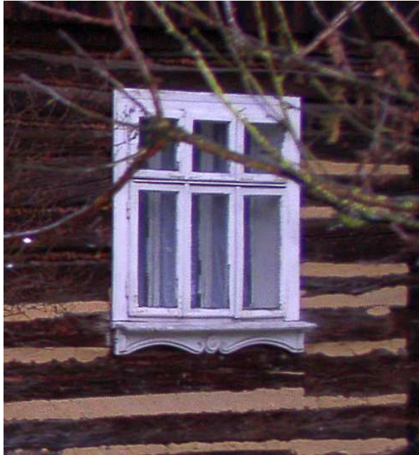
Fot. nr 313. Oryginalne okno typu weneckiego, typowe dla zabudowy z okolic przełomu III. i IV. dekady XX wieku. (21.12.2008)
