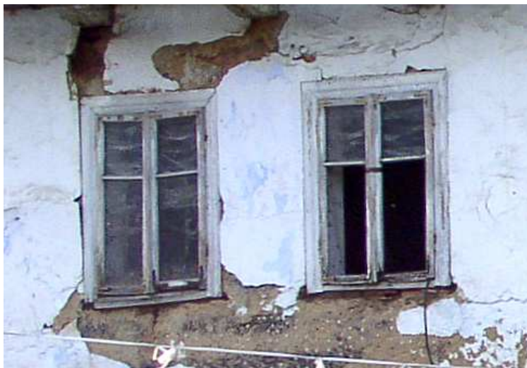
Fot. nr 273. Oryginalne okienka typu ościeżnicowego.
