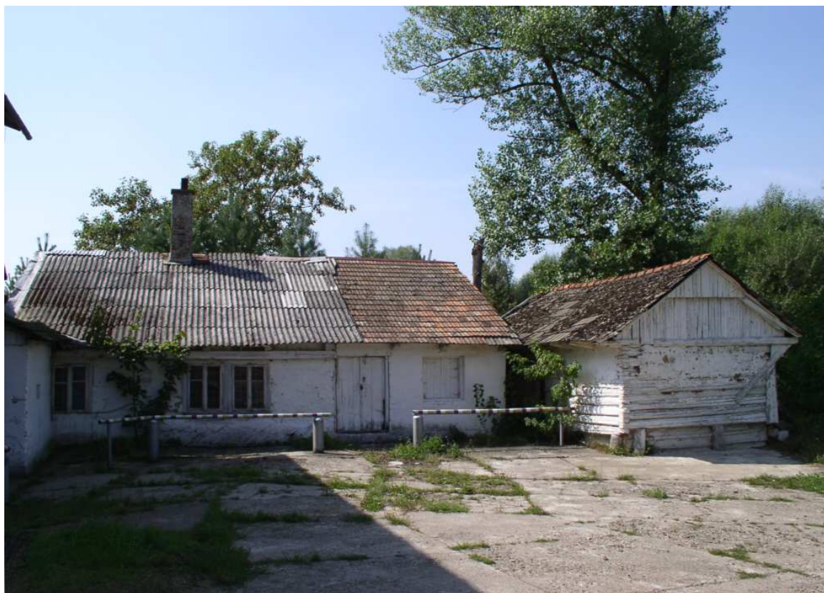
Fot. nr 370 (370-375). Zabudowania dawnej zagrody Stefana Wojasa; chałupa pospołu z częścią gospodarczą oraz przylegająca do niej w poprzek stajnia. (15.08.2009)
