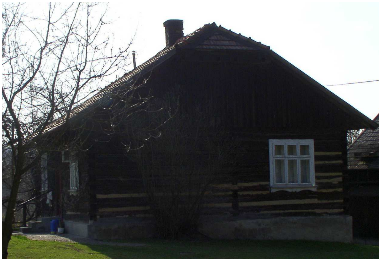
Fot. nr 311. Ściana szczytowa. (04.04.2009)
