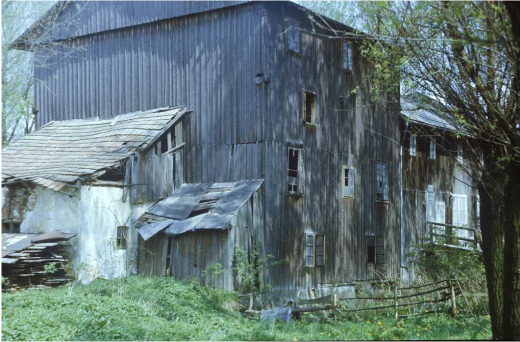
Fot. 353 (353-354). Młyny braci Wojasów: Stefana (z przodu) i Rudolfa (w tle). Stan z roku 1990. Na pierwszym planie zburzony ok. roku 1996 dawny młyn Stefana Wojasa, młodszego brata Rudolfa. Z lewej widoczne jest jeszcze zagłębienie po korycie dawnej młynówki, którą woda z Raby płynęła do 1963 roku.
