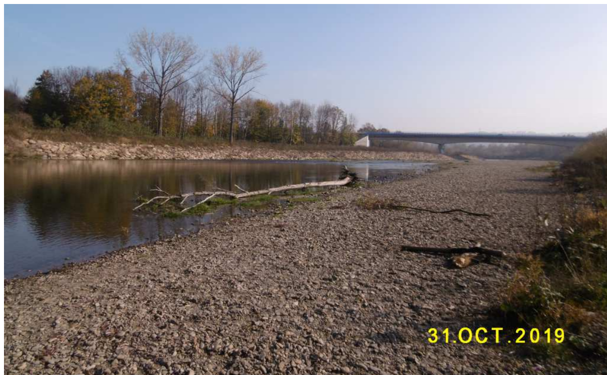
Fot. nr 14 (14-17). Most na nowej obwodnicy Gdowa, który przeciął Dłūżyzny. Na prawym brzegu jedna z ostatnich w tej okolicy rozległych plaż, ale z lewej już tylko sztucznie umocniony kamieniami brzeg.
