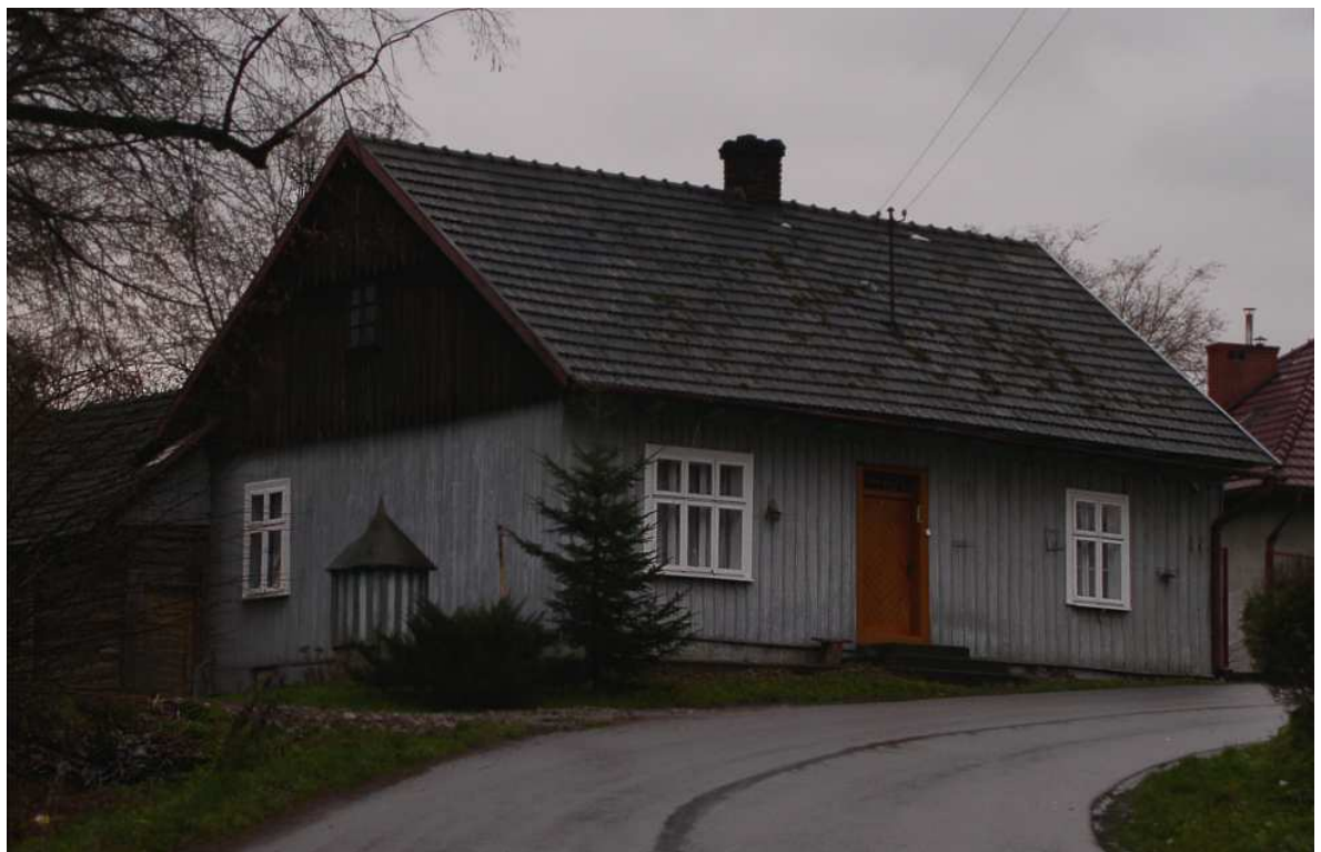
Fot. nr 262 (261-264). Ciągle dobrze utrzymana fasada. (21.12.2008)
