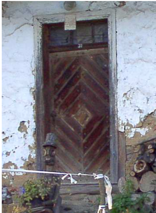
Fot. nr 272. Oryginalne drzwi.
