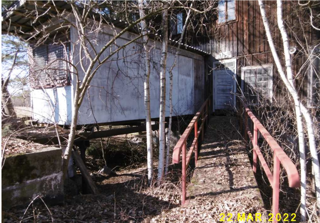
Fot. nr 347. Mostek w miejscu dawnego jazu.
