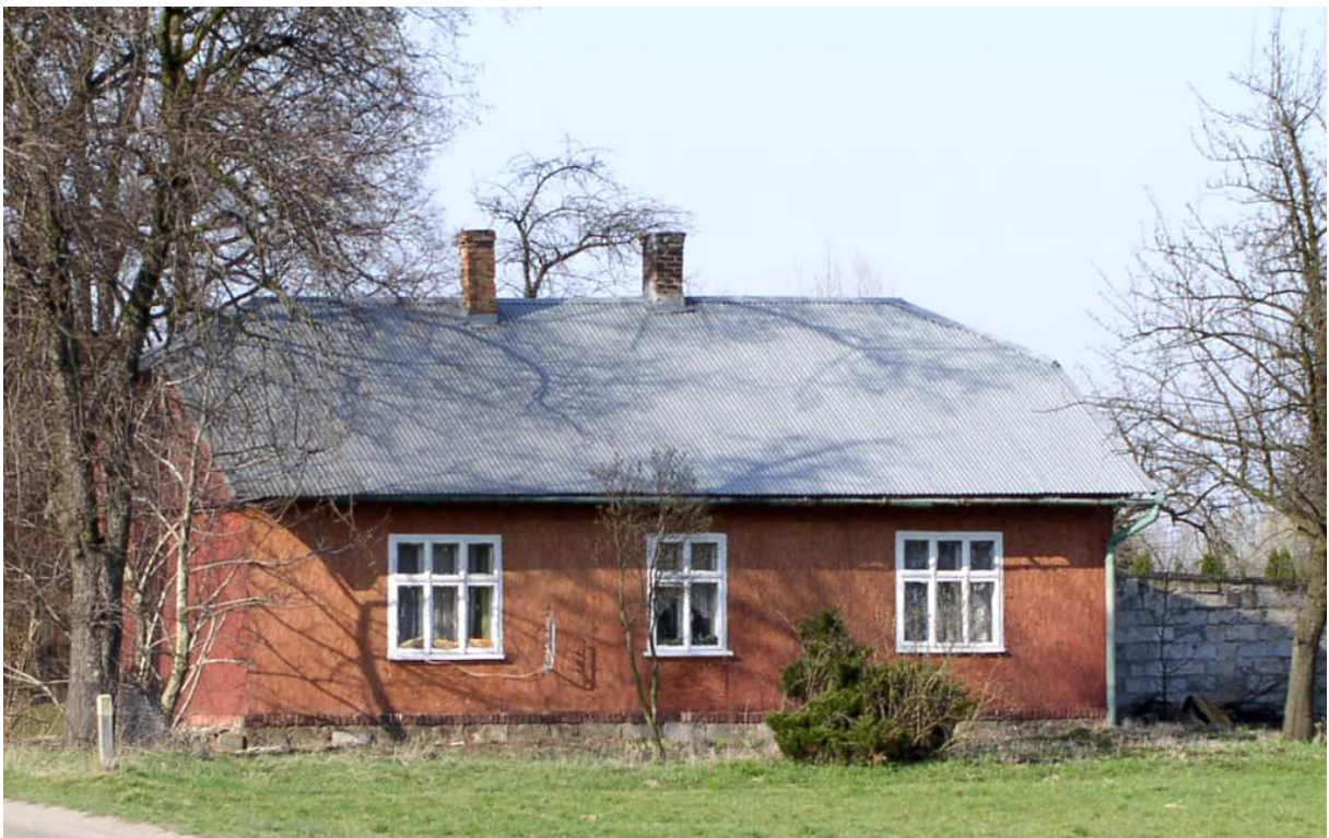
Fot. nr 260. Dom jeszcze z oryginalnymi oknami typu weneckiego. (04.04.2009)
