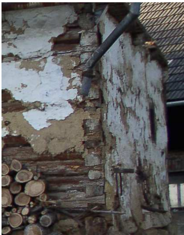
Fot. nr 274. Narożnik chałupy wybudowanej w konstrukcji zrębowej.
