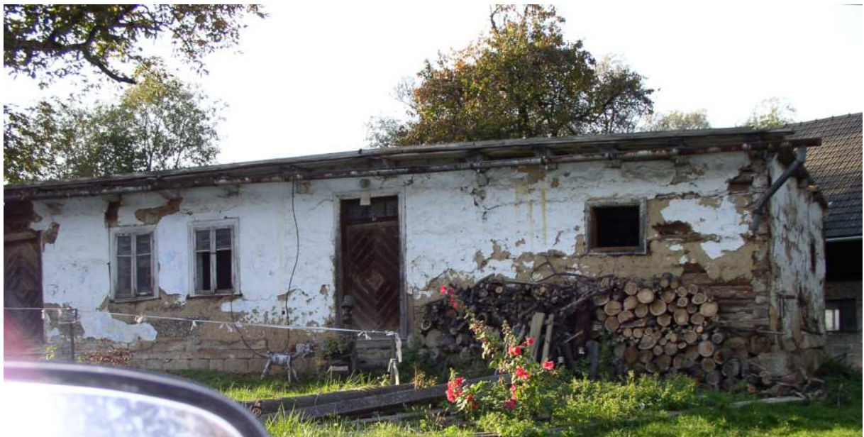
Fot. nr 270 (270-274). Zapewne jeszcze XIX-wieczna, bielona chałupa spod nr 37 w trakcie wyburzania, już bez dachu i jej detale. (12.10.2008)
