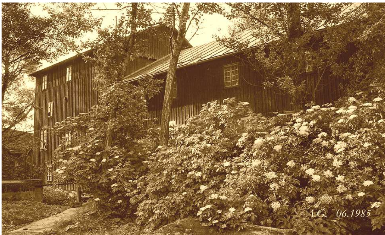
Fot. nr 340 (340-354). Kompleks dwóch młynów braci Wojasów: ten wyższy (z tyłu) kiedyś należący do Stefana i ten niższy, do niedawna czynny, stanowiący własność rodziny Rudolfa. Widoki od strony dawnej drogi dojazdowej od strony Raby. Fot. nr 340 autorstwa Adama Gryczyńskiego (1985).
