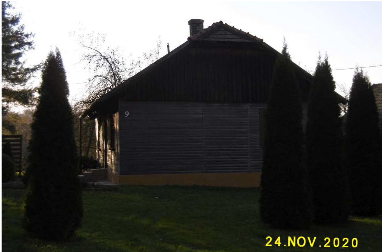
Fot. nr 315 (315-316). Stan z 24.11.2020 po nałożeniu na ściany sidingu.
