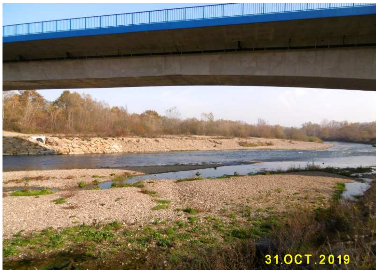
Fot. nr 17 (17-18). Krajobrazy znad Raby w stronę Podolan. W trakcie budowy mostu dawne plaże na sporych odcinkach zastąpiły kamienne umocnienia brzegów
