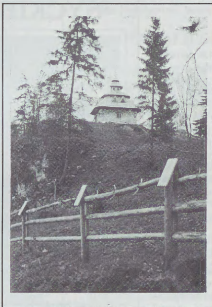
Szaflarska Stróża po modernizacji
