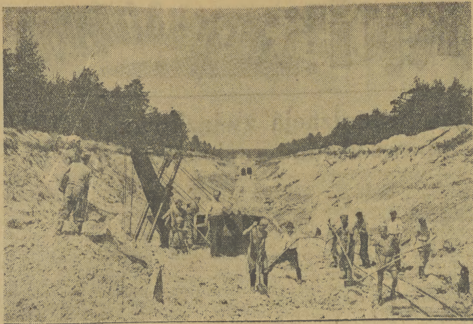
Na Śląsku w woj. katowickim powstaje wielka Magistrala Piaskowa, która będzie zaopatrywała w piasek z Pustyni Będzowskiej śląskie kopalnie węgla. Na zdjęciu: tramwaj budowy Magistrali Piaskowej. GAF - fot. Nowosielski
