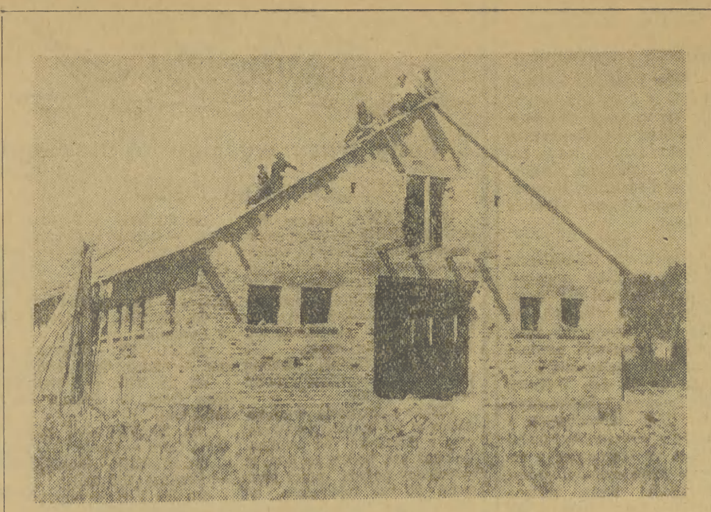
Dbając do podniesienia zespolowej hodowli była członkowie spółdzielni produkcyjnej w Powisnie w pow. płockim przystąpili do budowy obory spółdzielczej. Na zdjęciu: spółdzielcy przy budowie nowoczesnej obory.
