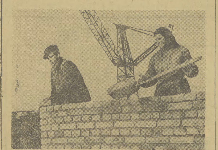
Celem uczczenia 10-ty rocznicy powstania PPR — ZMP-owska brygada młodzieżowa Jana Dembowskiego z ZBM — ZB 5 — budująca we Wrzeszczu osiedle robotnicze, zobowiązała się podnieść wydajność pracy o 30 do 40 proc. Na zdjęciu: brygadziści Jan Dembowski i Eugenia Kosińska przy murowaniu ściany systemem dwójkowym. CAF — fot. Celis
